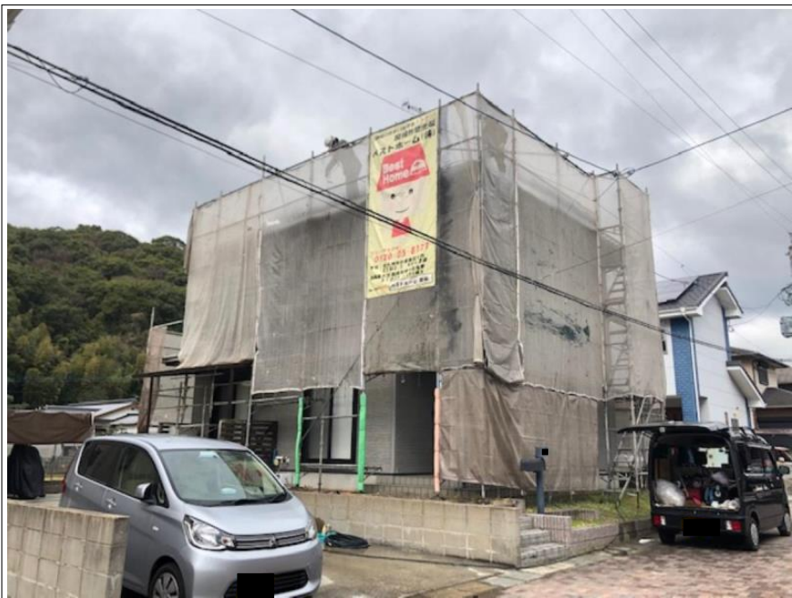
足場組立 完了
