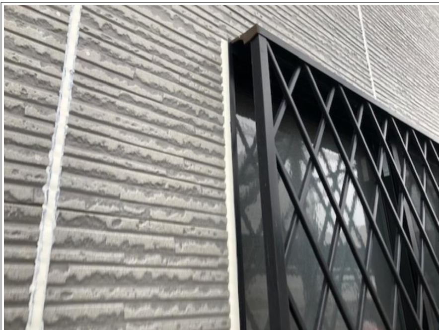
シーリング打ち増し
