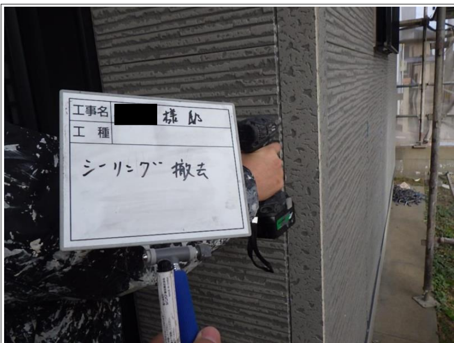
シーリング打ち替え
