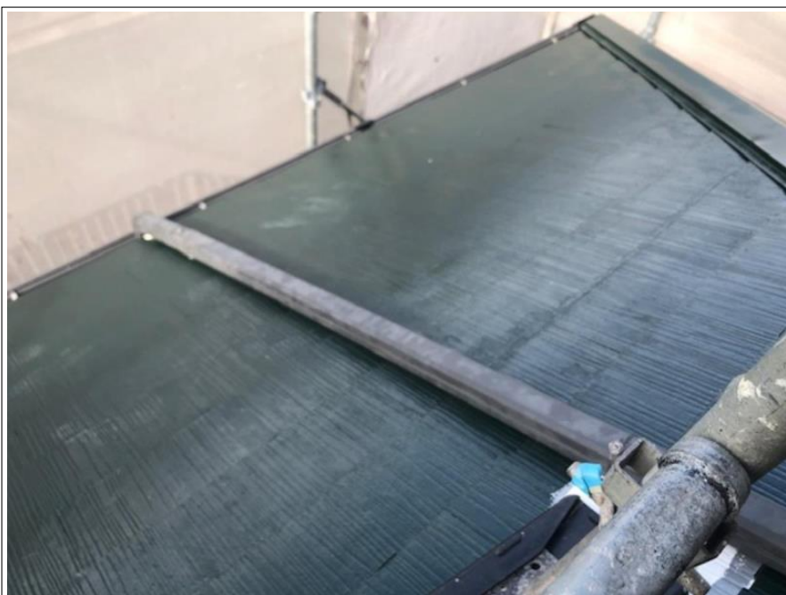
雨樋破損部 復旧工事
