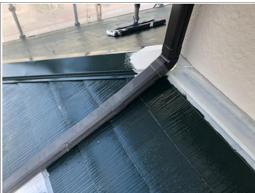
雨樋破損部 復旧工事
