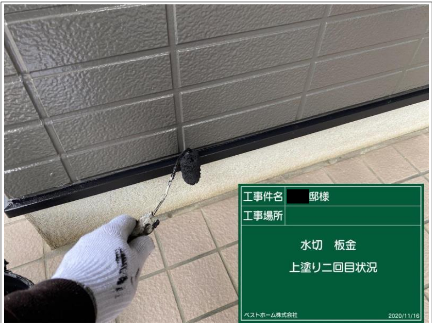
工事件名 ■ 邸様 工事場所 水切 板金 上塗り一回目完了 ベストホーム株式会社 2020/11/16
