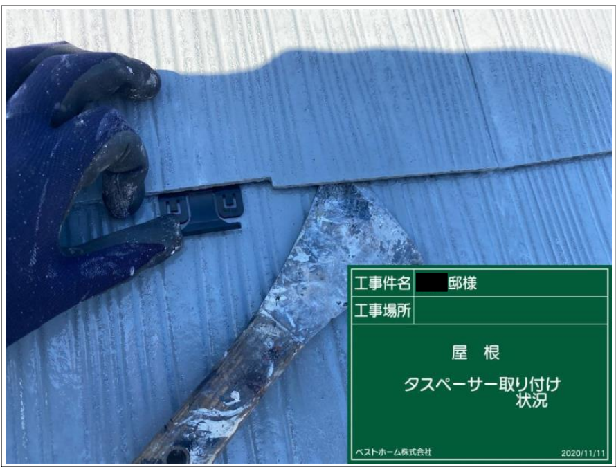
工事件名 ■ 邸様 工事場所 屋根 タスペーサー取り付け 状況 ベストホーム株式会社 2020/11/11
