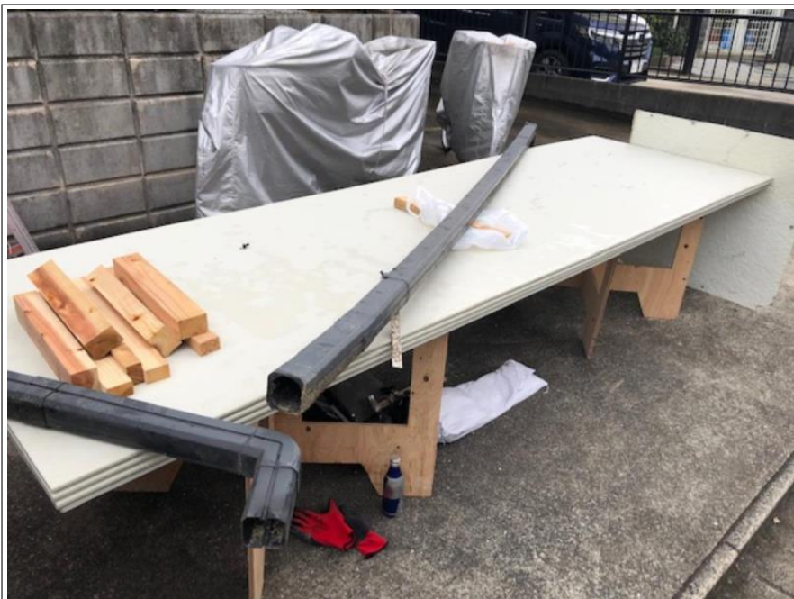
雨樋破損部 復旧工事
