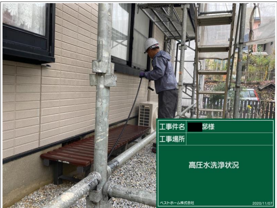
工事件名 ■ 邸様 工事場所 高圧水洗浄状況 ベストホーム株式会社 2020/11/07
