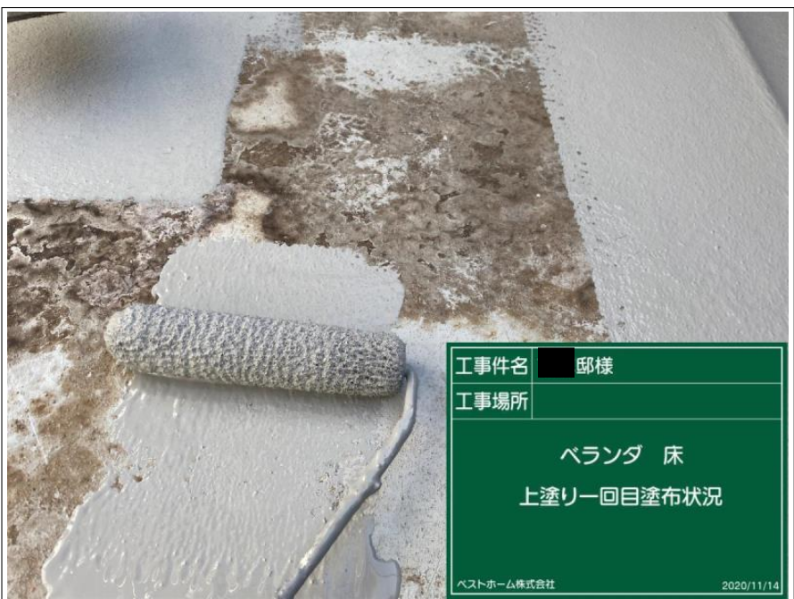
工事件名 邸様 工事場所 ベランダ 床 上塗り一回目塗布状況 ベストホーム株式会社 2020/11/14
