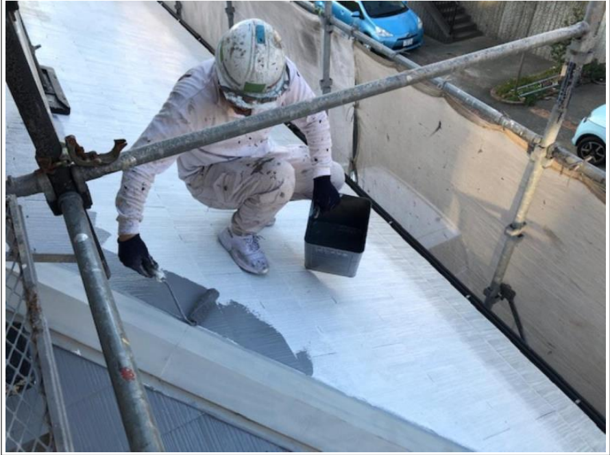
工事件名 邸様 工事場所 下屋根 下塗り二回目塗布 状況 ベストホーム株式会社 2020/11/11
