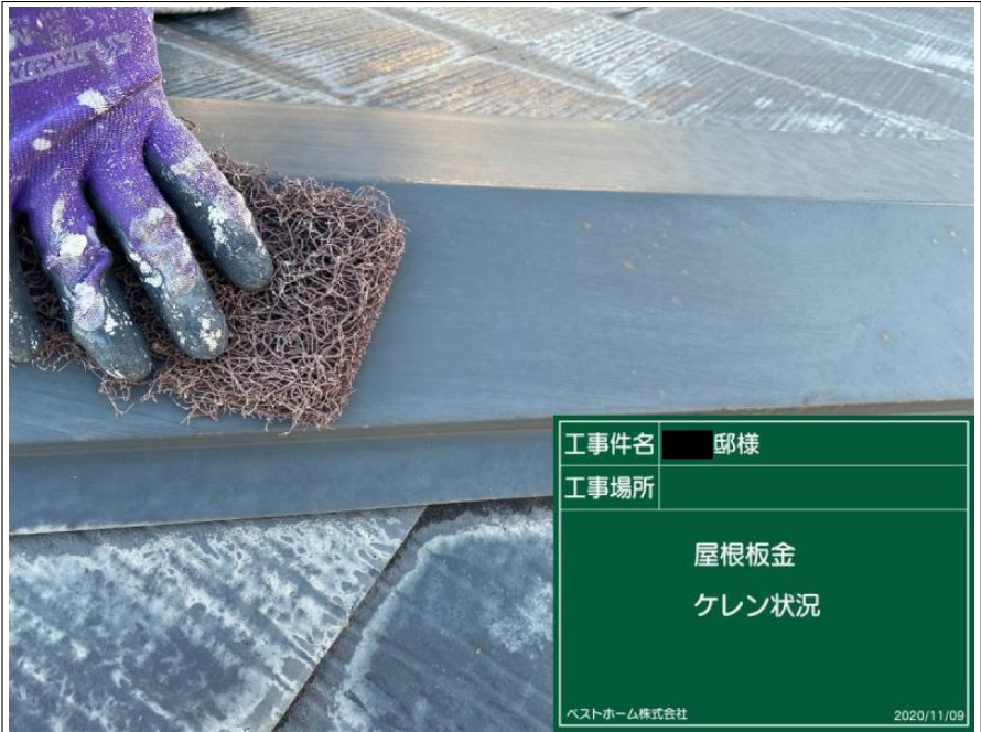
工事件名 ■ 邸様 工事場所 屋根板金 ケレン状況 ベストホーム株式会社 2020/11/09
