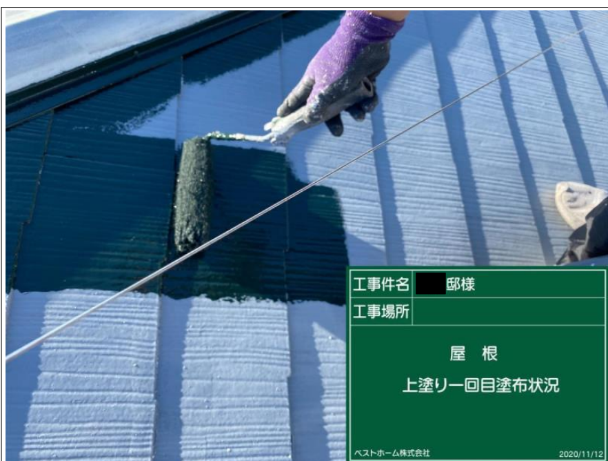
工事件名 ■ 邸様 工事場所 屋 根 上塗り一回目塗布状況 ベストホーム株式会社 2020/11/12
