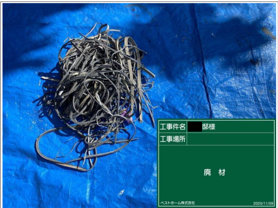
工事件名 邱様 工事場所 外壁目地シーリング 撤去 状況 ベストホーム株式会社 2020/11/09
