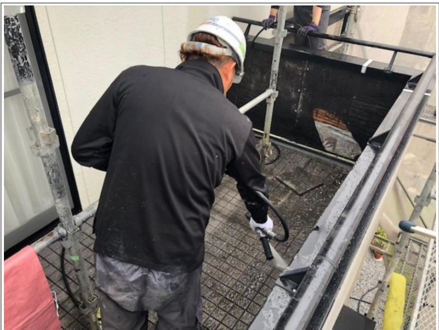
工事件名 ■ 邸様 工事場所 高圧水洗浄状況 ベストホーム株式会社 2020/11/07
