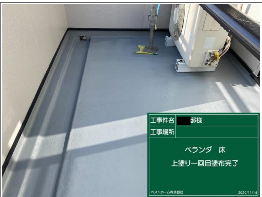
工事件名 邸様 工事場所 ベランダ 床 上塗り一回目塗布状況 ベストホーム株式会社 2020/11/14
