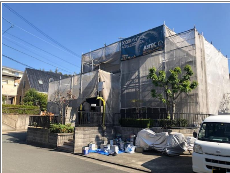
足場組立 完了
