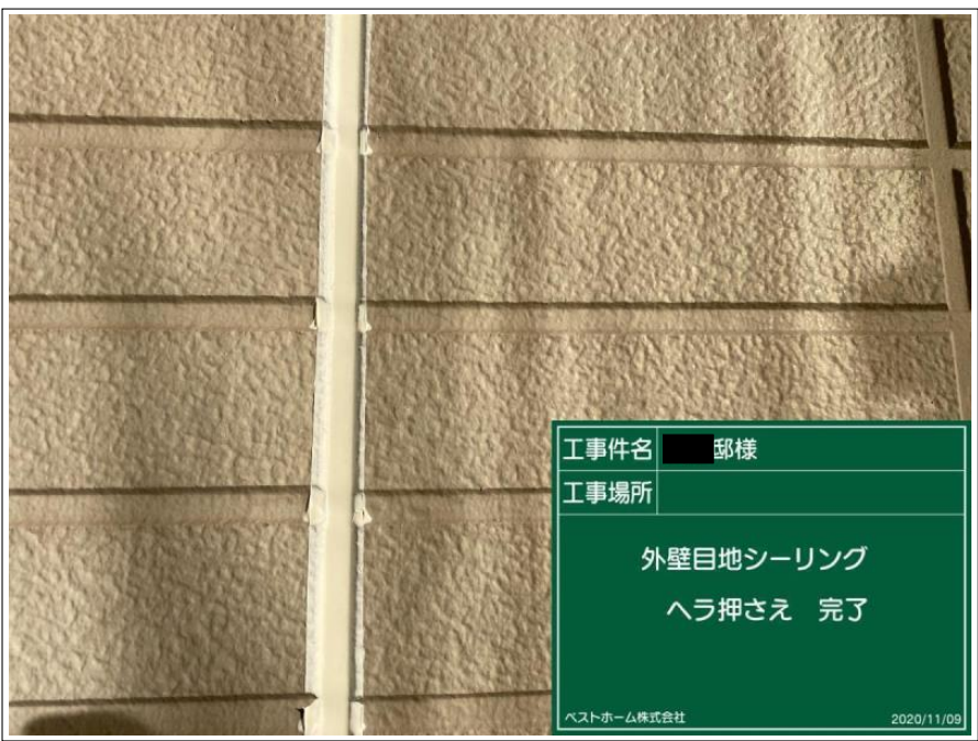
工事件名 ■ 邸様 工事場所 外壁目地シーリング ヘラ押さえ 完了 ベストホーム株式会社 2020/11/09
