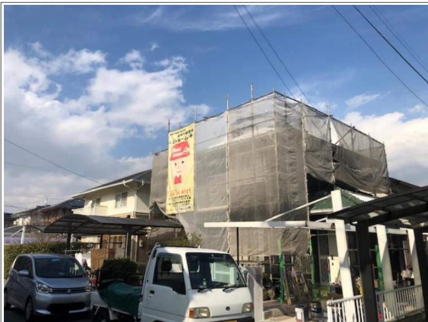
足場組立完了
