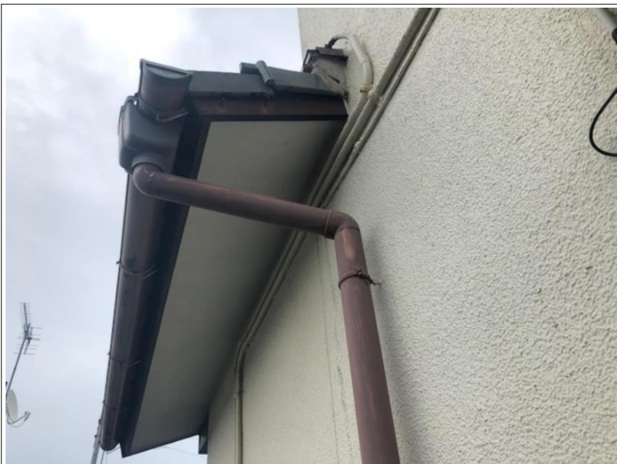
樋・ダクトカバー
