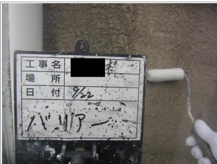
外壁 バリヤー
