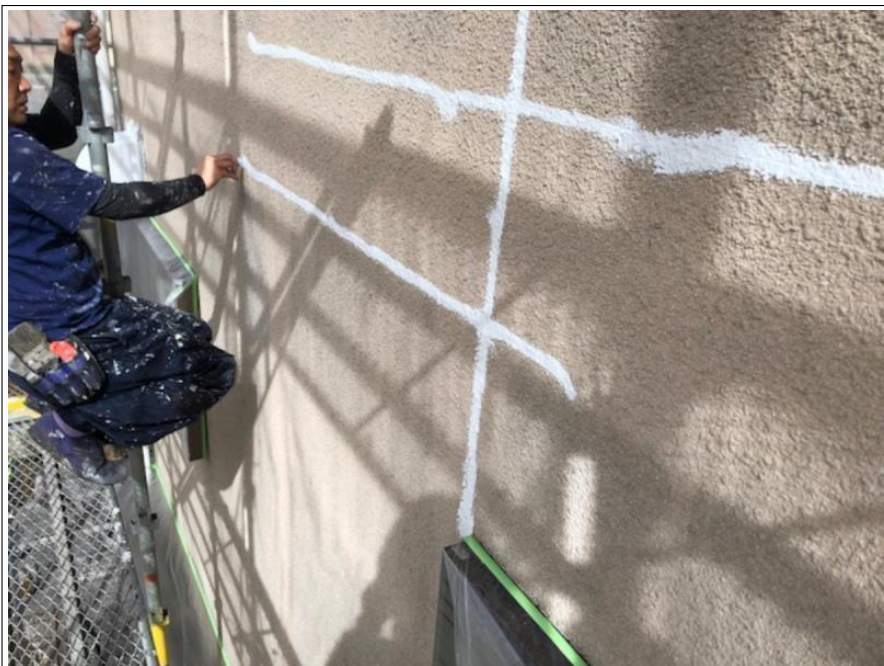
外壁 クラック補修
