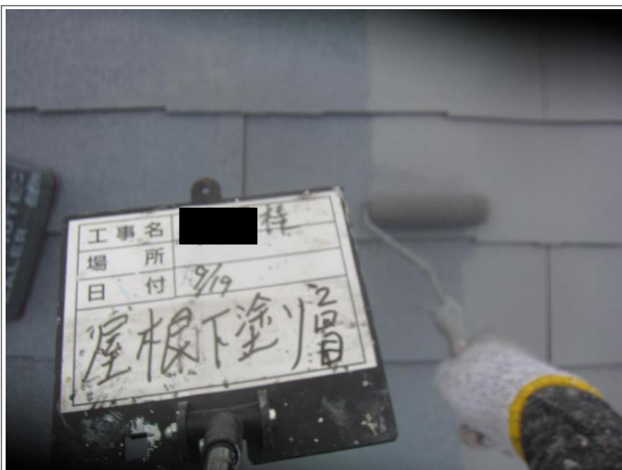
屋根 下塗り 2回目
