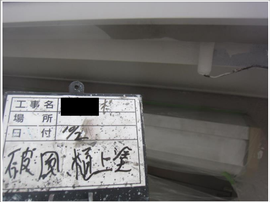
破風板・桧 上塗り
