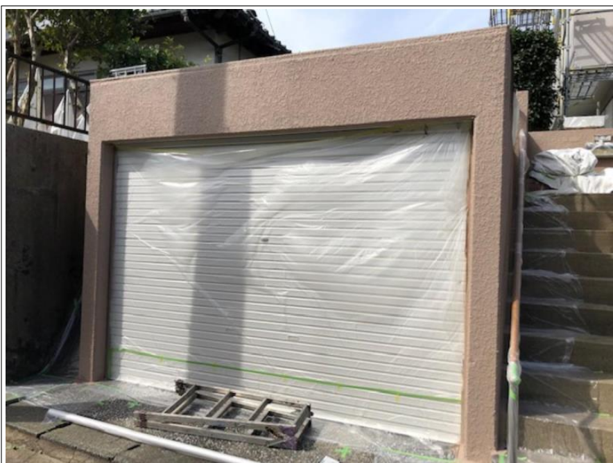
車庫シャッター 上塗り 完了
