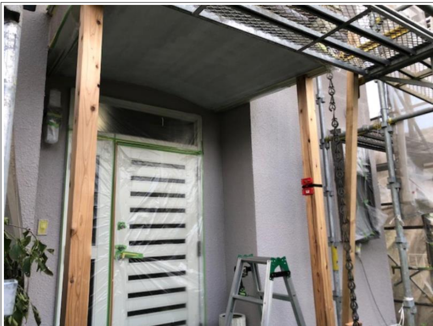
玄関柱 取付け 完了
