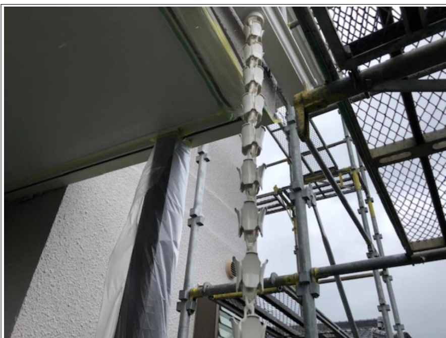
玄関 樋 鎖 取付け 完了
