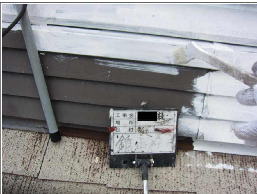
屋根棟鉄板 サビ止め
