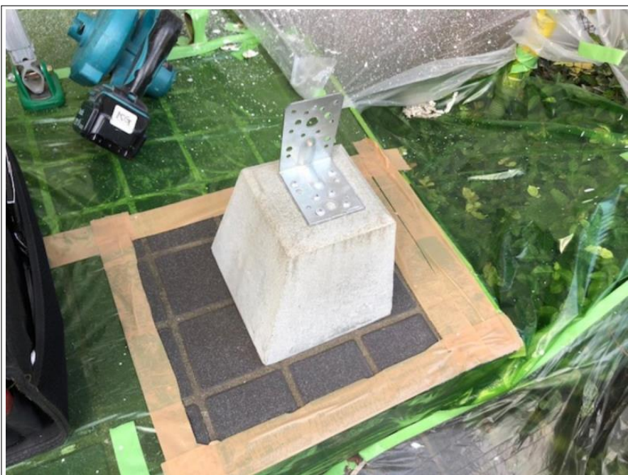
玄関柱 取付け
