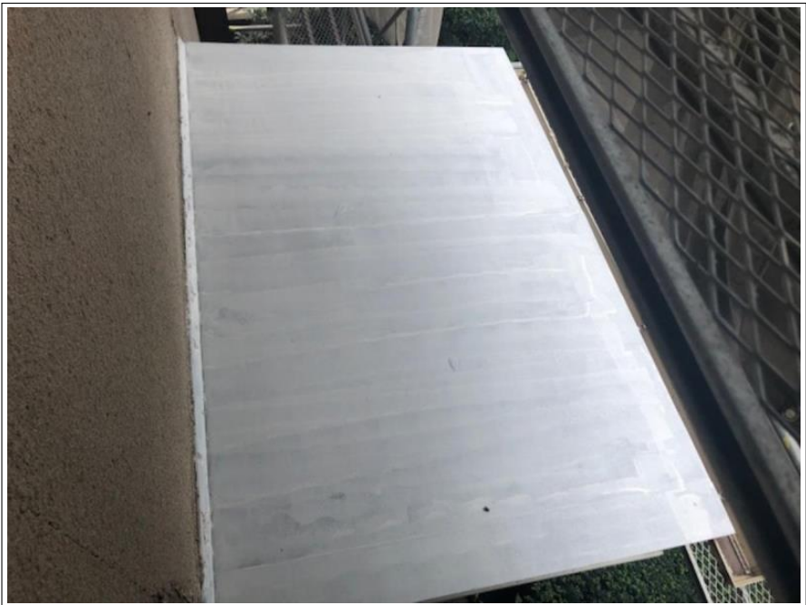
玄関庇 下塗り
