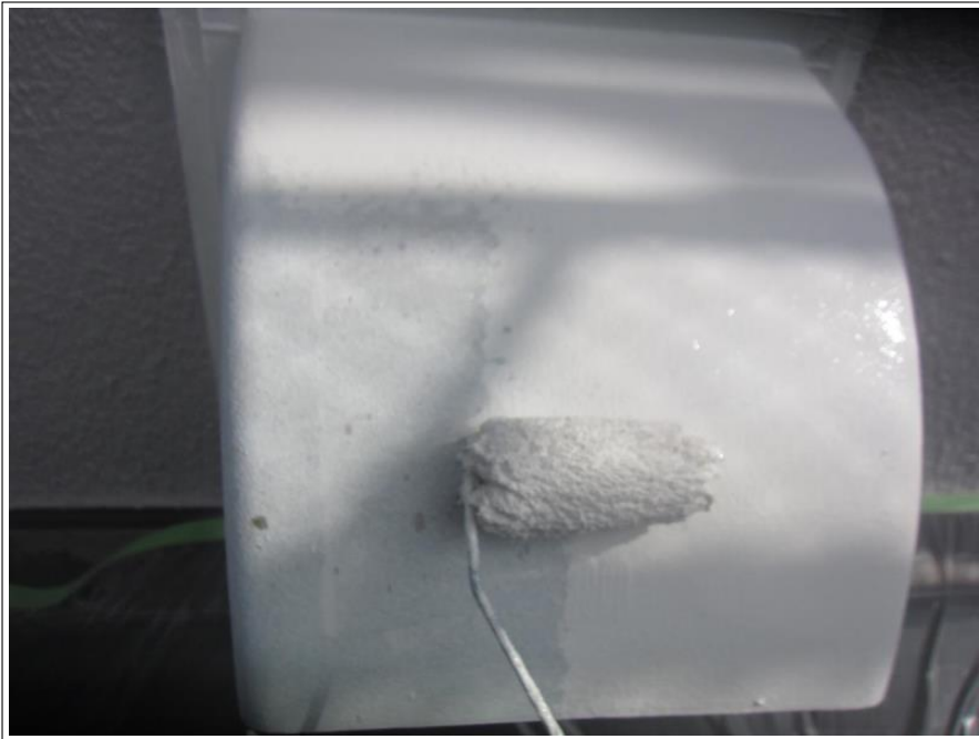
換気フード 上塗り
