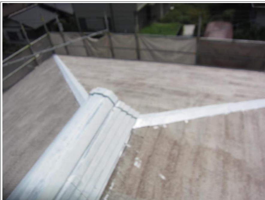
屋根棟鉄板 サビ止め
