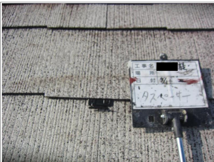
屋根 タスペーサー取付
