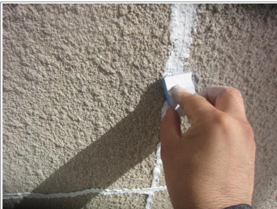
外壁 クラック補修
