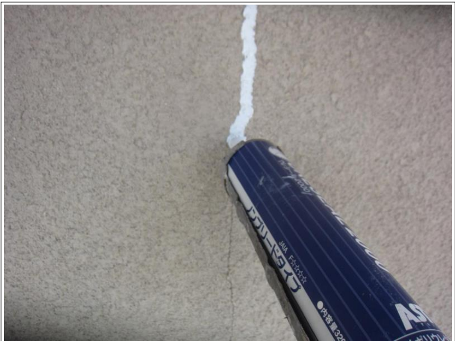
外壁 クラック補修
