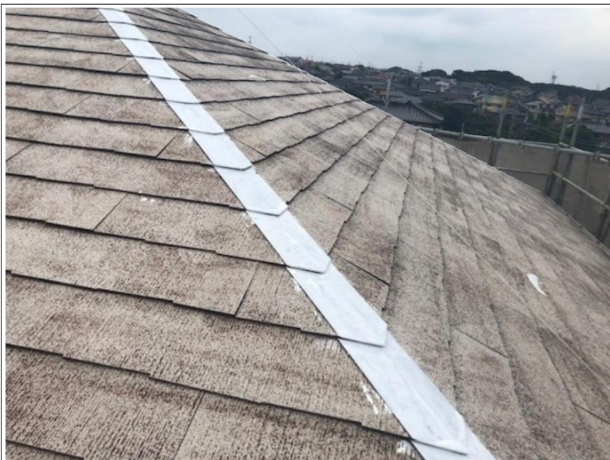
屋根棟鉄板 サビ止め
