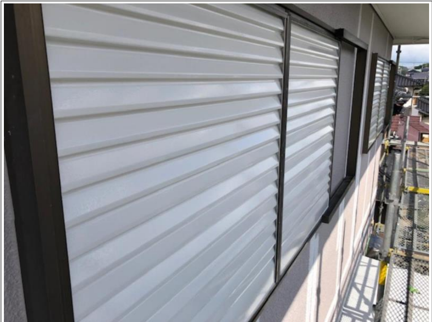
雨戸 上塗り 完了
