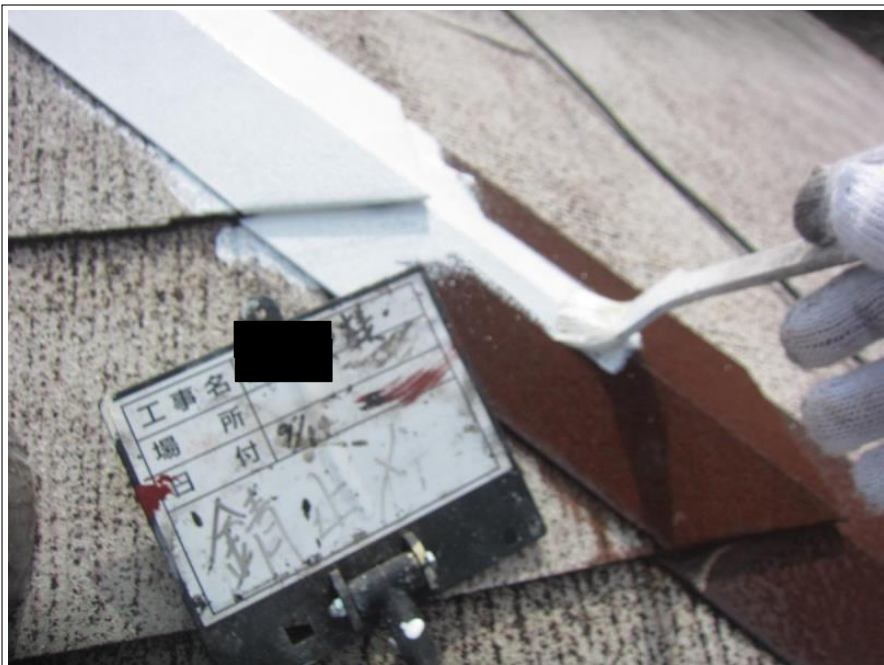
屋根棟鉄板 サビ止め
