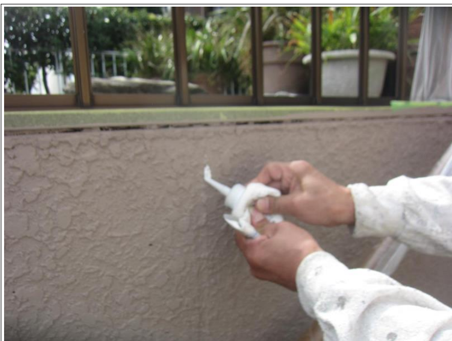
塀 クラック コーキング補修
