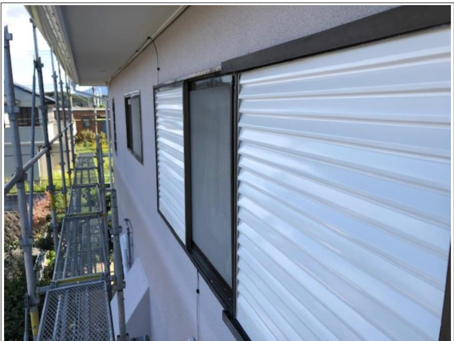
雨戸 上塗り 完了
