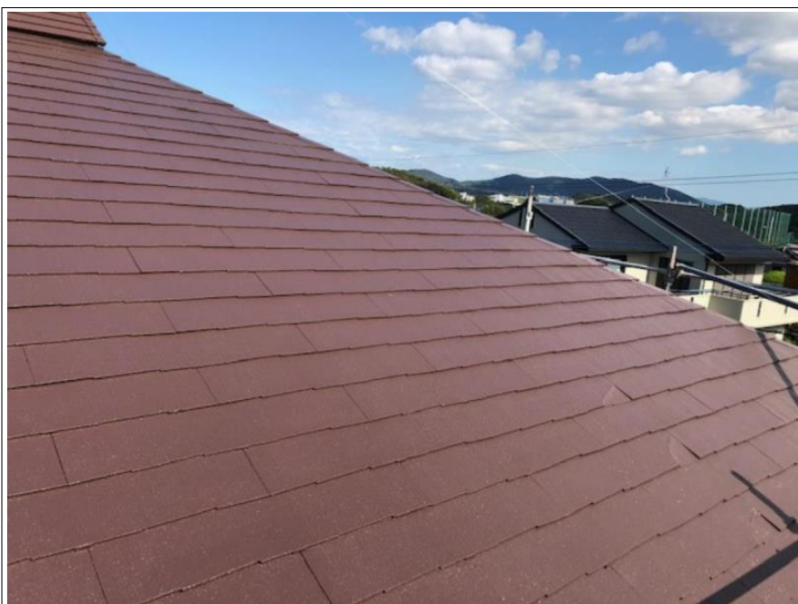
屋根 上塗り 完了
