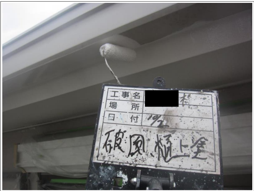
破風板・樋 上塗り
