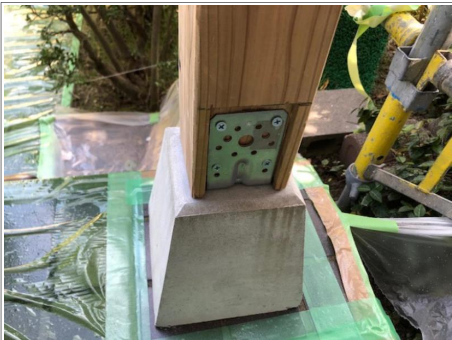
玄関柱 取付け
