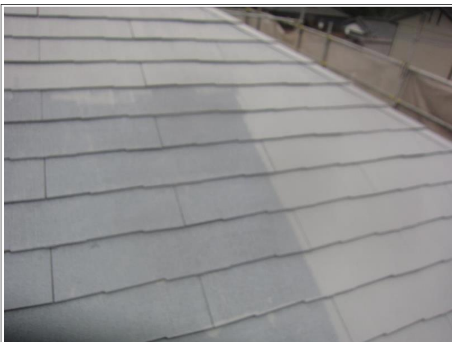
屋根 下塗り 2回目
