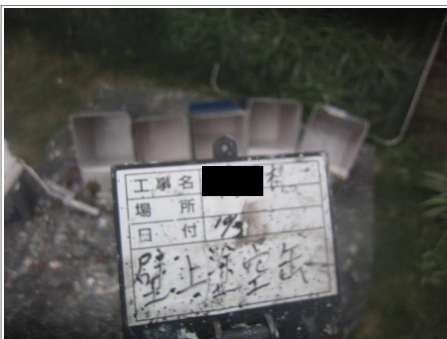
外壁 上塗り 空缶写真
