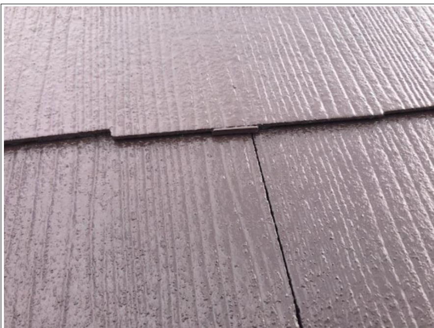
屋根 タスペーサー取付 完了
