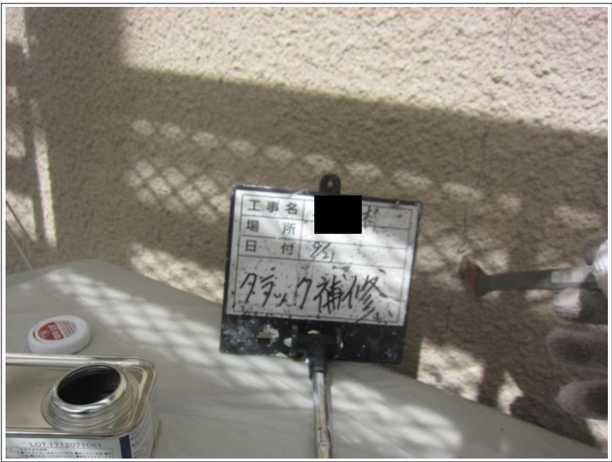
外壁 クラック補修
