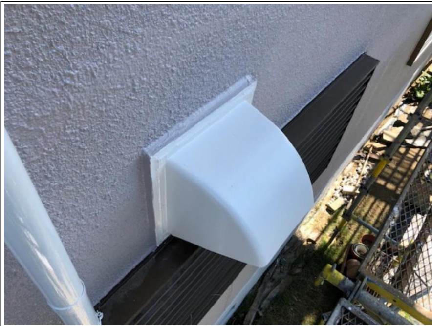
換気フード 施工完了
