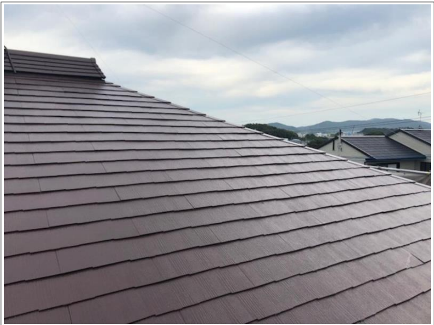
屋根 上塗り 完了
