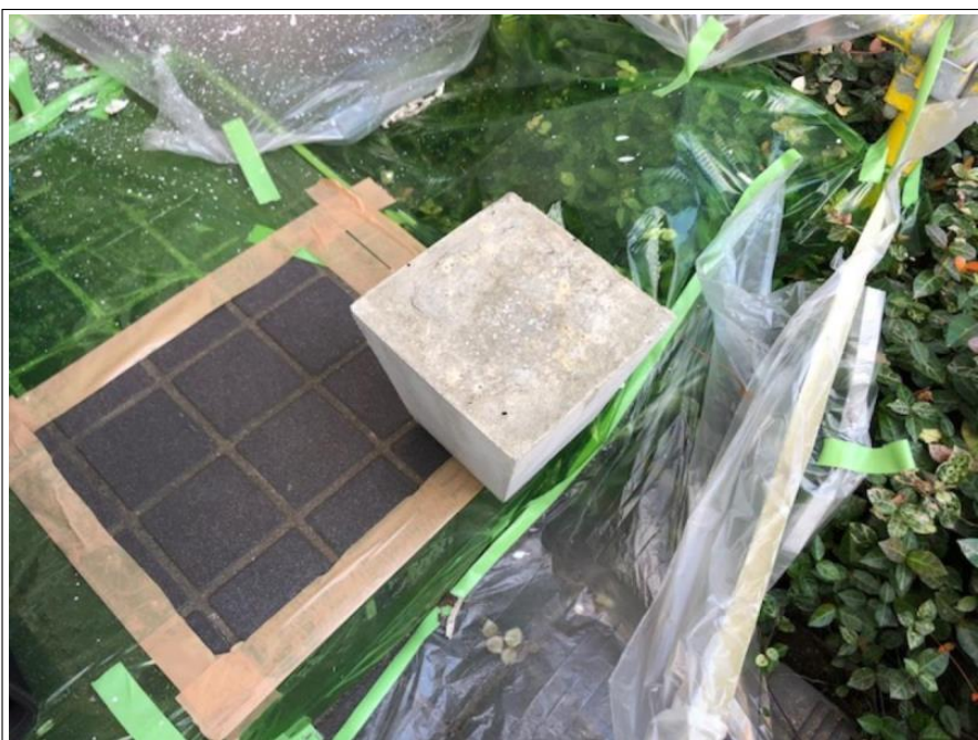
玄関柱 取付け
