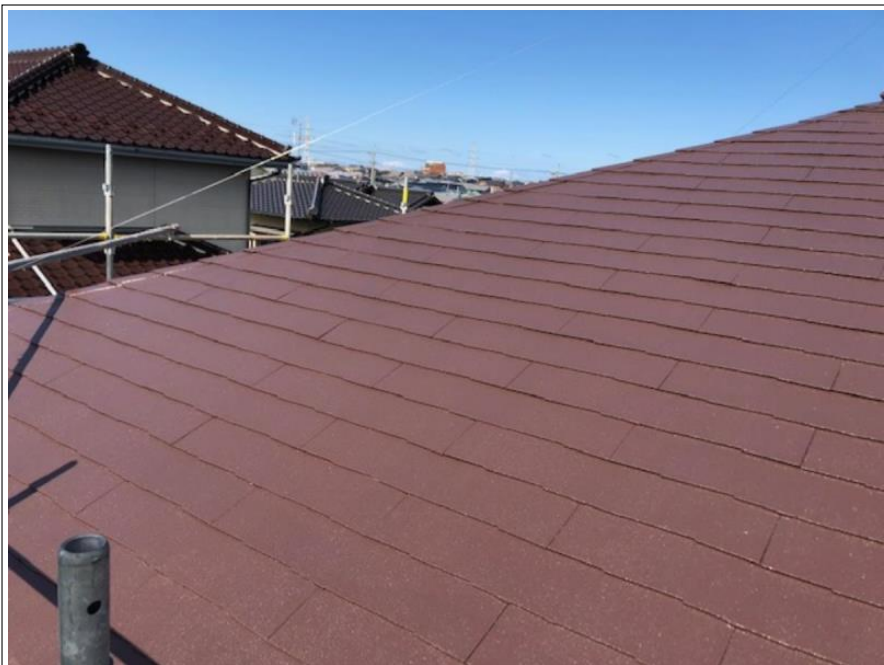
屋根 上塗り 完了
