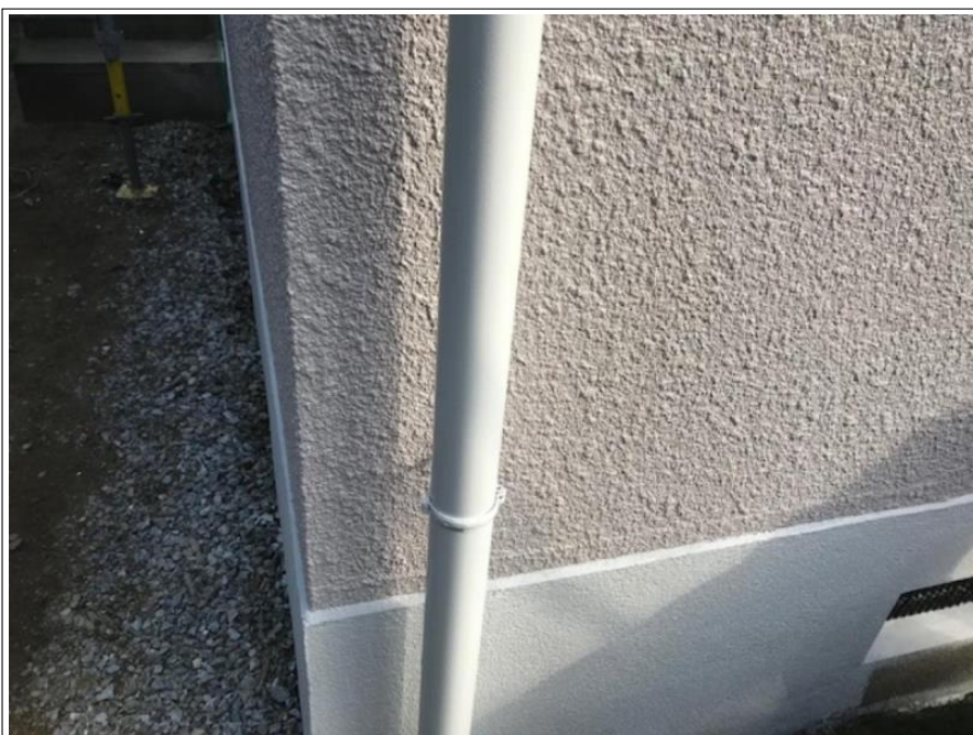
樋 上塗り 完了
