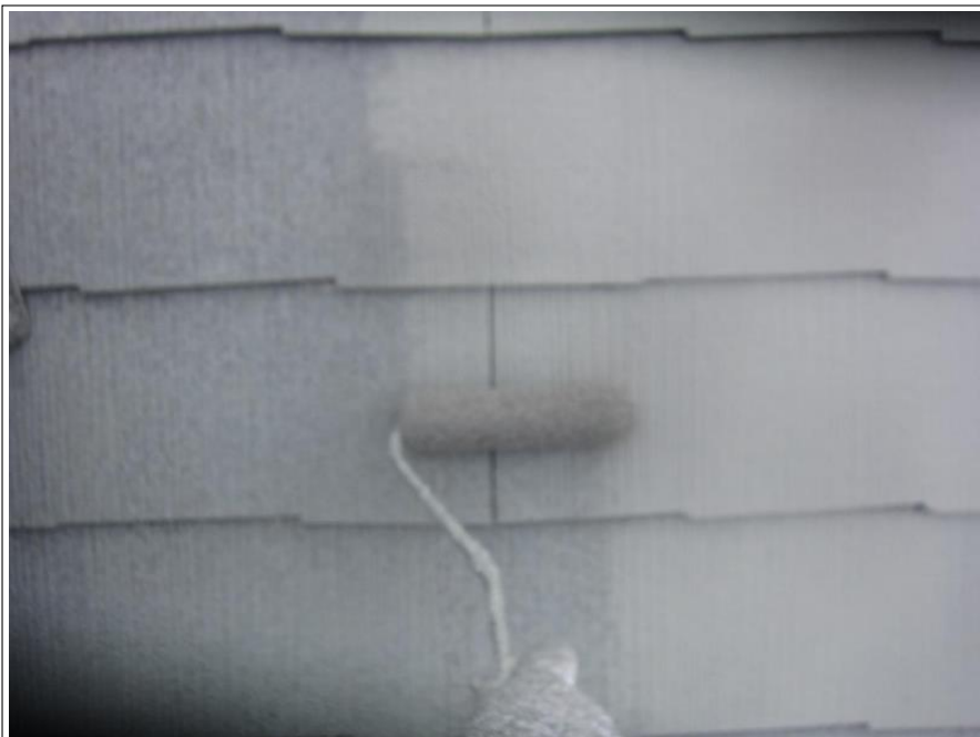
屋根 下塗り 2回目
