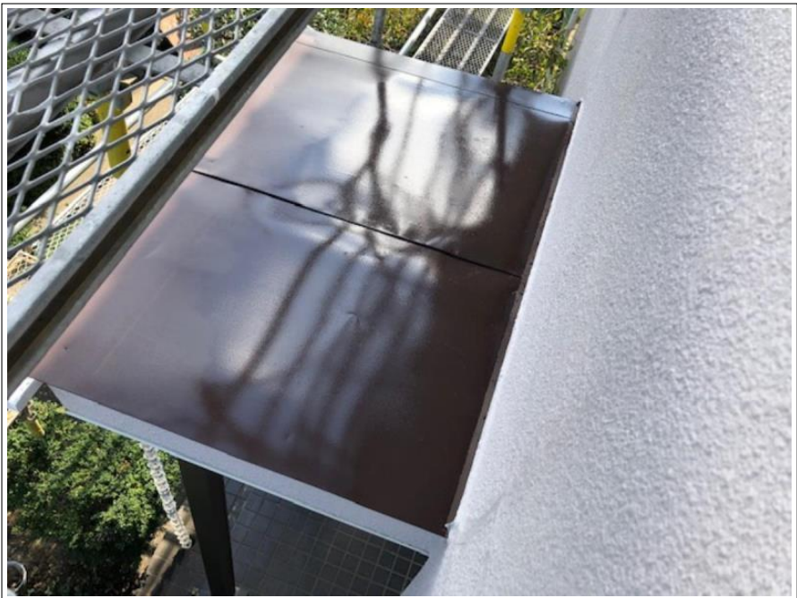
小庇 上塗り 完了
