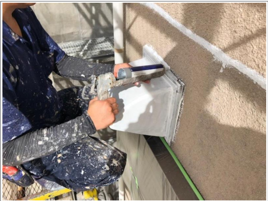
換気フード コーキング補修
