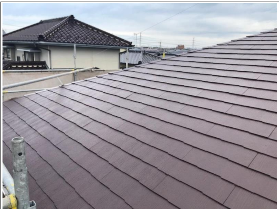
屋根 上塗り 完了
