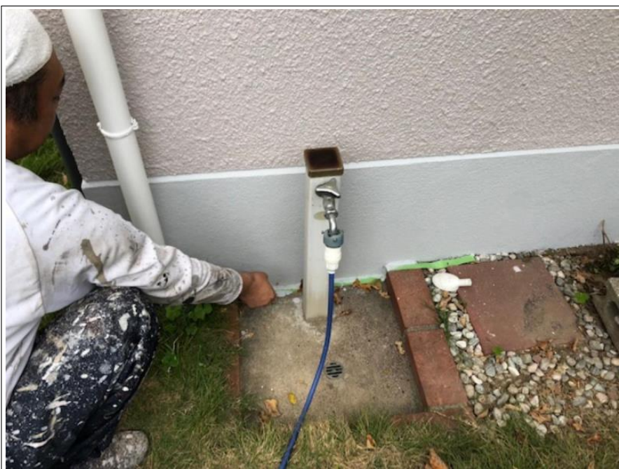
幅木 施工完了
