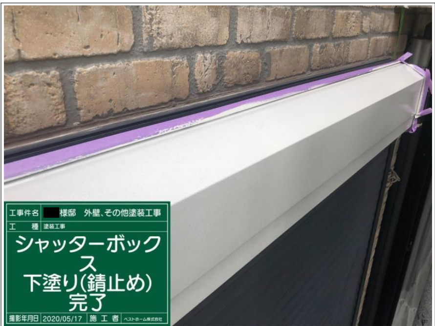
工 事 件 名 様邸 外壁、その他塗装工事 工 種 塗装工事 シャッターボックス 下塗り(錆止め) 撮影年月日 2020/05/17 施 工 者 ヘストホーム株式会社
