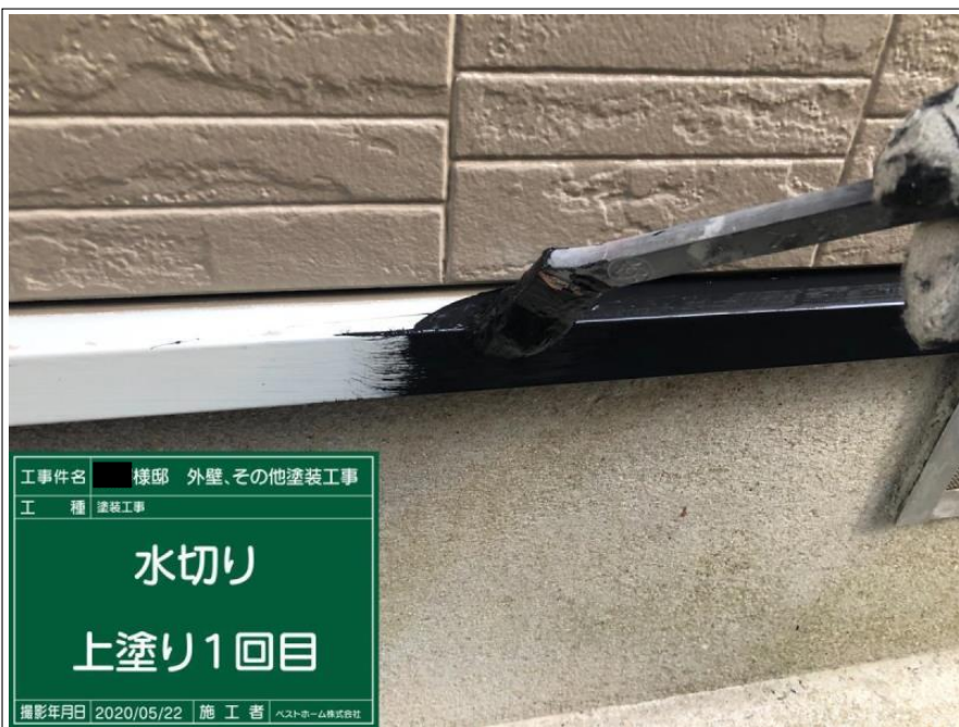
工 事 名 様邸 外壁、その他塗装工事 工 種 塗装工事 水切り 上塗り1回目 撮影年月日 2020/05/22 施 工 者 ヘストホーム株式会社
