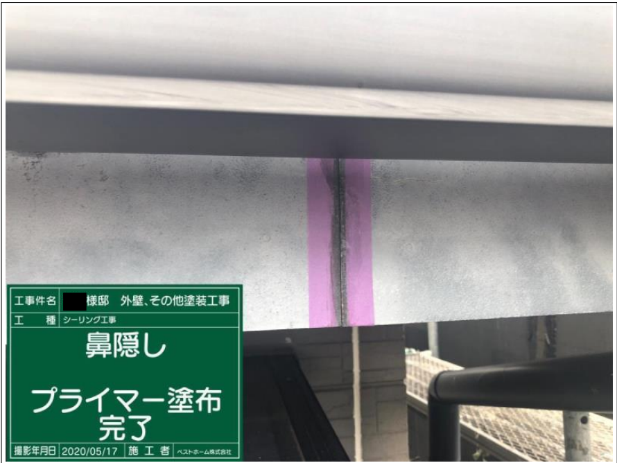
工事件名 様邸 外壁、その他塗装工事 工 種 シーリング工事 鼻隠し プライマー塗布 撮影年月日 2020/05/17 施 工 者 ベストホーム株式会社
