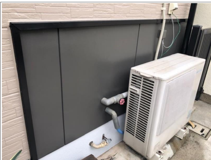
外壁 モルタル部
