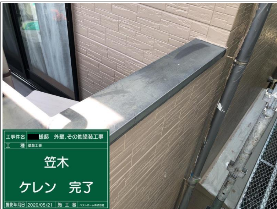
工事件名 様邸 外壁、その他塗装工事 工 種 塗装工事 笠木 ケレン 撮影年月日 2020/05/21 施 工 者 ベストホーム株式会社
