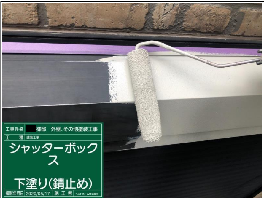
工 事 件 名 様邸 外壁、その他塗装工事 工 種 塗装工事 シャッターボックス 下塗り(錆止め) 撮影年月日 2020/05/17 施 工 者 ヘストホーム株式会社
