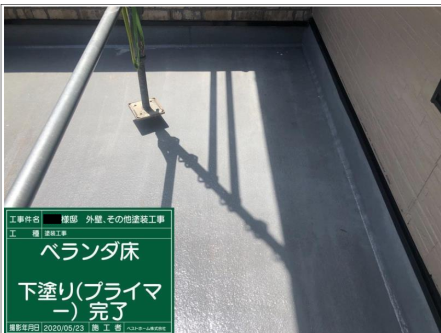
工 事 名 様邸 外壁、その他塗装工事 工 種 塗装工事 ベランダ床 下塗り(プライマ ー) 撮影年月日 2020/05/23 施 工 者 ベストホーム株式会社
