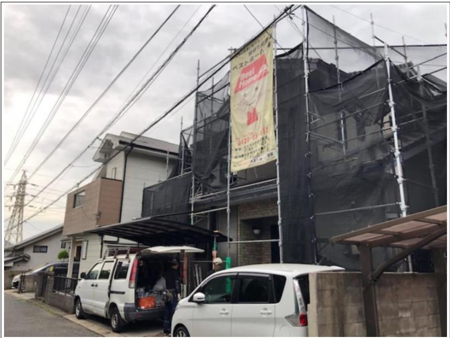
足場組立 完了
