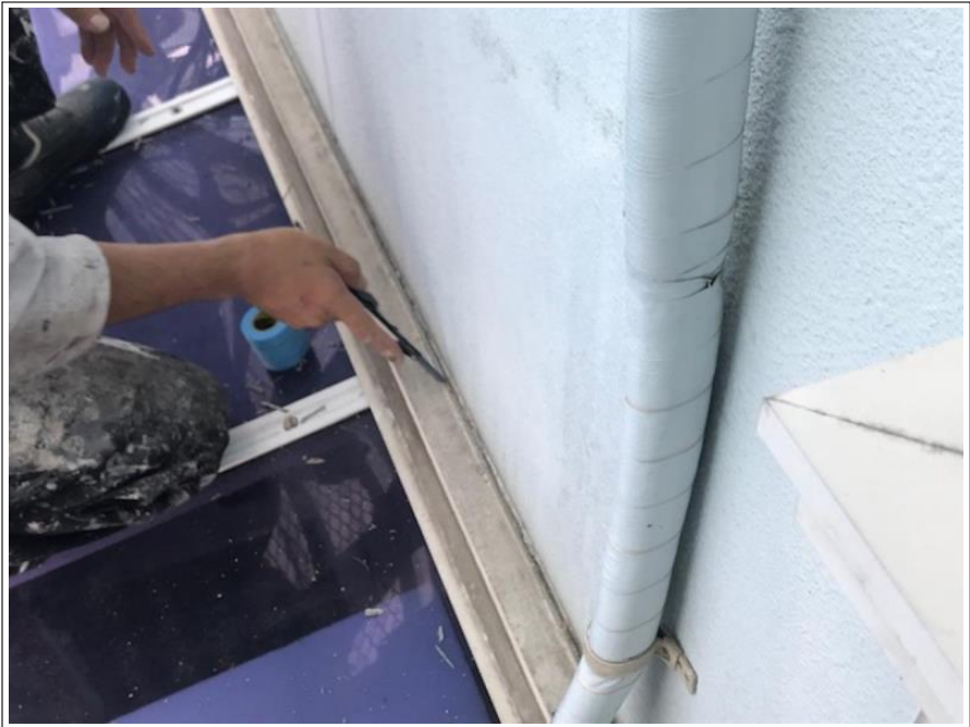
外壁 シーリング除去
