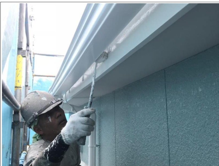
鼻隠し 上塗り
