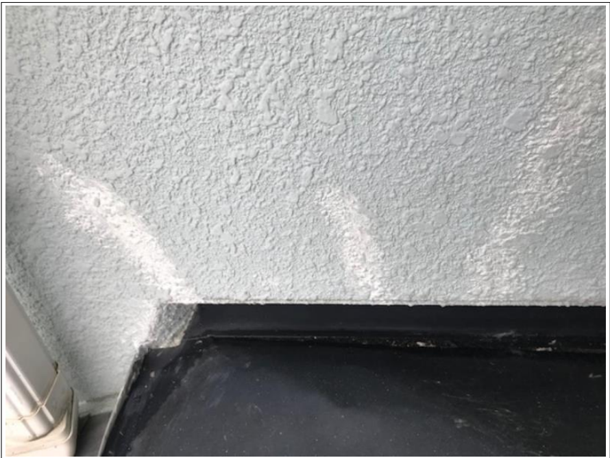
外壁 クラック補修
