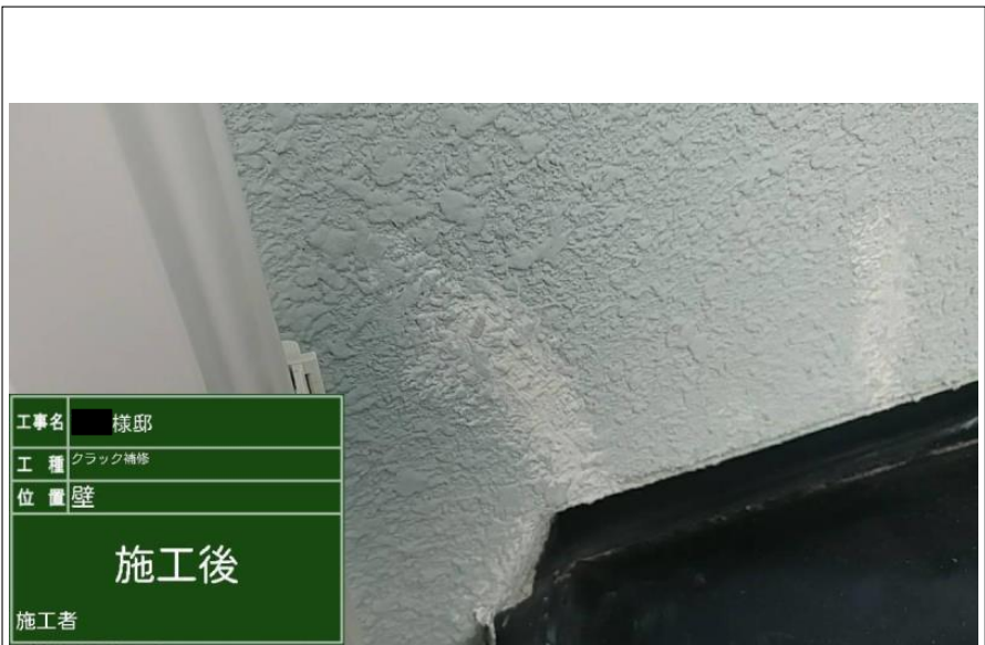
外壁 クラック補修
