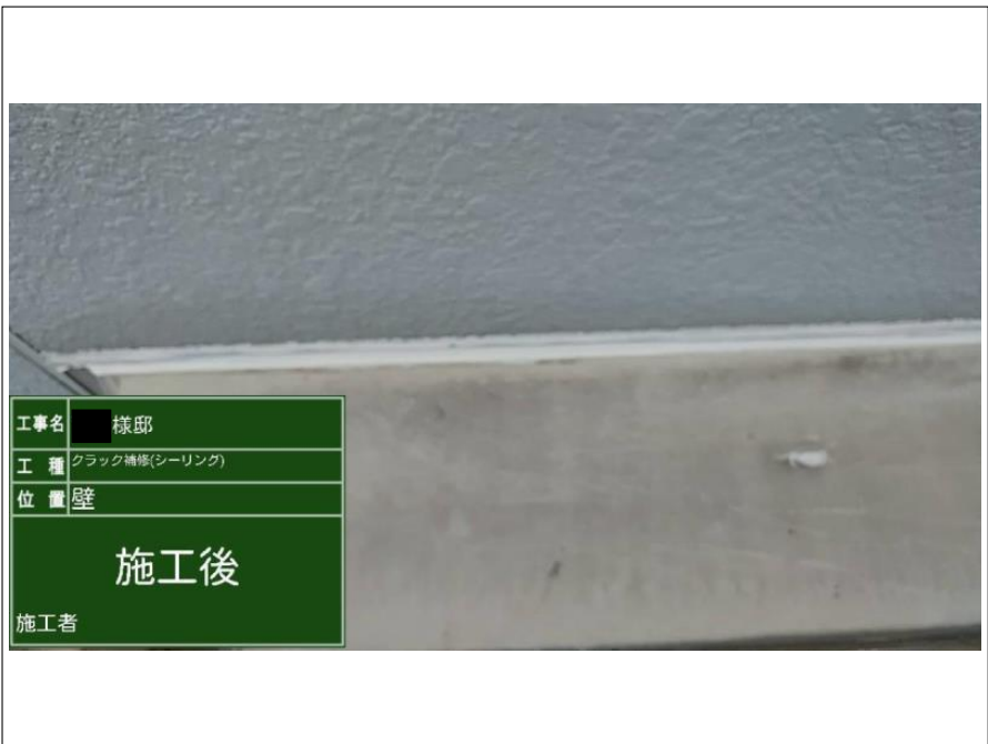
外壁 クラック補修
