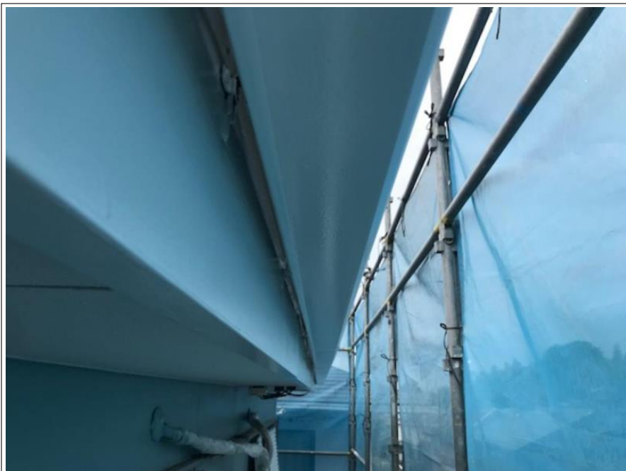
鼻隠し 上塗り
