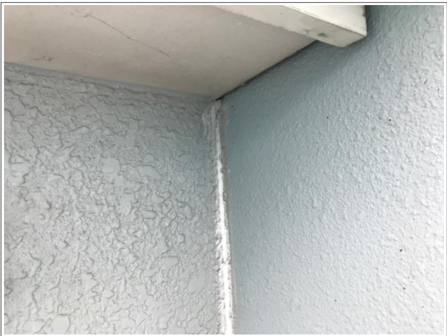
外壁 クラック補修
