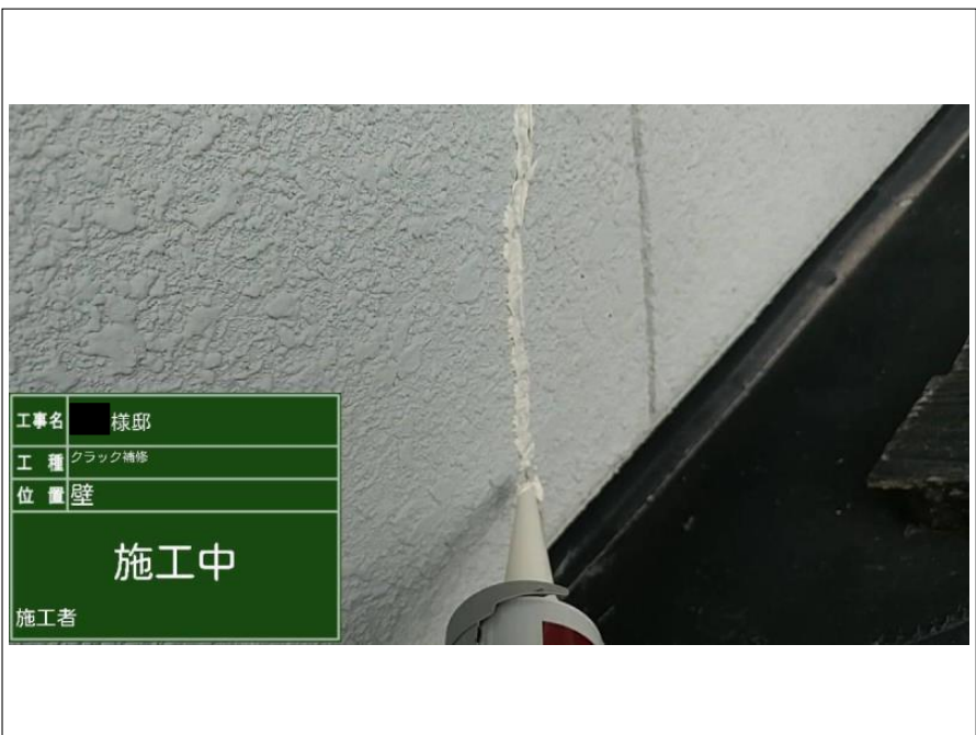
外壁 クラック補修
