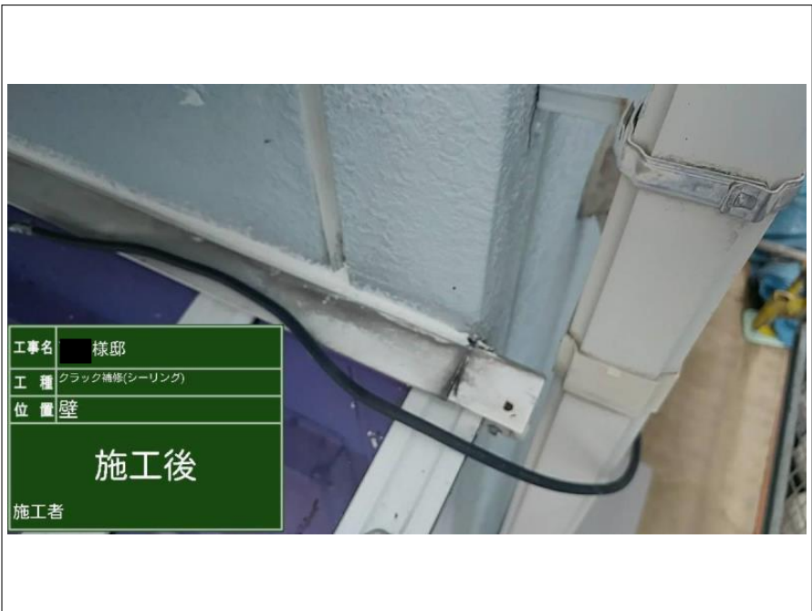
外壁 クラック補修
