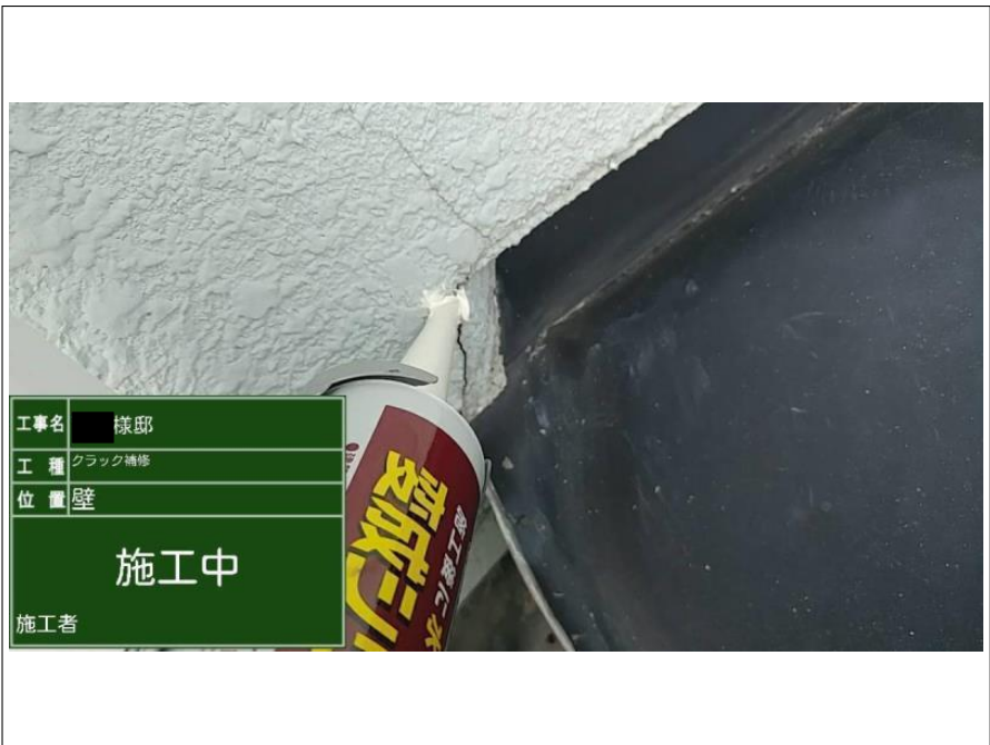
外壁 クラック補修
