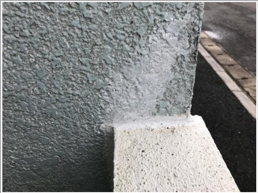
外壁 クラック補修
