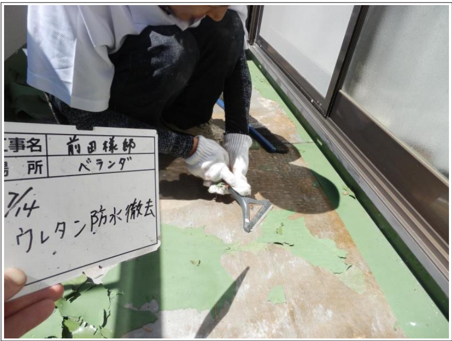
ベランダ ウレタン防水部 撤去
