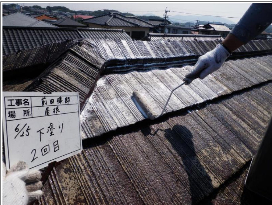
屋根 下塗り 2回目
