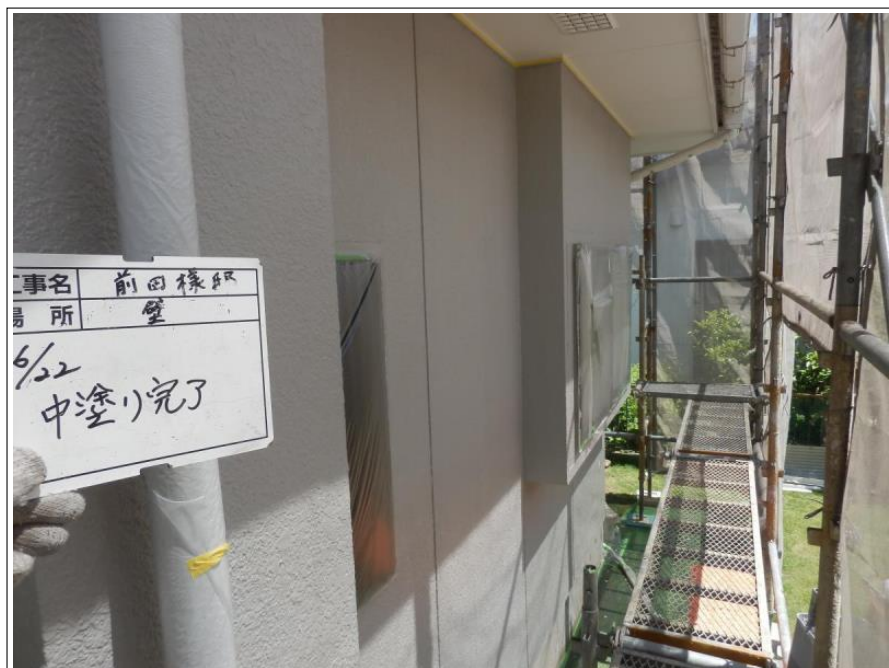
外壁 中塗り 完了
