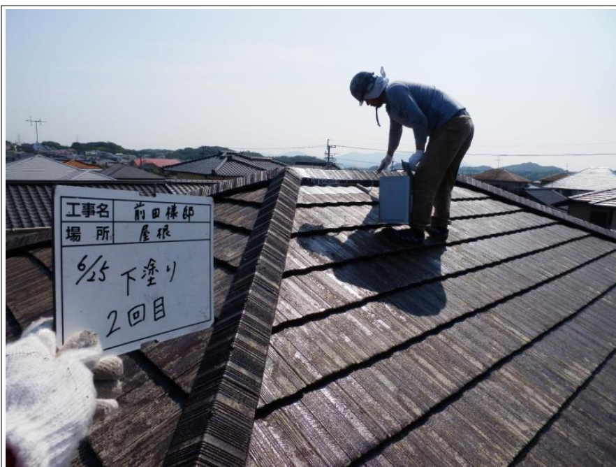
屋根 下塗り 2回目
