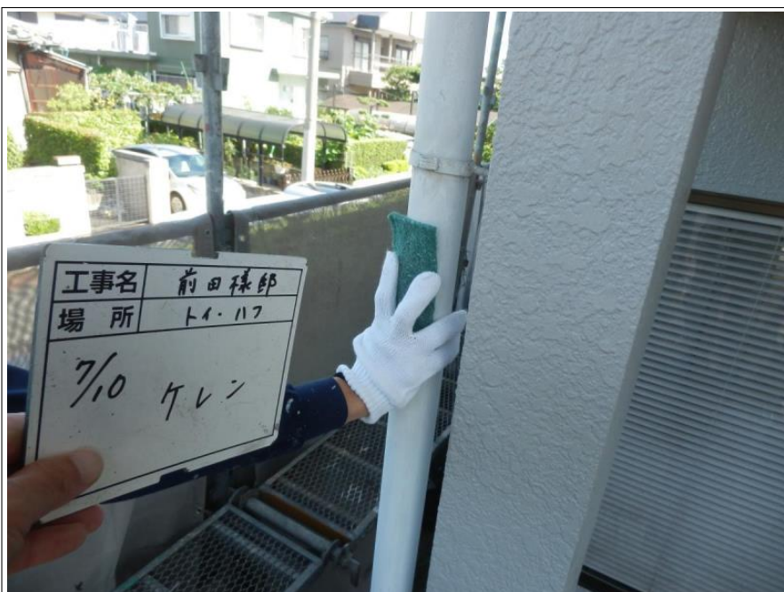
樋・破風 ケレン
