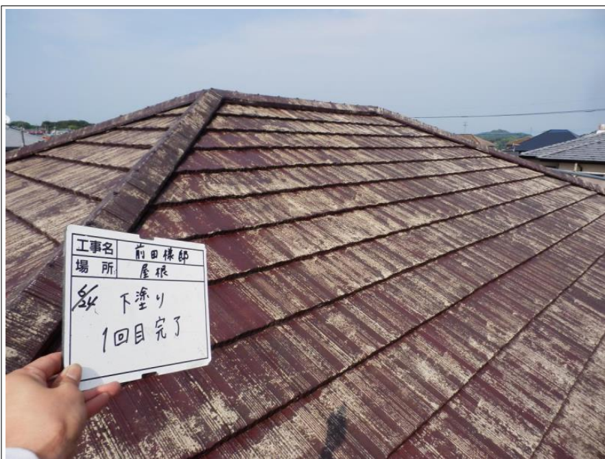
屋根 下塗り 1回目 完了
