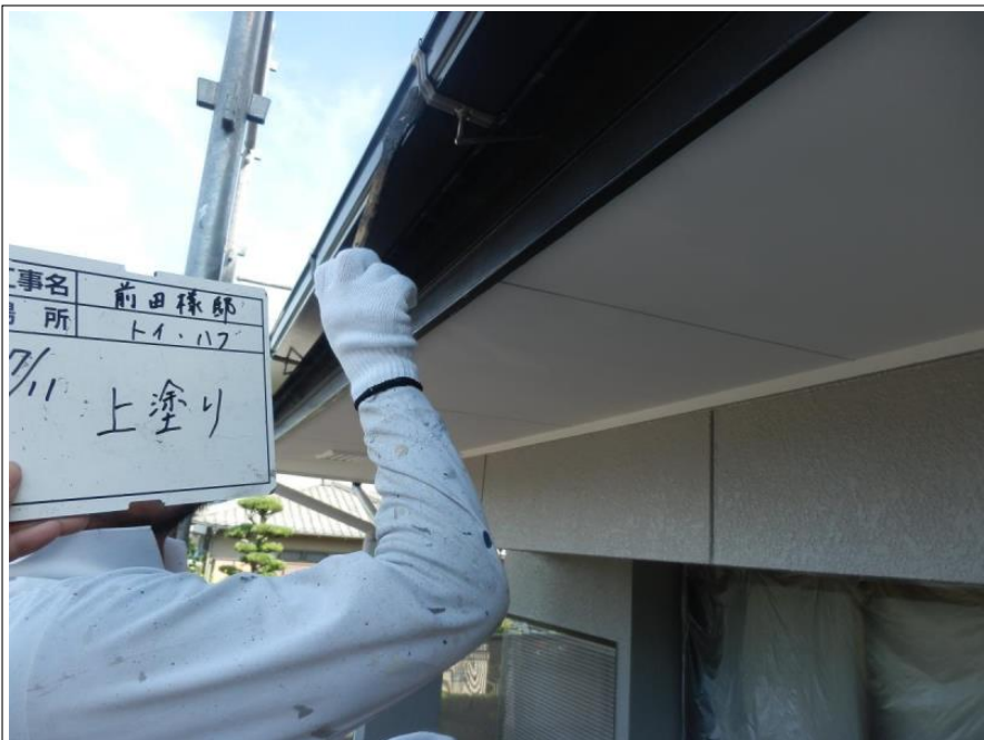
樋・破風 上塗り
