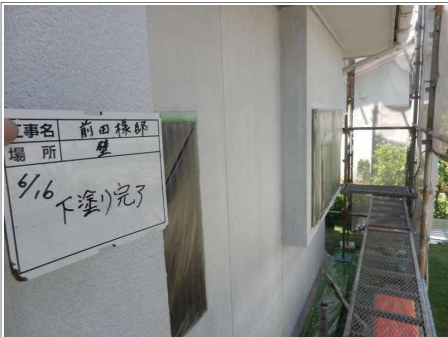
外壁 下塗り 完了
