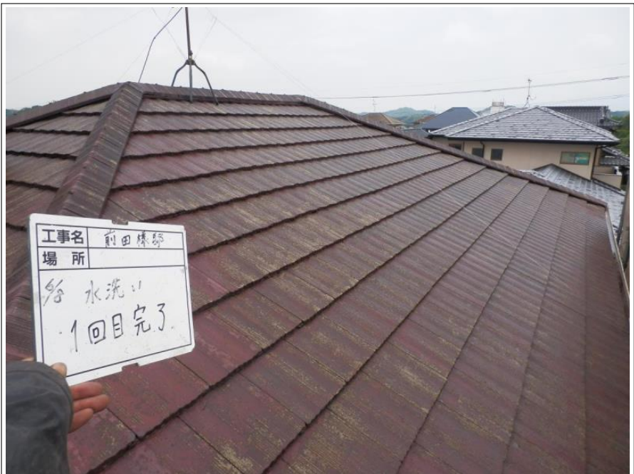
高圧洗浄 完了
