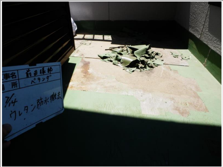
ベランダ ウレタン防水部 撤去
