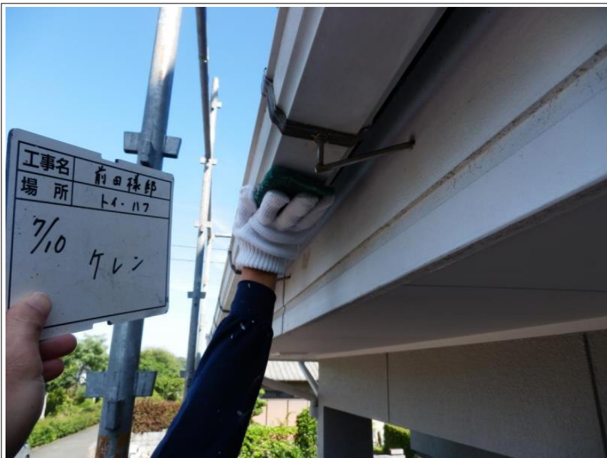
樋・破風 ケレン
