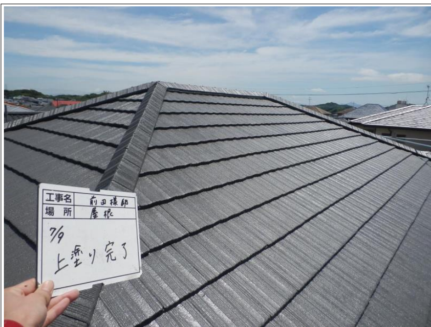
屋根 上塗り 完了
