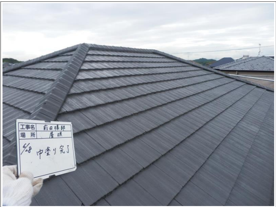
屋根 中塗り 完了
