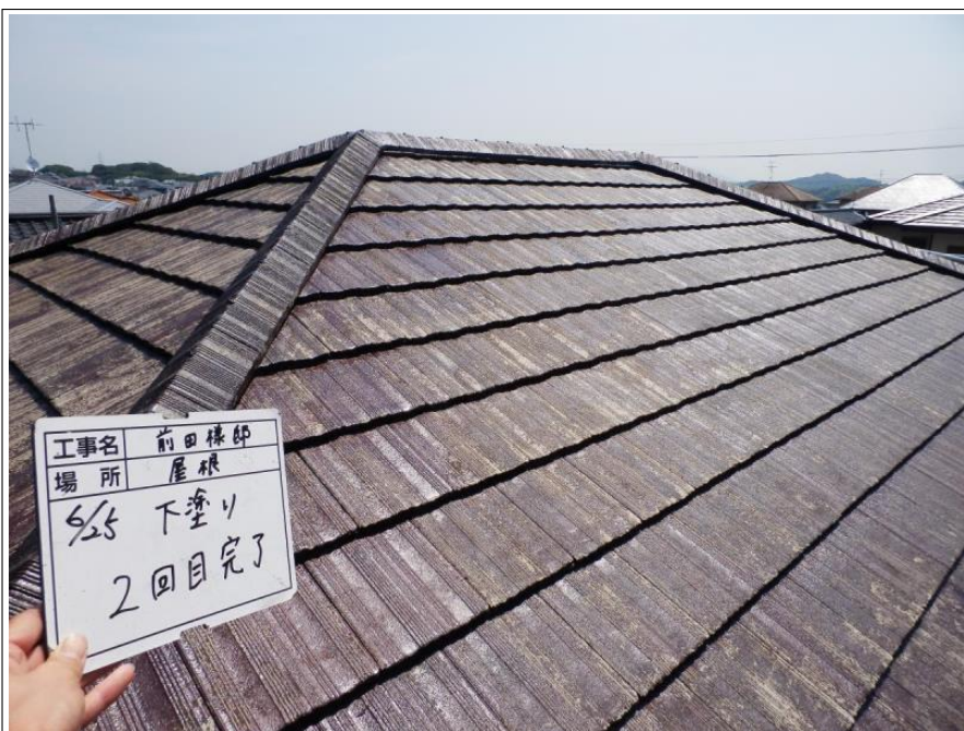
屋根 下塗り 2回目 完了
