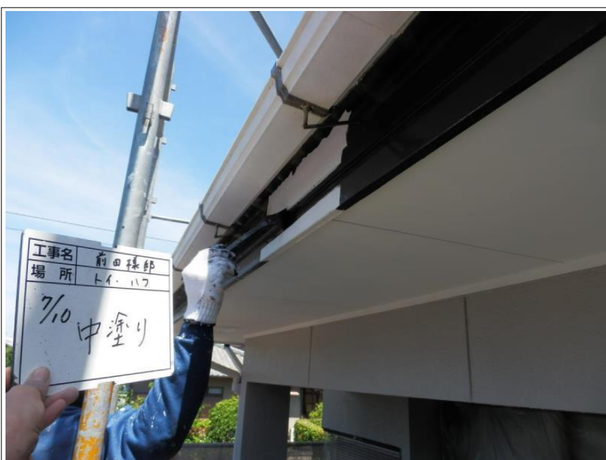
樋・破風 中塗り
