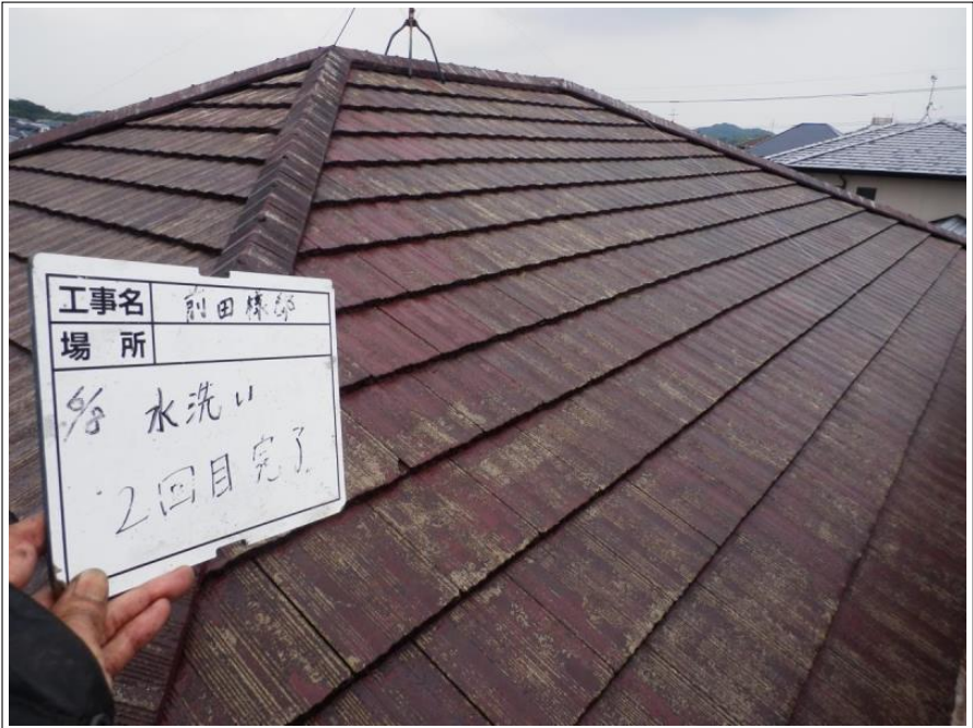
高圧洗浄 完了
