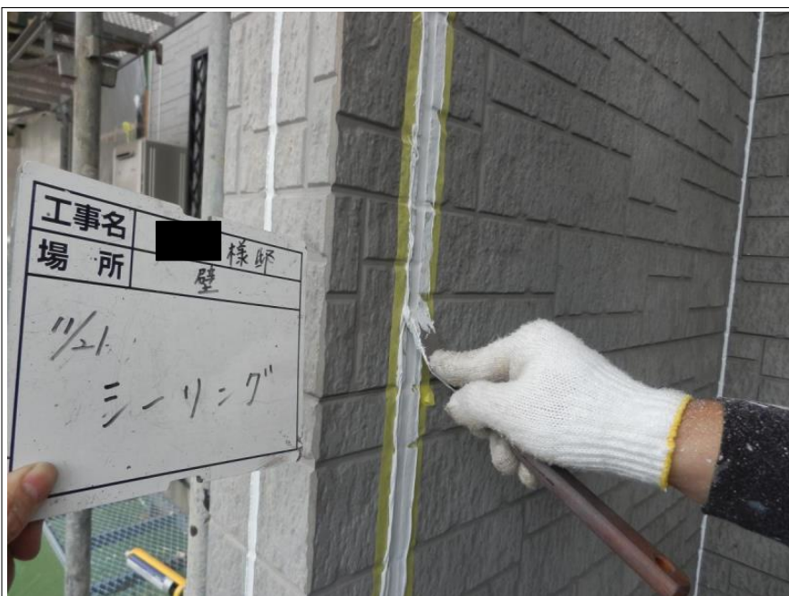
シーリング打替え 外壁
