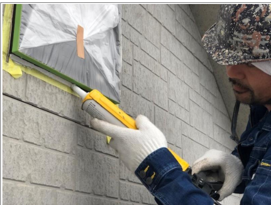
シーリング打増し サッシ廻り
