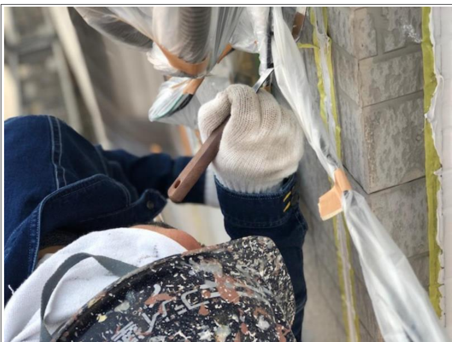
シーリング打替え 外壁
