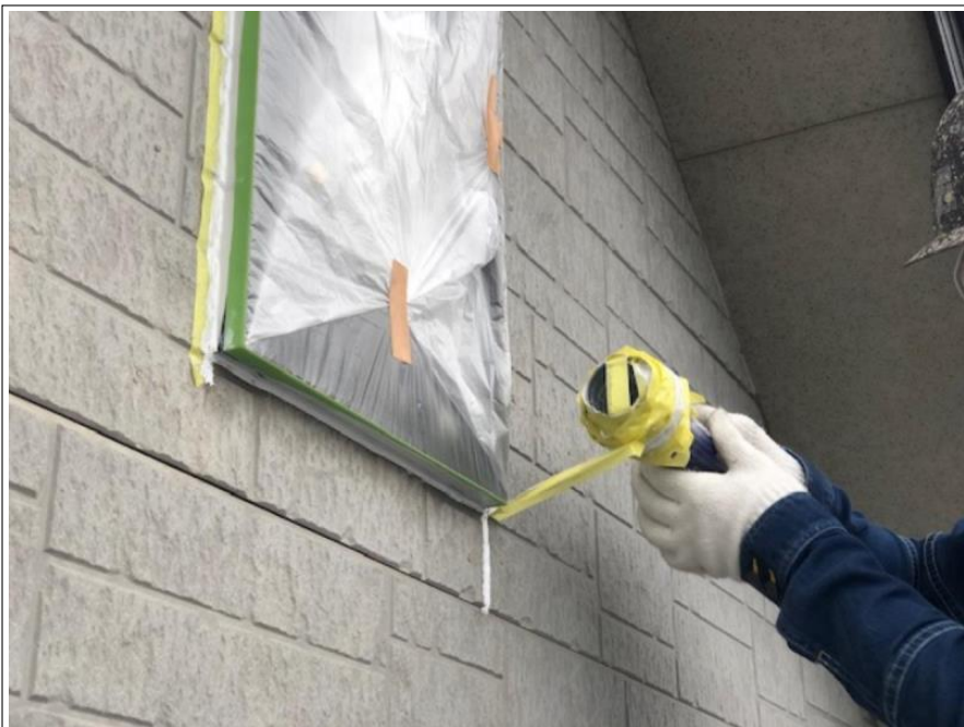
シーリング打増し サッシ廻り
