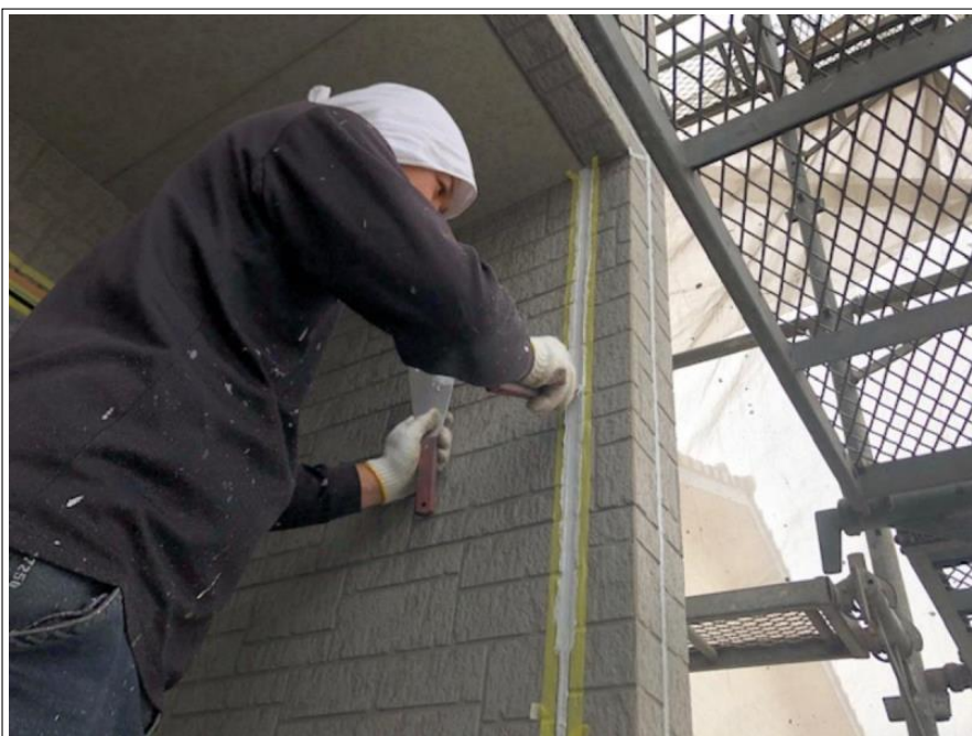
シーリング打替え 外壁
