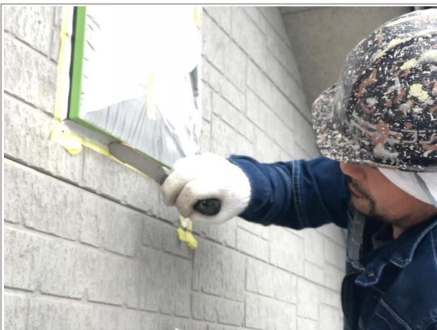
シーリング打増し サッシ廻り
