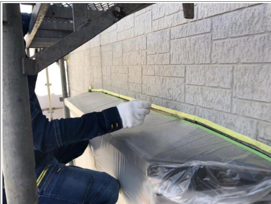
シーリング打増し サッシ廻り
