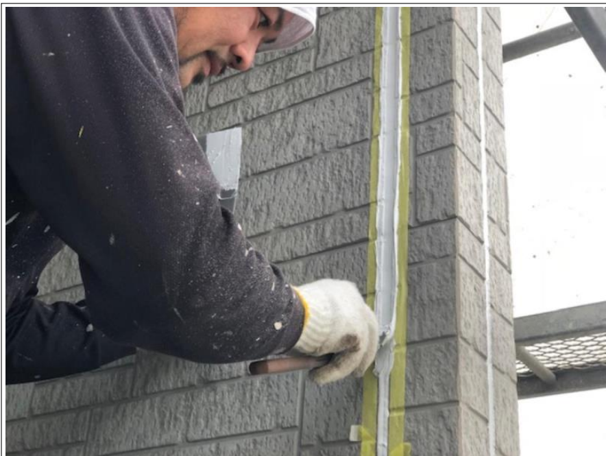
シーリング打替え 外壁
