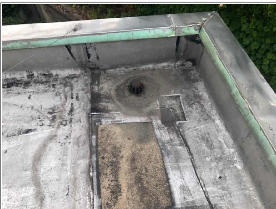
屋上防水部 ドレン部
