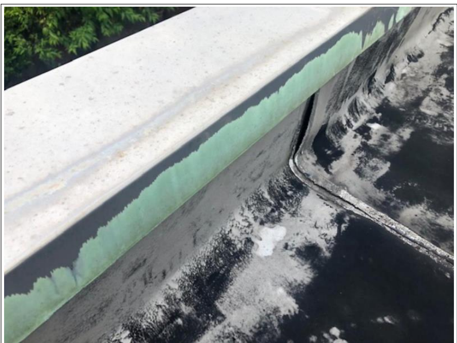
屋上防水部 立上り
