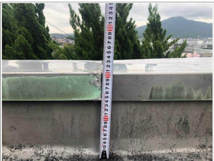
屋上防水部 立上り
