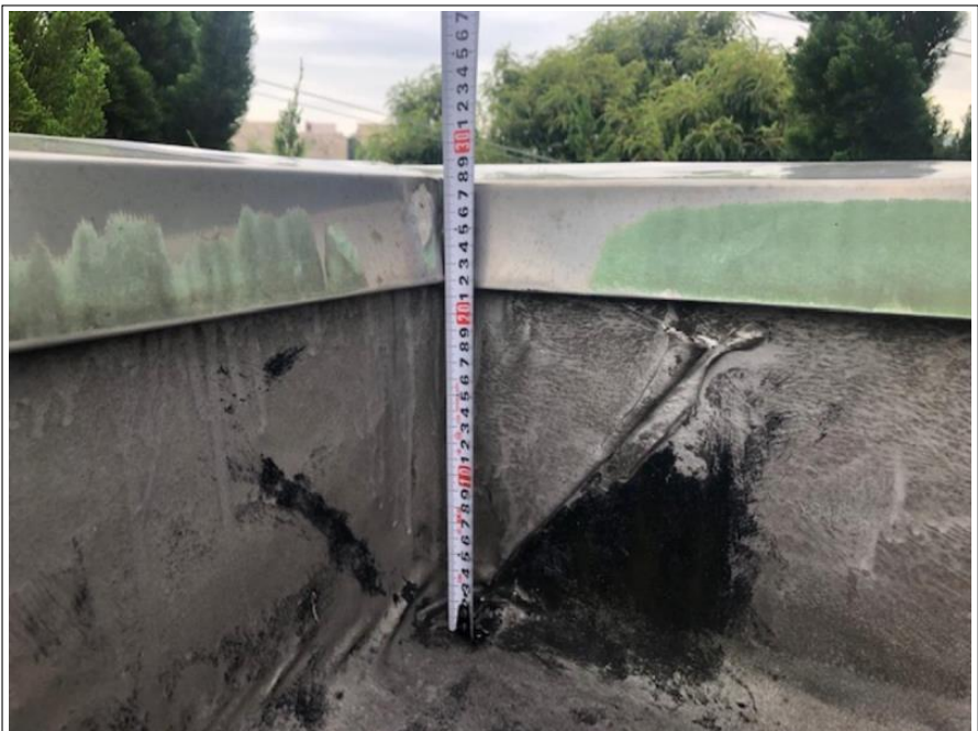
屋上防水部 立上り
