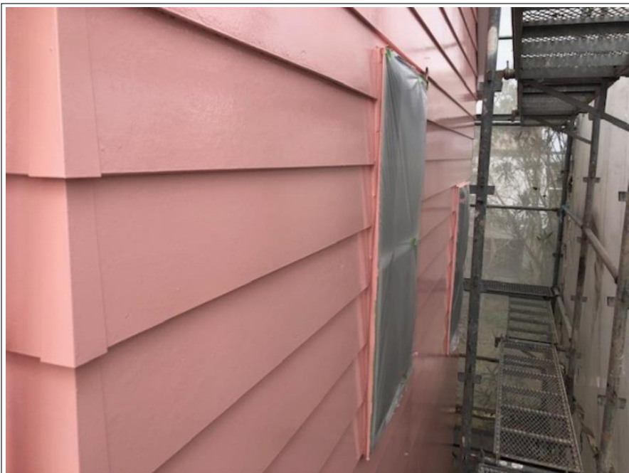
外壁 サイディング部
