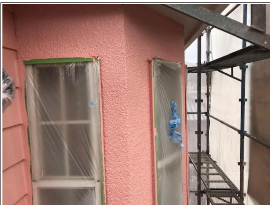
外壁 モルタル部
