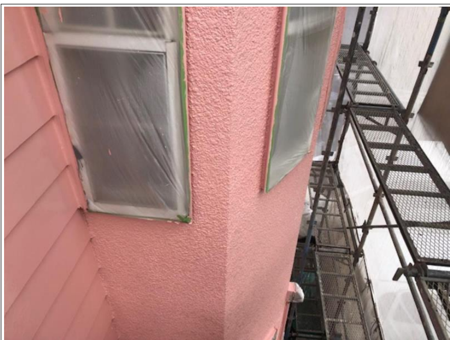
外壁 モルタル部
