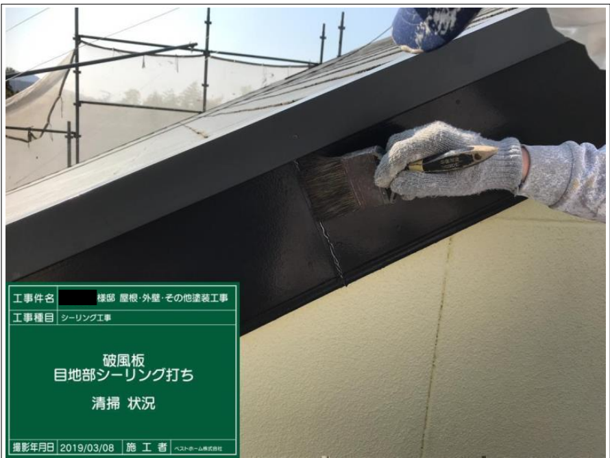
工事件名 様邸 屋根・外壁・その他塗装工事 工事種目 シーリング工事 破風板 目地部シーリング打ち 着工前 状況 撮影年月日 2019/03/08 施工者 ヘストホーム株式会社
