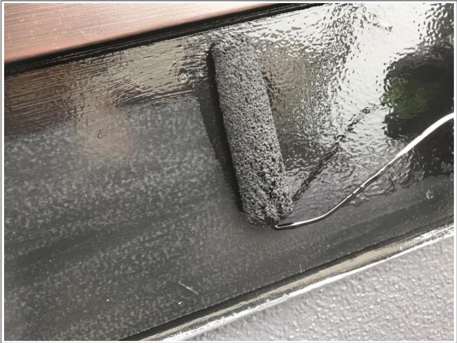
工事件名 棟梁 屋根・外壁・その他塗装工事 工事種目 塗装工事 破風板 上塗り1回目 状況 撮影年月日 2019/03/14 施工者 ヘストホーム株式会社
