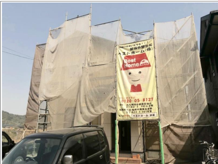
足場組立完了
