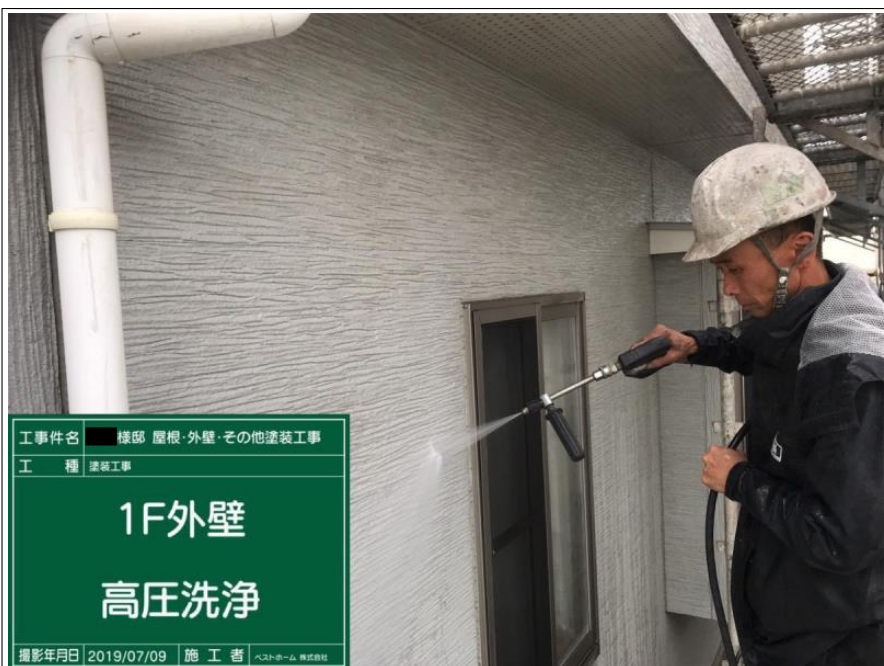
工 事 件 名 ■ 様邸 屋根・外壁・その他塗装工事 工 種 塗装工事 1F外壁 高圧洗浄 撮影年月日 2019/07/09 施 工 者 ベストホーム 株式会社
