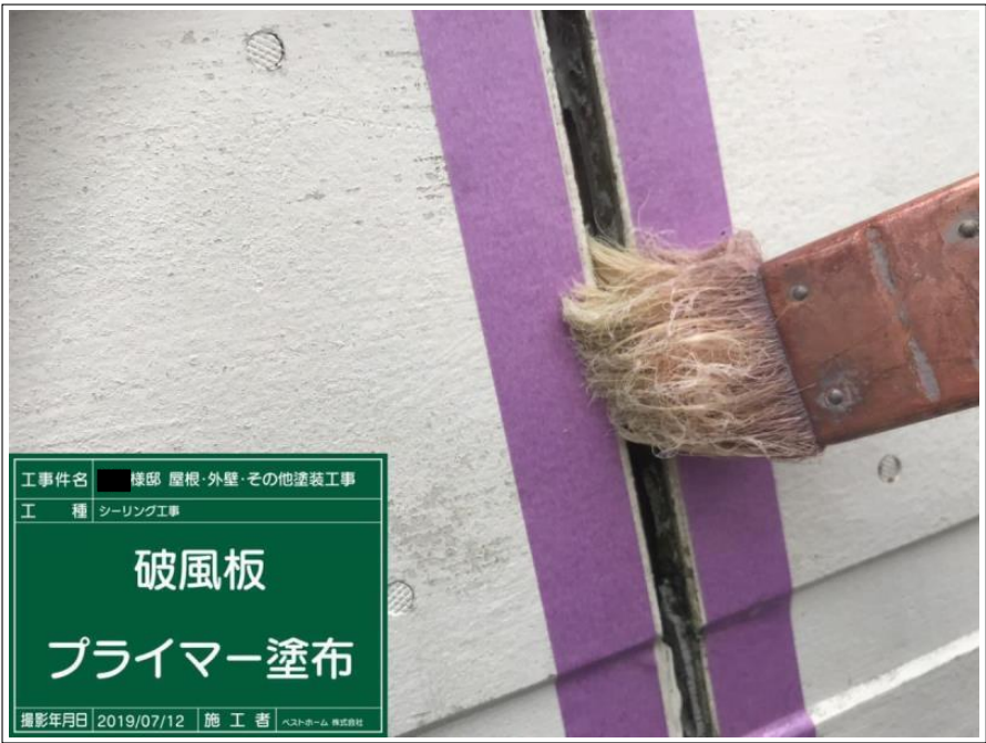
工事件名 ■ 棟部 屋根・外壁・その他塗装工事 工 種 シーリング工事 破風板 プライマー塗布 撮影年月日 2019/07/12 施 工 者 ベストホーム 株式会社
