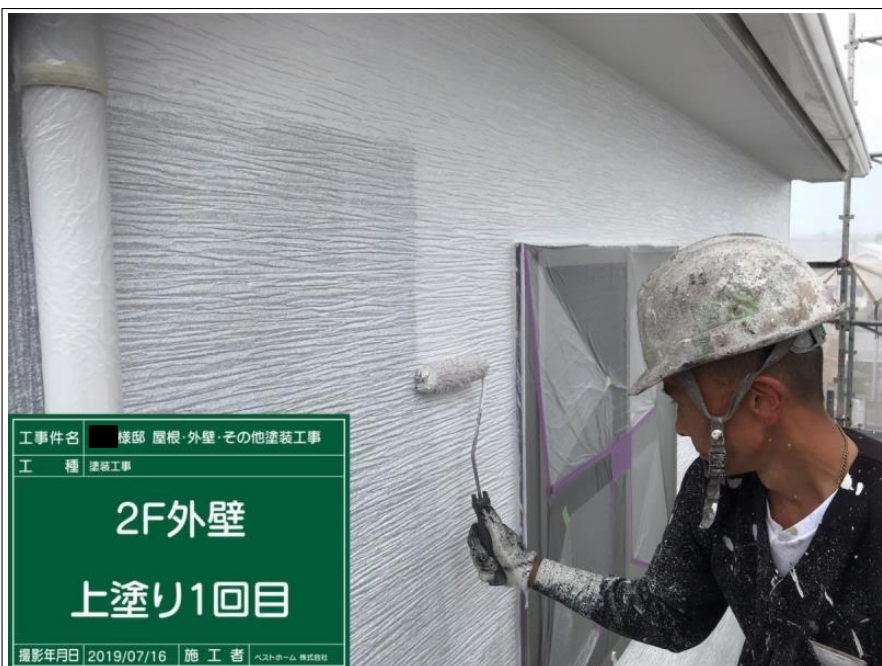
工事件名 ■ 様邸 屋根・外壁・その他塗装工事 工 種 塗装工事 2F外壁 上塗り1回目 撮影年月日 2019/07/16 施 工 者 ベストホーム 株式会社
