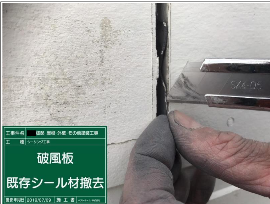
工 事 件 名 ■ 様邸 屋根・外壁・その他塗装工事 工 種 シーリング工事 破風板 既存シール材撤去 撮影年月日 2019/07/09 施 工 者 ベストホーム 株式会社
