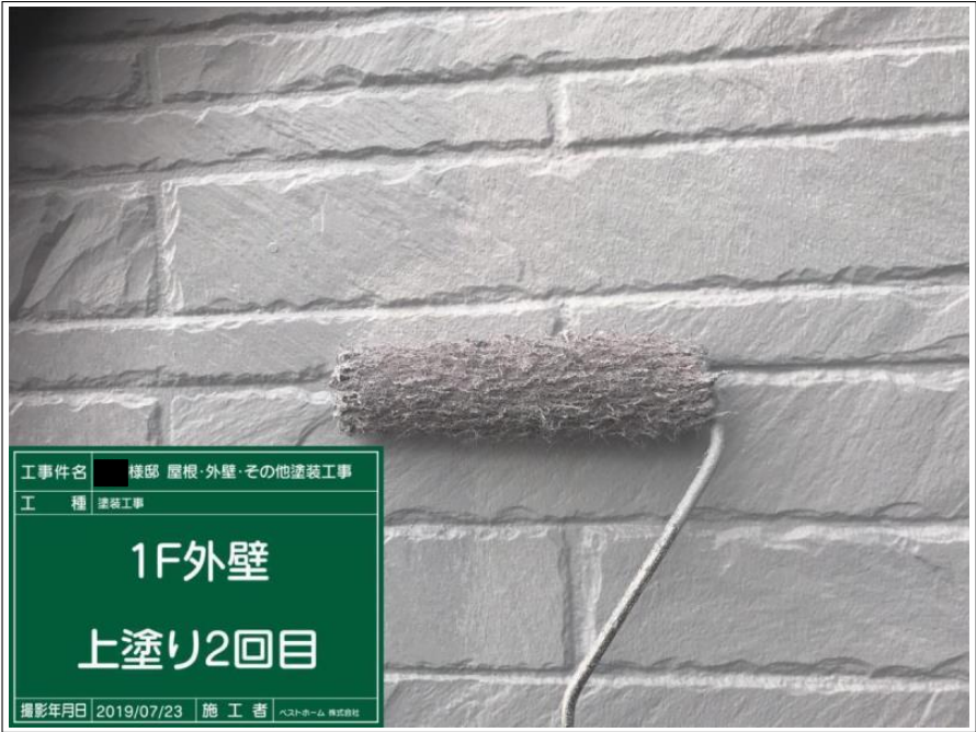
工事件名 様邸 屋根・外壁・その他塗装工事 工 種 塗装工事 1F外壁 上塗り2回目 撮影年月日 2019/07/23 施 工 者 ベストホーム 株式会社
