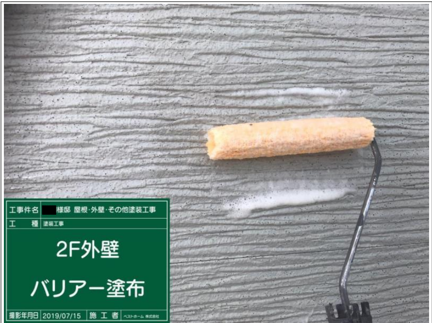
工事件名 ■ 棟部 屋根・外壁・その他塗装工事 工 種 塗装工事 2F外壁 バリアー塗布 撮影年月日 2019/07/15 施 工 者 ベストホーム 株式会社
