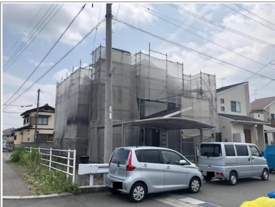
足場組立完了
