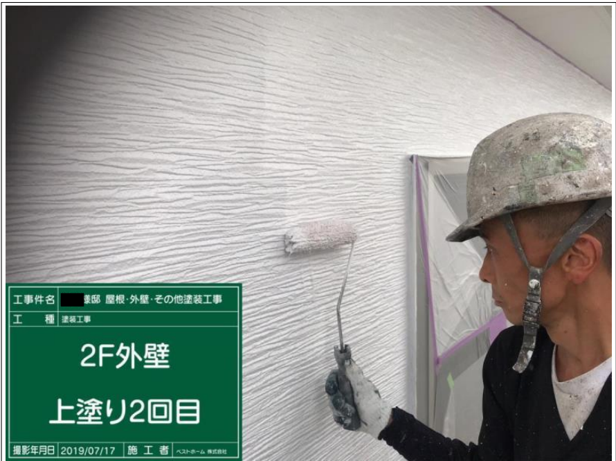
工 事 件 名 ■ 棟 梁 屋 根 ・ 外 壁 ・ 其 他 塗 装 工 事 工 種 塗 装 工 事 2F外壁 上塗り2回目 撮 影 年 月 日 2019/07/17 施 工 者 ベストホーム 株式会社
