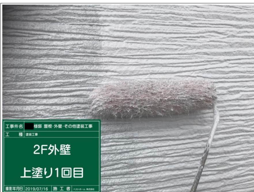
工事件名 ■ 様邸 屋根・外壁・その他塗装工事 工 種 塗装工事 2F外壁 上塗り1回目 撮影年月日 2019/07/16 施 工 者 ベストホーム 株式会社
