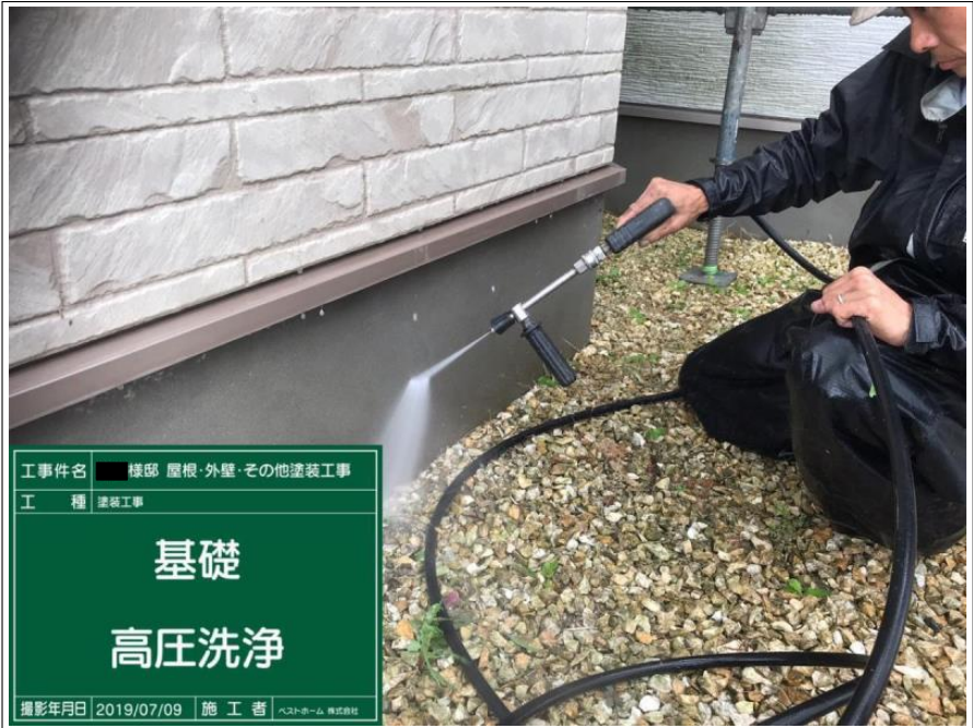
工 事 名 棟 梁 屋 根 ・ 外 壁 ・ そ の 他 塗 装 工 事 工 種 塗 装 工 事 その他部位 高圧洗浄 撮 影 年 月 日 2019/07/09 施 工 者 ペストホーム 株式会社
