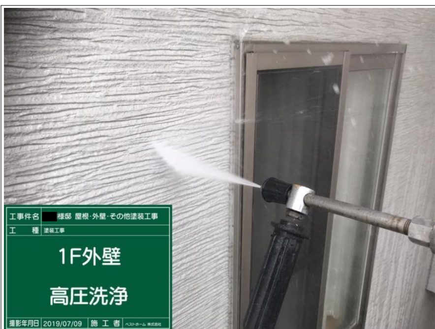
工 事 件 名 ■ 様邸 屋根・外壁・その他塗装工事 工 種 塗装工事 1F外壁 高圧洗浄 撮影年月日 2019/07/09 施 工 者 ベストホーム 株式会社
