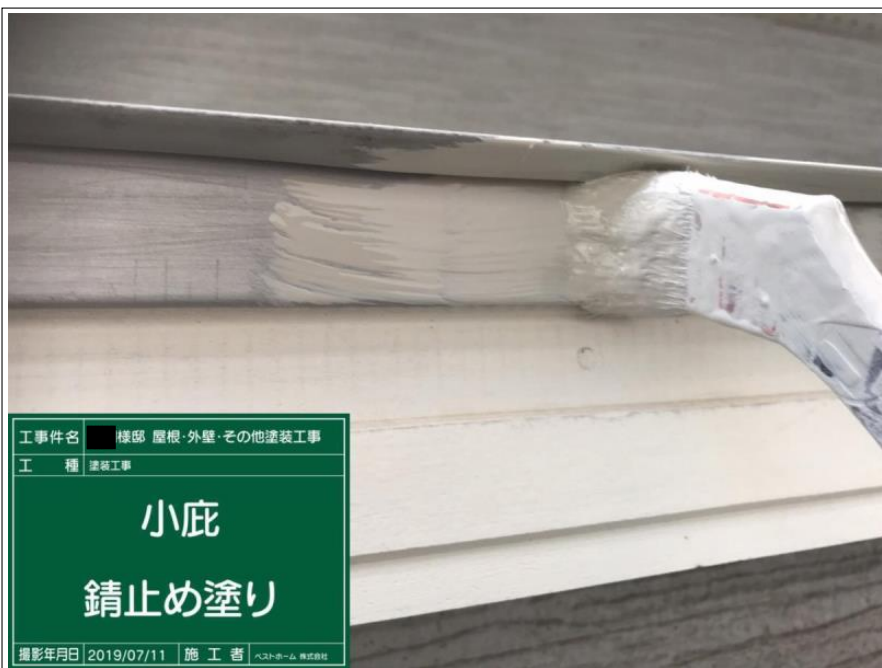
工事件名 棟部 屋根・外壁・その他塗装工事 工 種 塗装工事 小庇 錆止め塗り 撮影年月日 2019/07/11 施 工 者 ペストホーム 株式会社
