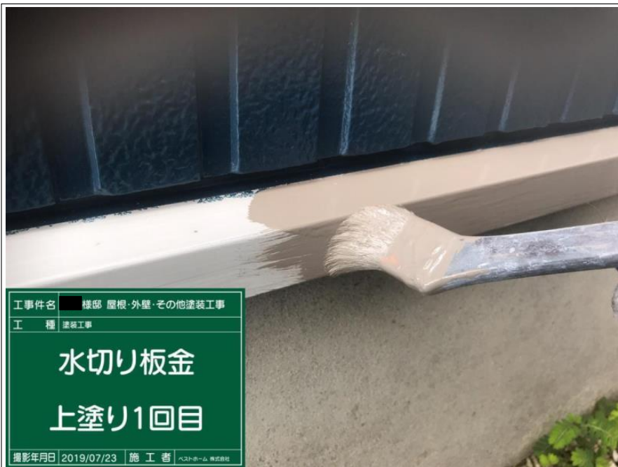
工事件名 ■ 様邸 屋根・外壁・その他塗装工事 工 種 塗装工事 水切り板金 上塗り1回目 撮影年月日 2019/07/23 施 工 者 ベストホーム 株式会社
