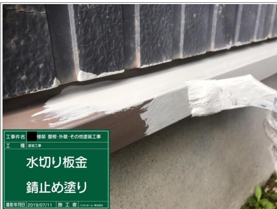
工事件名 様邸 屋根・外壁・その他塗装工事 工 種 塗装工事 水切り板金 錆止め塗り 撮影年月日 2019/07/11 施 工 者 ペストホーム 株式会社
