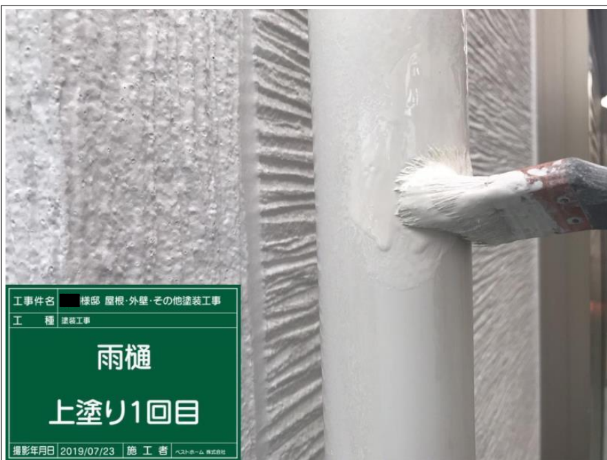
工事件名 ■ 様邸 屋根・外壁・その他塗装工事 工 種 塗装工事 雨樋 上塗り1回目 撮影年月日 2019/07/23 施 工 者 ベストホーム 株式会社
