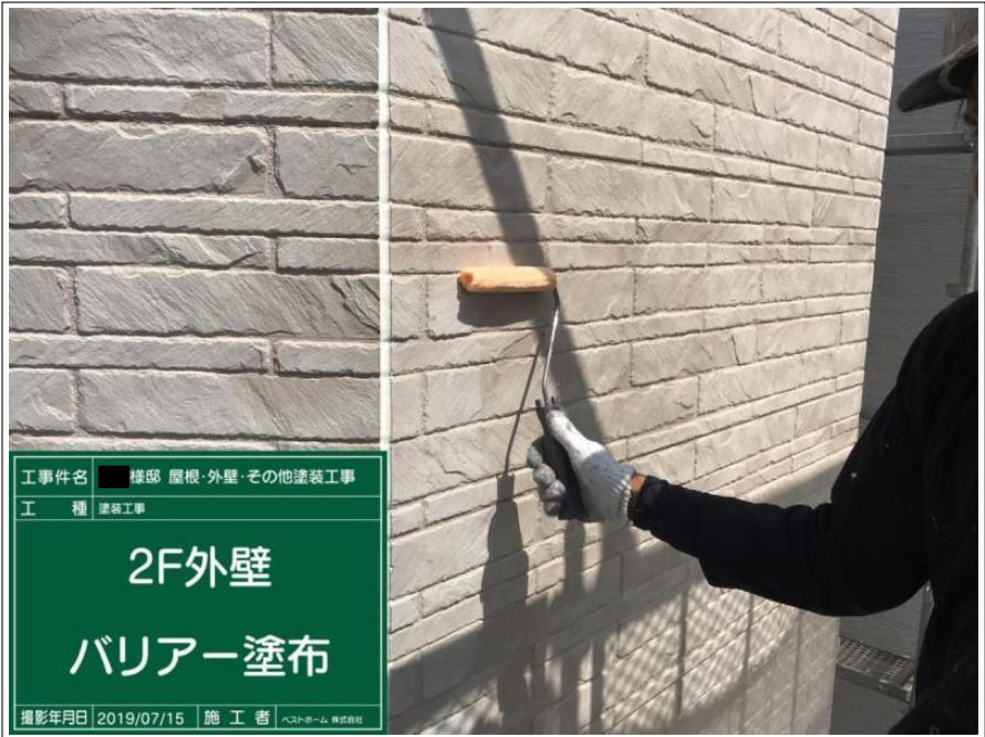
工事件名 ■ 棟部 屋根・外壁・その他塗装工事 工 種 塗装工事 2F外壁 バリアー塗布 撮影年月日 2019/07/15 施 工 者 ベストホーム 株式会社
