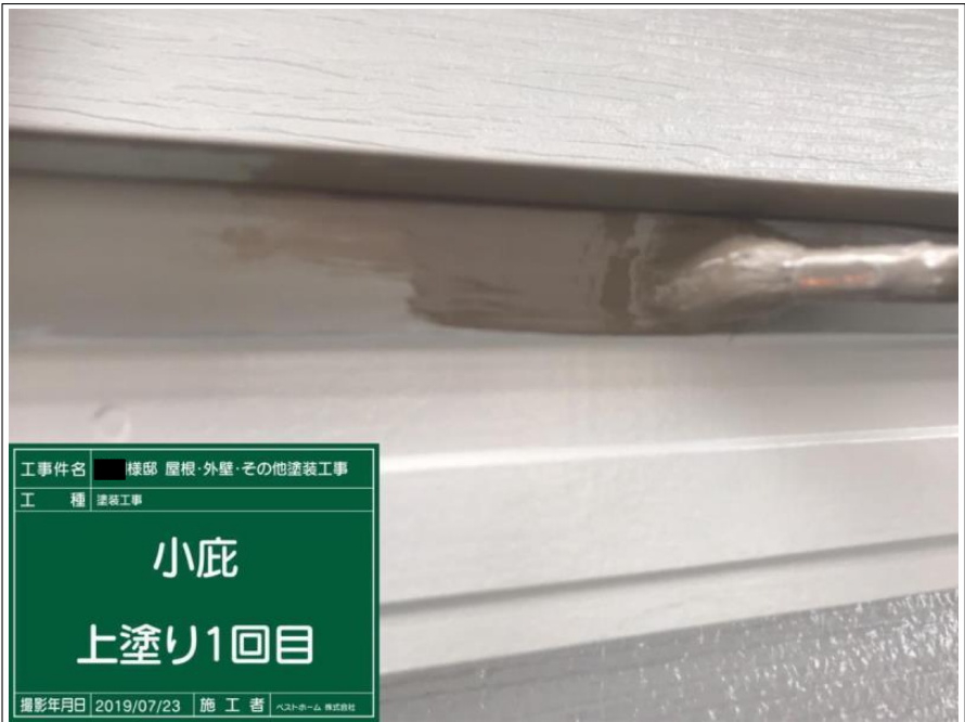
工事件名 ■ 棟梁 屋根・外壁・その他塗装工事 工 種 塗装工事 小庇 上塗り1回目 撮影年月日 2019/07/23 施 工 者 ベストホーム 株式会社
