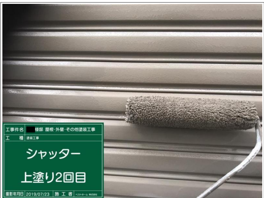
工 事 件 名 鎌田様邸 屋根・外壁・その他塗装工事 工 種 塗装工事 シャッター 上塗り2回目 撮影年月日 2019/07/23 施 工 者 ベストホーム 株式会社
