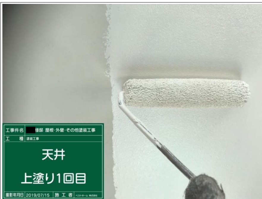
工事件名 棟邸 屋根・外壁・その他塗装工事 工 種 塗装工事 天井 上塗り1回目 撮影年月日 2019/07/15 施 工 者 ベストホーム 株式会社
