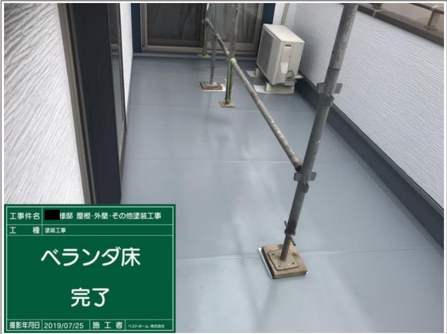
工 事 名 棟 梁 屋 根 ・ 外 壁 ・ そ の 他 塗 装 工 事 工 種 塗 装 工 事 ベランダ床 トップコート塗布 撮 影 年 月 日 2019/07/25 施 工 者 ベストホーム 株式会社
