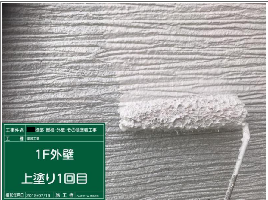
工事件名 ■ 棟邸 屋根・外壁・その他塗装工事 工 種 塗装工事 1F外壁 上塗り1回目 撮影年月日 2019/07/16 施 工 者 ベストホーム 株式会社
