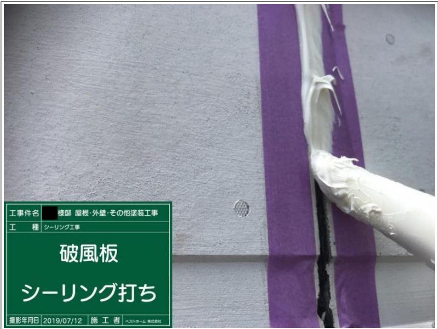
工 事 件 名 ■ 様邸 屋根・外壁・その他塗装工事 工 種 シーリング工事 破風板 シーリング打ち 撮影年月日 2019/07/12 施 工 者 ベストホーム 株式会社
