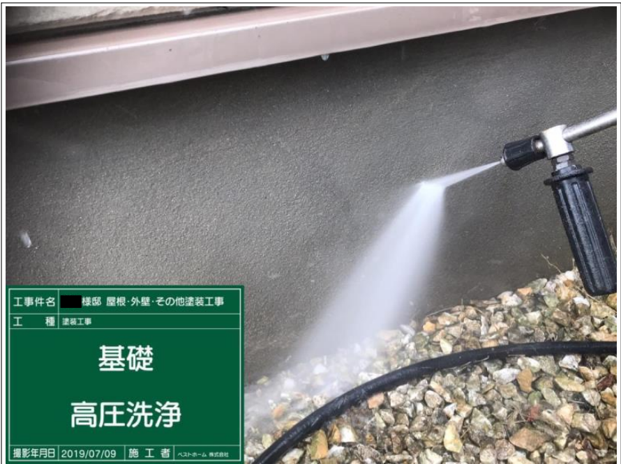
工 事 名 棟 梁 屋 根 ・ 外 壁 ・ そ の 他 塗 装 工 事 工 種 塗 装 工 事 基礎 高圧洗浄 撮 影 年 月 日 2019/07/09 施 工 者 ペストホーム 株式会社
