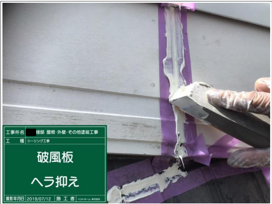
工 事 件 名 ■ 様邸 屋根・外壁・その他塗装工事 工 種 シーリング工事 破風板 シーリング打ち 撮影年月日 2019/07/12 施 工 者 ベストホーム 株式会社
