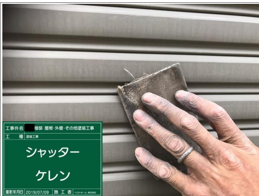
工事件名 ■ 様邸 屋根・外壁・その他塗装工事 工 種 塗装工事 シャッター ケレン 撮影年月日 2019/07/09 施 工 者 ベストホーム 株式会社
