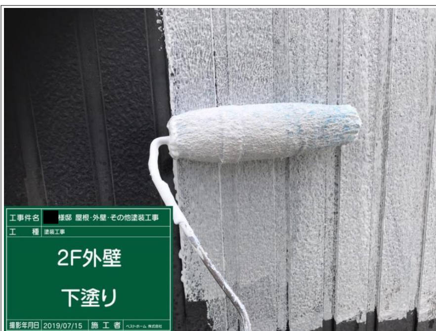
工事件名 ■ 棟部 屋根・外壁・その他塗装工事 工 種 塗装工事 2F外壁 下塗り 撮影年月日 2019/07/15 施 工 者 ベストホーム 株式会社
