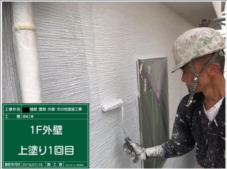
工事件名 ■ 棟邸 屋根・外壁・その他塗装工事 工 種 塗装工事 1F外壁 上塗り1回目 撮影年月日 2019/07/16 施 工 者 ベストホーム 株式会社
