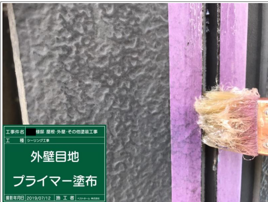
工事件名 様邸 屋根・外壁・その他塗装工事 工 種 シーリング工事 外壁目地 プライマー塗布 撮影年月日 2019/07/12 施 工 者 ベストホーム 株式会社
