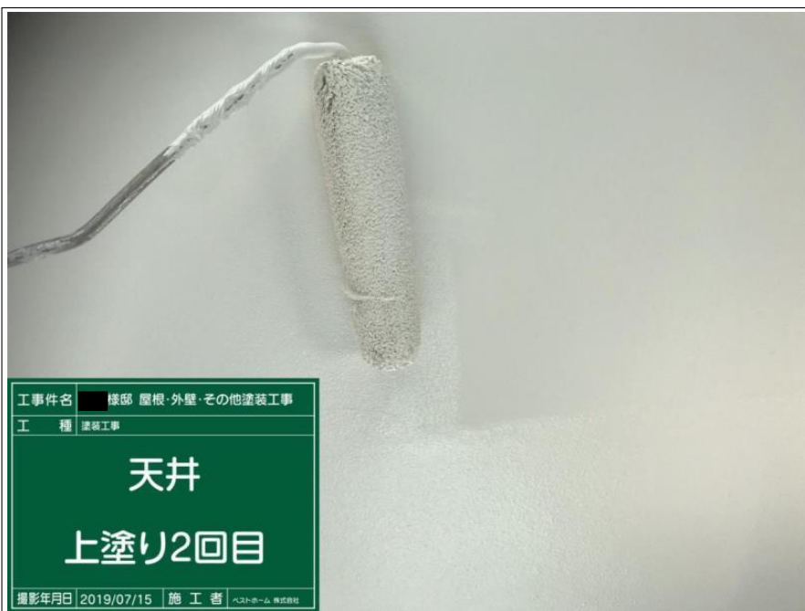
工事件名 様邸 屋根・外壁・その他塗装工事 工 種 塗装工事 天井 上塗り2回目 撮影年月日 2019/07/15 施 工 者 ベストホーム 株式会社
