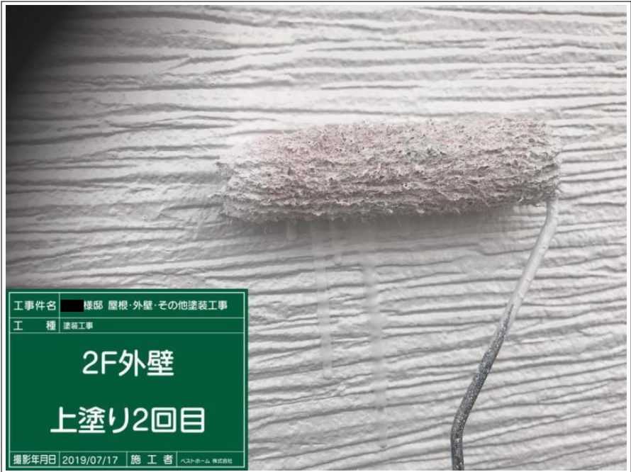
工 事 件 名 ■ 棟 梁 屋 根 ・ 外 壁 ・ 其 他 塗 装 工 事 工 種 塗 装 工 事 2F外壁 上塗り2回目 撮 影 年 月 日 2019/07/17 施 工 者 ベストホーム 株式会社
