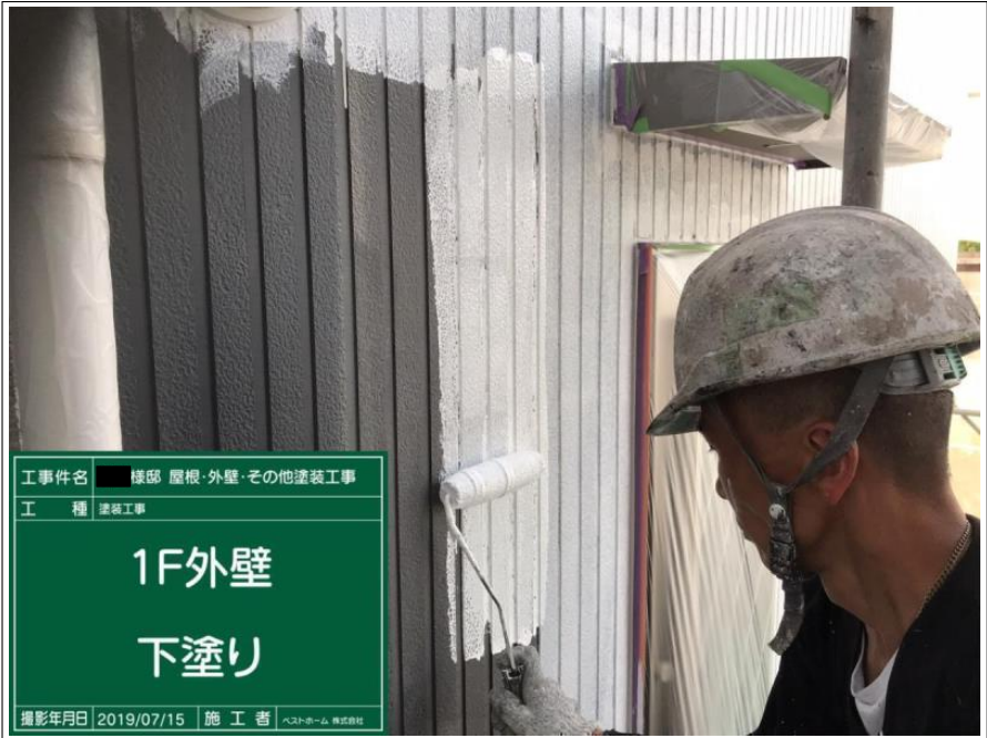
工 事 件 名 ■ 様邸 屋根・外壁・その他塗装工事 工 種 塗装工事 2F外壁 下塗り 撮影年月日 2019/07/15 施 工 者 ベストホーム 株式会社
