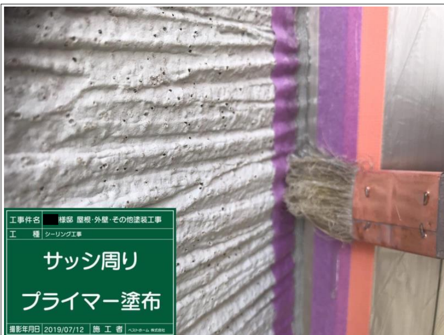
工 事 名 棟 卸 屋 根 ・ 外 壁 ・ 其 他 塗 装 工 事 工 種 シ ー リ ン グ 工 事 サッシ周り プライマー塗布 撮 影 年 月 日 2019/07/12 施 工 者 ベ ス ト ホ ー ム 有 限 公 司
