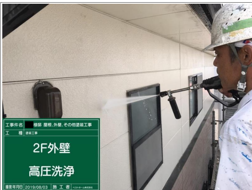
工事件名 ■ 様邸 屋根、外壁、その他塗装工事 工 種 塗装工事 天井 高圧洗浄 撮影年月日 2019/08/03 施 工 者 ペストホーム株式会社
