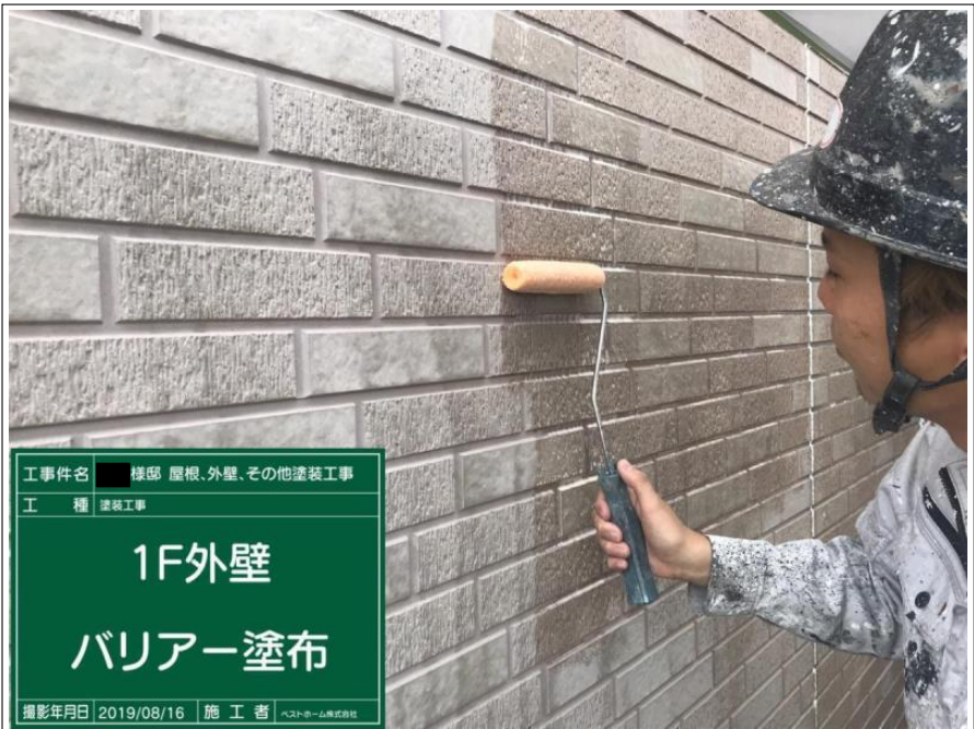
工事件名 様邸 屋根、外壁、その他塗装工事 工 種 塗装工事 2F外壁 バリアー塗布 撮影年月日 2019/08/16 施 工 者 ペストホーム株式会社
