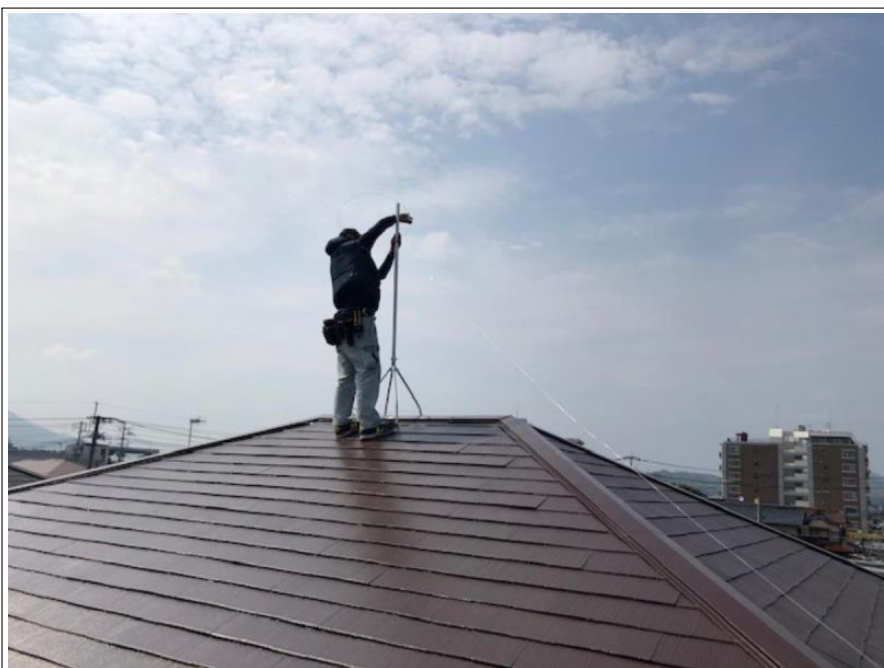
アンテナ 取り付け
