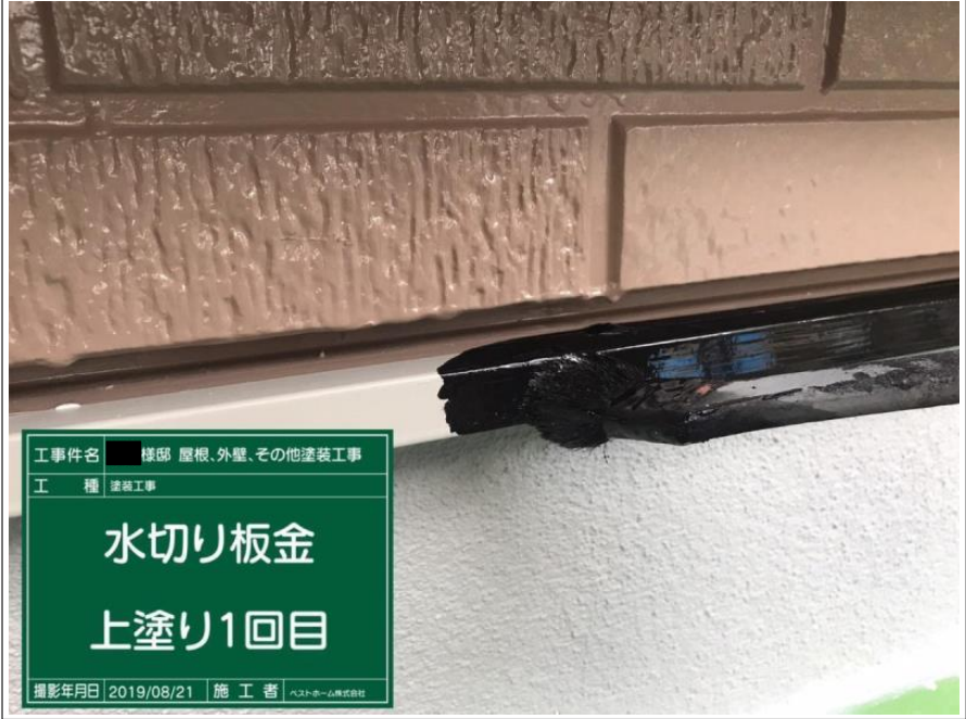
工 事 件 名 ■ 様邸 屋根、外壁、その他塗装工事 工 種 塗装工事 水切り板金 上塗り1回目 撮影年月日 2019/08/21 施 工 者 ベストホーム株式会社
