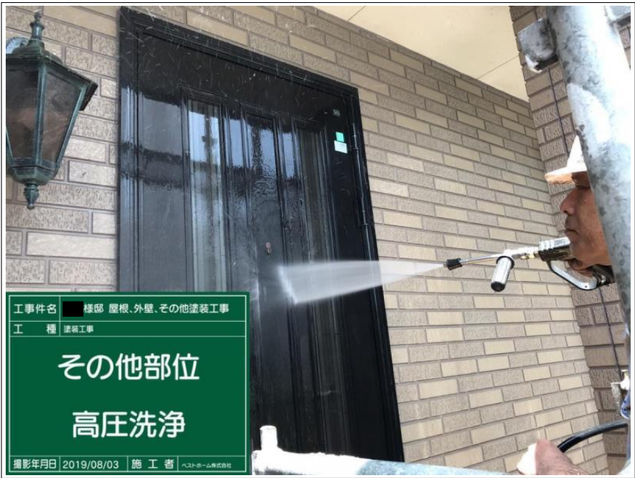
工事件名 ■ 様邸 屋根、外壁、その他塗装工事 工 種 塗装工事 基礎 高圧洗浄 撮影年月日 施工者 ヘストホーム株式会社
