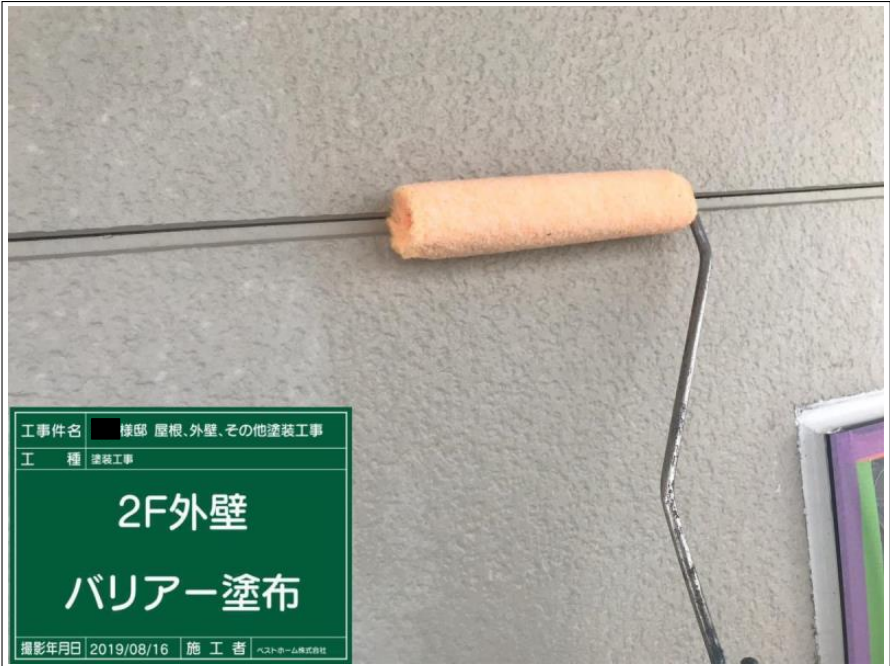
工事件名 様邸 屋根、外壁、その他塗装工事 工 種 塗装工事 2F外壁 バリアー塗布 撮影年月日 2019/08/16 施 工 者 ペストホーム株式会社
