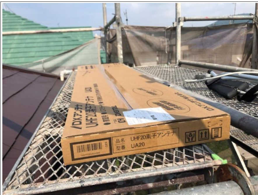
アンテナ 取り付け
