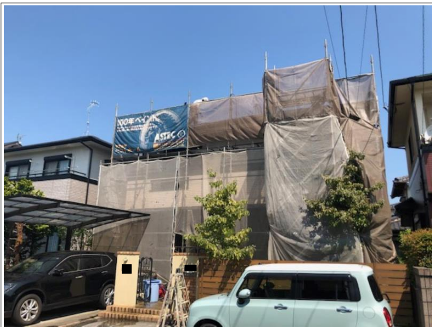
足場組立完了
