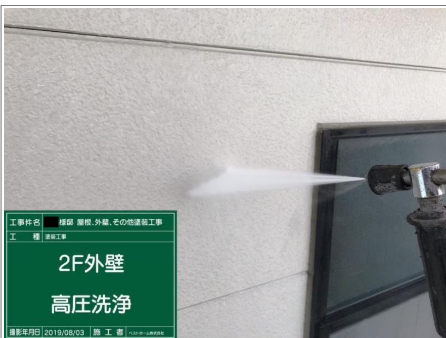
工事件名 ■ 様邸 屋根、外壁、その他塗装工事 工 種 塗装工事 2F外壁 高圧洗浄 撮影年月日 2019/08/03 施 工 者 ペストホーム株式会社
