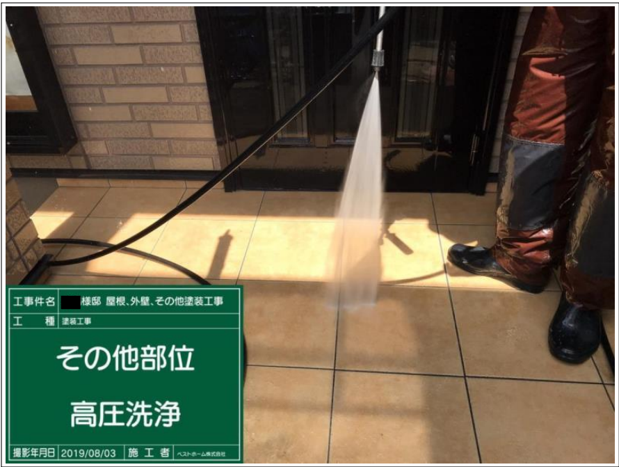
工事件名 ■ 様邸 屋根、外壁、その他塗装工事 工 種 塗装工事 その他部位 高圧洗浄 撮影年月日 2019/08/03 施工者 ヘストホーム株式会社
