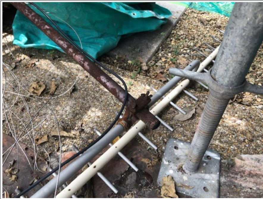
アンテナ 取り外し
