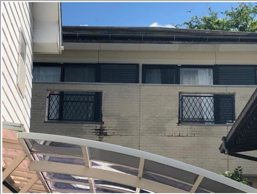
外壁 張替え部
