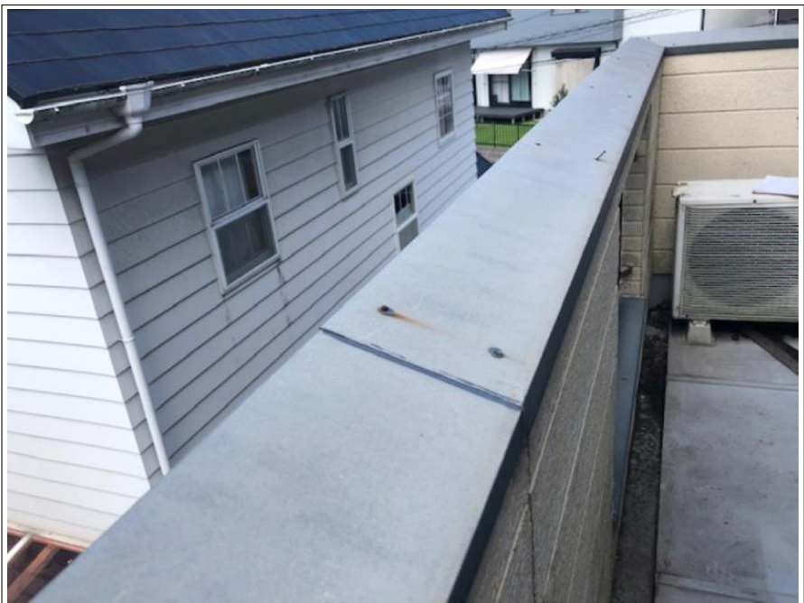
外壁 張替え部
