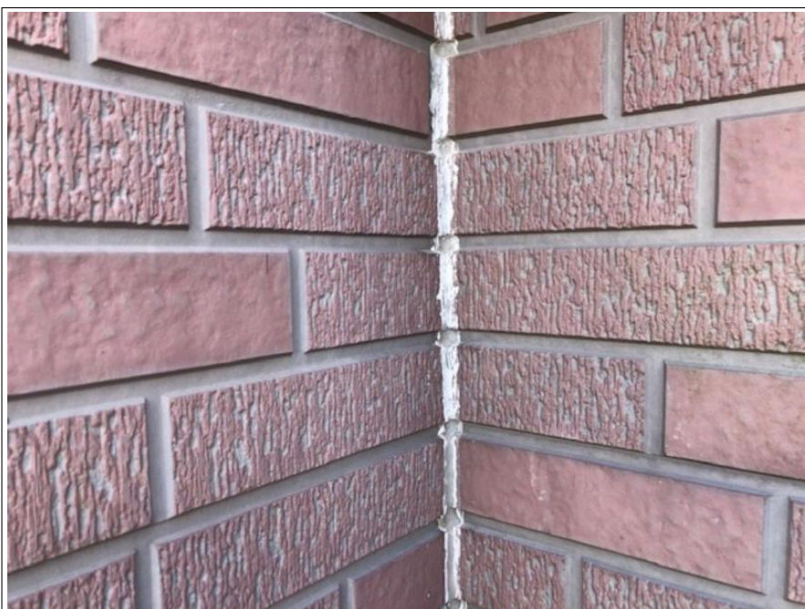
外壁 入隅シーリング部
