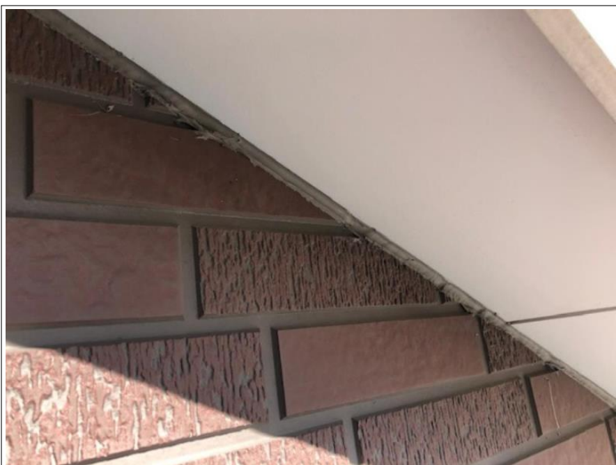
外壁 入隅シーリング部
