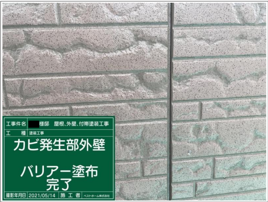
工事件名 ■ 様邸 屋根、外壁、付帯塗装工事 工 種 塗装工事 カビ発生部外壁 バリアー塗布 完了 撮影年月日 2021/05/14 施 工 者 ヘストホーム株式会社
