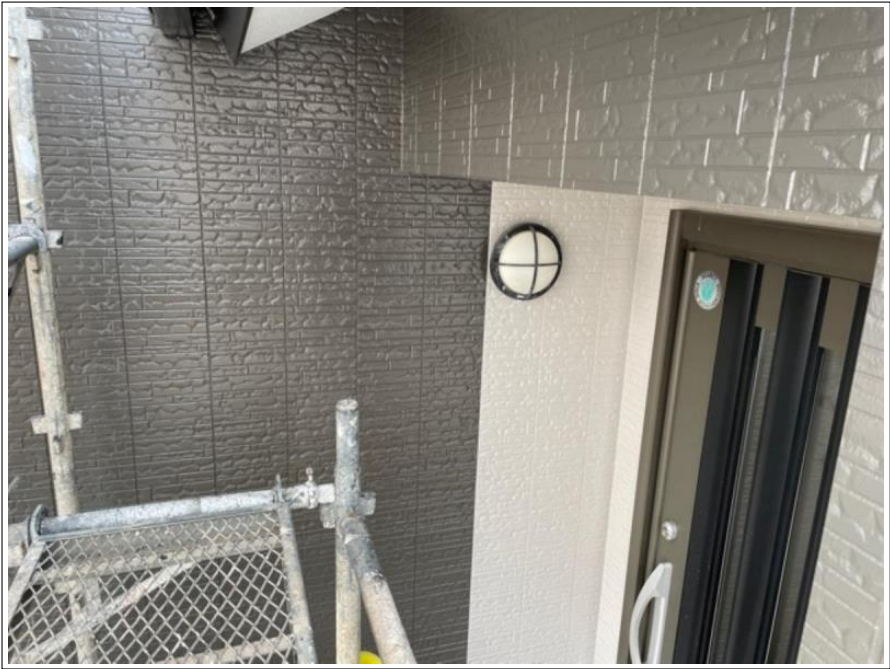
外壁メイン部 1階（北面）
