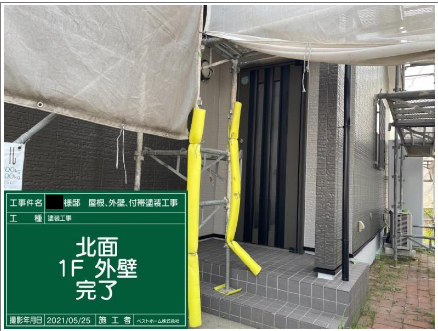
外壁メイン部 1階（北面）
