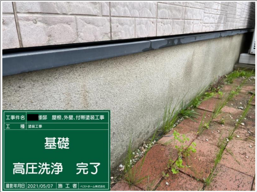
工事件名 ■■■ 様邸 屋根、外壁、付帯塗装工事 工 種 塗装工事 基礎 高圧洗浄 撮影年月日 2021/05/07 施 工 者 ヘストホーム株式会社
