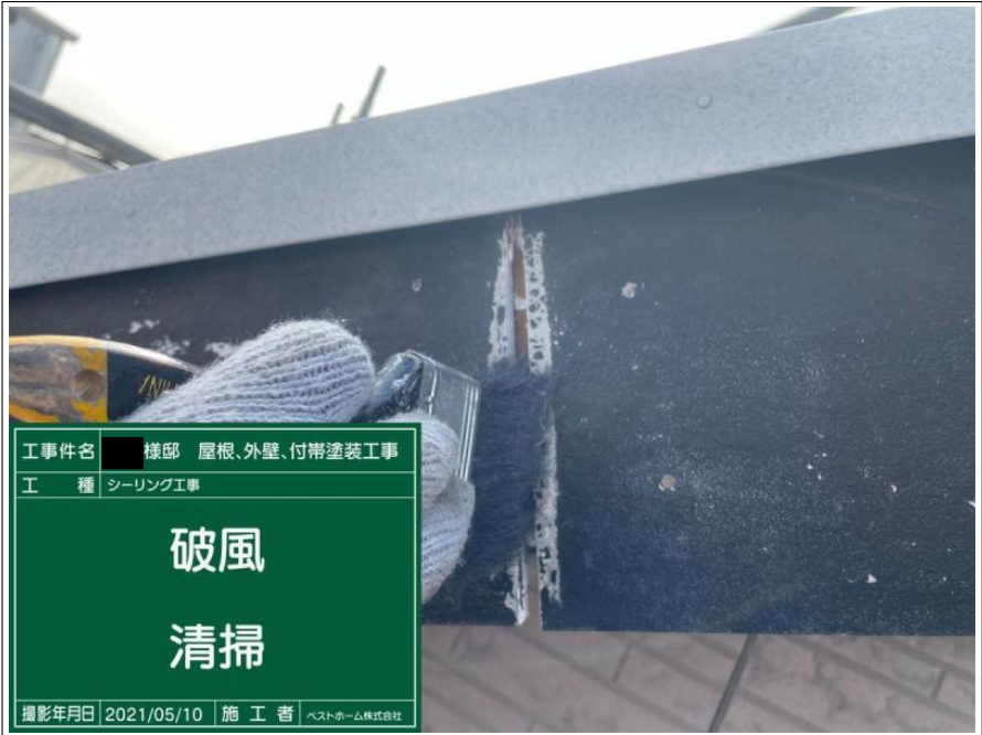
工事件名 様邸 屋根、外壁、付帯塗装工事 工種 シーリング工事 破風 旧シーリング撤去 完了 撮影年月日 2021/05/10 施工者 ベストホーム株式会社
