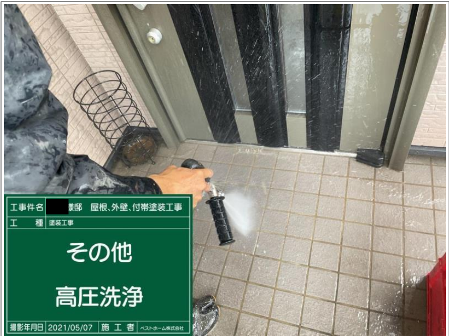
工事件名 ■■■ 兼邸 屋根、外壁、付帯塗装工事 工 種 塗装工事 その他 高圧洗浄 撮影年月日 2021/05/07 施 工 者 ヘストホーム株式会社
