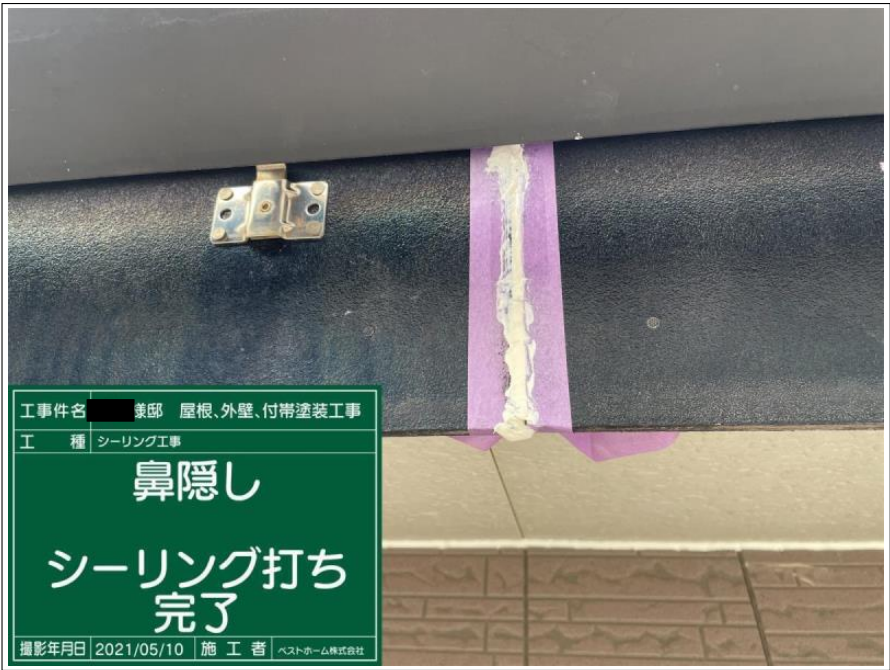
工 事 名 ■ 様邸 屋根、外壁、付帯塗装工事 工 種 シーリング工事 鼻隠し シーリング打ち 撮影年月日 2021/05/10 施 工 者 ベストホーム株式会社
