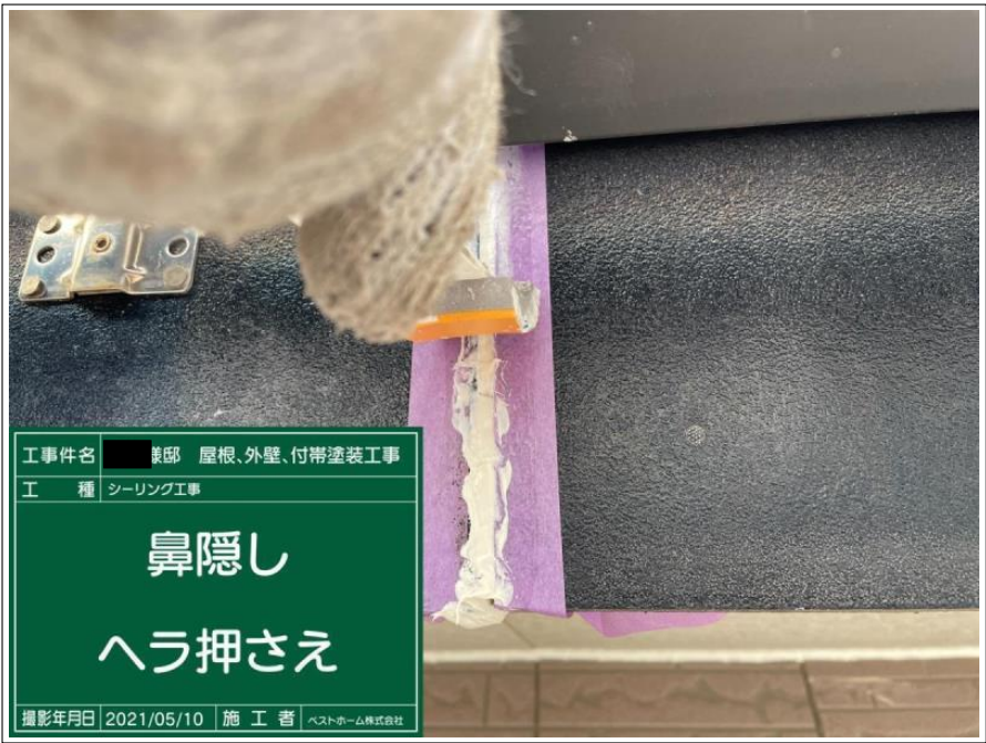
工 事 名 ■ 様邸 屋根、外壁、付帯塗装工事 工 種 シーリング工事 鼻隠し シーリング打ち 完了 撮影年月日 2021/05/10 施 工 者 ベストホーム株式会社
