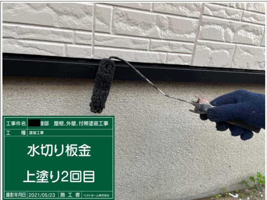
工事件名 ■ 様邸 屋根、外壁、付帯塗装工事 工 種 塗装工事 水切り板金 上塗り2回目 撮影年月日 2021/05/23 施 工 者 ヘストホーム株式会社
