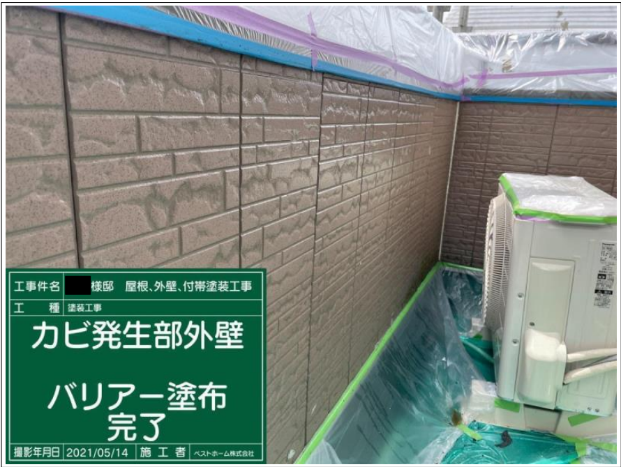
工事件名 ■ 様邸 屋根、外壁、付帯塗装工事 工 種 塗装工事 カビ発生部外壁 バリアー塗布 撮影年月日 2021/05/14 施 工 者 ヘストホーム株式会社
