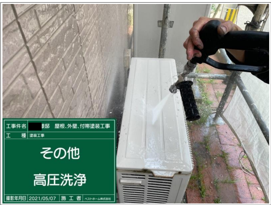
工事件名 ■■■ 兼邸 屋根、外壁、付帯塗装工事 工 種 塗装工事 その他 高圧洗浄 撮影年月日 2021/05/07 施 工 者 ヘストホーム株式会社
