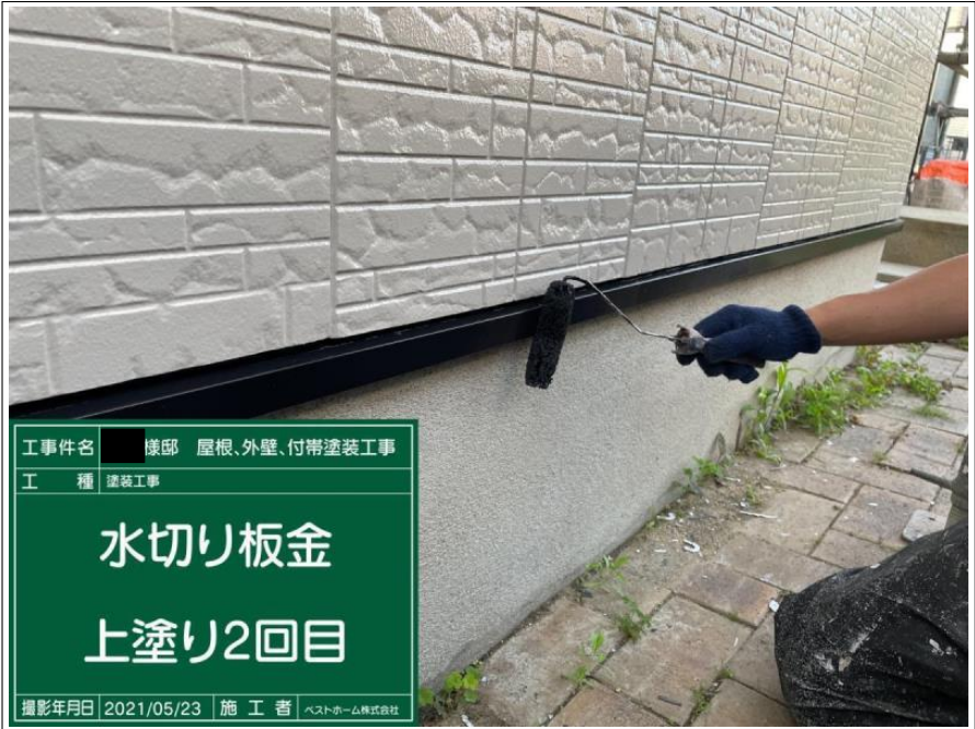
工事件名 ■ 様邸 屋根、外壁、付帯塗装工事 工 種 塗装工事 水切り板金 上塗り1回目 完了 撮影年月日 2021/05/23 施 工 者 ヘストホーム株式会社
