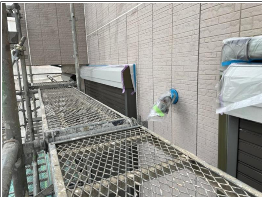
工事件名 ■■■ 邸 屋根、外壁、付帯塗装工事 工 種 塗装工事 シャッターボック ス 下塗り(錆止め) 完了 撮影年月日 2021/05/11 施 工 者 ヘストホーム株式会社
