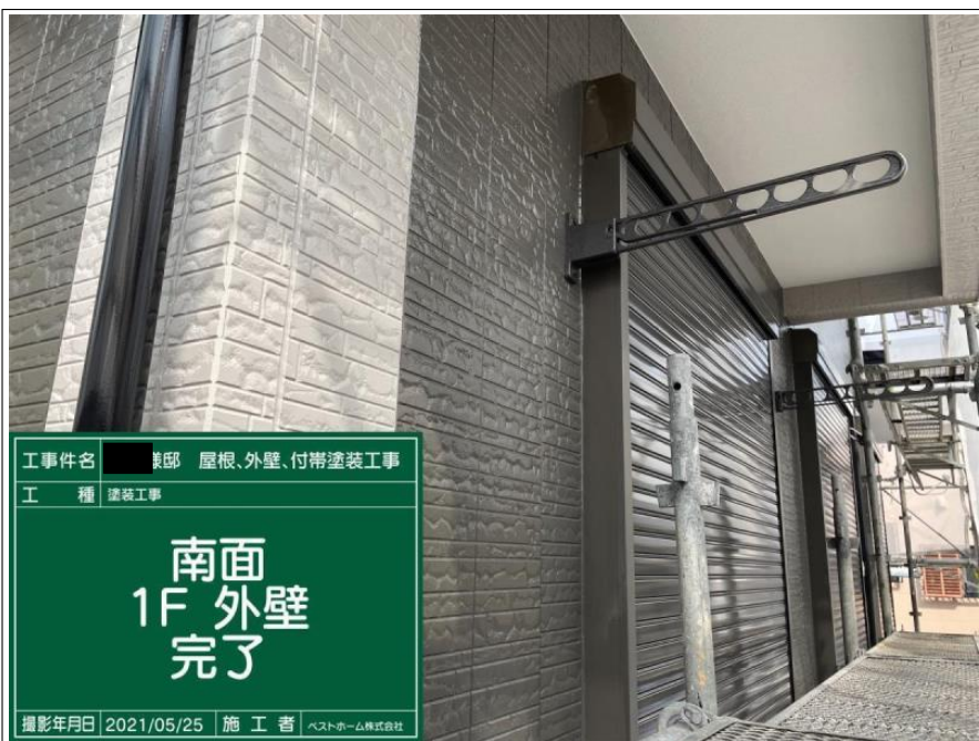
外壁メイン部 1階（南面）
