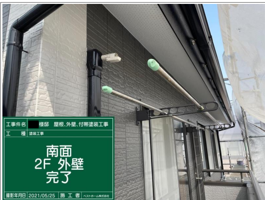
外壁メイン部 2階（南面）
