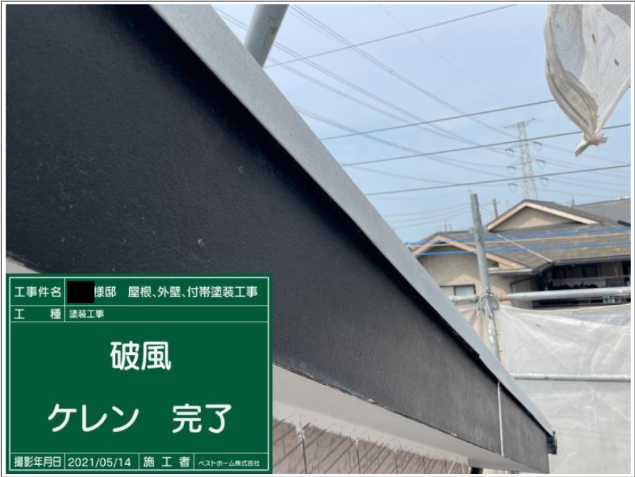
工事件名 様邸 屋根、外壁、付帯塗装工事 工種 塗装工事 破風 ケレン 撮影年月日 2021/05/14 施工者 ベストホーム株式会社
