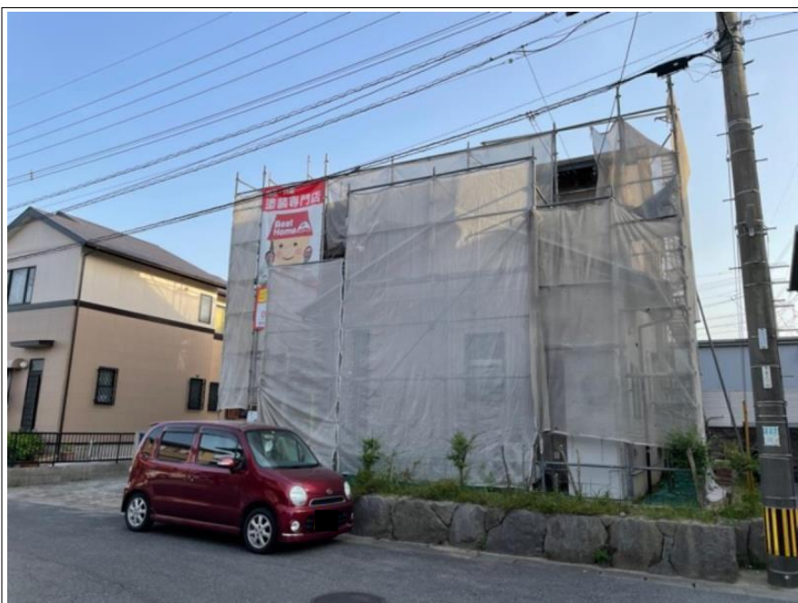
足場組立 完了
