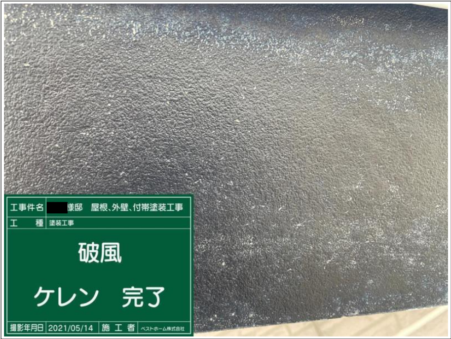
工事件名 様邸 屋根、外壁、付帯塗装工事 工種 塗装工事 破風 ケレン 完了 撮影年月日 2021/05/14 施工者 ベストホーム株式会社
