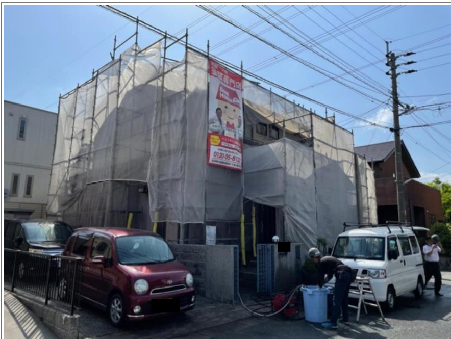
足場組立 完了
