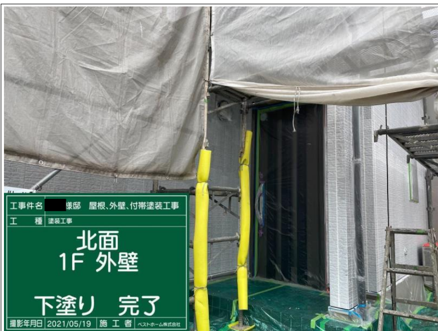
外壁メイン部 1階（北面）
