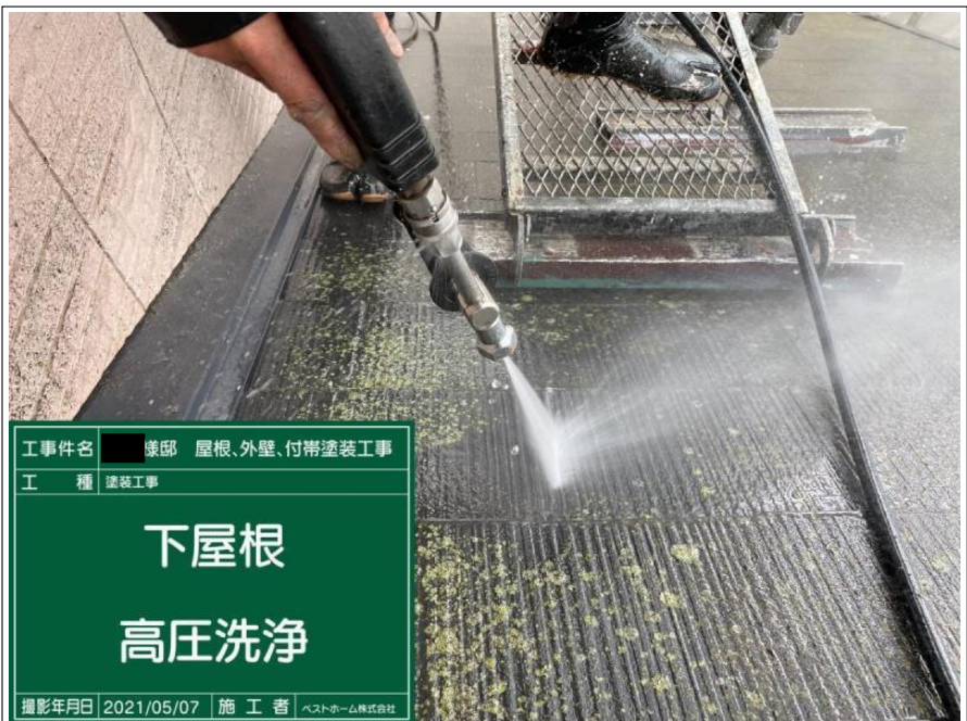
工 事 件 名 様邸 屋根、外壁、付帯塗装工事 工 種 塗装工事 下屋根 高圧洗浄 撮影年月日 2021/05/07 施 工 者 ヘストホーム株式会社
