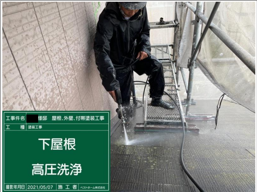
工 事 件 名 様邸 屋根、外壁、付帯塗装工事 工 種 塗装工事 北面 屋根 高圧洗浄 撮影年月日 2021/05/07 施 工 者 ヘストホーム株式会社
