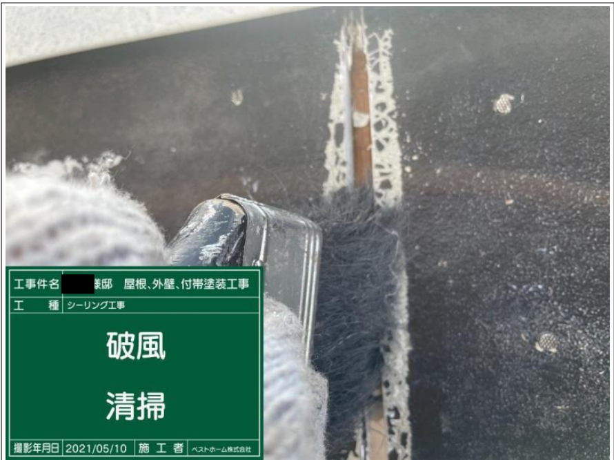
工事件名 様邸 屋根、外壁、付帯塗装工事 工種 シーリング工事 破風 清掃 撮影年月日 2021/05/10 施工者 ベストホーム株式会社
