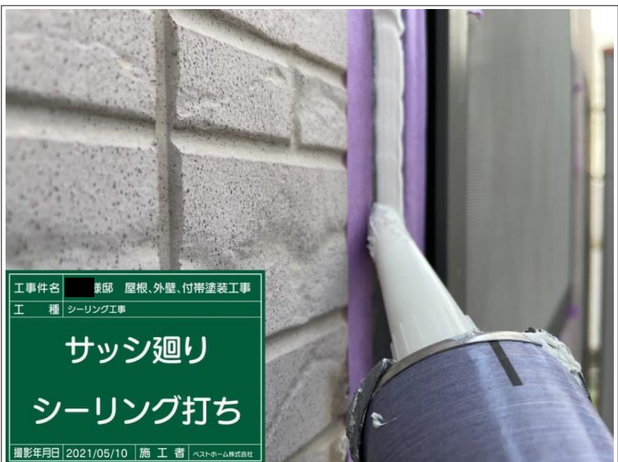
工 事 名 兼邸 屋根、外壁、付帯塗装工事 工 種 シーリング工事 サッシ廻り シーリング打ち 撮影年月日 2021/05/10 施 工 者 ベストホーム株式会社
