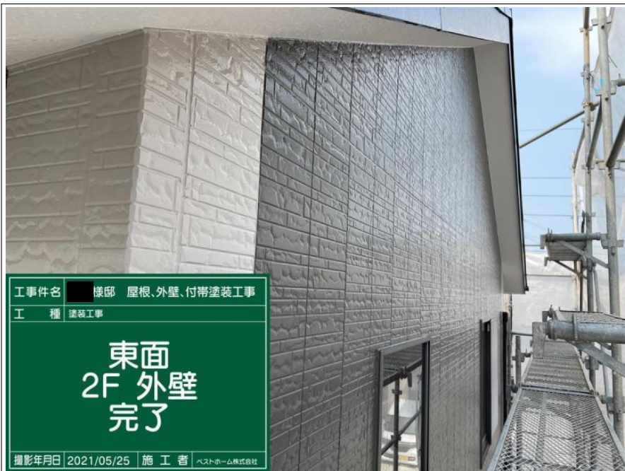
外壁メイン部 2階（東面）
