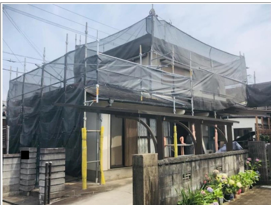
足場組立 完了
