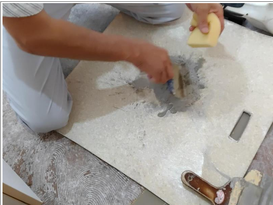
洗面所 CF 貼り替え工事
