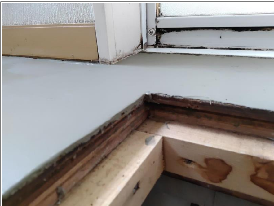
洗面所 CF貼り替え工事
