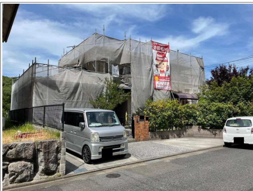
足場組立 完了
