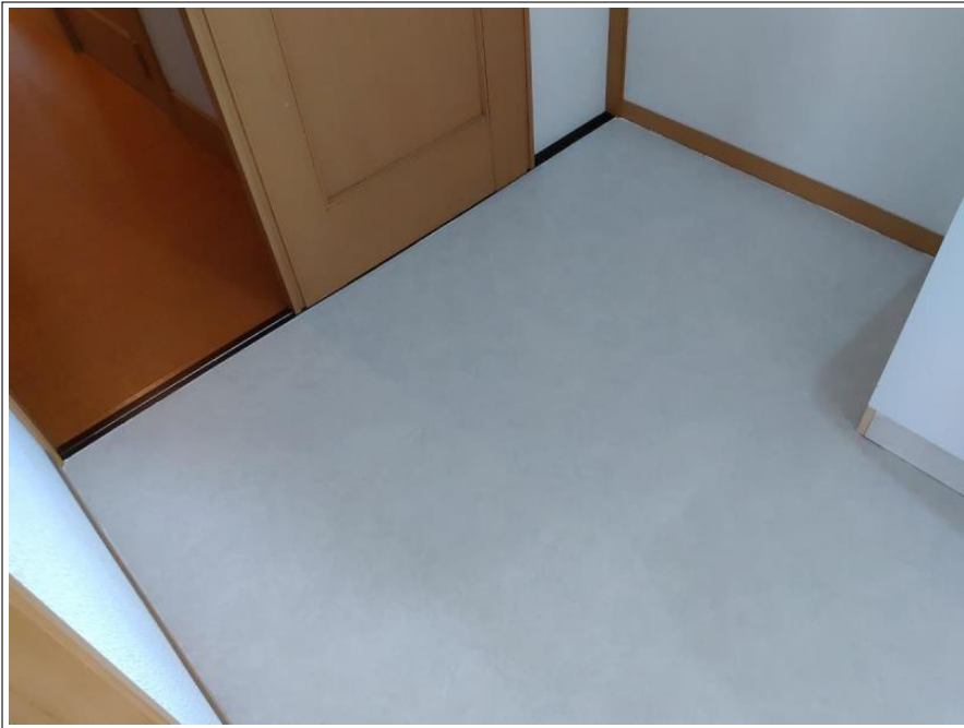
洗面所 CF貼り替え工事
