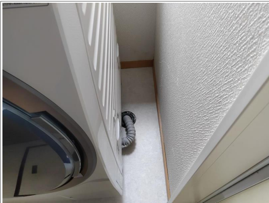
洗面所 CF貼り替え工事
