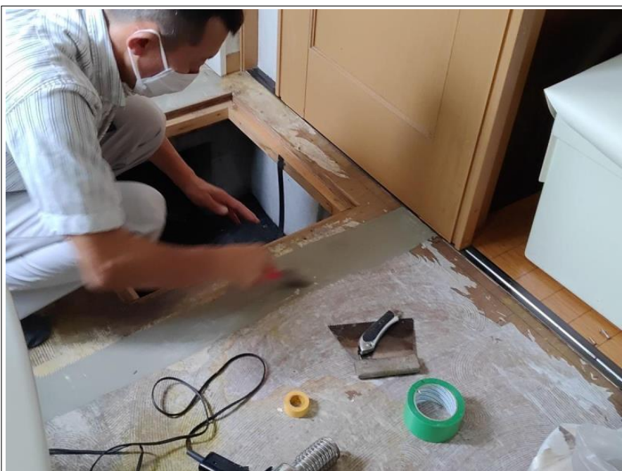
洗面所 CF 貼り替え工事
