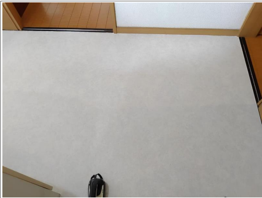
洗面所 CF貼り替え工事
