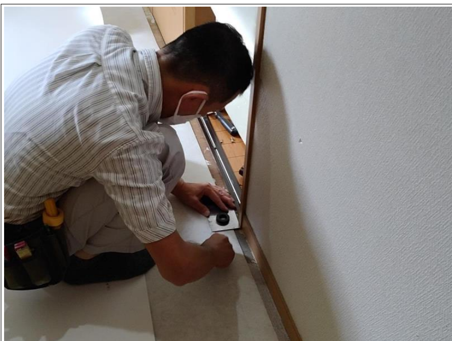
洗面所 CF貼り替え工事
