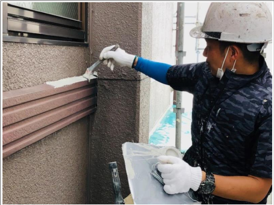
工事件名 様邸住宅塗装工事 工種 塗装工事 胴差し 下塗り(錆止め) 撮影年月日 2021/07/07 施工者 ベストホーム(株)
