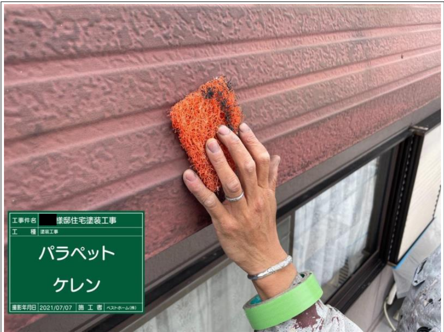
工事件名 様邸住宅塗装工事 工種 塗装工事 パラペット ケレン 撮影年月日 2021/07/07 施工者 ベストホーム(株)
