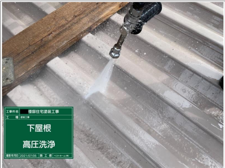
工事件名 様邸住宅塗装工事 工種 塗装工事 下屋根 高圧洗浄 撮影年月日 2021/07/05 | 施工者 | ハストホーム(株)
