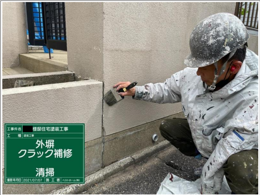
工事件名 様邸住宅塗装工事 工 種 塗装工事 外塀 クラック補修 ケレン完了 撮影年月日 2021/07/07 | 施 工 者 | ヘストホーム(株)
