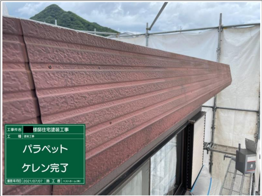
工事件名 様邸住宅塗装工事 工種 塗装工事 パラペット ケレン 撮影年月日 2021/07/07 施工者 ベストホーム(株)
