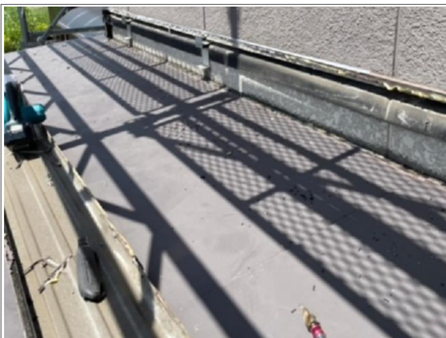
増築部 雨漏れ改修工事
