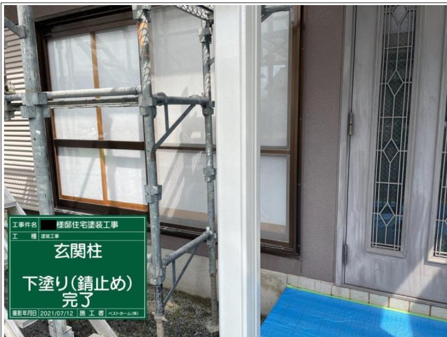
工事件名 様邸住宅塗装工事 工種 塗装工事 玄関柱 下塗り(錆止め) 撮影年月日 2021/07/12 | 施工者 ハストホーム(株)
