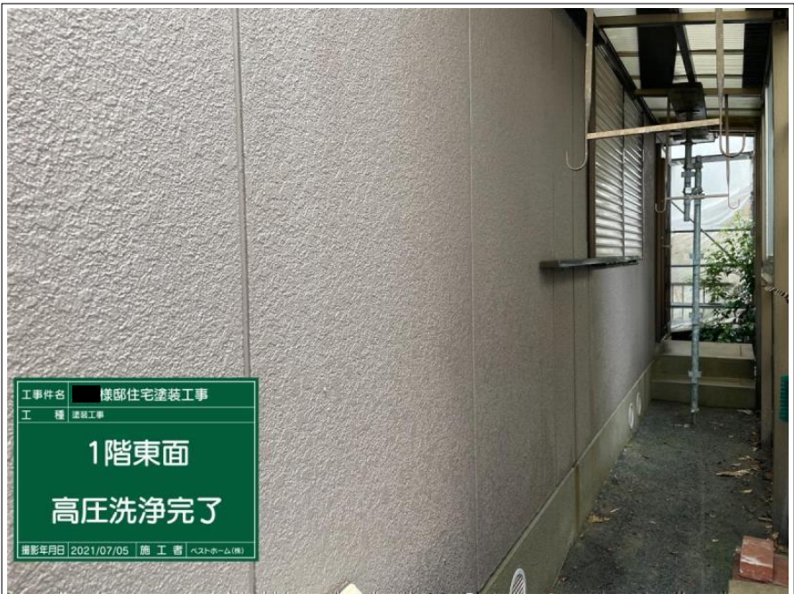
工事件名 棟部住宅塗装工事 工種 塗装工事 1階北面 高圧洗浄完了 撮影年月日 2021/07/05 | 施工者 | ヘストホーム(株)
