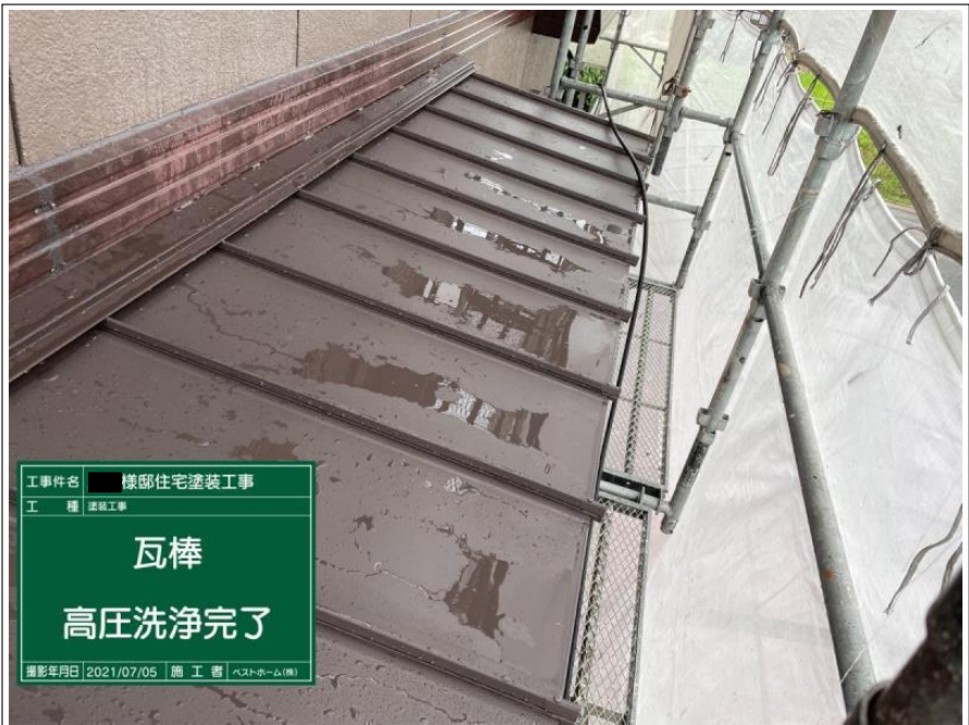
工事件名 棟部住宅塗装工事 工 種 塗装工事 瓦棒 高圧洗浄 撮影年月日 2021/07/05 | 施 工 者 | ヘストホーム(株)
