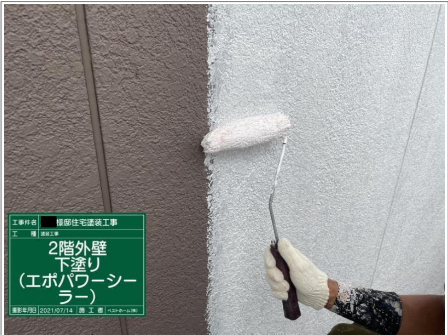
工事件名 棟部住宅塗装工事 工種 塗装工事 2階外壁 下塗り (エポパワーシーラー) 撮影年月日 2021/07/14 | 施工者 ヘストホーム(株)
