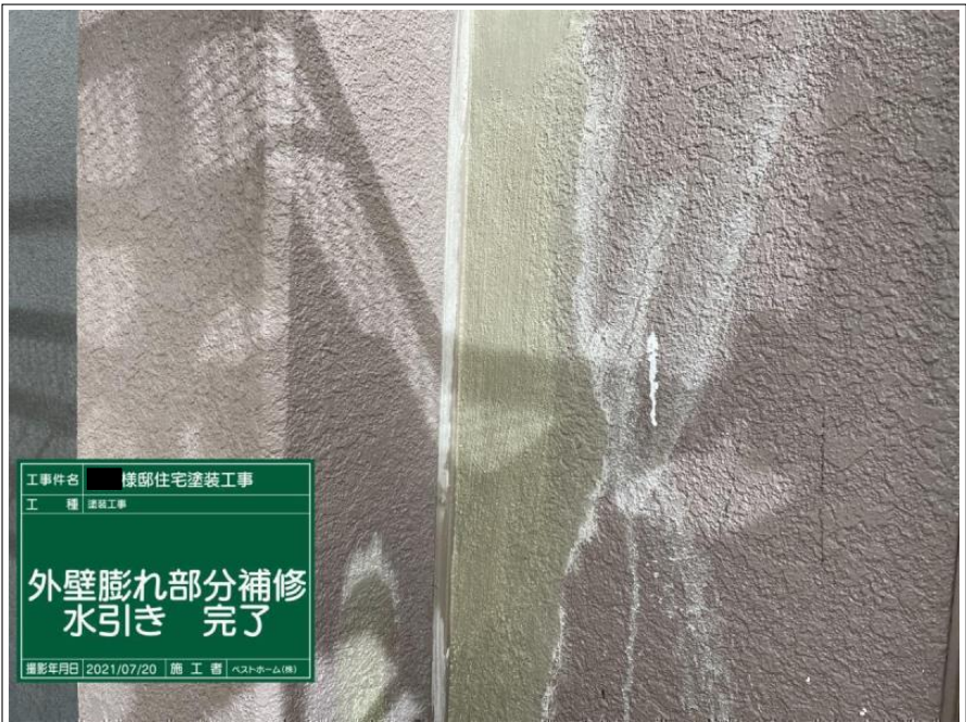
工事件名 様邸住宅塗装工事 工 種 塗装工事 外壁膨れ部分補修 水引き 撮影年月日 2021/07/20 施 工 者 ヘストホーム(株)
