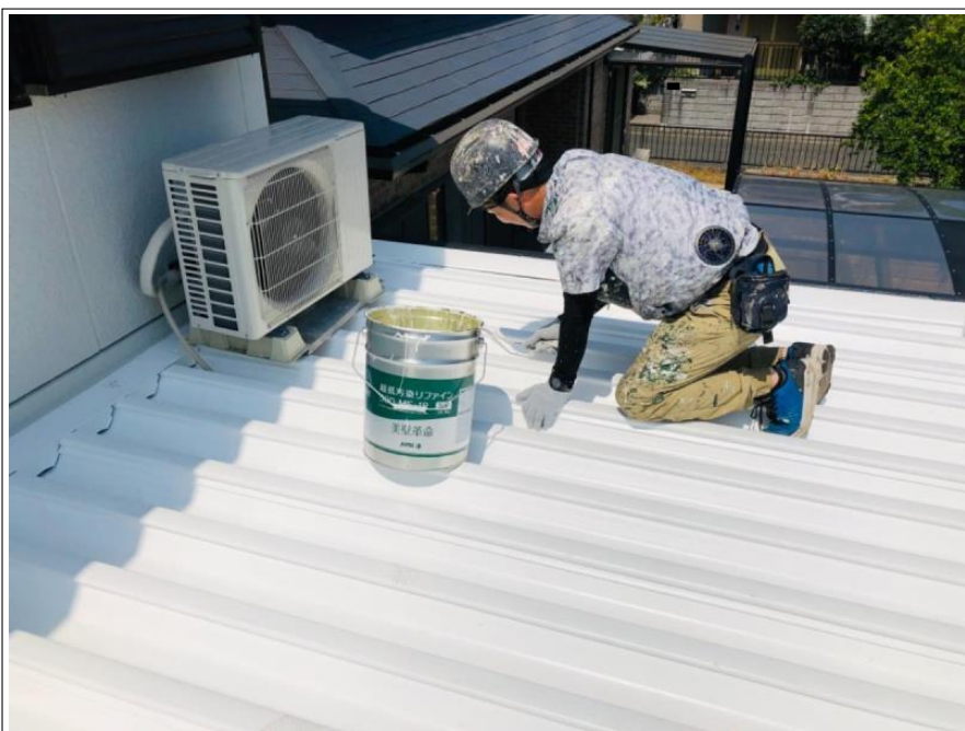
工事件名 ■ 様邸住宅塗装工事 工 種 塗装工事 下屋根 上塗り3回目 (リファイン) 撮影年月日 2021/07/28 施 工 者 株式会社ハストホーム
