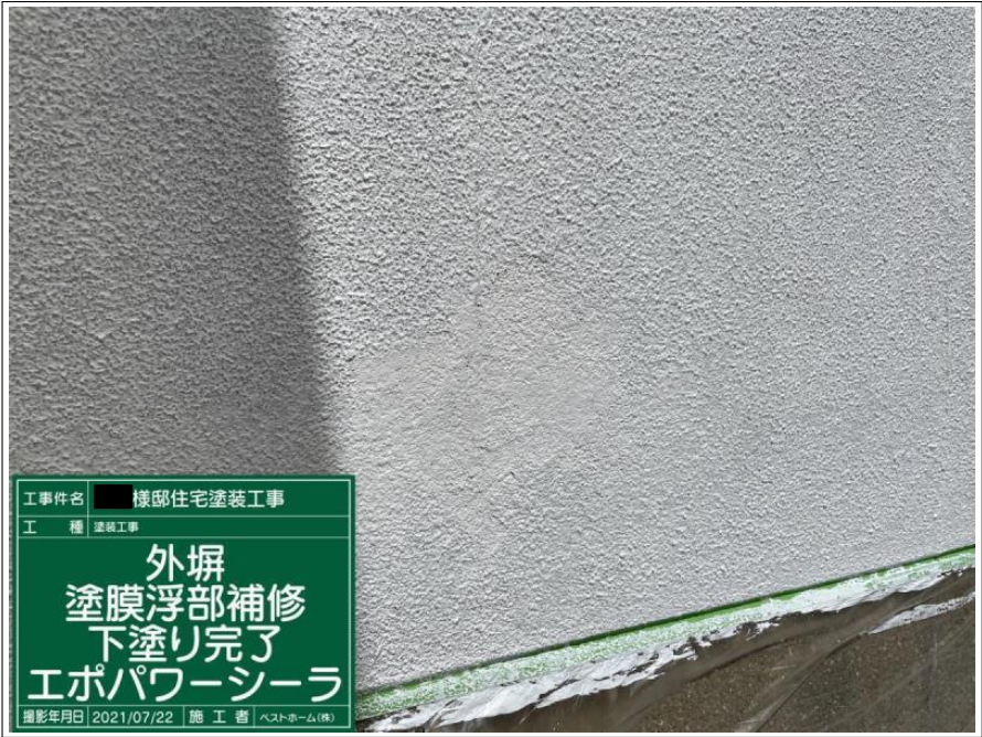
工事件名 様邸住宅塗装工事 工 種 塗装工事 外塀 塗膜浮部補修 下塗り エポパワーシーラ 撮影年月日 2021/07/22 | 施 工 者 | ベストホーム(株)
