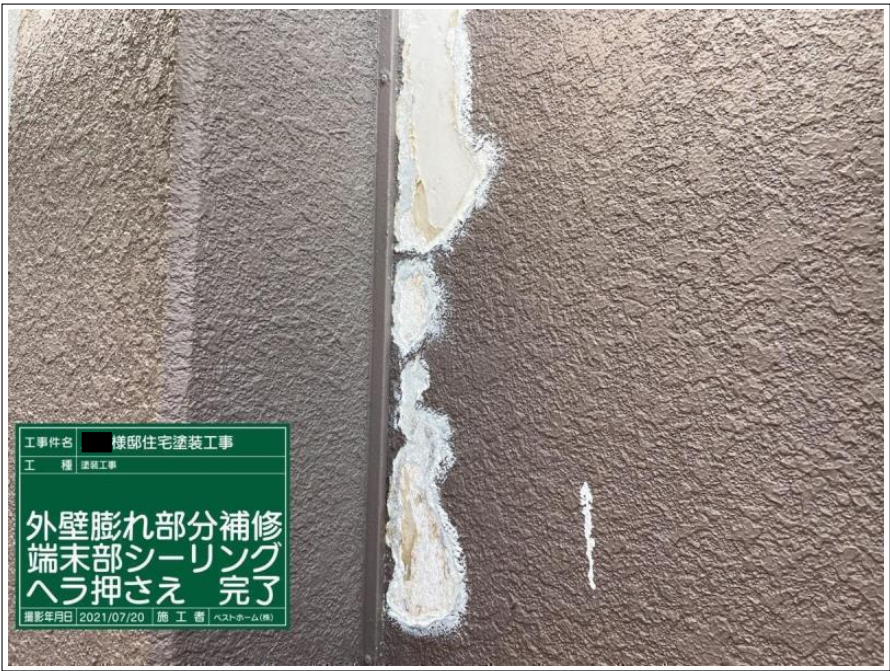
工事件名 様邸住宅塗装工事 工種 塗装工事 外壁膨れ部分補修 端末部シーリング ヘラ押さえ 撮影年月日 2021/07/20 | 施工者 ヘストホーム(株)
