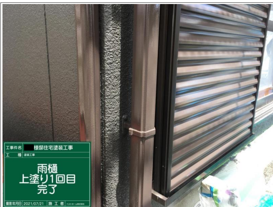
工事件名 様邸住宅塗装工事 工 種 塗装工事 雨樋 上塗り1回目 撮影年月日 2021/07/21 施 工 者 ハコチーエー建設株式会社
