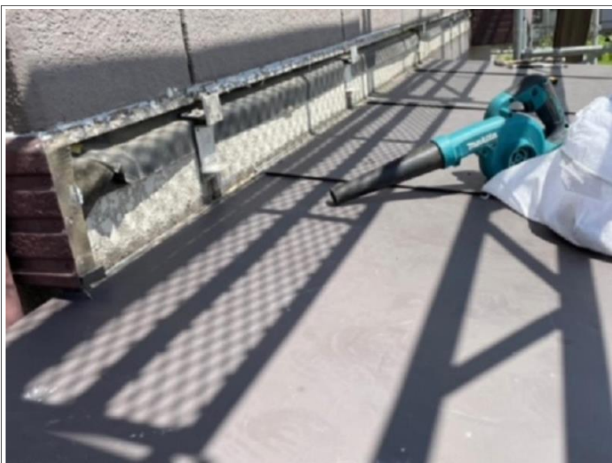
増築部 雨漏れ改修工事
