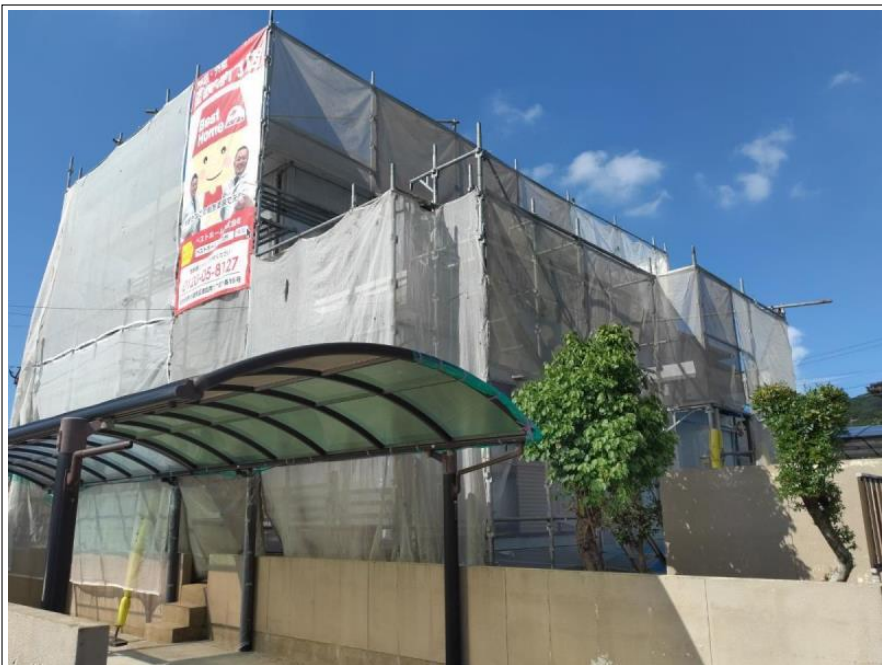
足場組立 完了
