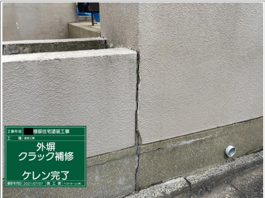
工事件名 様邸住宅塗装工事 工 種 塗装工事 外塀 クラック補修 ケレン 撮影年月日 2021/07/07 | 施 工 者 | ヘストホーム(株)
