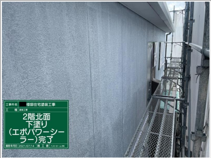
工事件名 棟部住宅塗装工事 工種 塗装工事 2階外壁 下塗り (エポパワーシーラー) 撮影年月日 2021/07/14 | 施工者 ヘストホーム(株)
