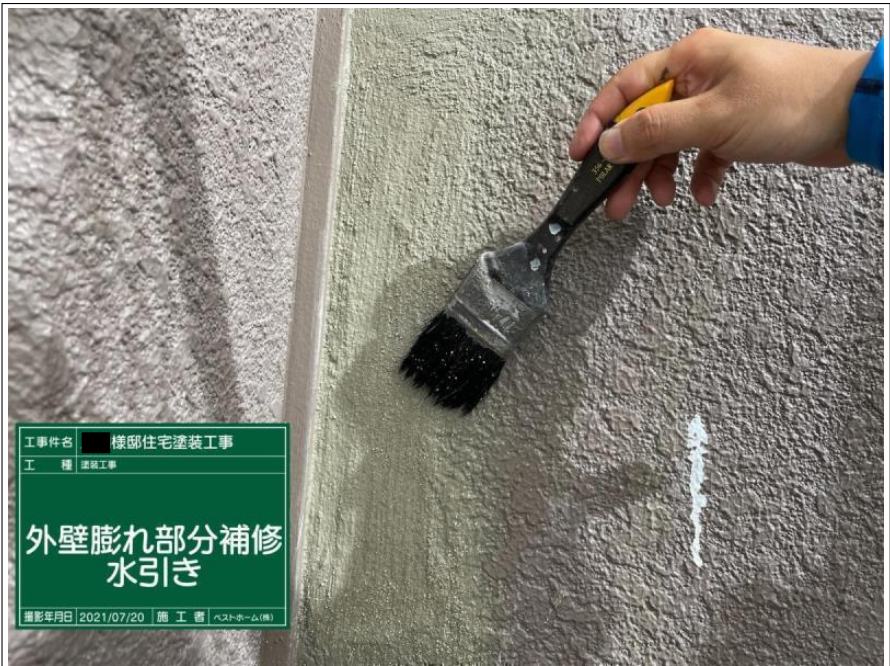
工事件名 様邸住宅塗装工事 工 種 塗装工事 外壁膨れ部分補修 水引き 撮影年月日 2021/07/20 施 工 者 ヘストホーム(株)
