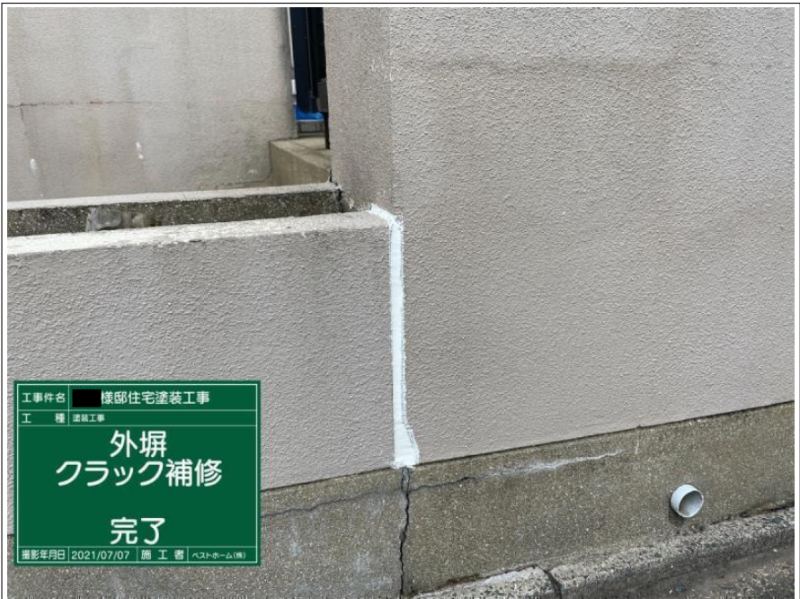
工事件名 様邸住宅塗装工事 工 種 塗装工事 外塀 クラック補修 ヘラ押さえ 撮影年月日 2021/07/07 施 工 者 ベストホーム(株)
