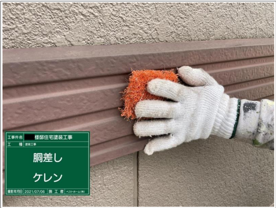
工事件名 様邸住宅塗装工事 工種 塗装工事 胴差し ケレン 撮影年月日 2021/07/06 | 施工者 | ヘストホーム(株)
