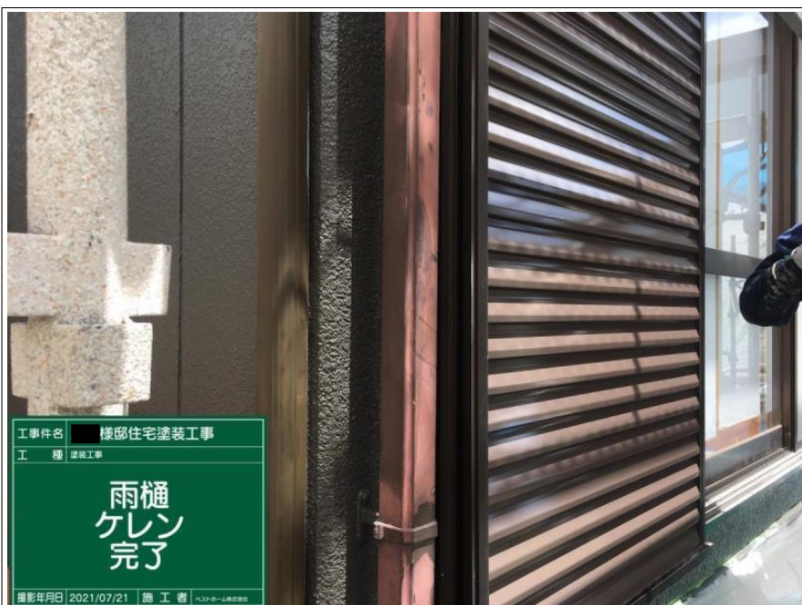
工事件名 棟邸住宅塗装工事 工 種 塗装工事 雨樋 ケレン 撮影年月日 2021/07/21 | 施 工 者 ハコブネホーム株式会社
