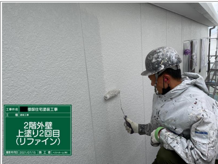
工事件名 棟部住宅塗装工事 工種 塗装工事 2階西面 上塗り1回目完了 (リファイン) 撮影年月日 2021/07/15 施工者 ヘストホーム(株)
