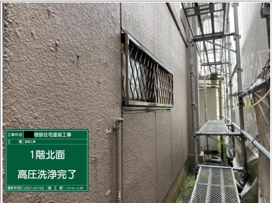
工事件名 棟部住宅塗装工事 工種 塗装工事 1階外壁 高圧洗浄 撮影年月日 2021/07/05 | 施工者 | ヘストホーム(株)
