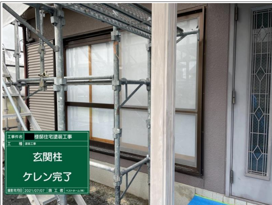
工事件名 様邸住宅塗装工事 工種 塗装工事 玄関柱 ケレン 撮影年月日 2021/07/07 施工者 ヘストホーム(株)
