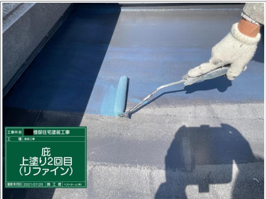
工事件名 様邸住宅塗装工事 工種 塗装工事 底 上塗り2回目 (リファイン) 撮影年月日 2021/07/20 施工者 ベストホーム(株)
