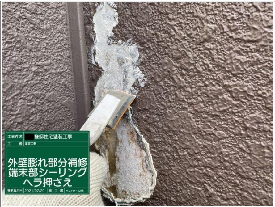
工事件名 様邸住宅塗装工事 工種 塗装工事 外壁膨れ部分補修 端末部シーリング ヘラ押さえ 撮影年月日 2021/07/20 | 施工者 ヘストホーム(株)
