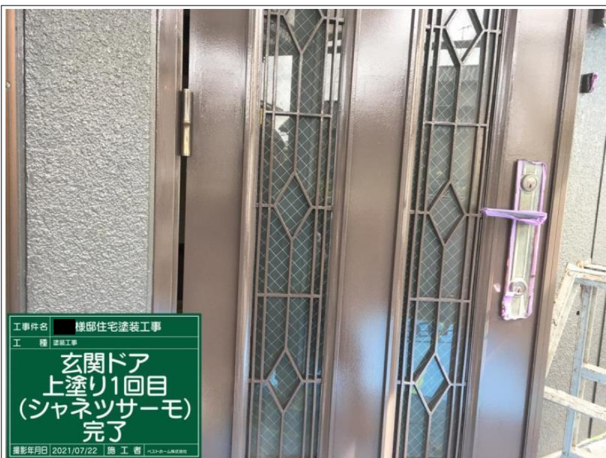
工事件名 棟邸住宅塗装工事 工 種 塗装工事 玄関ドア 上塗り1回目 (シャネツサーモ) 撮影年月日 2021/07/22 施 工 者 ベストホーム株式会社
