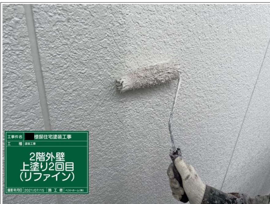
工事件名 棟部住宅塗装工事 工種 塗装工事 2階外壁 上塗り2回目 (リファイン) 撮影年月日 2021/07/15 施工者 ヘストホーム(株)
