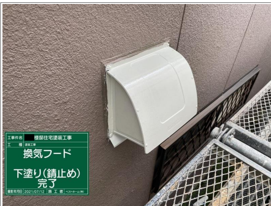
工事件名 様邸住宅塗装工事 工種 塗装工事 換気フード 下塗り(錆止め) 撮影年月日 2021/07/12 | 施工者 | ベストホーム(株)
