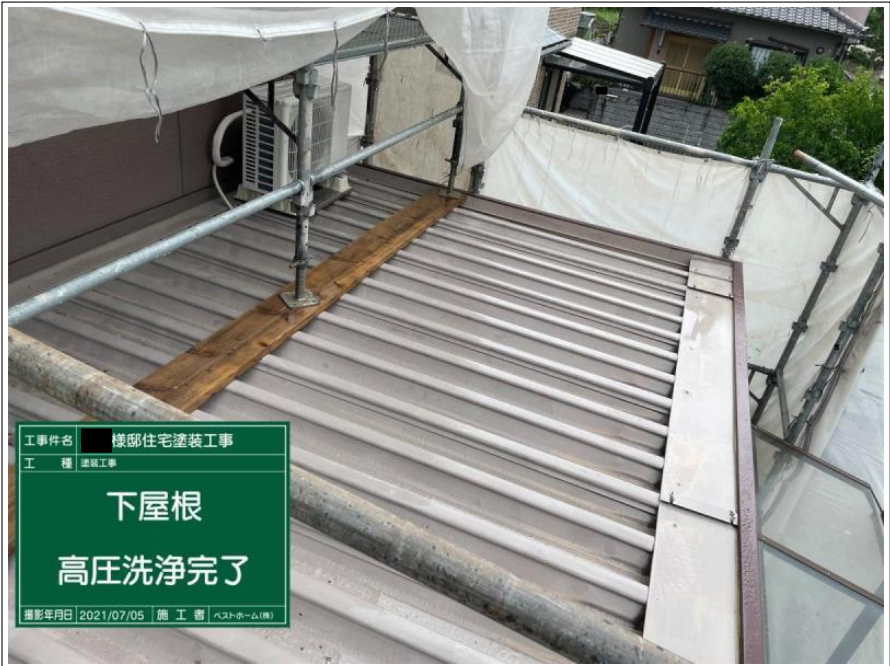
工事件名 様邸住宅塗装工事 工種 塗装工事 下屋根 高圧洗浄 撮影年月日 2021/07/05 | 施工者 | ハストホーム(株)
