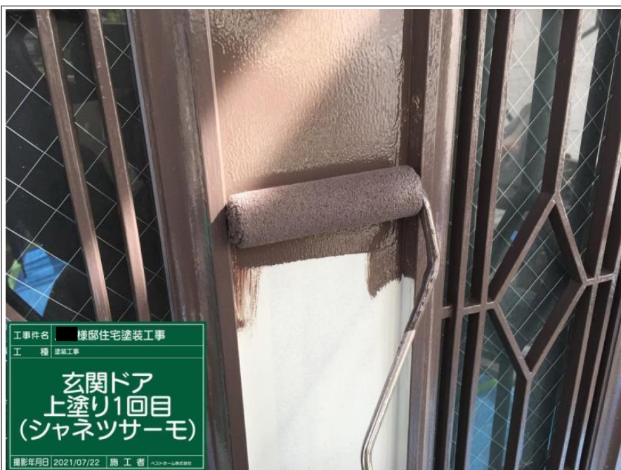
工事件名 棟邸住宅塗装工事 工 種 塗装工事 玄関ドア 上塗り1回目 (シャネツサーモ) 撮影年月日 2021/07/22 施 工 者 ベストホーム株式会社
