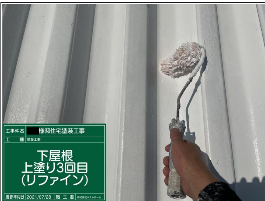
工事件名 ■ 様邸住宅塗装工事 工 種 塗装工事 下屋根 上塗り3回目 (リファイン) 撮影年月日 2021/07/28 施 工 者 株式会社ハストホーム
