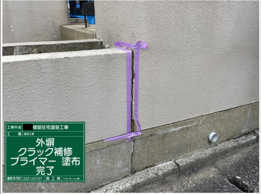
工事件名 様邸住宅塗装工事 工 種 塗装工事 外塀 クラック補修 プライマー 塗布 撮影年月日 2021/07/07 施 工 者 ヘストホーム(株)
