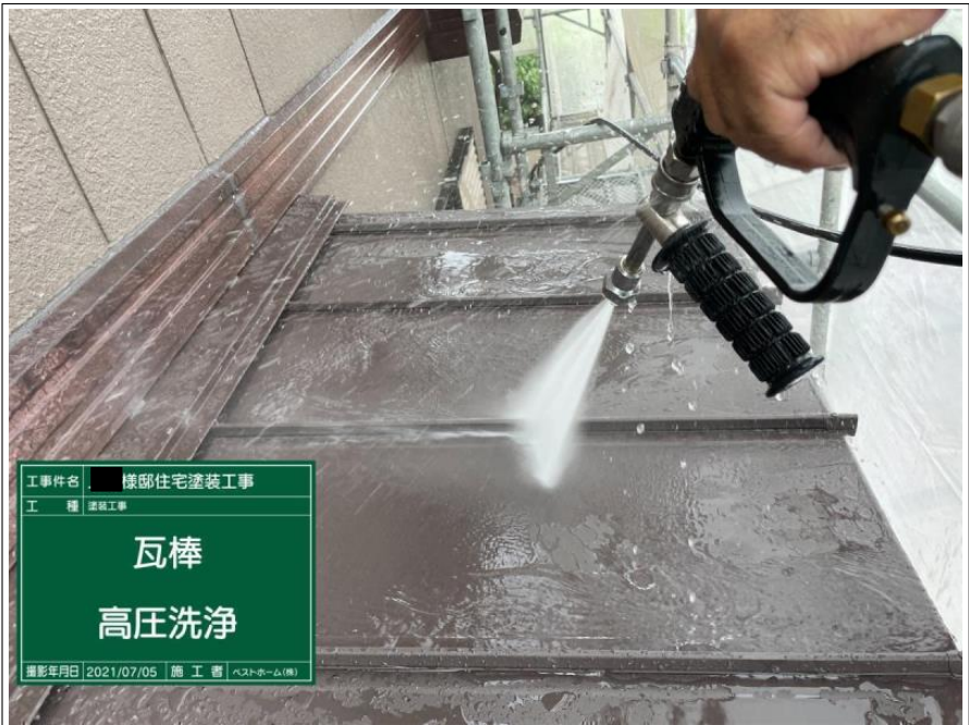
工事件名 棟部住宅塗装工事 工 種 塗装工事 瓦棒 高圧洗浄 撮影年月日 2021/07/05 | 施 工 者 | ヘストホーム(株)
