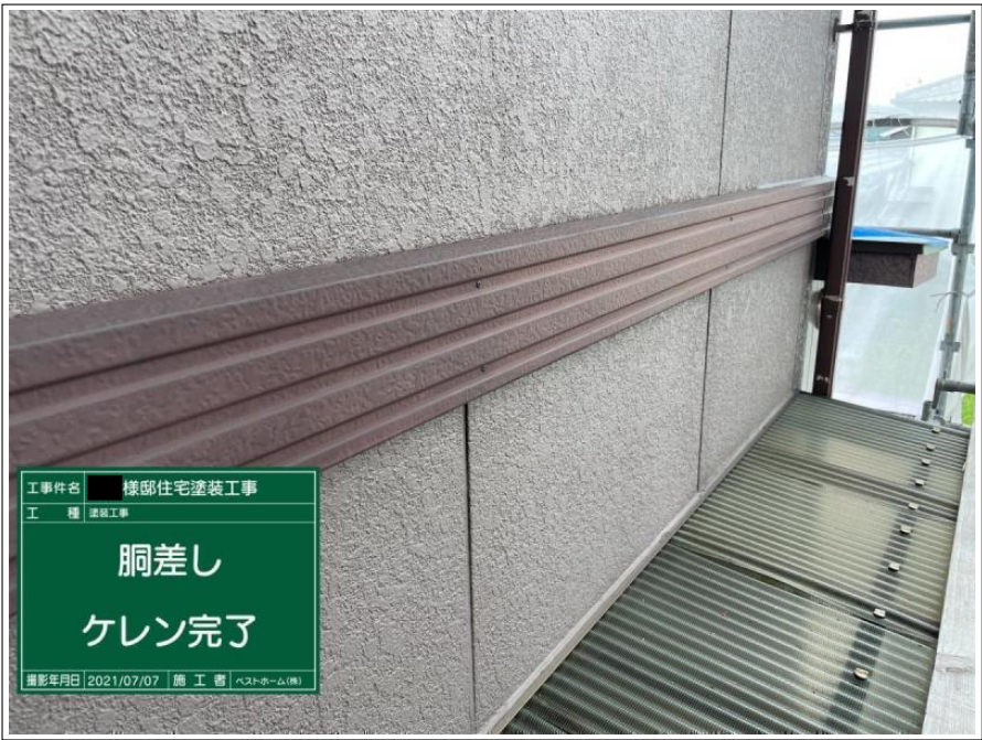
工事件名 様邸住宅塗装工事 工種 塗装工事 胴差し ケレン 撮影年月日 2021/07/06 | 施工者 | ヘストホーム(株)
