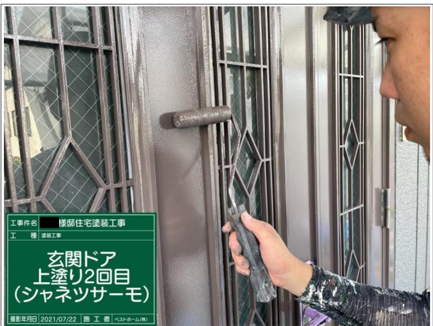
工事件名 様邸住宅塗装工事 工種 塗装工事 玄関ドア 上塗り2回目 (シャネツサーモ) 撮影年月日 2021/07/22 施工者 ベストホーム(株)
