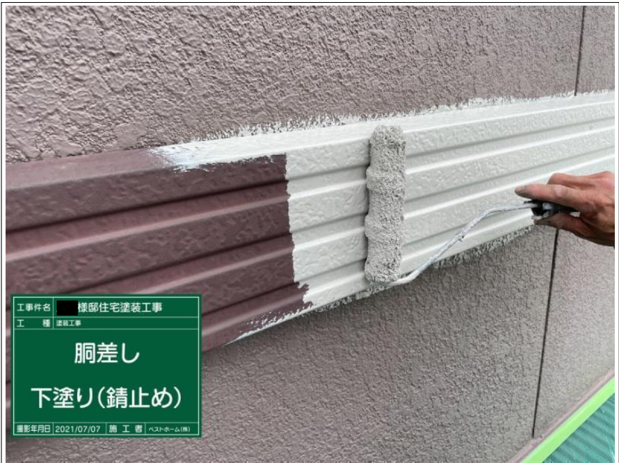
工事件名 様邸住宅塗装工事 工種 塗装工事 胴差し 下塗り(錆止め) 撮影年月日 2021/07/07 施工者 ベストホーム(株)
