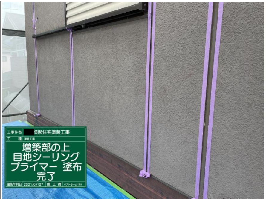
工事件名 棟部住宅塗装工事 工種 塗装工事 増築部の上 目地シーリング プライマー 塗布 撮影年月日 2021/07/07 施工者 ベストホーム(株)
