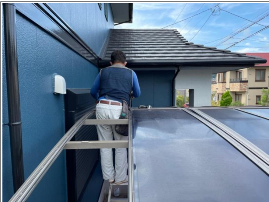
カーポート垂木 部分取替え
