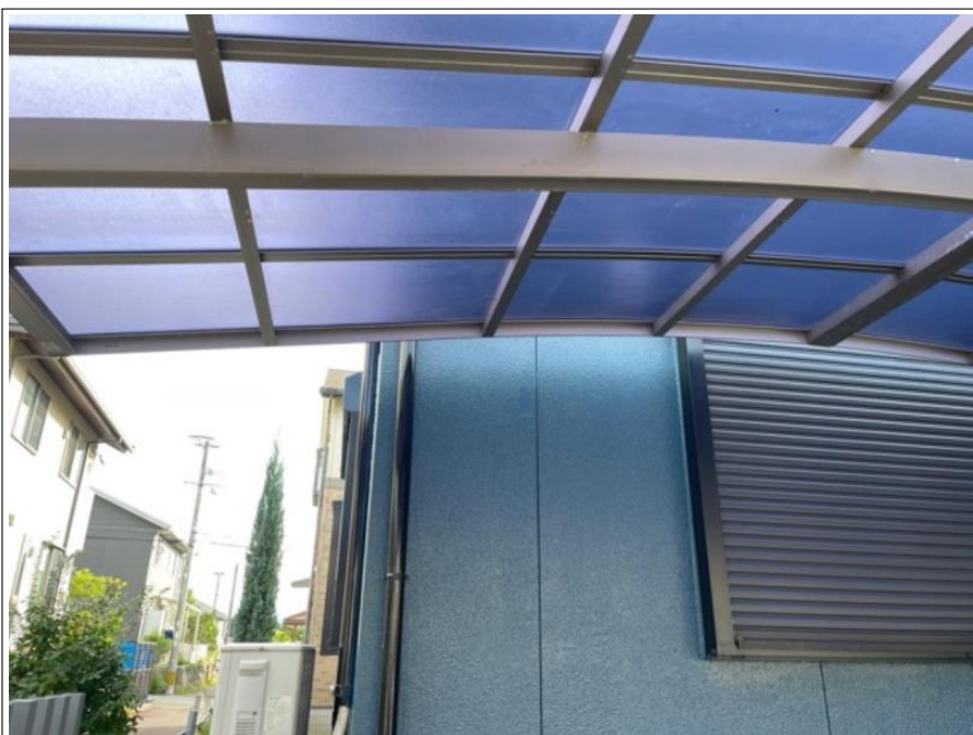
カーポート垂木 部分取替え
