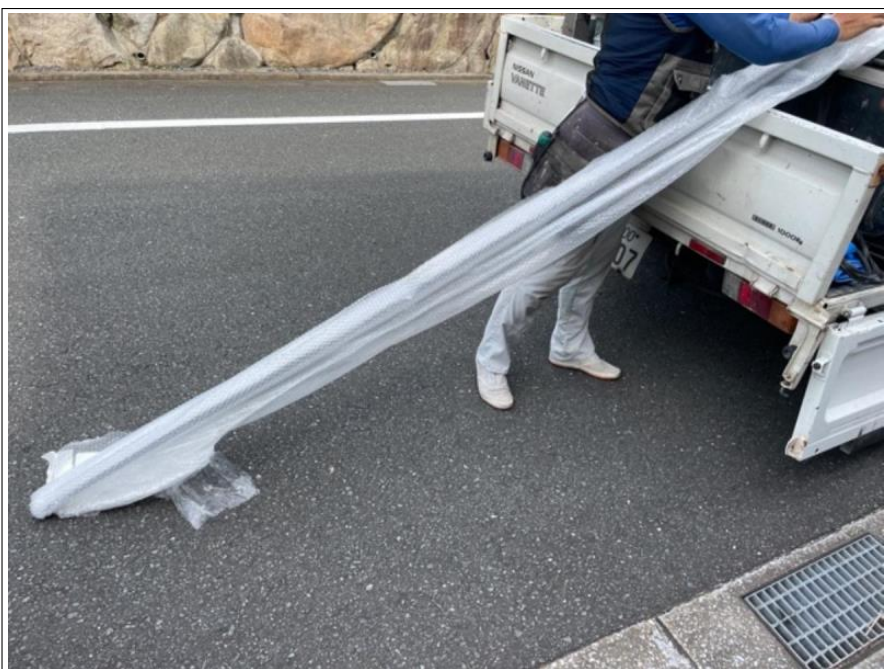
カーポート垂木 部分取替え
