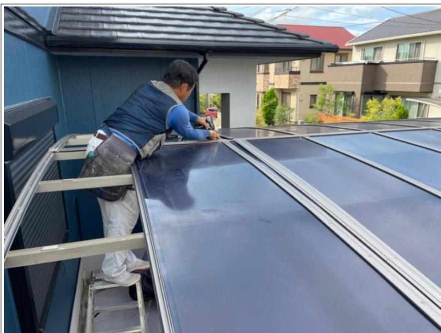
カーポート垂木 部分取替え
