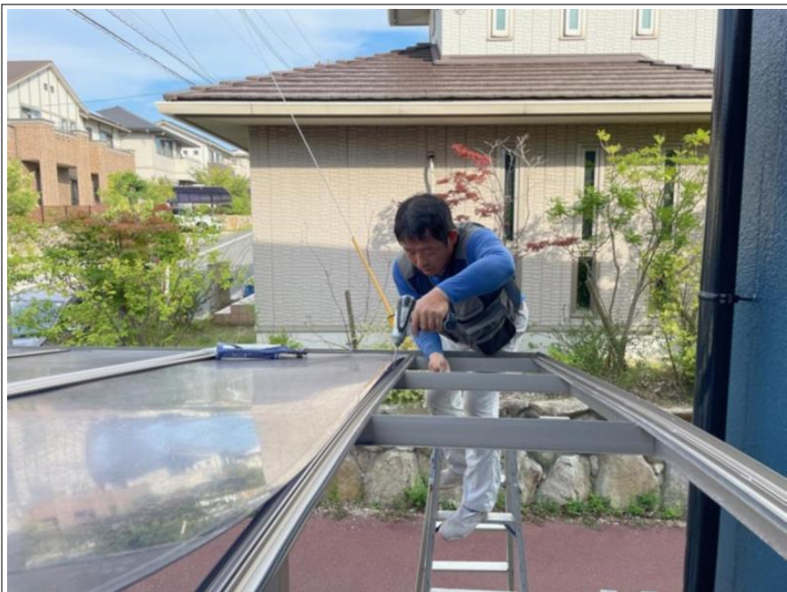
カーポート垂木 部分取替え
