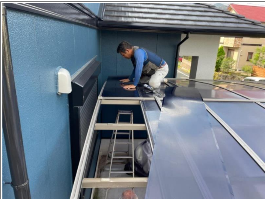
カーポート垂木 部分取替え
