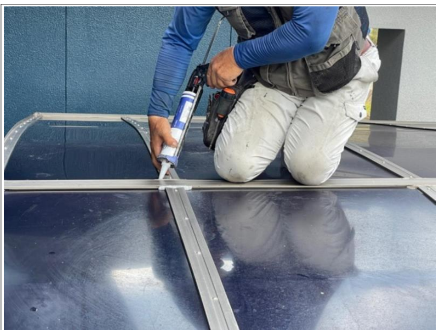
カーポート垂木 部分取替え
