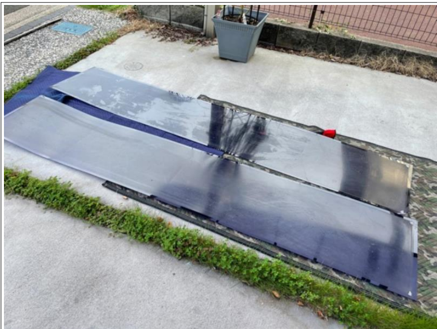
カーポート垂木 部分取替え
