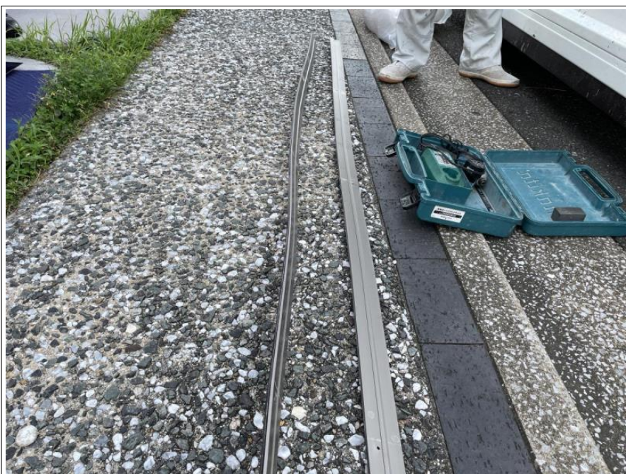
カーポート垂木 部分取替え
