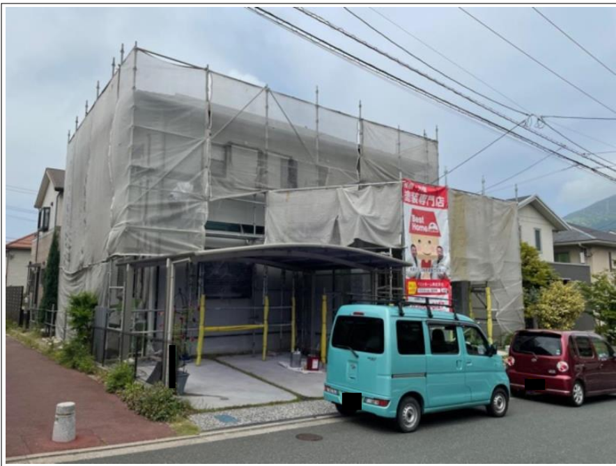
足場組立 完了
