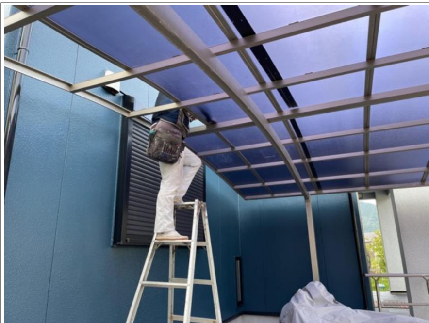
カーポート垂木 部分取替え
