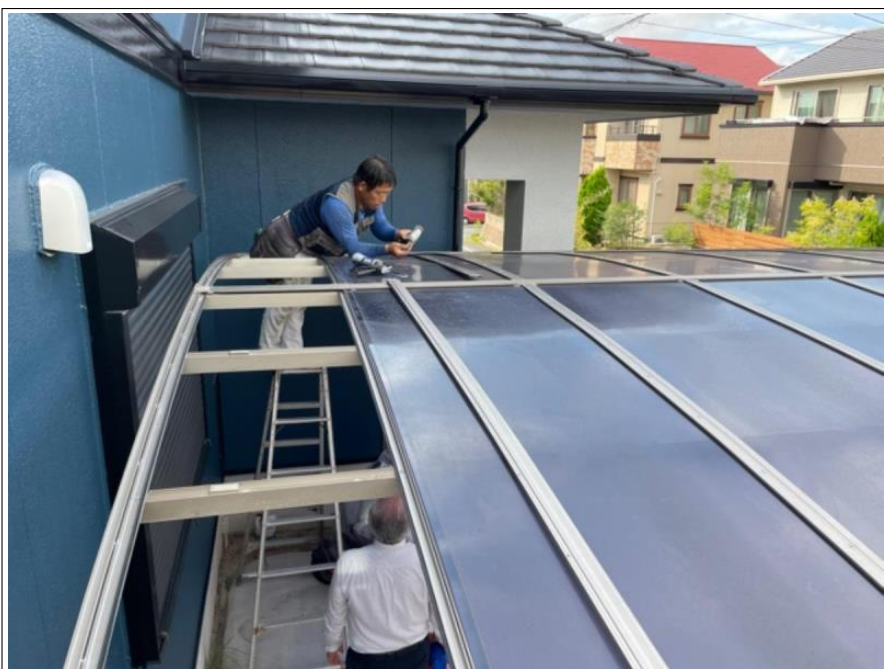
カーポート垂木 部分取替え
