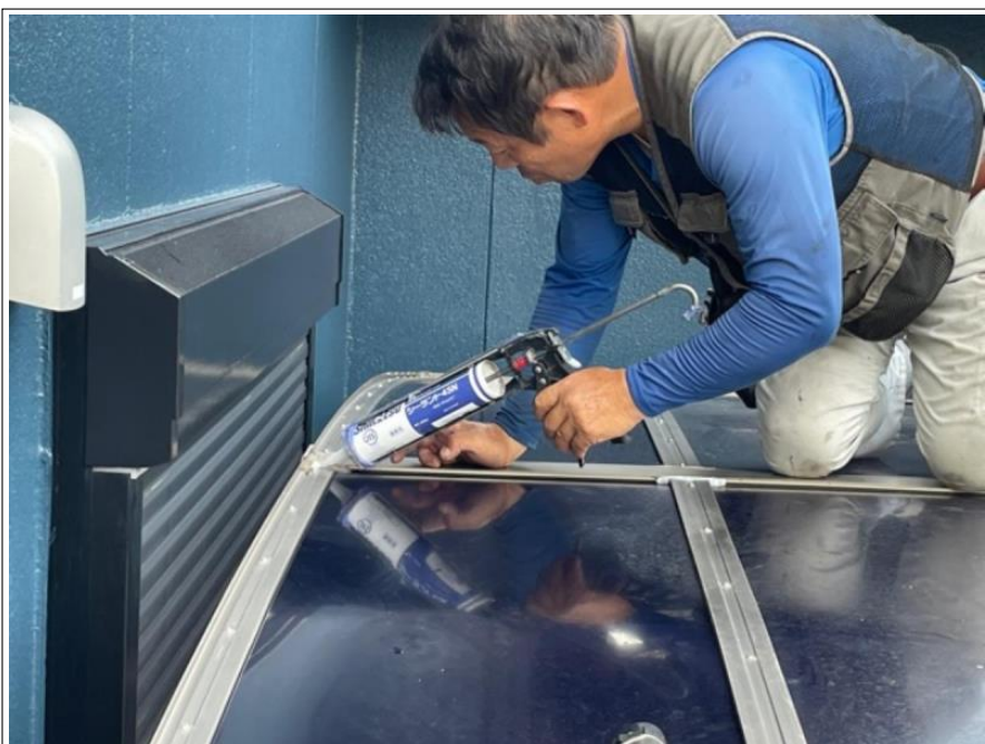
カーポート垂木 部分取替え
