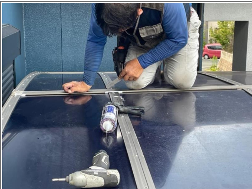
カーポート垂木 部分取替え
