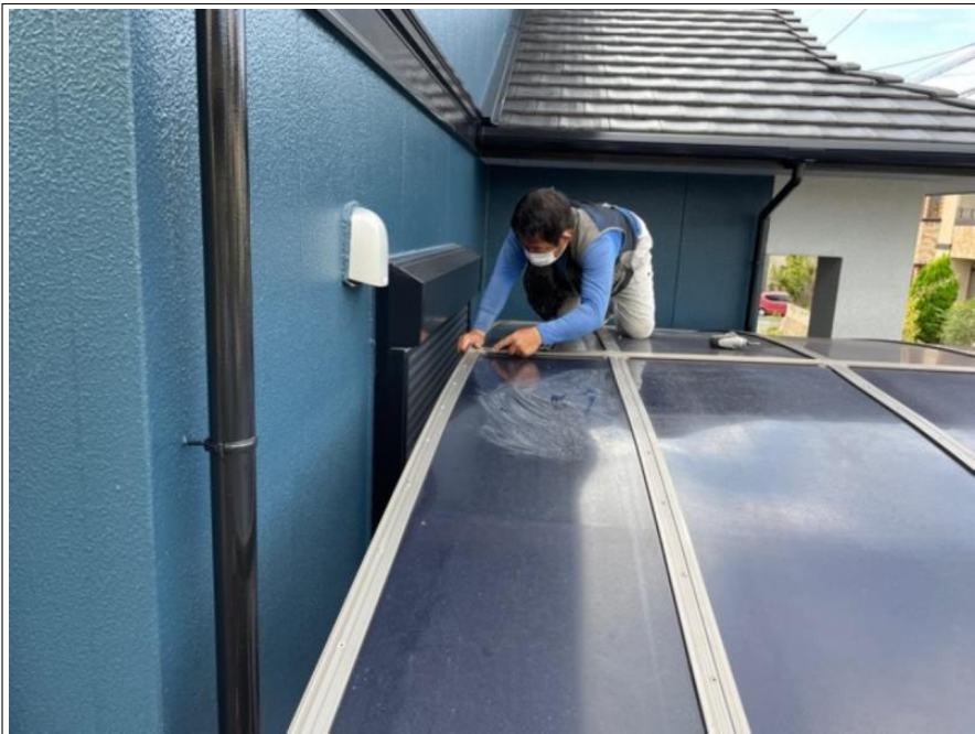
カーポート垂木 部分取替え
