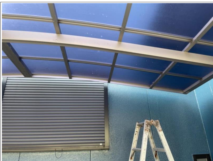
カーポート垂木 部分取替え
