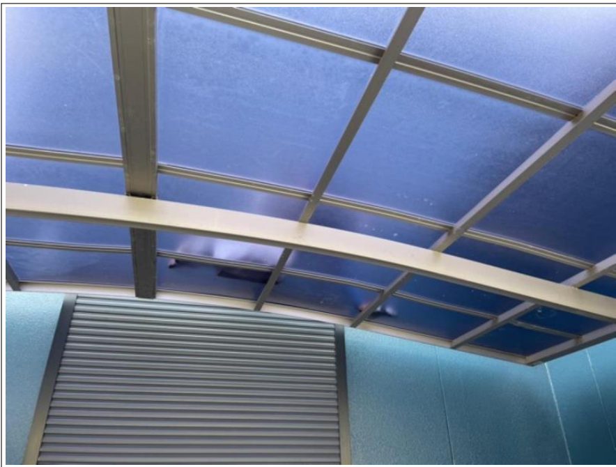
カーポート垂木 部分取替え
