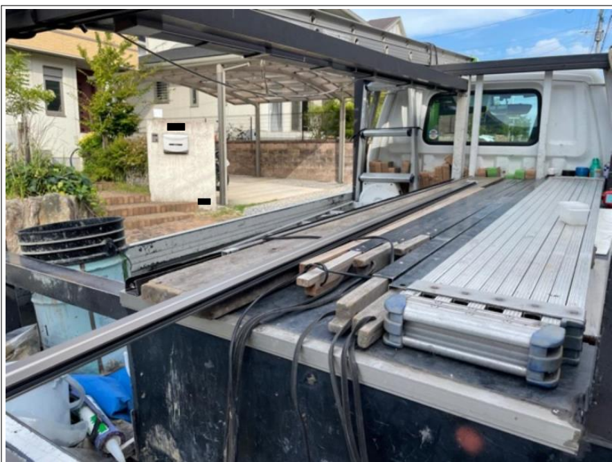
カーポート垂木 部分取替え
