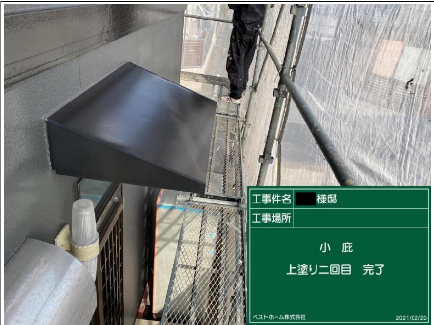
工事件名 様邸 工事場所 小 庇 上塗り二回目 状況 ベストホーム株式会社 2021/02/20
