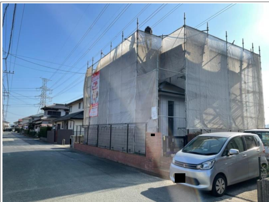
足場組立 完了
