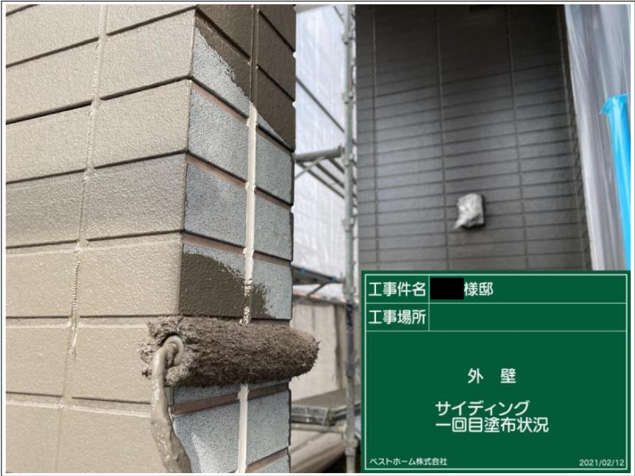
工事件名 ■ 様邸 工事場所 外 壁 サイディング 一回目塗布状況 ベストホーム株式会社 2021/02/12
