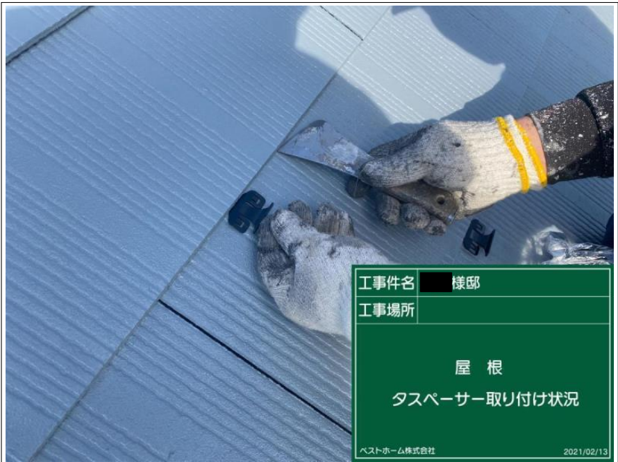
工事件名 ■ 様邸 工事場所 屋根 タスペーサー取り付け状況 ベストホーム株式会社 2021/02/13
