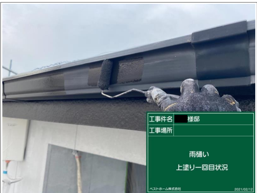
工事件名 様邸 工事場所 雨樋い 上塗り一回目状況 ベストホーム株式会社 2021/02/12
