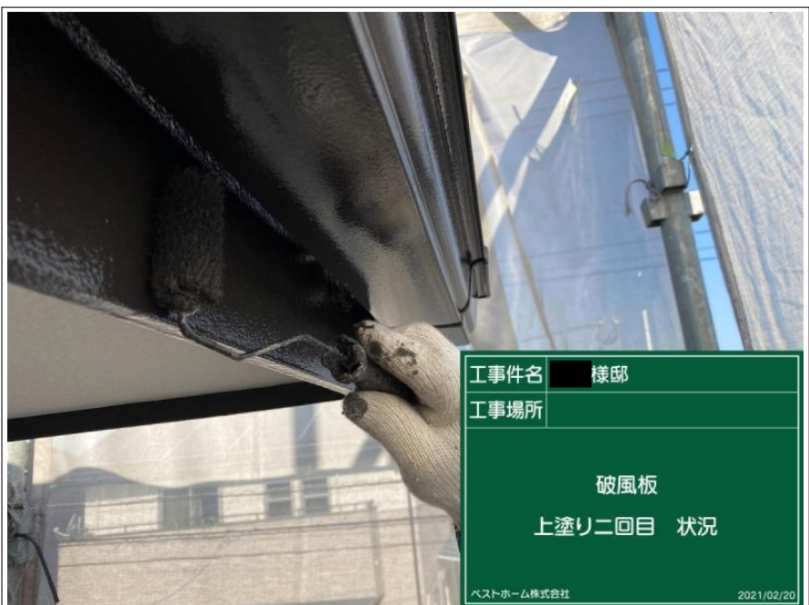
工事件名 様邸 工事場所 破風板 上塗り二回目 状況 ベストホーム株式会社 2021/02/20
