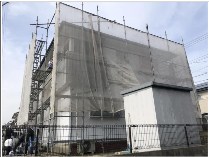
足場組立 完了
