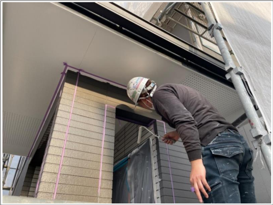
工事件名 ■ 様邸 工事場所 外 壁 サイディング 一回目塗布状況 ベストホーム株式会社 2021/02/12
