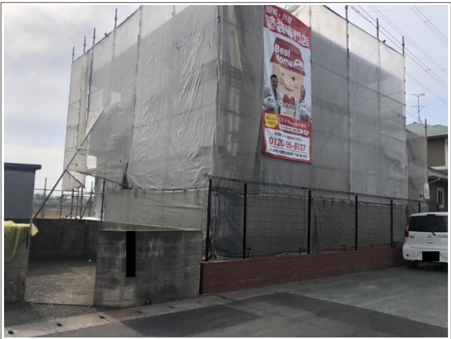
足場組立 完了
