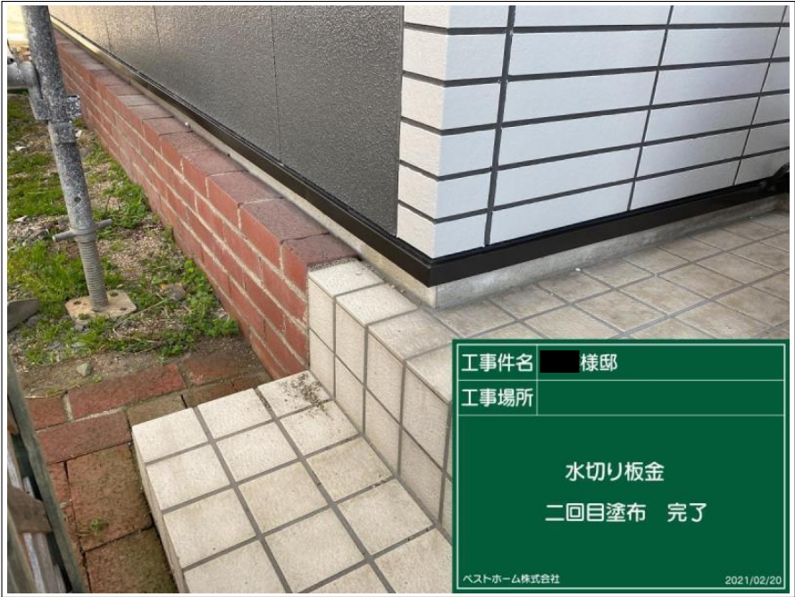
工事件名 様邸 工事場所 水切り板金 二回目塗布 状況 ベストホーム株式会社 2021/02/20
