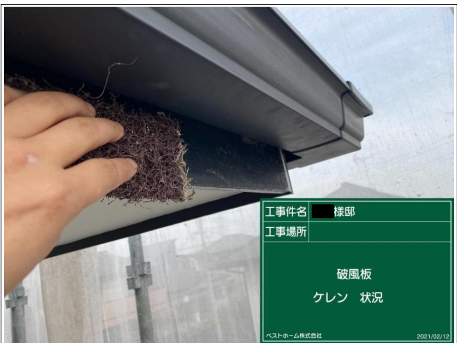
工事件名 様邸 工事場所 破風板 ケレン 状況 ベストホーム株式会社 2021/02/12
