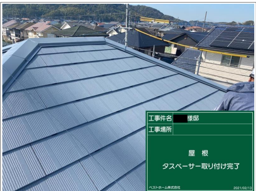
工事件名 ■ 様邸 工事場所 屋根 タスペーサー取り付け状況 ベストホーム株式会社 2021/02/13
