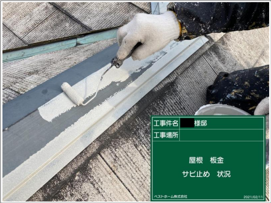
工事件名 様邸 工事場所 屋根 板金 サビ止め 状況 ベストホーム株式会社 2021/02/11
