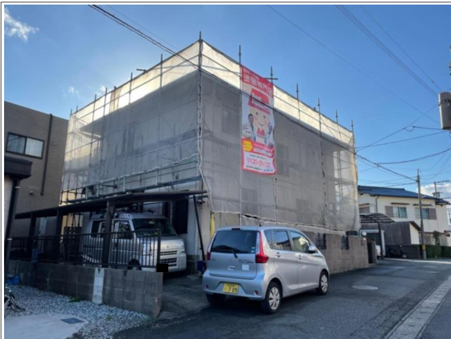
足場組立 完了
