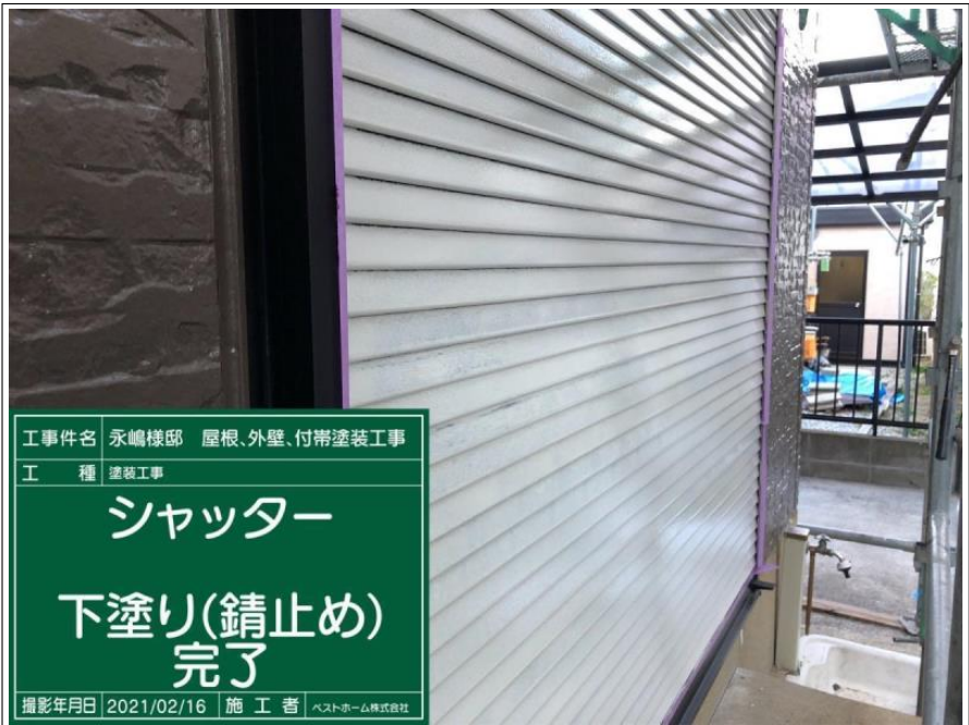
工事件名 永嶋様邸 屋根、外壁、付帯塗装工事 工 種 塗装工事 シャッター 下塗り(錆止め) 撮影年月日 2021/02/16 施 工 者 ベストホーム株式会社
