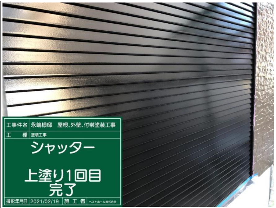
工事件名 永嶋様邸 屋根、外壁、付帯塗装工事 工種 塗装工事 シャッター 上塗り1回目 撮影年月日 2021/02/19 施工者 ベストホーム株式会社
