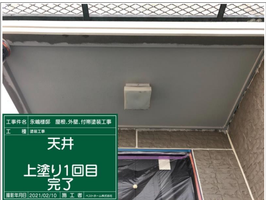
工事件名 永嶋様邸 屋根、外壁、付帯塗装工事 工種 塗装工事 天井 上塗り1回目 撮影年月日 2021/02/10 施工者 ベストホーム株式会社
