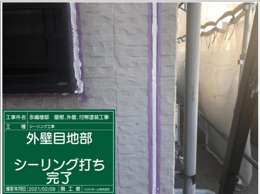
工事件名 永嶋様邸 屋根、外壁、付帯塗装工事 工 種 シーリング工事 外壁目地部 シーリング打ち 撮影年月日 2021/02/09 施 工 者 ベストホーム株式会社
