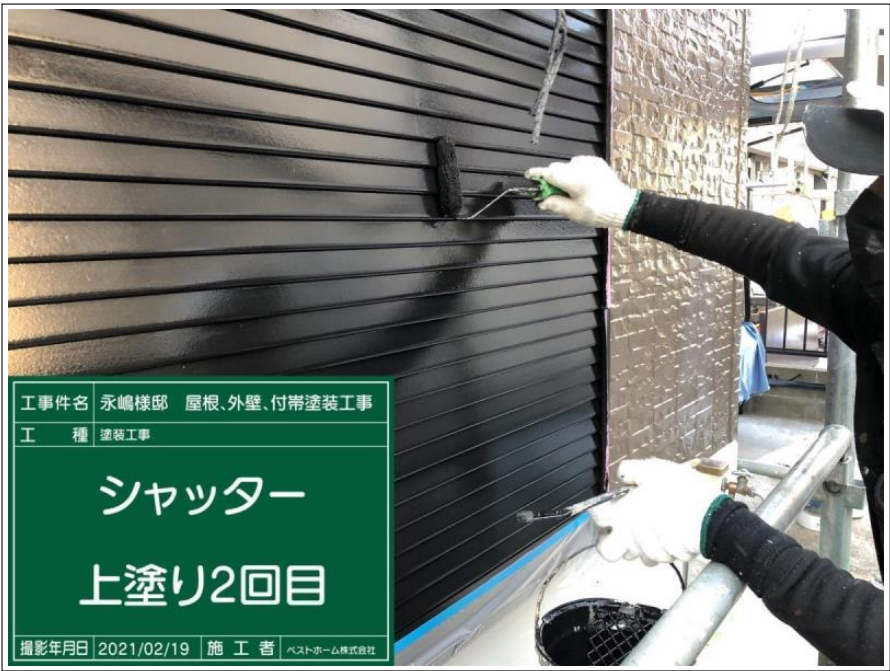
工事件名 永嶋様邸 屋根、外壁、付帯塗装工事 工種 塗装工事 シャッター 上塗り1回目 完了 撮影年月日 2021/02/19 施工者 ベストホーム株式会社
