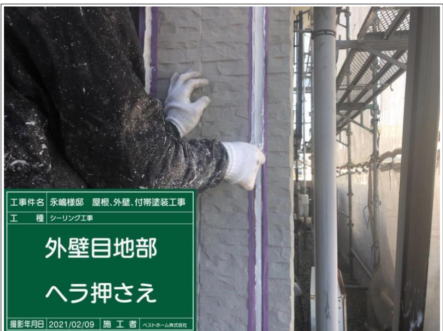
工事件名 永嶋様邸 屋根、外壁、付帯塗装工事 工 種 シーリング工事 外壁目地部 シーリング打ち 完了 撮影年月日 2021/02/09 施 工 者 ベストホーム株式会社
