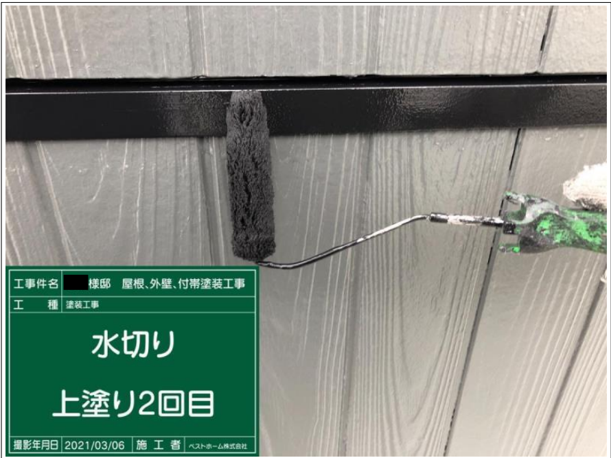
工事件名 ■ 様邸 屋根、外壁、付帯塗装工事 工 種 塗装工事 水切り 上塗り2回目 撮影年月日 2021/03/06 施 工 者 ベストホーム株式会社
