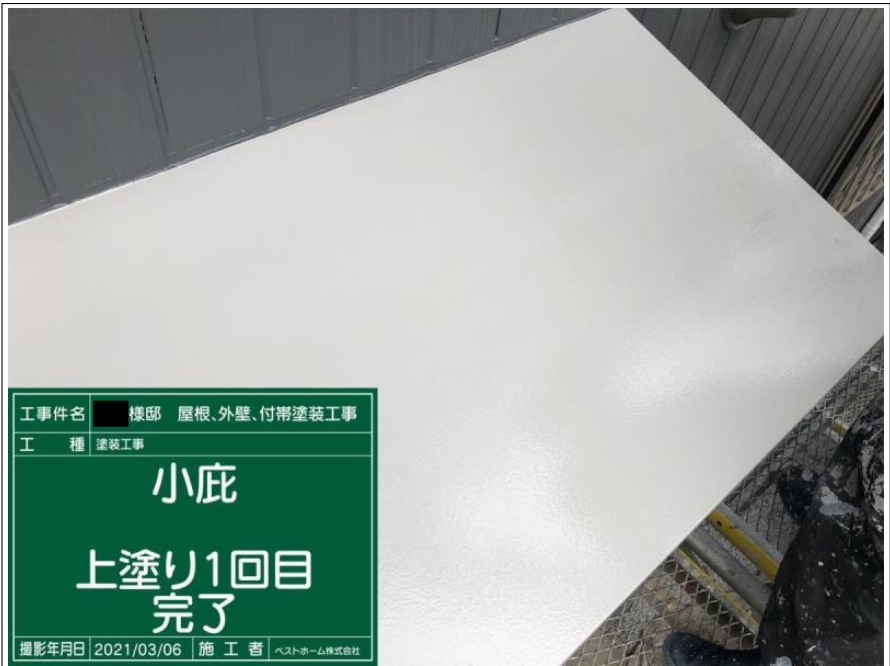
工事件名 ■ 様邸 屋根、外壁、付帯塗装工事 工 種 塗装工事 小庇 上塗り1回目 撮影年月日 2021/03/06 施 工 者 ベストホーム株式会社
