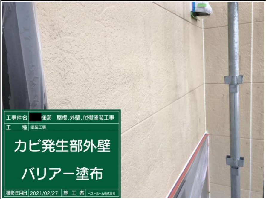
工事件名 ■ 様邸 屋根、外壁、付帯塗装工事 工 種 塗装工事 カビ発生部外壁 バリアー塗布 撮影年月日 2021/02/27 施 工 者 ヘストホーム株式会社
