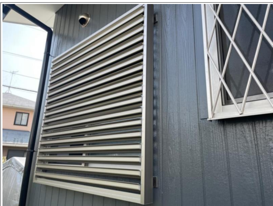
目隠しルーバー取付け工事
