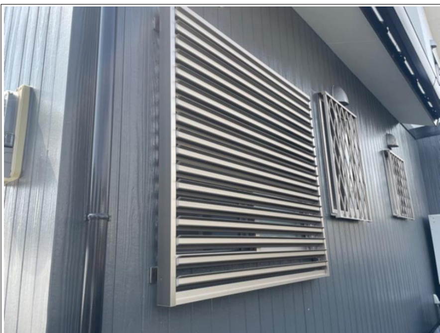
目隠しルーバー取付け工事
