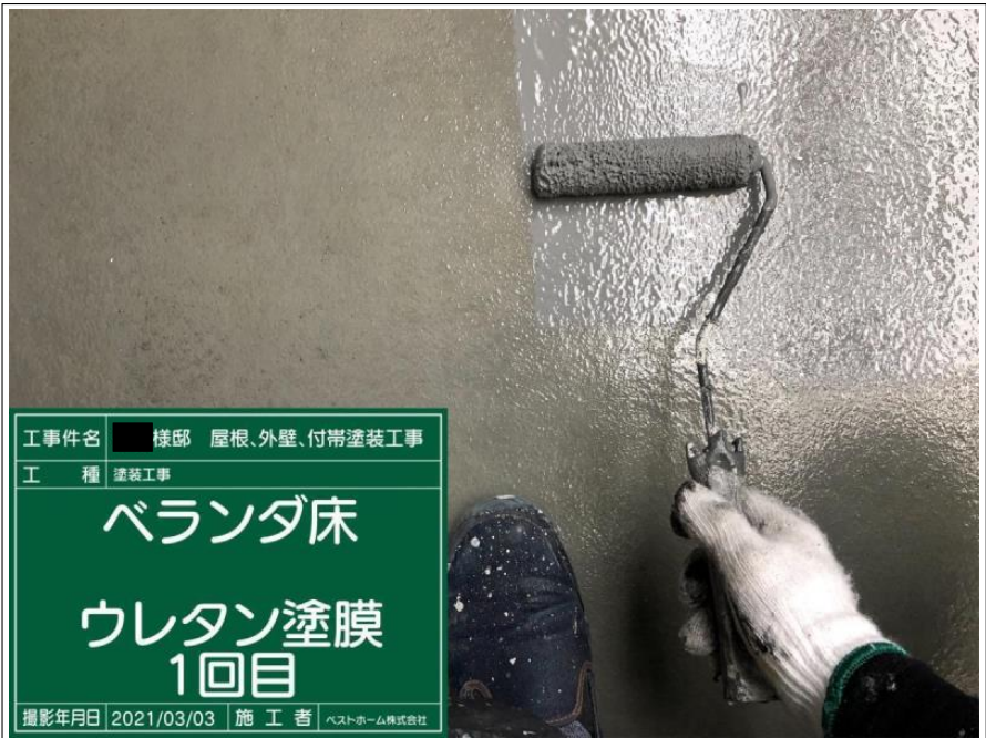
工事件名 ■ 棟邸 屋根、外壁、付帯塗装工事 工 種 塗装工事 ベランダ床 ウレタン塗膜 1回目 撮影年月日 2021/03/03 施 工 者 ヘストホーム株式会社
