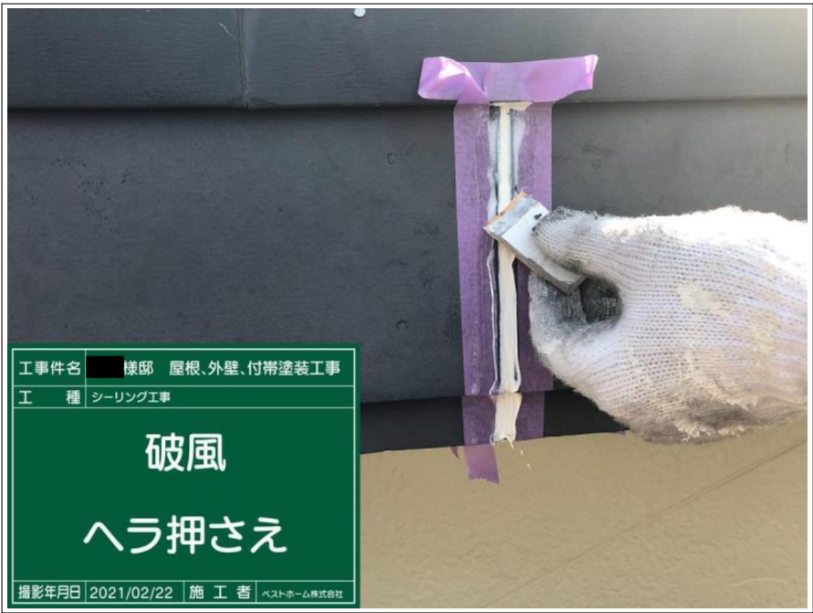
工事件名 様邸 屋根、外壁、付帯塗装工事 工種 シーリング工事 破風 ヘラ押さえ 撮影年月日 2021/02/22 施工者 ベストホーム株式会社
