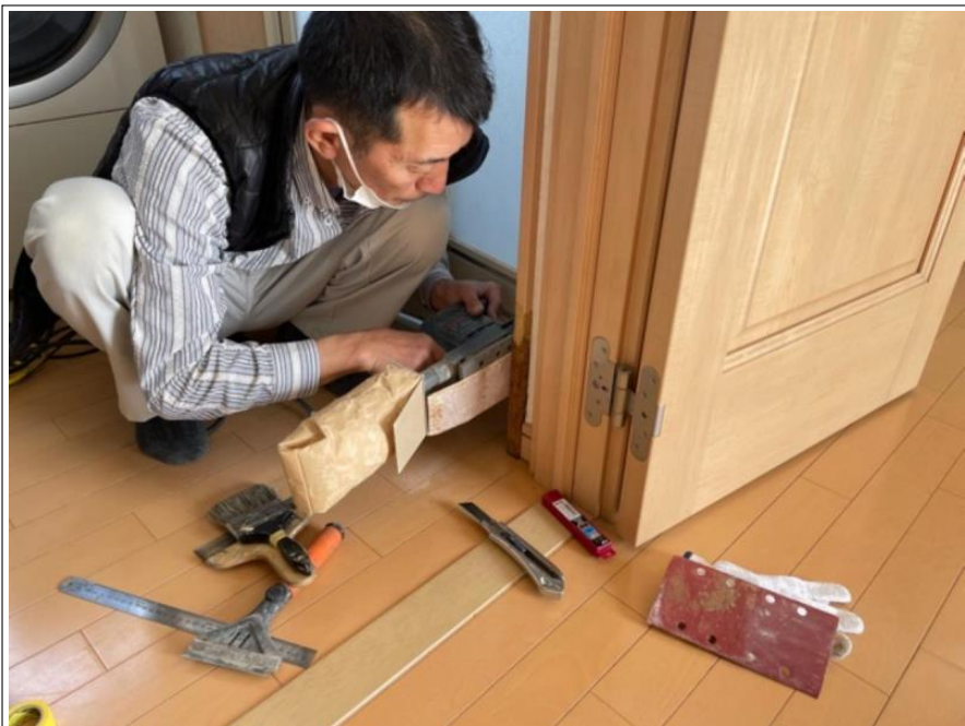
脱衣所 改修工事
