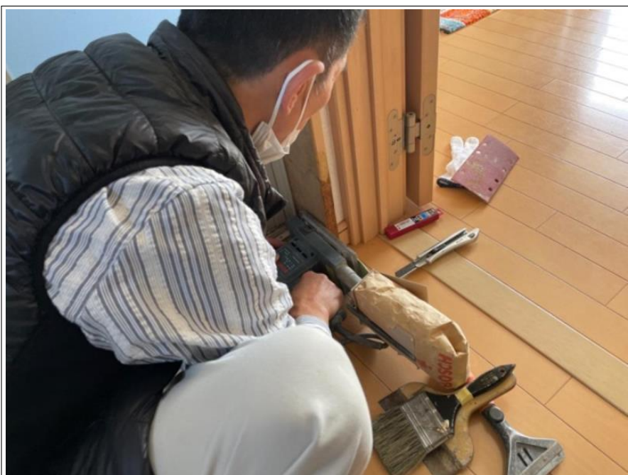
脱衣所 改修工事
