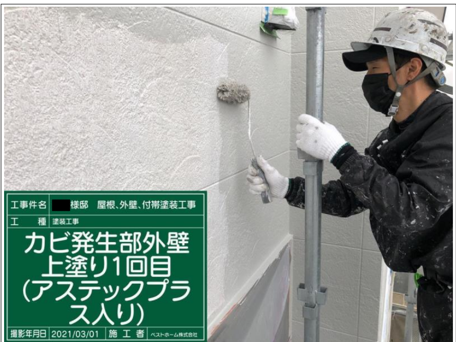
工 事 名 棟 邸 屋 根、外 壁、付 帯 塗 装 工 事 工 種 塗 装 工 事 1F外壁 上塗り1回目 撮 影 年 月 日 2021/03/01 施 工 者 ヘ ス ト 京 一 ム 株 式 有 限 公 司
