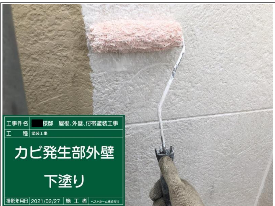
工事件名 ■ 棟邸 屋根、外壁、付帯塗装工事 工 種 塗装工事 カビ発生部外壁 下塗り 撮影年月日 2021/02/27 施 工 者 ヘストホーム株式会社
