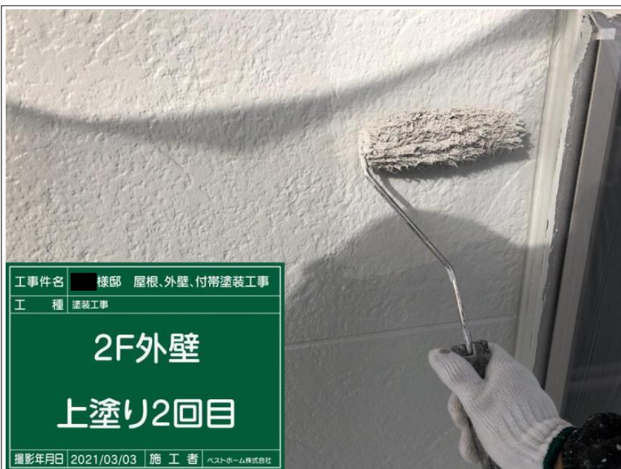
工 事 名 棟 号 屋 根、外 壁、付 帯 塗 装 工 事 工 種 塗 装 工 事 2F 外 壁 上 塗 り 2 回 目 撮 影 年 月 日 2021/03/03 施 工 者 ヘ ス ト 京 一 ン 株 式 有 限 公 司
