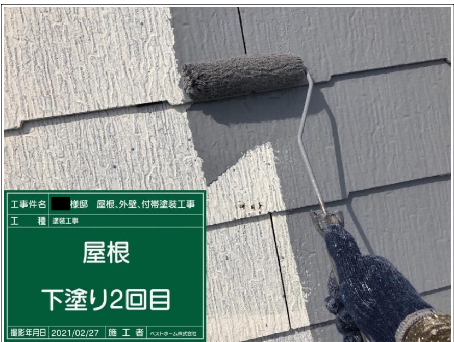
工事件名 棟邸 屋根、外壁、付帯塗装工事 工種 塗装工事 屋根 下塗り2回目 撮影年月日 2021/02/27 施工者 ベストホーム株式会社
