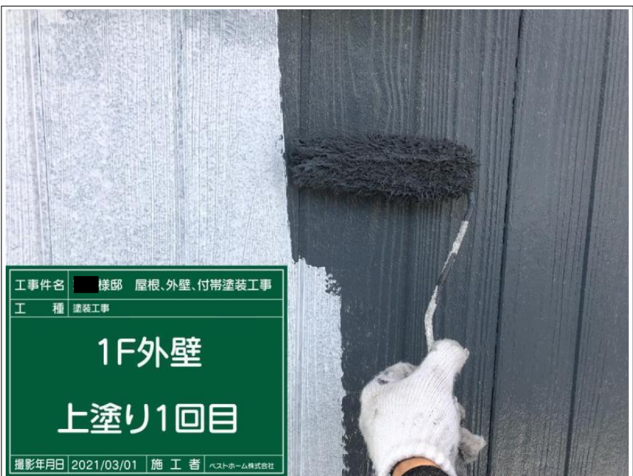
工 事 名 棟 邸 屋 根、外 壁、付 帯 塗 装 工 事 工 種 塗 装 工 事 1F外壁 上塗り1回目 撮 影 年 月 日 2021/03/01 施 工 者 ヘ ス ト 京 一 ム 株 式 有 限 公 司
