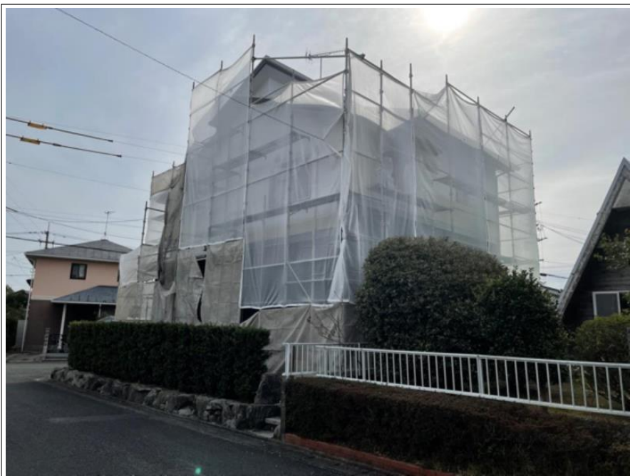
足場組立 完了
