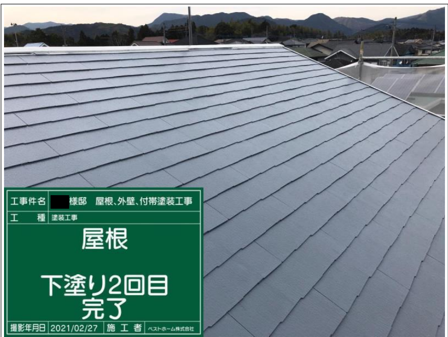
工事件名 ■ 棟邸 屋根、外壁、付帯塗装工事 工 種 塗装工事 下屋根 下塗り2回目 撮影年月日 2021/02/27 施 工 者 ヘスト京一ム株式会社
