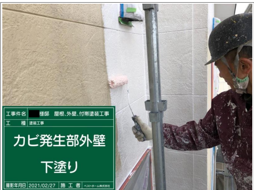
工事件名 ■ 棟邸 屋根、外壁、付帯塗装工事 工 種 塗装工事 1F外壁 下塗り 撮影年月日 2021/02/27 施 工 者 ヘストホーム株式会社
