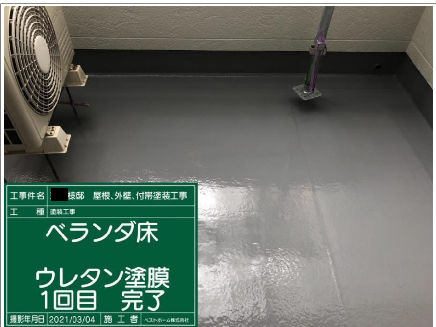
工事件名 ■ 棟邸 屋根、外壁、付帯塗装工事 工 種 塗装工事 ベランダ床 ウレタン塗膜 1回目 撮影年月日 2021/03/03 施 工 者 ヘストホーム株式会社
