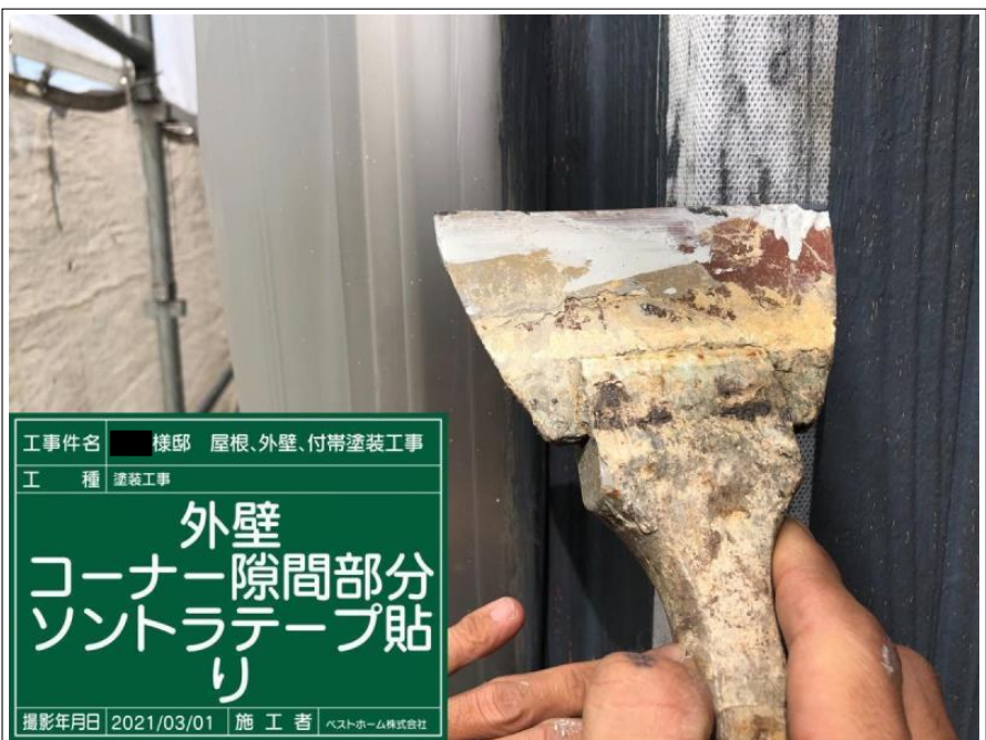
工事件名 ■ 棟邸 屋根、外壁、付帯塗装工事 工 種 塗装工事 外壁 コーナー隙間部分 ソントラテープ貼 り 撮影年月日 2021/03/01 施 工 者 ヘストホーム株式会社
