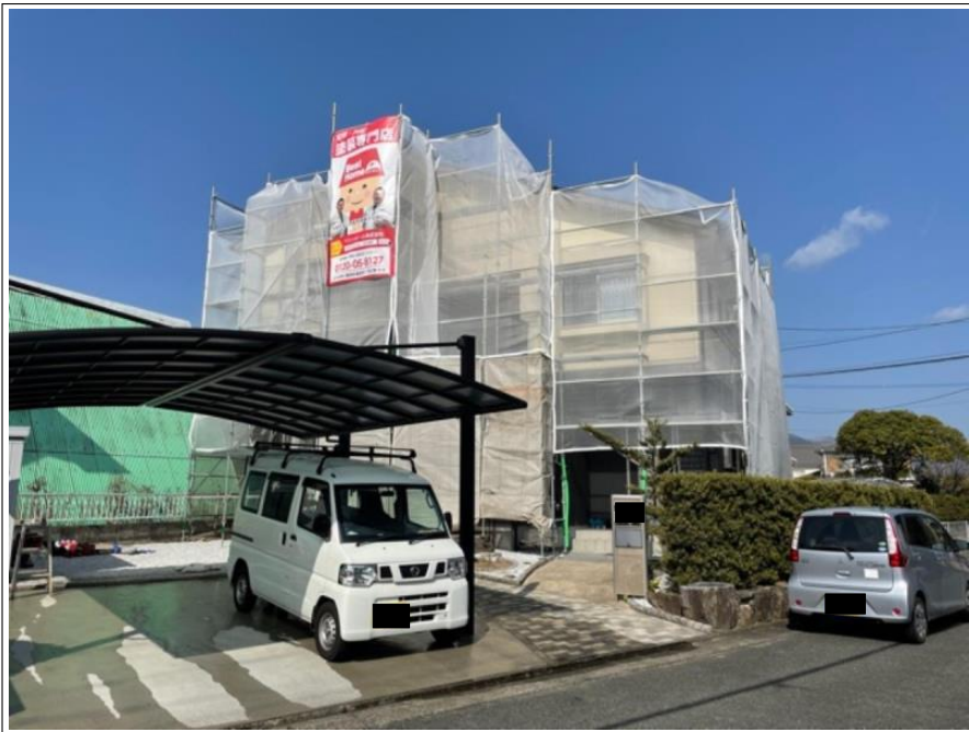
足場組立 完了
