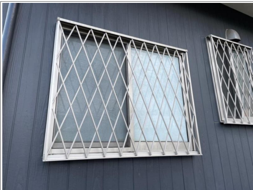
目隠しルーバー取付け工事
