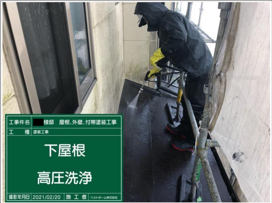
工事件名 ■ 様邸 屋根、外壁、付帯塗装工事 工 種 塗装工事 屋根 高圧洗浄 撮影年月日 2021/02/20 施 工 者 ベストホーム株式会社
