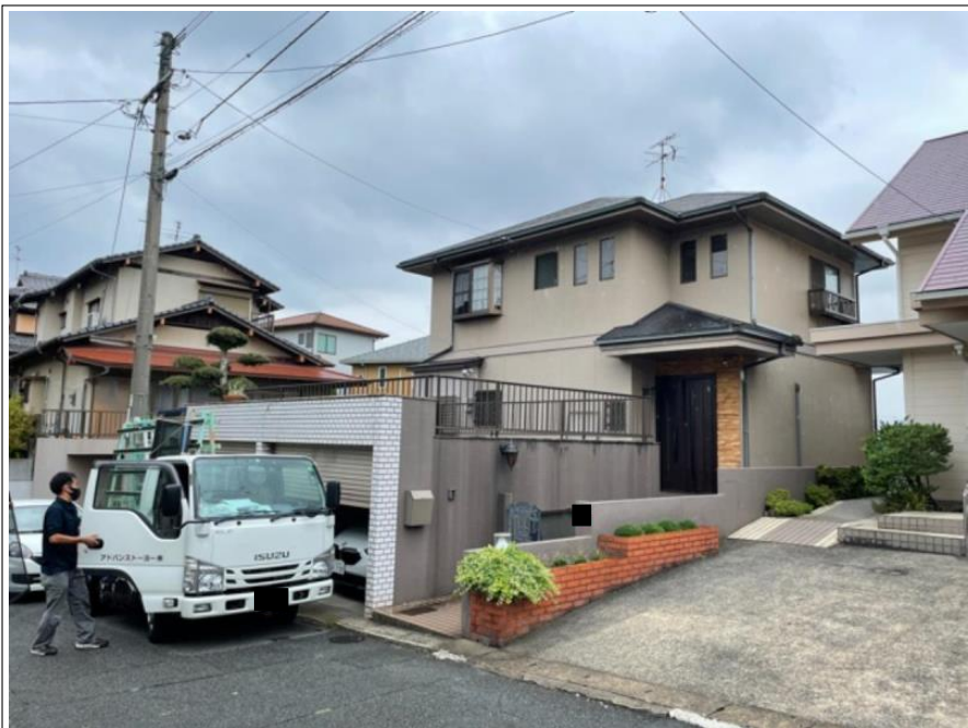
サッシカバー工法
