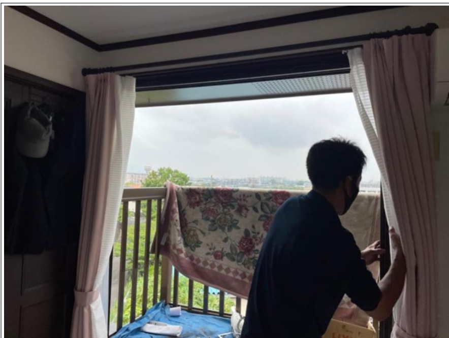
サッシカバー工法
