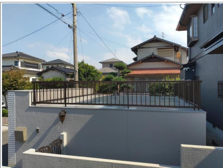
車庫上フェンス取り付け工事
