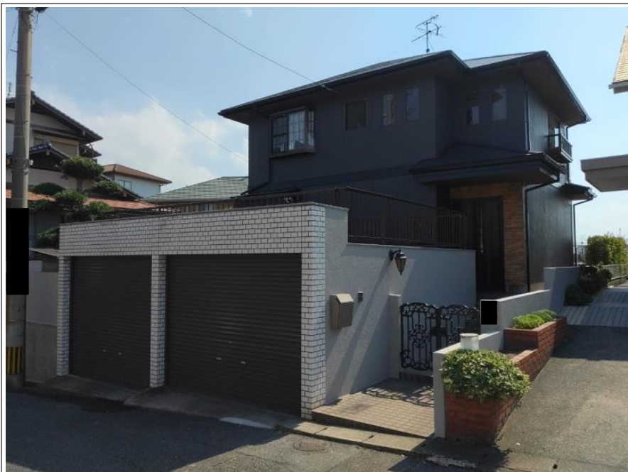
車庫上フェンス取り付け工事
