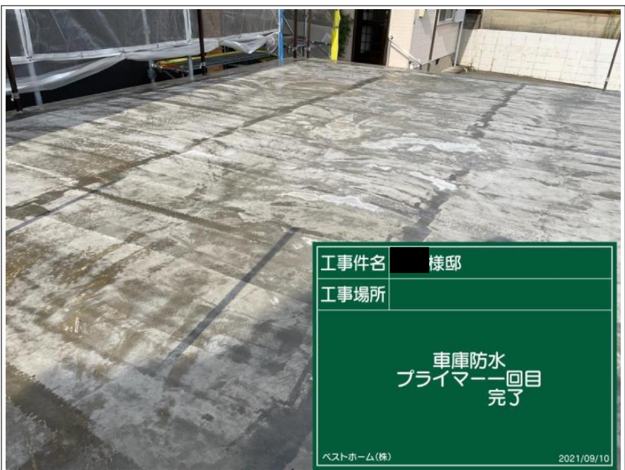
工事件名 ■ 様邸 工事場所 車庫防水 プライマー 2 回目 か ベストホーム(株) 2021/09/09
