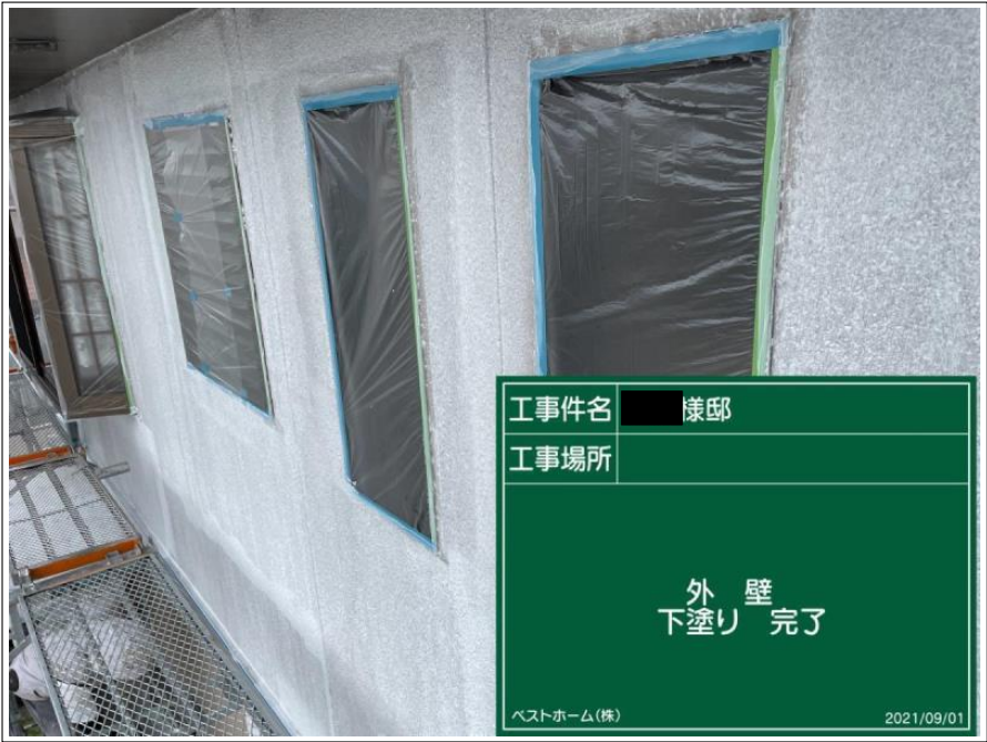
工事件名 様邸 工事場所 外 壁 下塗り 完了 ベストホーム(株) 2021/09/01
