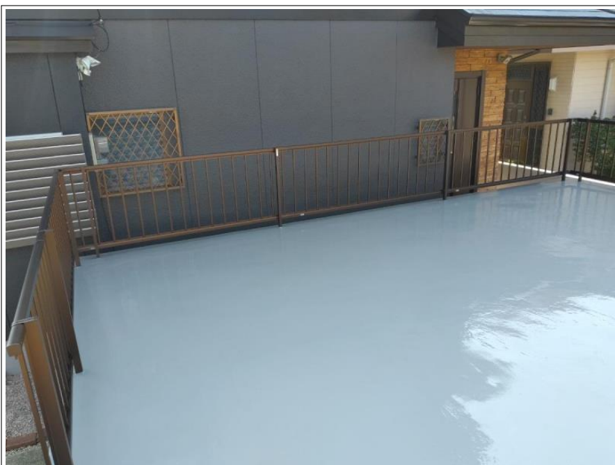
車庫上フェンス取り付け工事
