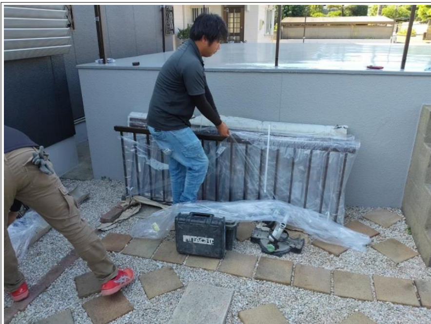
車庫上フェンス取り付け工事
