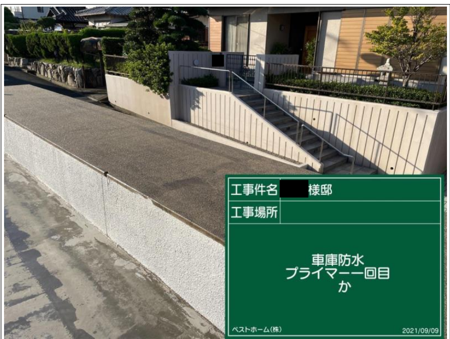
工事件名 ■ 様邸 工事場所 車庫防水 プライマー 状況 ベストホーム(株) 2021/09/09
