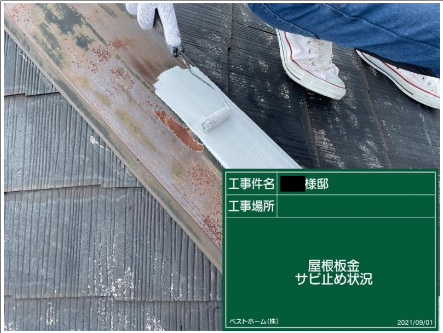
工事件名 様邸 工事場所 屋根板金 サビ止め状況 ベストホーム(株) 2021/09/01
