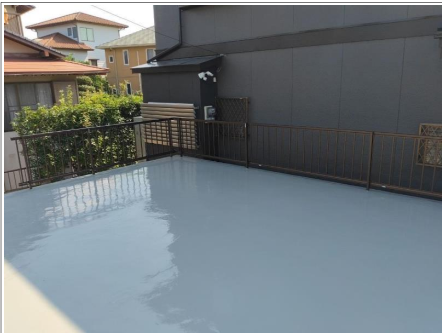
車庫上フェンス取り付け工事
