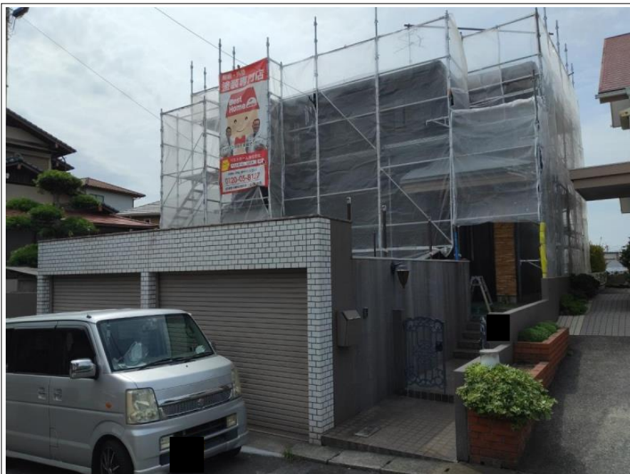
足場組立 完了
