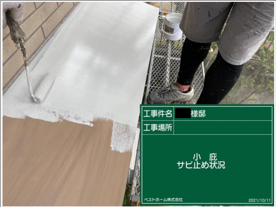
工事件名 様邸 工事場所 小 庇 サビ止め状況 ベストホーム株式会社 2021/10/11
