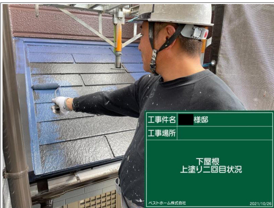
工事件名 ■ 様邸 工事場所 屋根 上塗り二回目完了 ベストホーム株式会社 2021/10/25
