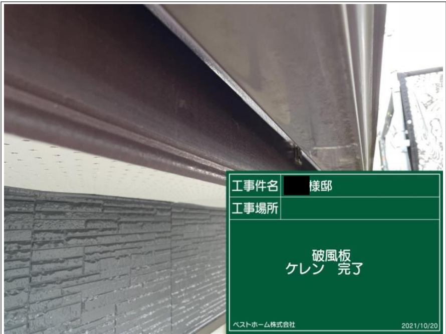
工事件名 様邸 工事場所 破風板 ケレン 状況 ベストホーム株式会社 2021/10/20
