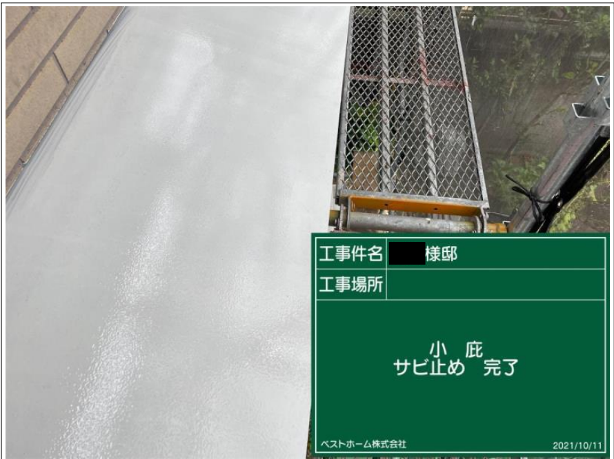
工事件名 様邸 工事場所 小 庇 サビ止め状況 ベストホーム株式会社 2021/10/11
