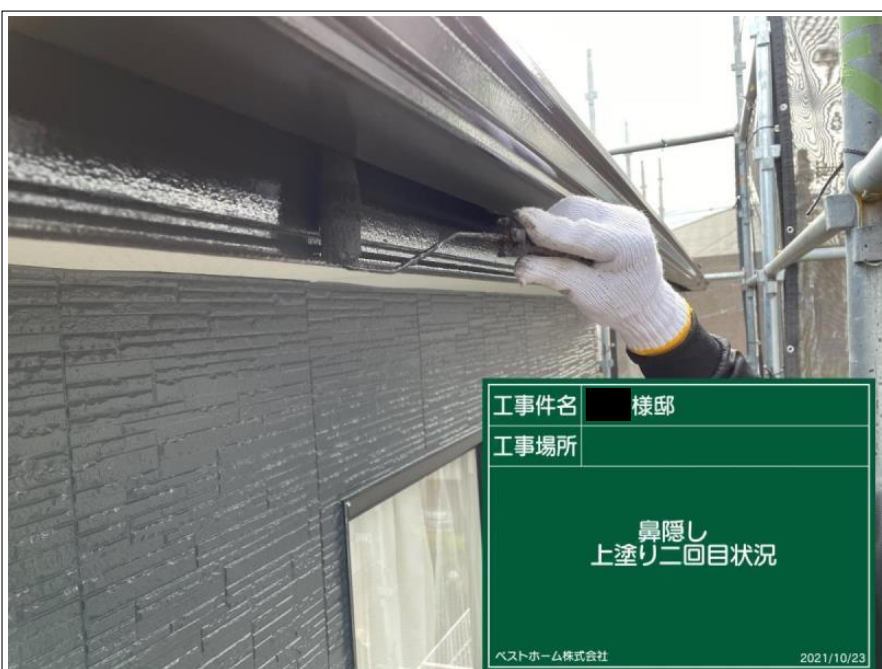
工事件名 様邸 工事場所 鼻隠し 上塗り二回目状況 ベストホーム株式会社 2021/10/23
