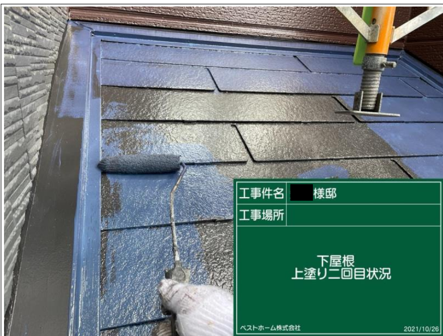
工事件名 ■ 様邸 工事場所 下屋根 上塗り二回目状況 ベストホーム株式会社 2021/10/26
