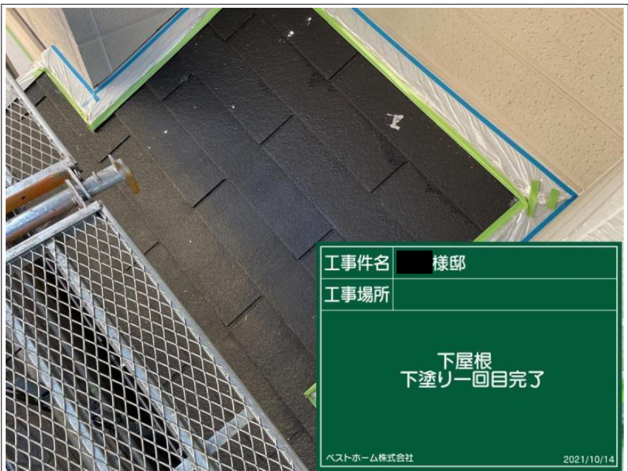
工事件名 様邸 工事場所 下屋根 下塗り一回目完了 ベストホーム株式会社 2021/10/14
