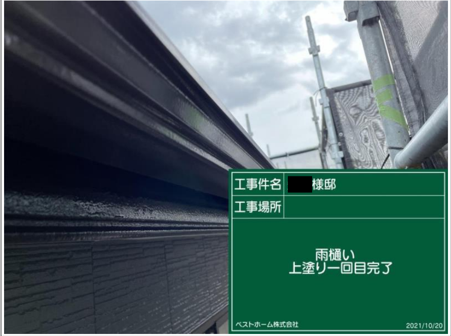
工事件名 様邸 工事場所 雨樋い 上塗り一回目状況 ベストホーム株式会社 2021/10/20
