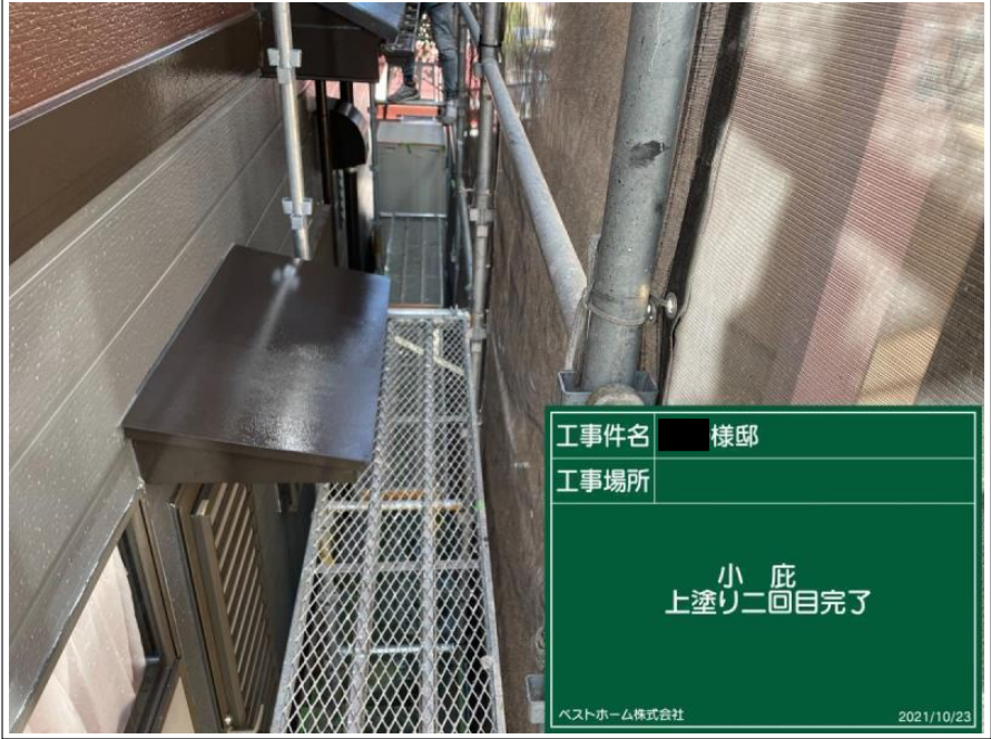
工事件名 様邸 工事場所 小 庇 上塗り二回目完了 ベストホーム株式会社 2021/10/23
