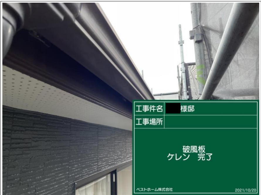
工事件名 様邸 工事場所 破風板 ケレン 完了 ベストホーム株式会社 2021/10/20
