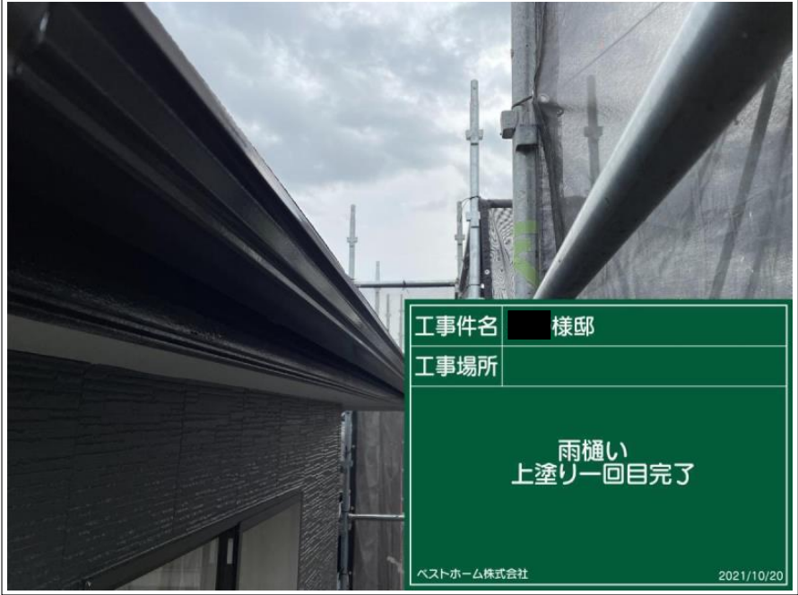
工事件名 様邸 工事場所 雨樋い 上塗り一回目完了 ベストホーム株式会社 2021/10/20
