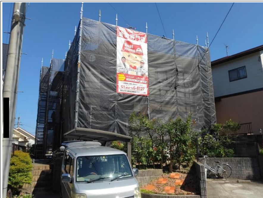
足場組立 完了
