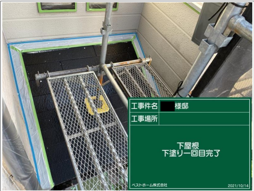
工事件名 様邸 工事場所 下屋根 下塗り一回目状況 ベストホーム株式会社 2021/10/14
