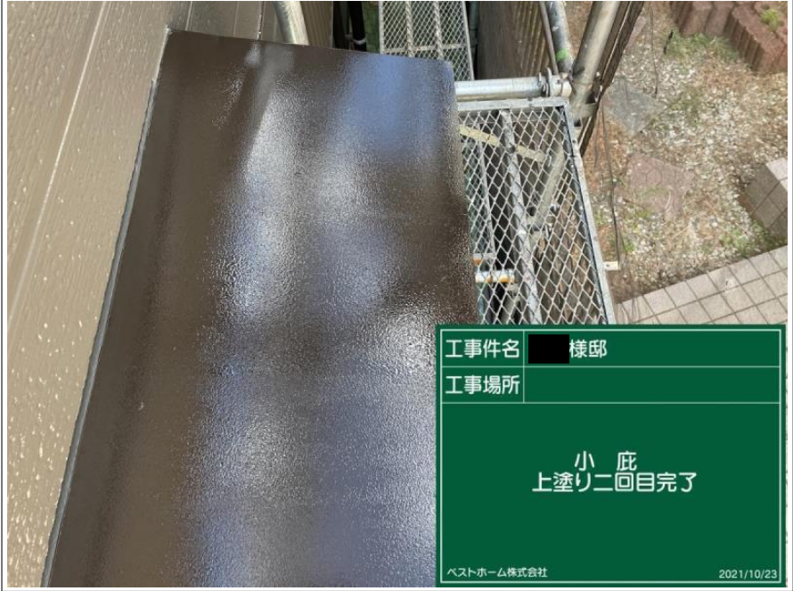
工事件名 様邸 工事場所 小 庇 上塗り二回目状況 ベストホーム株式会社 2021/10/23
