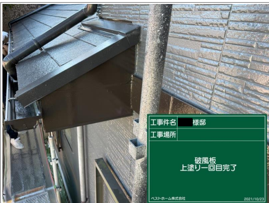
工事件名 様邸 工事場所 破風板 上塗り一回目完了 ベストホーム株式会社 2021/10/23
