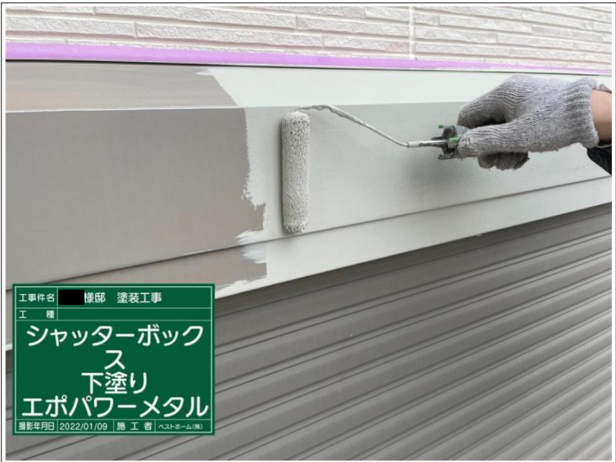
工事件名 棟邸 塗装工事 工種 シャッターボック ス 下塗り エポパワーメタル 撮影年月日 2022/01/09 施工者 ベストホーム(株)
