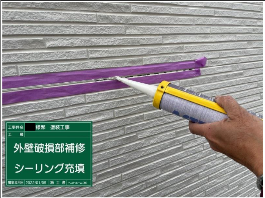
工事件名 様邸 塗装工事 工 種 外壁破損部補修 シーリング充填 撮影年月日 2022/01/09 施 工 者 ヘストホーム(株)
