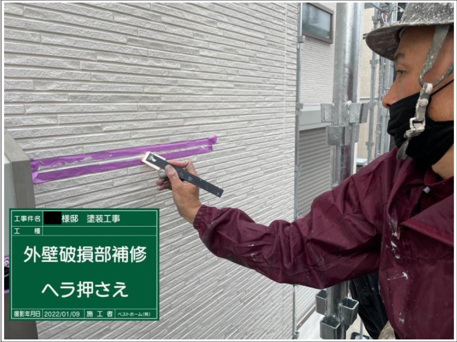
工事件名 様邸 塗装工事 工 種 外壁破損部補修 シーリング充填 撮影年月日 2022/01/09 施 工 者 ヘストホーム(株)
