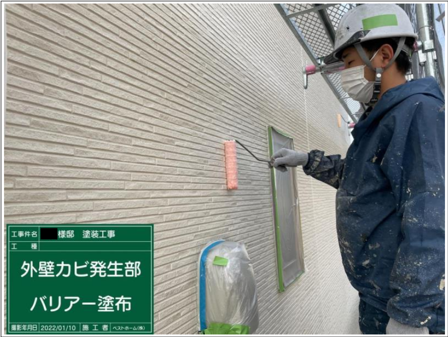
工事件名 様邸 塗装工事 工種 外壁カビ発生部 バリアー塗布完了 撮影年月日 2022/01/10 施工者 ベストホーム(株)
