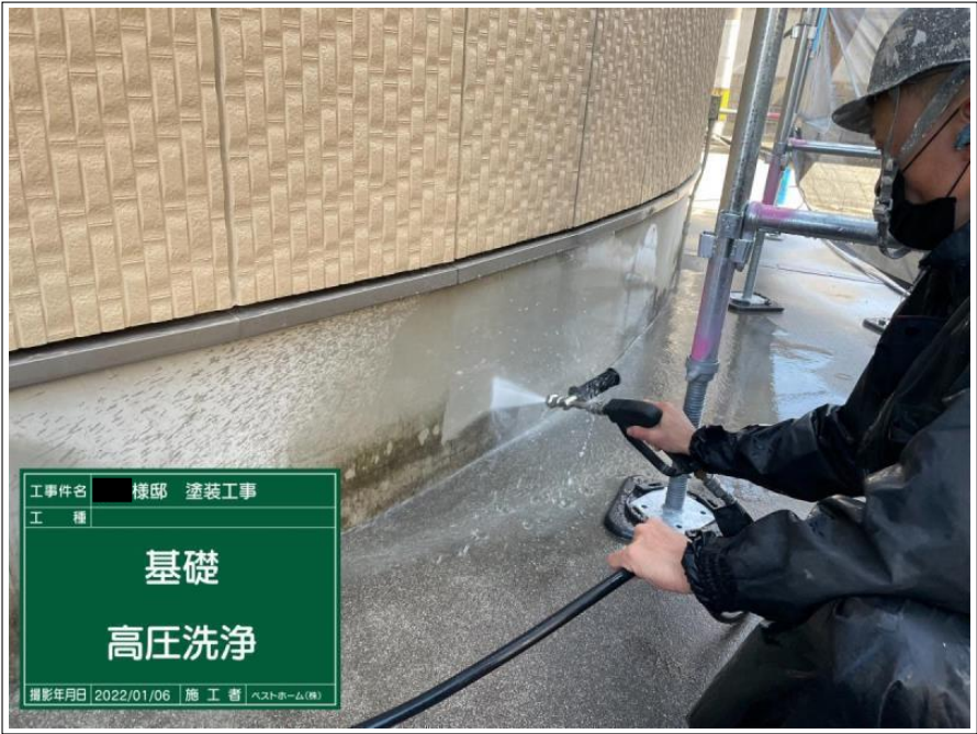
工事件名 様邸 塗装工事 工 種 水切 高圧洗浄 撮影年月日 2022/01/06 施 工 者 ベストホーム(株)
