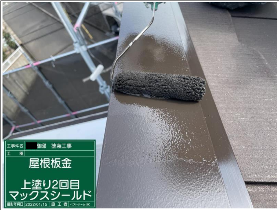
工事件名 棟邸 塗装工事 工 種 屋根板金 屋根板金 上塗り2回目 マックスシールド 撮影年月日 2022/01/15 施 工 者 ベストホーム(株)
