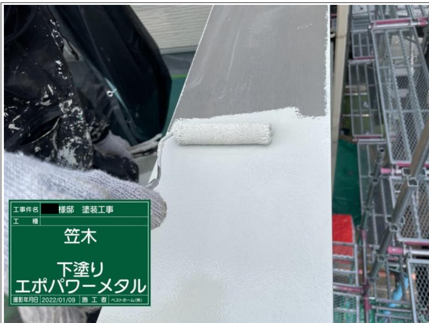
工事件名 棟邸 塗装工事 工 種 笠木 下塗り エポパワーメタル 撮影年月日 2022/01/09 施 工 者 ベストホーム(株)
