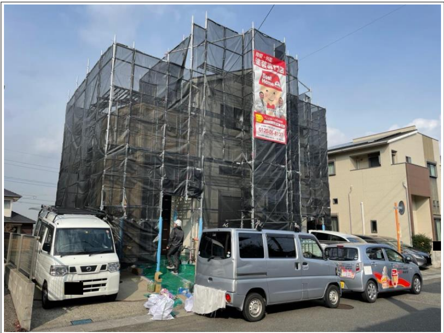
足場組立 完了
