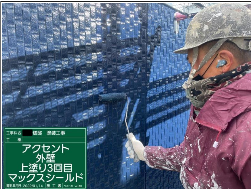
工事件名 棟邸 塗装工事 工 種 西面アクセント 外壁 上塗り2回目完了 マックスシールド 撮影年月日 2022/01/14 施 工 者 ベストホーム(株)
