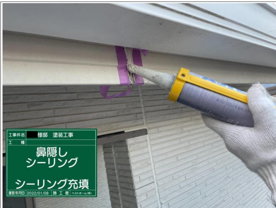
工事件名 棟邸 塗装工事 工種 鼻隠し シーリング シーリング充填 撮影年月日 2022/01/08 施工者 ハストホーム(株)
