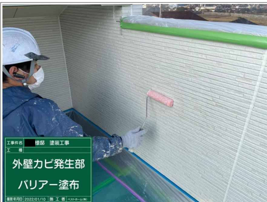
工事件名 棟邸 塗装工事 工種 外壁カビ発生部 バリアー塗布完了 撮影年月日 2022/01/10 施工者 ペストホーム(株)
