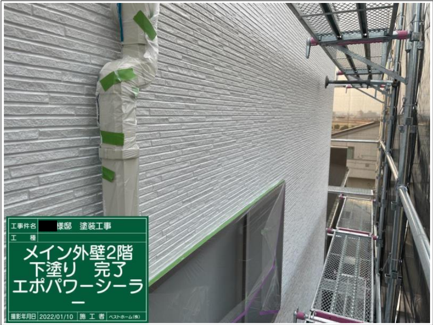
工事件名 棟邸 塗装工事 工種 メイン外壁2階 下塗り エポパワーシーラ — 撮影年月日 2022/01/10 施工者 ベストホーム(株)
