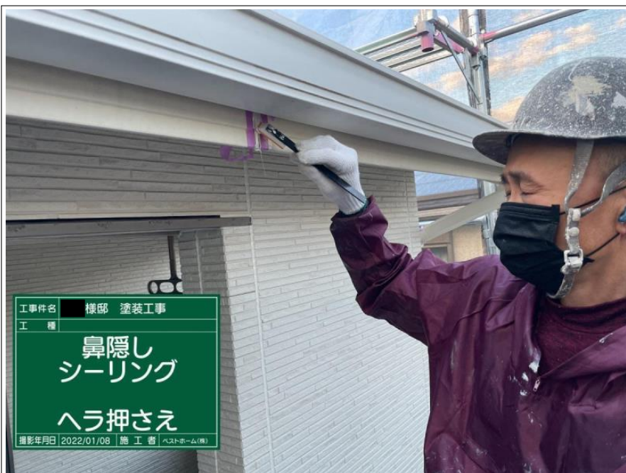
工事件名 棟邸 塗装工事 工種 鼻隠し シーリング シーリング充填 撮影年月日 2022/01/08 施工者 ハストホーム(株)
