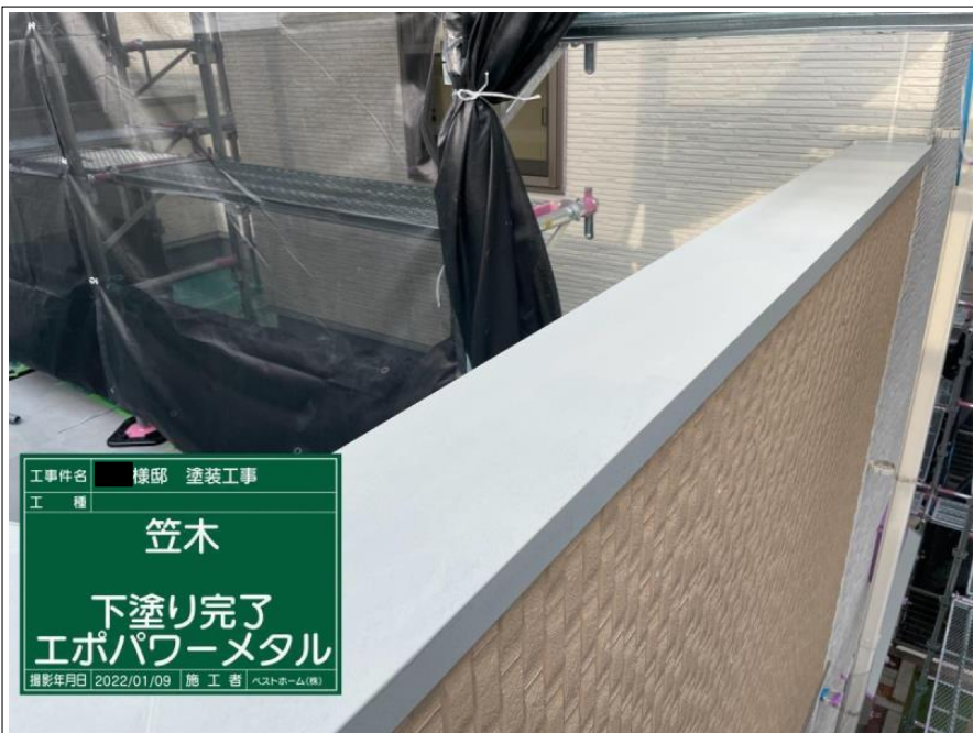
工事件名 棟邸 塗装工事 工 種 笠木 下塗り エポパワーメタル 撮影年月日 2022/01/09 施 工 者 ベストホーム(株)
