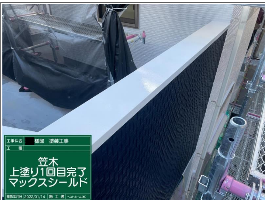
工事件名 様邸 塗装工事 工 種 笠木 上塗り1回目 マックスシールド 撮影年月日 2022/01/14 施 工 者 ベストホーム(株)
