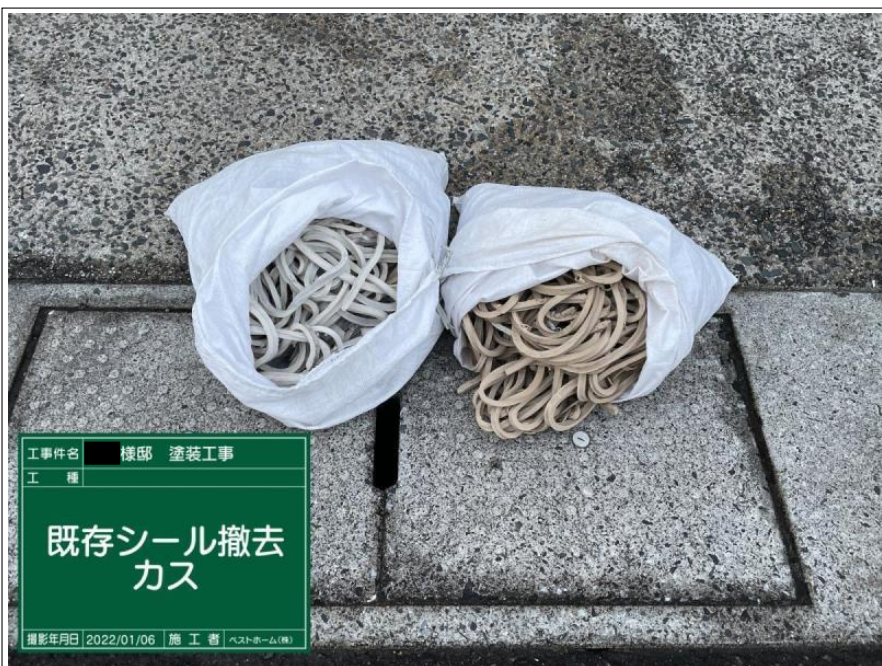
工事件名 様邸 塗装工事 工 種 ボード目地 シーリング 既存シール撤去 完了 撮影年月日 2022/01/06 施 工 者 ベストホーム(株)
