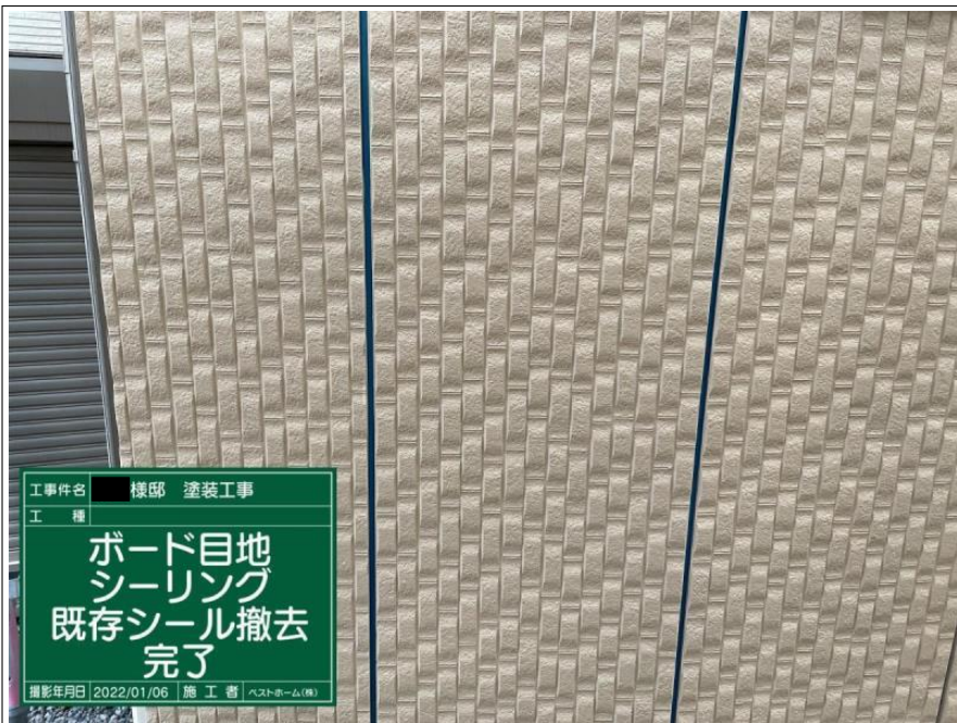
工事件名 様邸 塗装工事 工 種 ボード目地 シーリング 既存シール撤去 撮影年月日 2022/01/06 施 工 者 ベストホーム(株)
