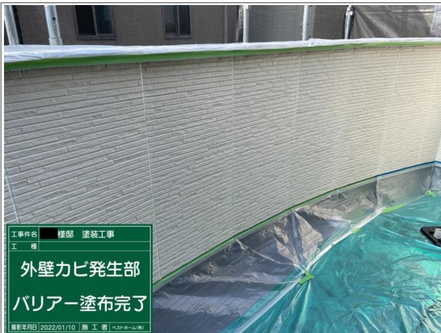
工事件名 棟邸 塗装工事 工種 外壁カビ発生部 バリアー塗布 撮影年月日 2022/01/10 施工者 ペストホーム(株)
