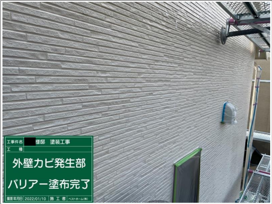
工事件名 様邸 塗装工事 工種 外壁カビ発生部 バリアー塗布 撮影年月日 2022/01/10 施工者 ベストホーム(株)
