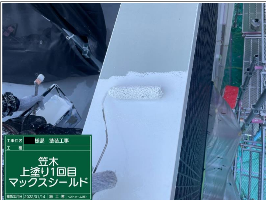
工事件名 様邸 塗装工事 工 種 笠木 上塗り1回目 マックスシールド 撮影年月日 2022/01/14 施 工 者 ベストホーム(株)
