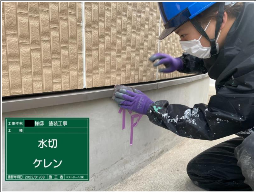
工事件名 棟邸 塗装工事 工 種 水切 着工前 撮影年月日 2022/01/06 施 工 者 ベストホーム(株)
