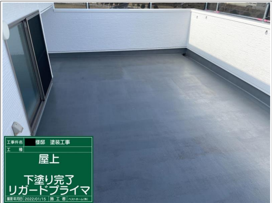
工事件名 様邸 塗装工事 工 種 屋上 下塗り リガードプライマ 撮影年月日 2022/01/15 施 工 者 ベストホーム(株)
