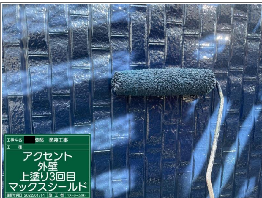
工事件名 棟邸 塗装工事 工 種 アクセント 外壁 上塗り3回目 マックスシールド 撮影年月日 2022/01/14 施 工 者 ベストホーム(株)
