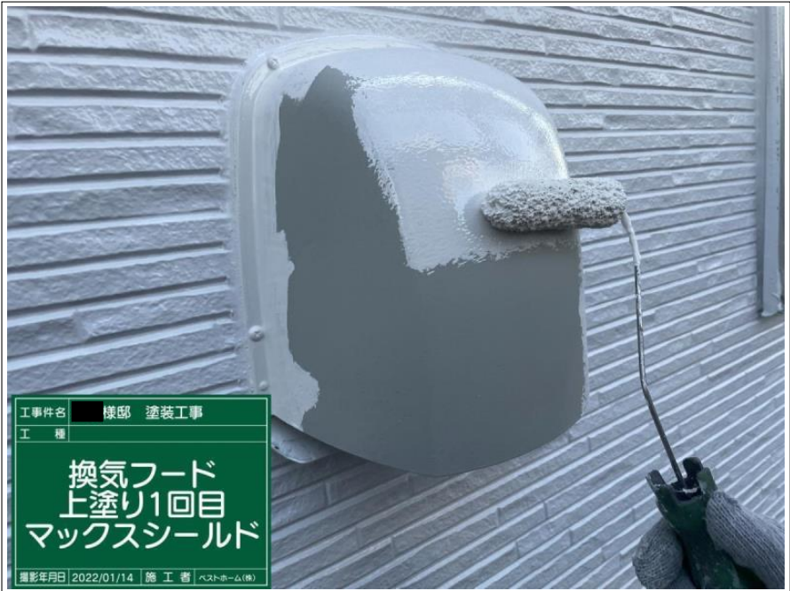
工事件名 様邸 塗装工事 工 種 換気フード 上塗り1回目 マックスシールド 撮影年月日 2022/01/14 施 工 者 ベストホーム(株)
