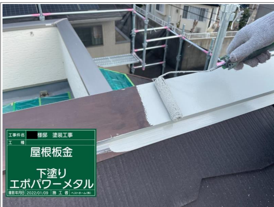
工事件名 棟邸 塗装工事 工 種 屋根板金 下塗り エポパワーメタル 撮影年月日 2022/01/09 施 工 者 ヘストホーム(株)
