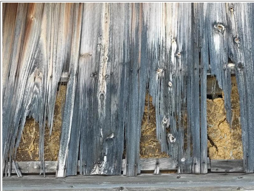
外壁 一部張り替え工事
