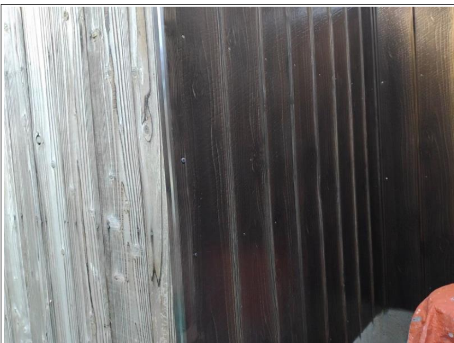
外壁 一部張り替え工事
