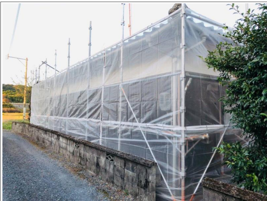
足場組立 完了
