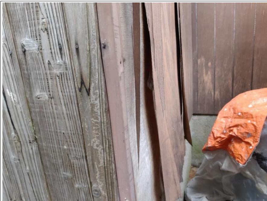
外壁 一部張り替え工事
