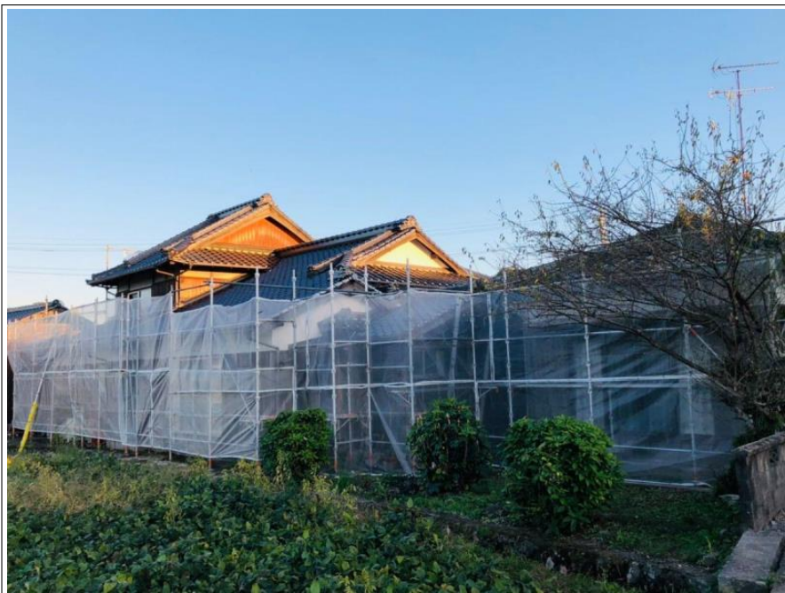
足場組立 完了
