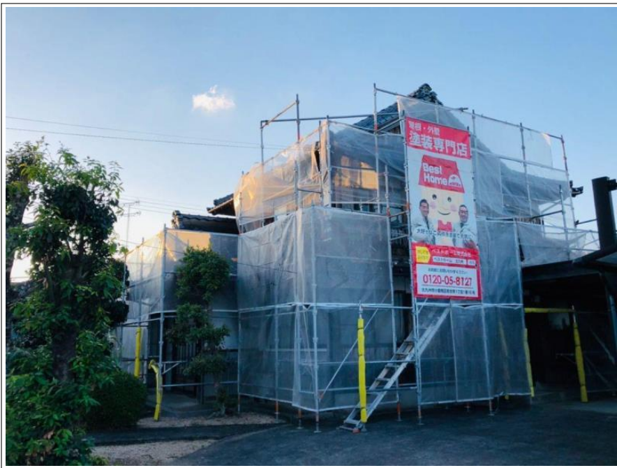
足場組立 完了
