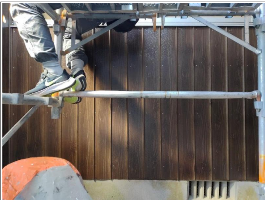
外壁 一部張り替え工事
