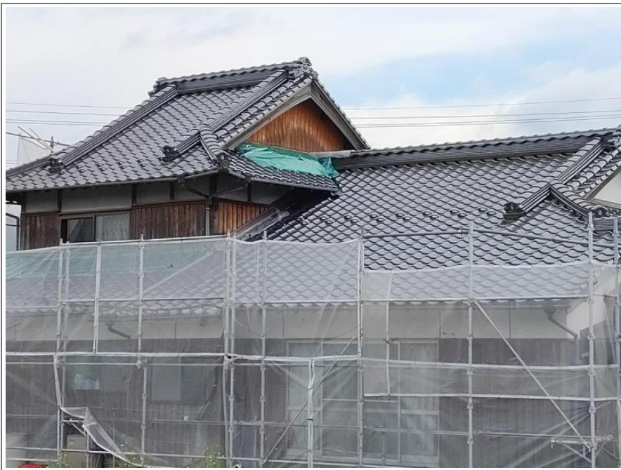
足場組立 完了
