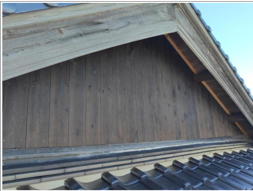
外壁 一部張り替え工事
