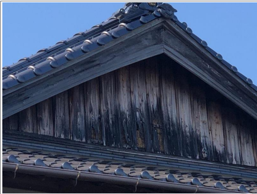
外壁 一部張り替え工事
