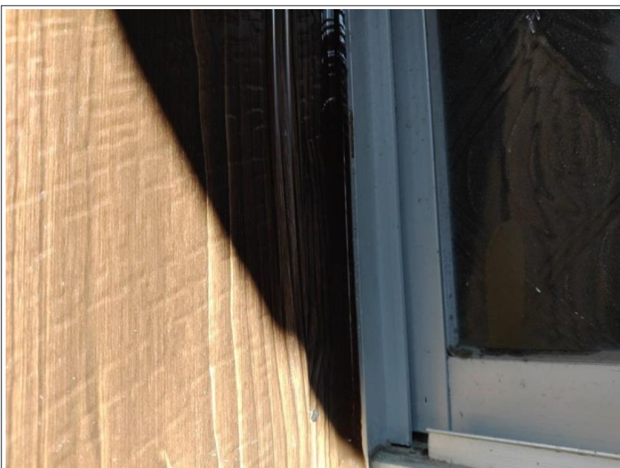
外壁 一部張り替え工事
