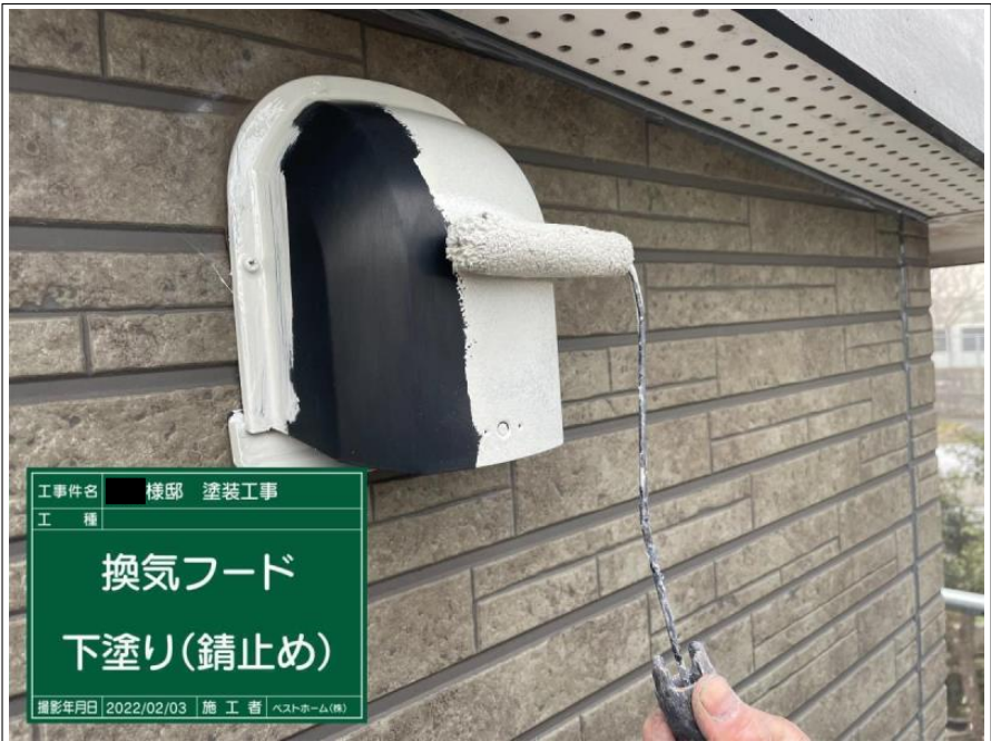
工事件名 ■ 様邸 塗装工事 工 種 換気フード 下塗り(錆止め) 撮影年月日 2022/02/03 施 工 者 ベストホーム(株)
