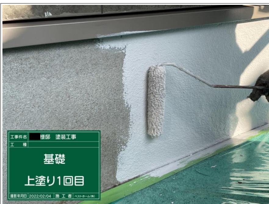
工事件名 様邸 塗装工事 工 種 基礎 上塗り1回目 撮影年月日 2022/02/04 施 工 者 ベストホーム(株)
