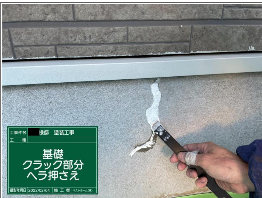
工事件名 ■ 様邸 塗装工事 工 種 基礎 クラック部分 ヘラ押さえ 撮影年月日 2022/02/04 施 工 者 ベストホーム(株)
