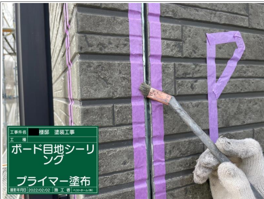
工事件名 様邸 塗装工事 工種 ボード目地シーリング プライマー塗布 撮影年月日 2022/02/02 施工者 ヘストホーム(株)
