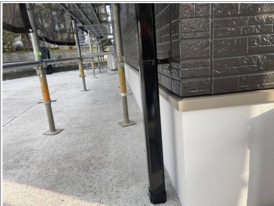
樋・ダクトカバー交換工事
