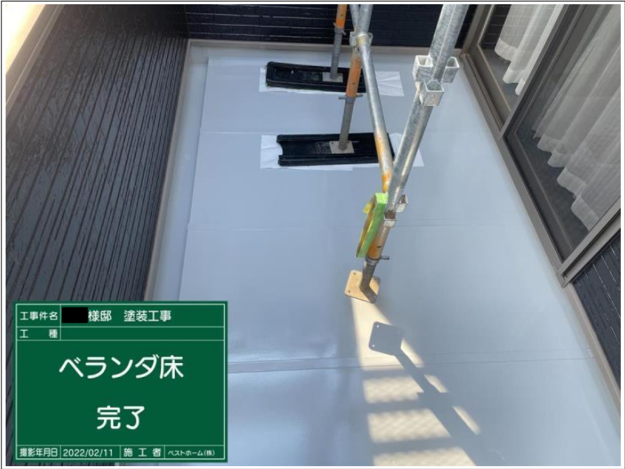
工事件名 様邸 塗装工事 工 種 ベランダ床 トップコート塗り 撮影年月日 2022/02/11 施 工 者 ベストホーム(株)
