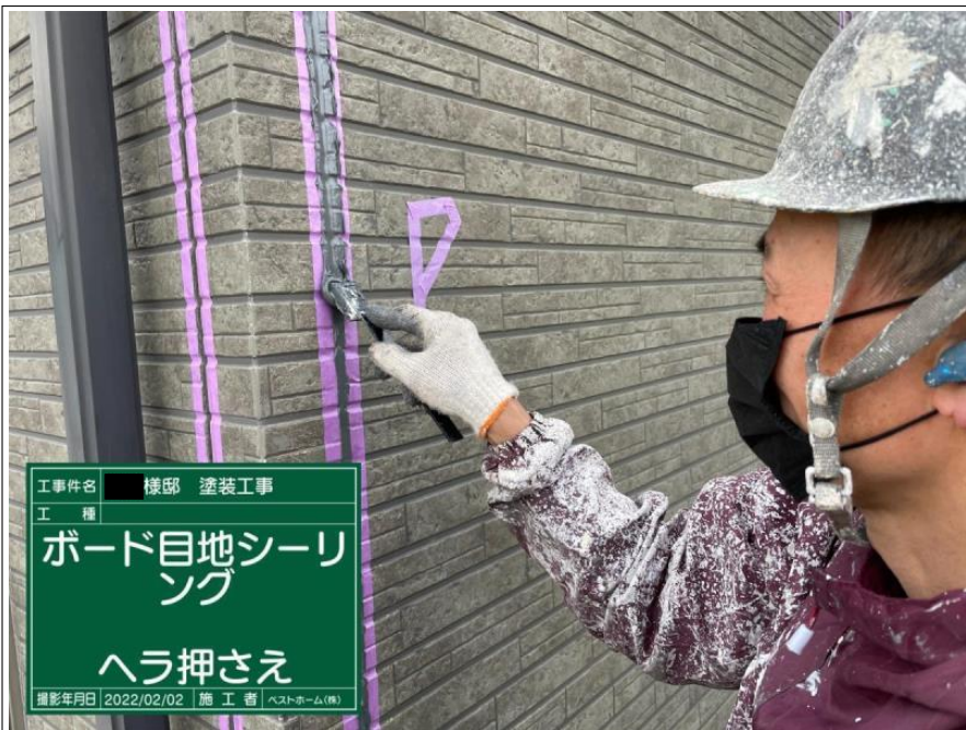
工事件名 様邸 塗装工事 工種 ボード目地シーリング シーリング充填 撮影年月日 2022/02/02 施工者 ヘストホーム(株)
