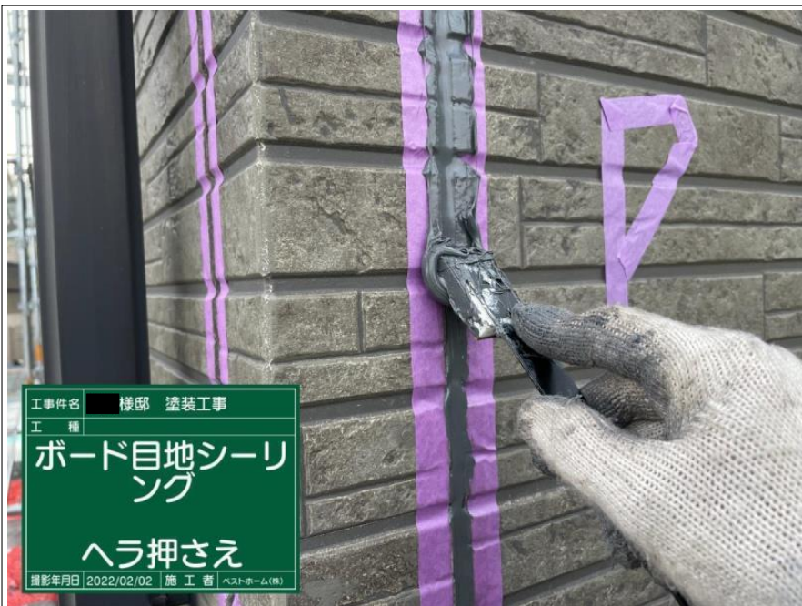
工事件名 様邸 塗装工事 工種 ボード目地シーリング ヘラ押さえ 撮影年月日 2022/02/02 施工者 ヘストホーム(株)
