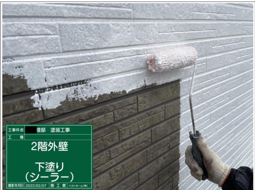
工事件名 様邸 塗装工事 工種 2階外壁 下塗り (シーラー) 撮影年月日 2022/02/07 施工者 ベストホーム(株)
