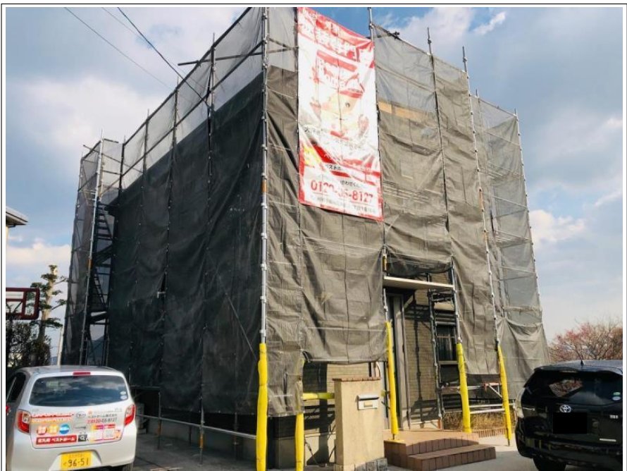
足場組立 完了
