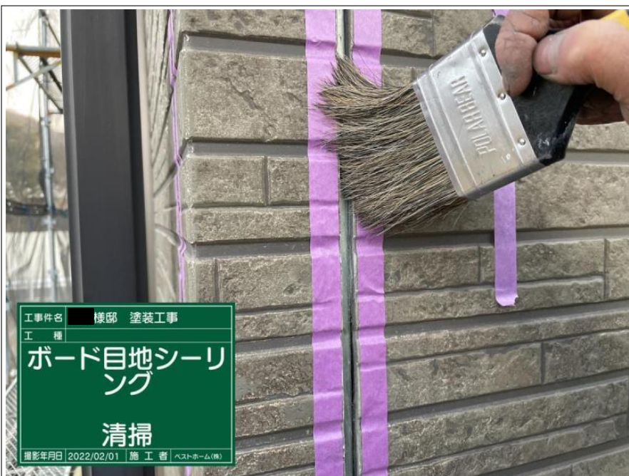
工事件名 様邸 塗装工事 工種 ボード目地シーリ ング 清掃 撮影年月日 2022/02/01 施工者 ベストホーム(株)
