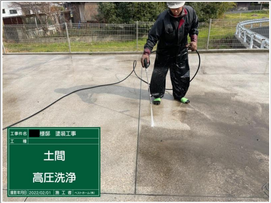
工事件名 ■ 様邸 塗装工事 工 種 塀 高圧洗浄 撮影年月日 2022/02/01 施 工 者 ヘストホーム(株)
