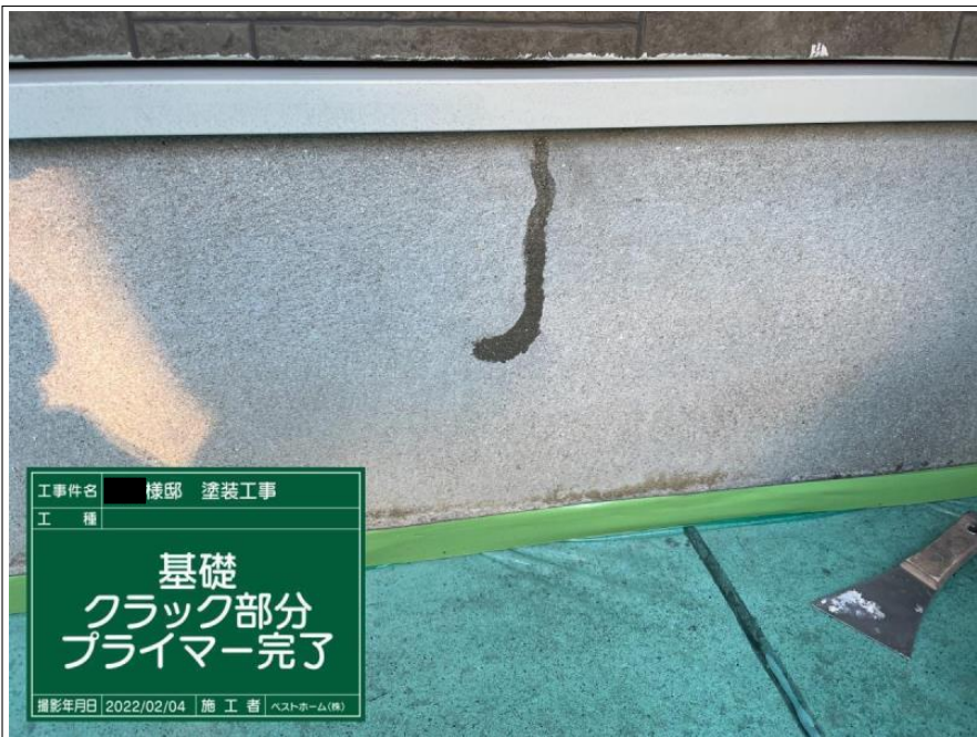
工事件名 様邸 塗装工事 工 種 基礎 クラック部分 プライマー塗布 撮影年月日 2022/02/04 施 工 者 ヘストホーム(株)
