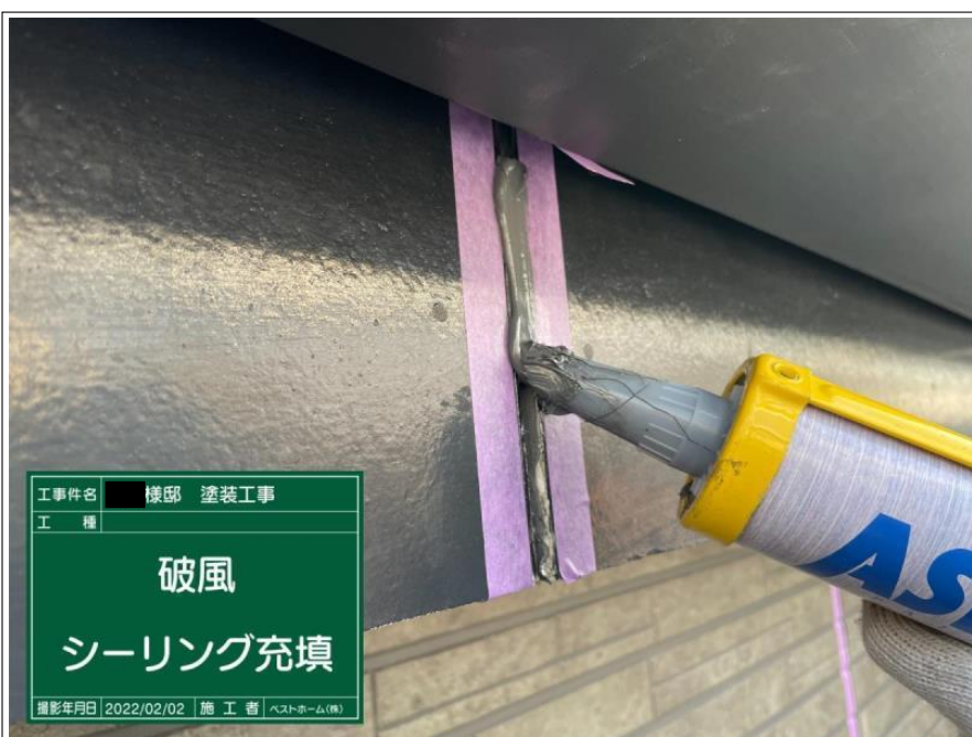
工事件名 様邸 塗装工事 工 種 破風 シーリング充填 撮影年月日 2022/02/02 施 工 者 ヘストホーム(株)
