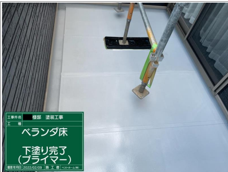
工事件名 様邸 塗装工事 工 種 ベランダ床 下塗り (プライマー) 撮影年月日 2022/02/09 施 工 者 ベストホーム(株)
