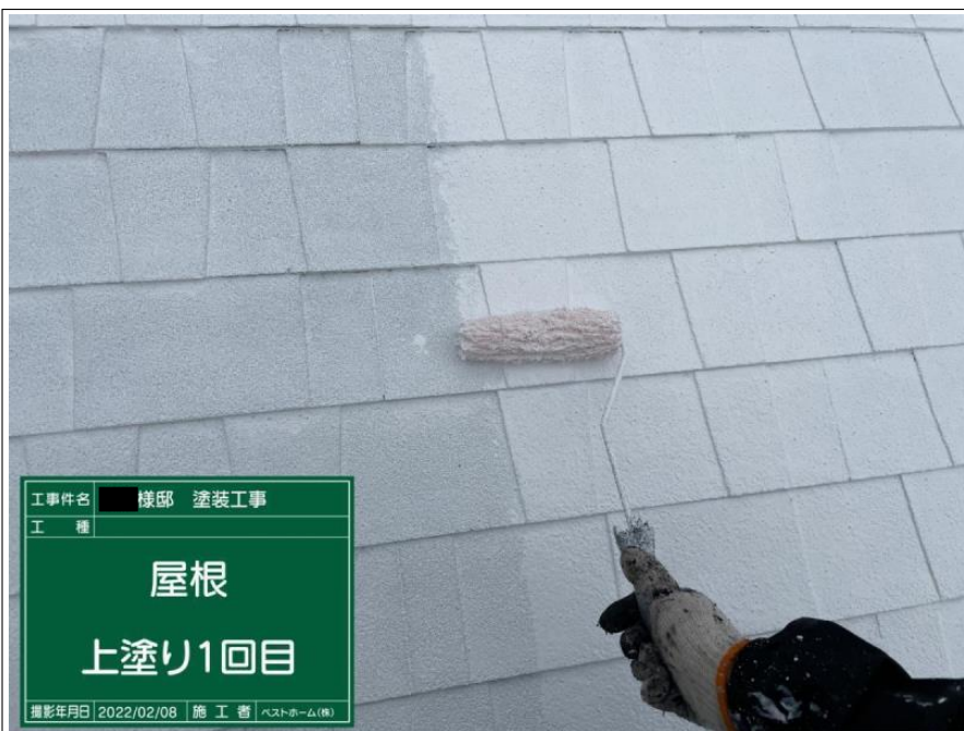
工事件名 様邸 塗装工事 工 種 屋根 上塗り1回目 撮影年月日 2022/02/08 施 工 者 ペストホーム(株)
