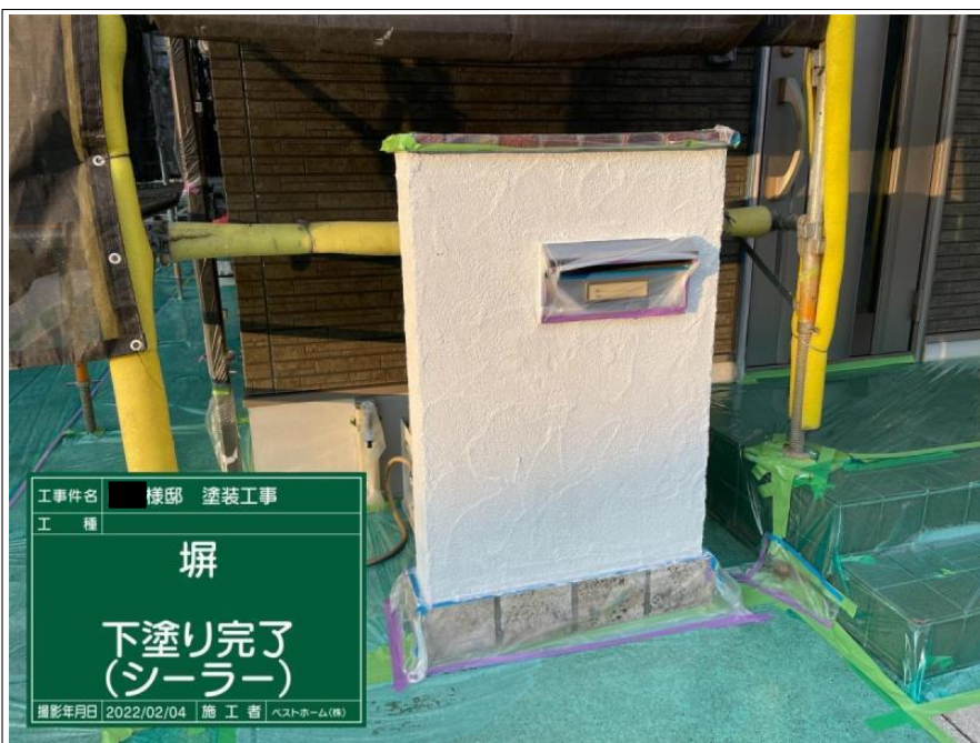
工事件名 様邸 塗装工事 工 種 塀 下塗り (シーラー) 撮影年月日 2022/02/04 施 工 者 ベストホーム(株)
