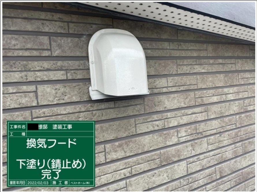
工事件名 ■ 様邸 塗装工事 工 種 換気フード 下塗り(錆止め) 撮影年月日 2022/02/03 施 工 者 ベストホーム(株)
