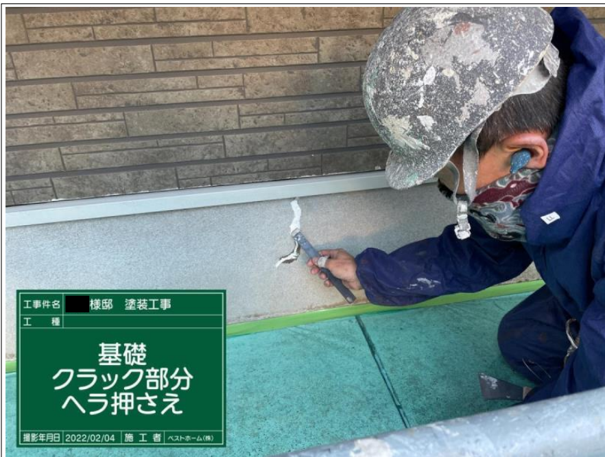
工事件名 ■ 様邸 塗装工事 工 種 基礎 クラック部分 シーリング充填 撮影年月日 2022/02/04 施 工 者 ベストホーム(株)
