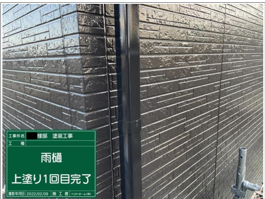
工事件名 様邸 塗装工事 工 種 雨樋 上塗り1回目 撮影年月日 2022/02/09 施 工 者 ベストホーム(株)
