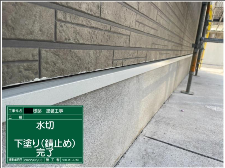
工事件名 様邸 塗装工事 工種 水切 下塗り(錆止め) 撮影年月日 2022/02/03 施工者 ヘストホーム(株)
