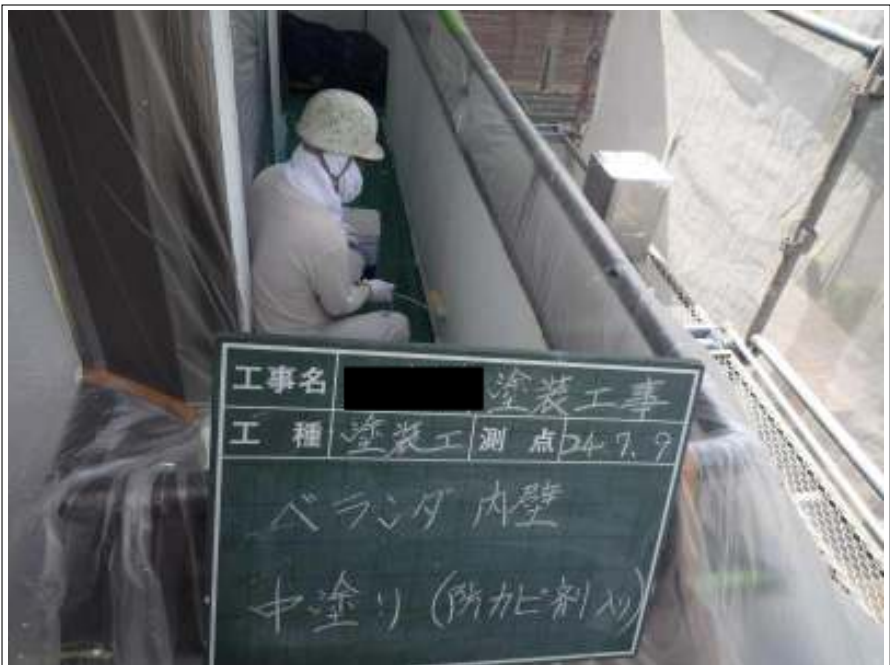
ベランダ内壁中塗り塗装施工中
