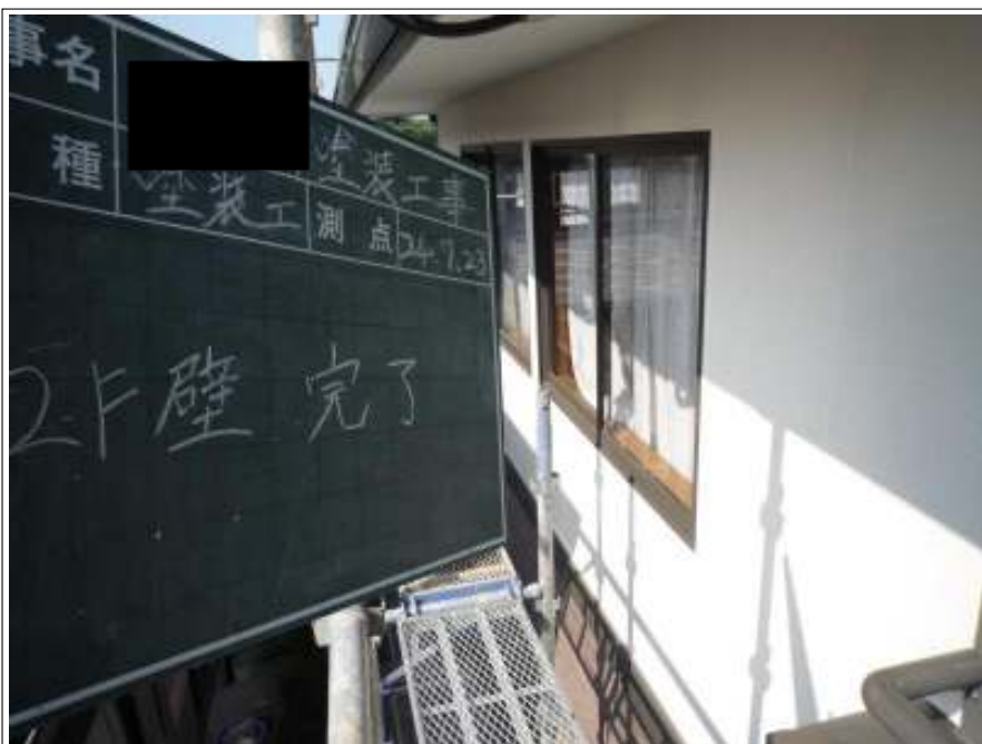
2階外壁上塗り塗装施工後
