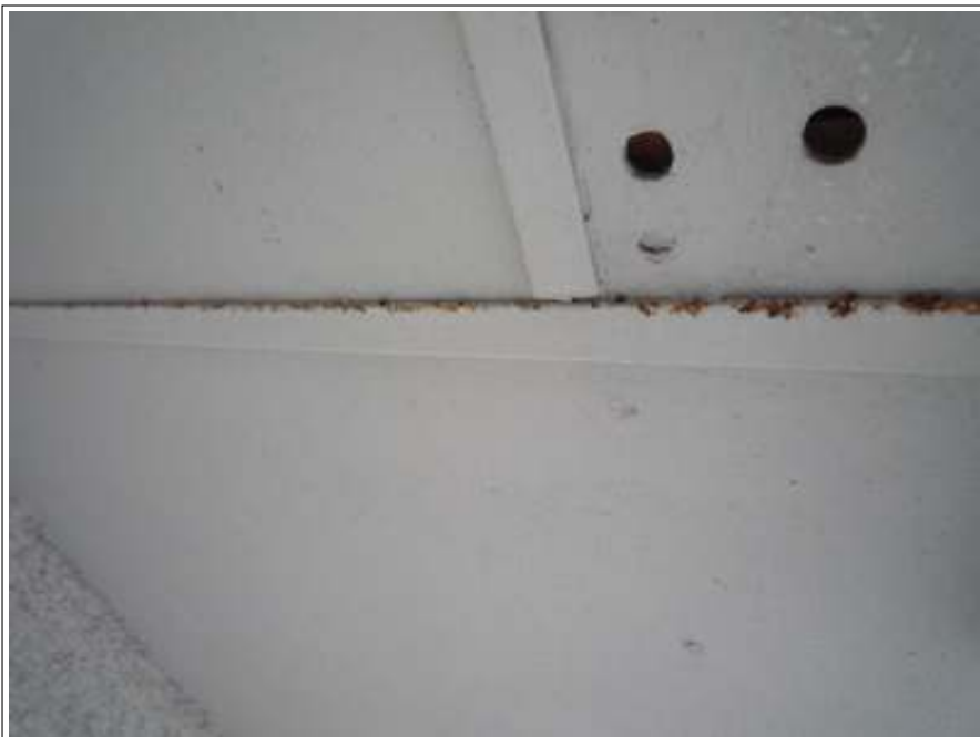
軒天サビ止め塗装前
