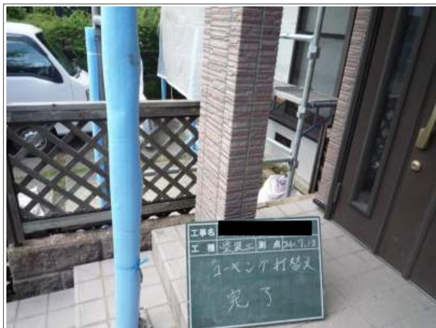
コーキング打替え施工後
