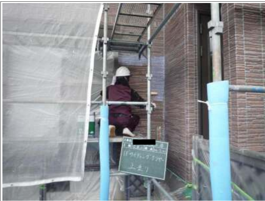
1階外壁クリアー上塗り塗装施工中
