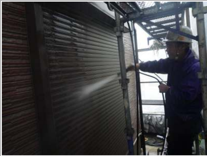
雨戸高圧洗浄状況
