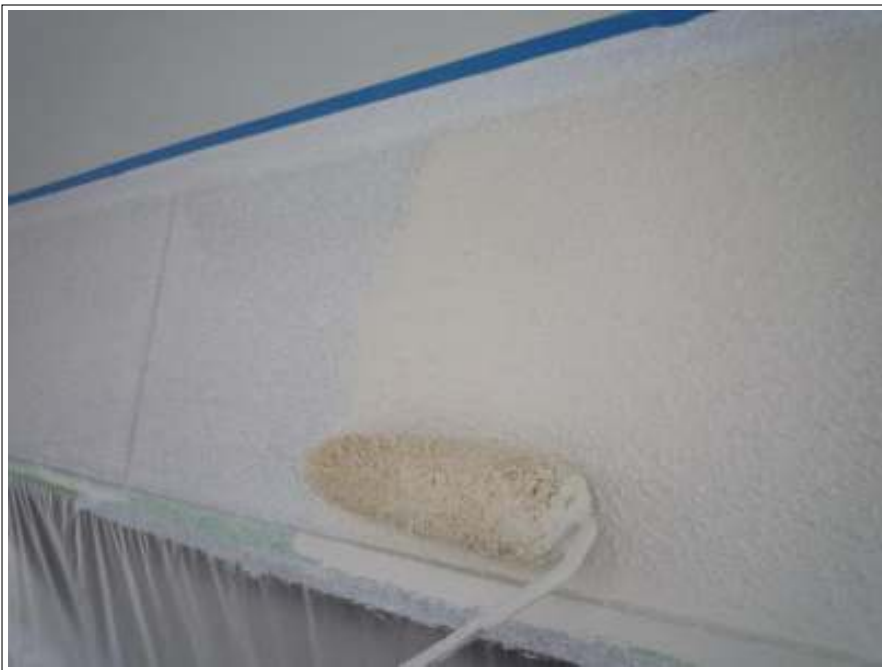
2階外壁中塗り塗装施工状況
