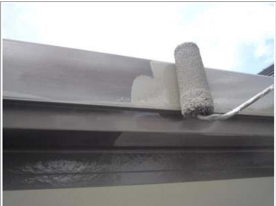
樋・破風板上塗り塗装施工状況
