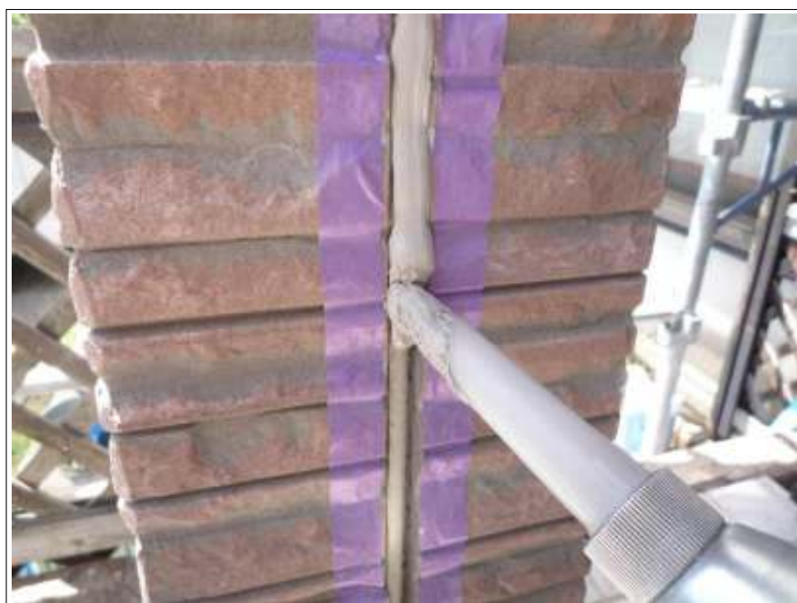
コーキング打替え施工状況
