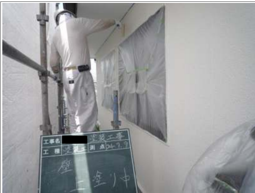
2階外壁上塗り塗装施工中
