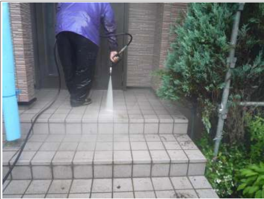
玄関前高圧洗浄状況
