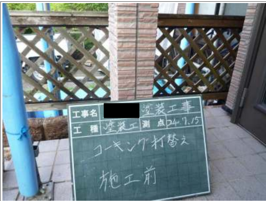
コーキング打替え施工前
