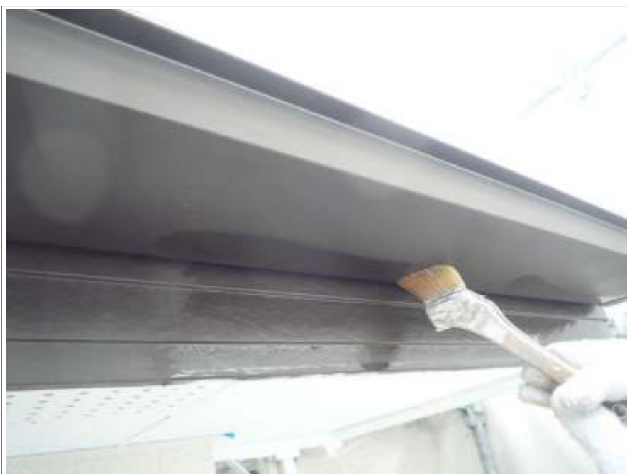
樋・破風板下塗り塗装施工状況
