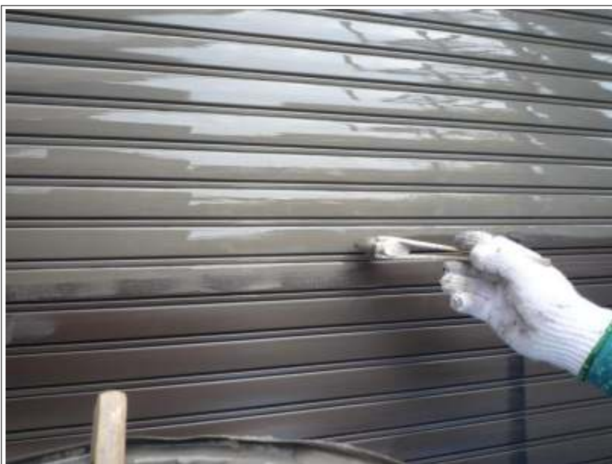
シャッターBOX 上塗り塗装施工状況
