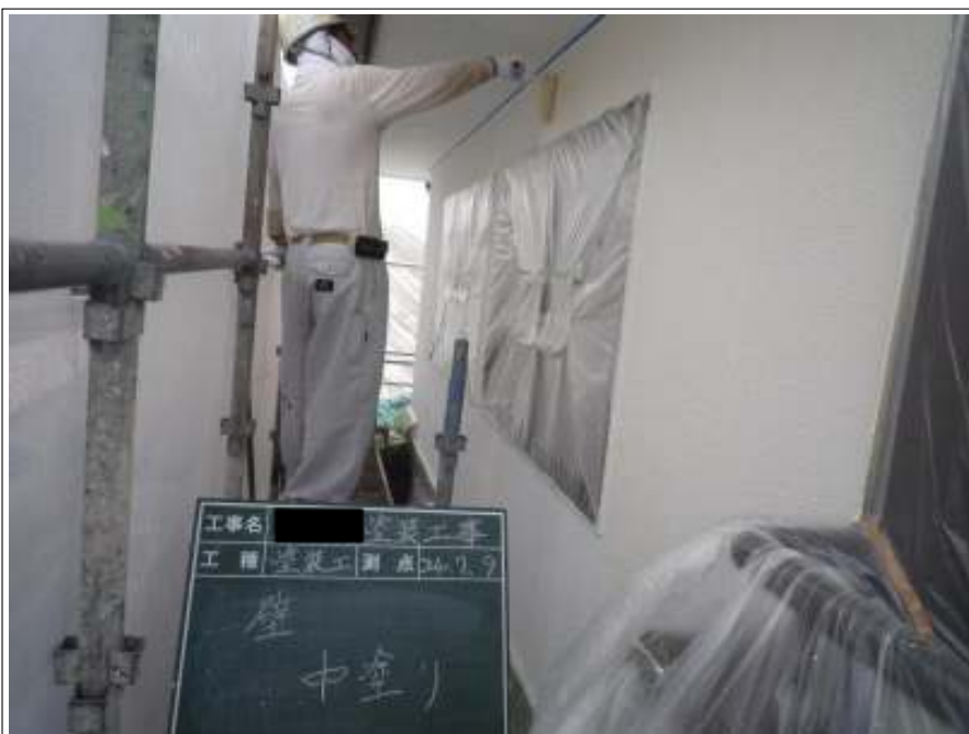
2階外壁中塗り塗装施工中
