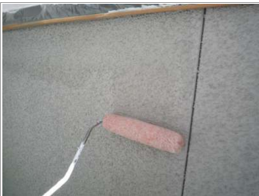
ベランダ内壁バリアー施工状況
