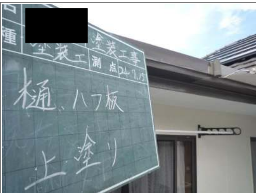
樋・破風板上塗り塗装施工中
