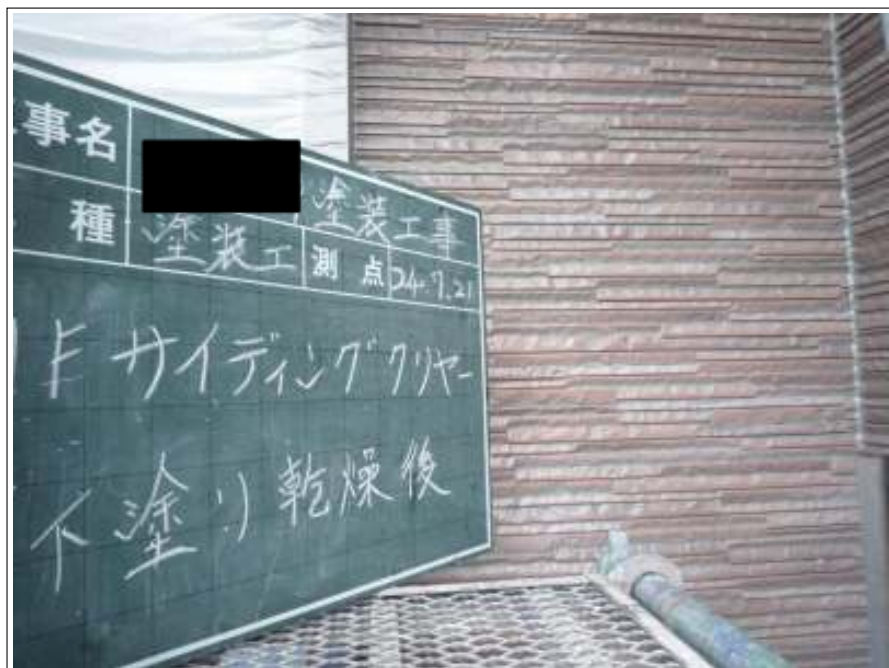
1階外壁クリア-下塗り塗装施工後
