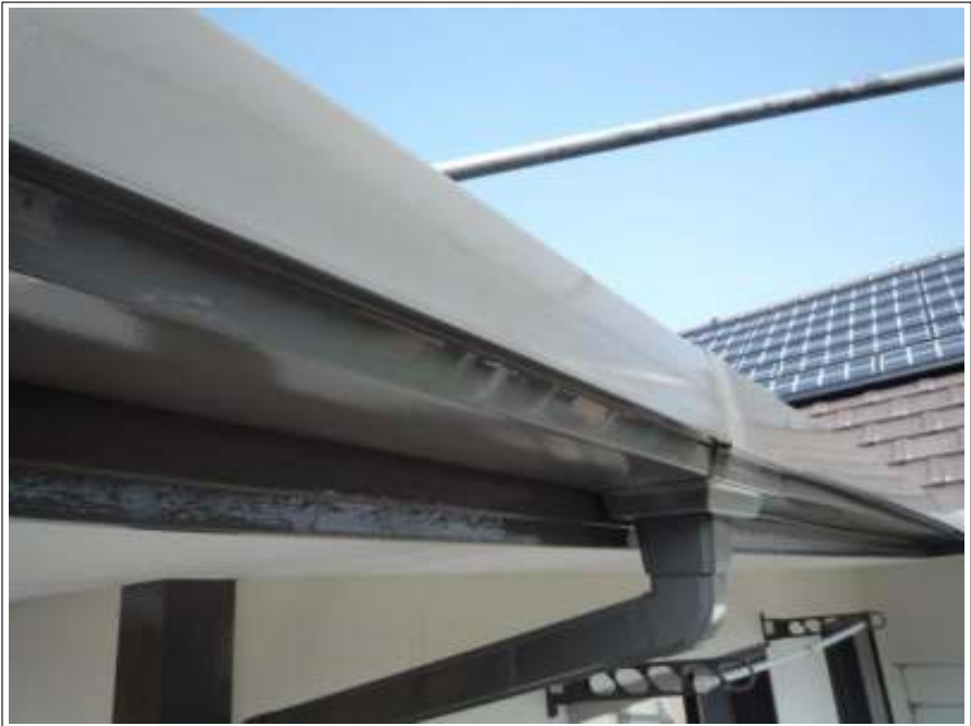
樋・破風板上塗り塗装施工完了
