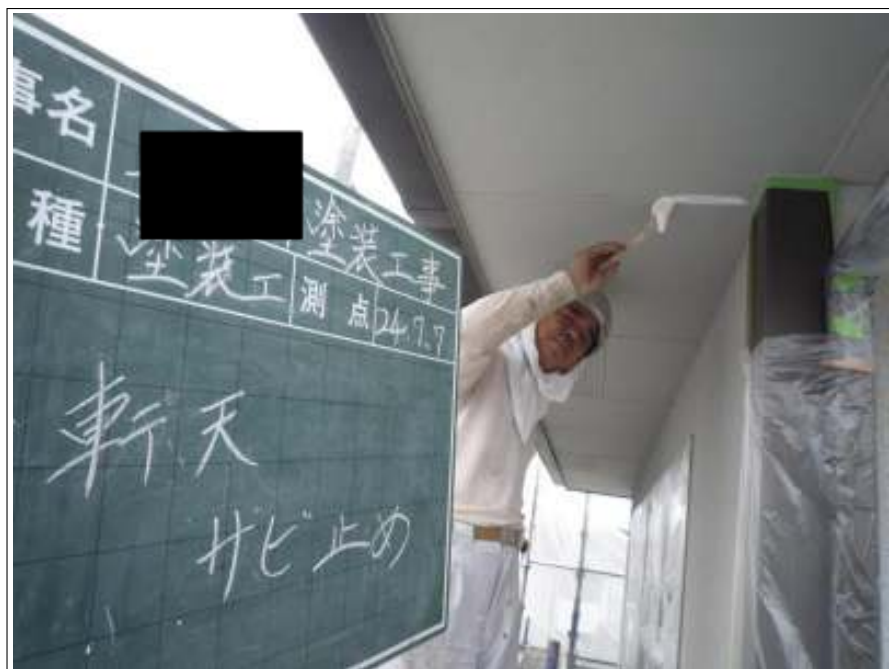
軒天サビ止め塗装施工中
