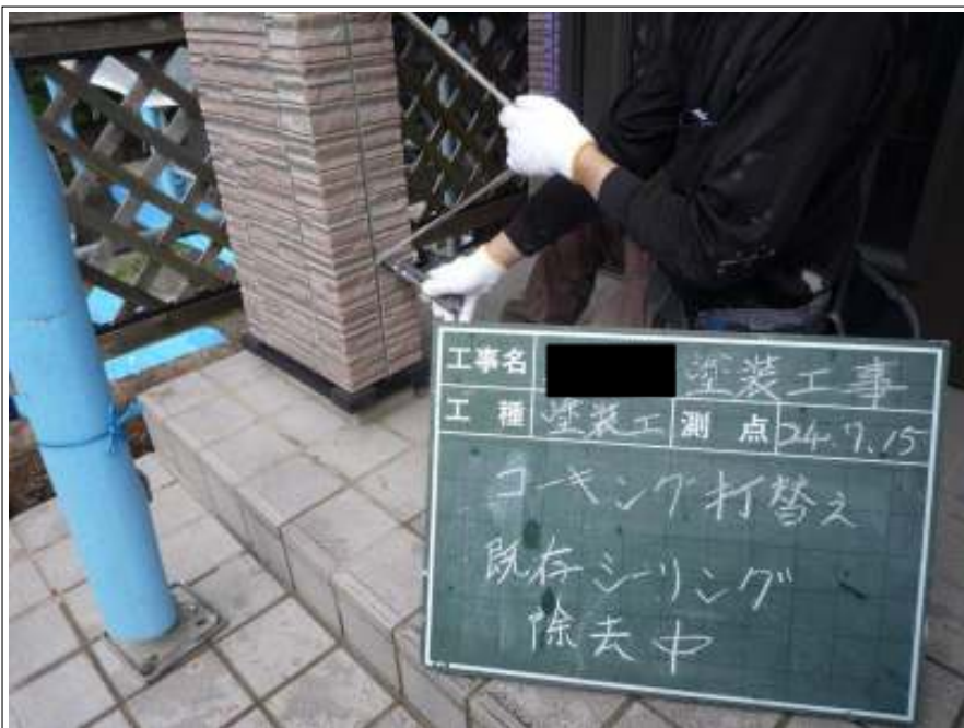
コーキング打替え施工中
