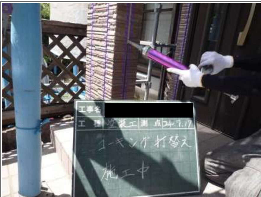
コーキング打替え施工中
