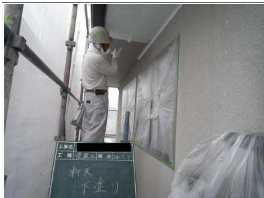
軒天下塗り塗装施工中
