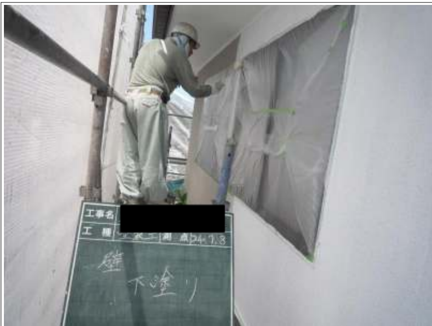
2階外壁下塗り塗装施工中
