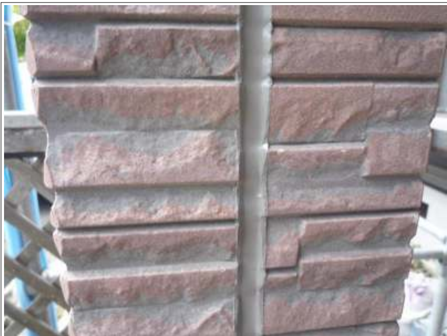
コーキング打替え施工後状況
