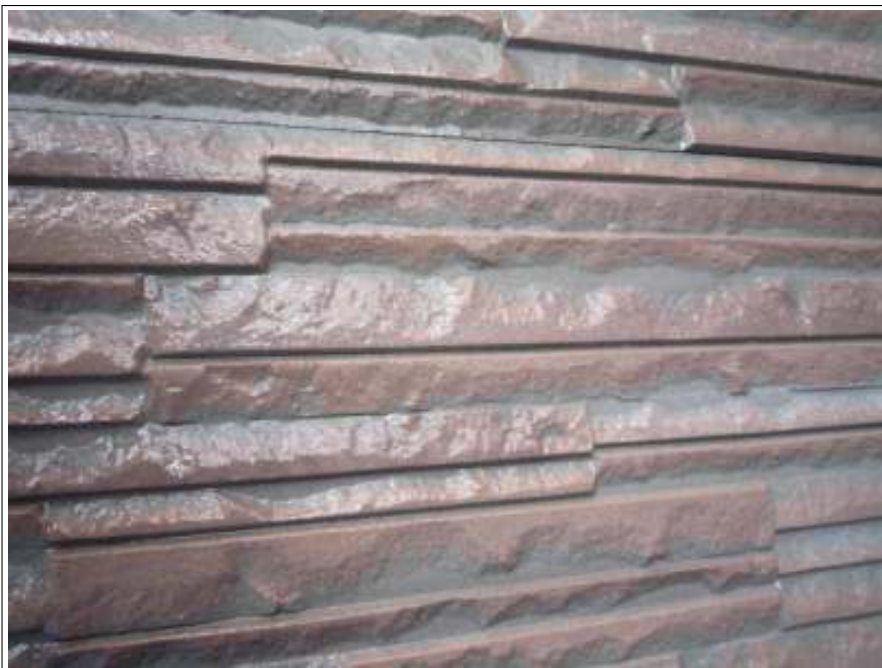
1階外壁クリアー上塗り塗装施工状況
