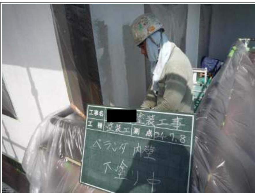
ベランダ内壁下塗り塗装施工中
