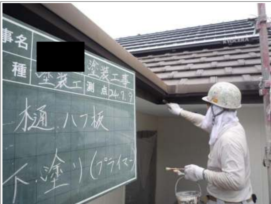
樋・破風板下塗り塗装施工中
