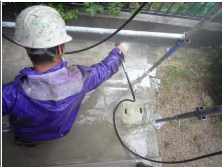
土間高圧洗浄状況
