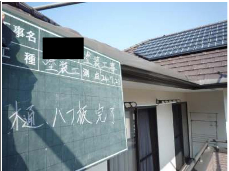
樋・破風板上塗り塗装施工後
