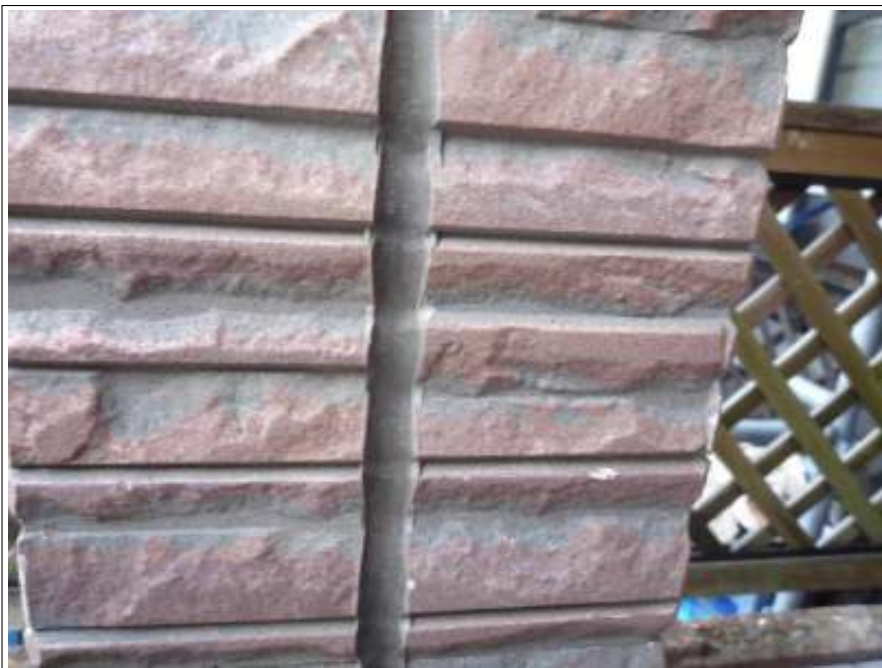
コーキング打替え施工前状況
