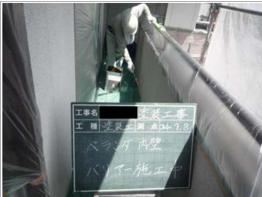
ベランダ内壁バリアー施工中
