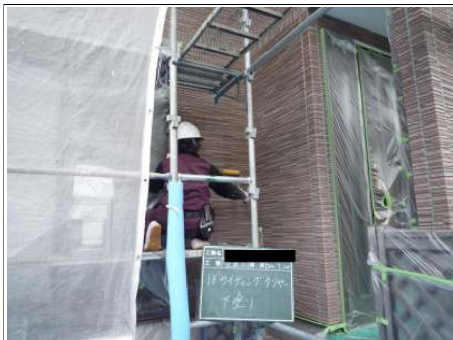
1階外壁クリア-下塗り塗装施工中
