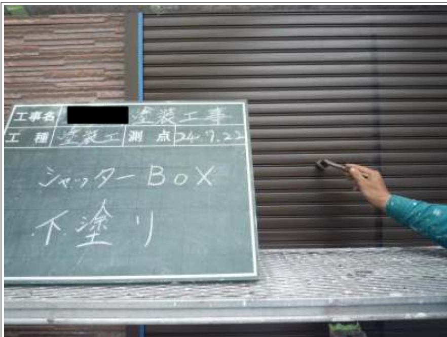
シャッターBOX 下塗り塗装施工中
