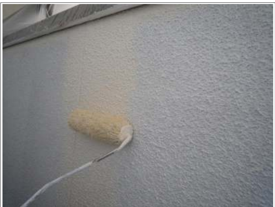
ベランダ内壁中塗り塗装施工状況
