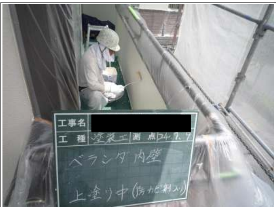
ベランダ内壁上塗り塗装施工中
