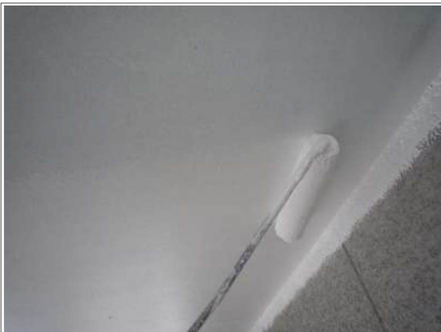
軒天上塗り塗装施工状況
