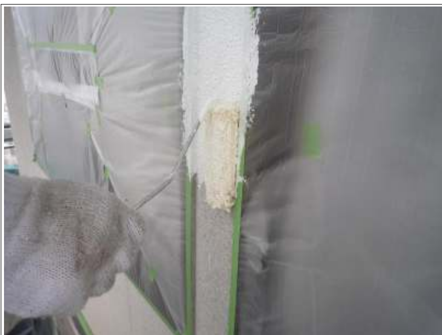
2階外壁下塗り塗装施工状況
