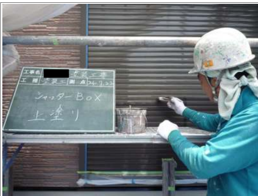
シャッターBOX 上塗り塗装施工中
