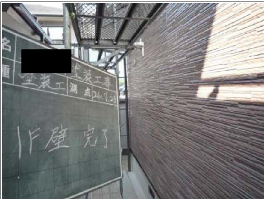
1階外壁クリアー上塗り塗装施工後
