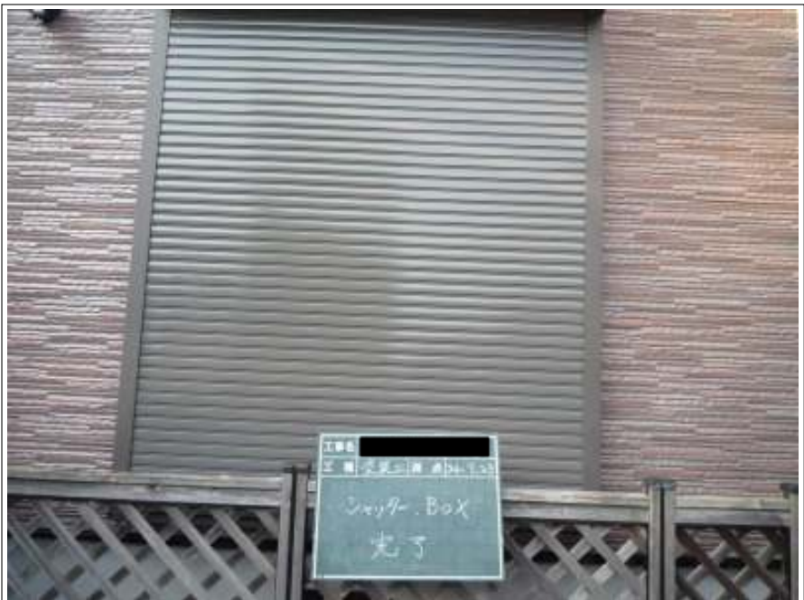
シャッター・BOX 上塗り塗装施工後
