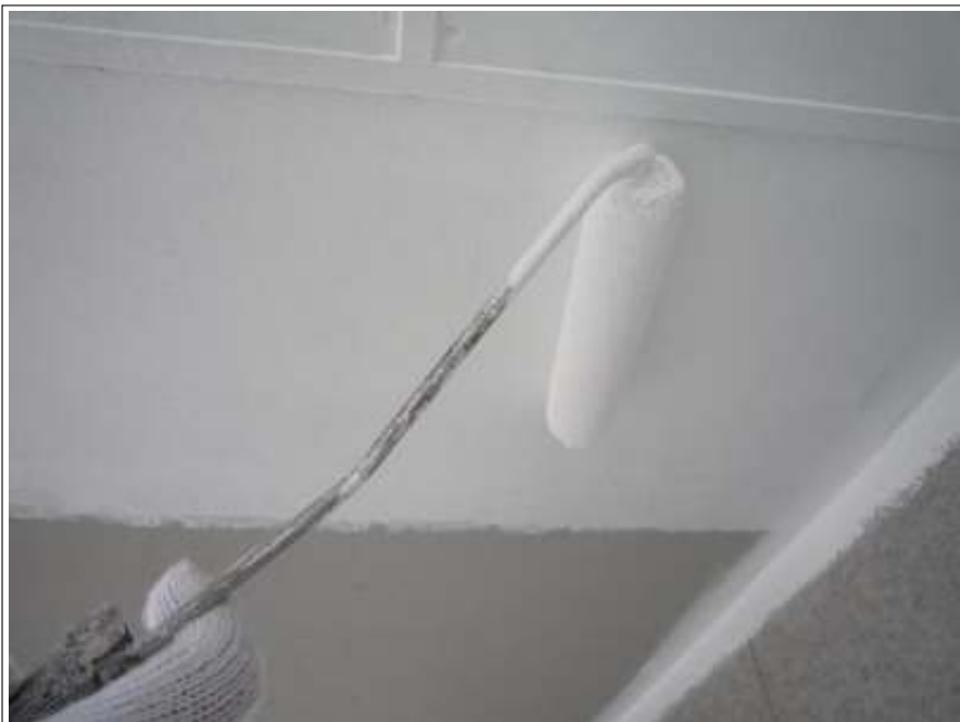
軒天下塗り塗装施工状況
