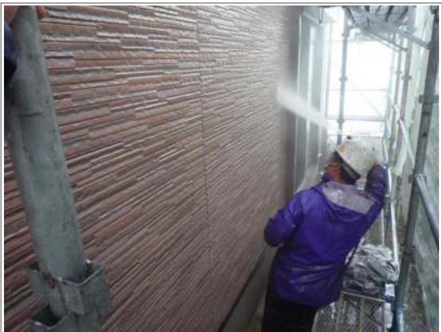
外壁高圧洗浄状況
