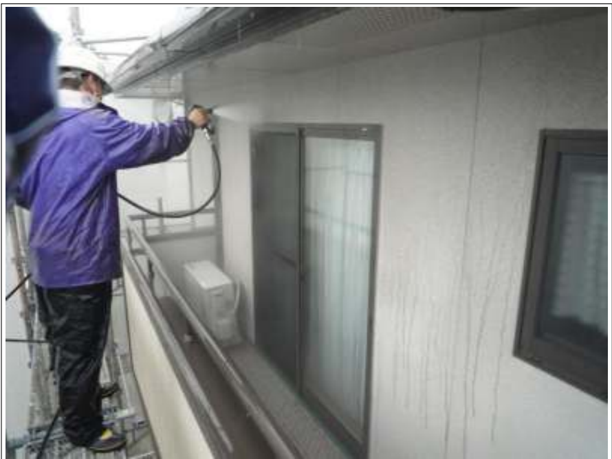
外壁高圧洗浄状況
