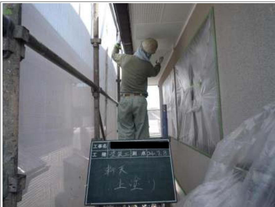
軒天上塗り塗装施工中
