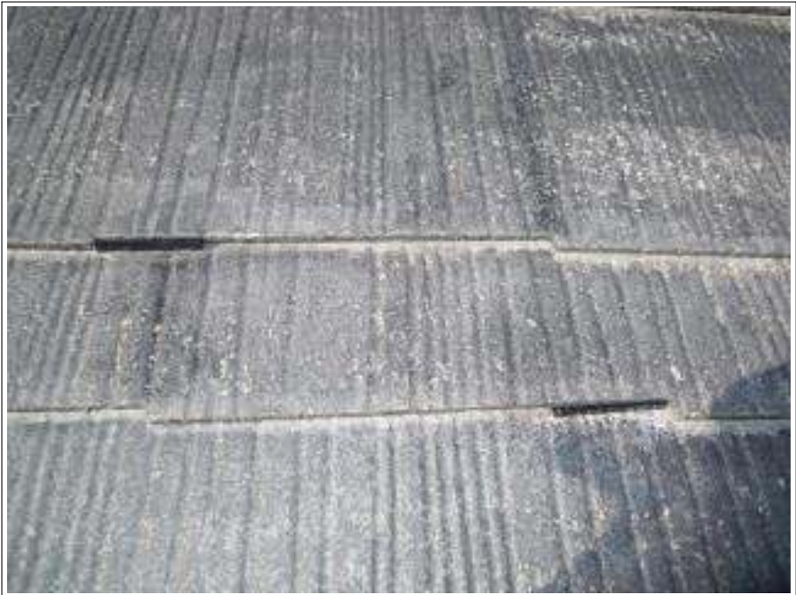
屋根タスペーサー施工前
