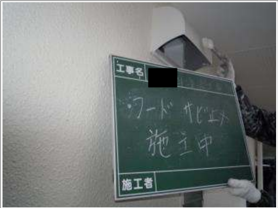
換気フードサビ止め施工中
