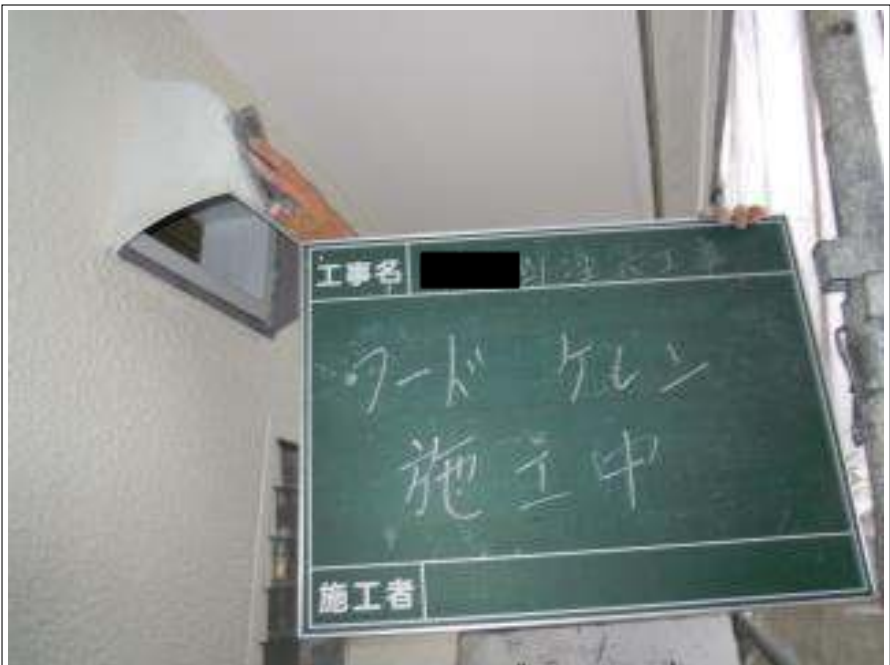
換気フードケレン施工中
