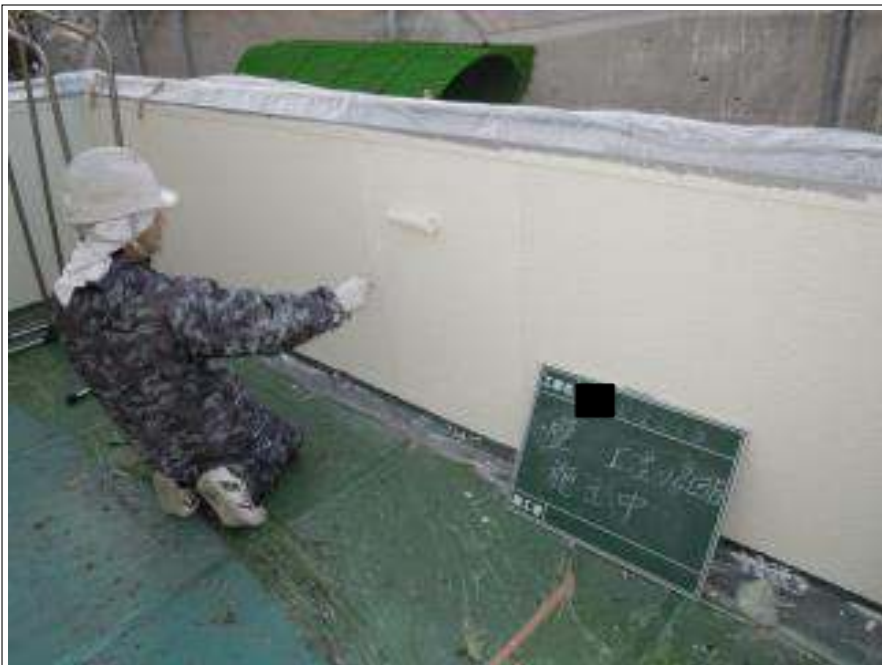
外壁塗装上塗り 2 回目施工中
