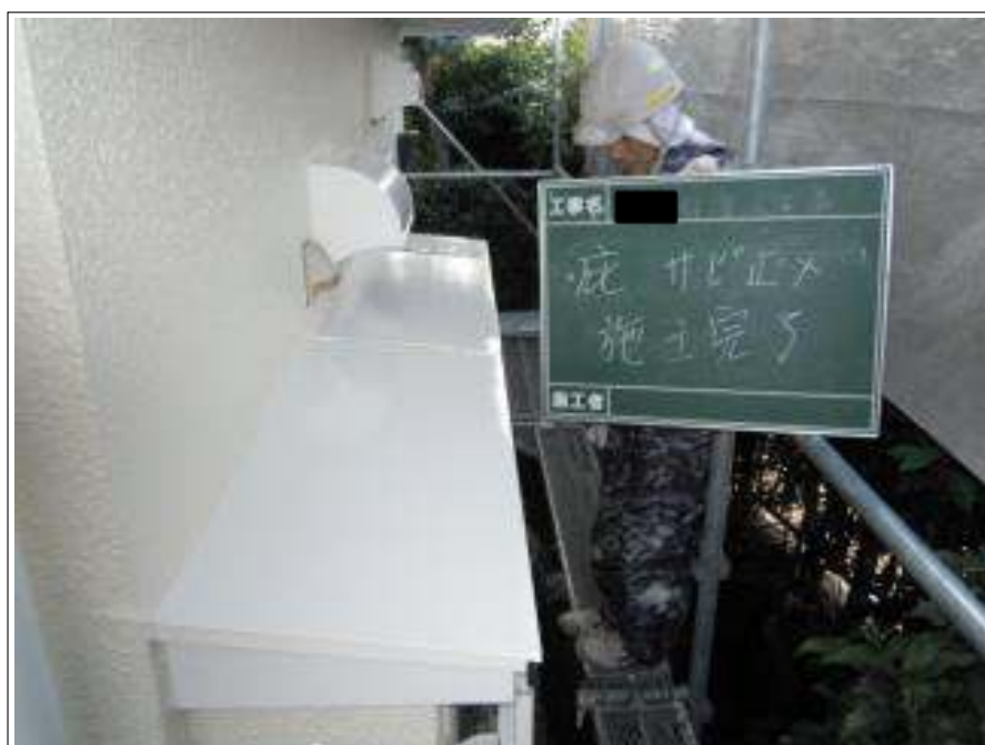
小底サビ止め施工完了
