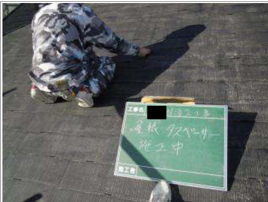
屋根タスペーサー施工中
