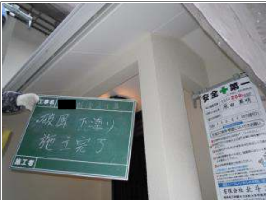
破風板下塗り施工完了
