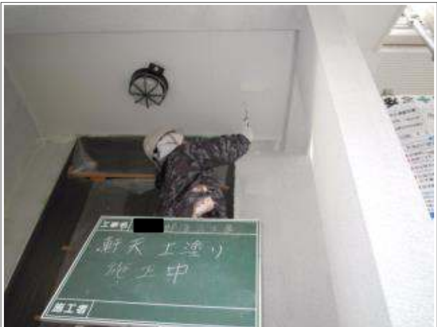
軒天塗装上塗り施工中
