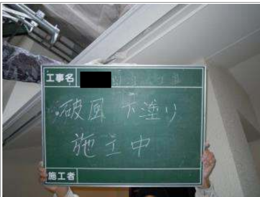
破風板下塗り施工中
