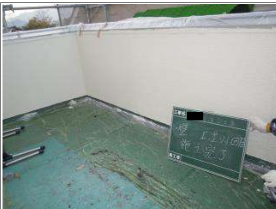
外壁塗装上塗り1回目施工完了
