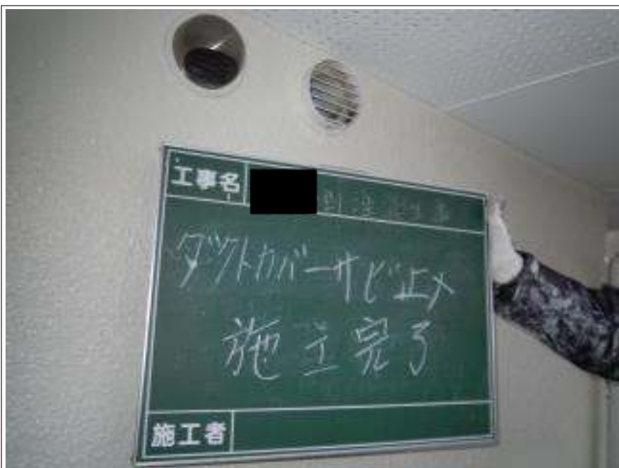
ダクトカバーサビ止め施工完了
