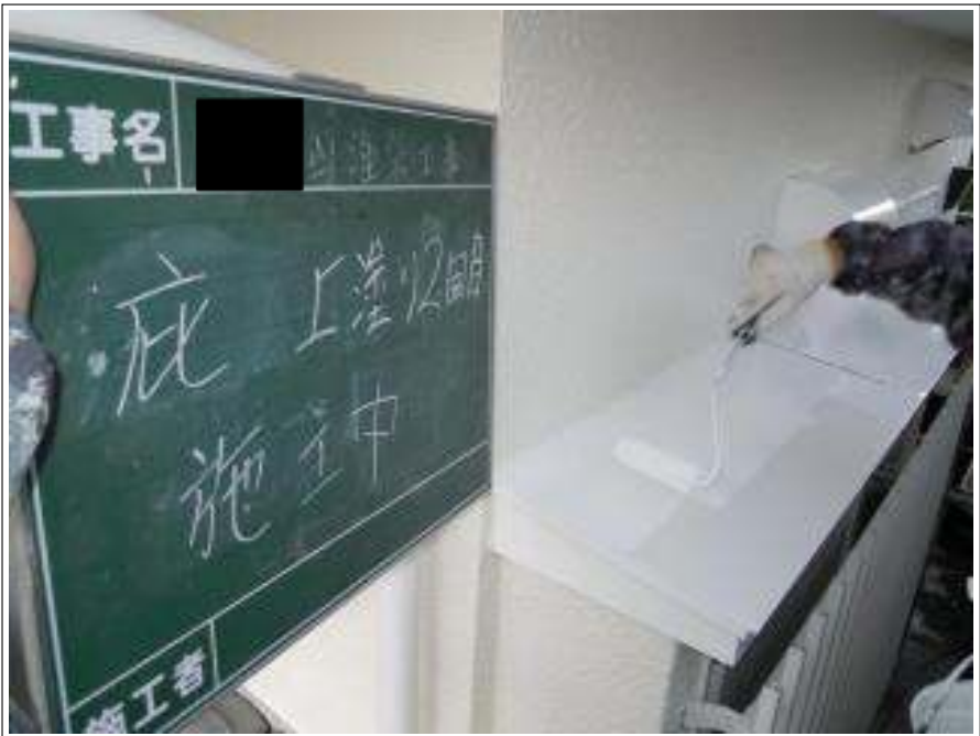
小庇上塗り 2 回目施工中
