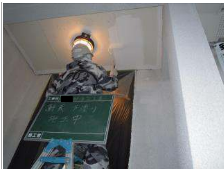
軒天塗装下塗り施工中
