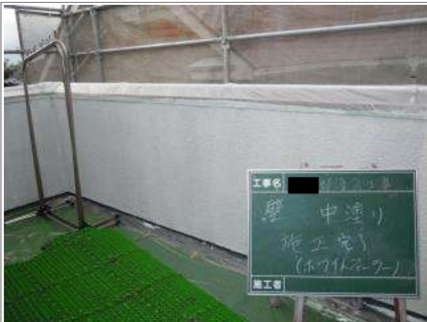
外壁塗装中塗り施工完了
