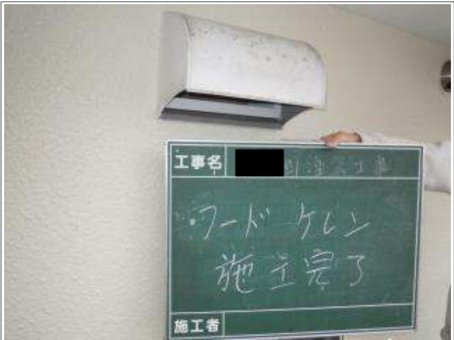
換気フードケレン施工完了
