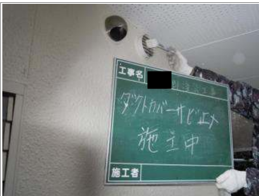
ダクトカバーサビ止め施工中
