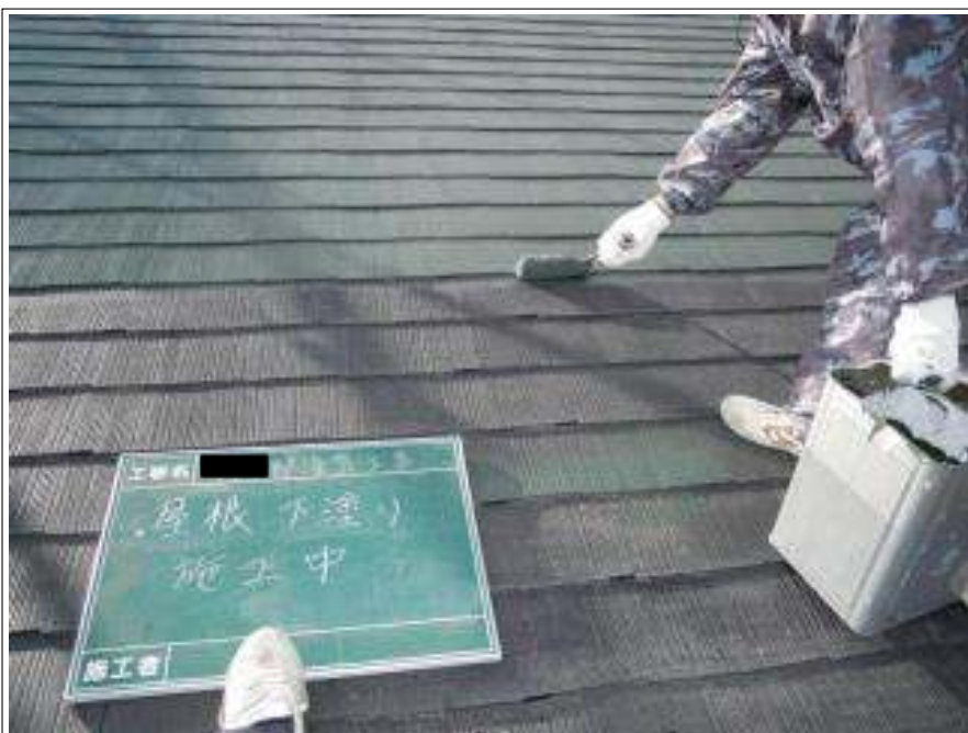
屋根塗装下塗り施工中
