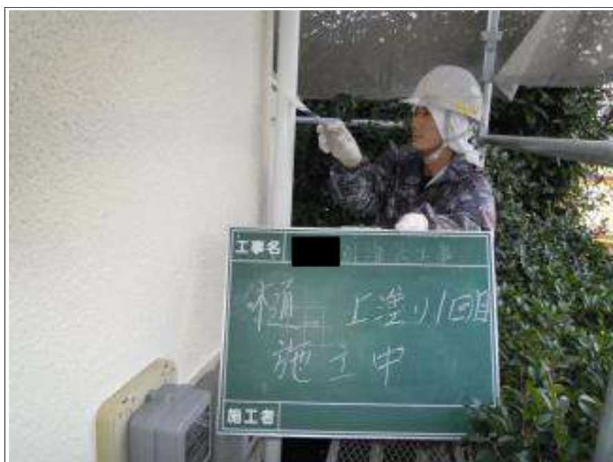
樋上塗り塗装 1 回目施工中
