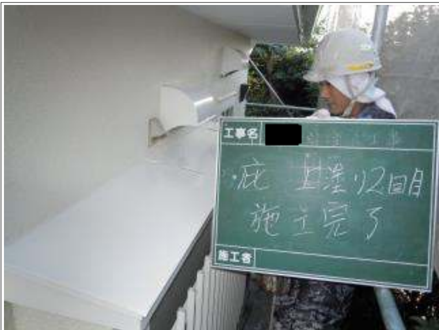
小庇上塗り2回目施工完了
