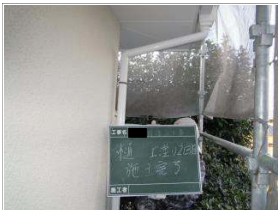
樋上塗り塗装2回目施工完了
