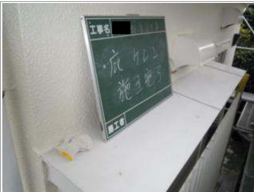
小底ケレン施工完了
