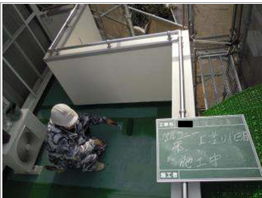
バルコニー床上塗り施工中
