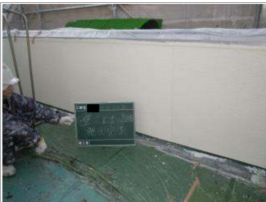
外壁塗装上塗り 2 回目施工完了
