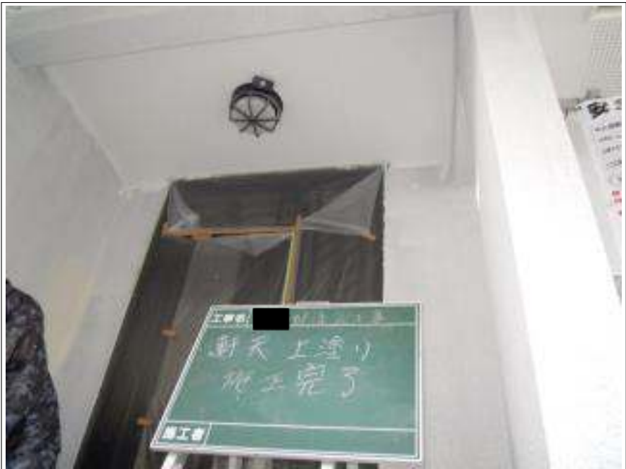
軒天塗装上塗り施工完了
