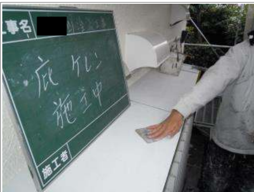
小底ケレン施工中
