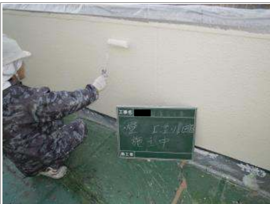
外壁塗装上塗り1回目施工中
