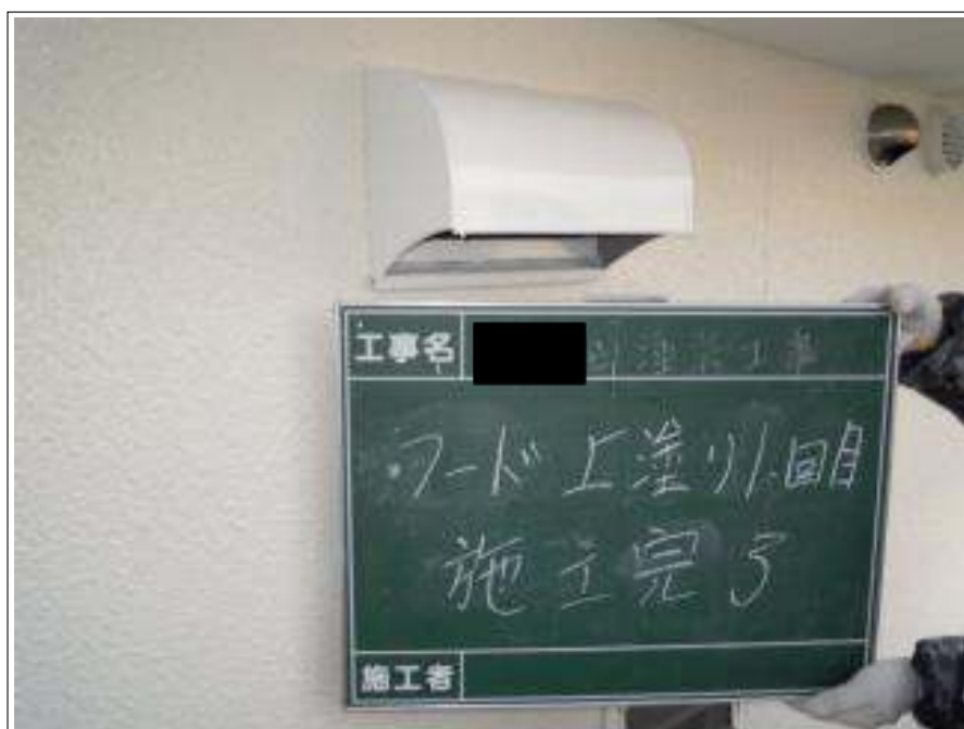
換気フード上塗り1回目施工完了
