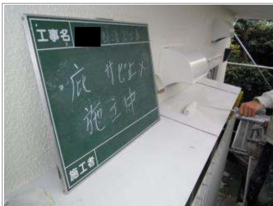
小底サビ止め施工中
