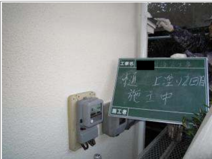
樋上塗り塗装2回目施工中
