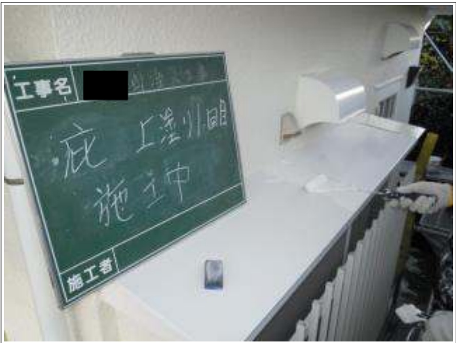
小庇上塗り 1 回目施工中
