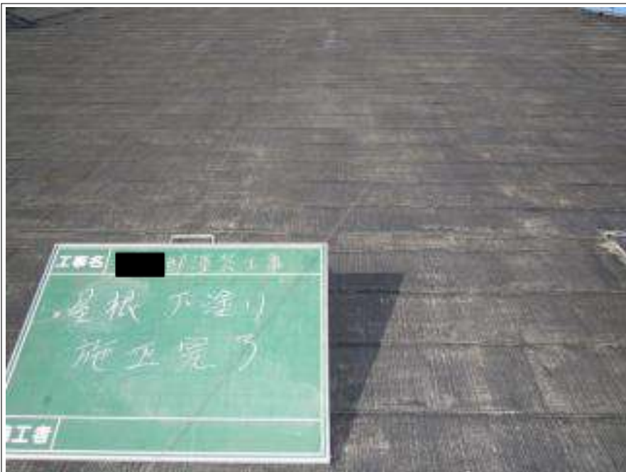
屋根塗装下塗り施工完了
