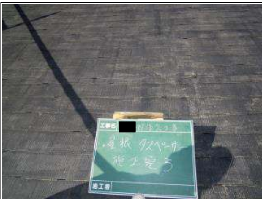
屋根タスペーサー施工完了
