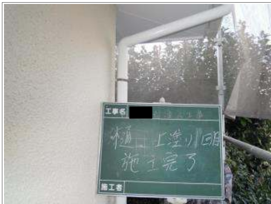
樋上塗り塗装 1 回目施工完了
