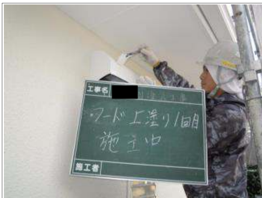
換気フード上塗り1回目施工中
