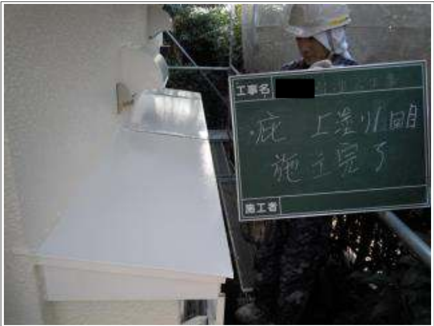
小庇上塗り 1 回目施工完了
