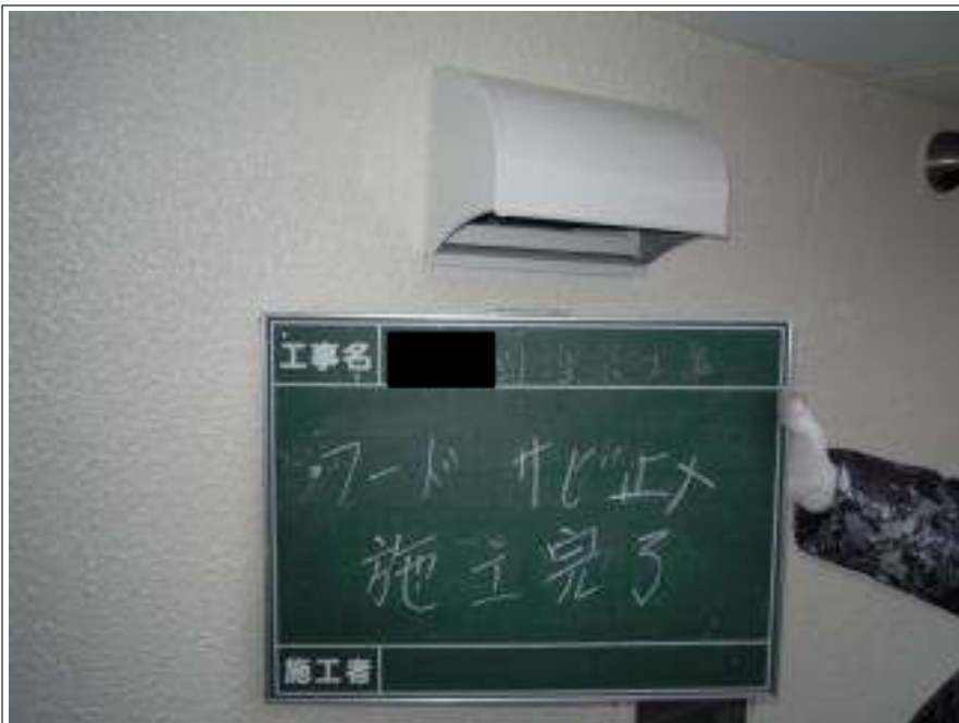
換気フードサビ止め施工完了
