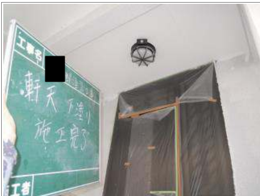
軒天塗装下塗り施工完了
