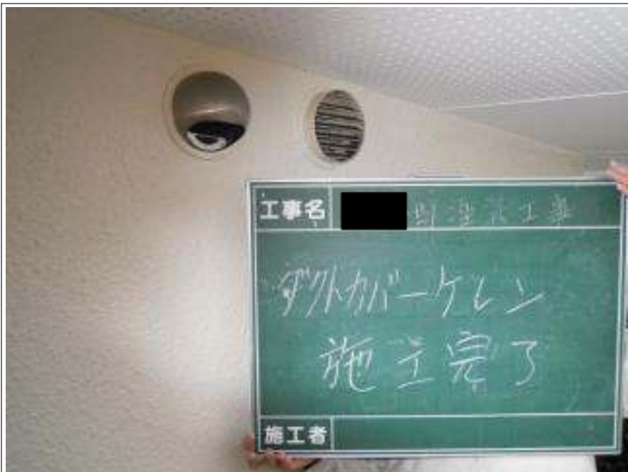
ダクトカバーケレン施工完了
