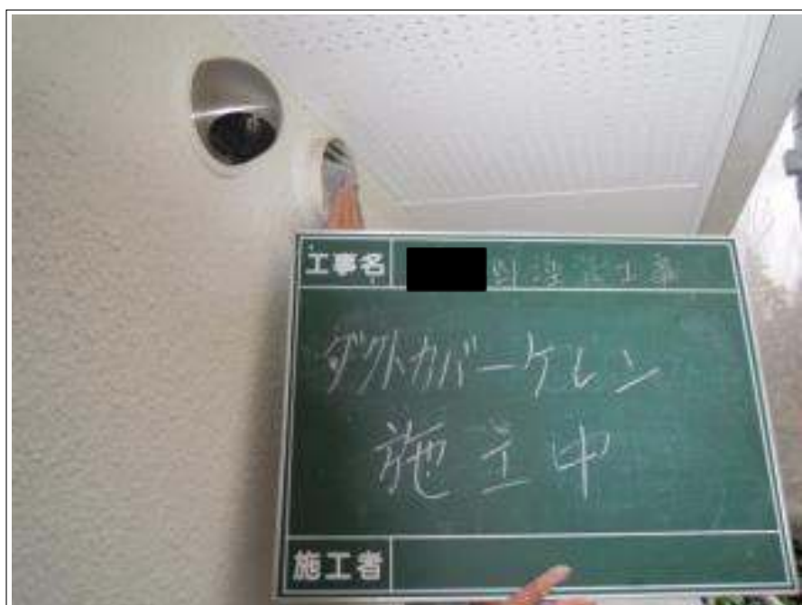
ダクトカバーケレン施工中
