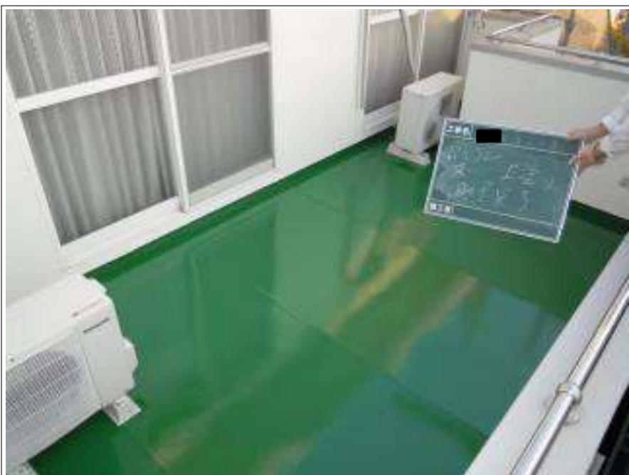
バルコニー床塗装施工完了
