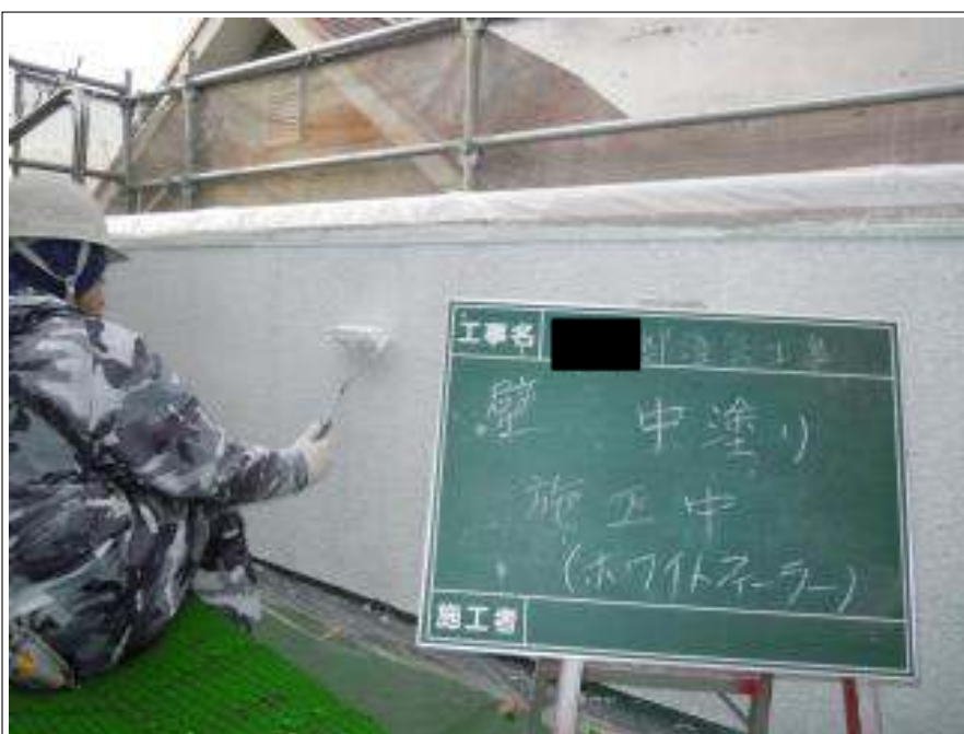
外壁塗装中塗り施工中
