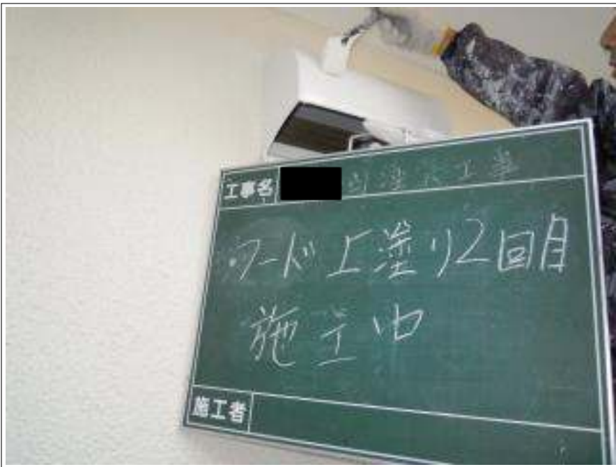
換気フード上塗り2回目施工中
