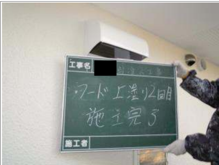
換気フード上塗り2回目施工完了
