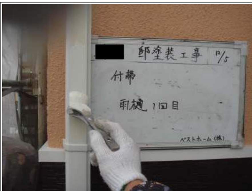
付帯 雨樋1回目施工中
