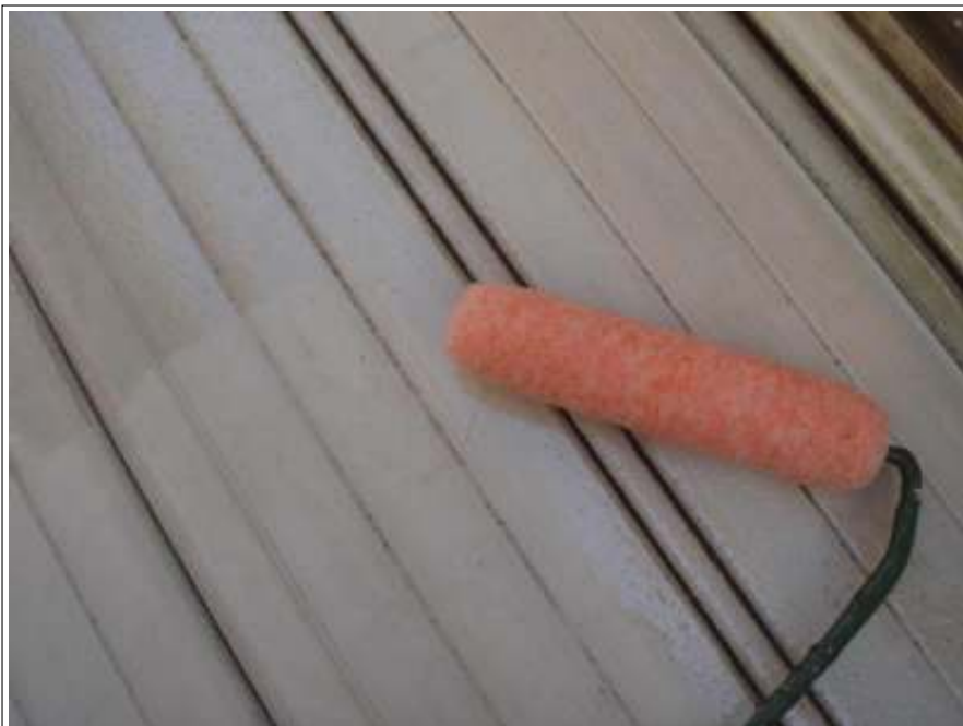
ベランダプライマー施工中
