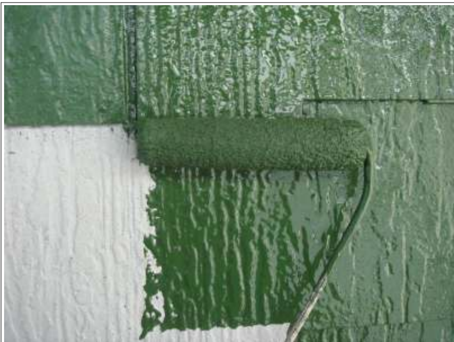
屋根中塗り施工中
