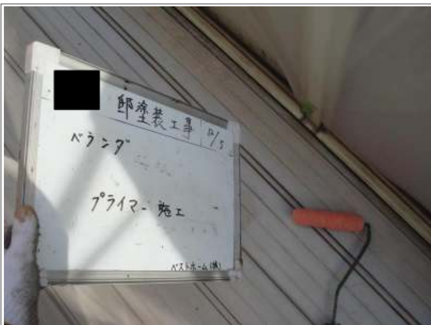
ベランダプライマー施工中
