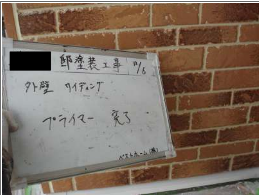
外壁サイディングプライマー施工完了
