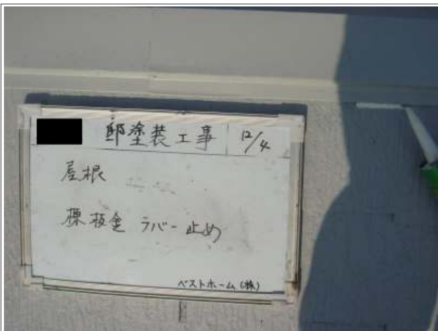
屋根ラバー止め施工中
