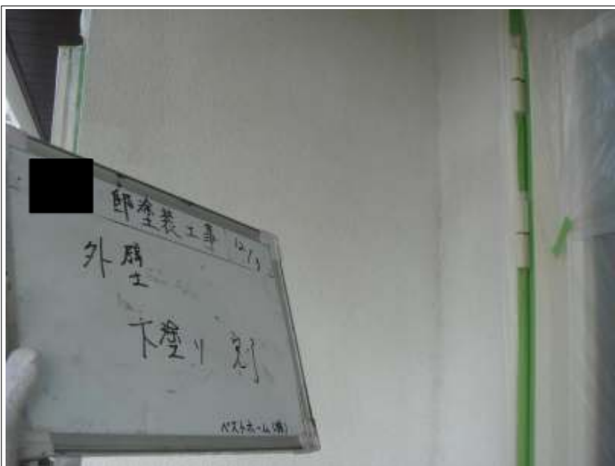
外壁下塗り施工完了
