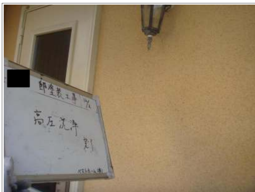
外壁高圧洗浄完了
