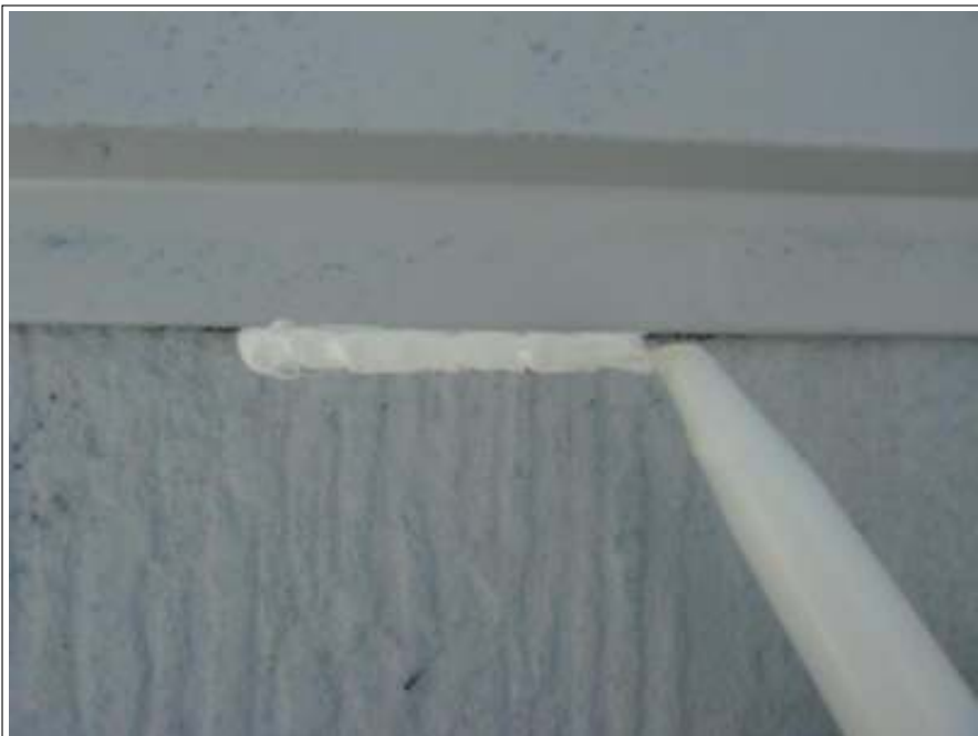
屋根ラバー止め施工中
