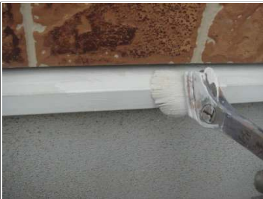
付帯 水切りサビ止め施工中
