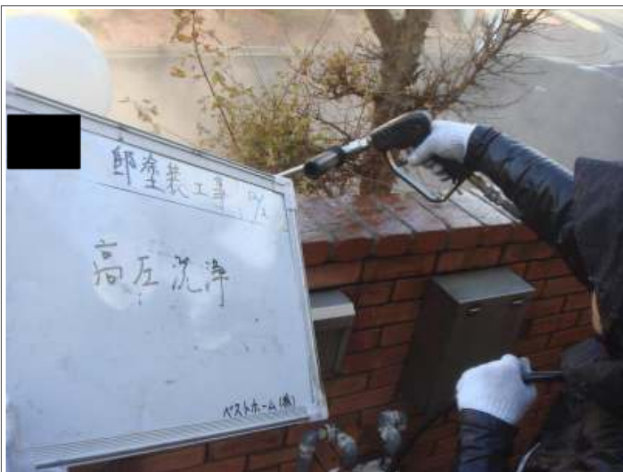
塀高圧洗浄中
