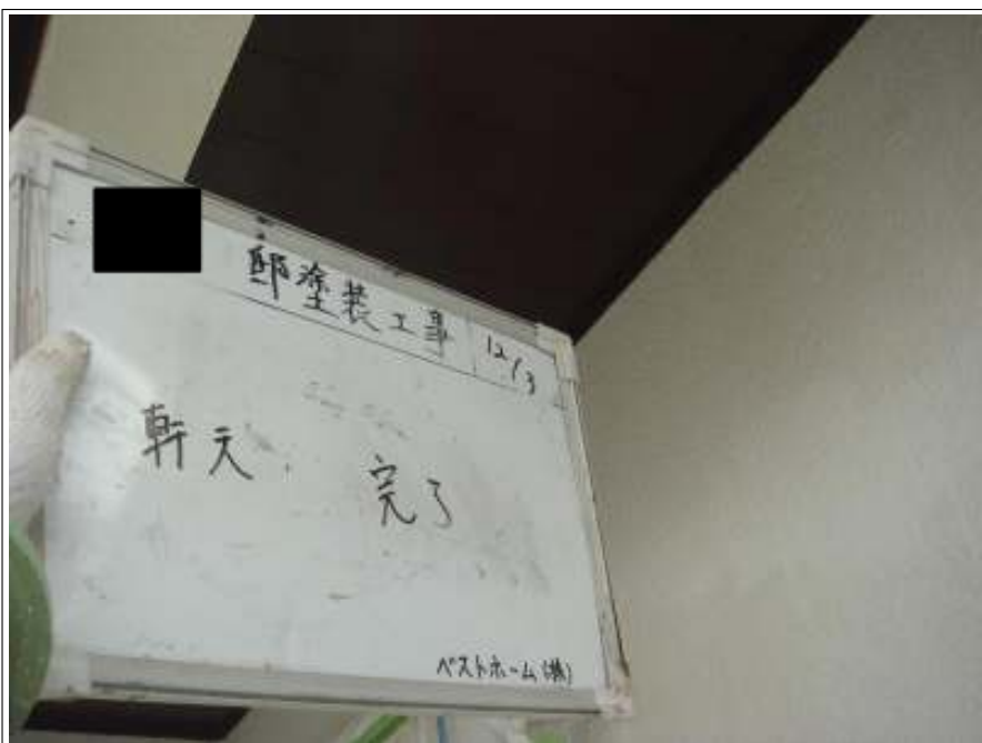
軒天2回目施工完了
