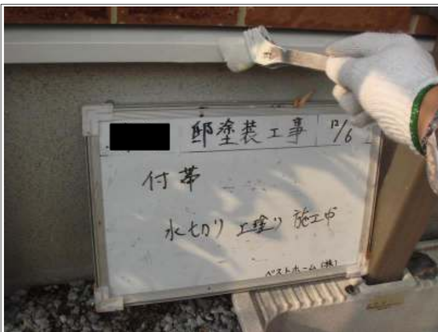
付帯 水切り上塗り施工中
