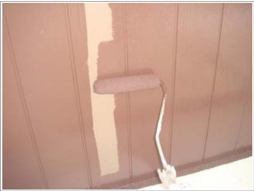
軒天1回目施工中
