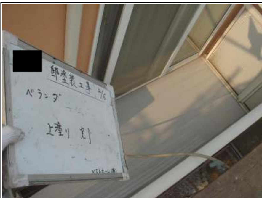
ベランダ上塗り施工完了
