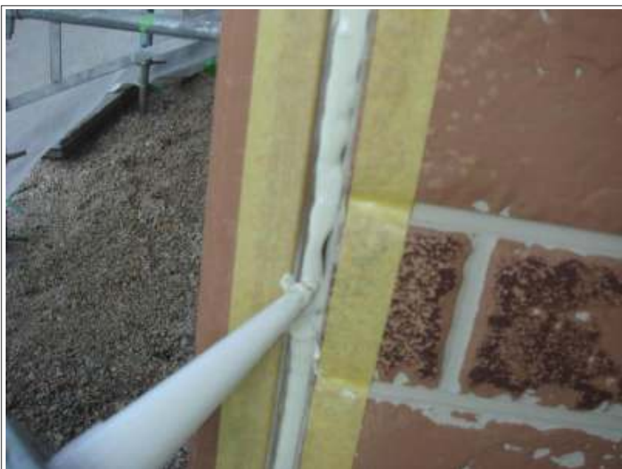
サイディング面シーリング施工中
