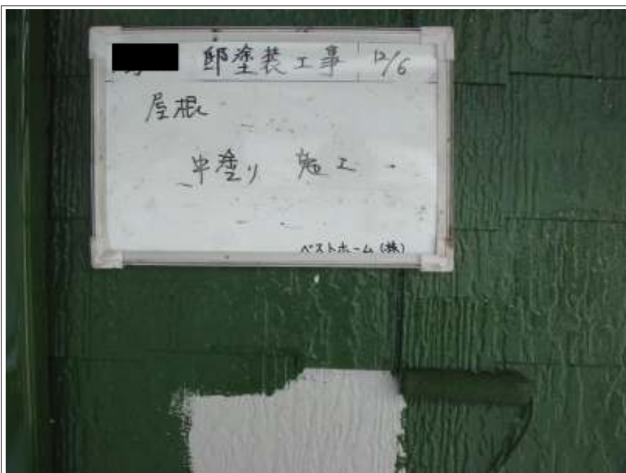
屋根中塗り施工中
