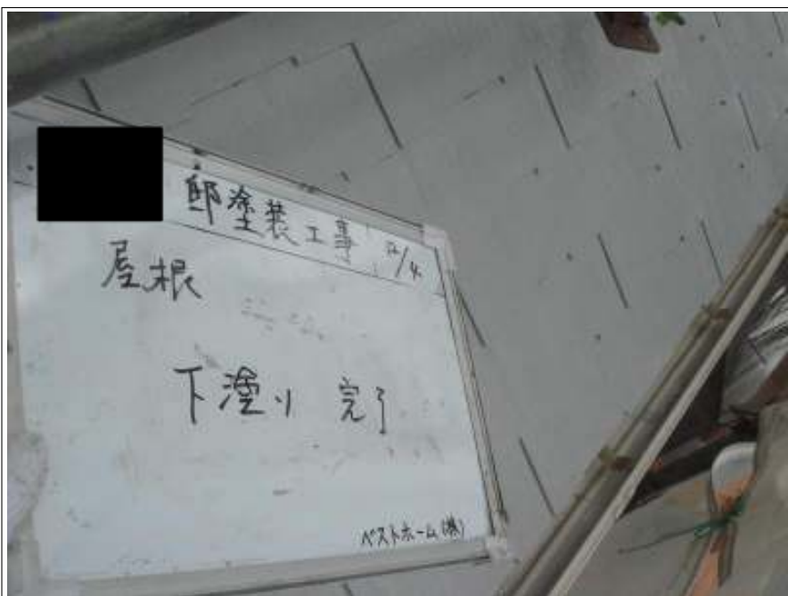
屋根下塗り施工完了
