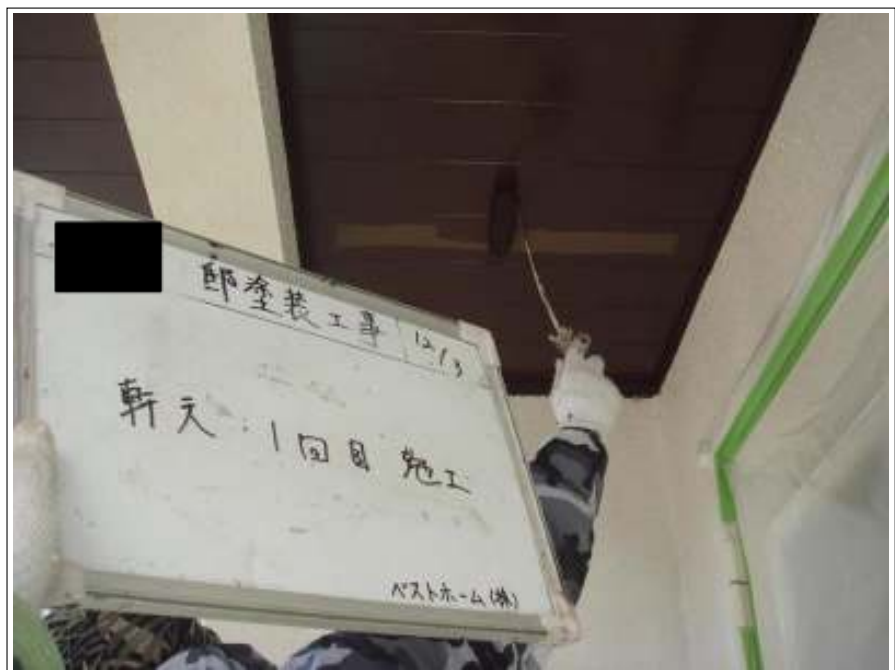
軒天1回目施工中
