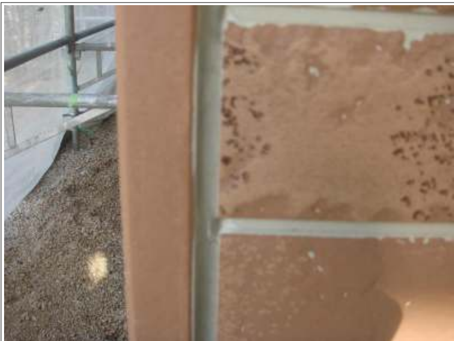
サイディング面シーリング施工中
