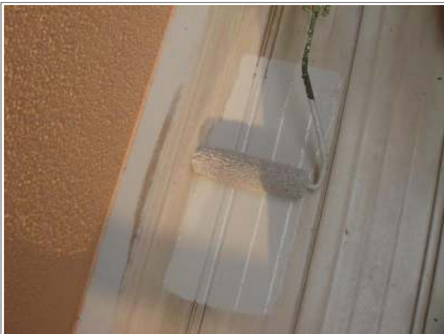
ベランダ上塗り施工中
