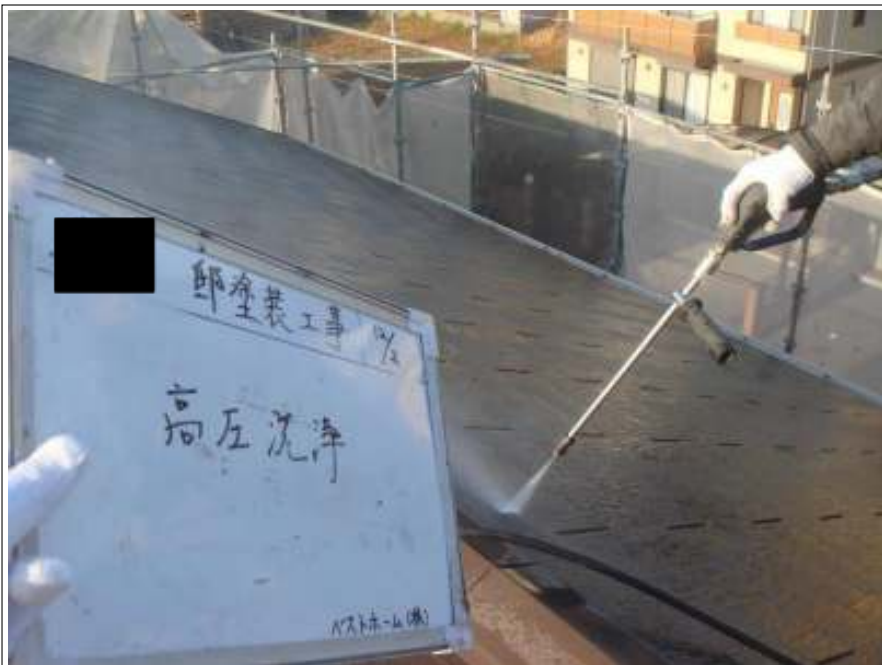
屋根高圧洗浄中
