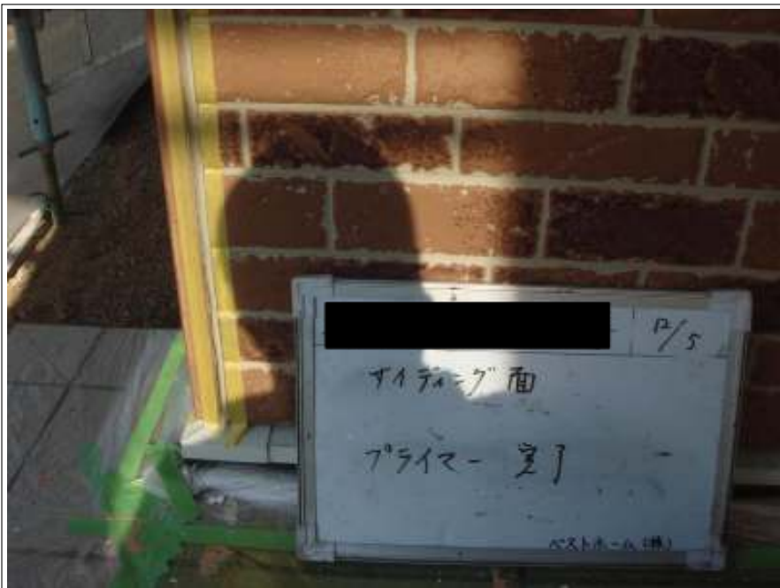
サイディング面プライマー施工完了
