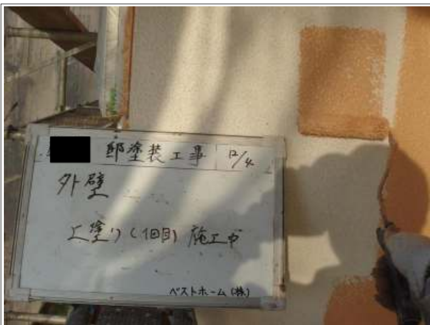
外壁上塗り1回目施工中
