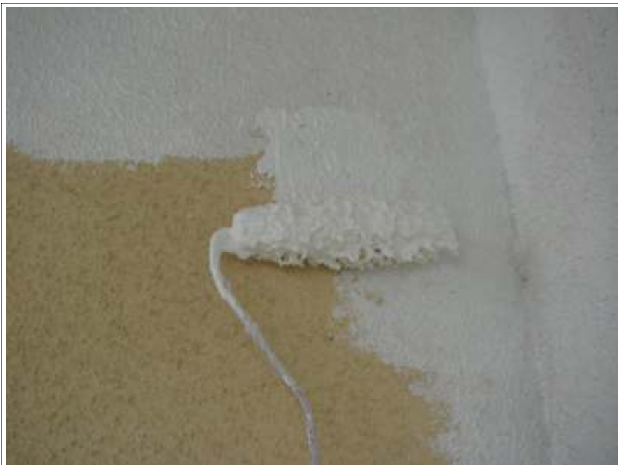
外壁下塗り施工中
