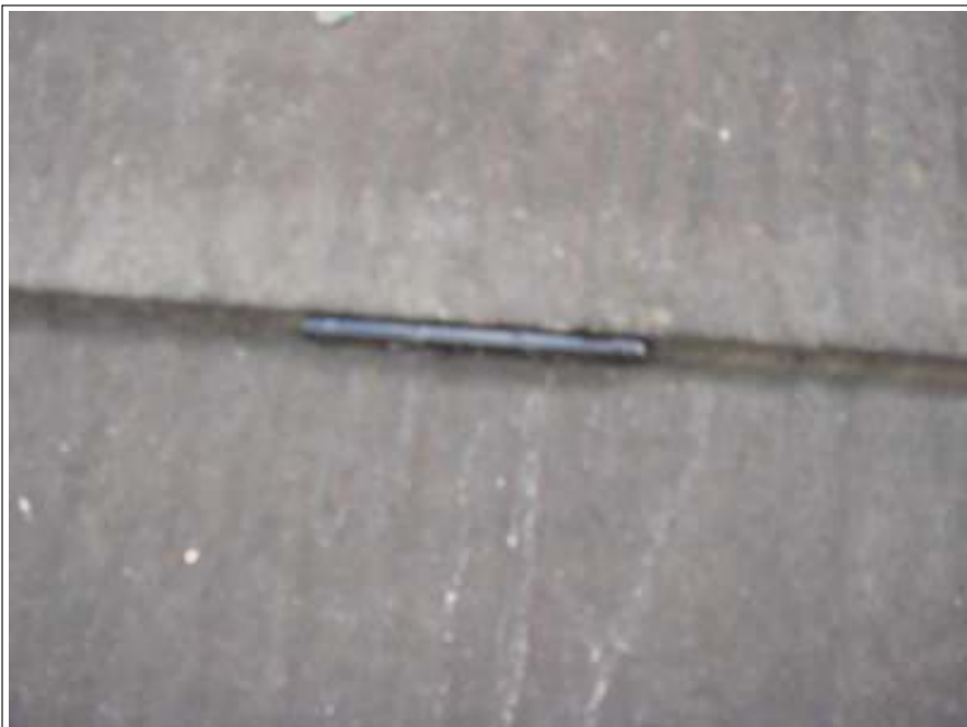
屋根タスペーサー取付中
