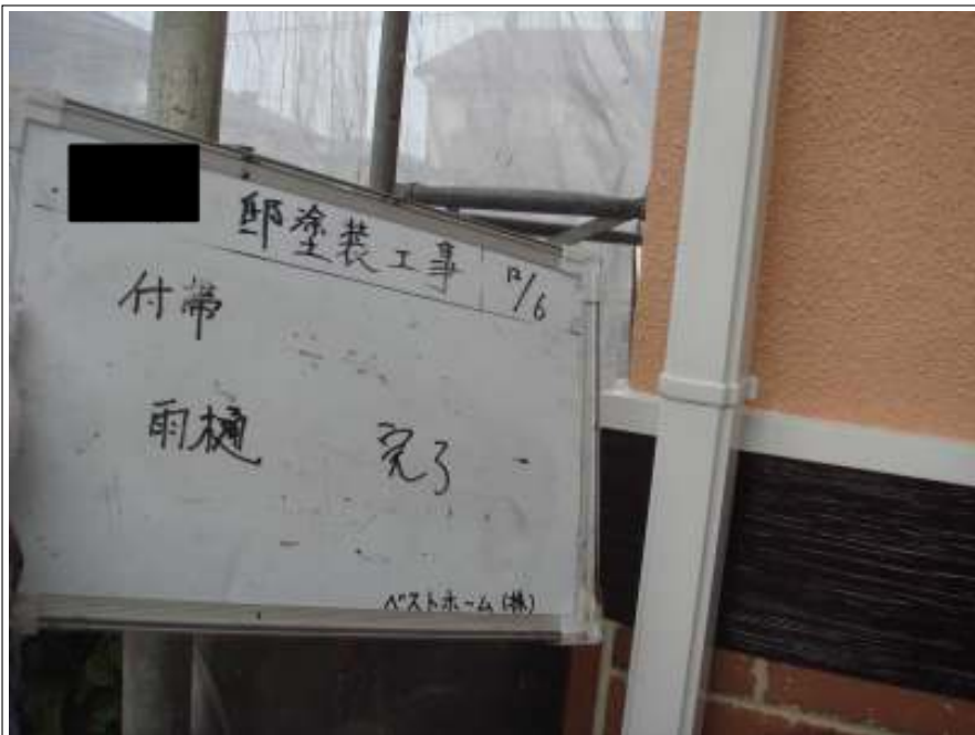
付帯 雨樋2回目施工完了
