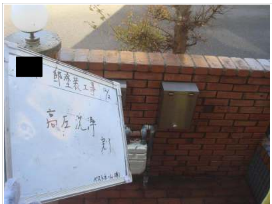
塀高压洗浄完了
