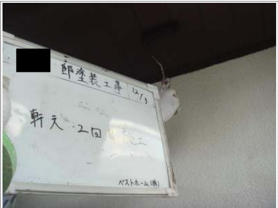
軒天2回目施工中
