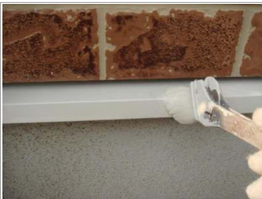
付帯 水切り上塗り施工中
