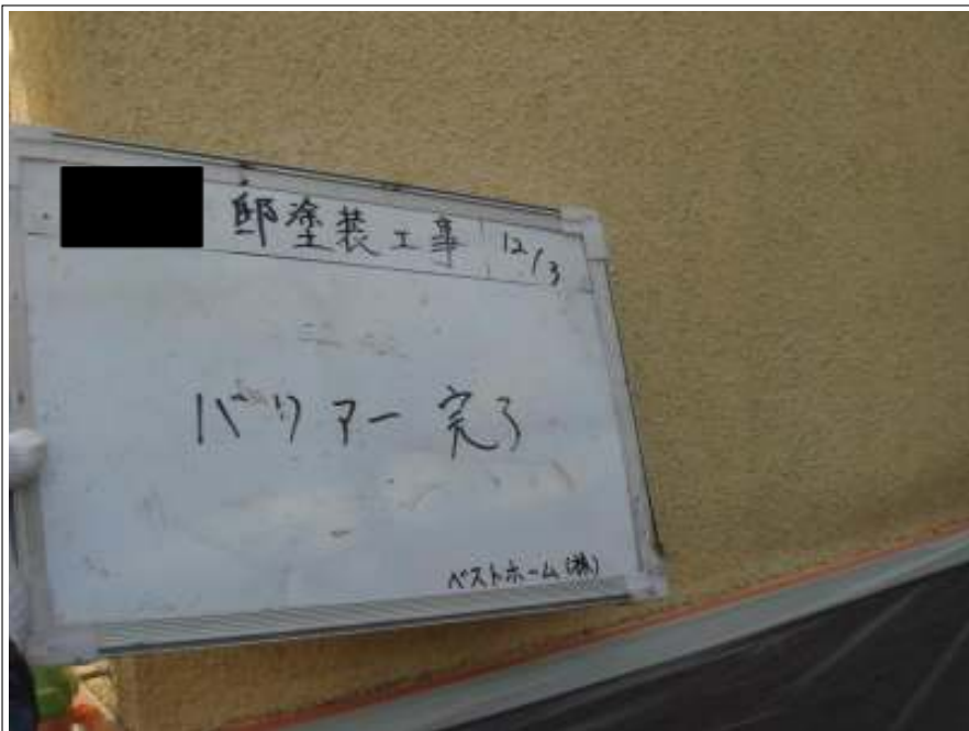
バリアー施工完了
