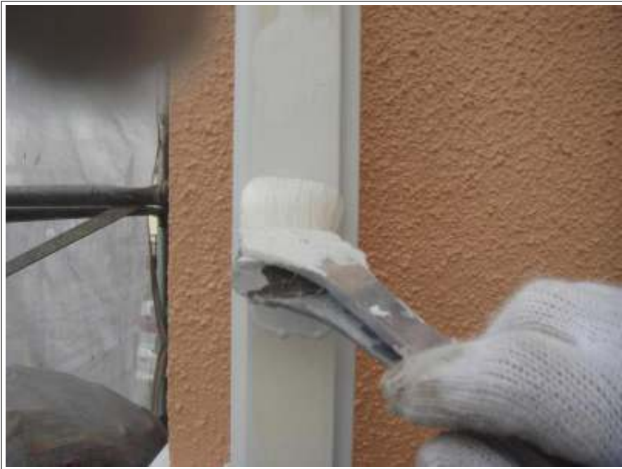
付帯 雨樋1回目施工中
