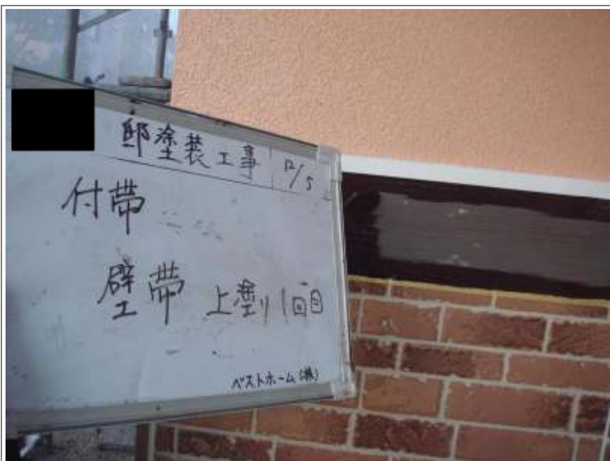
付帯 外帯上塗り施工中
