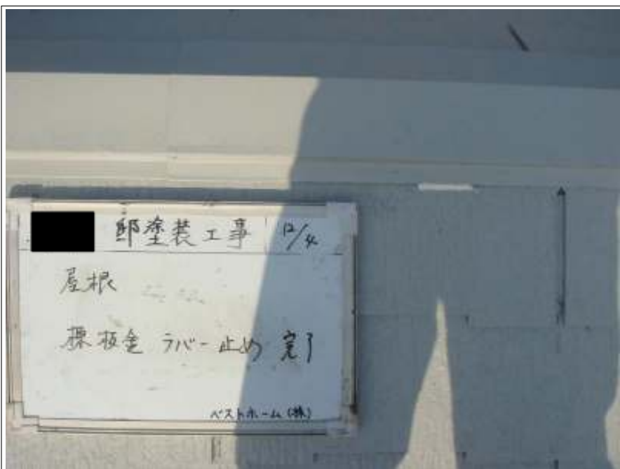
屋根ラバー止め施工完了
