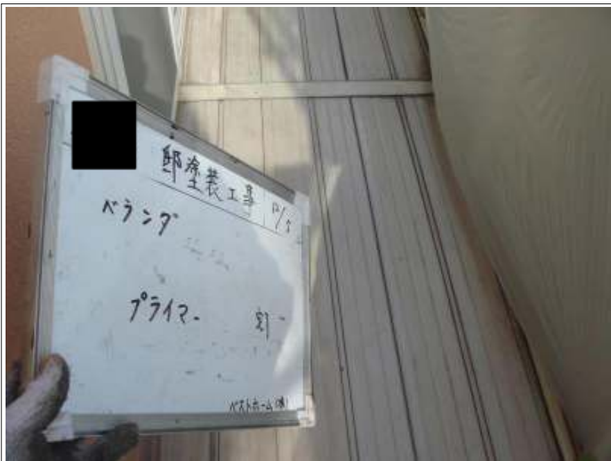
ベランダプライマー施工完了
