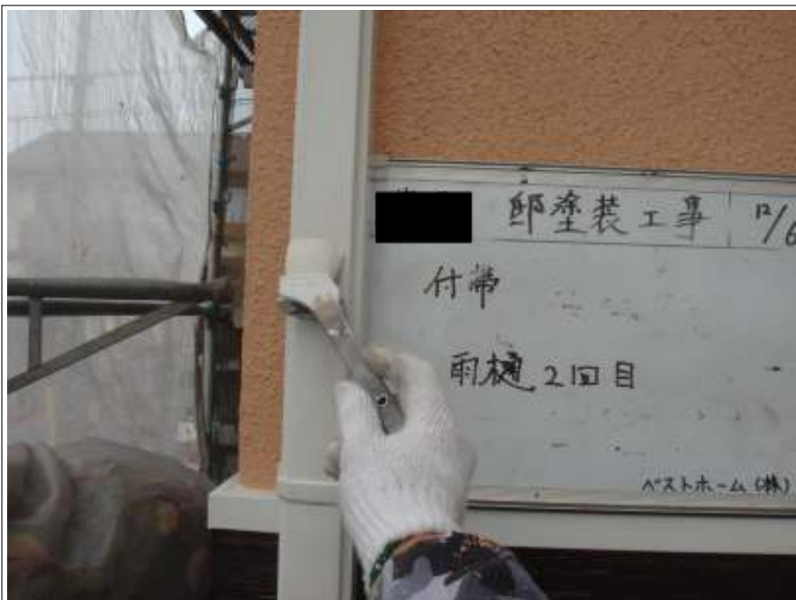
付帯 雨樋2回目施工中
