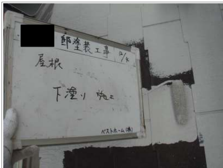
屋根下塗り施工中
