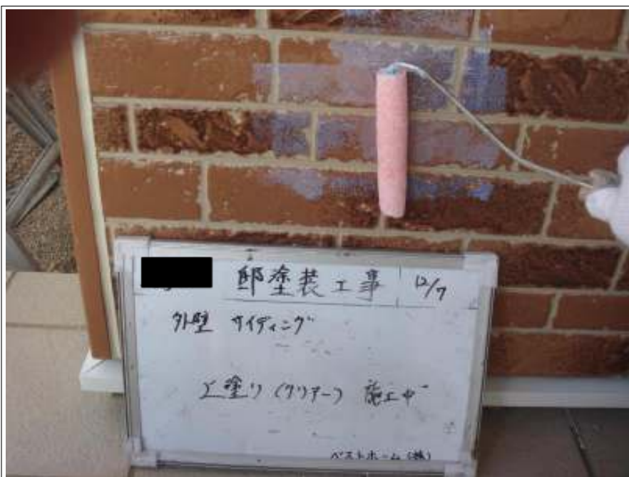
外壁サイディング上塗り施工中
