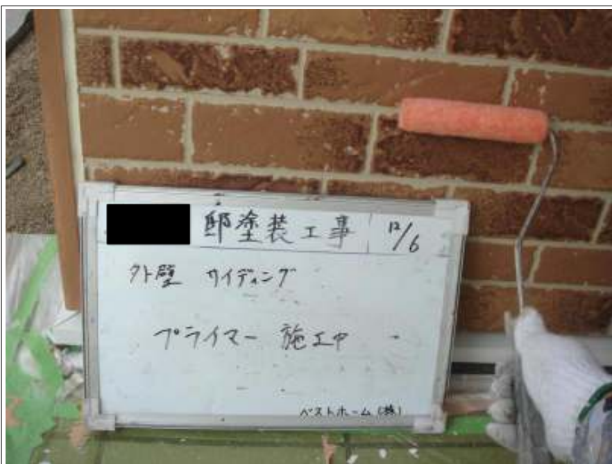
外壁サイディングプライマー施工中
