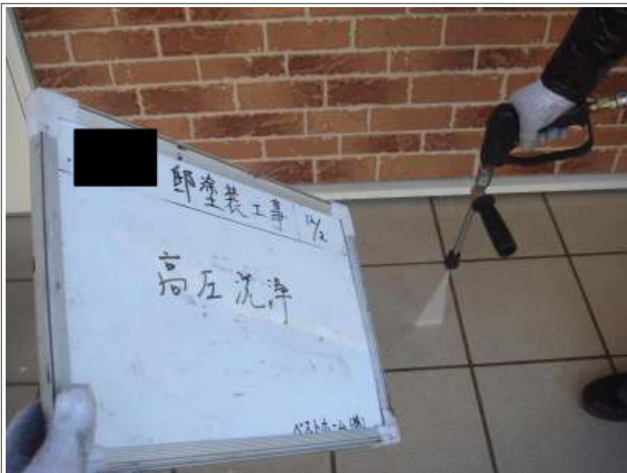
玄関前高圧洗浄中
