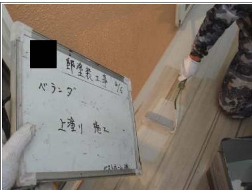
ベランダ上塗り施工中
