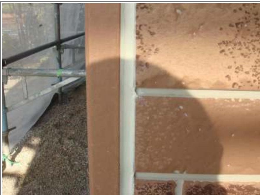
サイディング面シーリング施工中
