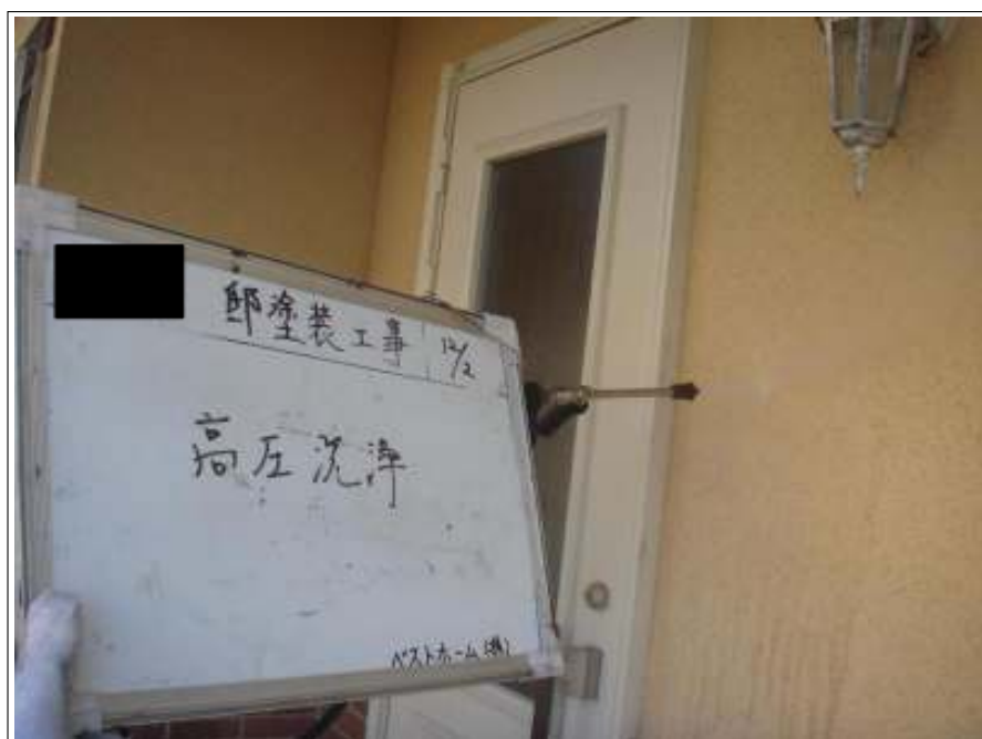
外壁高圧洗浄中
