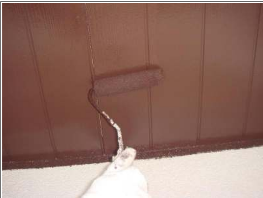
軒天2回目施工中
