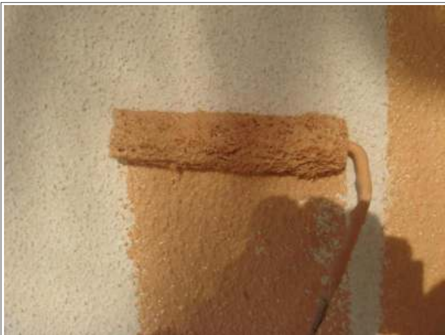
外壁上塗り1回目施工中
