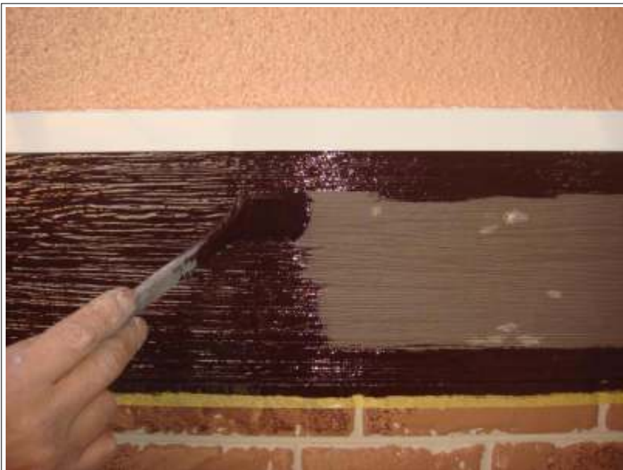
付帯 外帯上塗り施工中
