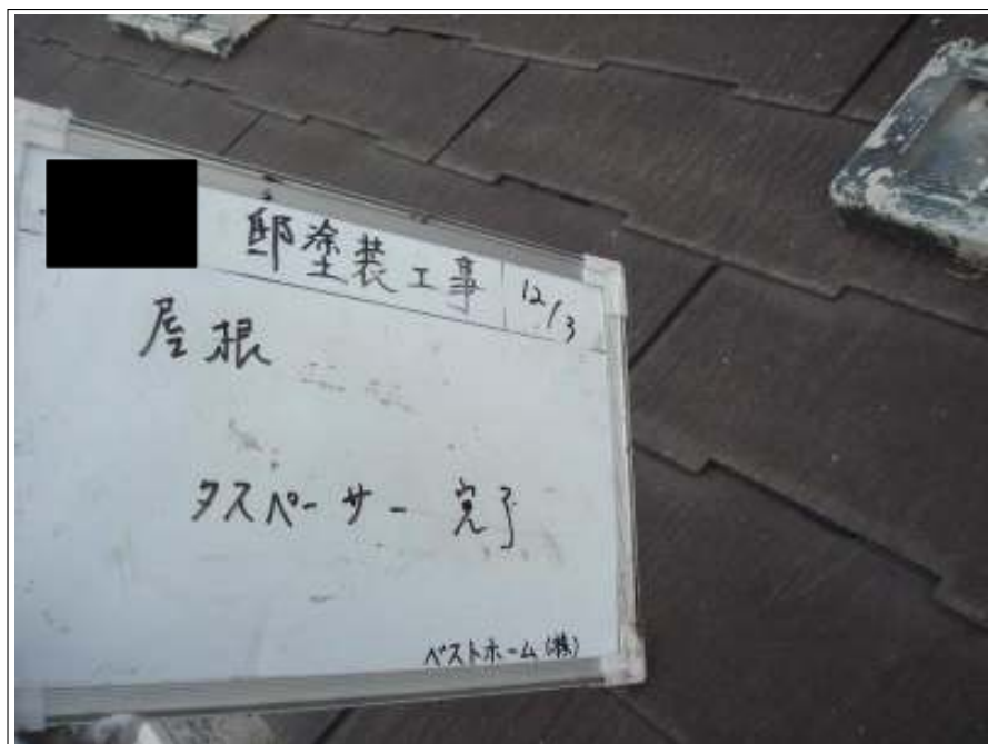
屋根タスペーサー取付完了
