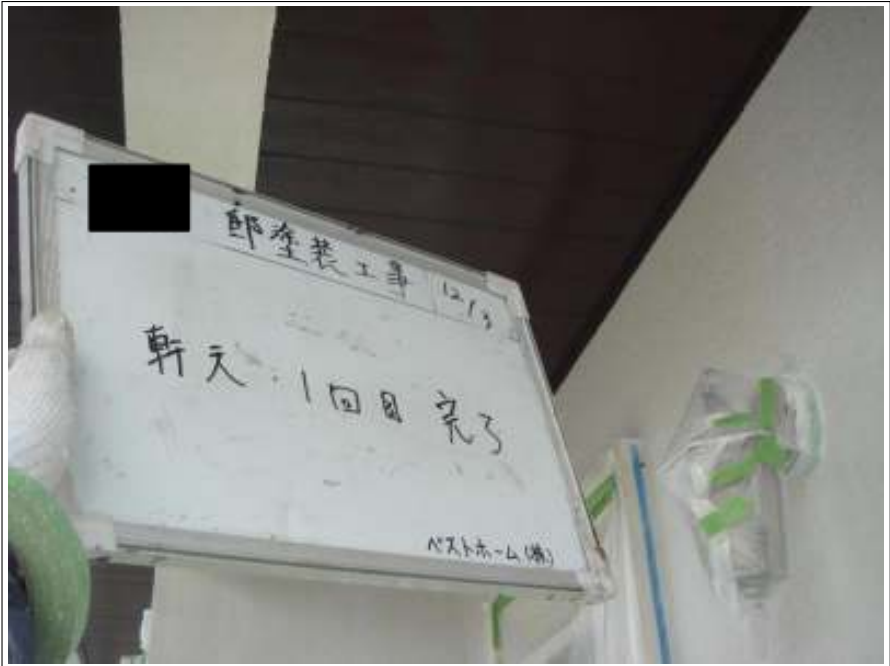
軒天1回目施工完了
