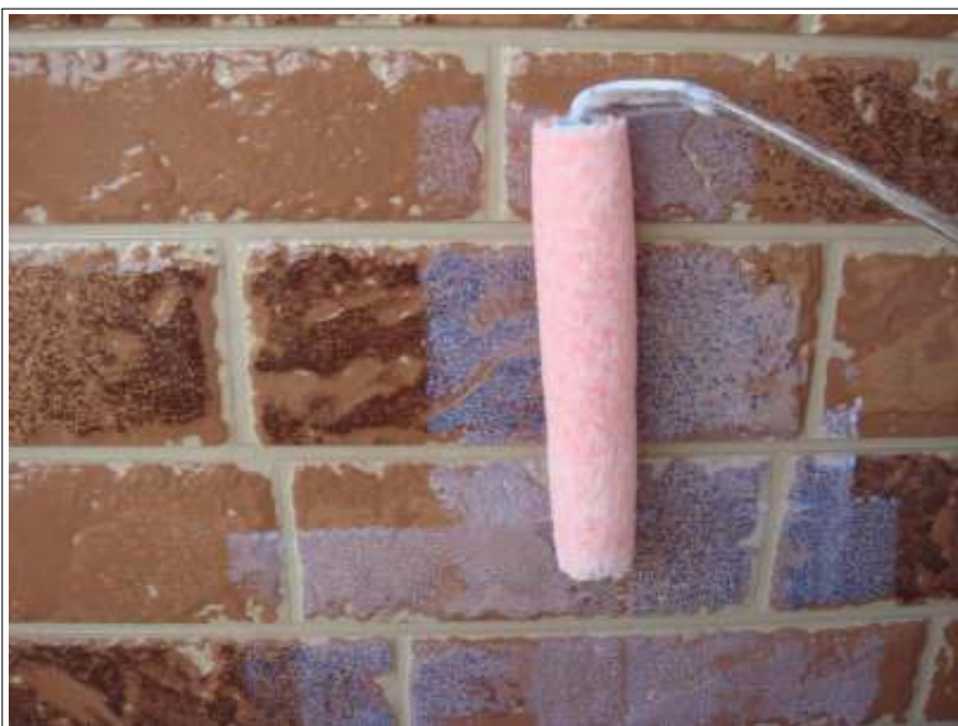
外壁サイディング上塗り施工中
