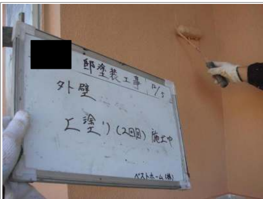
外壁上塗り2回目施工中
