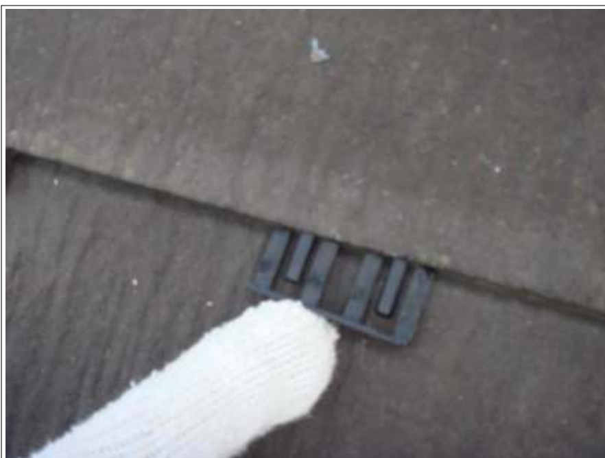
屋根タスペーサー取付中
