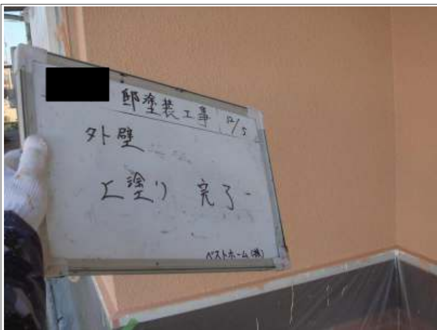
外壁上塗り2回目施工完了
