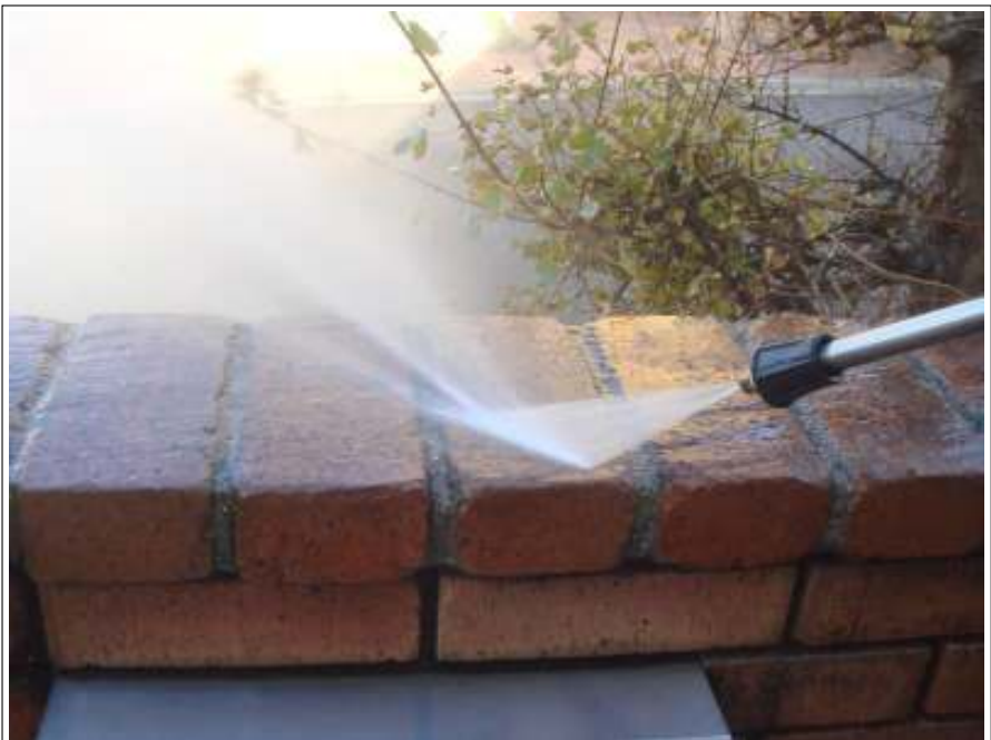
塀高压洗浄中
