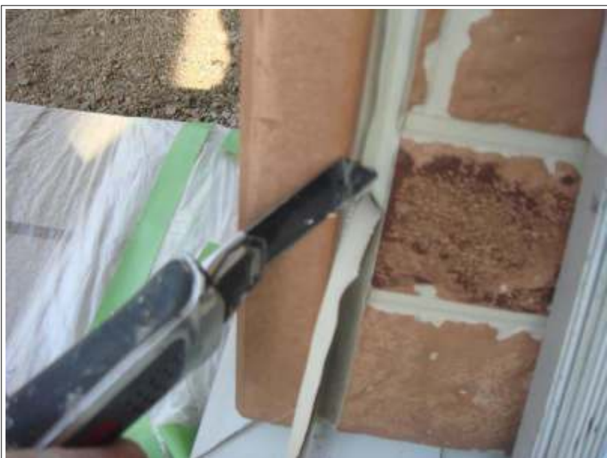
サイディング面シーリング施工中
