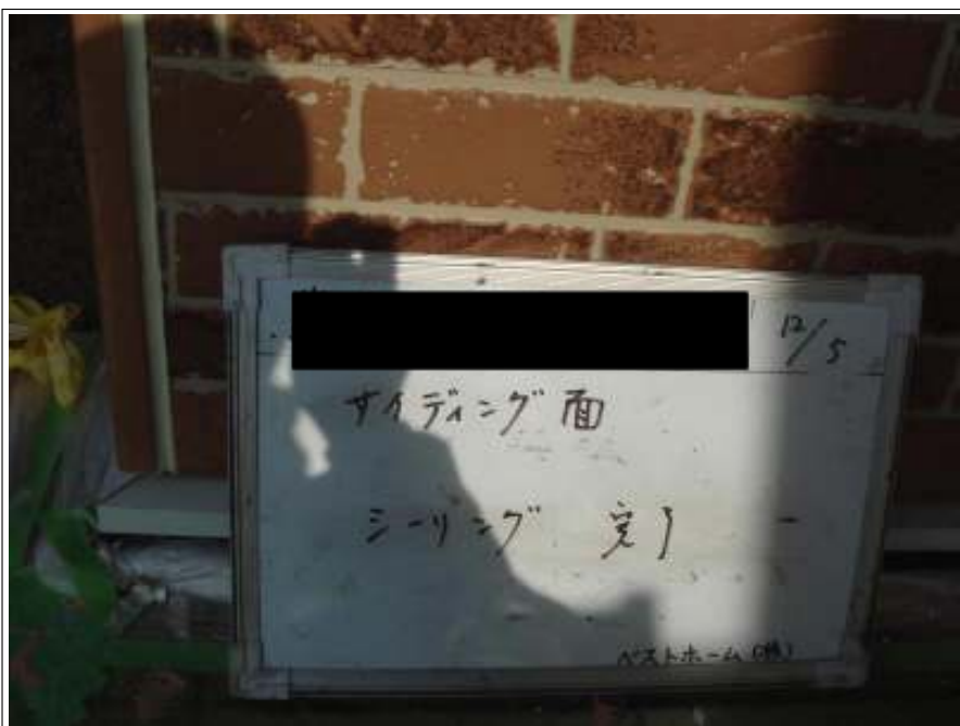
サイディング面シーリング施工完了
