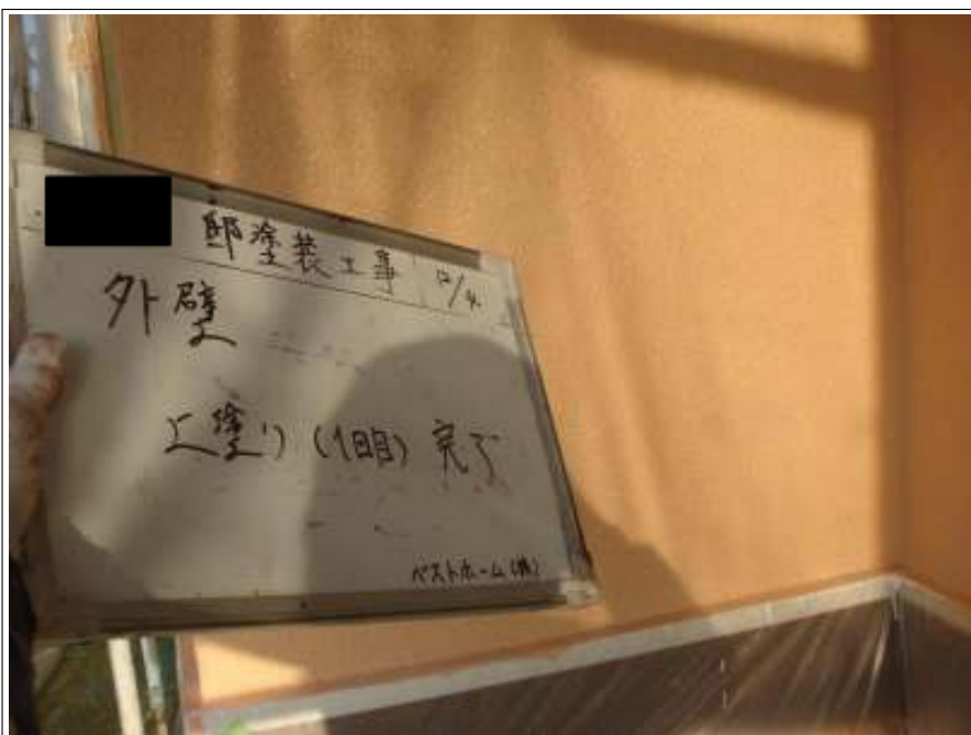
外壁上塗り1回目施工完了
