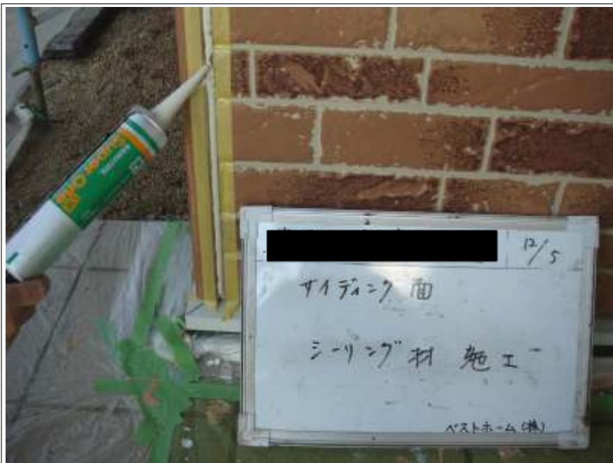
サイディング面シーリング施工中
