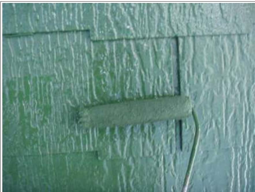
屋根上塗り施工中
