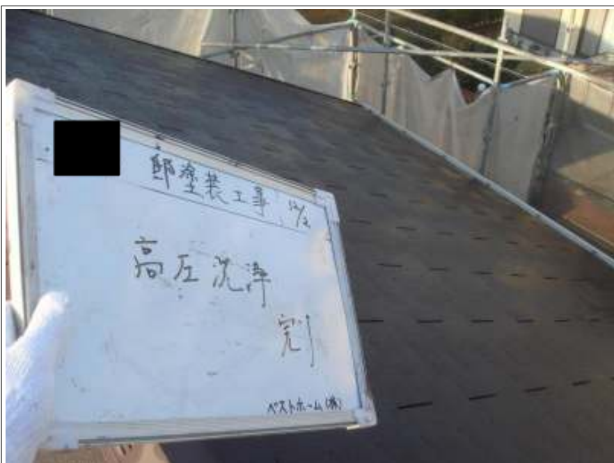
屋根高圧洗浄中
