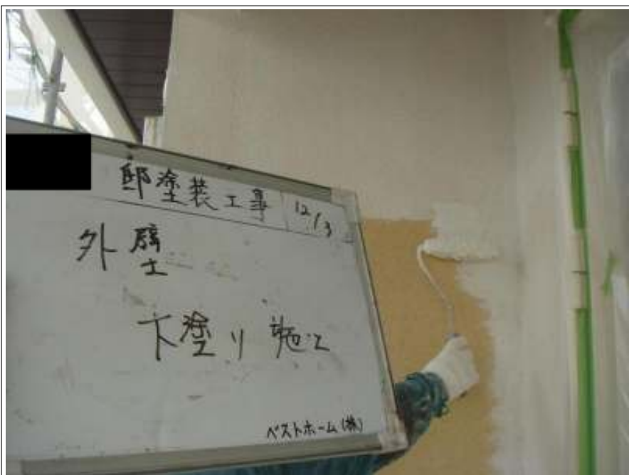
外壁下塗り施工中
