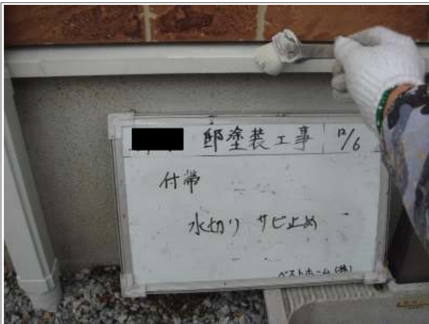
付帯 水切りサビ止め施工中
