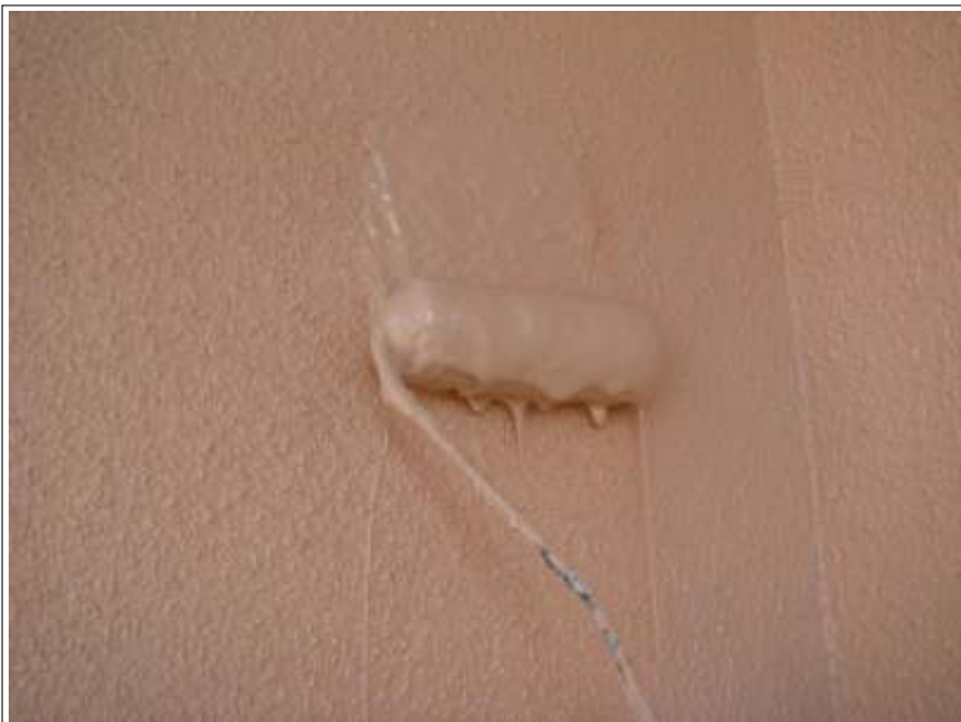
外壁上塗り2回目施工中
