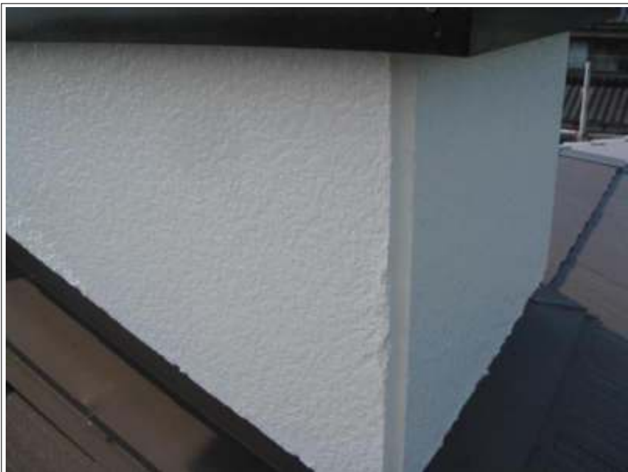
外壁施工完了
