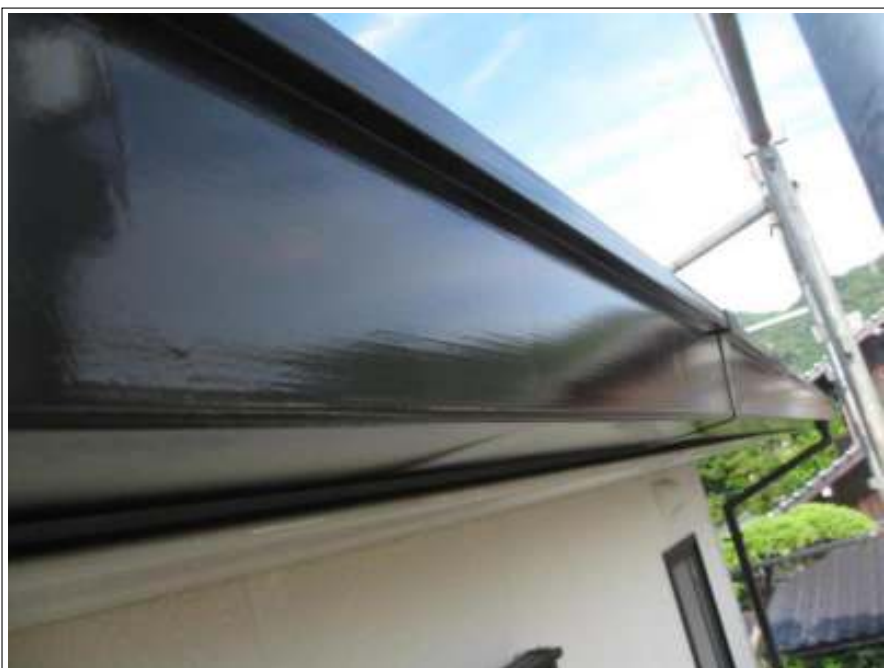
破風施工完了
