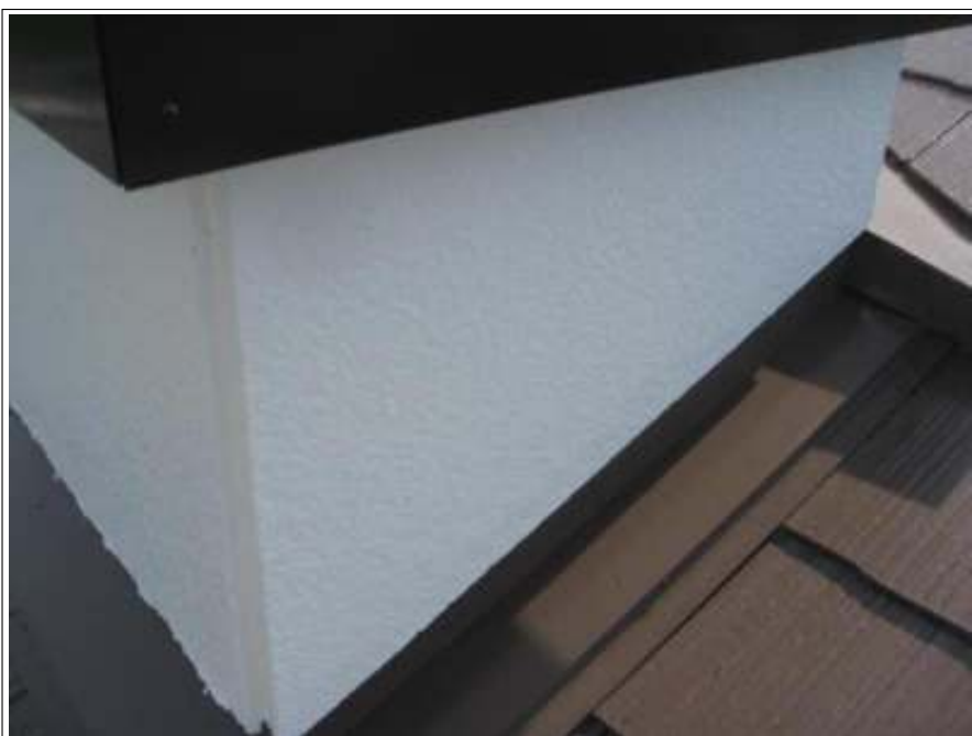
外壁施工完了
