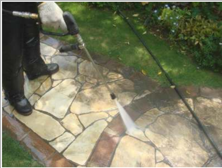
玄関前タイル高圧洗浄施工状況
