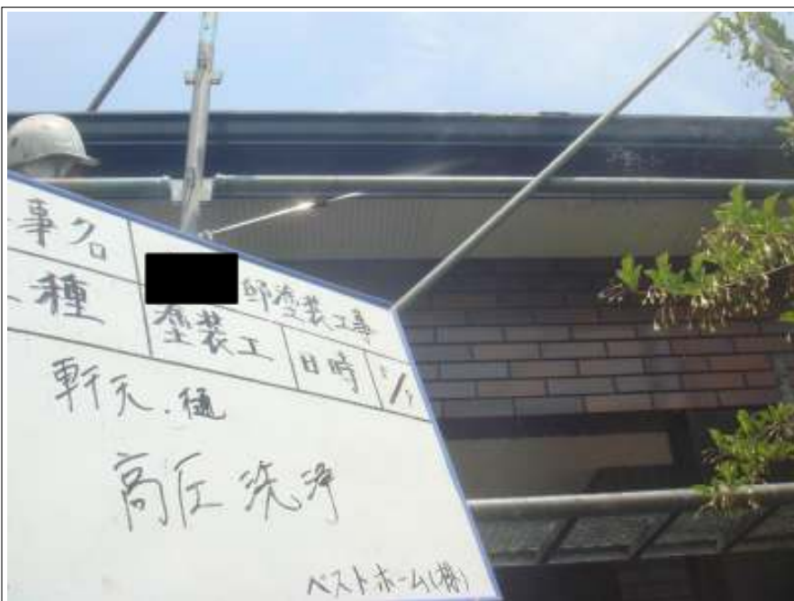
軒天・樋高圧洗浄施工状況
