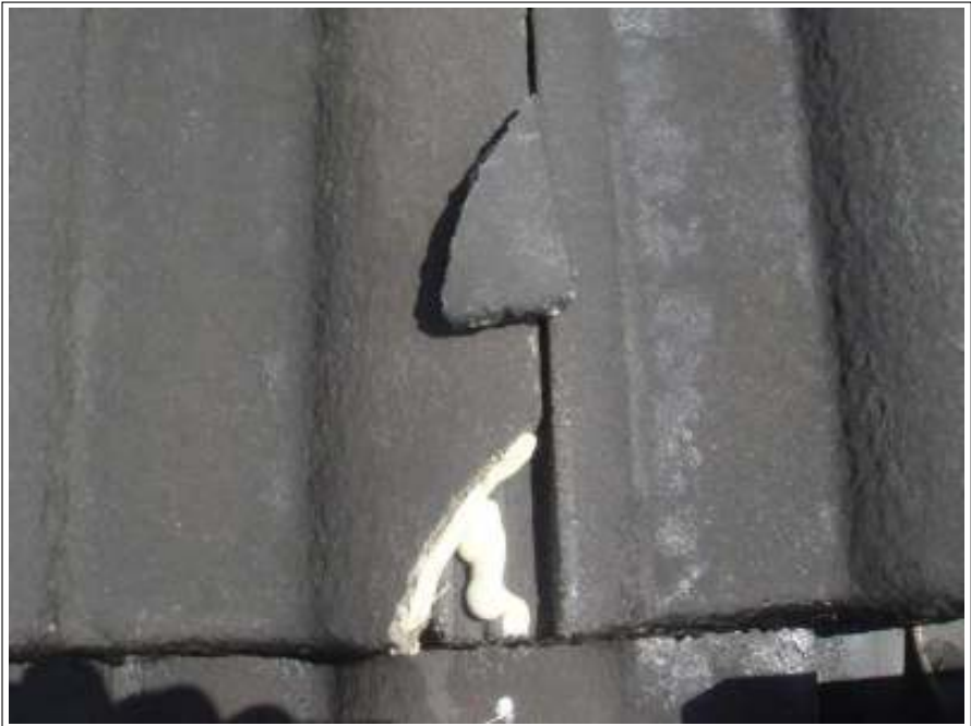
屋根クラック補修施工状況
