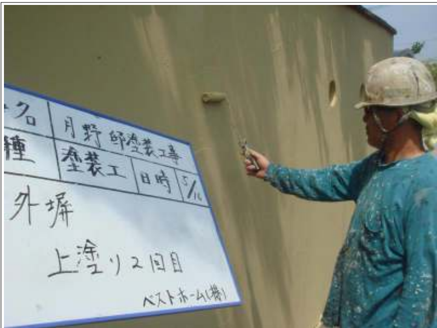
外塀上塗り施工状況 (2回目)
