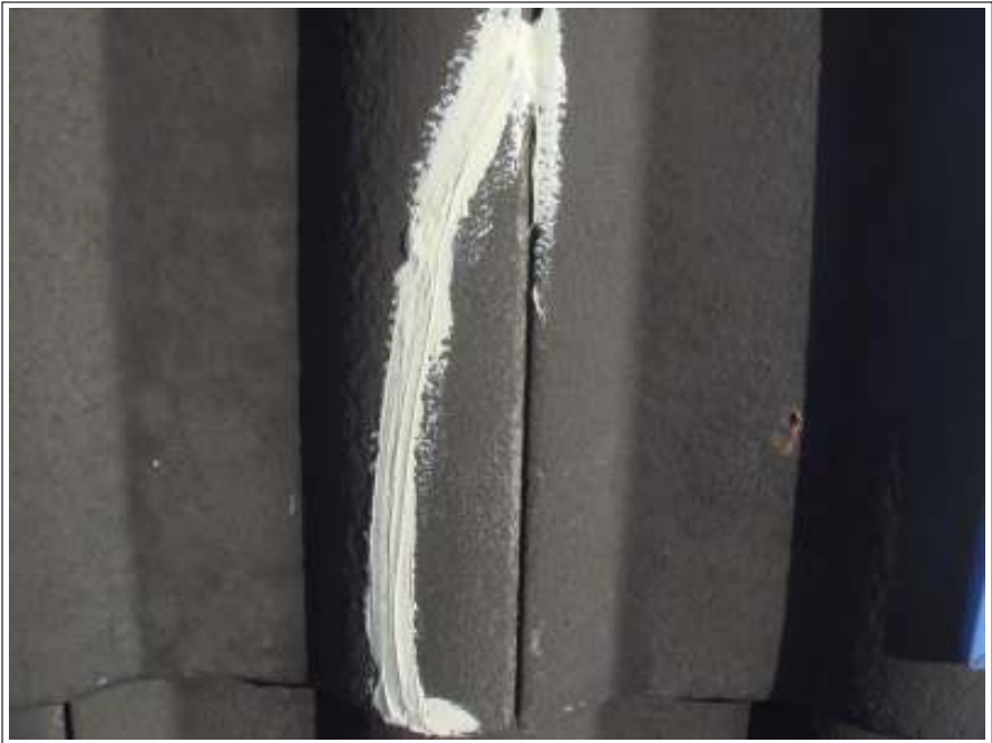
屋根クラック補修施工完了
