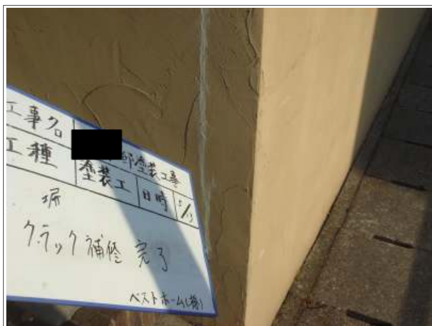
塀クラック補修施工完了
