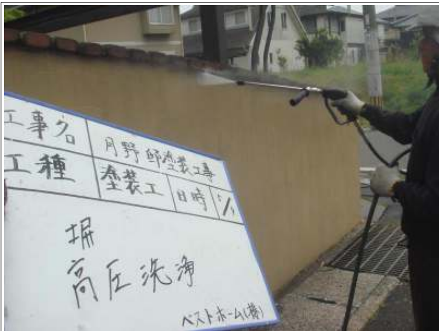
塀高圧洗浄施工状況
