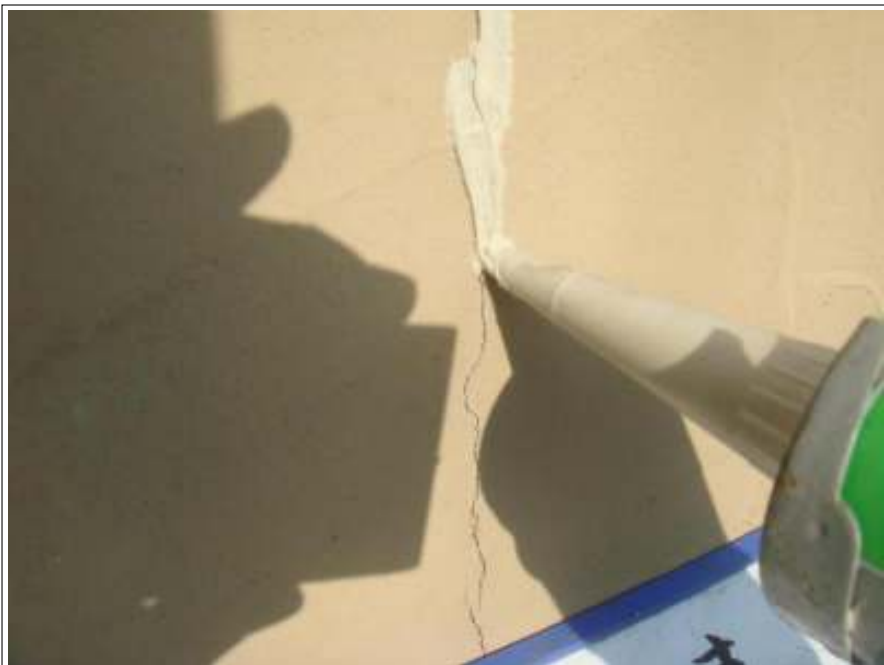
塀クラック補修施工中
