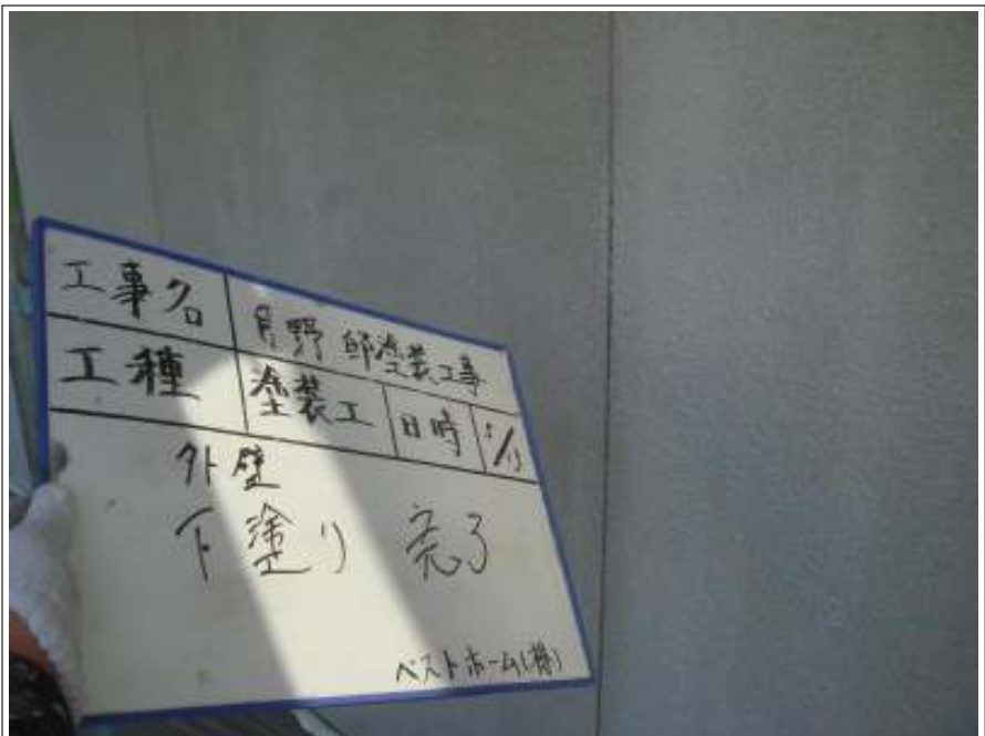
外壁下塗り施工完了
