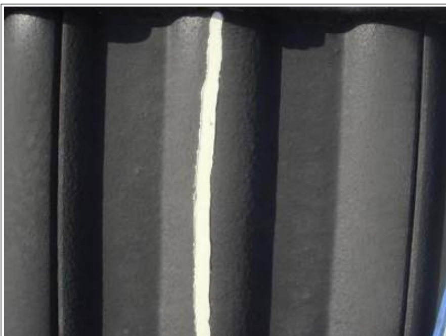
屋根クラック補修施工完了
