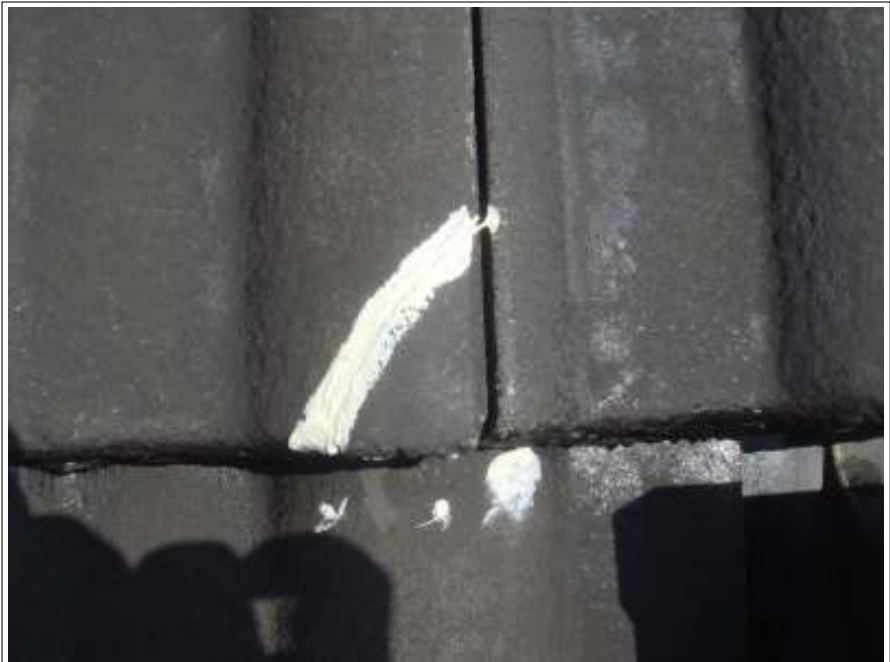
屋根クラック補修施工完了
