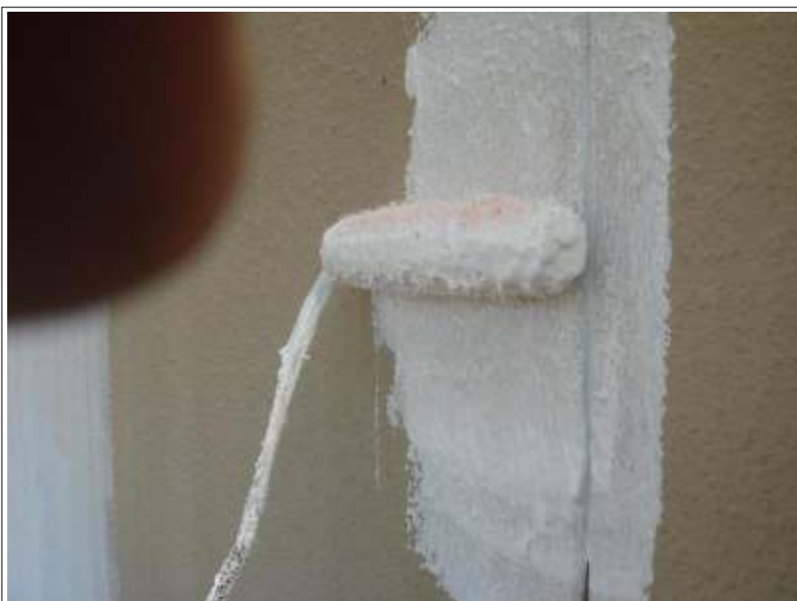
外壁下塗り施工中
