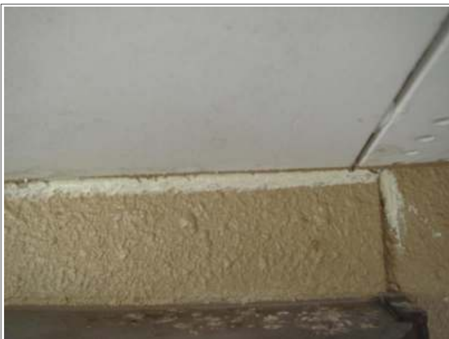
外壁クラック補修施工完了
