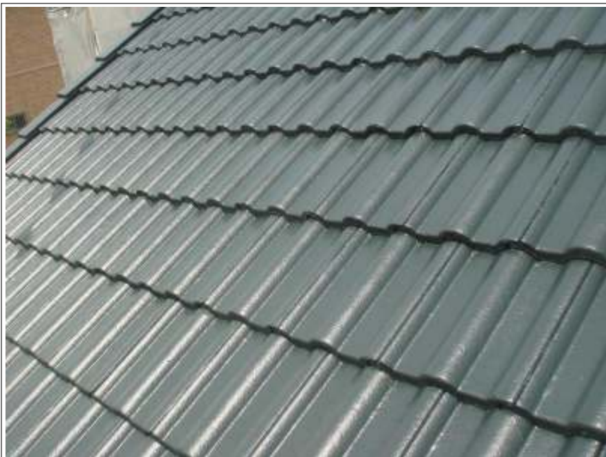
屋根上塗り施工完了 (2回目)
