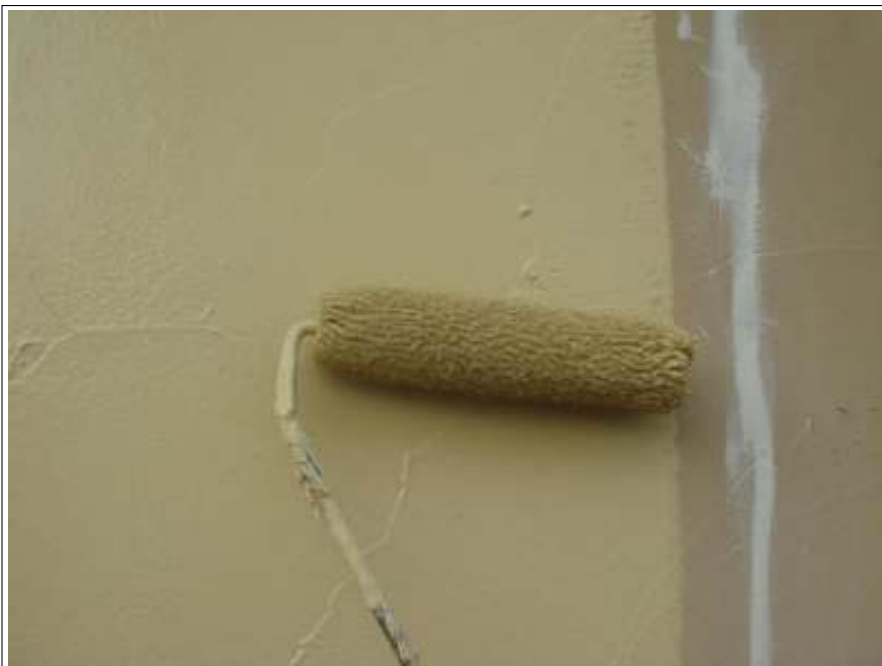
外塀上塗り施工中 (1回目)
