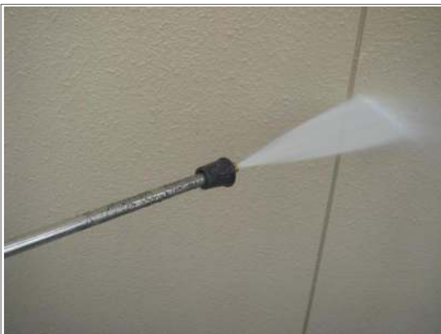
外壁高圧洗浄施工中
