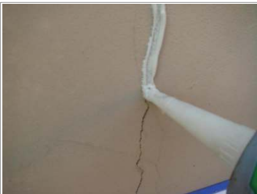
塀クラック補修施工中
