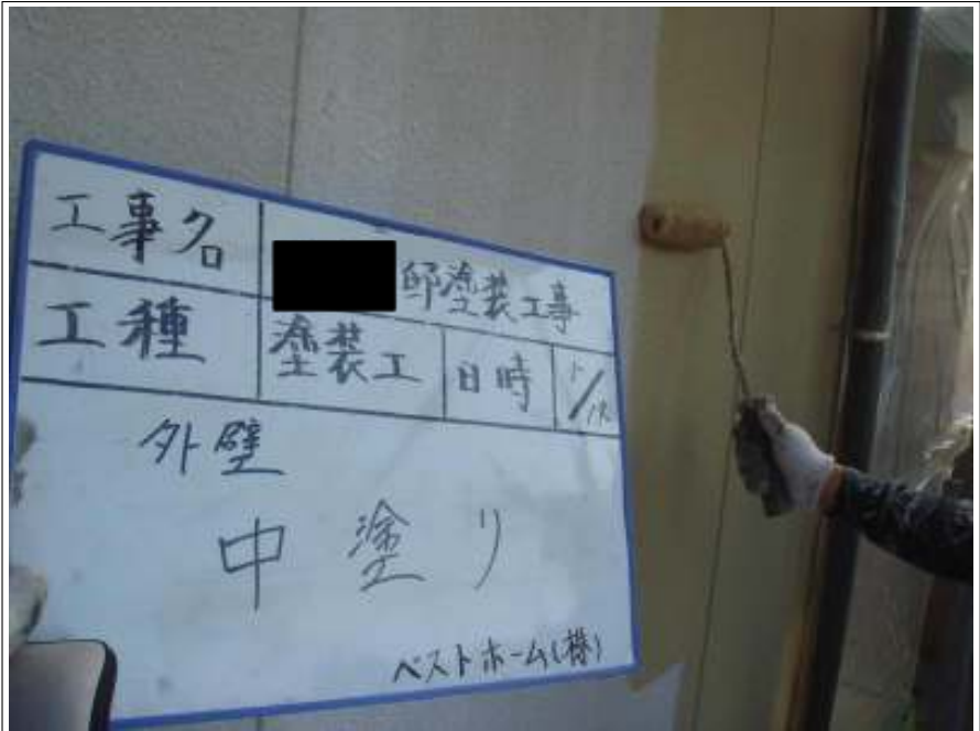
外壁中塗り施工状況
