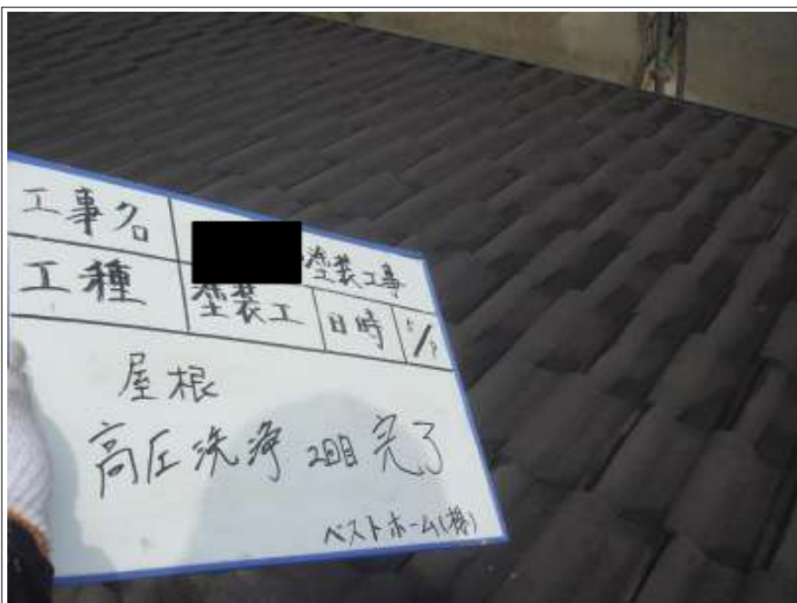
屋根高圧洗浄施工完了 (2回目)
