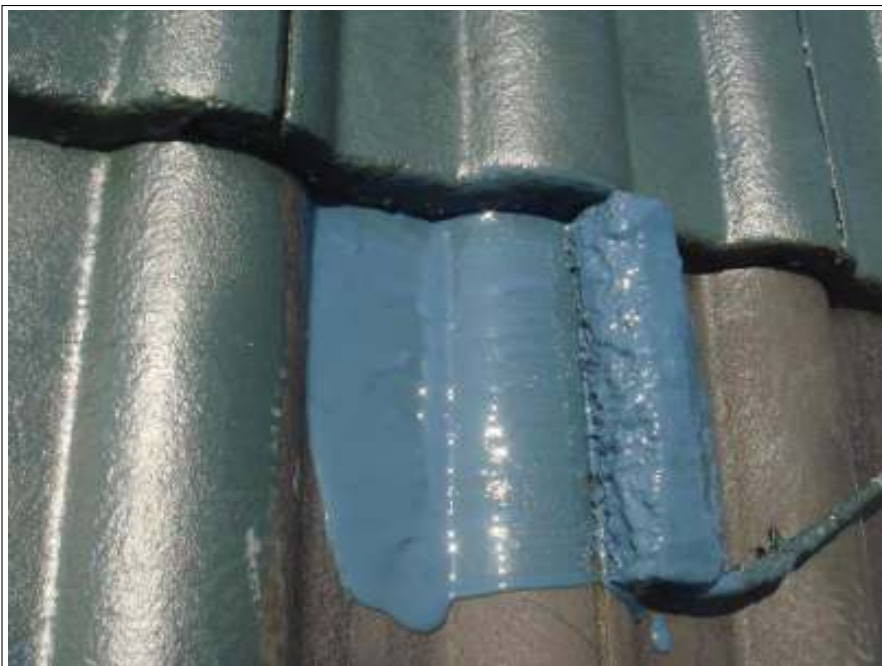
屋根上塗り施工中 (1回目)
