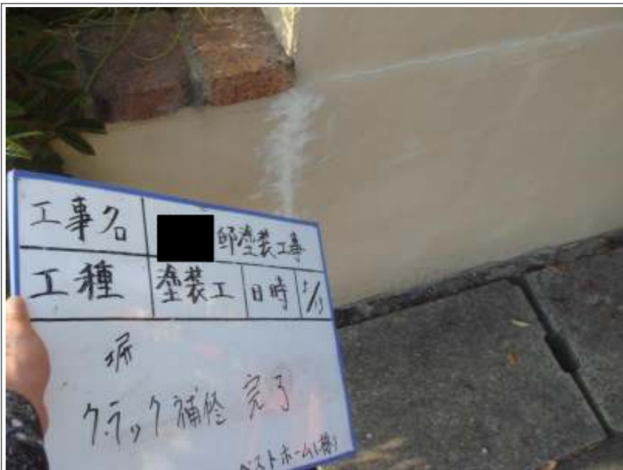
塀クラック補修施工完了
