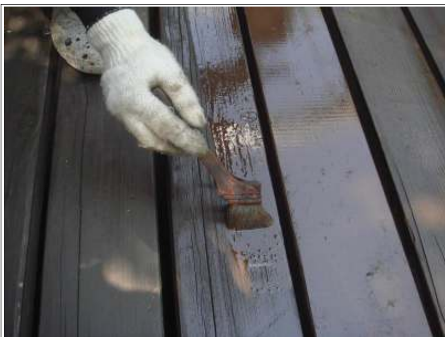
ウッドデッキ施工中 (2回目)
