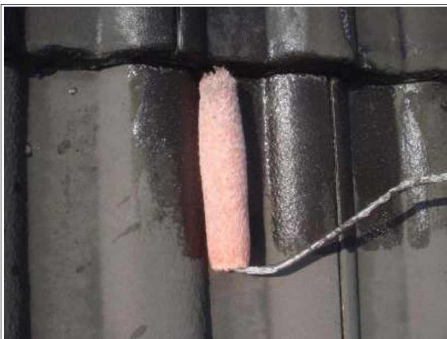
屋根下塗り施工中 (1回目)
