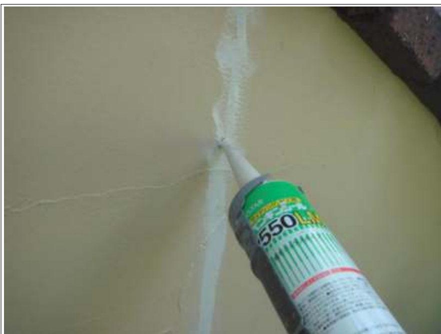
塀クラック補修施工中
