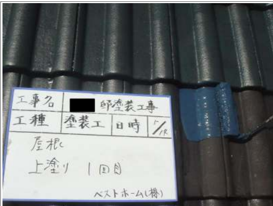
屋根上塗り施工状況 (1回目)
