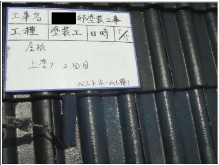
屋根上塗り施工状況 (2回目)
