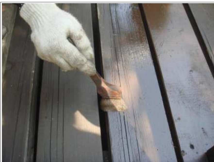
ウッドデッキ施工中 (1回目)
