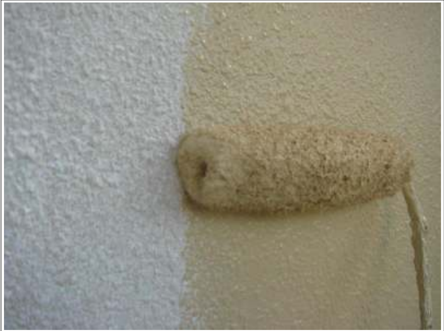
外壁中塗り施工中
