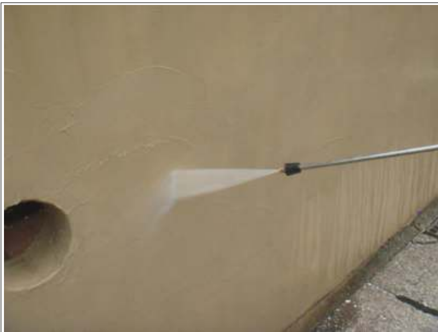
塀高圧洗浄施工中
