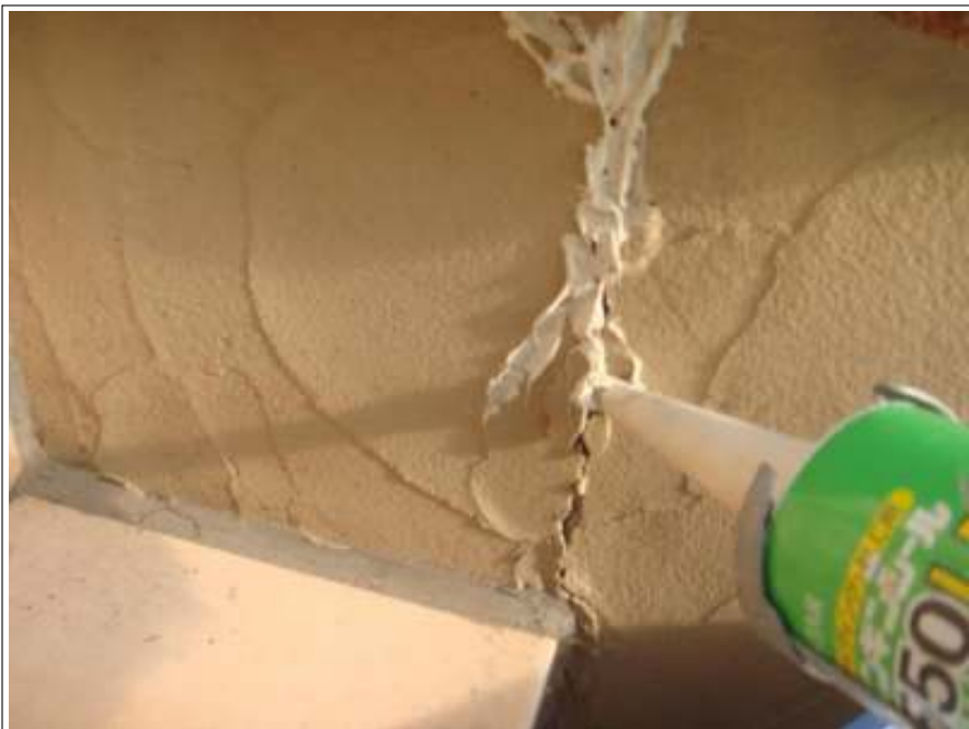
塀クラック補修施工中
