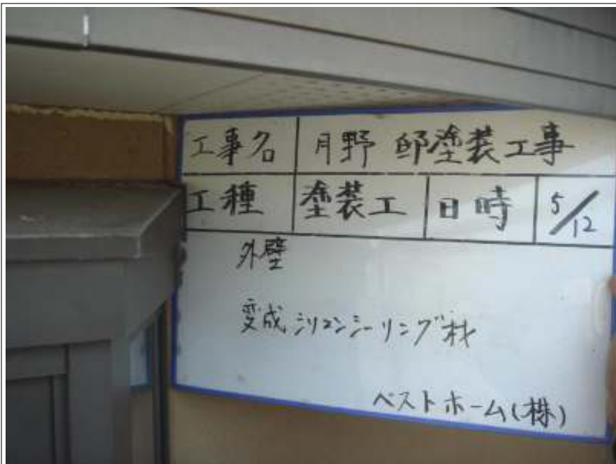
外壁クラック補修施工状況
