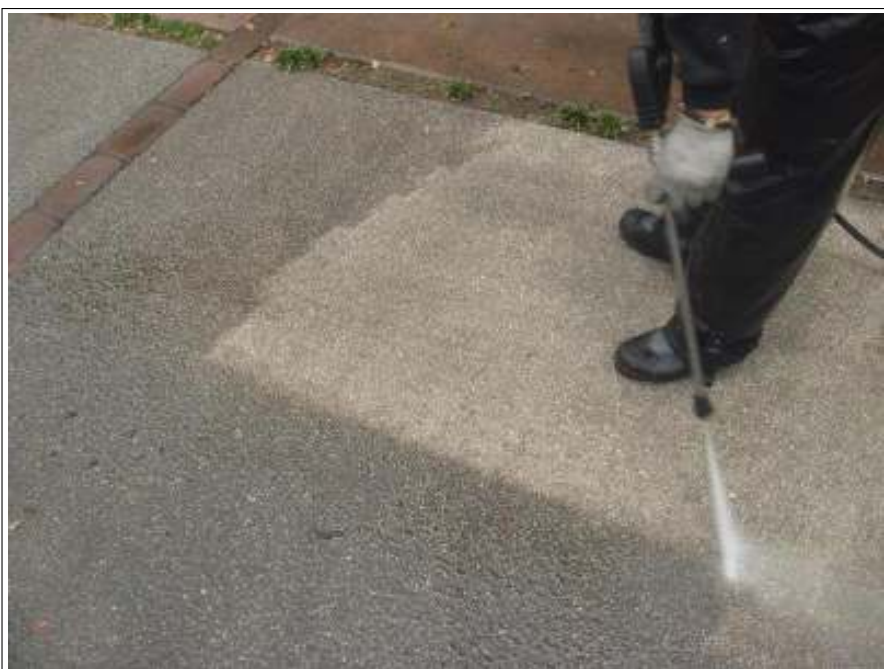
土間高圧洗浄施工状況
