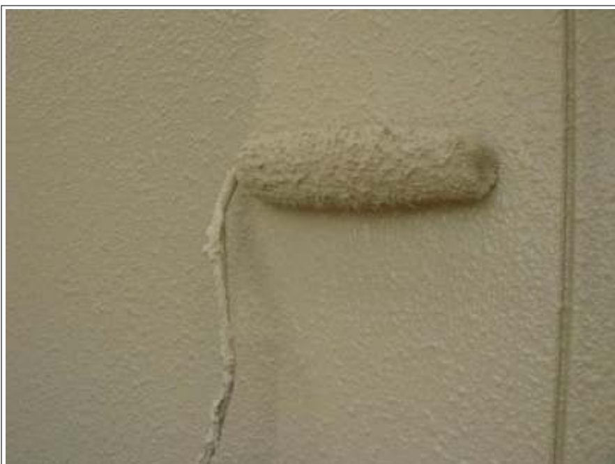
外壁上塗り施工中
