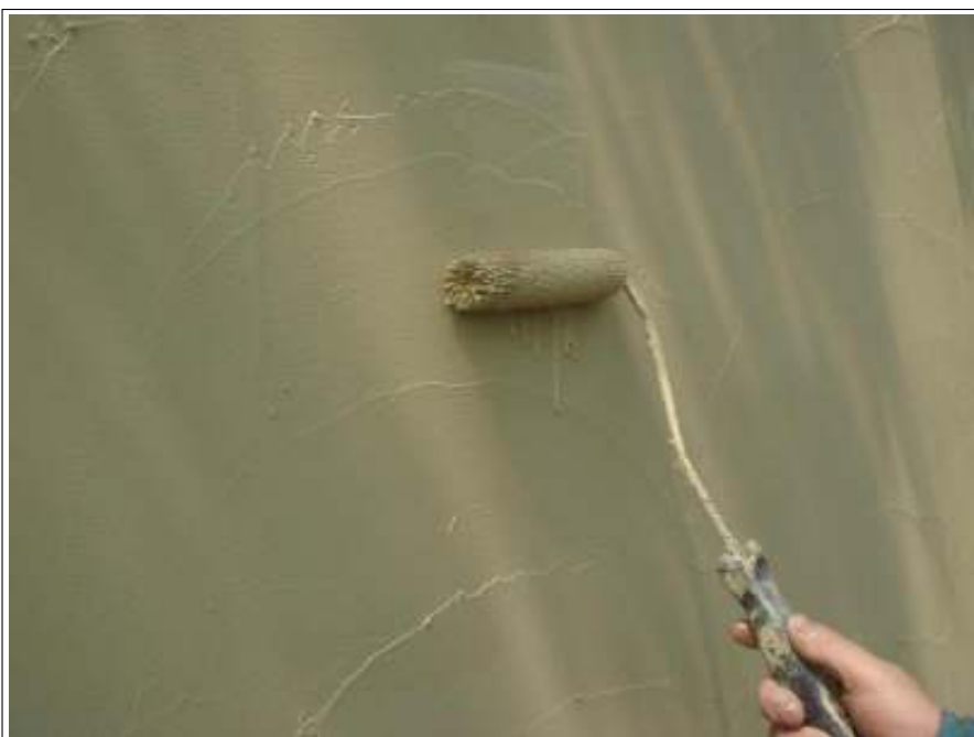
外塀上塗り施工中 (2回目)
