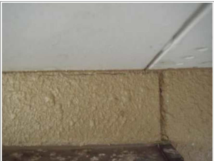
外壁クラック補修施工前
