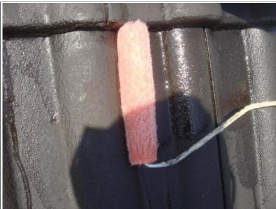
屋根下塗り施工中 (2回目)
