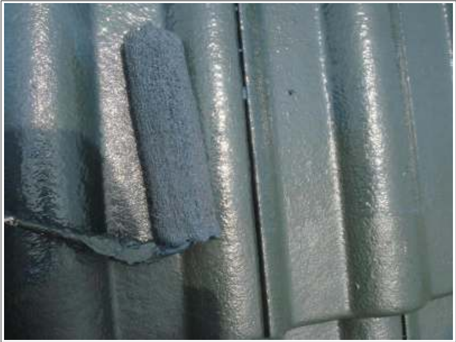
屋根上塗り施工中 (2回目)
