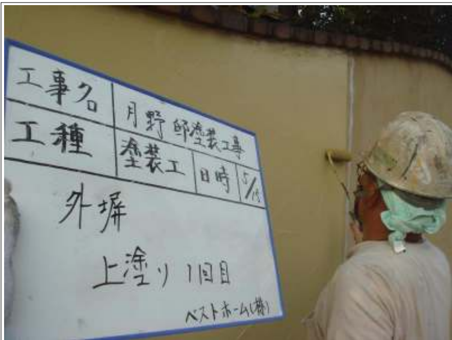
外塀上塗り施工状況 (1回目)
