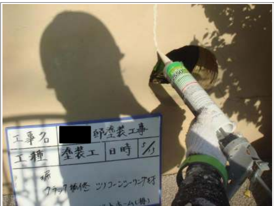
塀クラック補修施工状況
