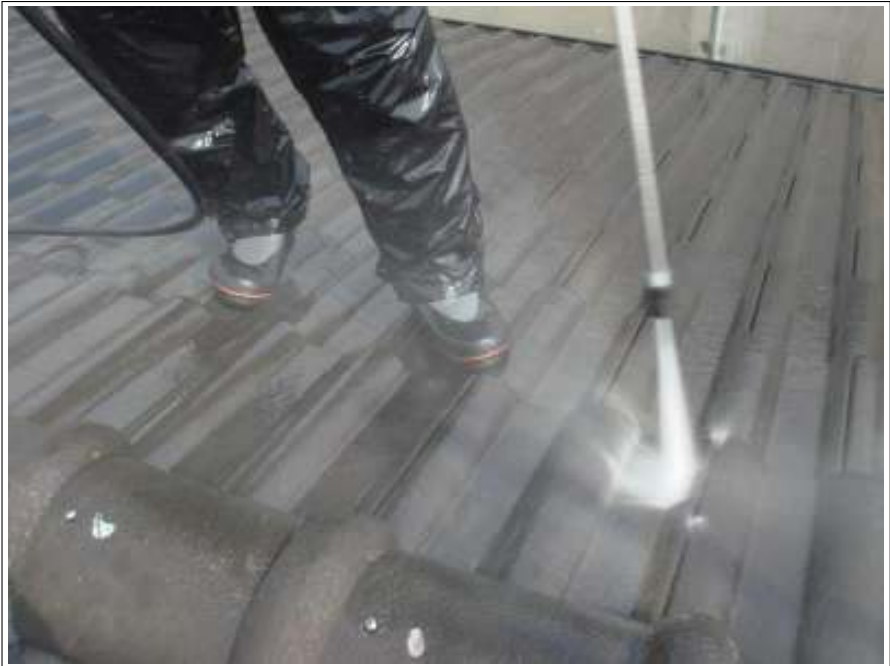
屋根高圧洗浄施工中 (1回目)
