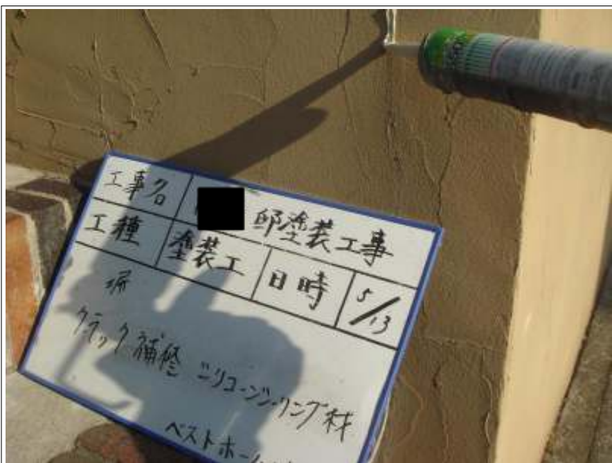
塀クラック補修施工状況
