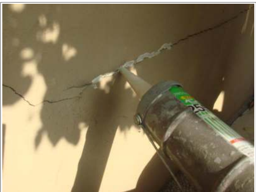
塀クラック補修施工中
