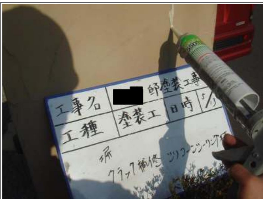
塀クラック補修施工状況
