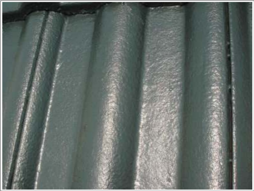
屋根上塗り施工完了 (2回目)
