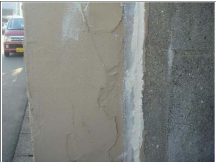
塀クラック補修施工中
