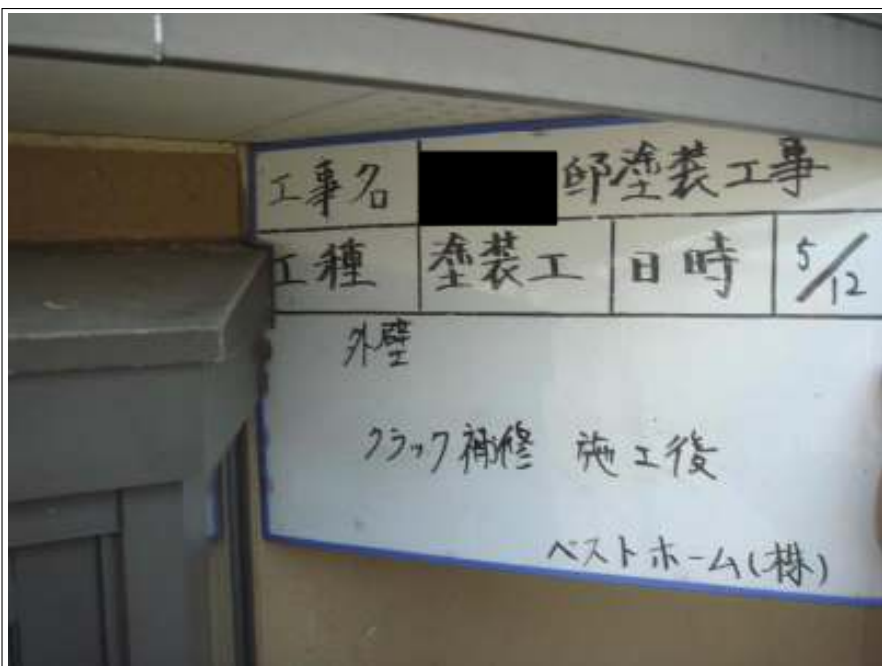
外壁クラック補修施工完了
