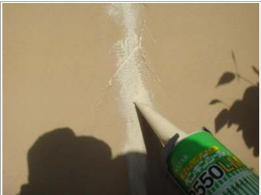
塀クラック補修施工中
