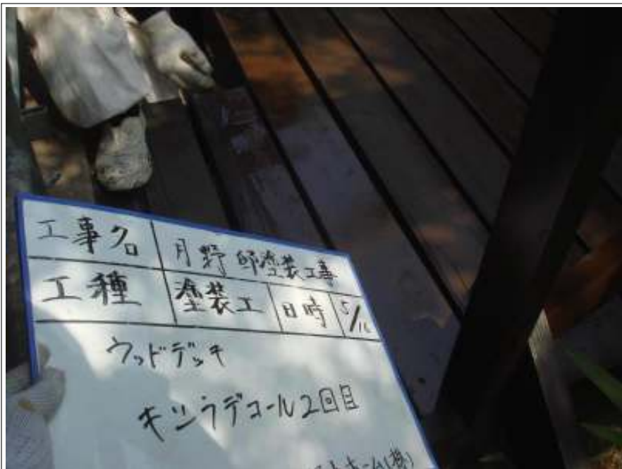
ウッドデッキ施工状況 (2回目)
