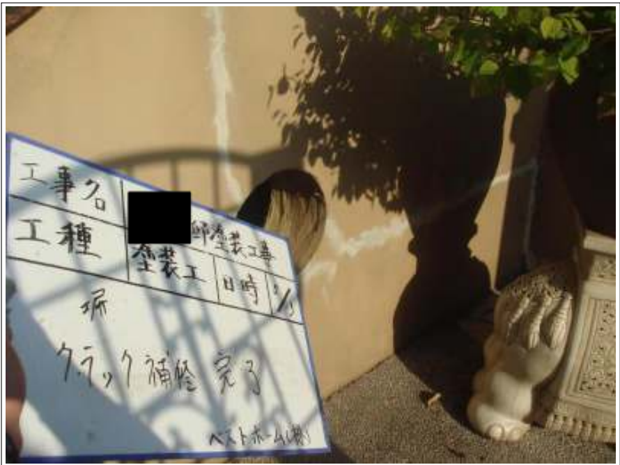
塀クラック補修施工完了
