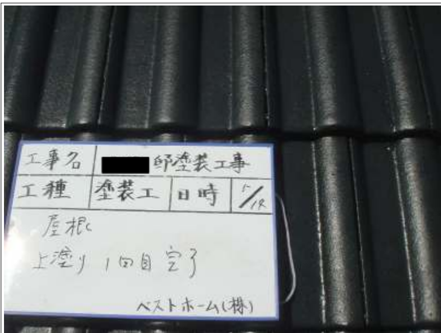
屋根上塗り施工完了 (1回目)
