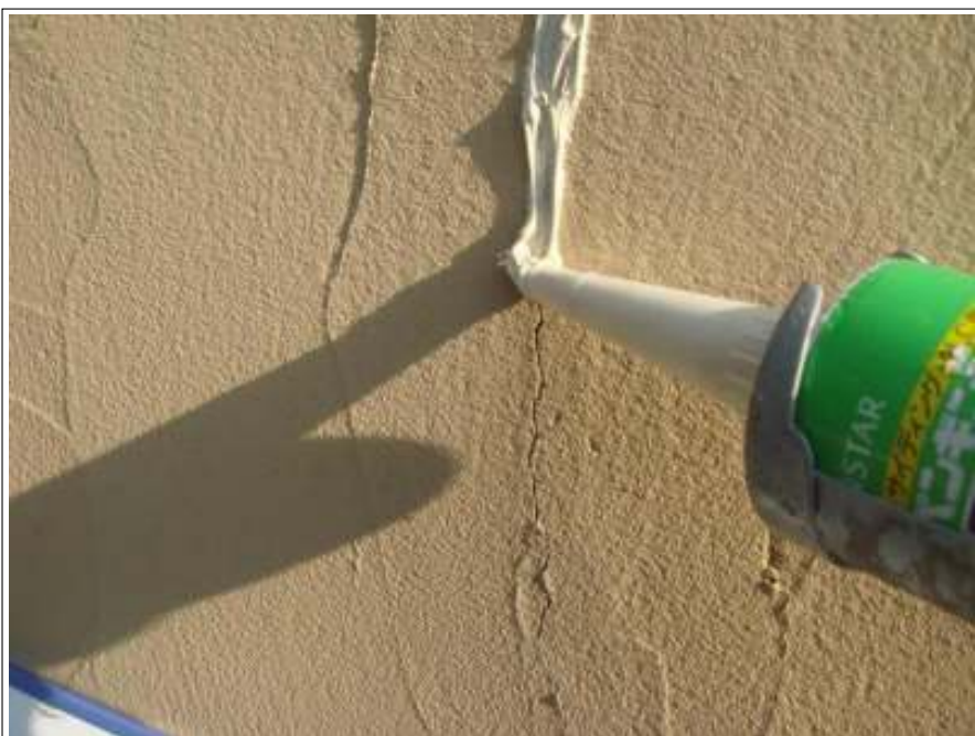
塀クラック補修施工中
