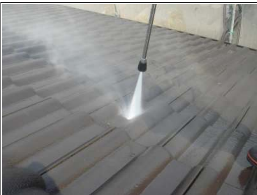
屋根高圧洗浄施工中 (2回目)
