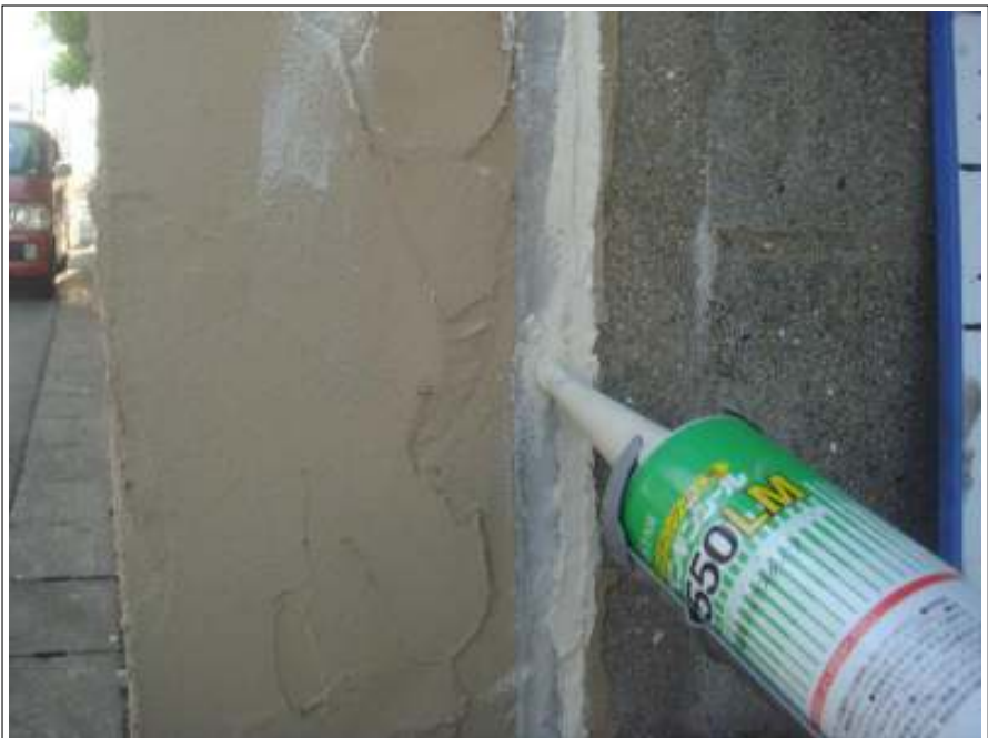
塀クラック補修施工状況
