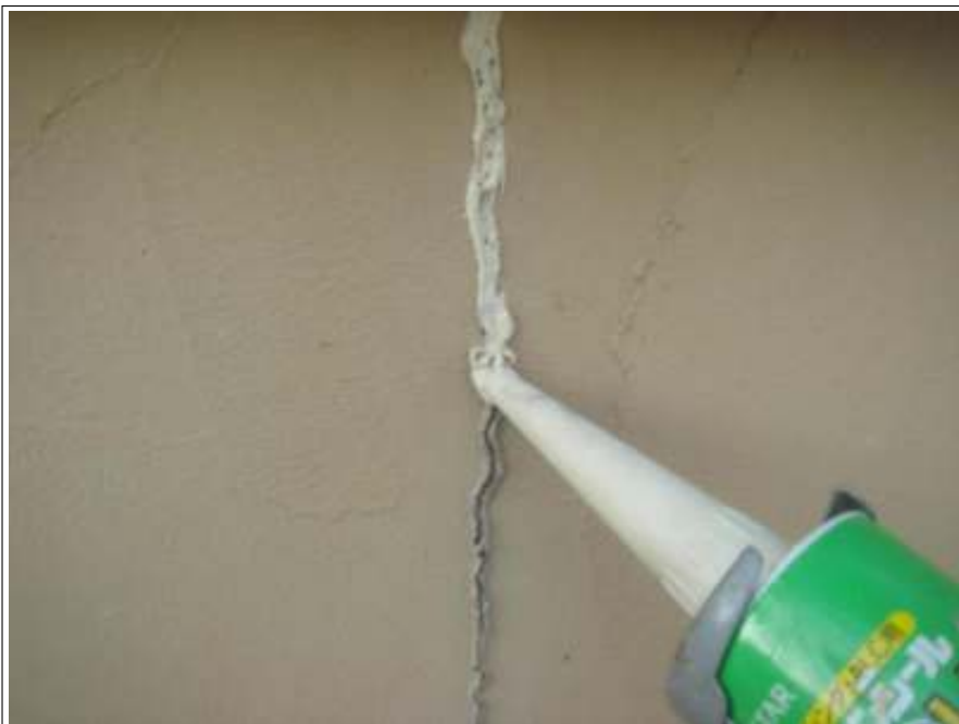
塀クラック補修施工中
