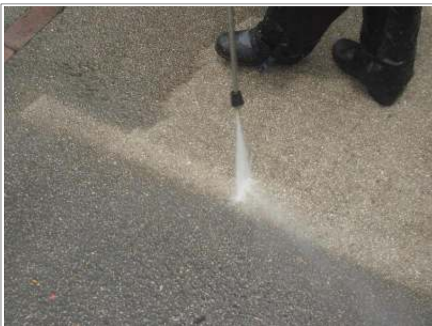
土間高圧洗浄施工中
