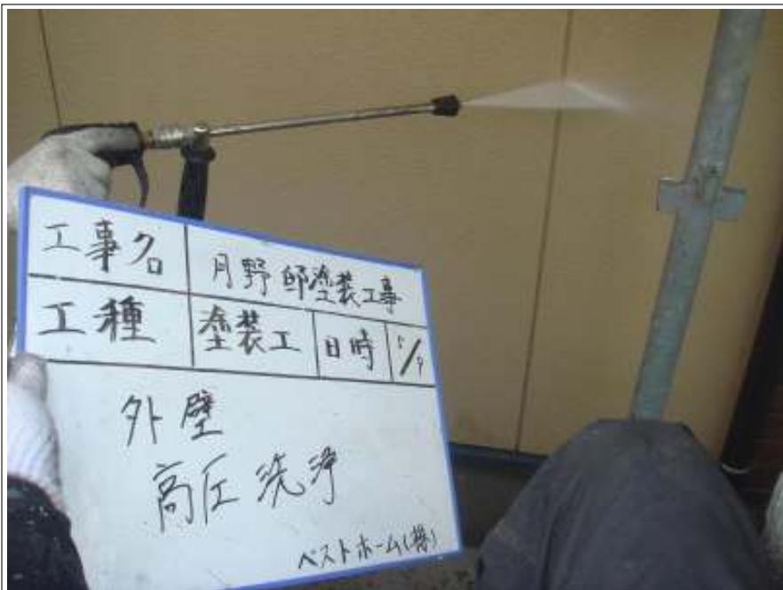
外壁高圧洗浄施工状況
