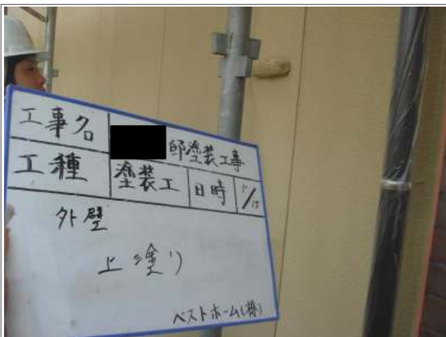
外壁上塗り施工状況
