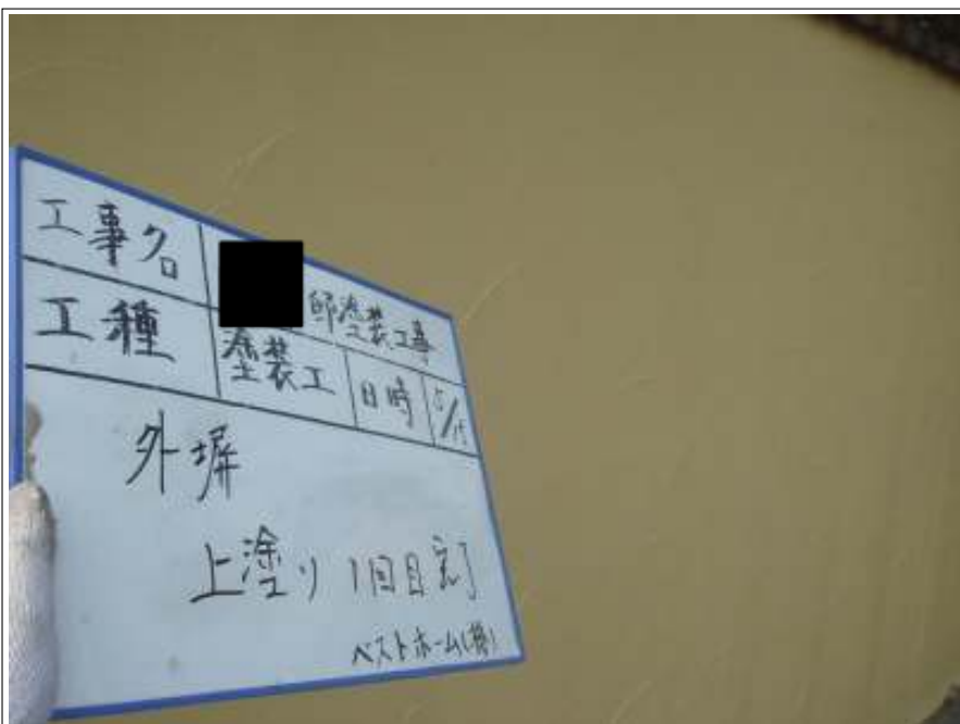
外塀上塗り施工完了 (1回目)
