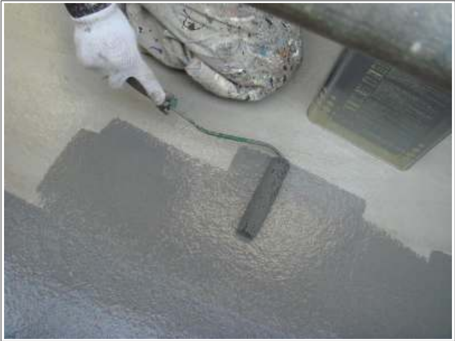
バルコニー上塗り施工中
