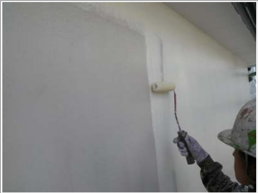
外壁塗装中塗り施工中
