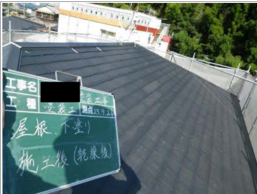
屋根塗装下塗り施工後
