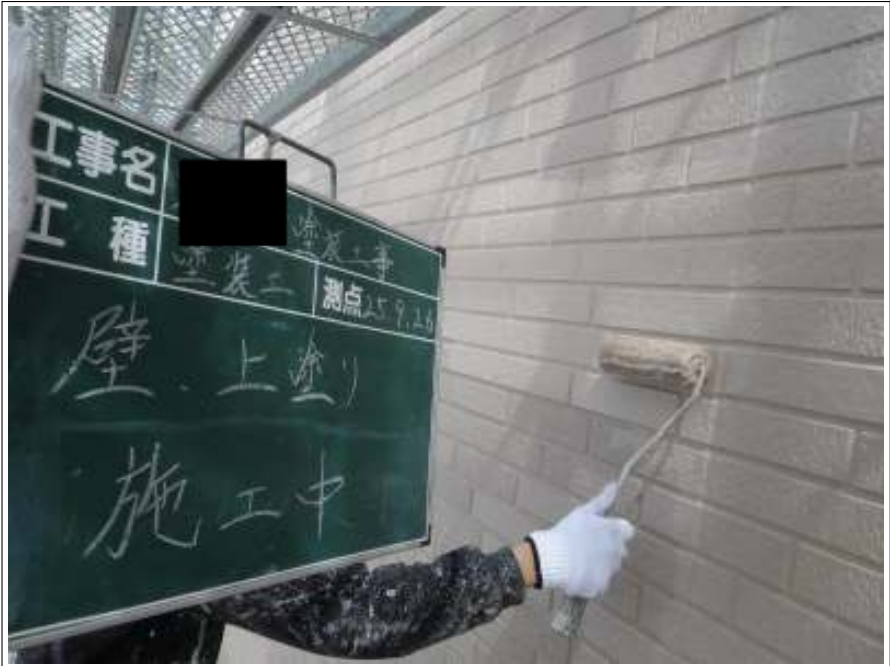
外壁塗装上塗り施工中
