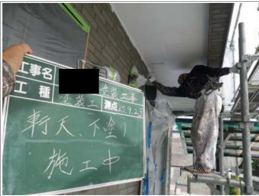
軒天塗装下塗り施工中
