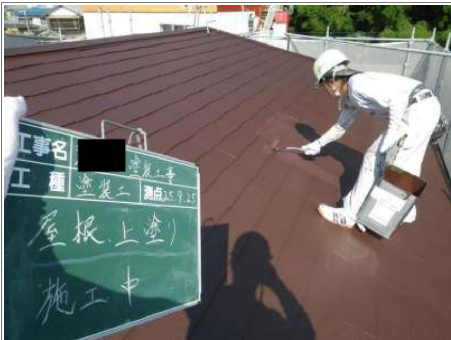
屋根塗装上塗り施工中
