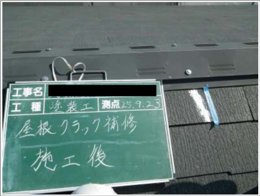
屋根クラック補修施工後
