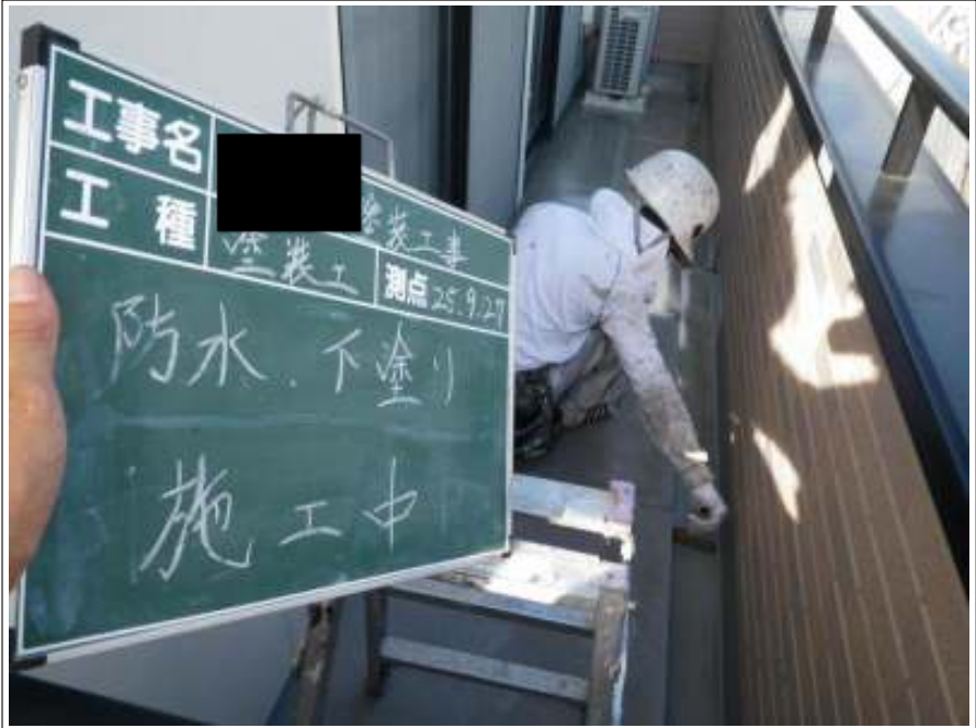
防水下塗り施工中
