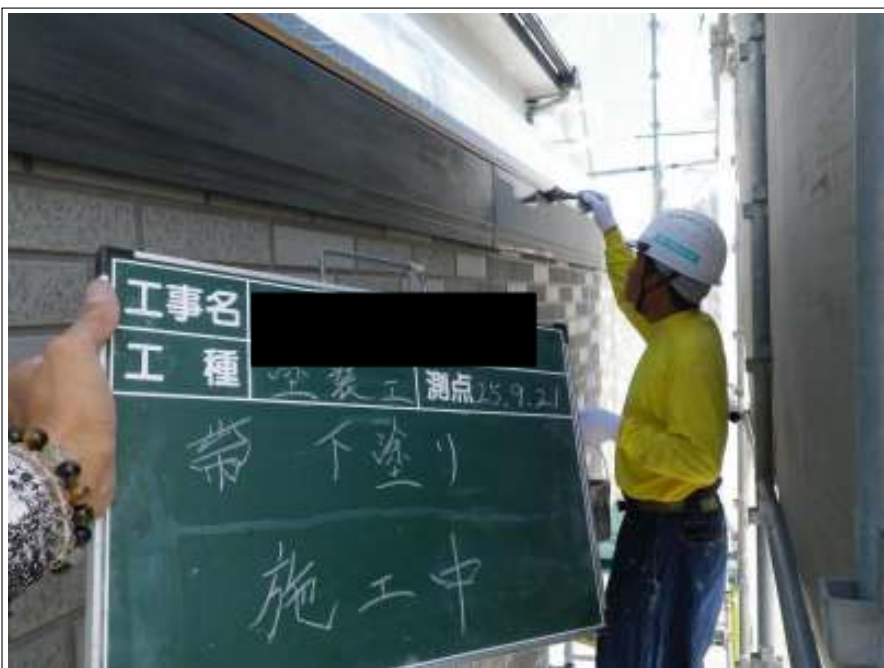
帯下塗り施工中
