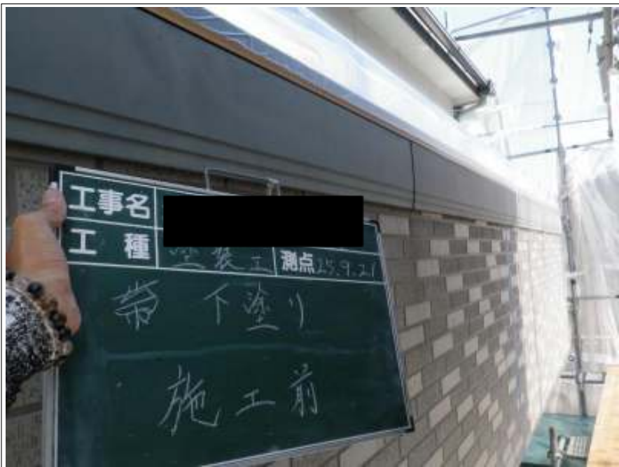
帯下塗り施工前
