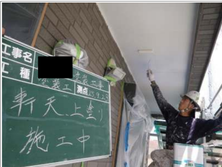
軒天塗装上塗り施工中
