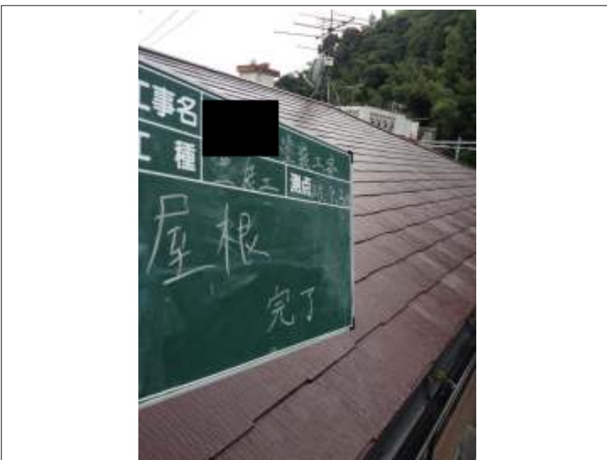
屋根塗装上塗り完了
