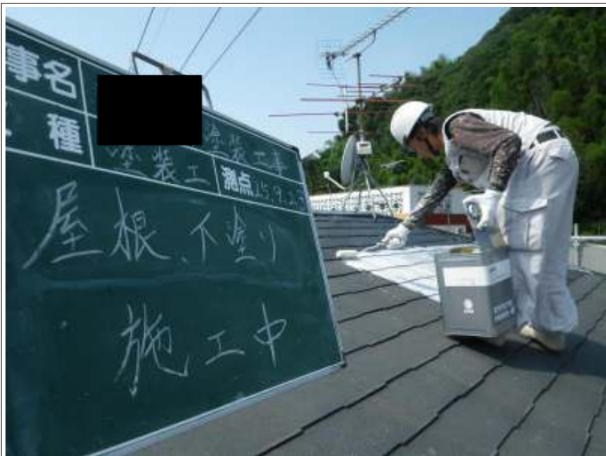
屋根塗装下塗り施工中
