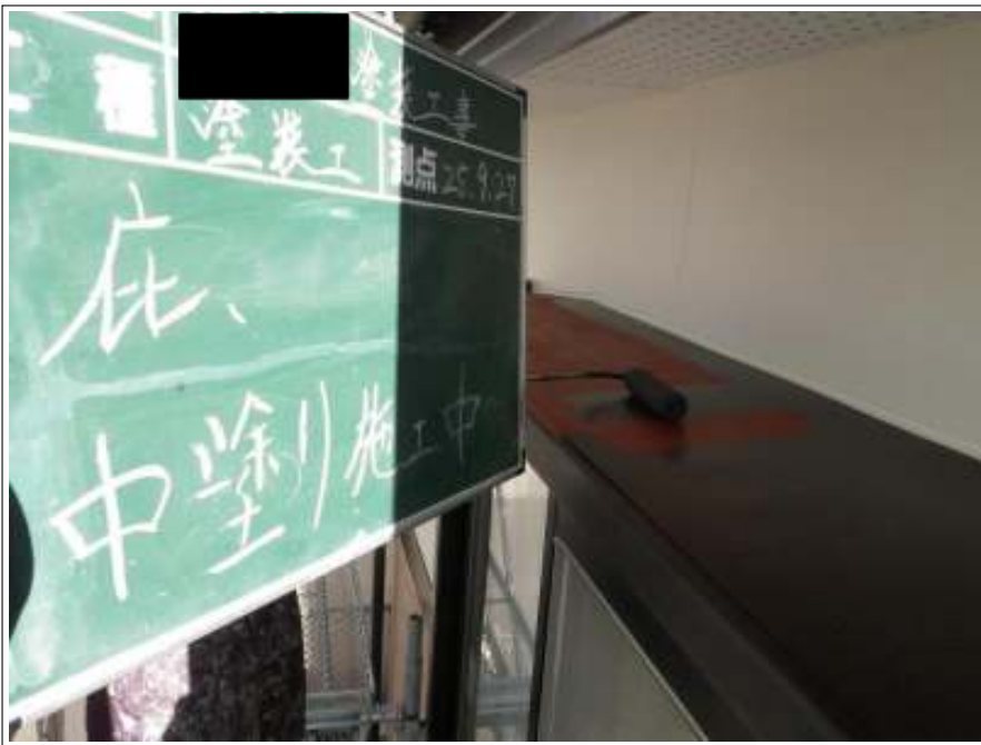
底中塗り施工中
