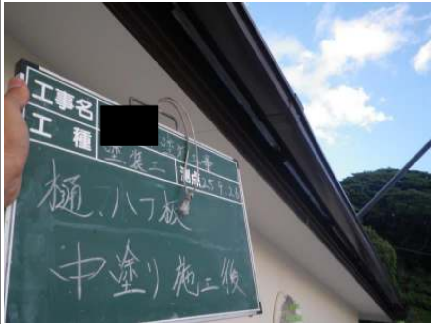
樋・ハフ板中塗り施工後
