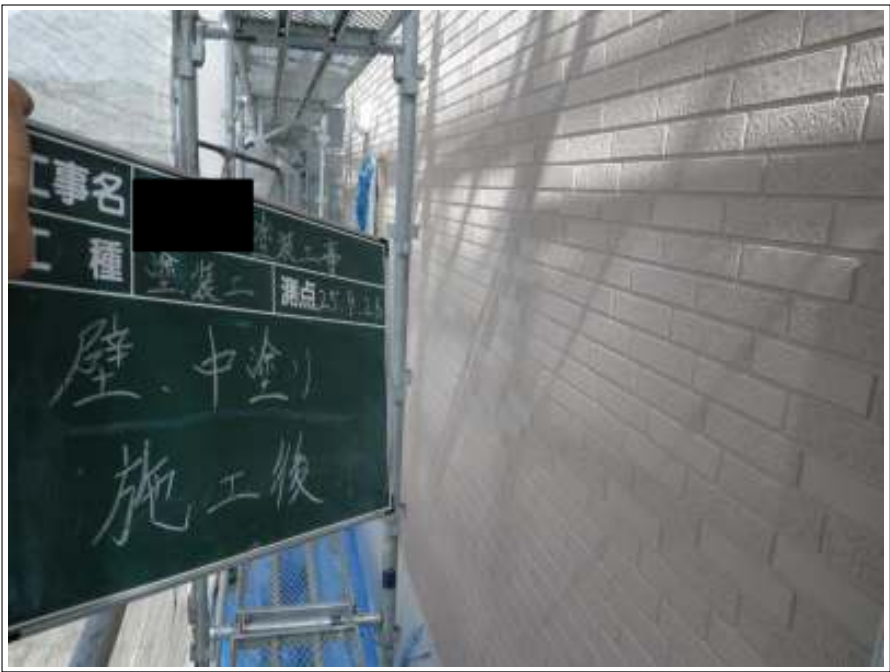
外壁塗装中塗り施工中
