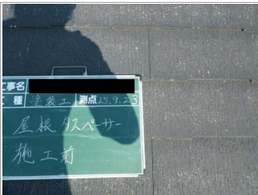
屋根タスペーサー施工前
