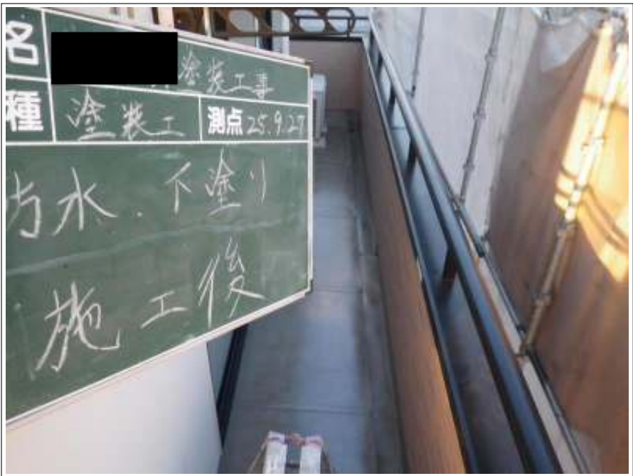
防水下塗り施工後
