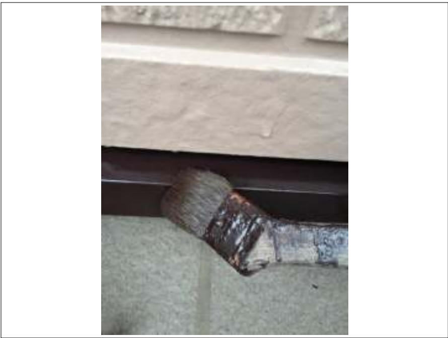
水切り上塗り施工中
