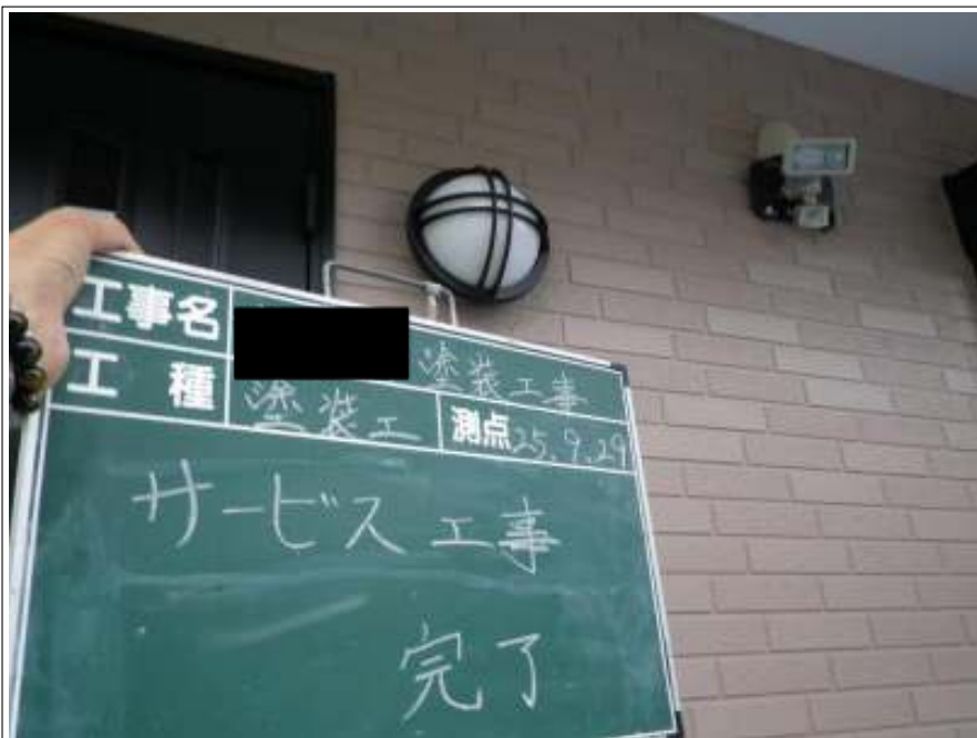
サービス工事塗装完了
