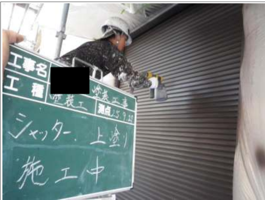
シャッター上塗り施工中
