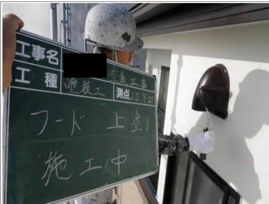
フード上塗り施工中
