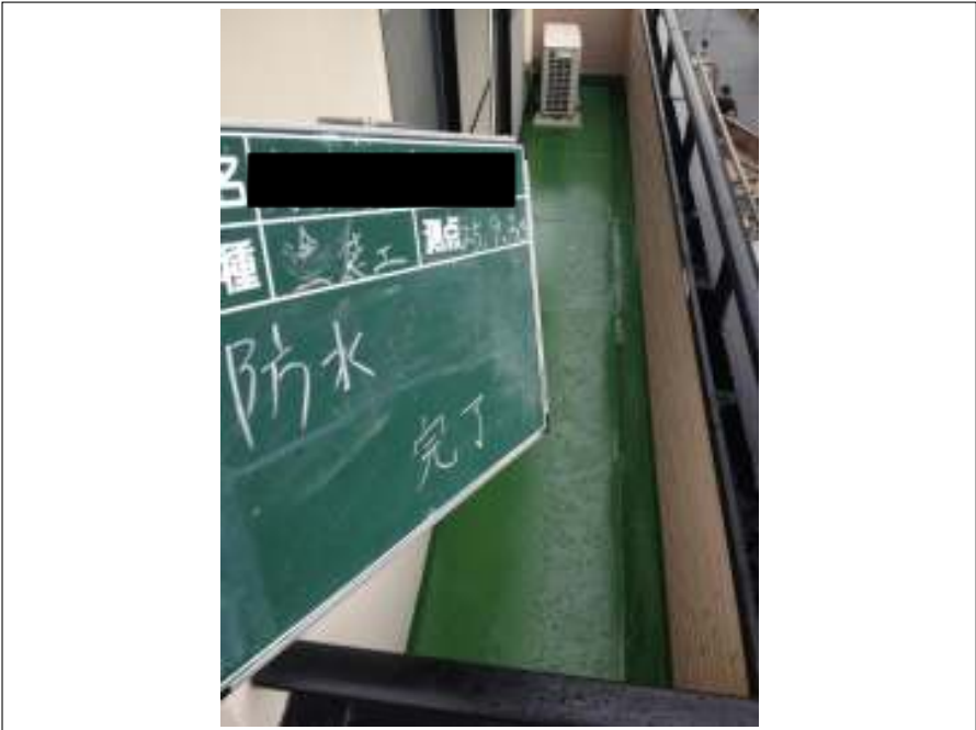
防水塗装完了
