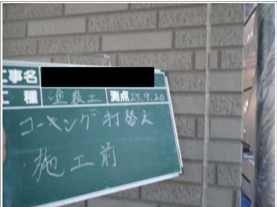
外壁コーキング打替え施工前
