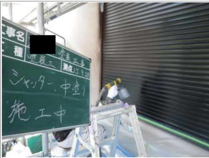
シャッター中塗り施工中
