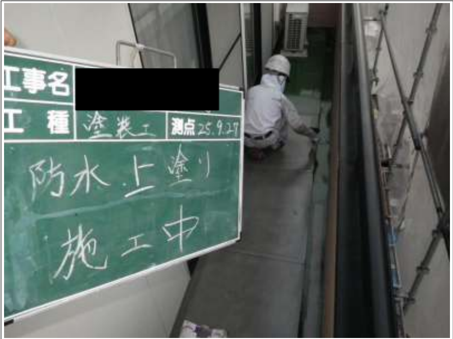
防水上塗り施工中
