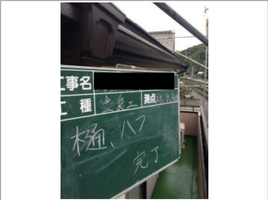
樋・ハフ板塗装完了
