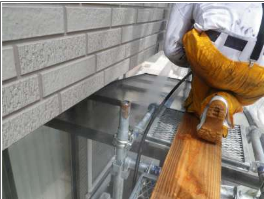
カーポート高圧洗浄中
