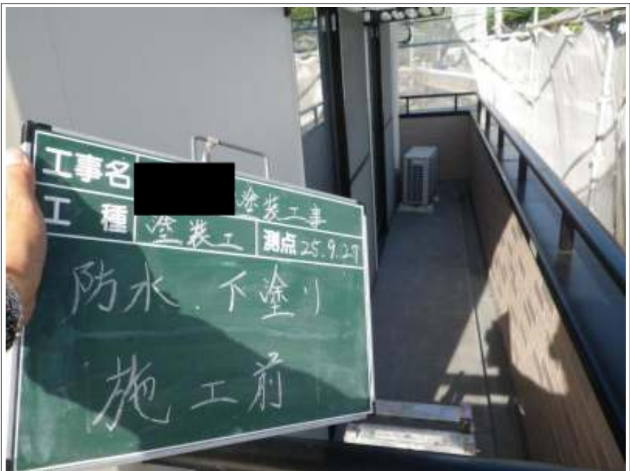
防水下塗り施工前
