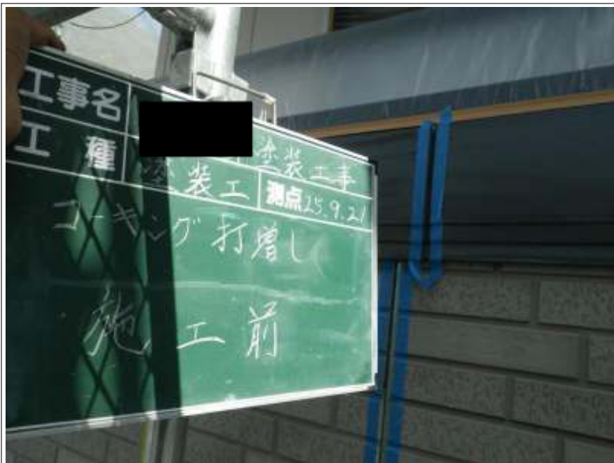
コーキング打増し施工前
