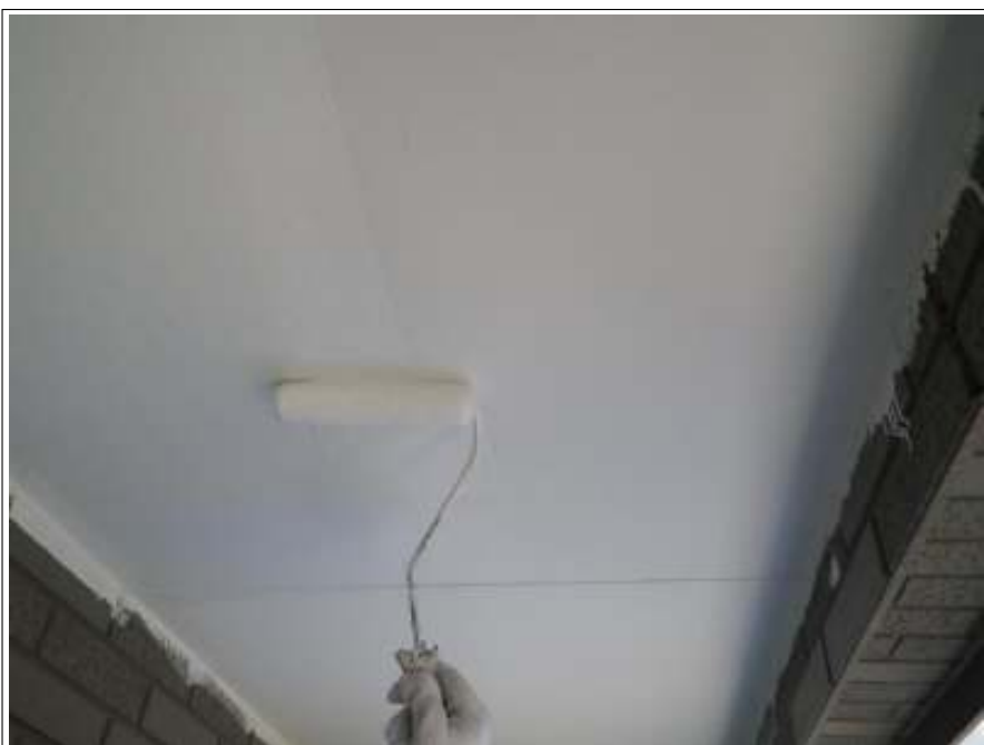
軒天塗装上塗り施工中
