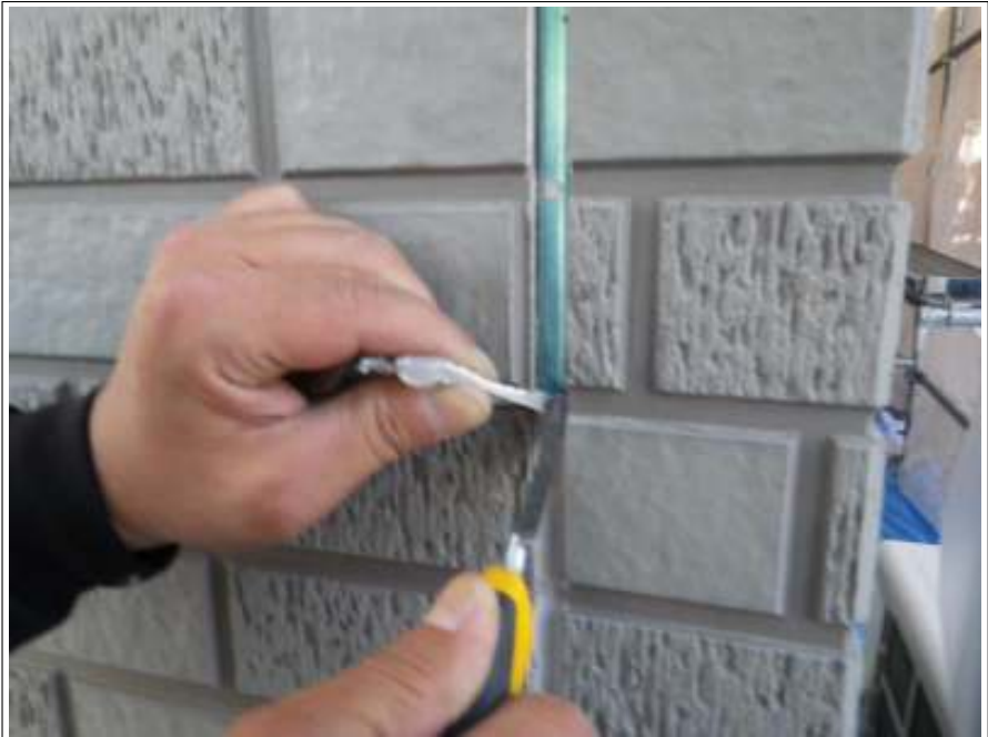
外壁コーキング打替え除去中
