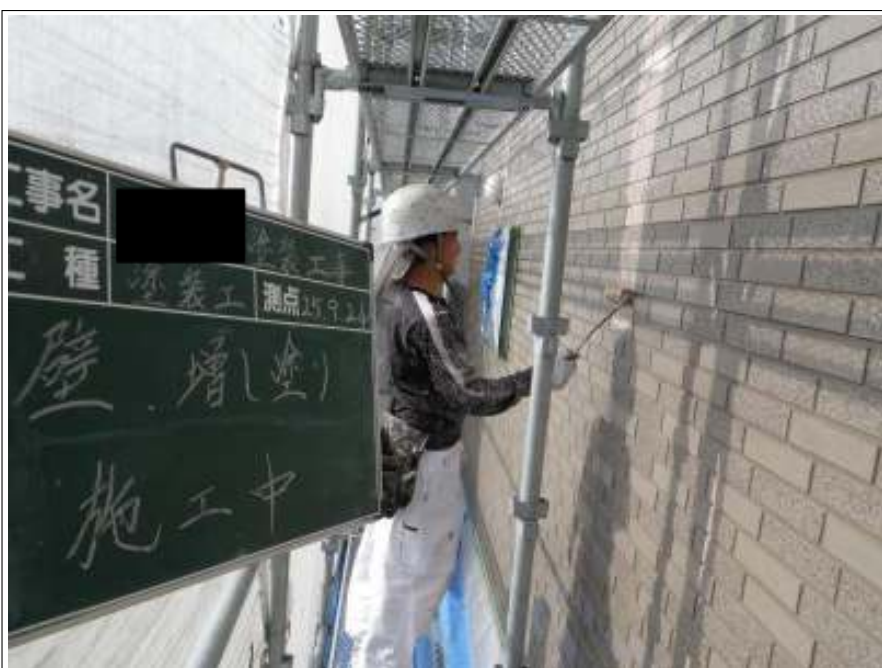
外壁塗装増し塗り施工中
