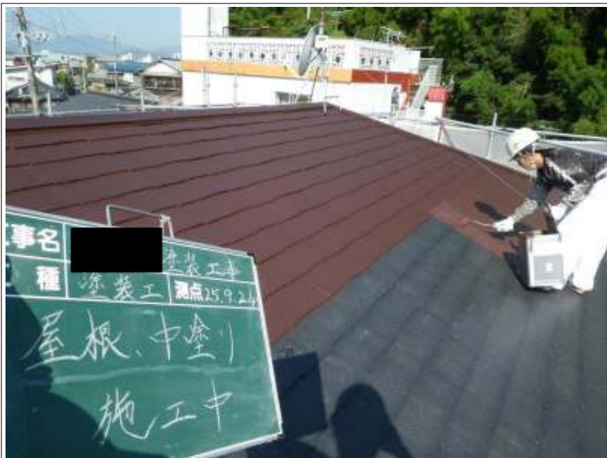
屋根塗装中塗り施工中
