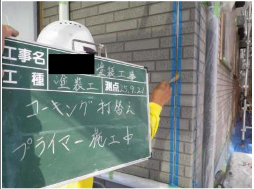
外壁コーキング打替え施工中
