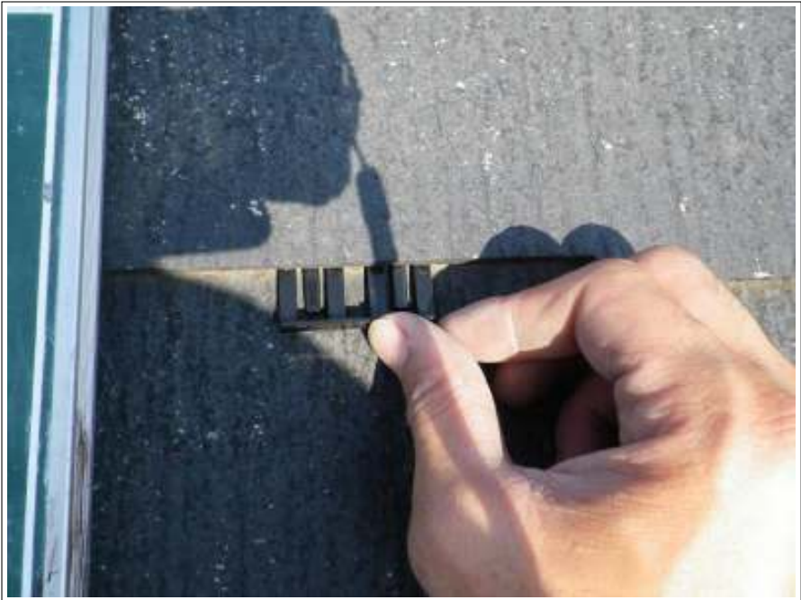
屋根タスペーサー施工中
