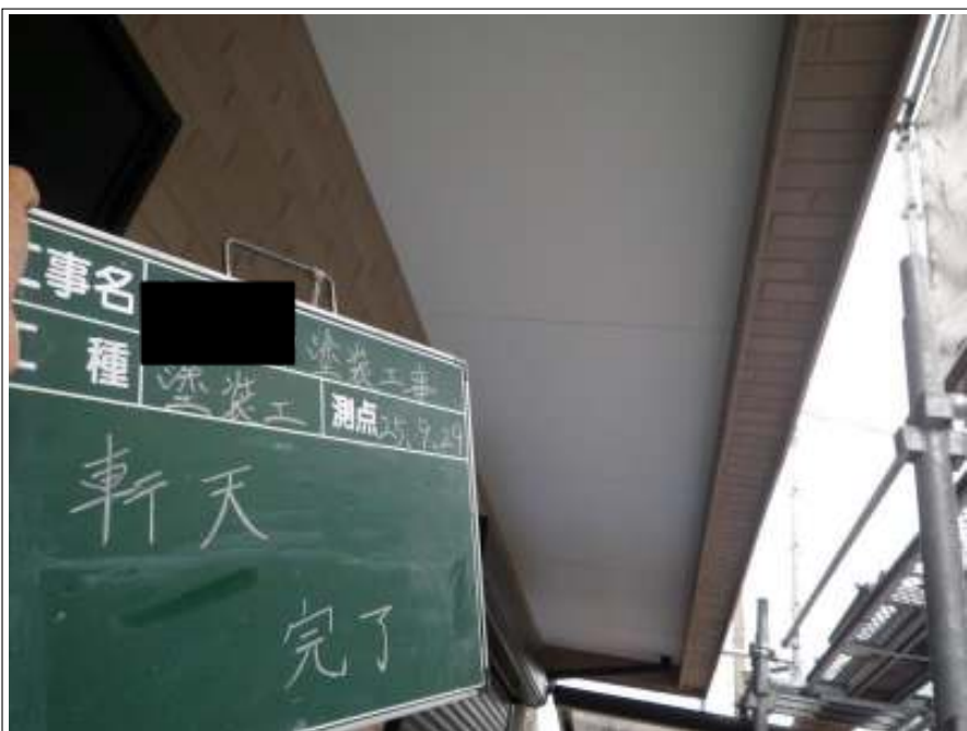
軒天塗装完了
