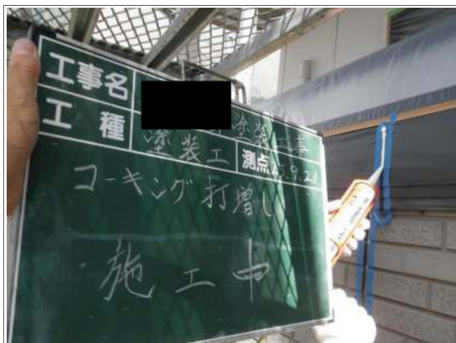
コーキング打増し施工中
