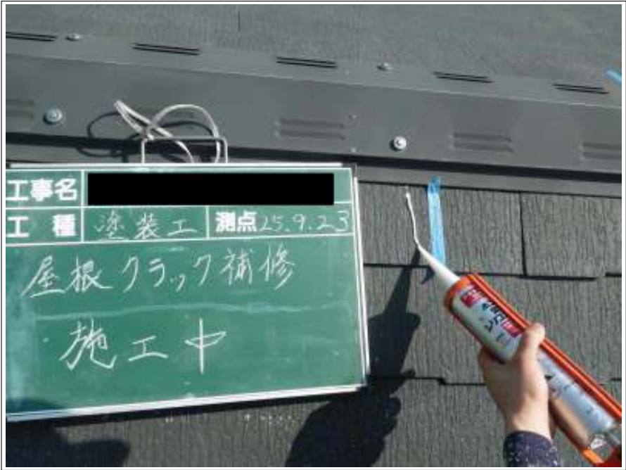
屋根クラック補修施工中
