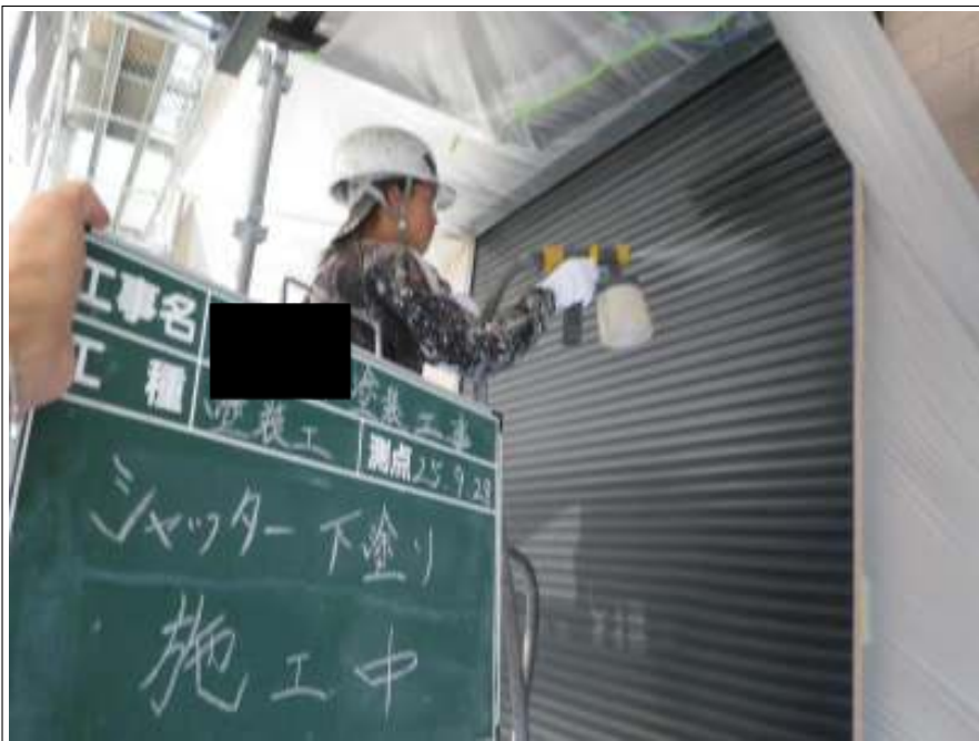
シャッター下塗り施工中
