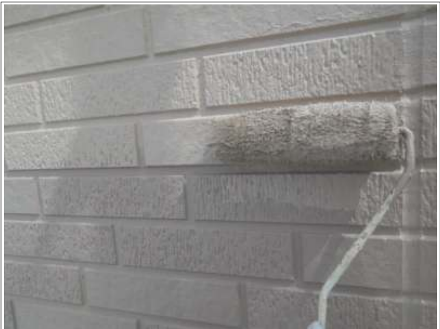
外壁塗装上塗り施工中
