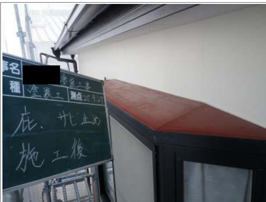
底サビ止め施工後
