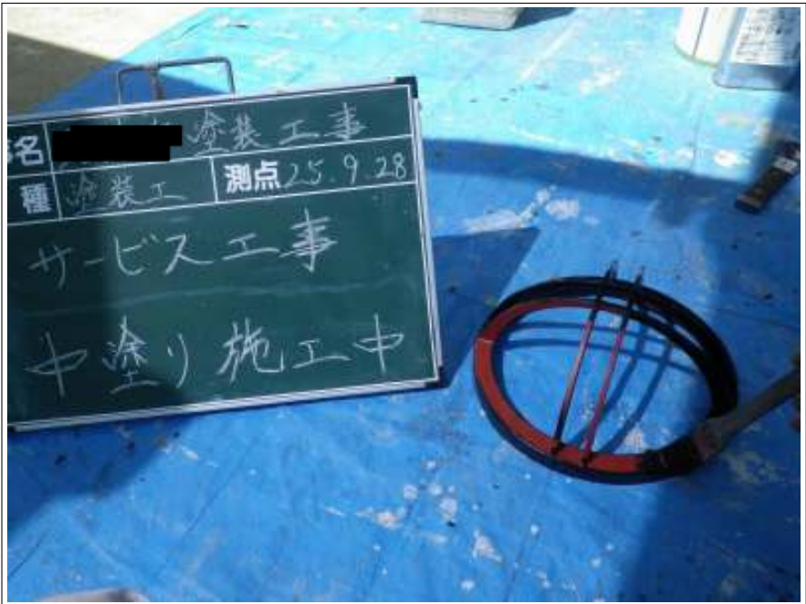
サービス工事中塗り施工中
