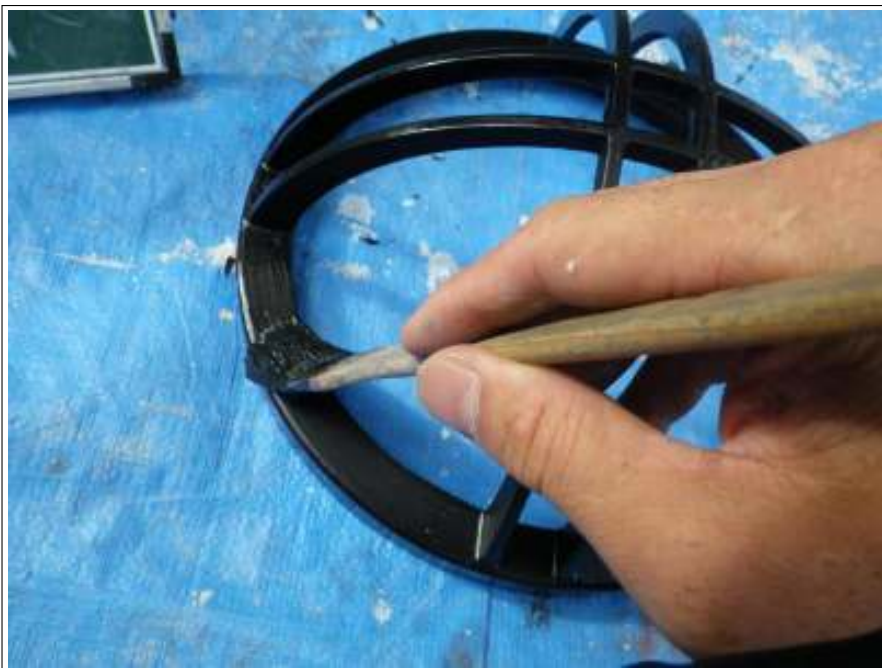
サービス工事上塗り施工中
