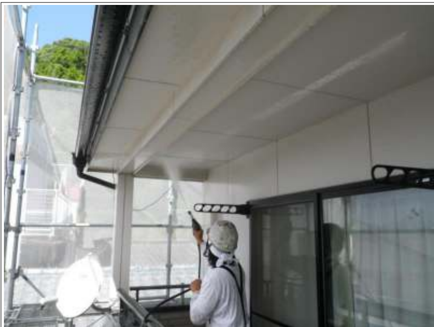
軒天高压洗浄中
