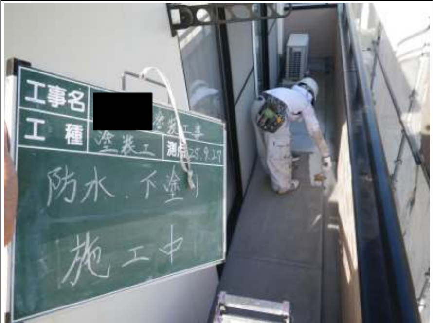
防水下塗り施工中
