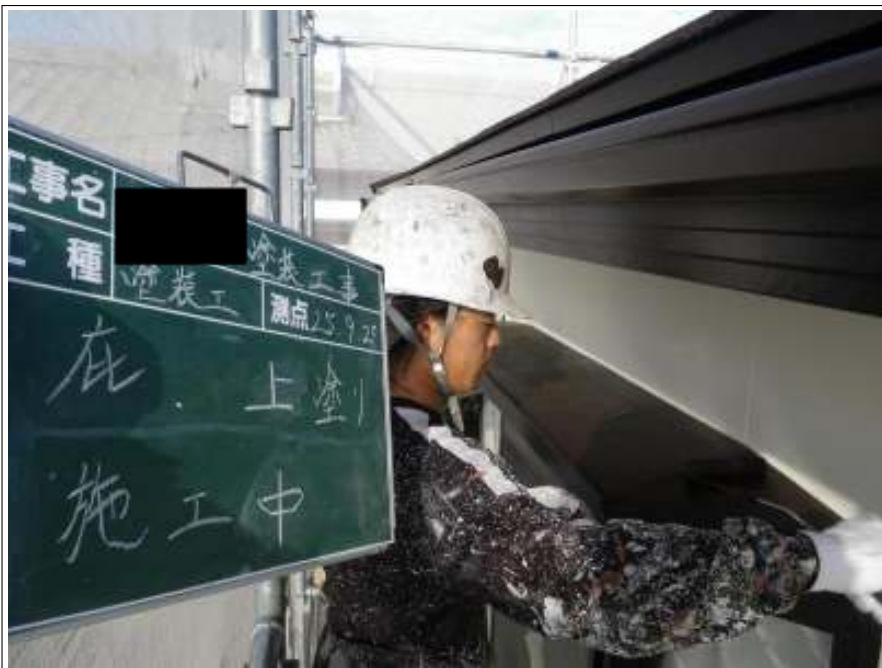
底上塗り施工中
