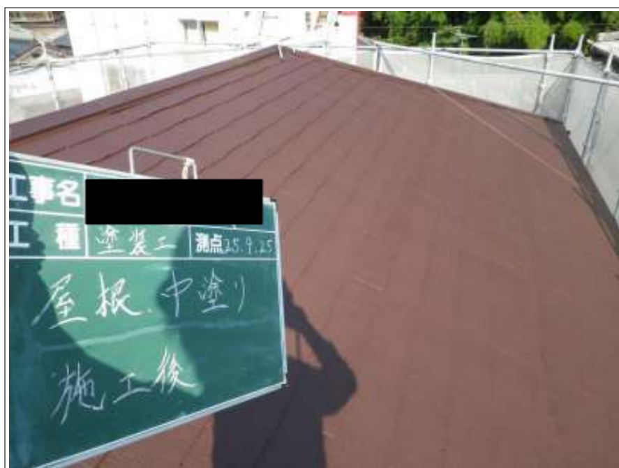
屋根塗装中塗り施工後
