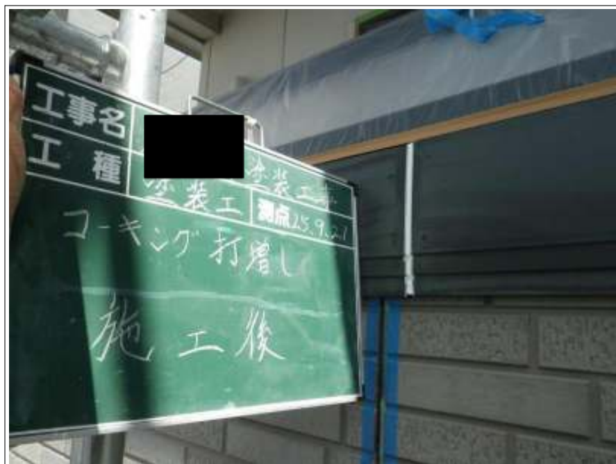
コーキング打増し施工後
