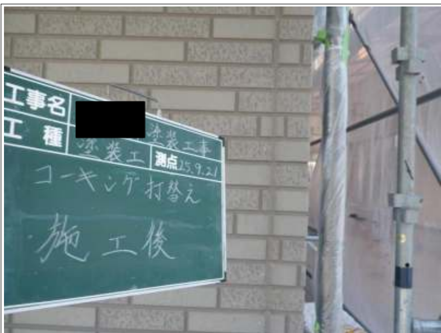
外壁コーキング打替え施工後
