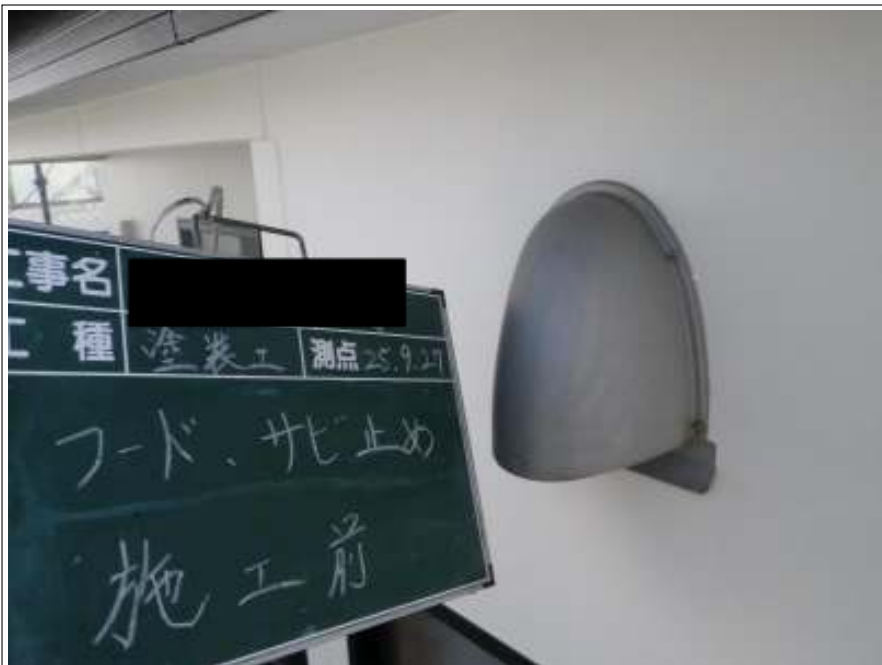
フードサビ止め施工前
