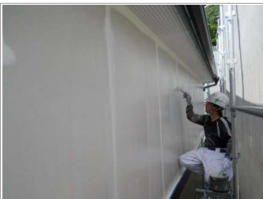
外壁塗装増し塗り施工中
