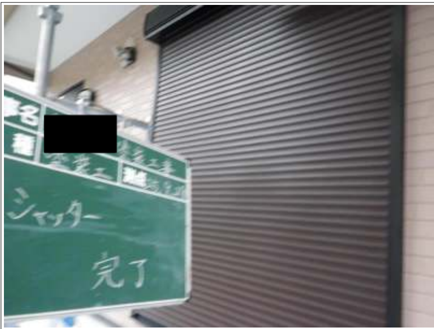
シャッター塗装完了
