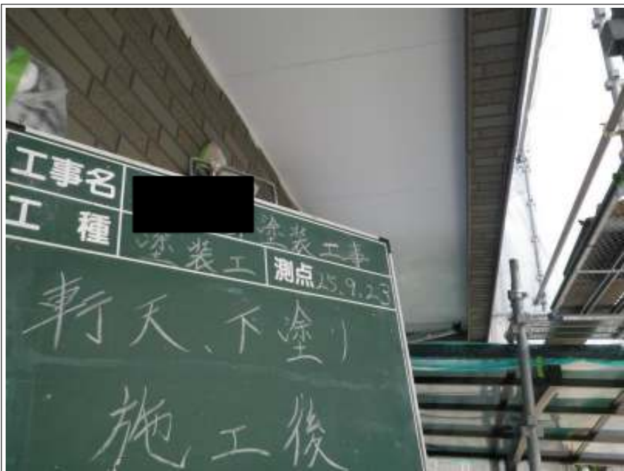
軒天塗装下塗り施工後
