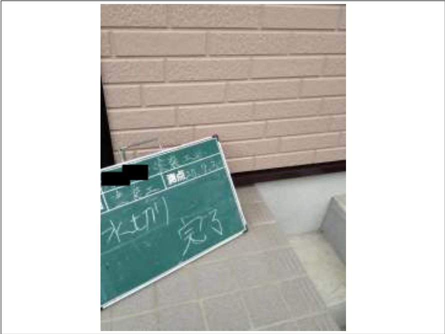
水切り塗装完了
