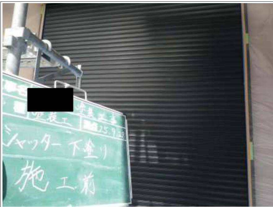
シャッター下塗り施工前
