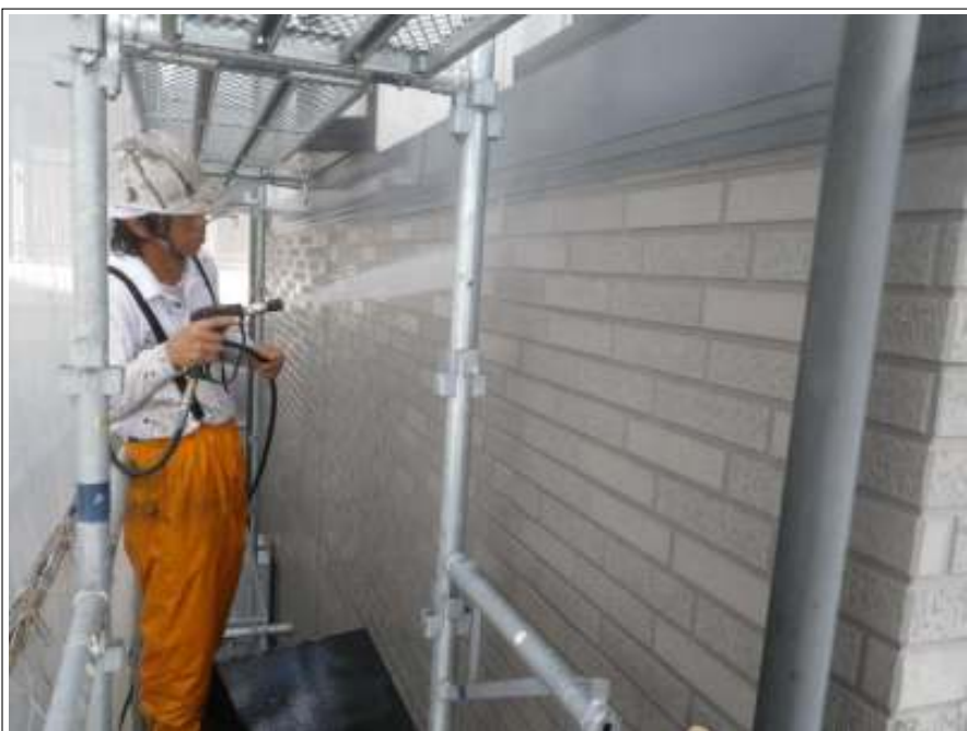
外壁高圧洗浄中
