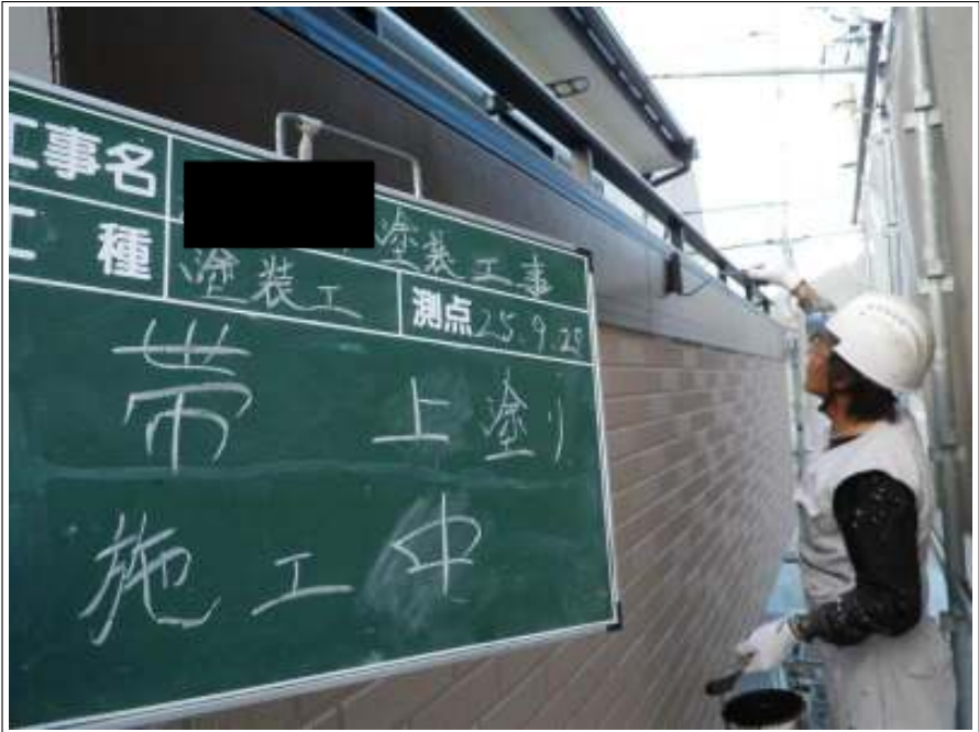
帯上塗り施工中
