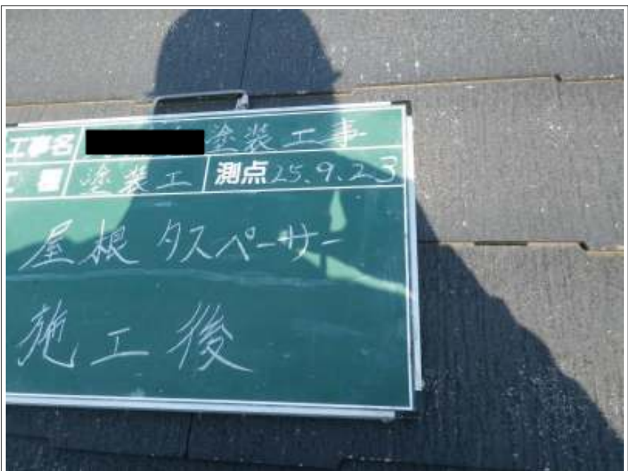
屋根タスペーサー完了
