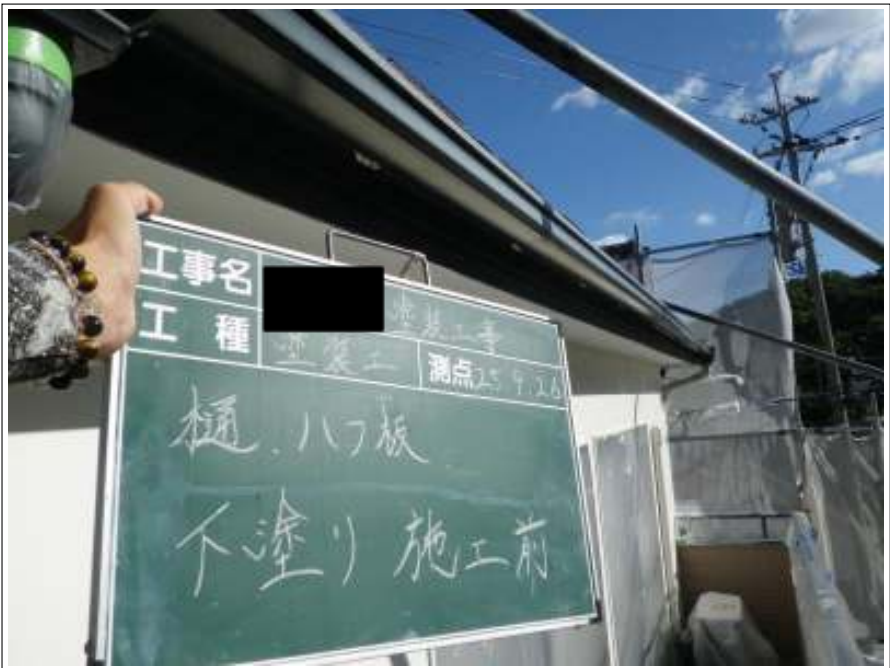
樋・ハフ板下塗り施工前
