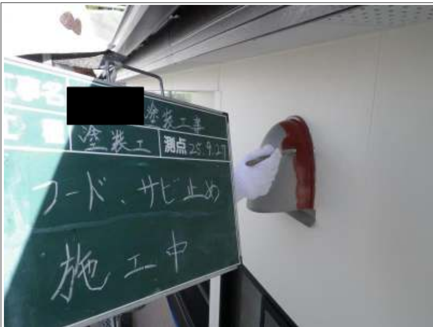
フードサビ止め施工中
