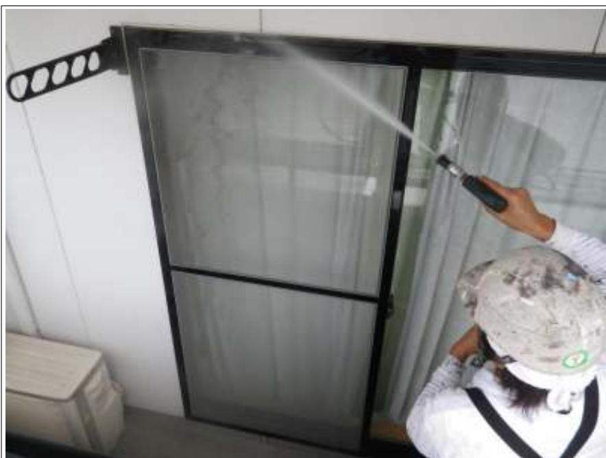
窓枠高压洗浄中
