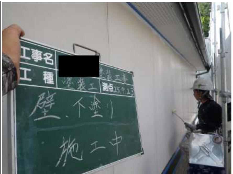
外壁塗装下塗り施工中
