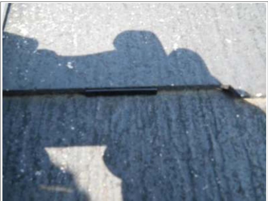
屋根タスペーサー施工後
