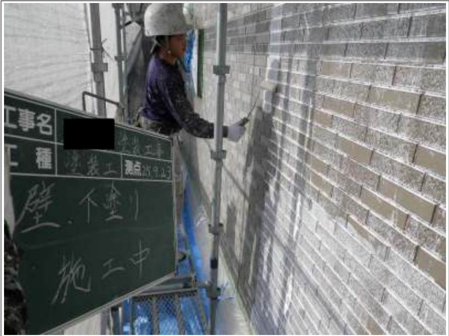
外壁塗装下塗り施工中
