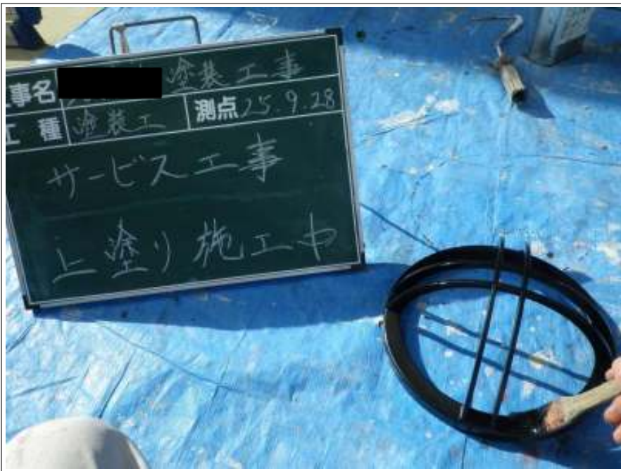
サービス工事上塗り施工中
