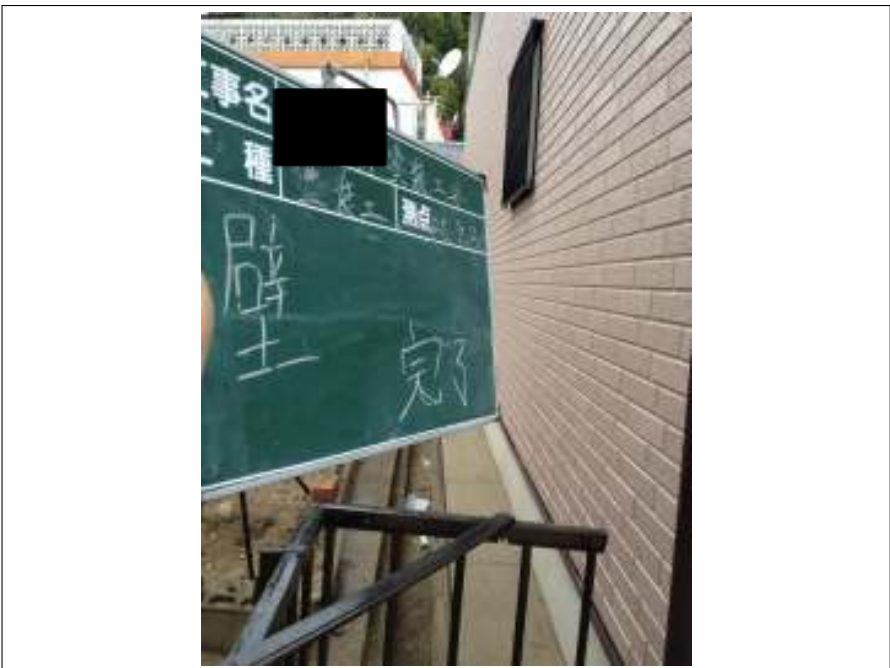
外壁塗装完了
