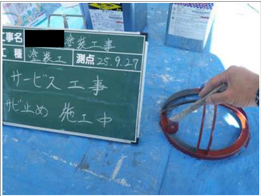
サービス工事施工中 サビ止め
