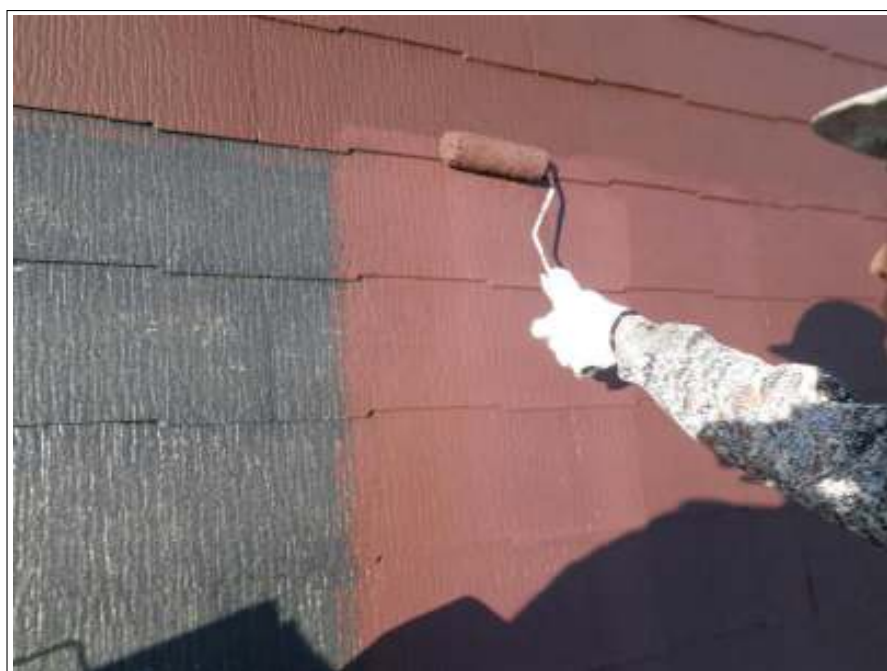
屋根塗装中塗り施工中
