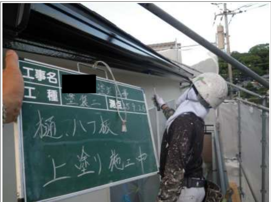
樋・ハフ板上塗り施工中
