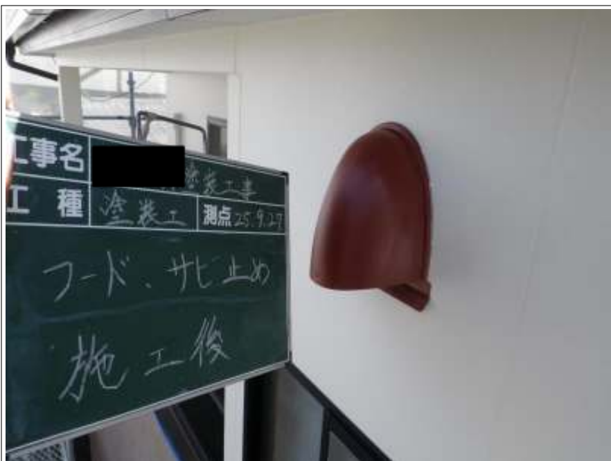
フードサビ止め施工後
