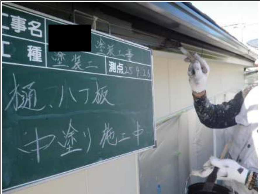
樋・ハフ板中塗り施工中
