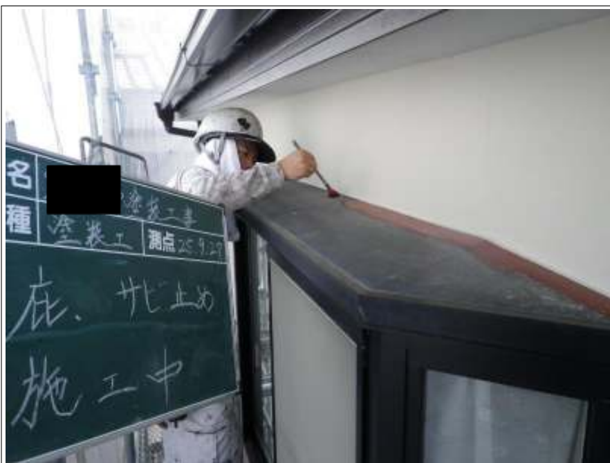
底サビ止め施工中
