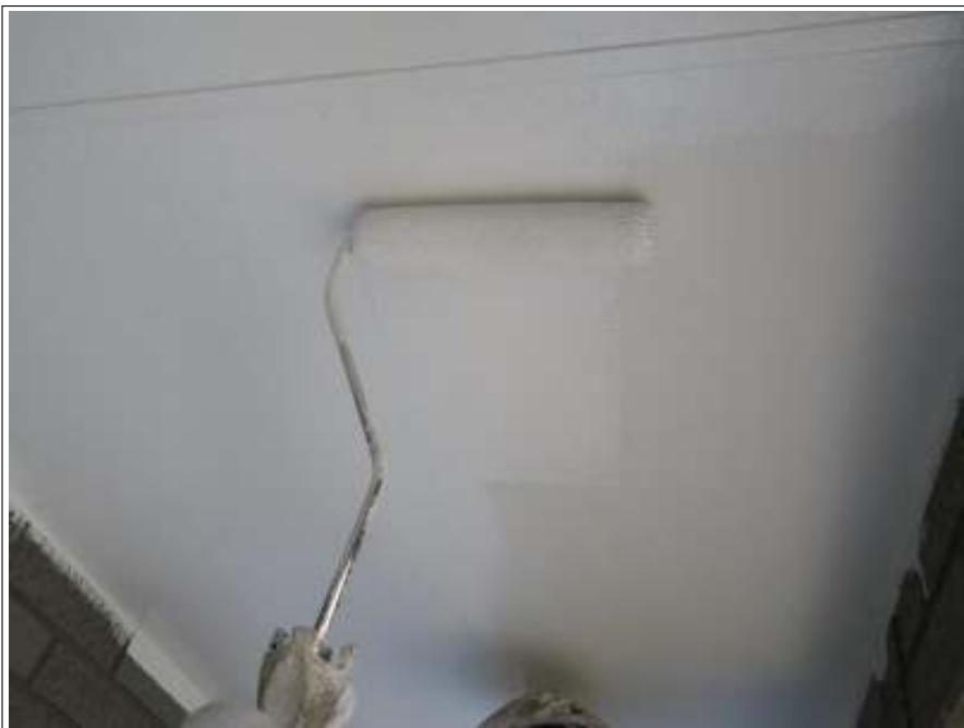
軒天塗装下塗り施工中
