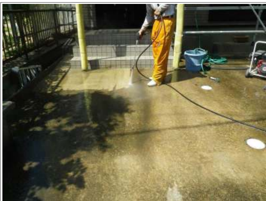
玄関前土間高圧洗浄中
