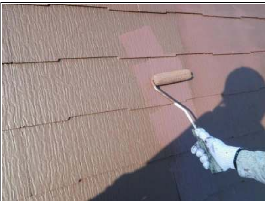
屋根塗装上塗り施工中
