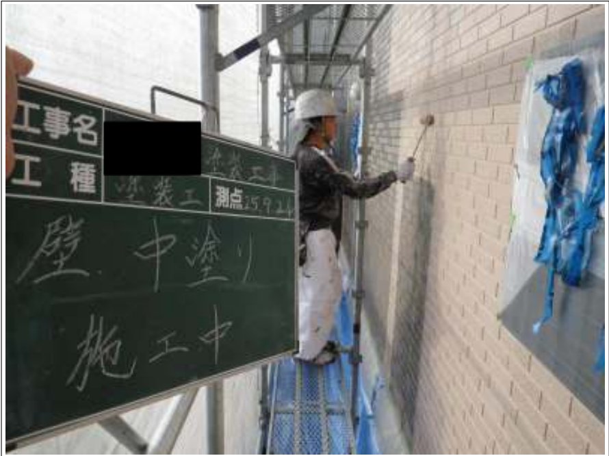
外壁塗装中塗り施工中
