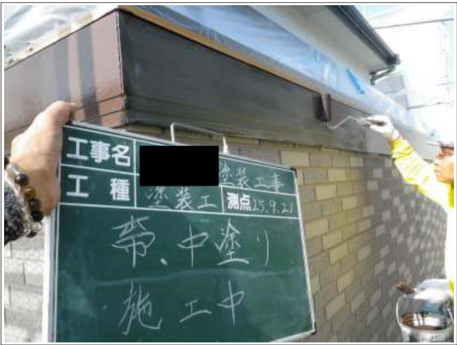
帯中塗り施工中
