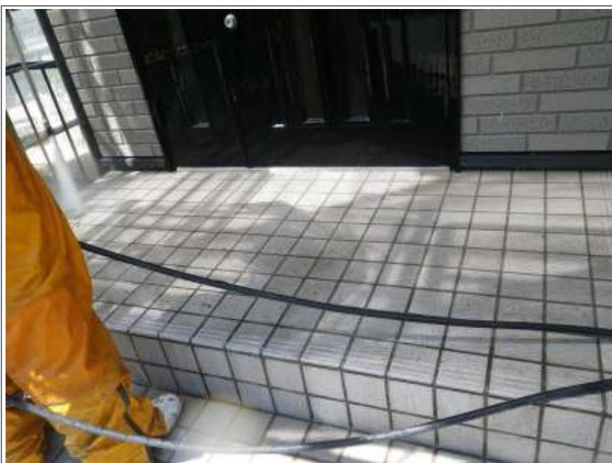
玄関前高圧洗浄中
