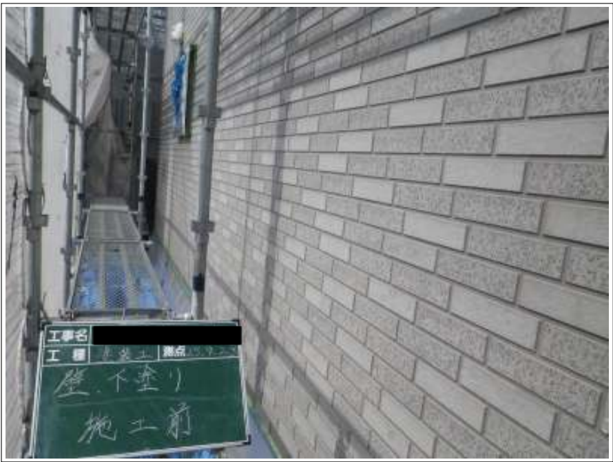
外壁塗装下塗り施工前
