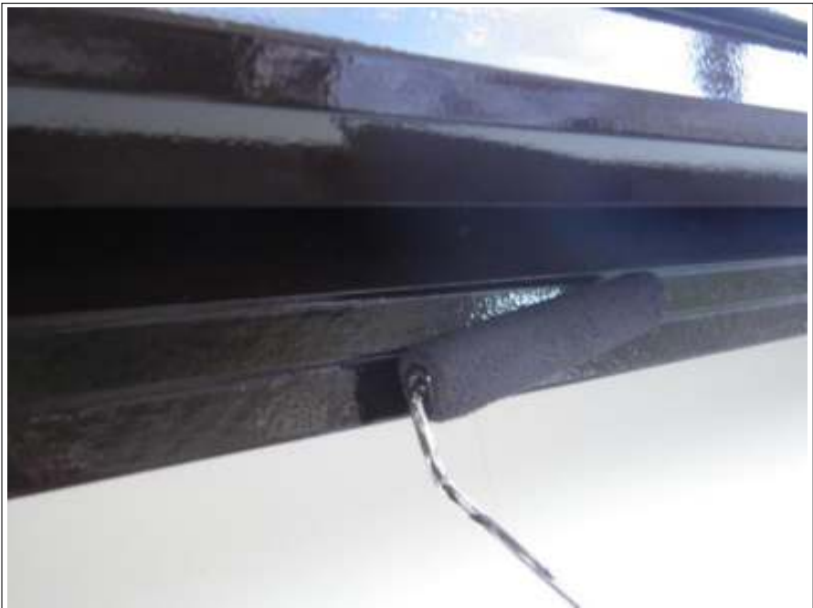
樋・ハフ板上塗り施工中
