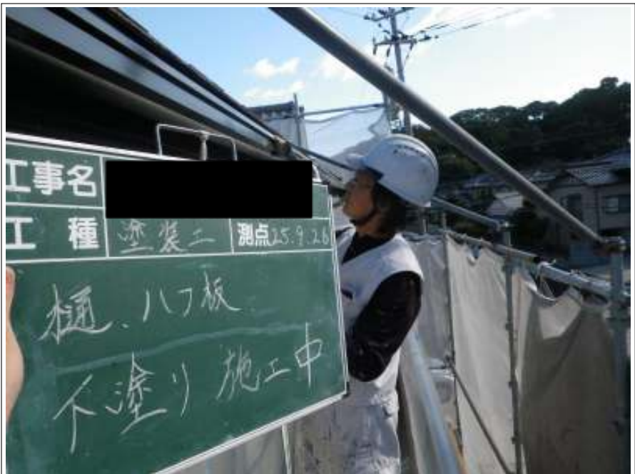
樋・ハフ板下塗り施工中
