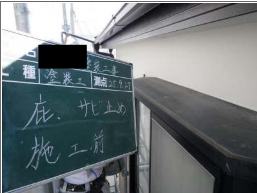
底サビ止め施工前
