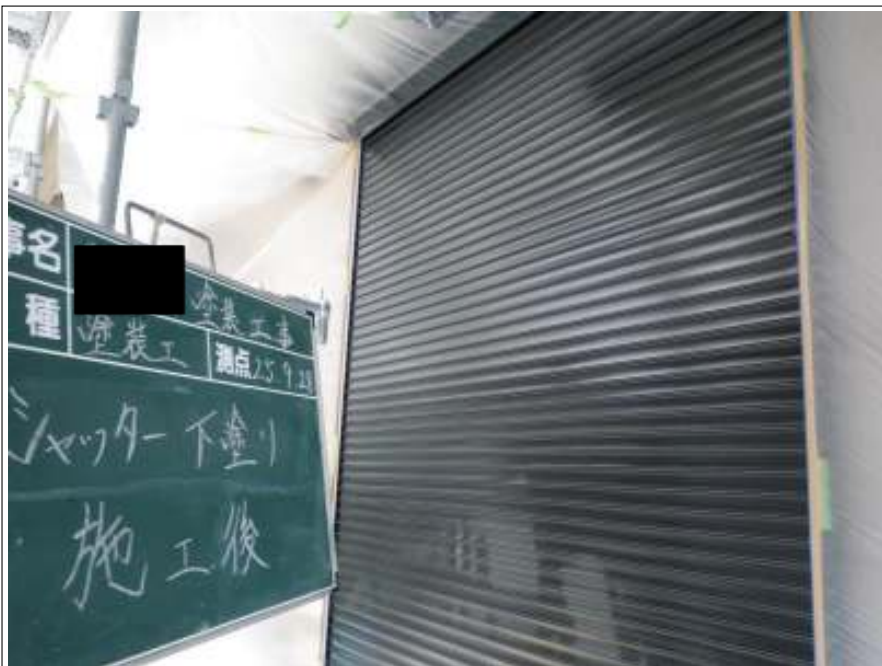
シャッター下塗り施工後
