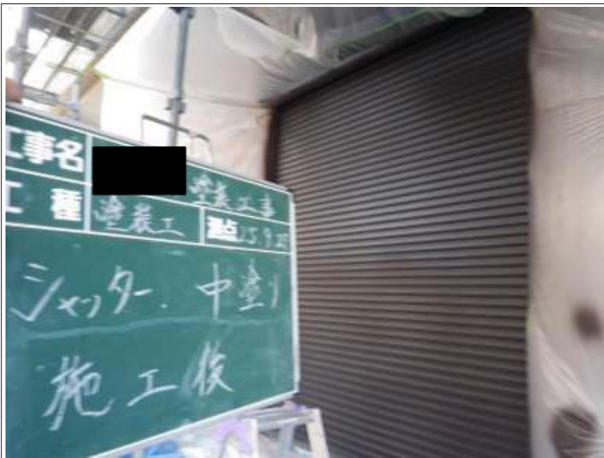
シャッター中塗り施工後
