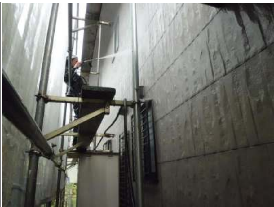
外壁洗淨 施工中
