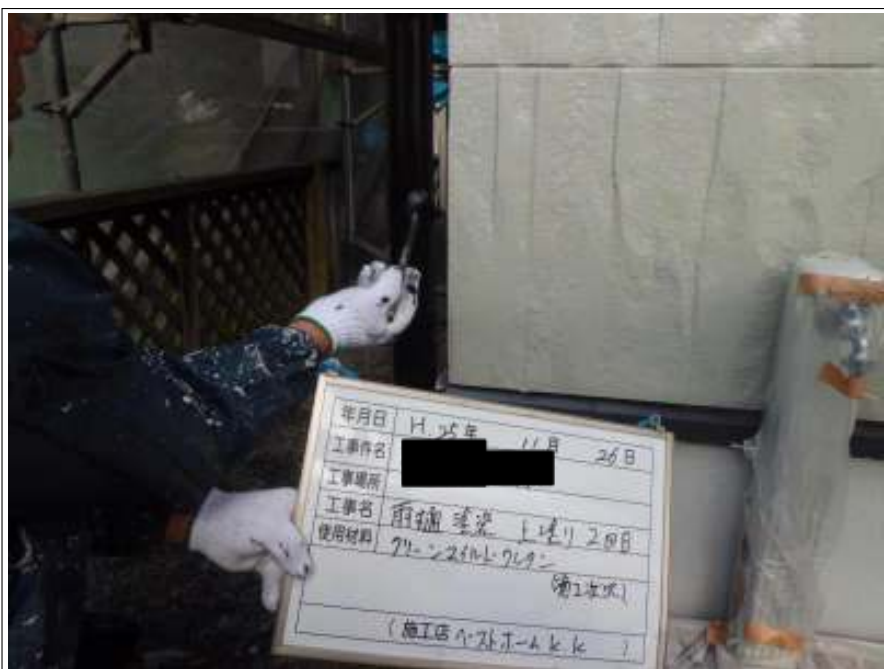
雨樋 上塗り2回目 施工中
