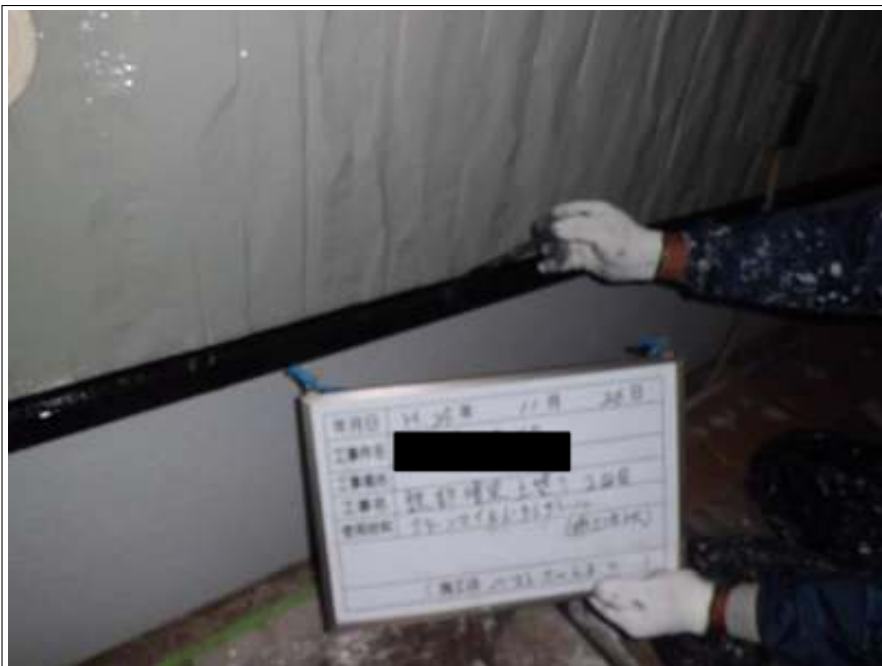
鉄部塗装 上塗り2回目 施工中
