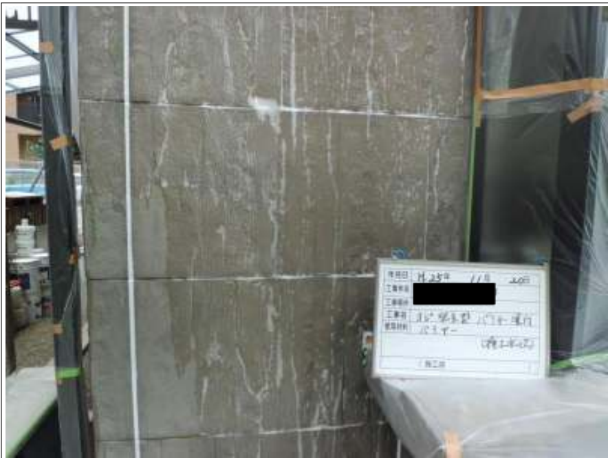
外壁 バリアー塗装 施工中
