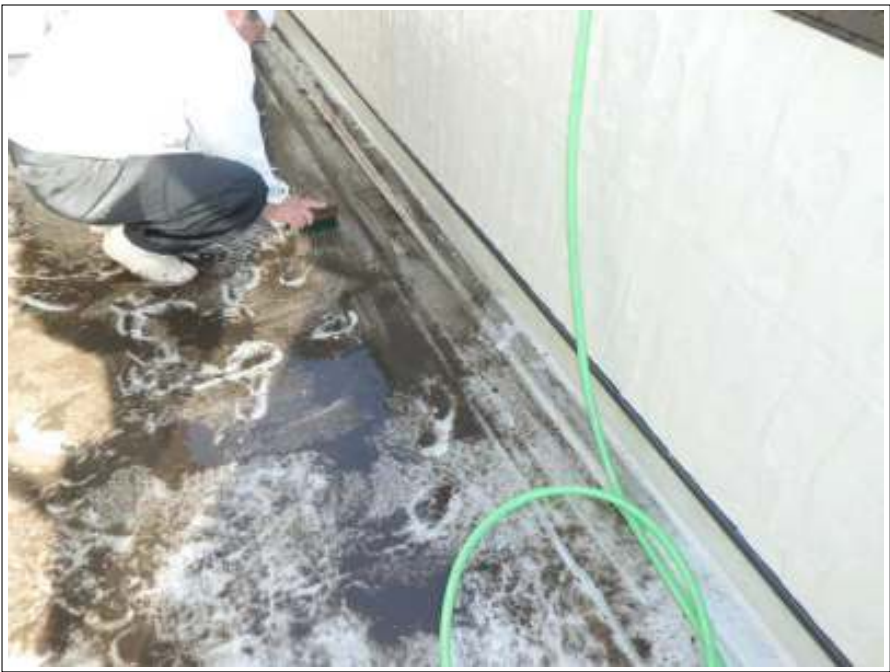
ベランダ 洗浄中
