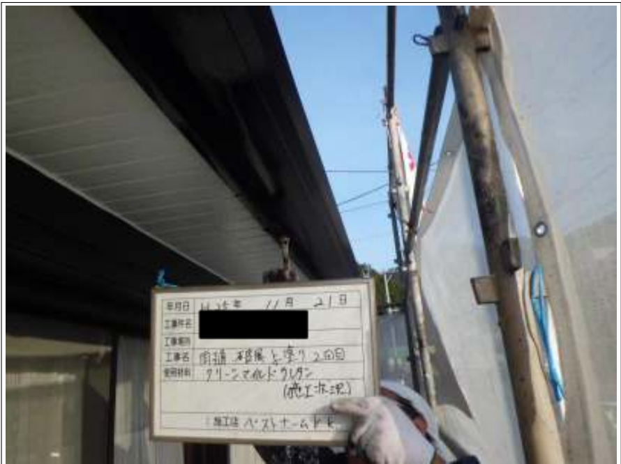
雨樋・破風 上塗り2回目 施工中
