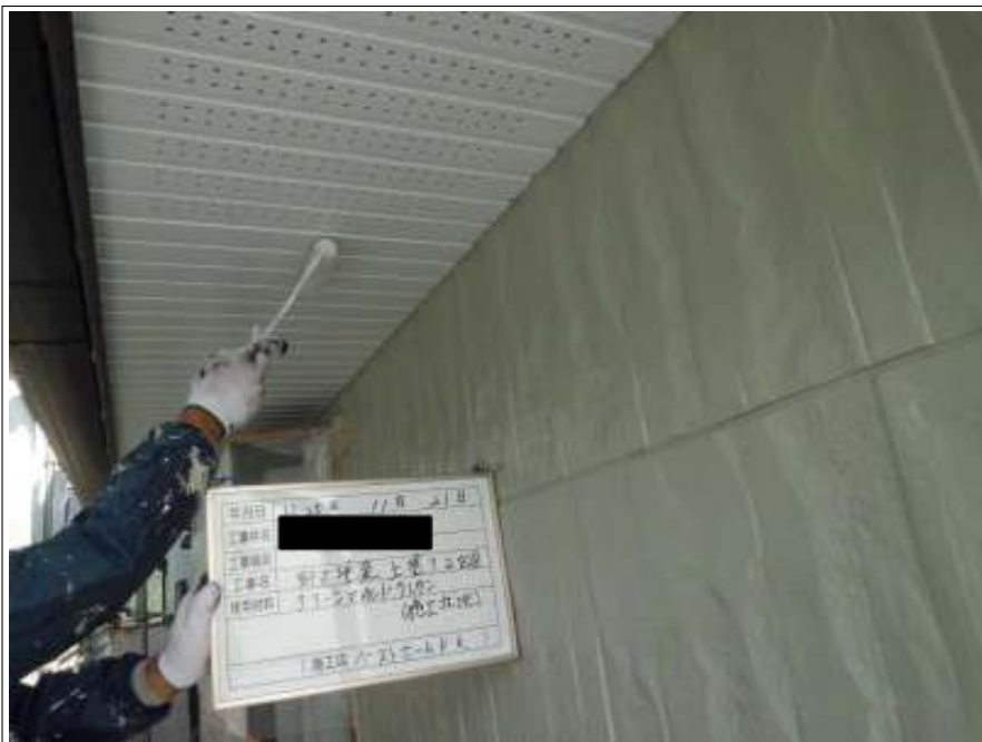
軒天塗装 2回目 施工完了
