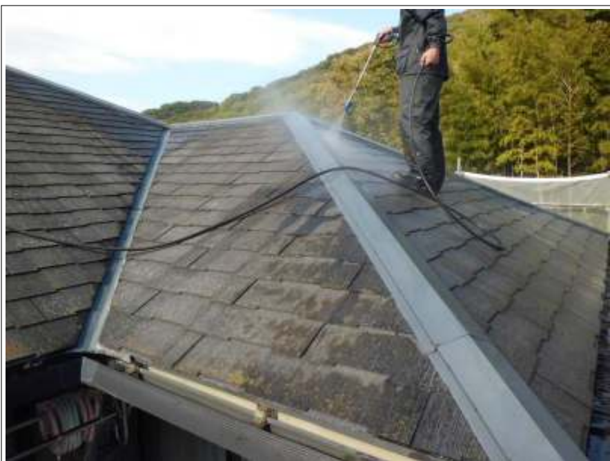
屋根洗淨 施工中
