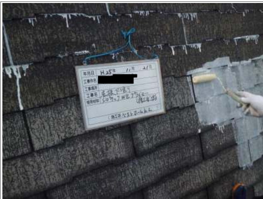
屋根 下塗り 施工中
