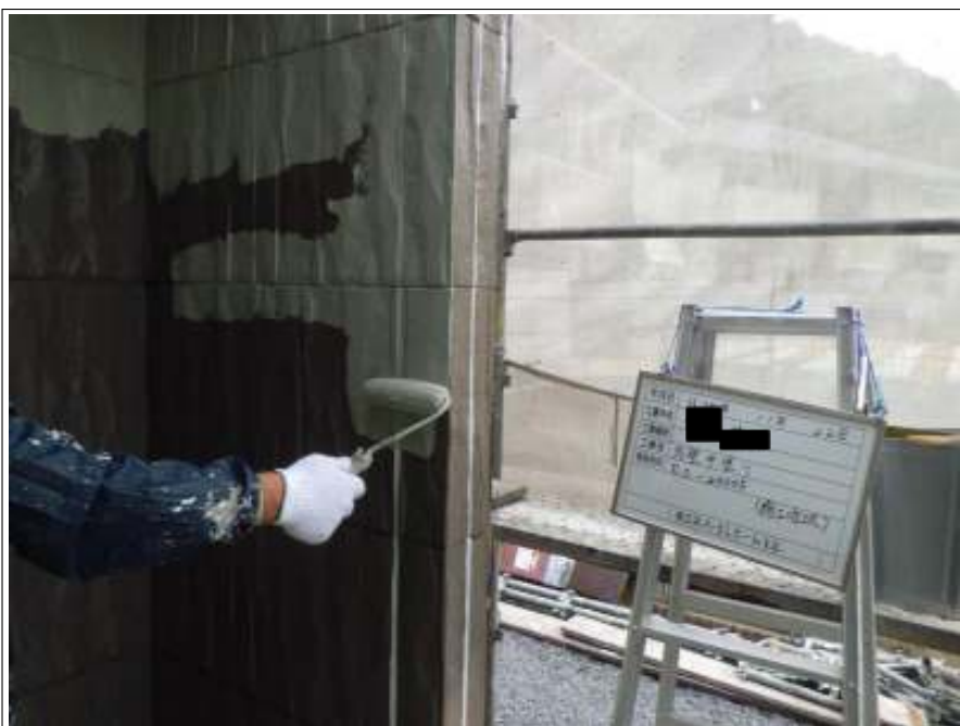
外壁 中塗り 施工中
