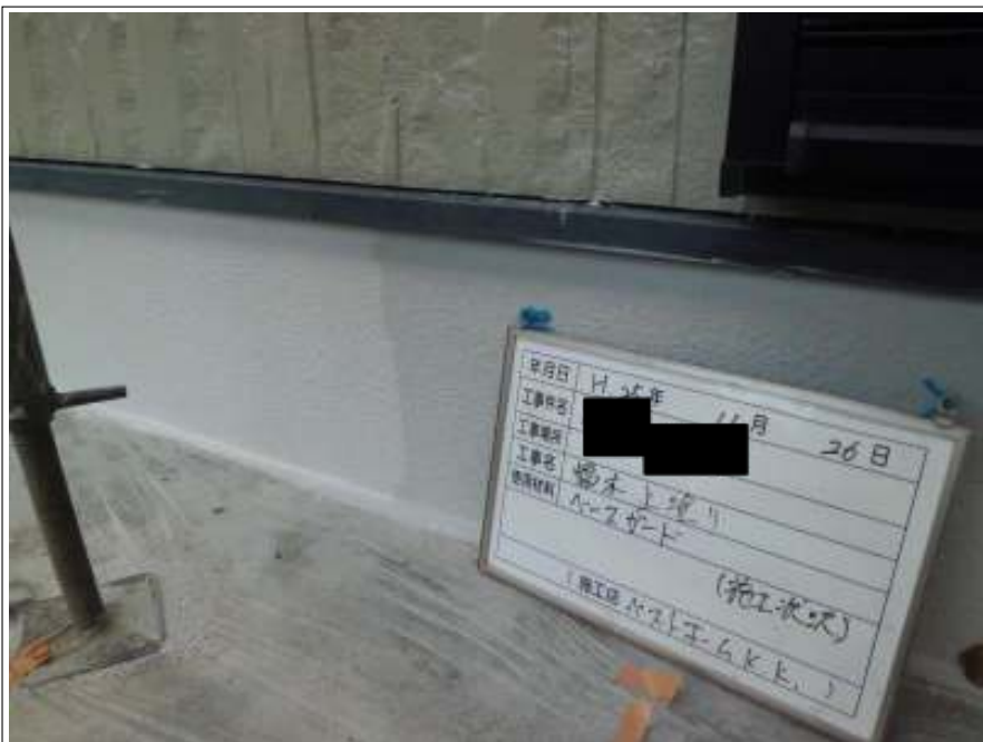
幅木 塗装 上塗り 施工完了
