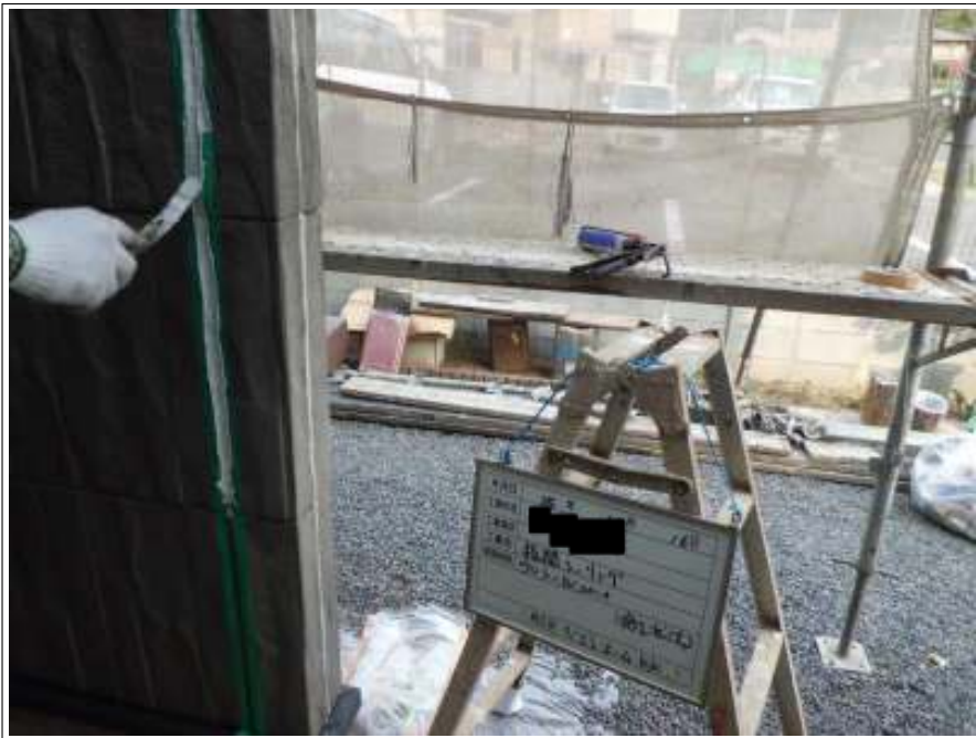
外壁 シーリング打替え 施工中
