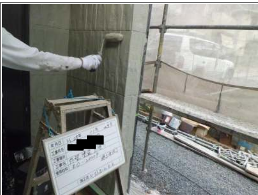
外壁 上塗り 施工中
