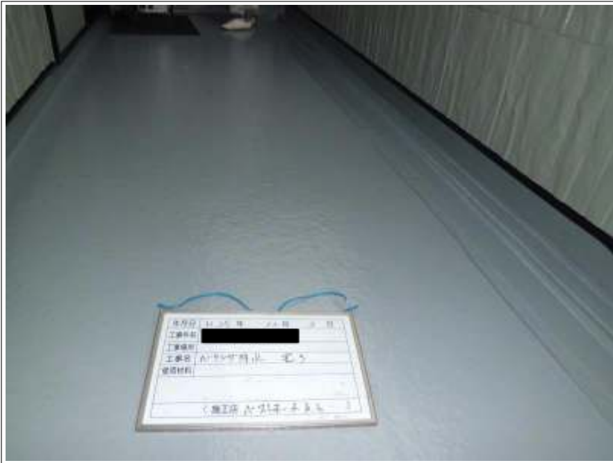
ベランダ 塗装 完了
