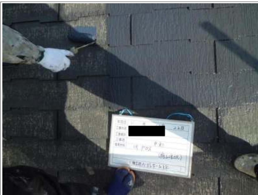
屋根 中塗り 施工中
