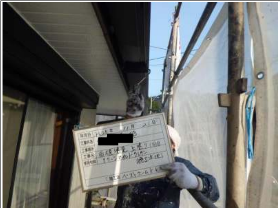
雨樋・破風 上塗り1回目 施工中
