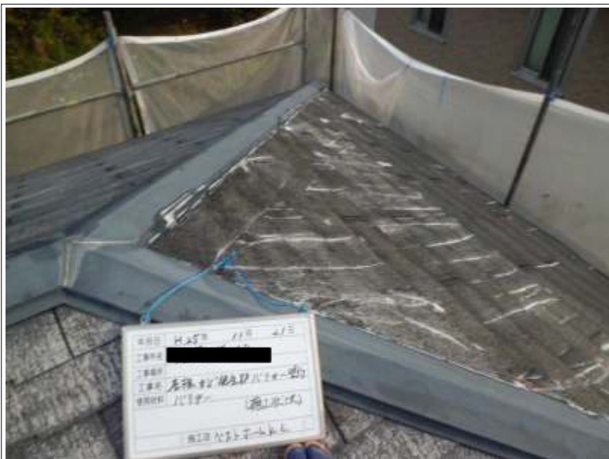
屋根 バリアー塗装 施工中
