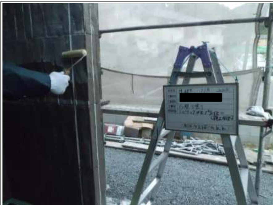
外壁 下塗り 施工中
