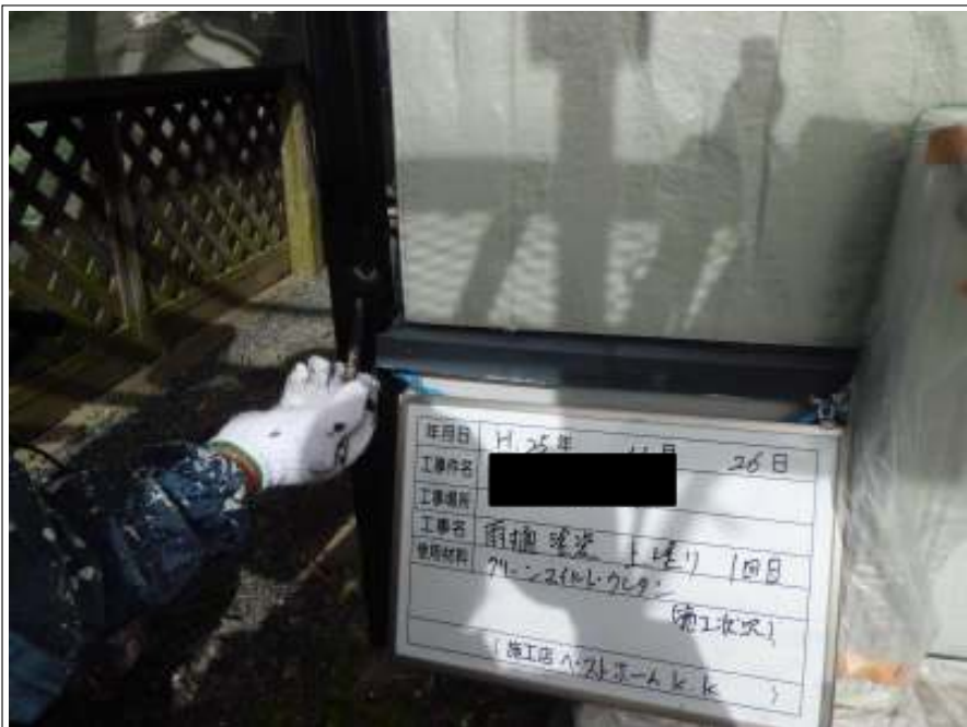
雨樋 上塗り1回目 施工中
