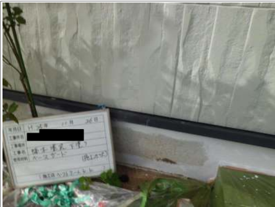
幅木 塗装 下塗り 施工中
