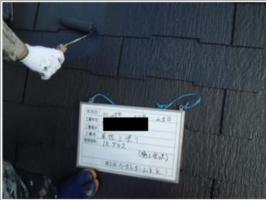
屋根 上塗り 施工中
