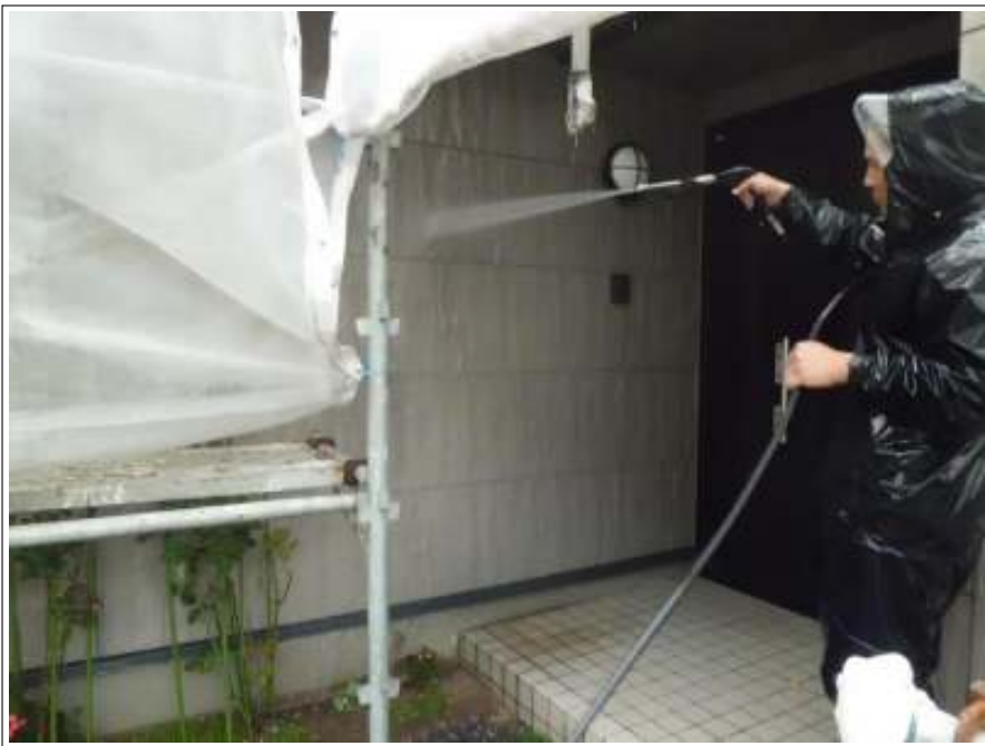
外壁洗淨 施工中
