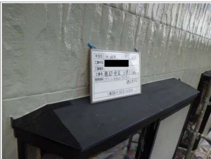
鉄部 上塗り1回目 施工中
