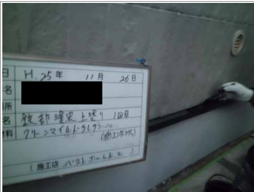
鉄部塗装 上塗り1回目 施工中
