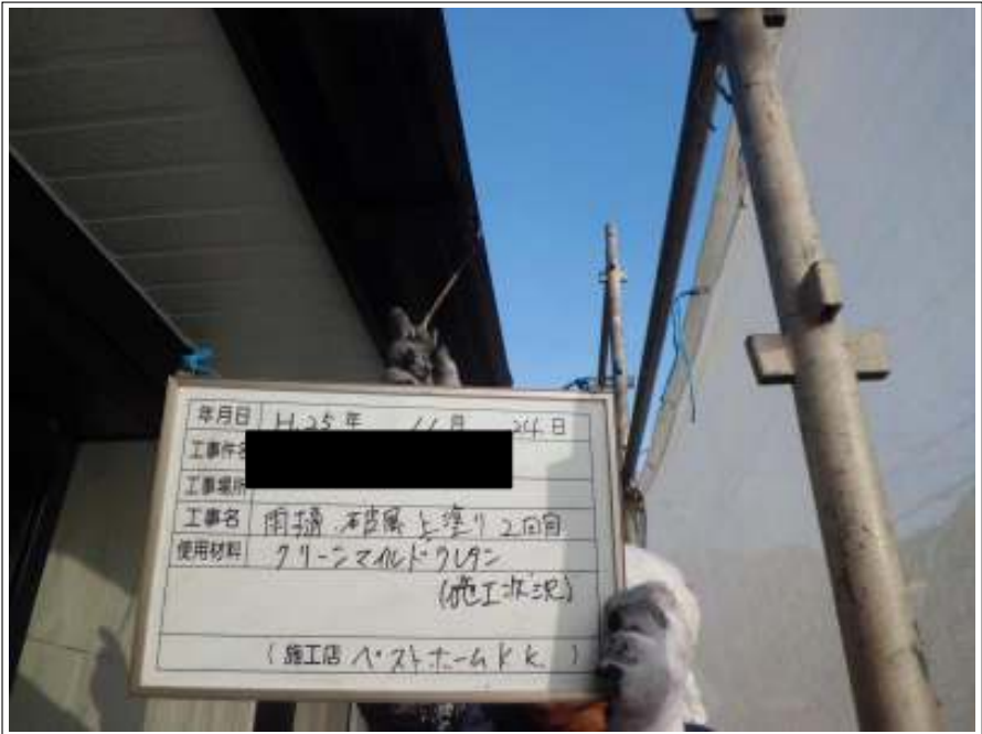
雨樋・破風 上塗り 施工完了
