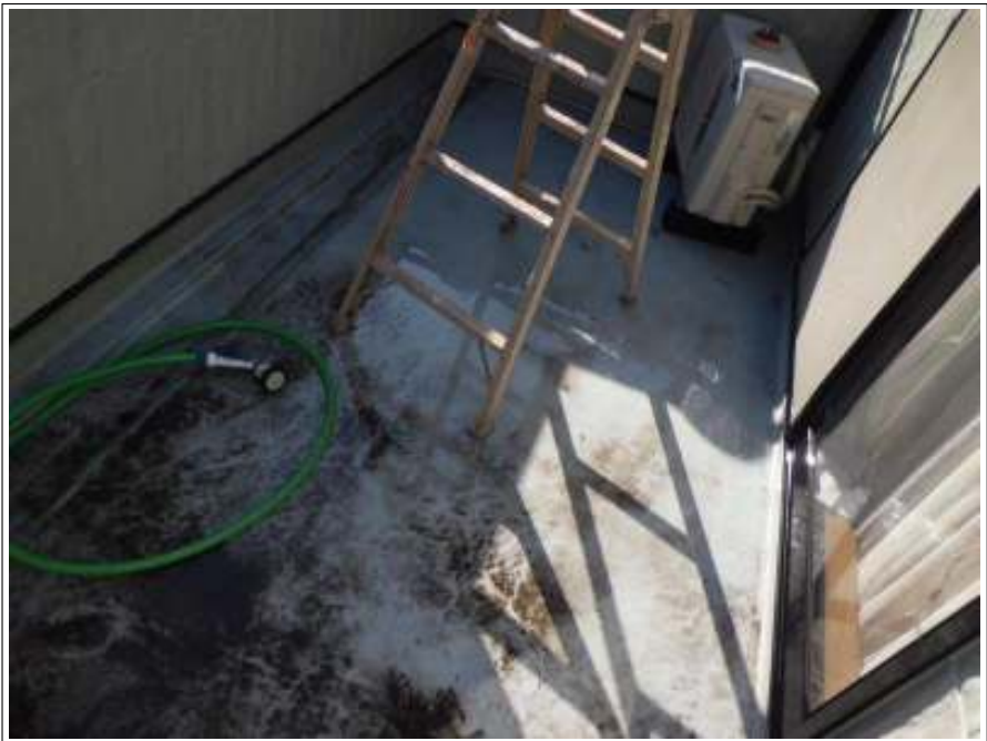
ベランダ 洗浄中
