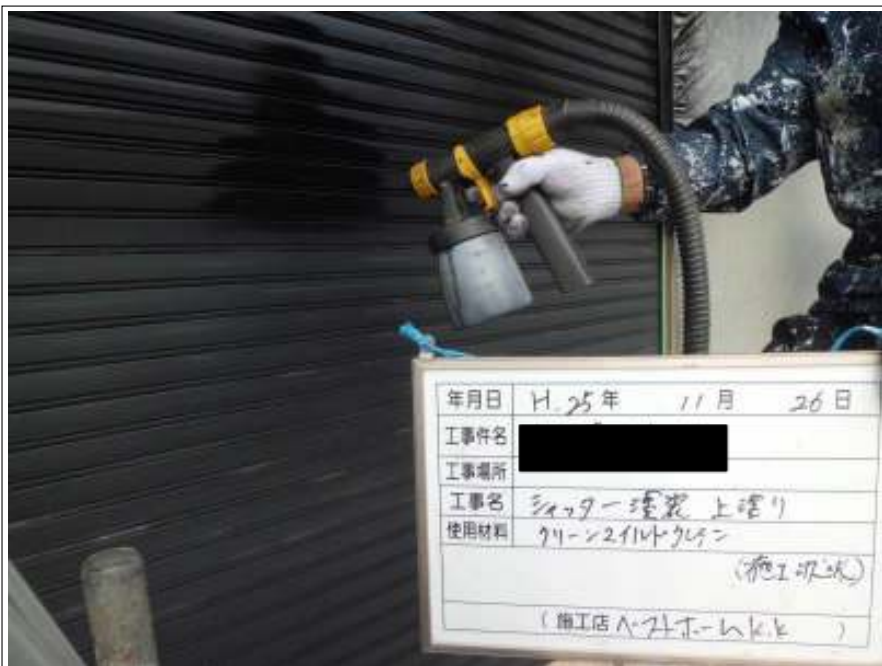
シャッター塗装 施工中
