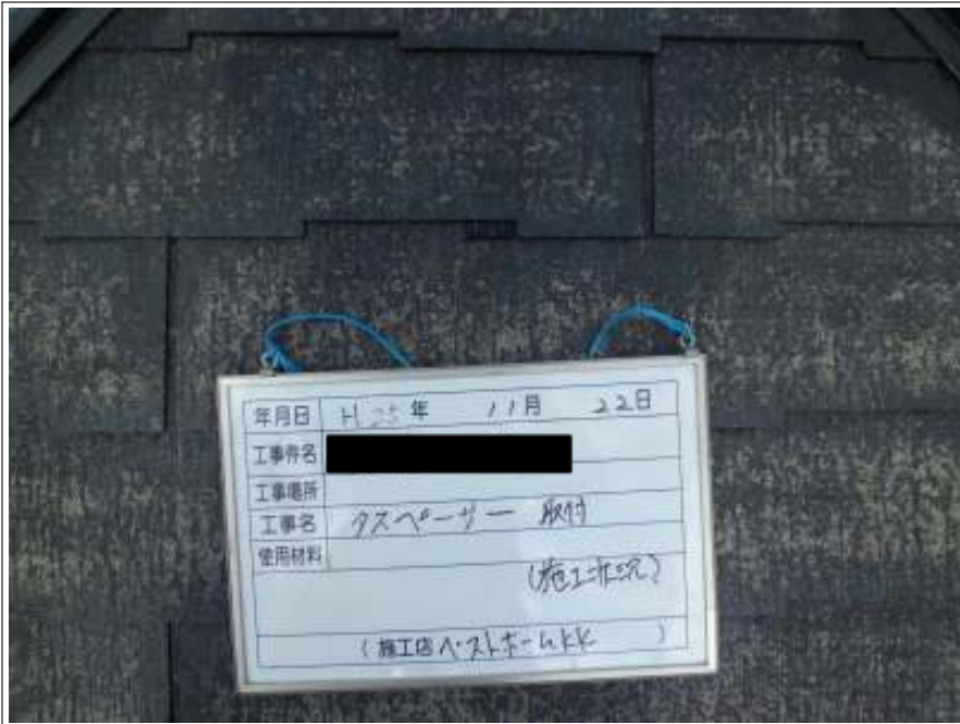
屋根 タスペーサー 施工中
