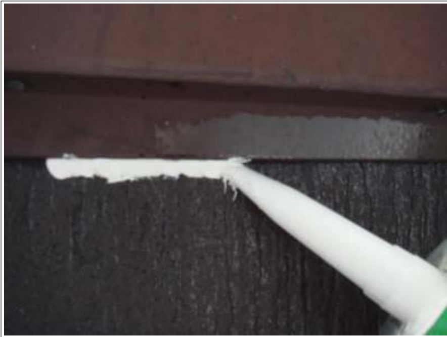
屋根 棟板金ラバー止め施工中
