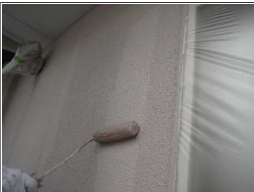
外壁上塗り施工中
