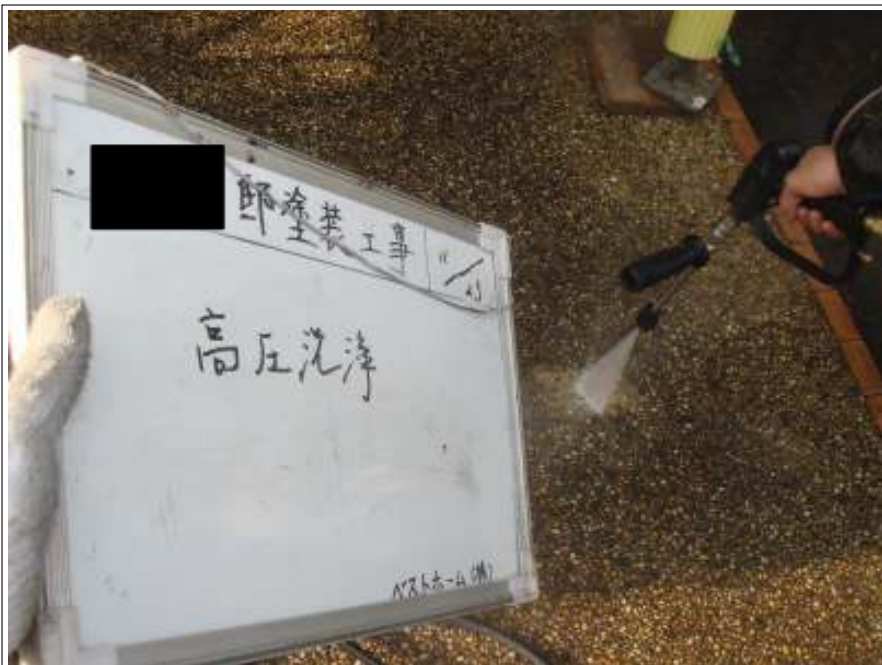
高压洗浄施工中
