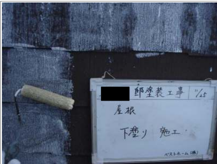
屋根 下塗り施工中
