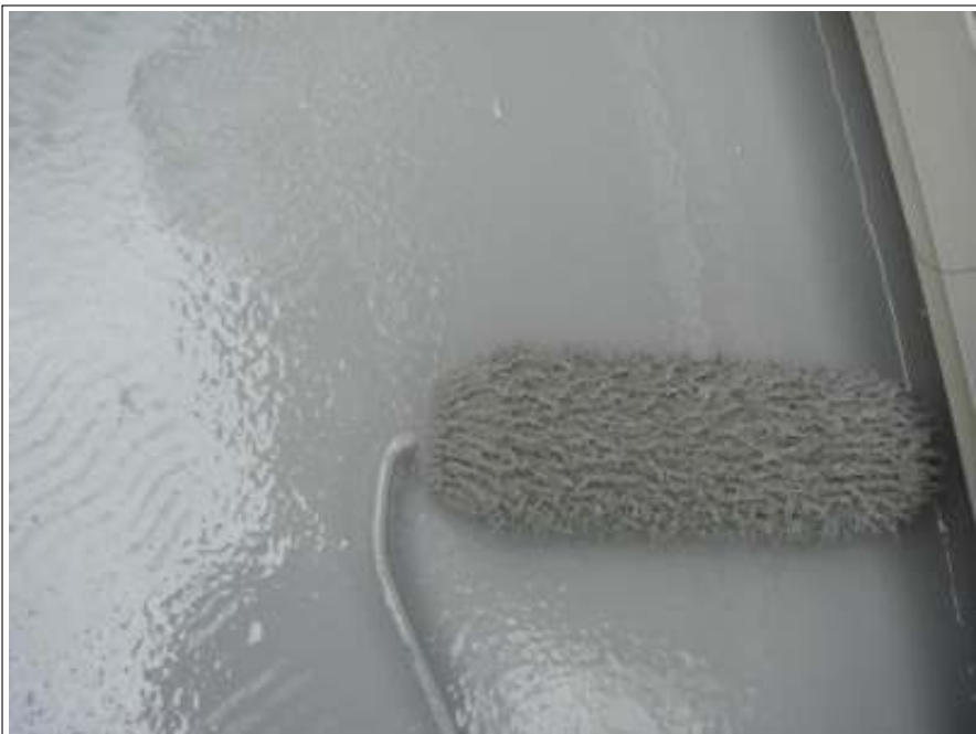
ベランダ防水上塗り2回目施工中
