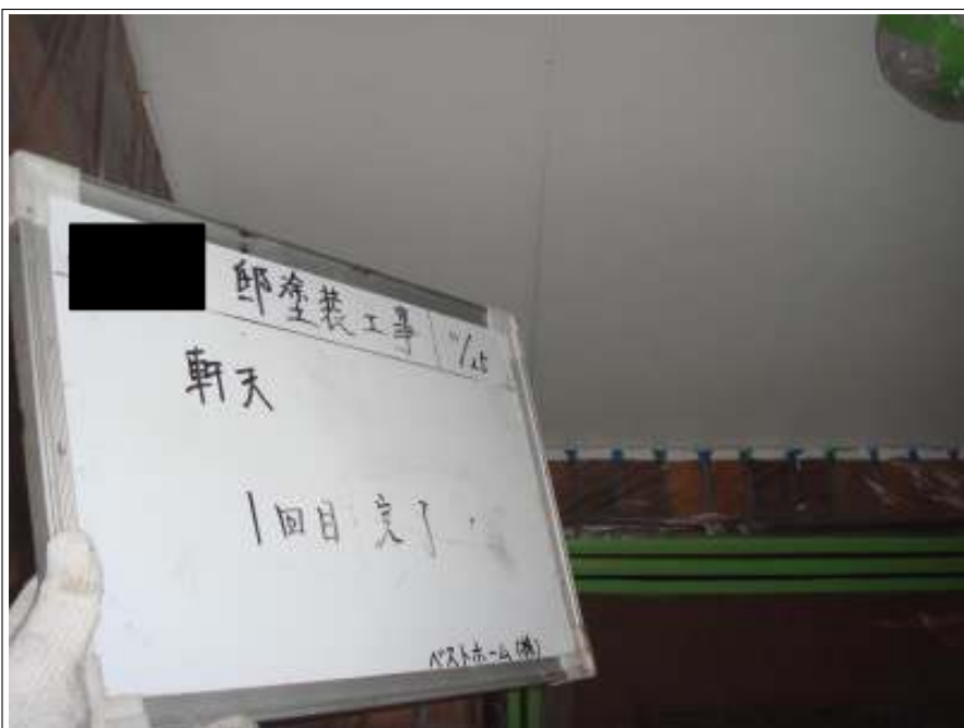
軒天塗装1回目施工完了
