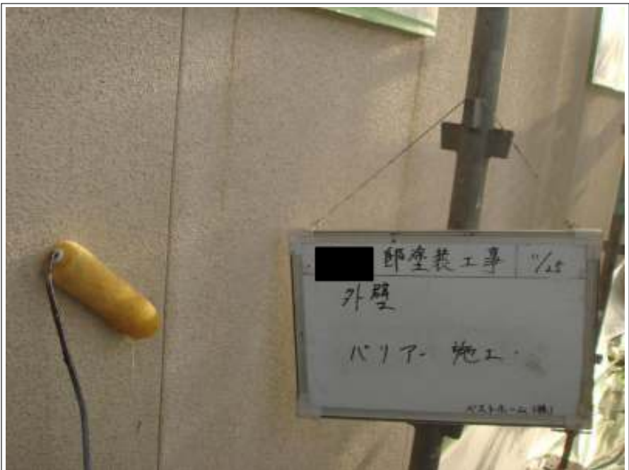
外壁バリアー施工中
