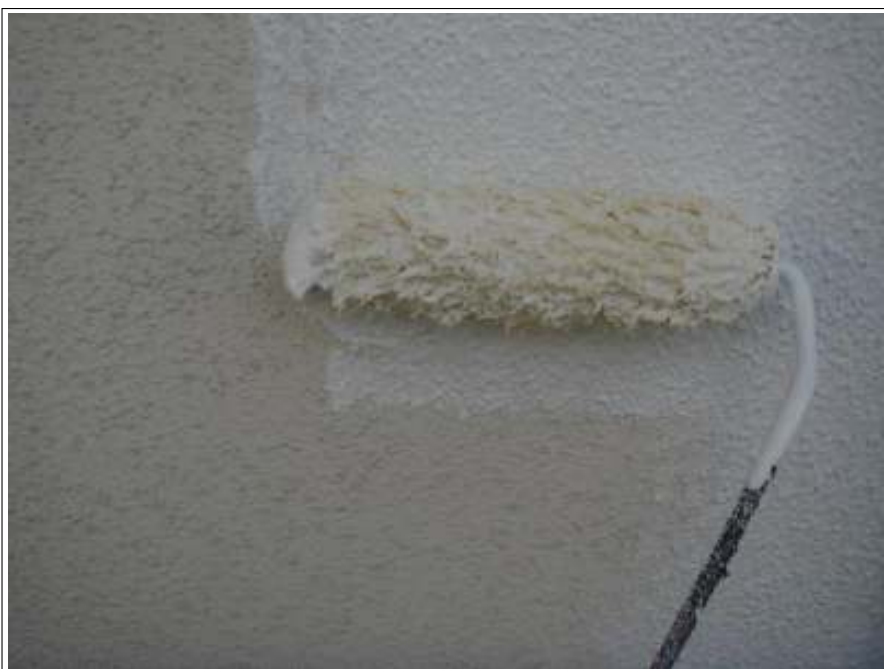
外壁下塗り施工中
