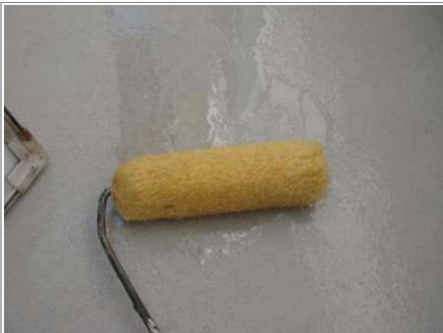
ベランダ防水プライマー施工中
