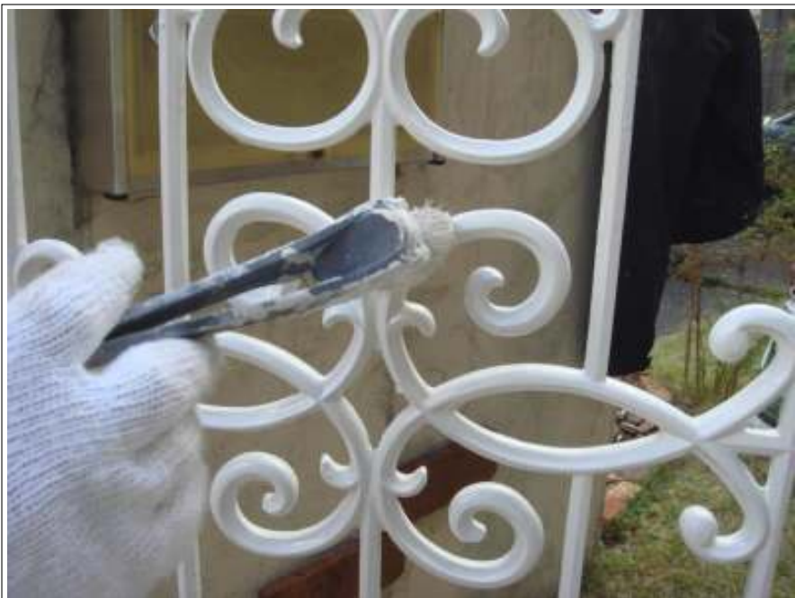
門扉2回目施工中
