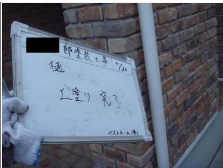
雨樋2回目施工完了
