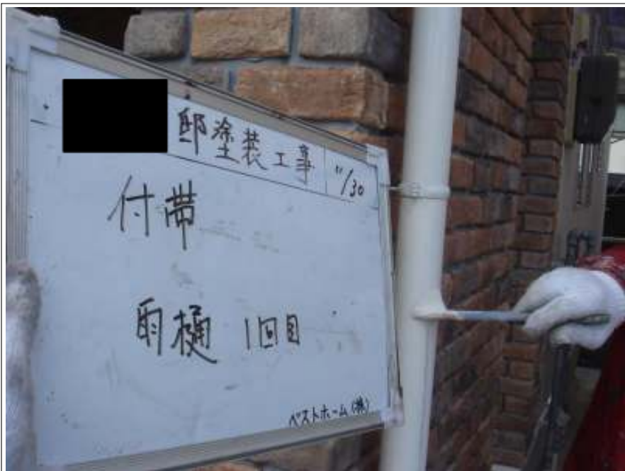
雨樋1回目施工中
