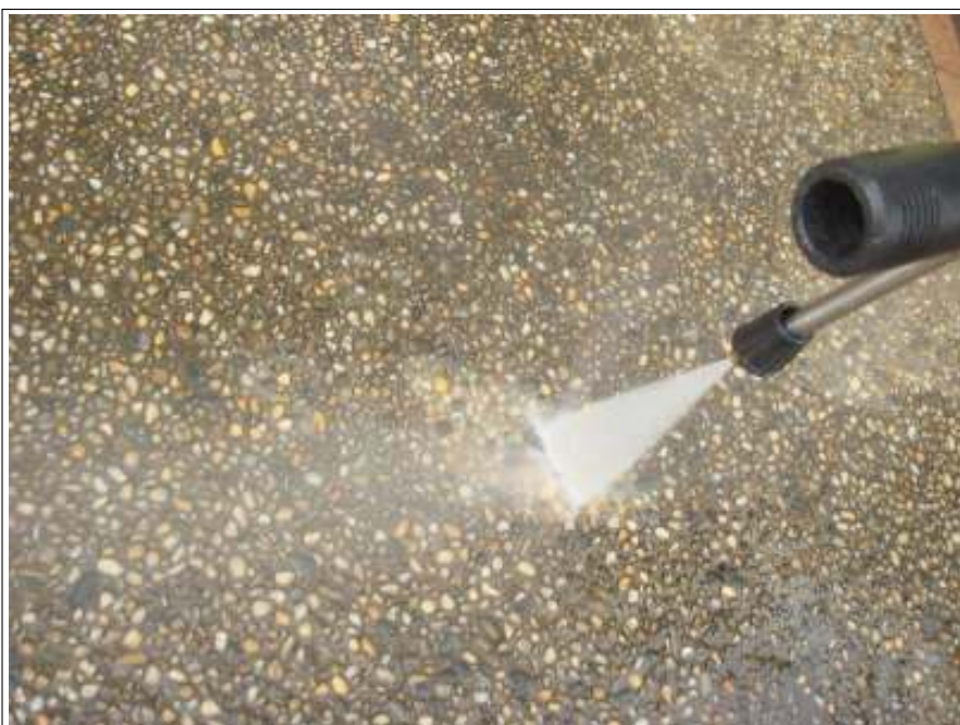
高压洗浄施工中
