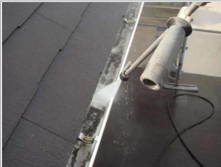
高圧洗浄施工中
