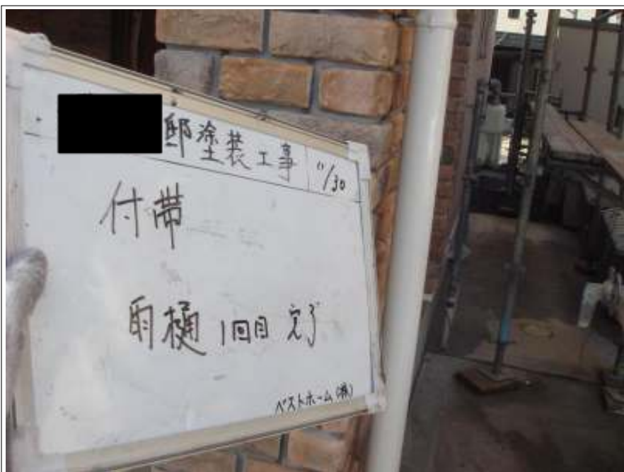
雨樋1回目施工完了
