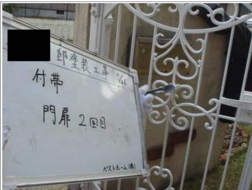
門扉2回目施工中
