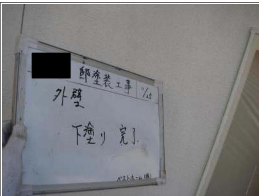
外壁下塗り施工完了
