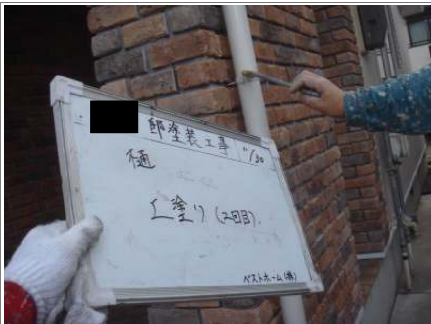
雨樋2回目施工中
