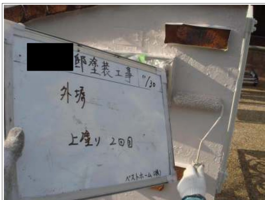
外塀上塗り2回目施工中
