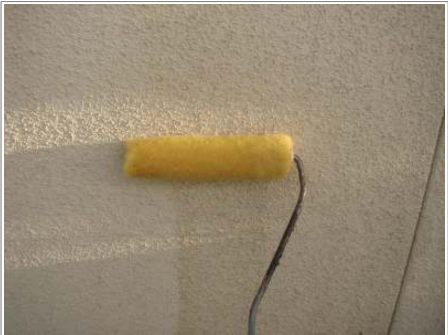
外壁バリアー施工中
