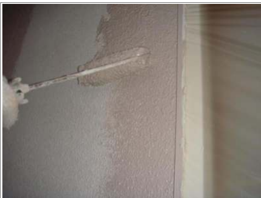
外壁中塗り施工中
