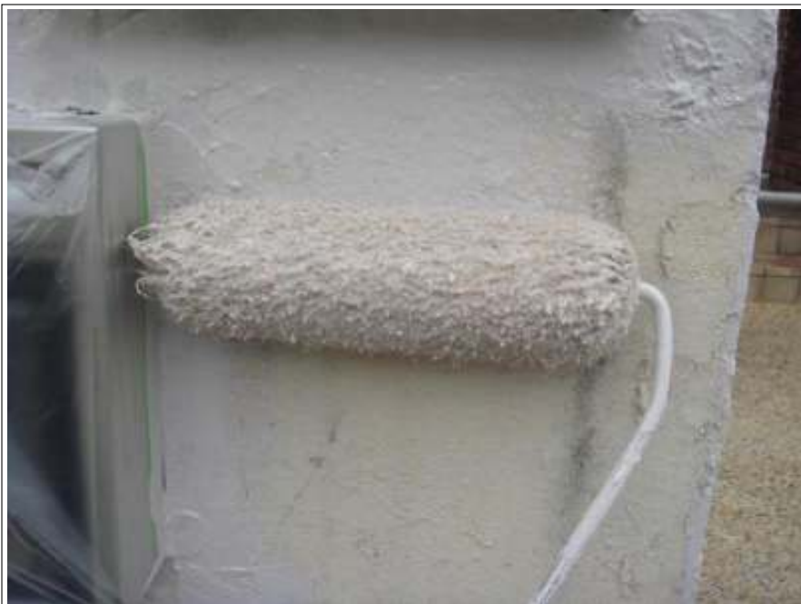
外塀上塗り1回目施工中
