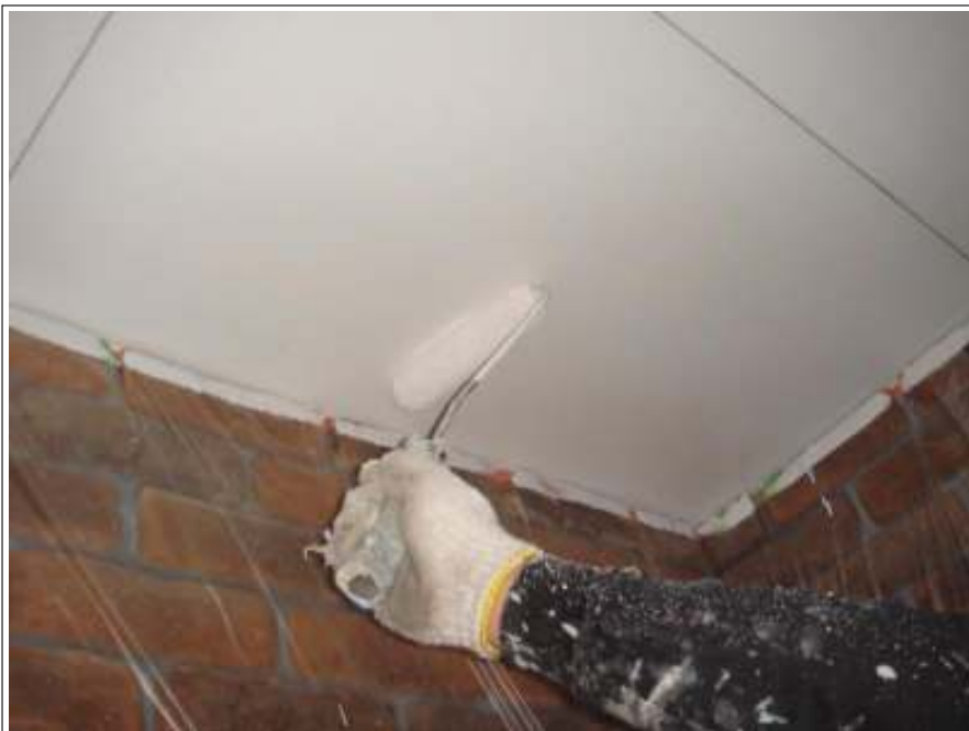
軒天塗装2回目施工中
