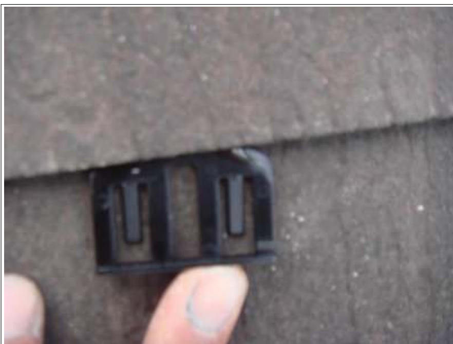
屋根 タスペーサー取付
