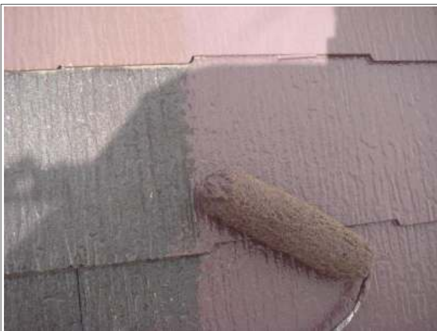
屋根 中塗り施工中
