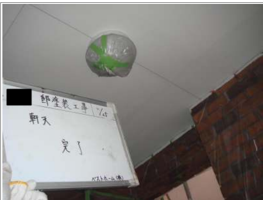
軒天塗装2回目施工完了
