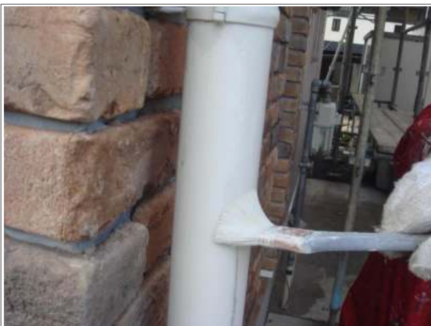
雨樋1回目施工中
