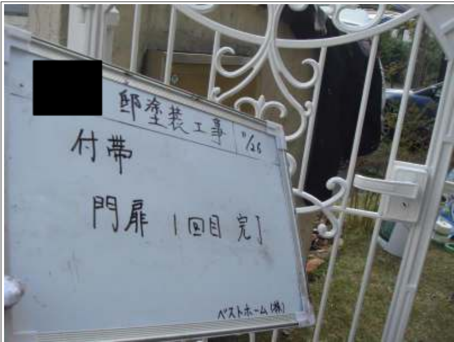
門扉1回目施工完了
