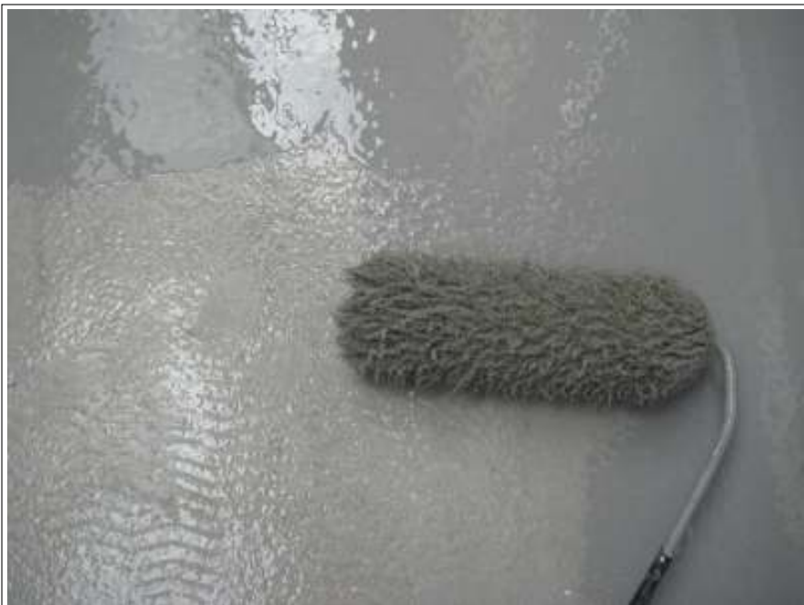
ベランダ防水上塗り1回目施工中
