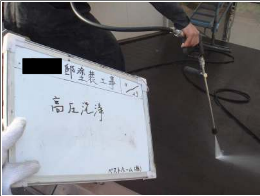
高圧洗浄施工中
