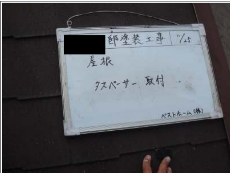
屋根 タスペーサー取付
