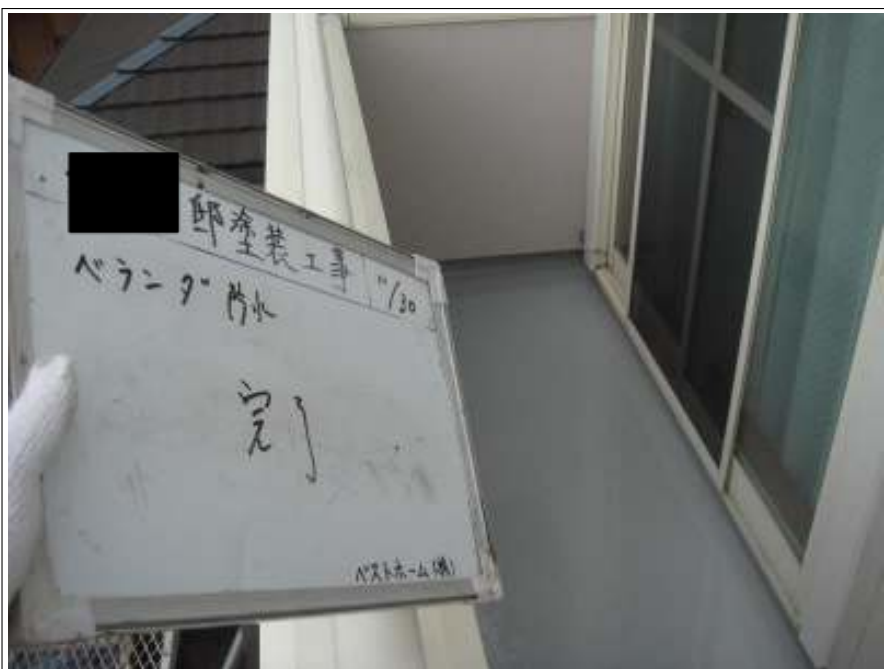
ベランダ防水上塗り2回目施工完了
