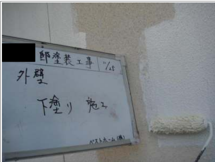
外壁下塗り施工中
