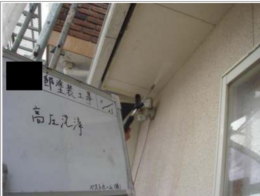
高压洗浄施工中
