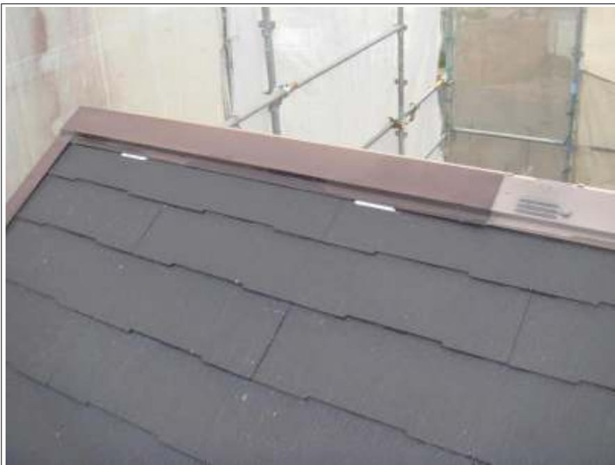
屋根 棟板金ラバー止め施工中
