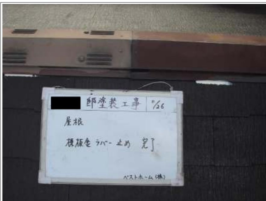
屋根 棟板金ラバー止め施工完了
