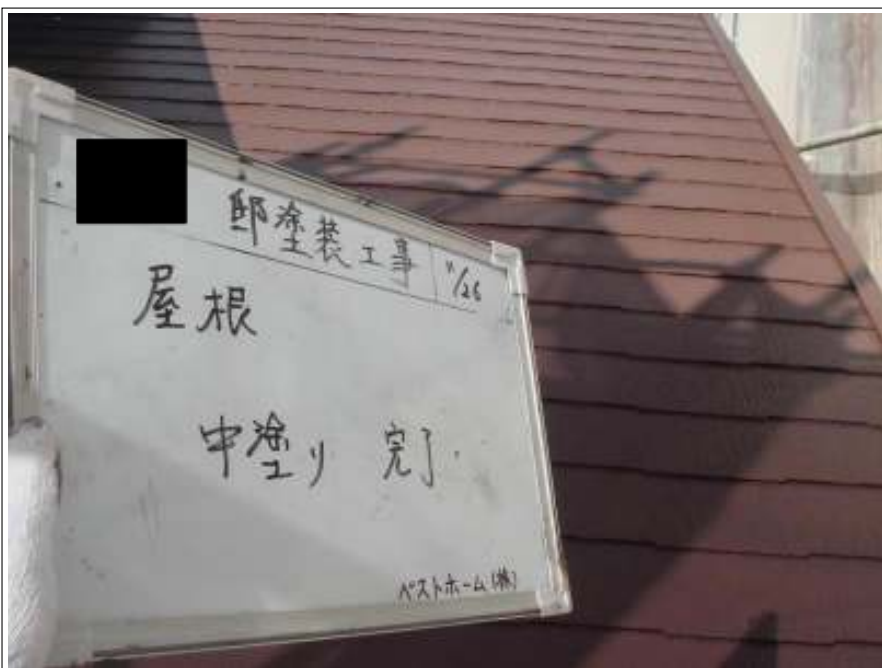
屋根 中塗り施工完了
