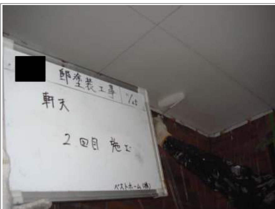
軒天塗装2回目施工中
