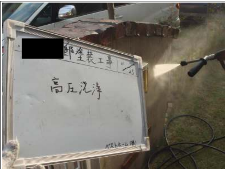
高圧洗浄施工中
