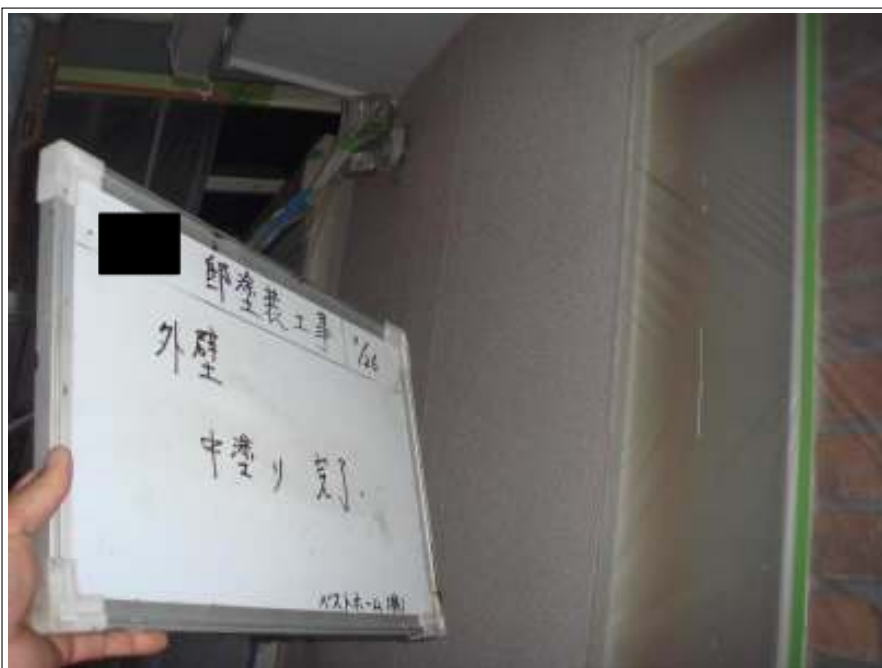
外壁中塗り施工完了
