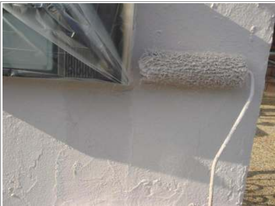
外塀上塗り2回目施工中
