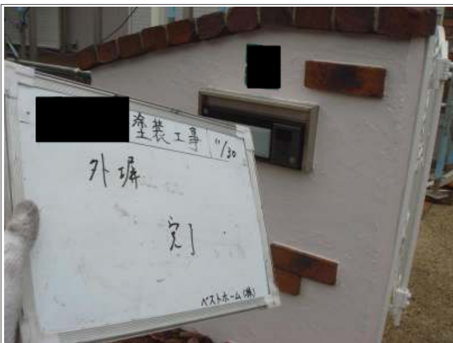
外塀上塗り2回目施工完了
