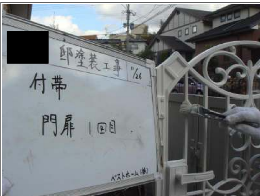
門扉1回目施工中
