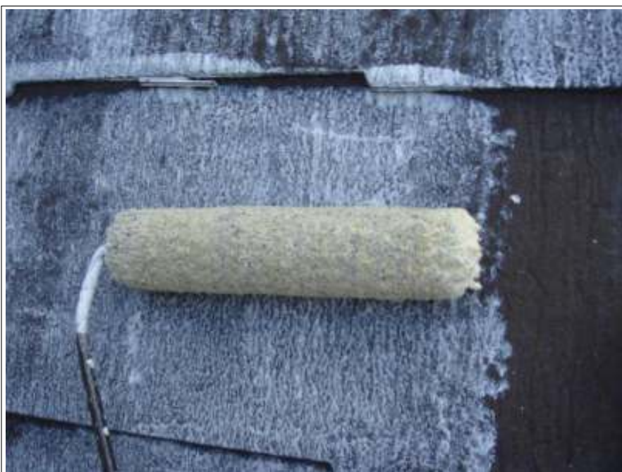
屋根 下塗り施工中
