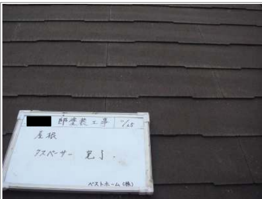
屋根 タスペーサー取付完了
