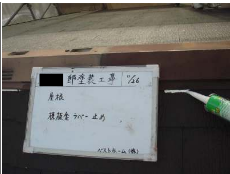
屋根 棟板金ラバー止め施工中
