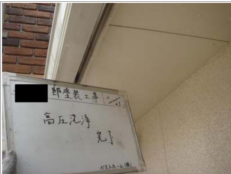
高压洗浄施工完了
