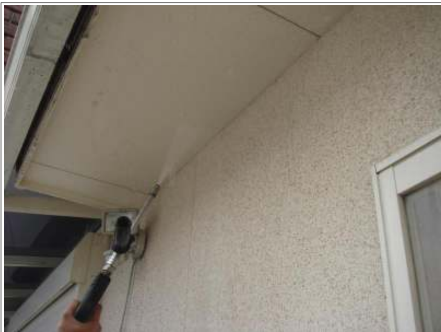
高压洗浄施工中
