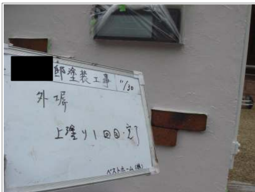
外塀上塗り1回目施工完了
