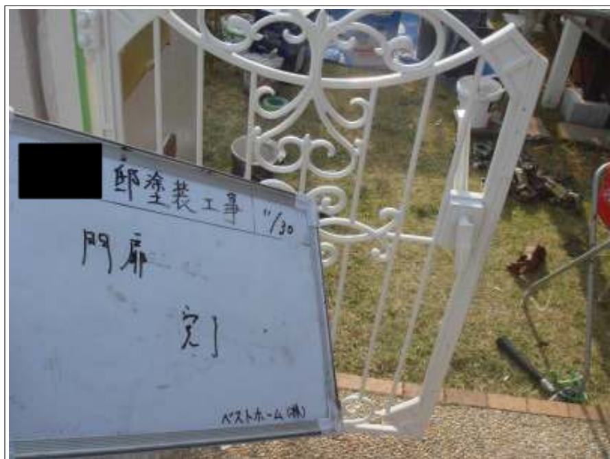
門扉2回目施工完了
