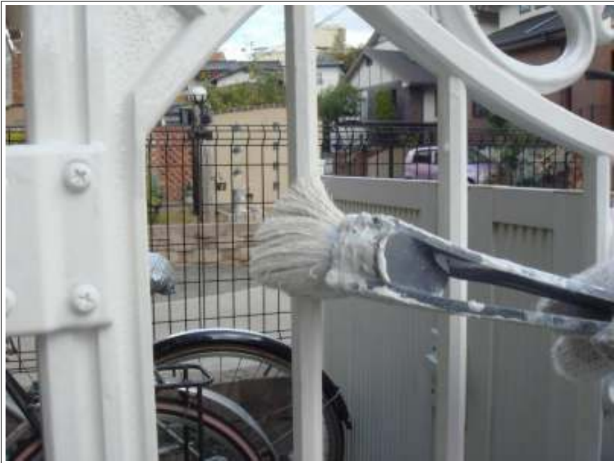
門扉1回目施工中
