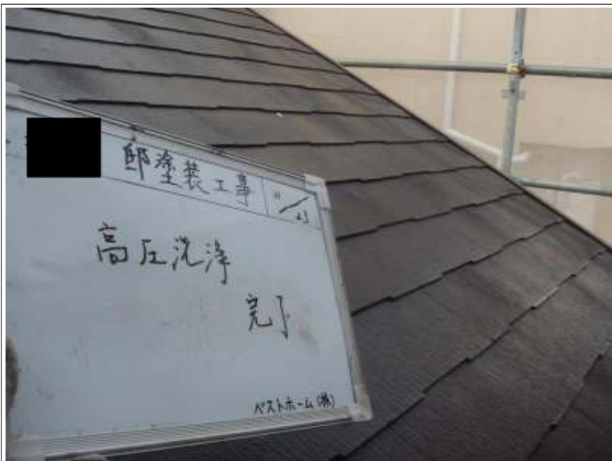
高圧洗浄施工完了
