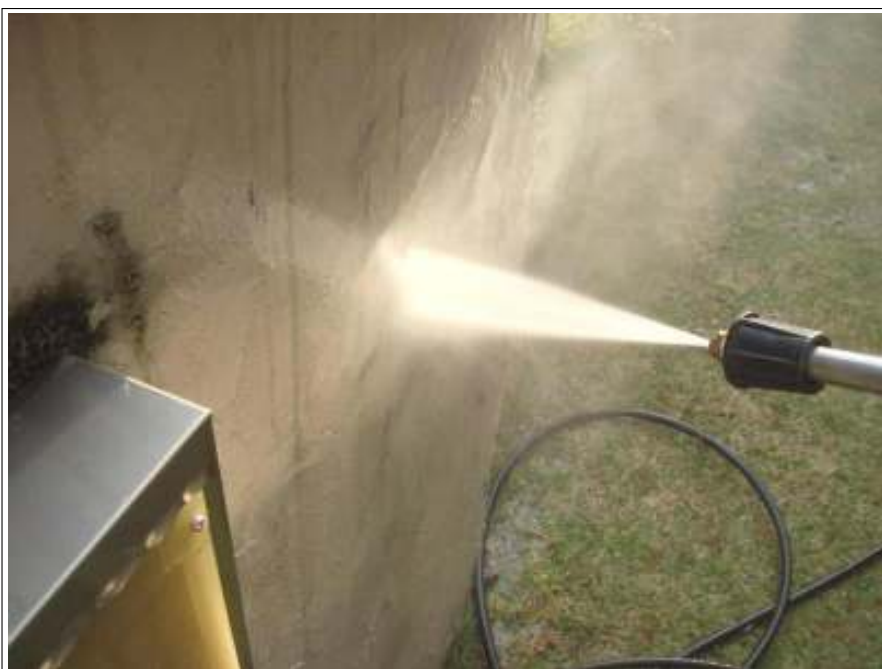
高圧洗浄施工中
