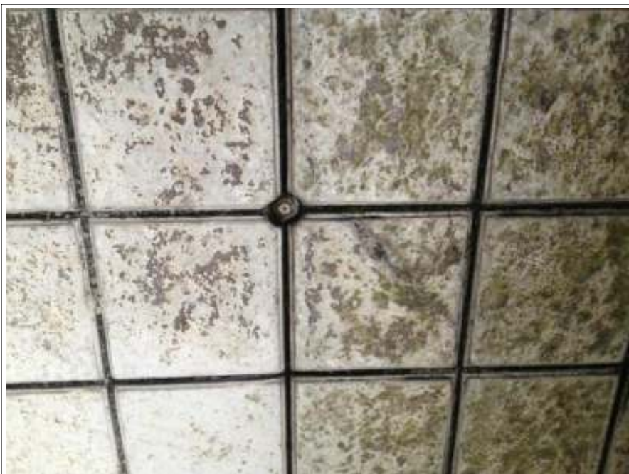
ベランダ 床タイル部
