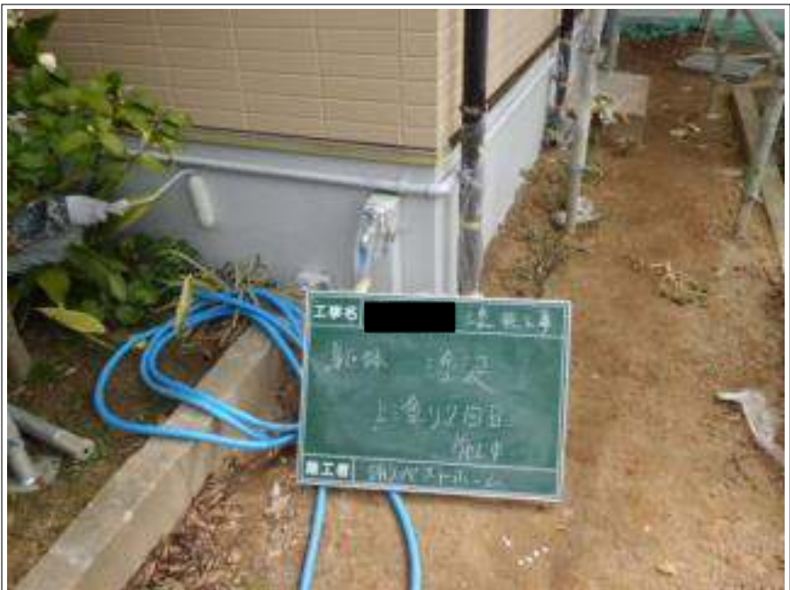
基礎塗装上塗り2回目施工中
