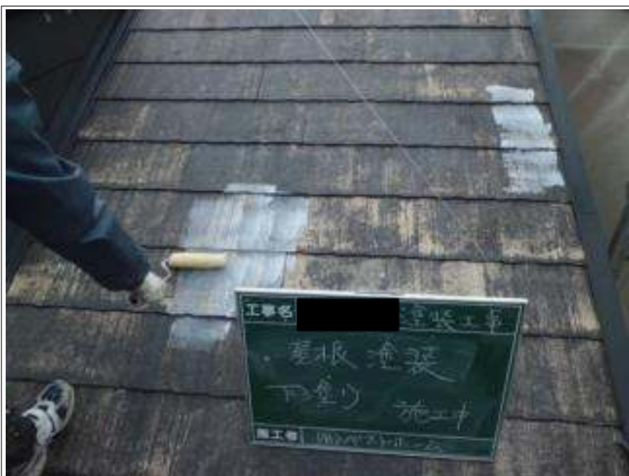
屋根塗装下塗り施工中
