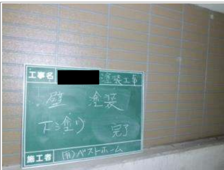
外壁塗装下塗り施工完了
