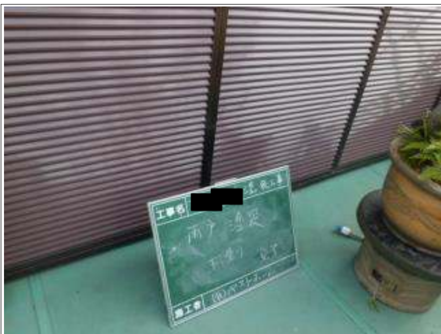
雨戸塗装下塗り施工完了
