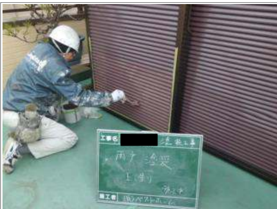
雨戸塗装上塗り施工中
