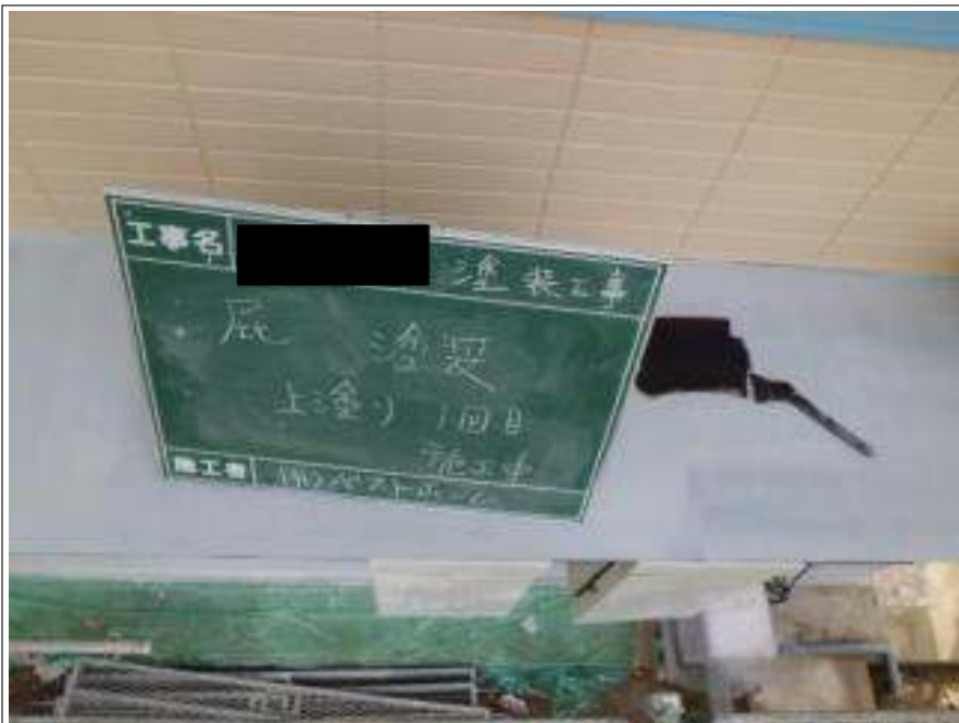
小庇塗装上塗り 1 回目施工中
