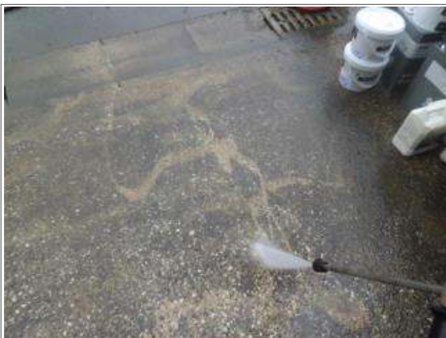
土間高压洗净施工中
