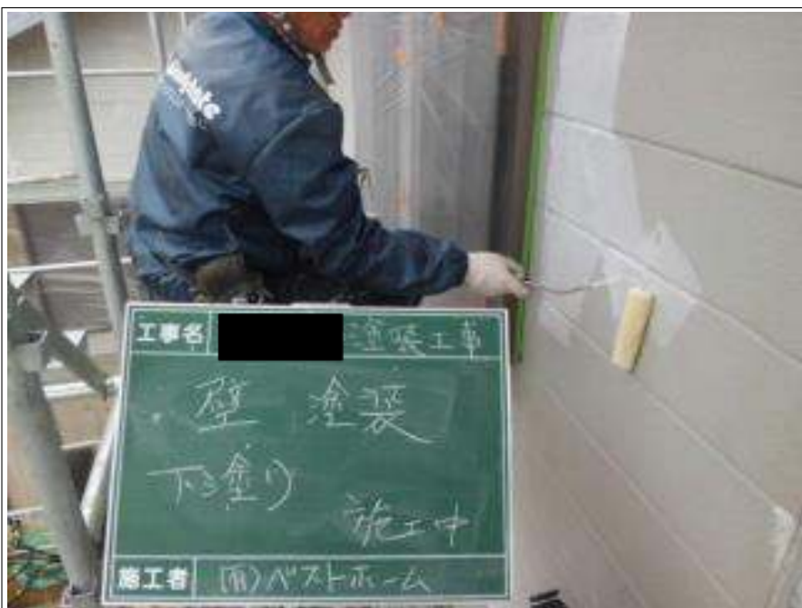
外壁塗装下塗り施工中
