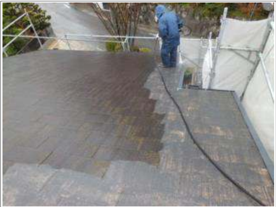
屋根高圧洗浄施工中
