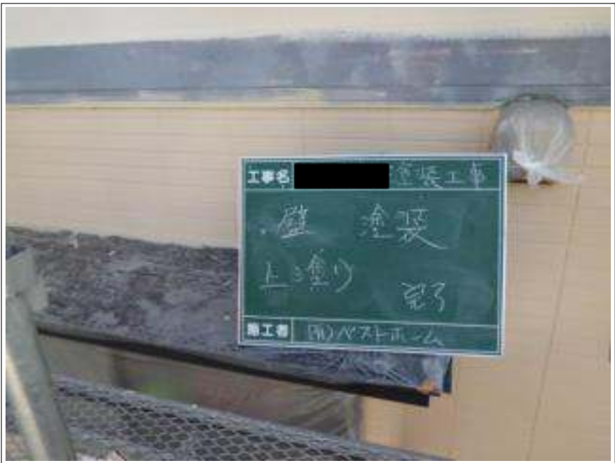
外壁塗装上塗り施工完了
