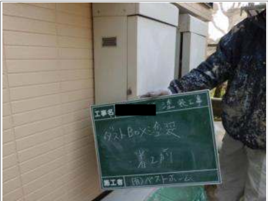
ダストボックス塗装施工前
