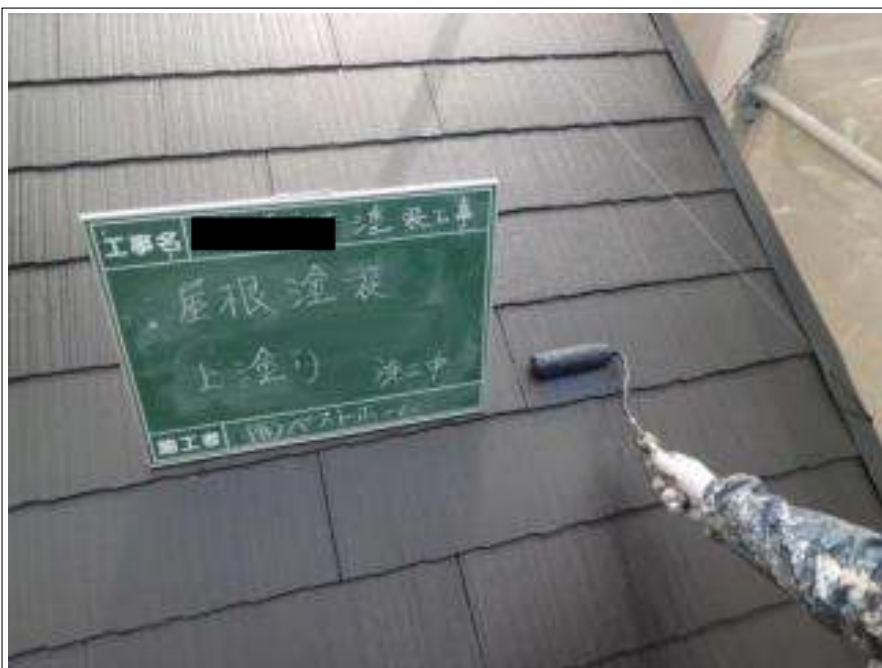
屋根塗装上塗り施工中
