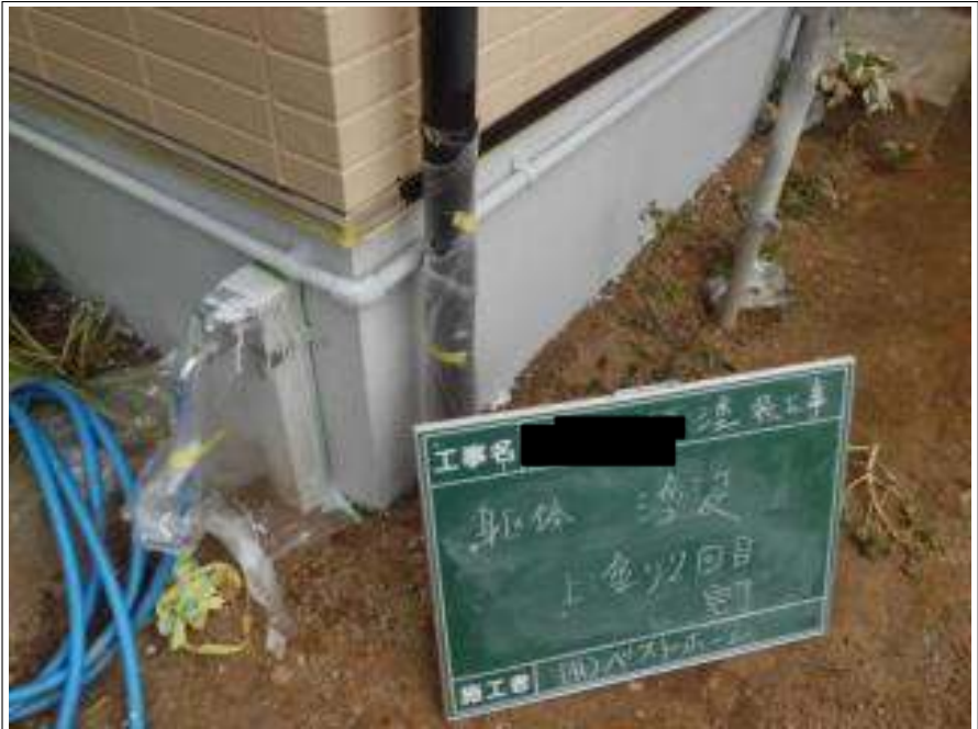
基礎塗装上塗り2回目施工完了
