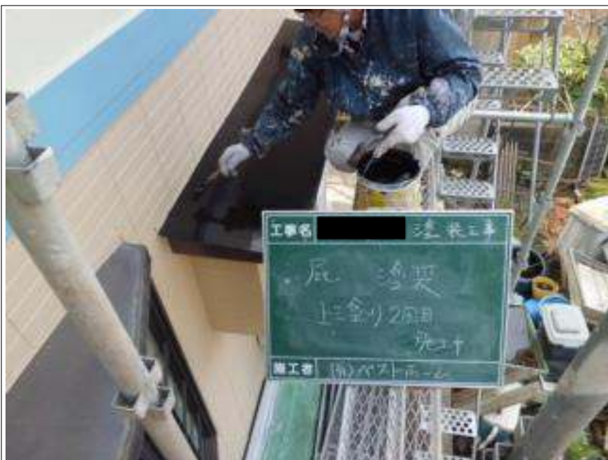
小庇塗装上塗り 2 回目施工中
