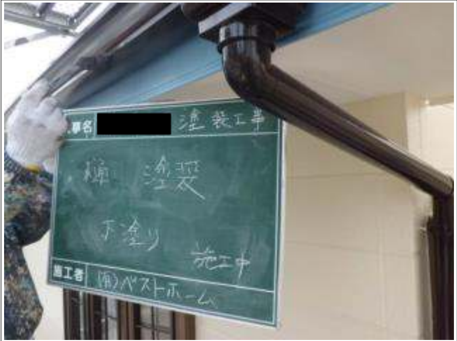
棟塗装下塗り施工中
