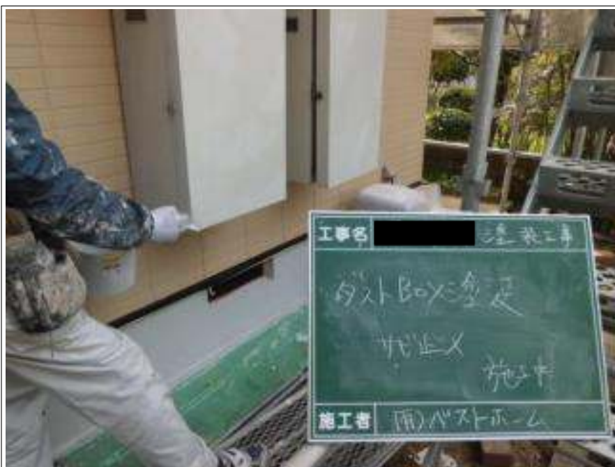
ダストボックスサビ止め施工中
