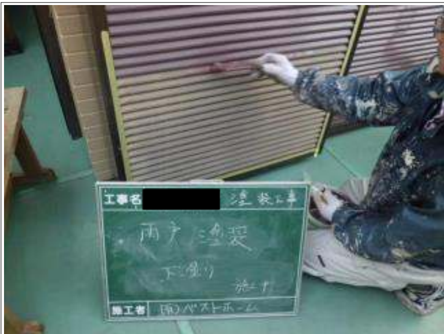
雨戸塗装下塗り施工中
