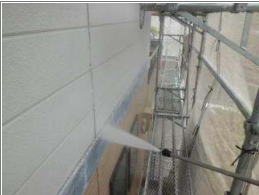
外壁高圧洗浄施工中
