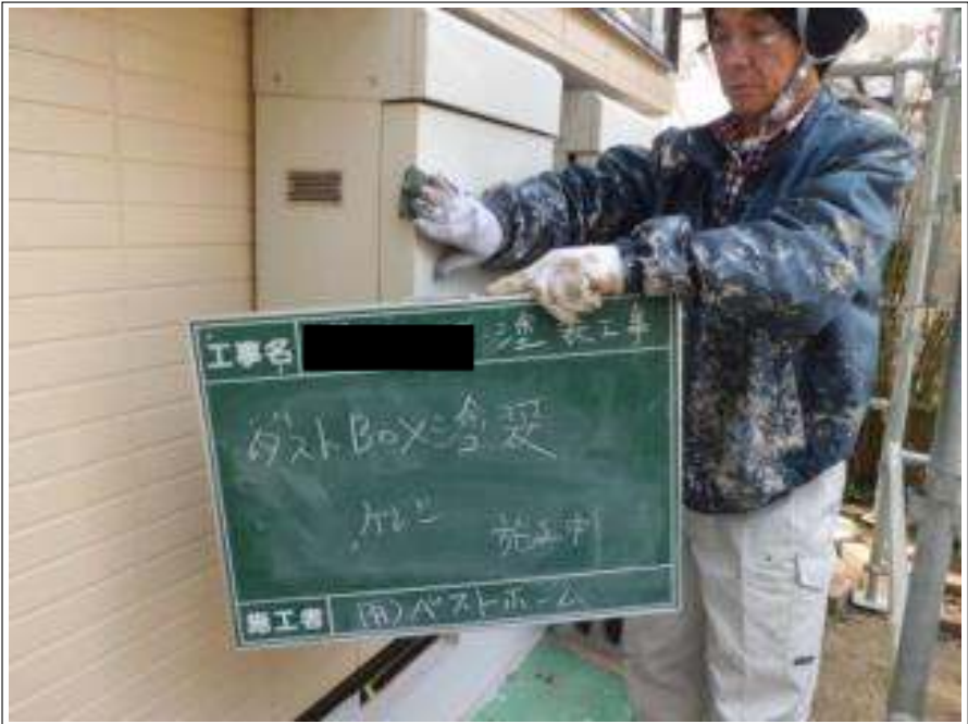
ダストボックス架設施工中
