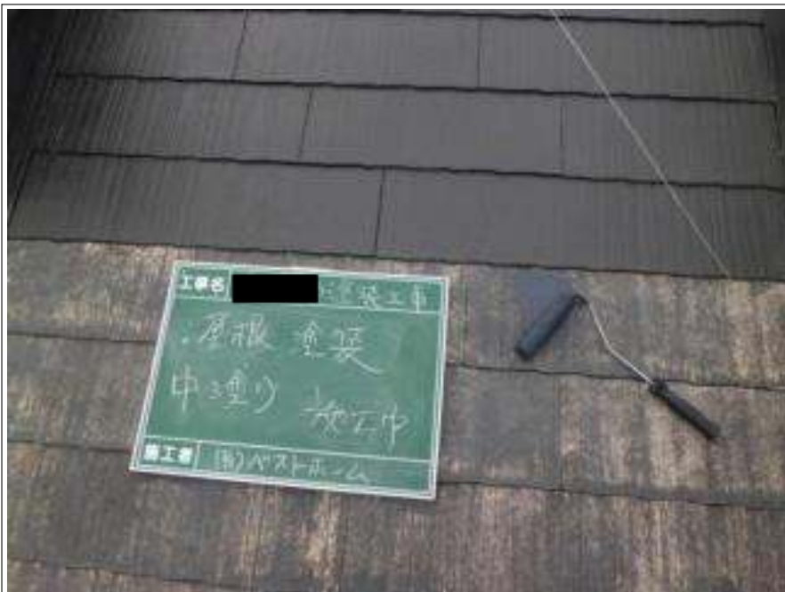
屋根塗装中塗り施工中
