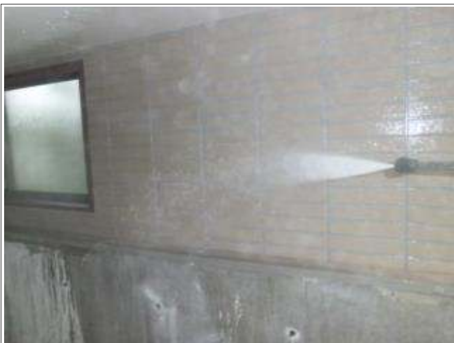
車庫高压洗净施工中
