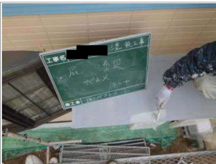
小庇塗装サビ止め施工中
