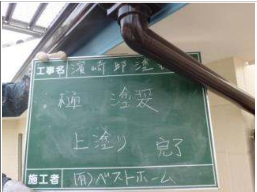
樋塗装上塗り施工完了
