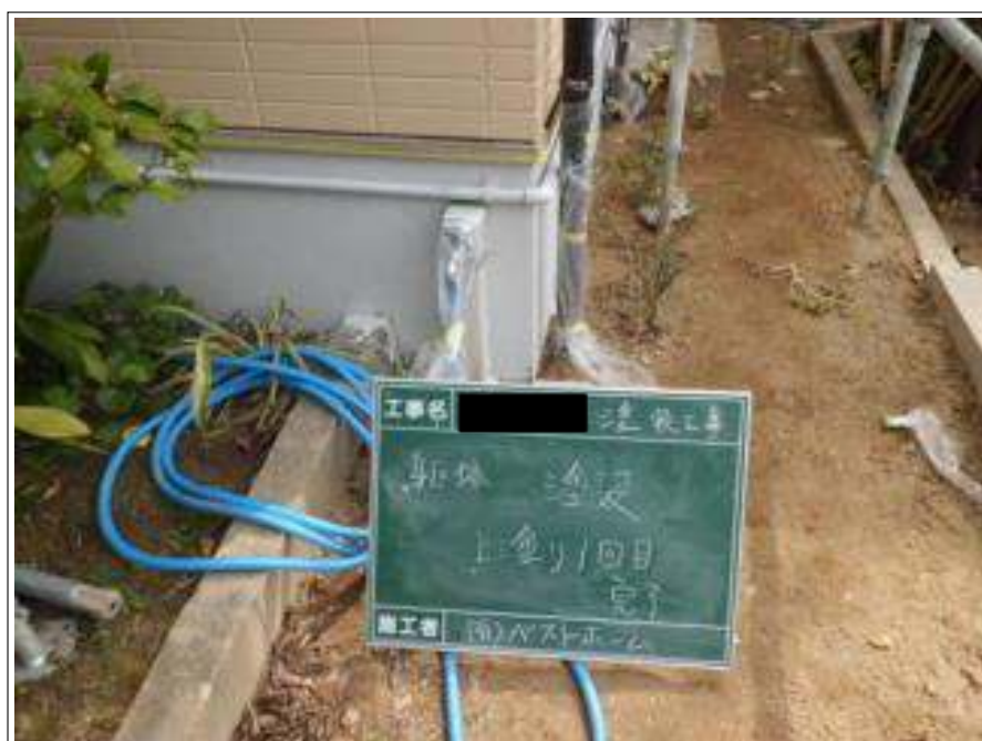
基礎塗装上塗り1回目施工完了
