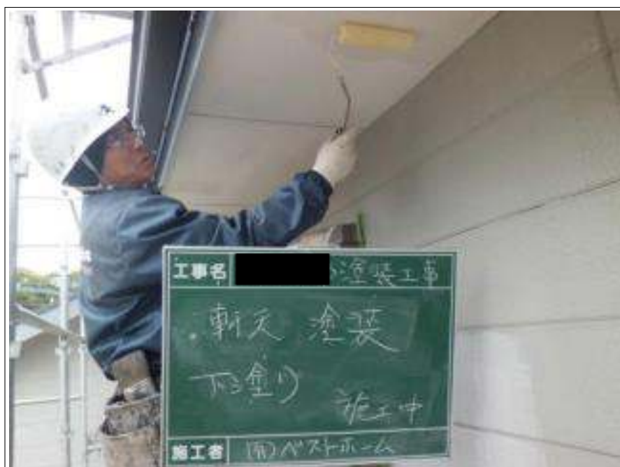
軒天塗装下塗り施工中
