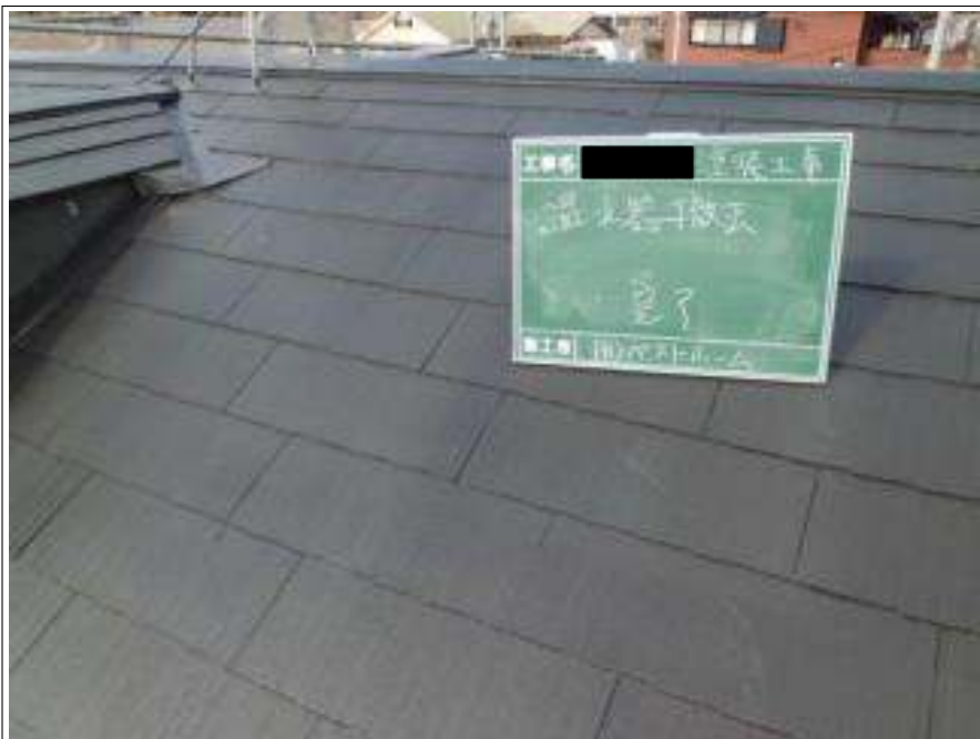
温水器撤去施工完了
