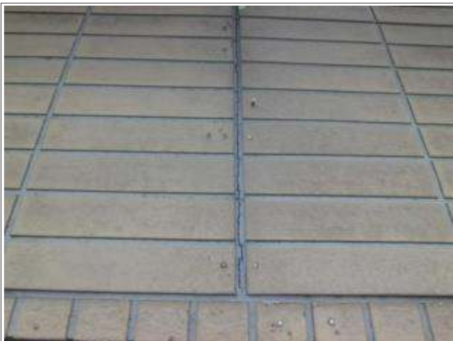
外壁コーキング打替え施工前
