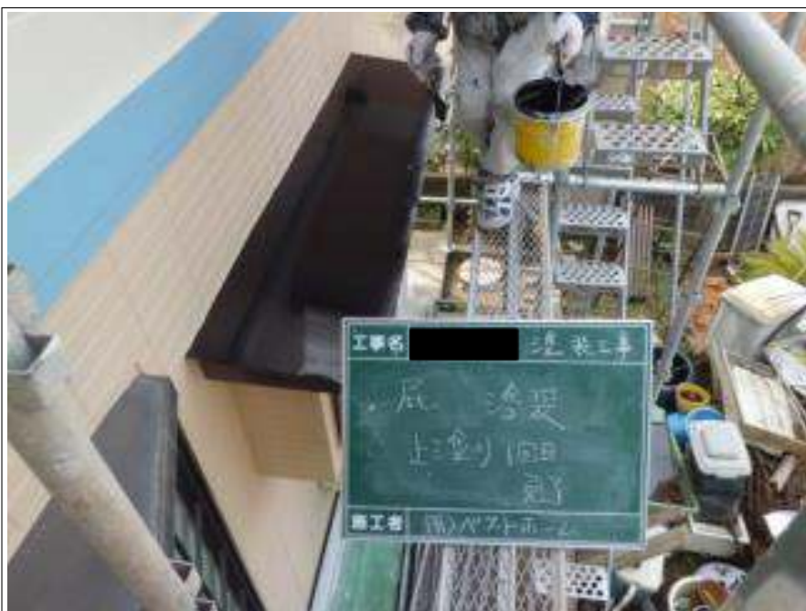
小庇塗装上塗り 1 回目施工完了
