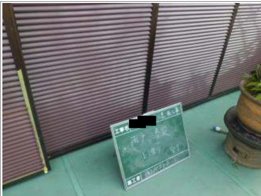
雨戸塗装上塗り施工完了
