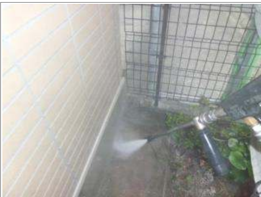
基礎高圧洗浄施工中
