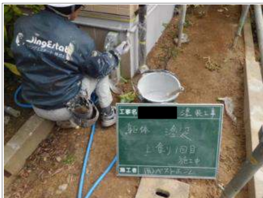
基礎塗装上塗り1回目施工中
