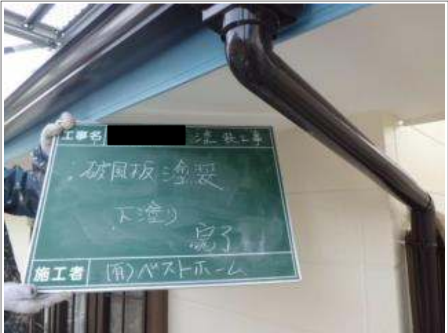
破風板塗装下塗り施工完了
