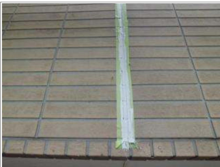
外壁コーキング補修施工中
