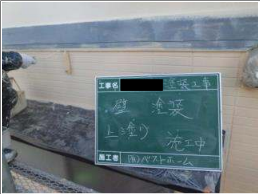
外壁塗装上塗り施工中
