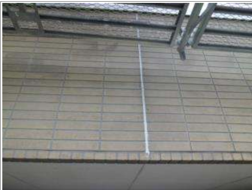
外壁コーキング補修施工完了
