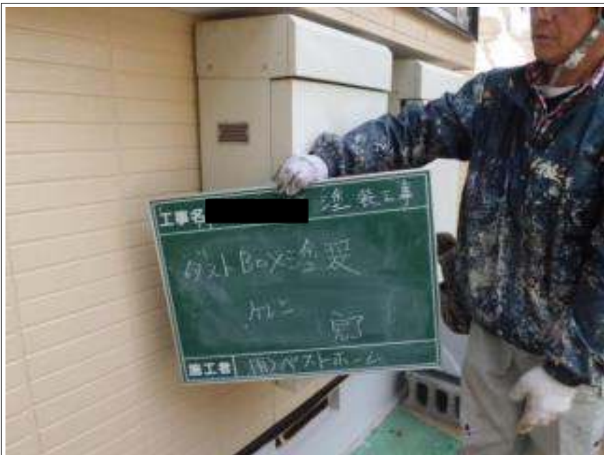
ダストボックスケレン施工完了
