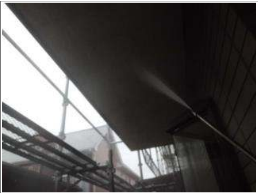
軒天高圧洗浄施工中
