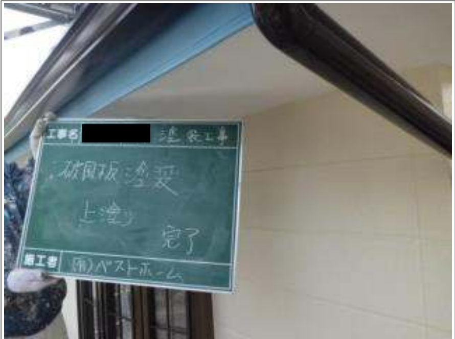
破風板塗装上塗り施工完了
