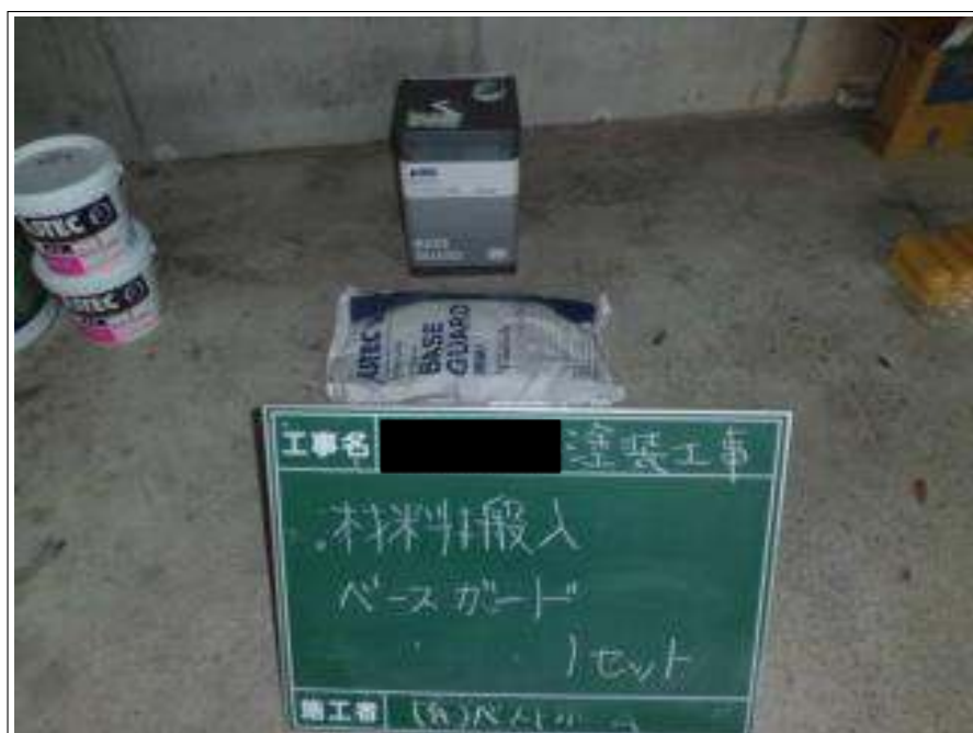
基礎上塗り塗装使用材料
