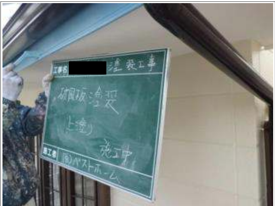
破風板塗装上塗り施工中
