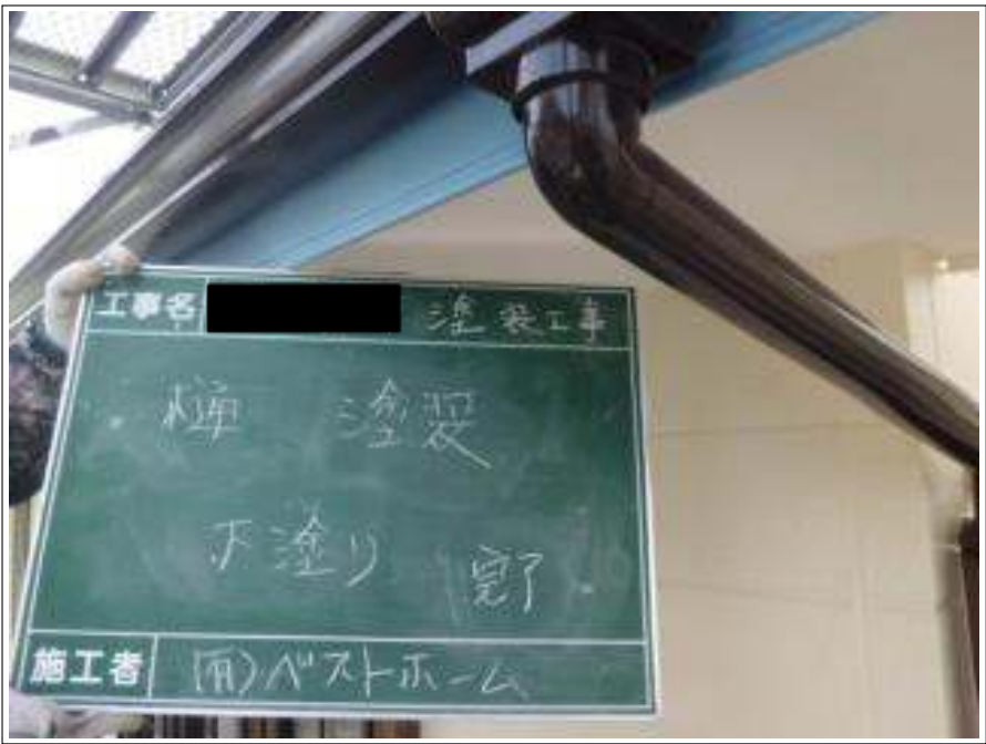
樋塗装下塗り施工完了
