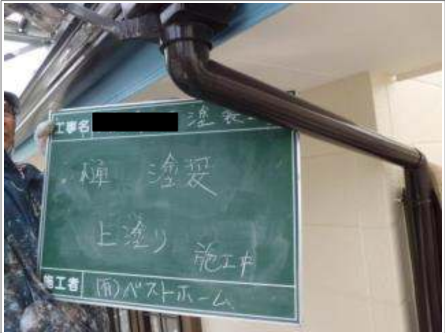
樋塗装上塗り施工中
