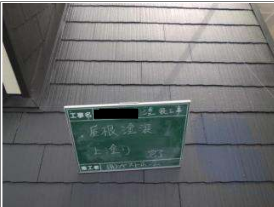
屋根塗装上塗り施工完了
