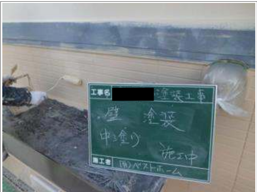
外壁塗装中塗り施工中
