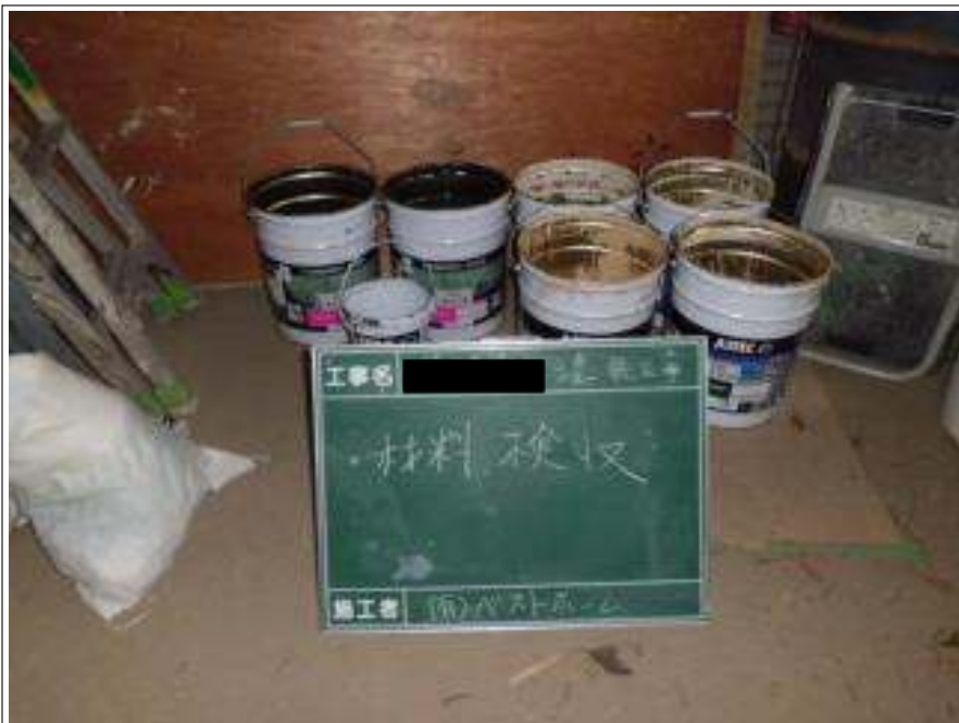
屋根・外壁上塗り使用材料空缶
