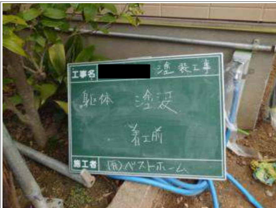
基礎塗装施工前
