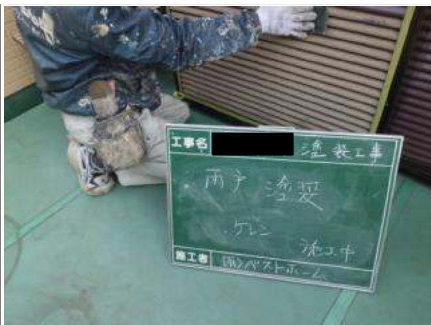
雨戸ケレン施工中
