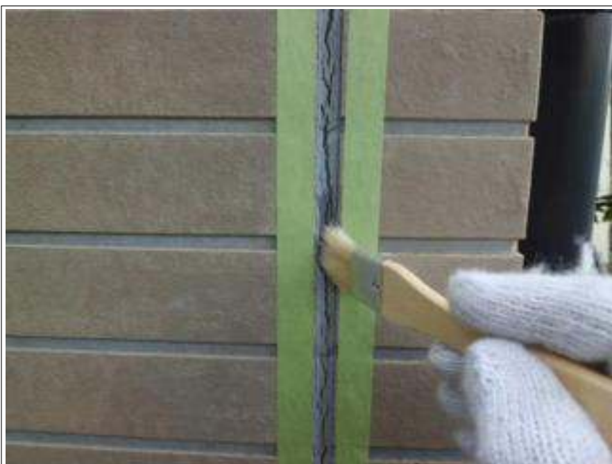
外壁コーキング補修施工中
