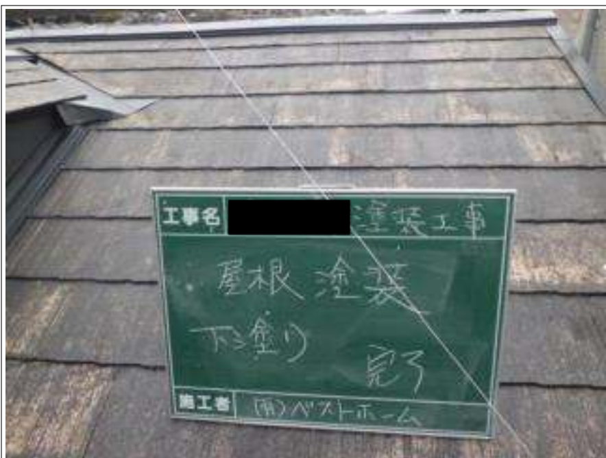
屋根塗装下塗り施工完了
