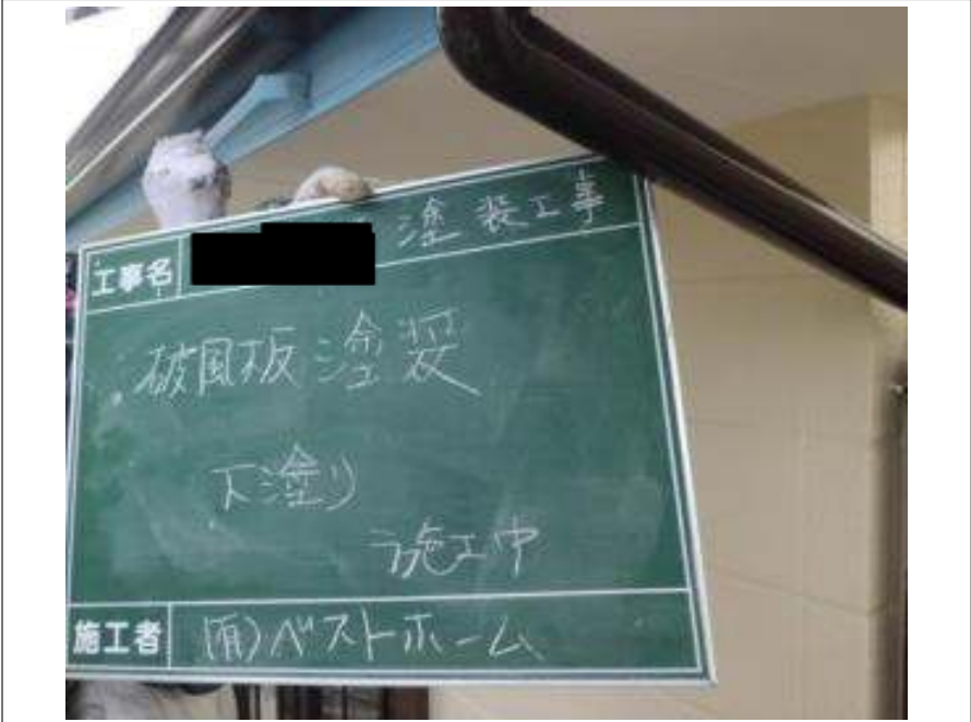
破風板塗装下塗り施工中
