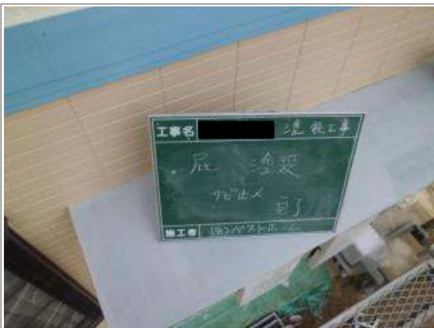
小庇塗装サビ止め施工完了
