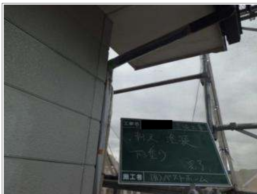
軒天塗装下塗り施工完了
