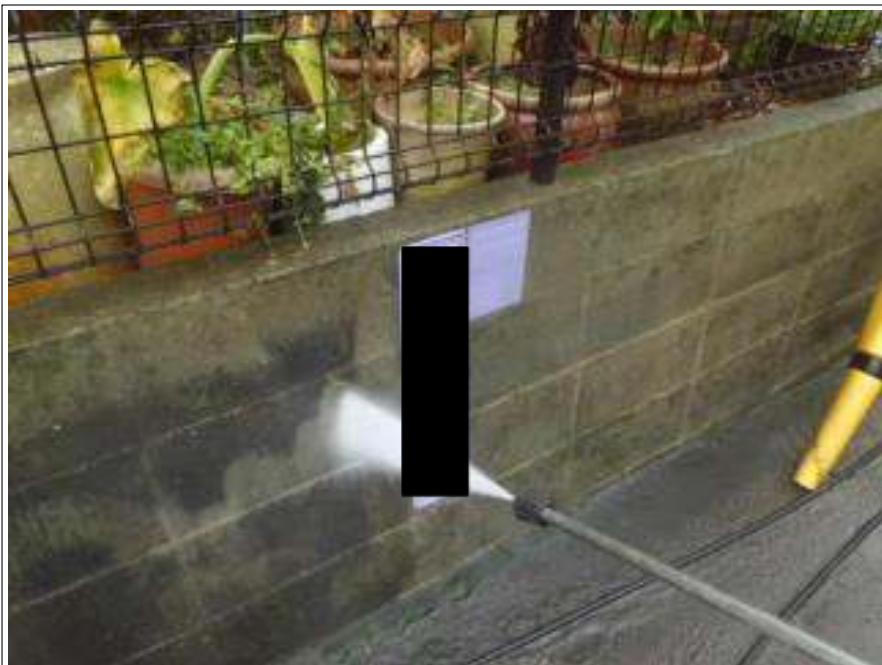
塀高压洗净施工中
