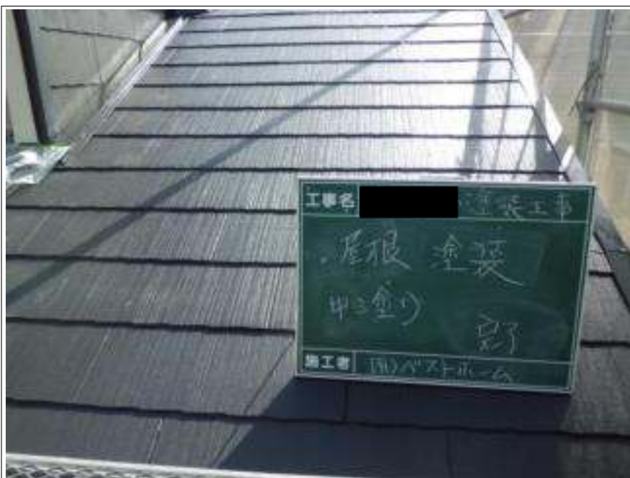
屋根塗装中塗り施工完了
