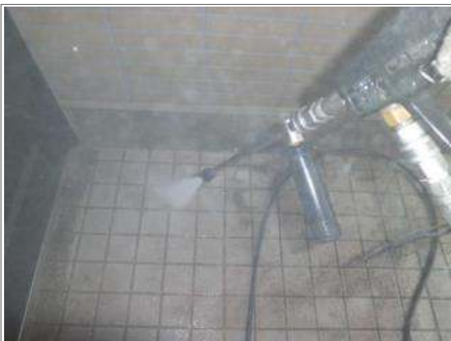
玄関高圧洗浄施工中
