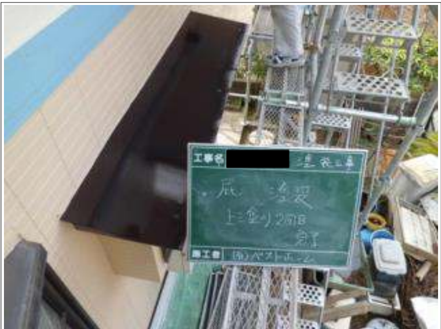
小庇塗装上塗り2回目施工完了
