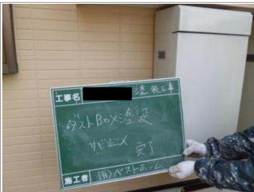
ダストボックスサビ止め施工完了
