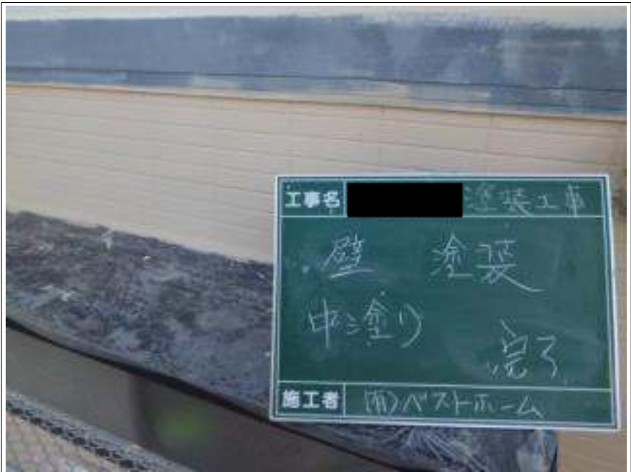
外壁塗装中塗り施工完了
