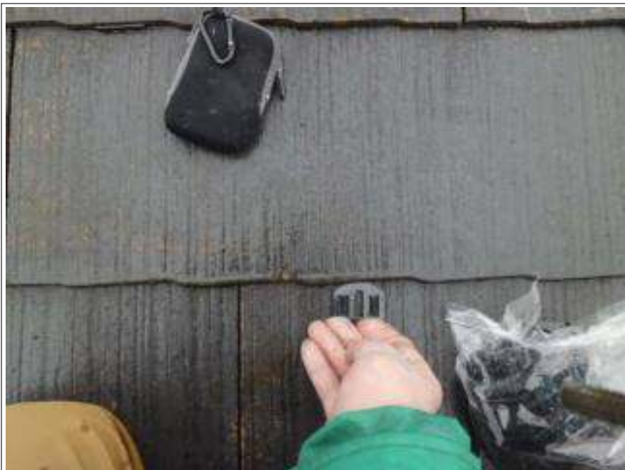
屋根タスペーサー施工中
