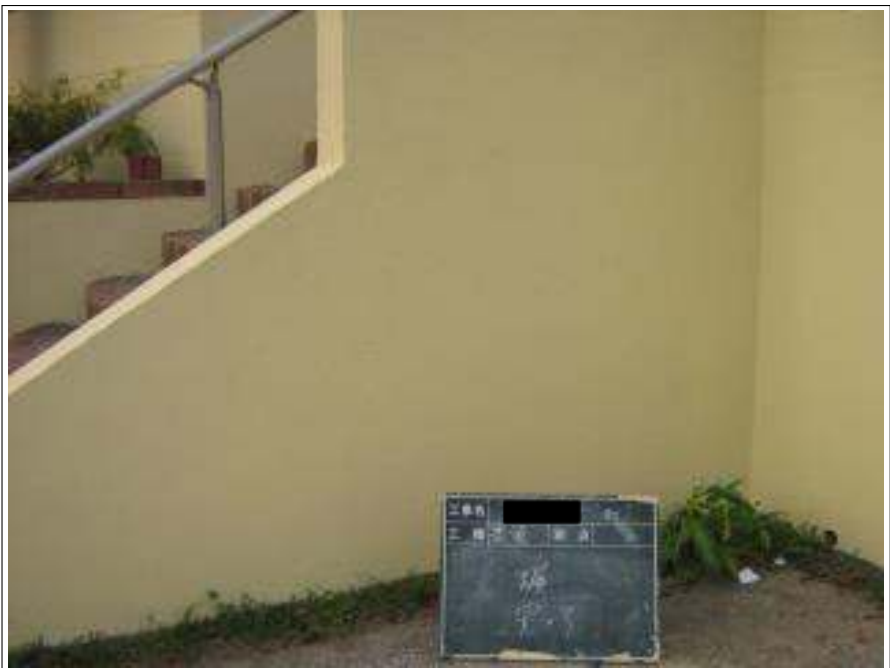
塀塗装施工完了
