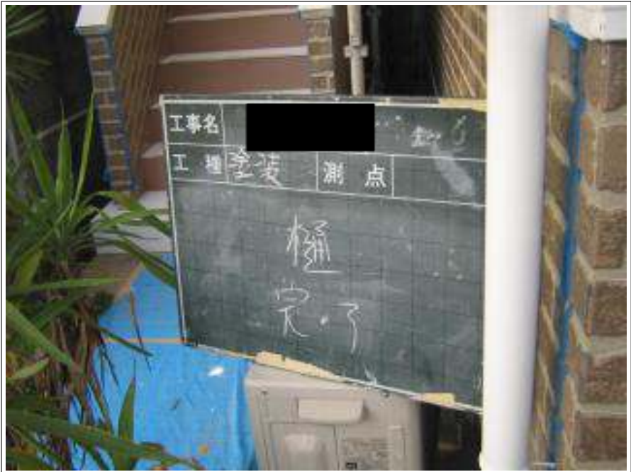
樋塗装施工完了
