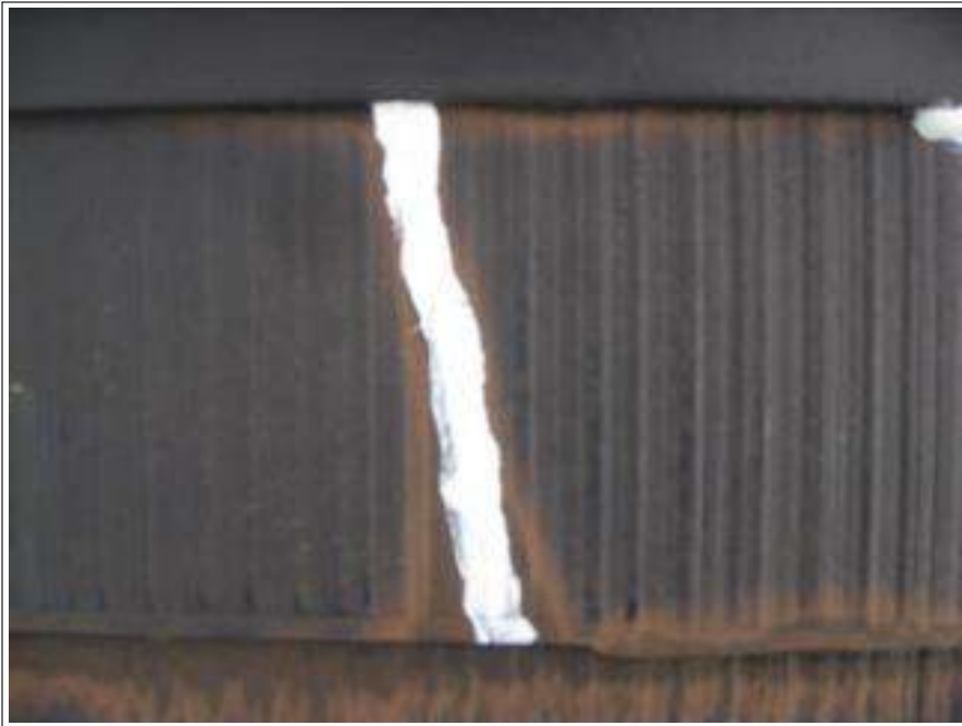
クラック補修施工完了
