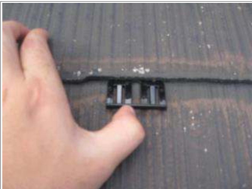
タスペーサー施工中
