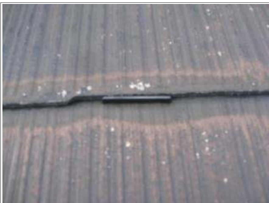
タスペーサー施工完了
