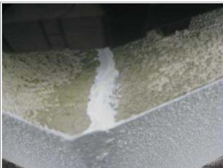
クラック補修施工完了
