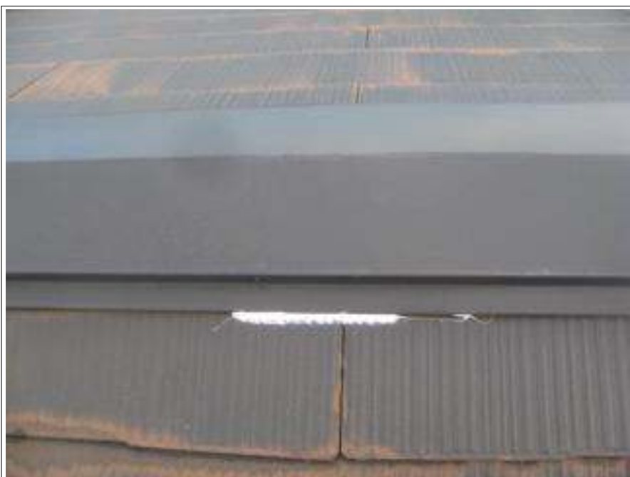
棟鉄板ラバー止め施工完了
