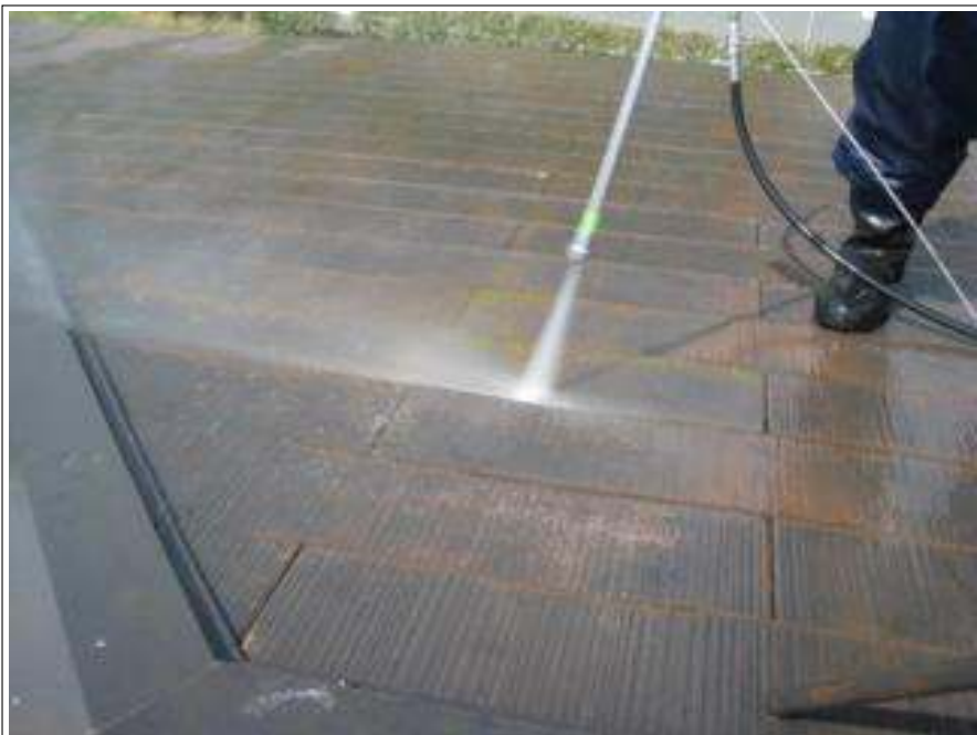
屋根高圧洗浄施工中
