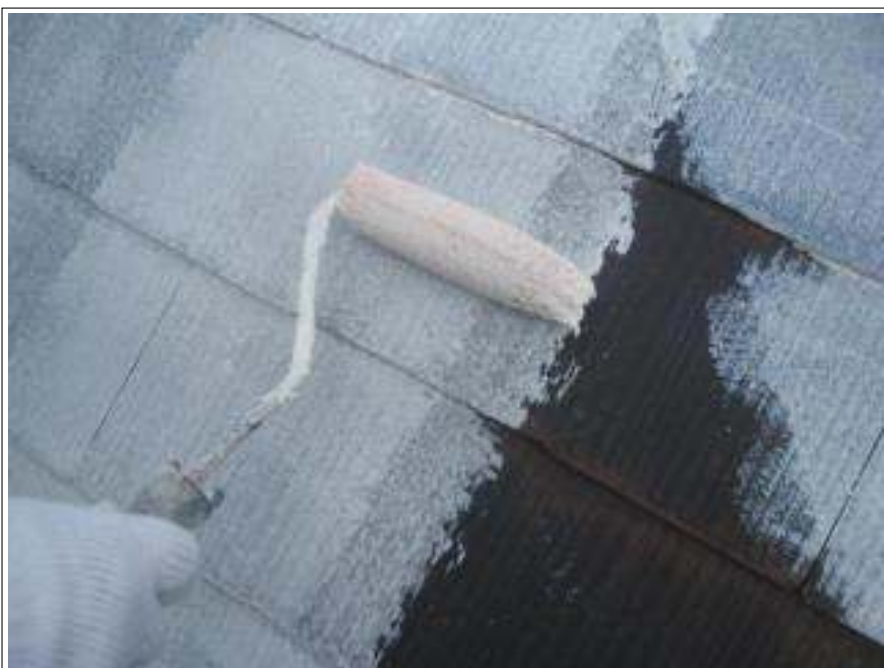
屋根塗装下塗り施工中
