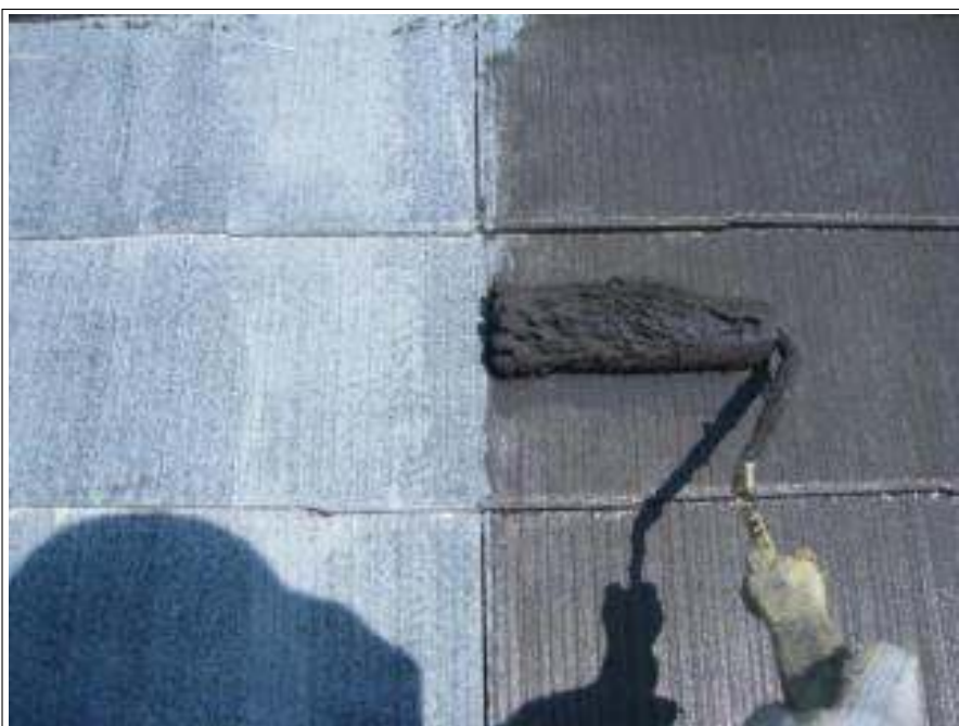
屋根塗装中塗り施工中
