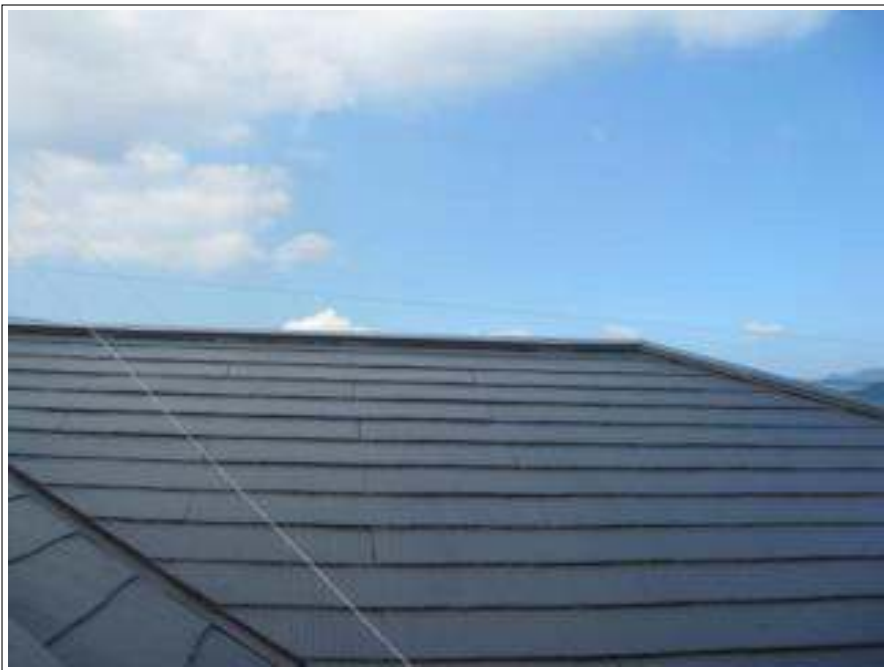
屋根塗装施工完了
