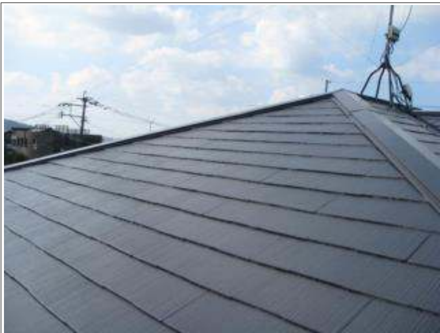
屋根塗装施工完了
