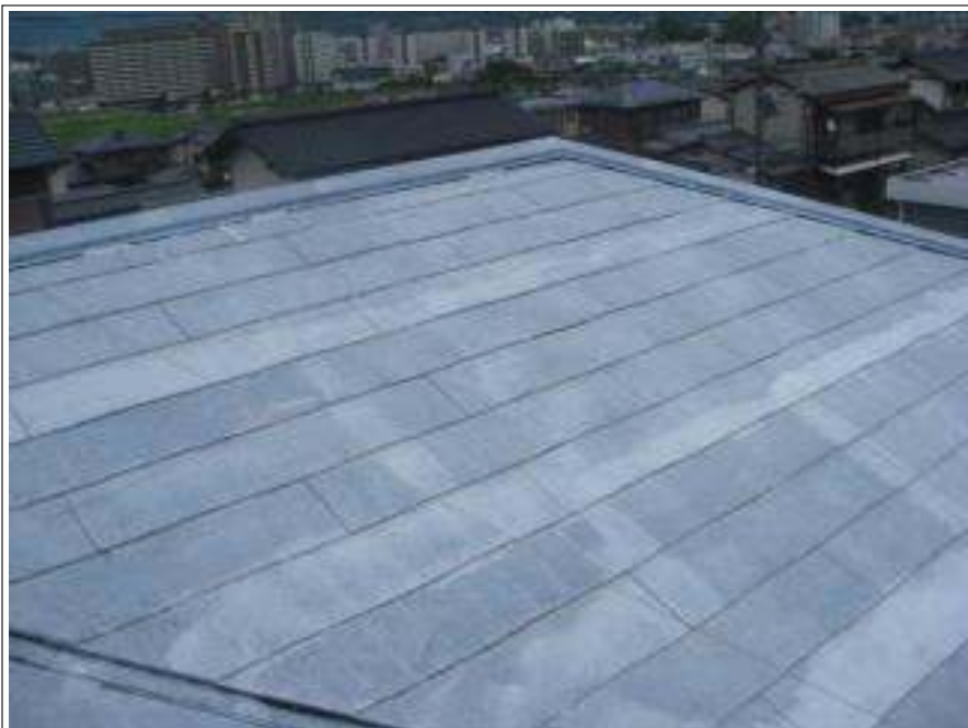
屋根塗装下塗り施工完了
