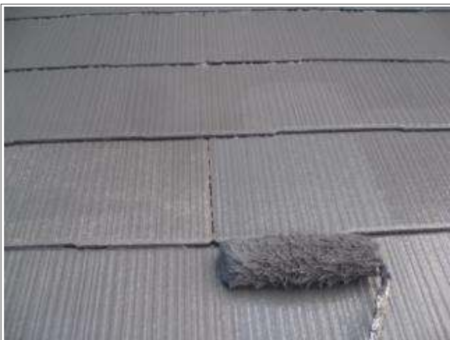
屋根塗装上塗り施工中
