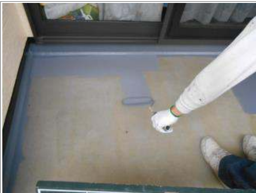
ベランダ塗装中塗り施工中
