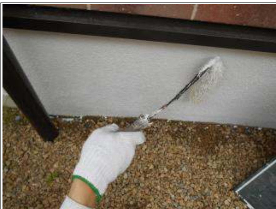
基礎塗装 2回目施工中
