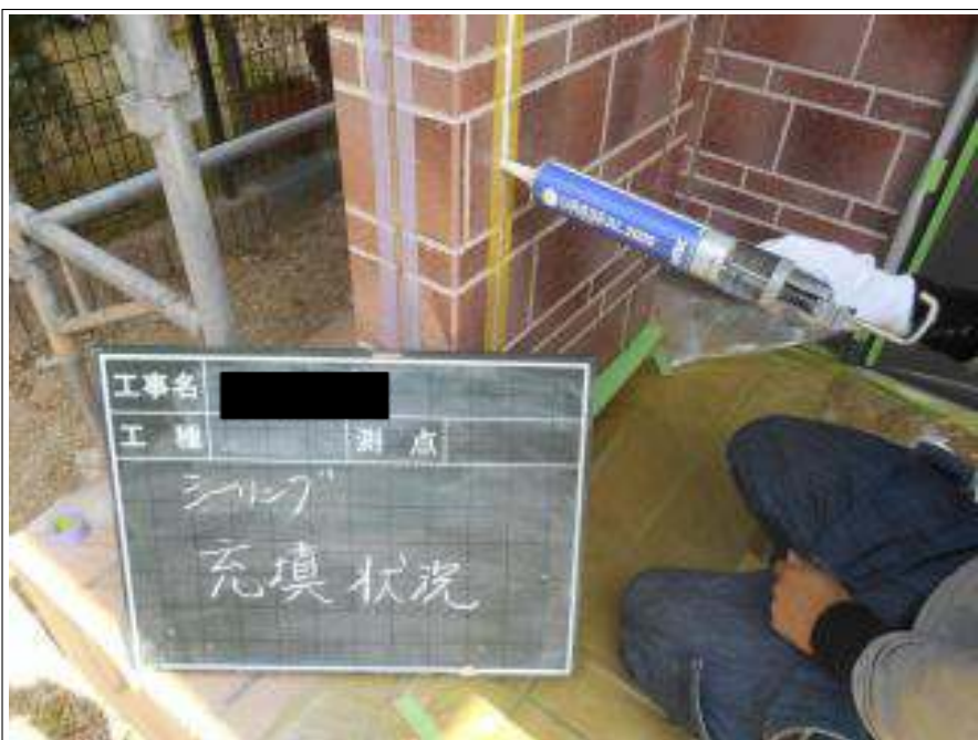
外壁シーリング充填状況
