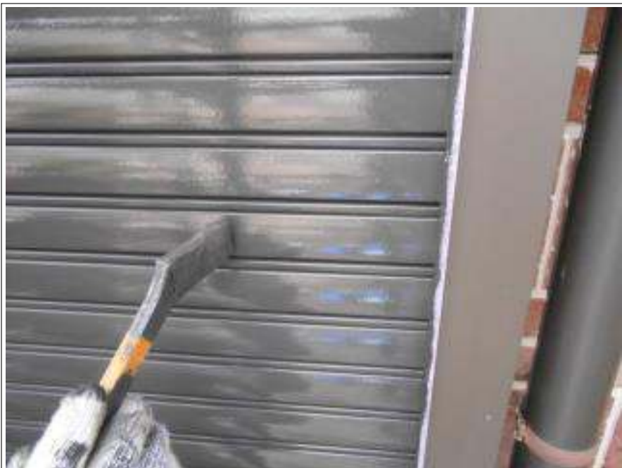
シャッター塗装施工中
