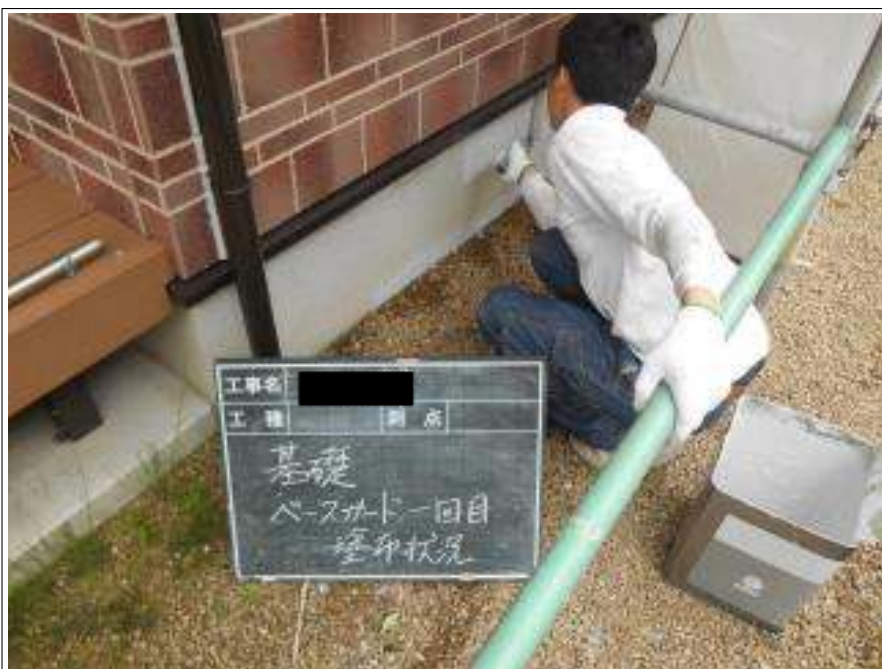
基礎塗装 1 回目施工中
