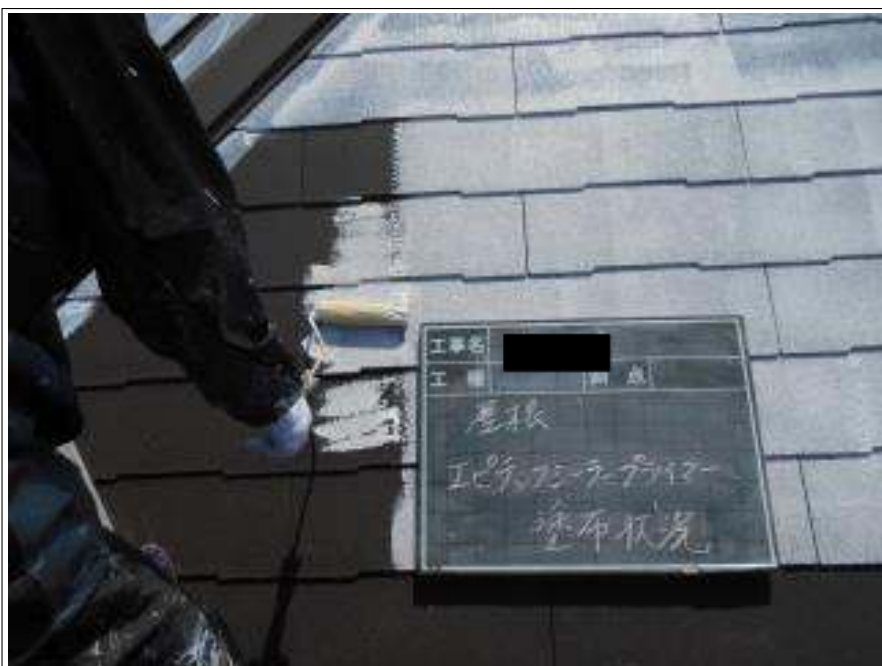
屋根塗装下塗り施工中
