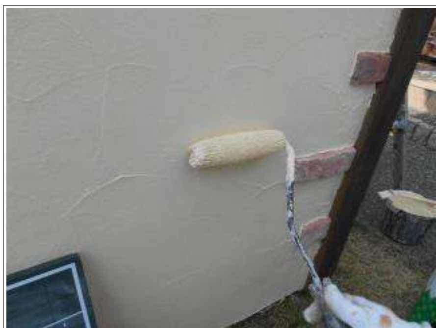
小屋外壁塗装上塗り施工中
