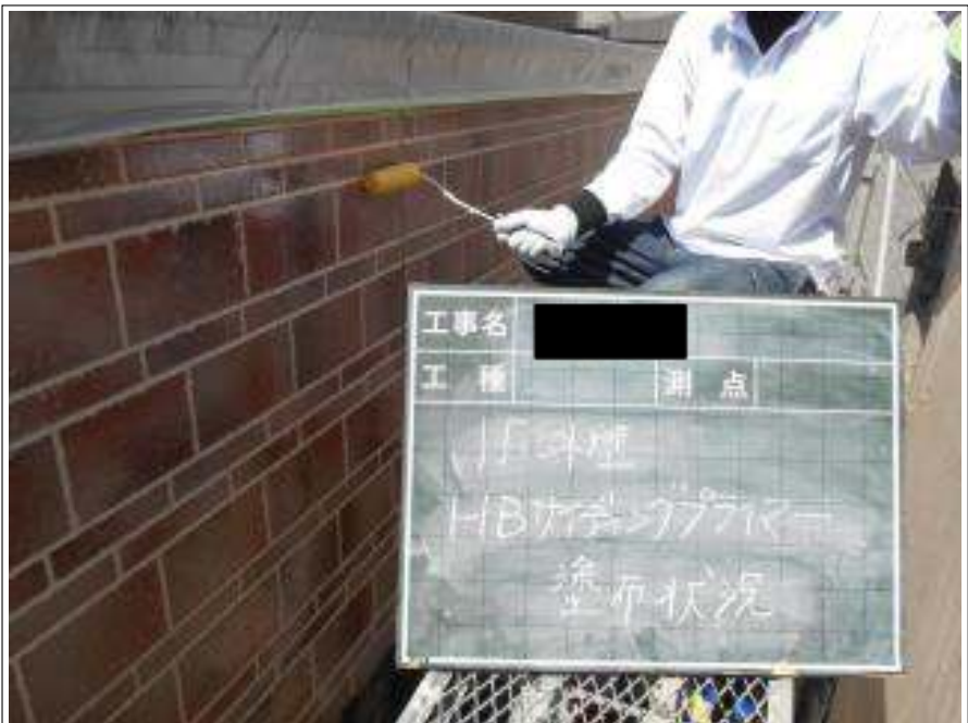
外壁塗装下塗り施工中
