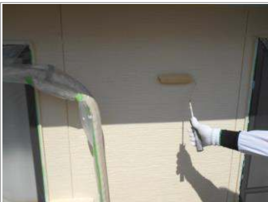
外壁塗装上塗り施工中
