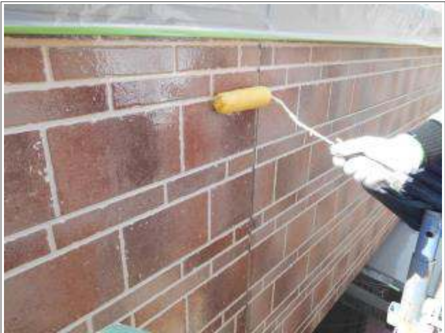
外壁塗装下塗り施工中
