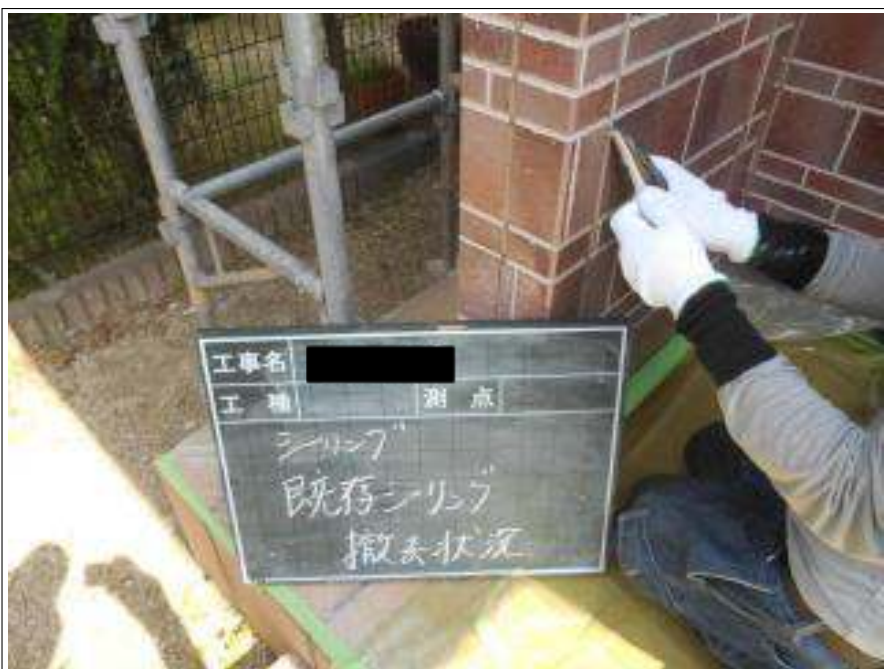
外壁シーリング撤去施工中
