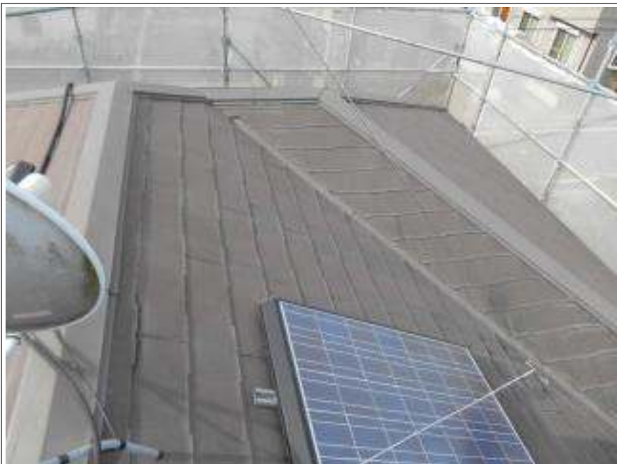
屋根高圧洗浄
