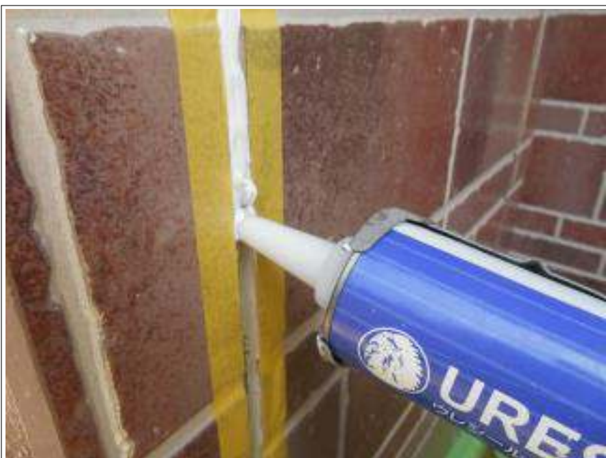
外壁シーリング充填状況
