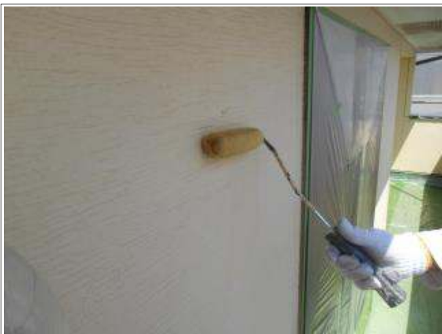
外壁バリアー施工中
