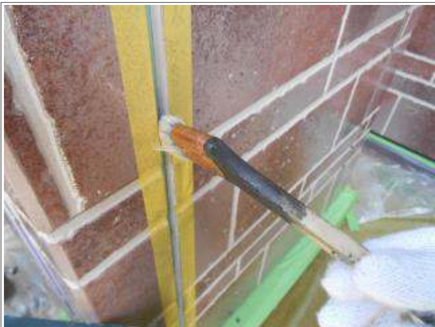
外壁プライマー塗布施工中
