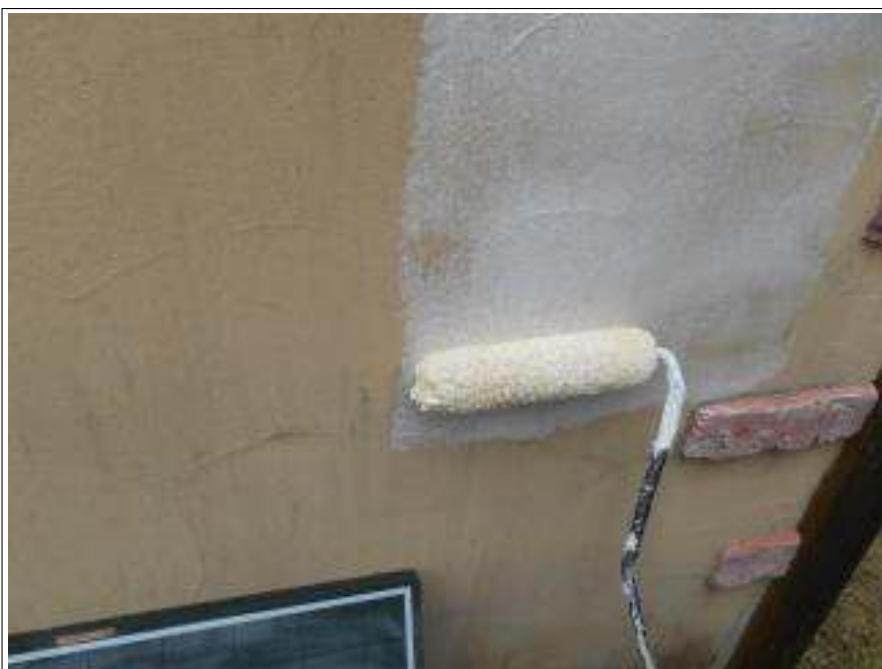
小屋外壁塗装下塗り施工中
