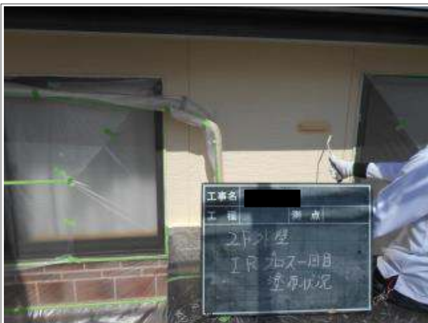
外壁塗装中塗り施工中
