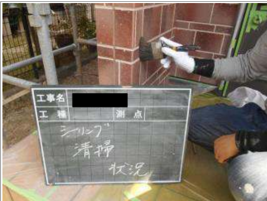
外壁シーリング掃除施工中
