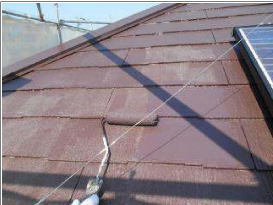
屋根塗装上塗り施工中
