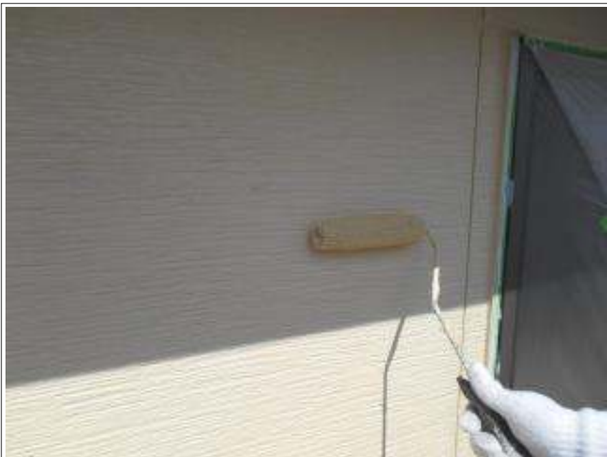
外壁塗装中塗り施工中
