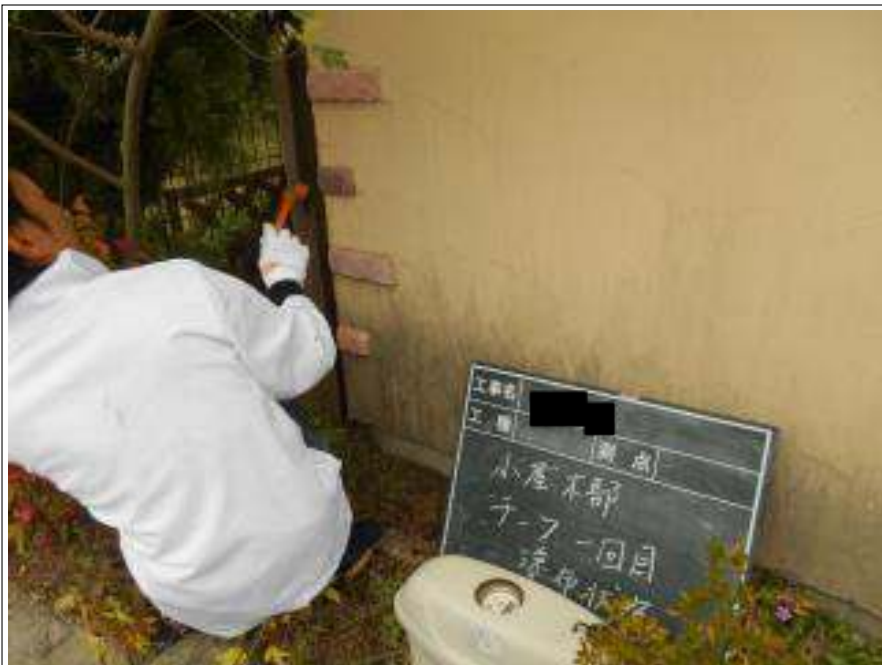
木部塗装 1 回目施工中
