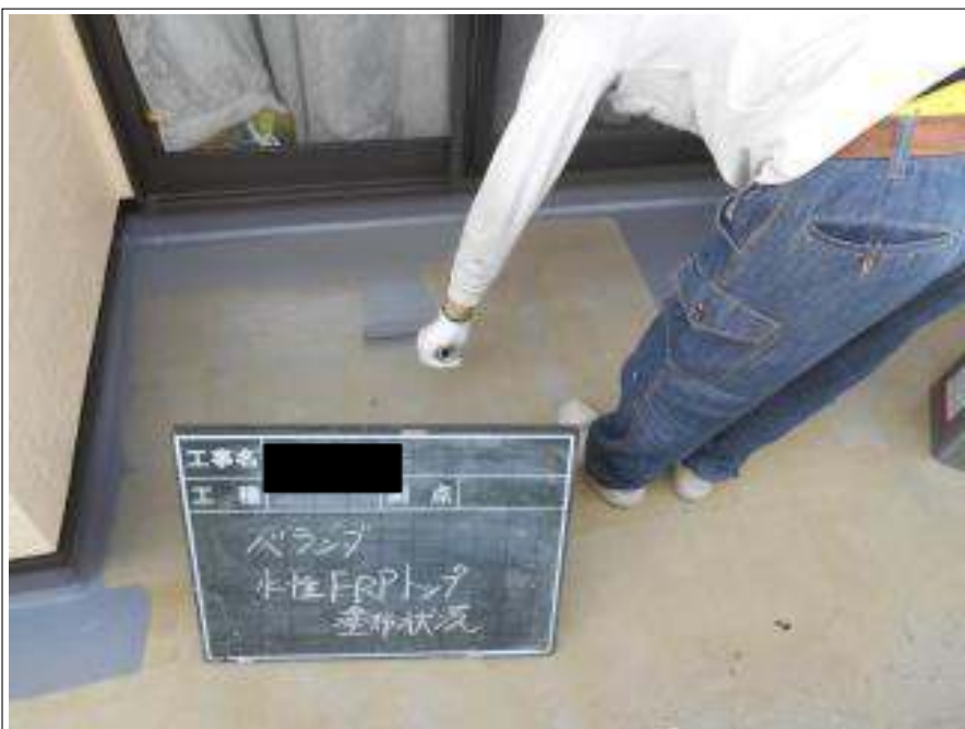
ベランダ塗装中塗り施工中
