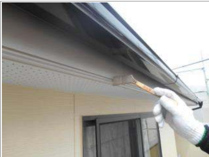
破風板塗装施工中
