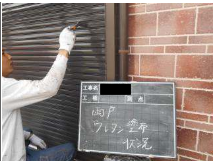
シャッター塗装施工中
