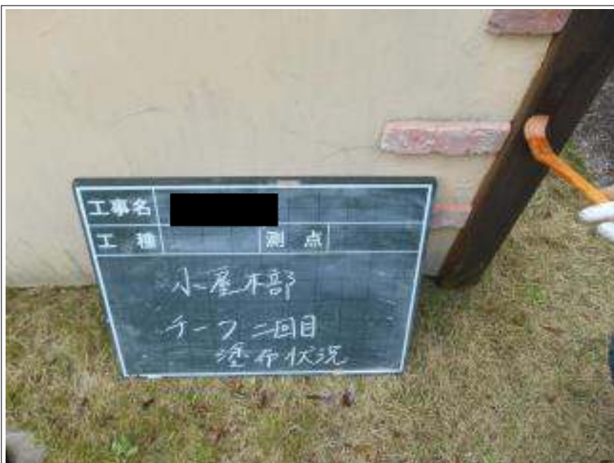
木部塗装 2 回目施工中
