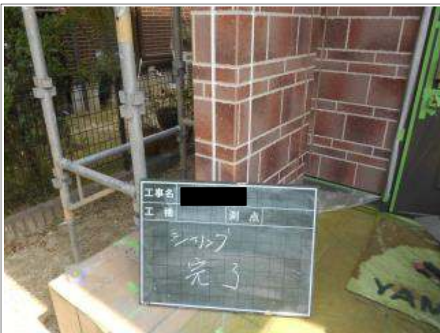
外壁シーリング補修施工完了
