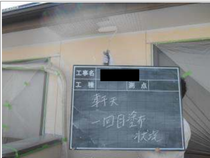
軒天塗装 1 回目施工中
