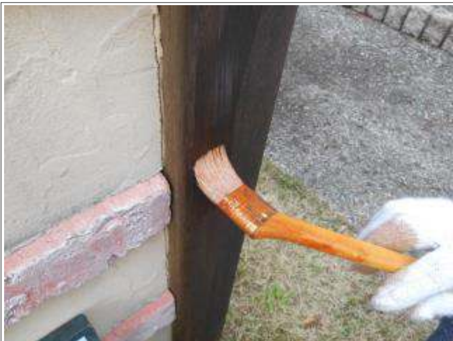
木部塗装 2回目施工中
