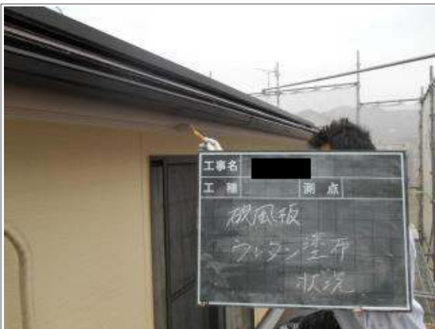
破風板塗装施工中
