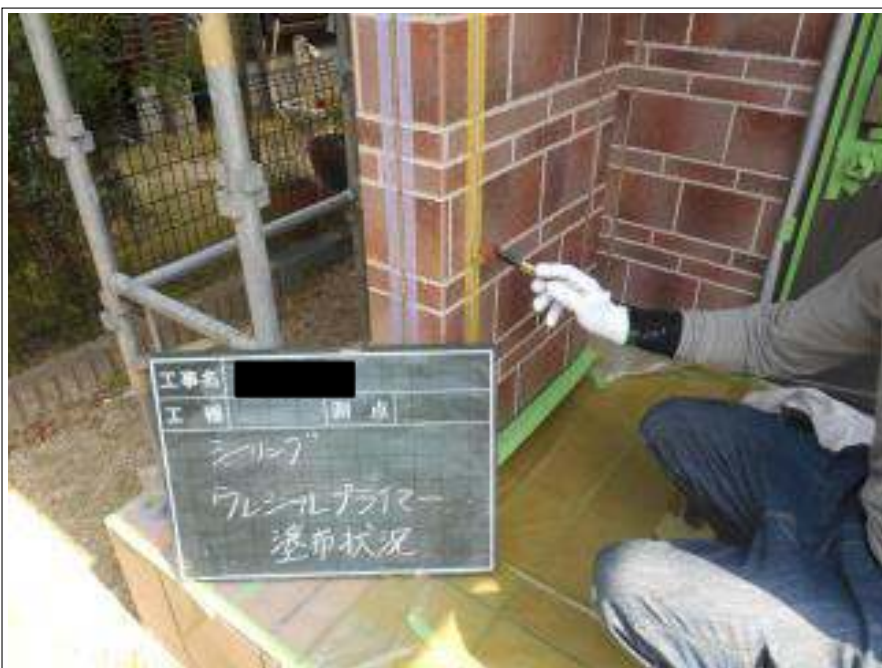
外壁プライマー塗布施工中
