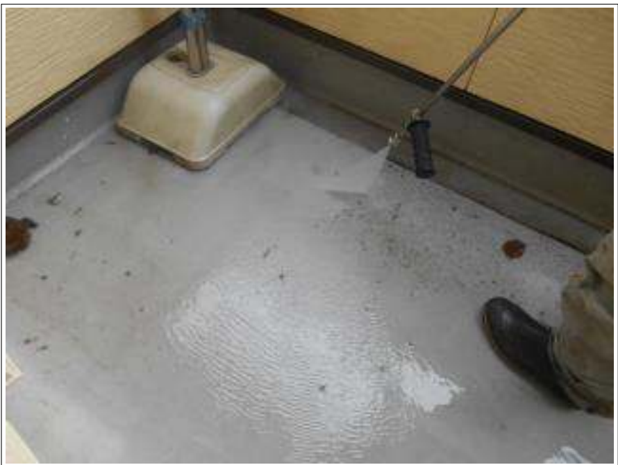
ベランダ高圧洗浄施工中
