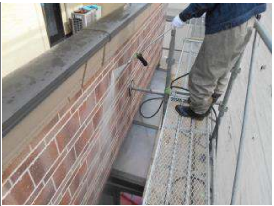
外壁高圧洗浄施工中
