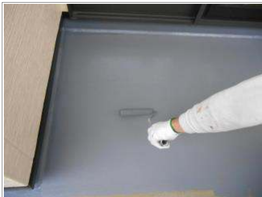
ベランダ塗装上塗り施工中
