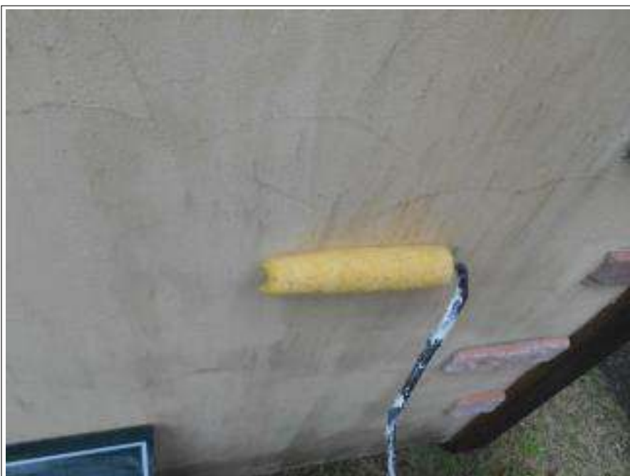
小屋外壁バリアー施工中
