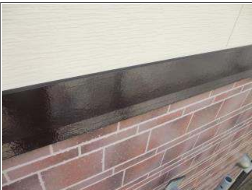
付帯塗装施工完了
