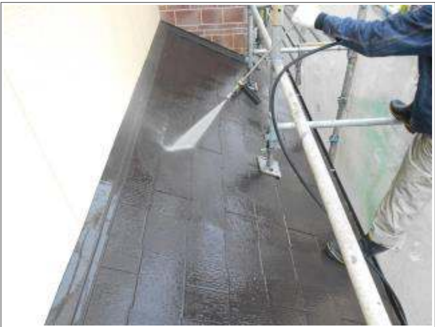
下屋根高圧洗浄施工中
