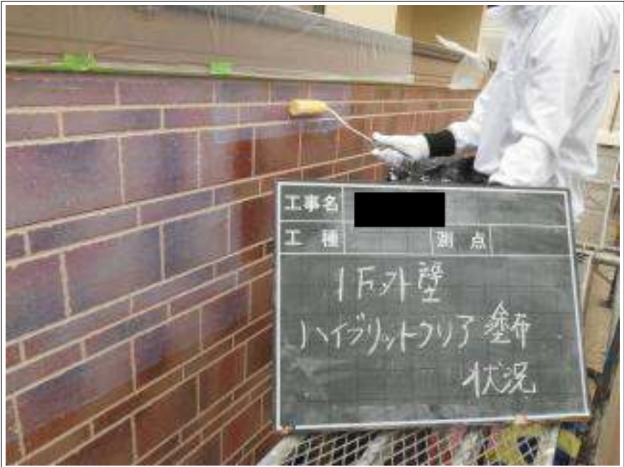
外壁塗装上塗り施工中
