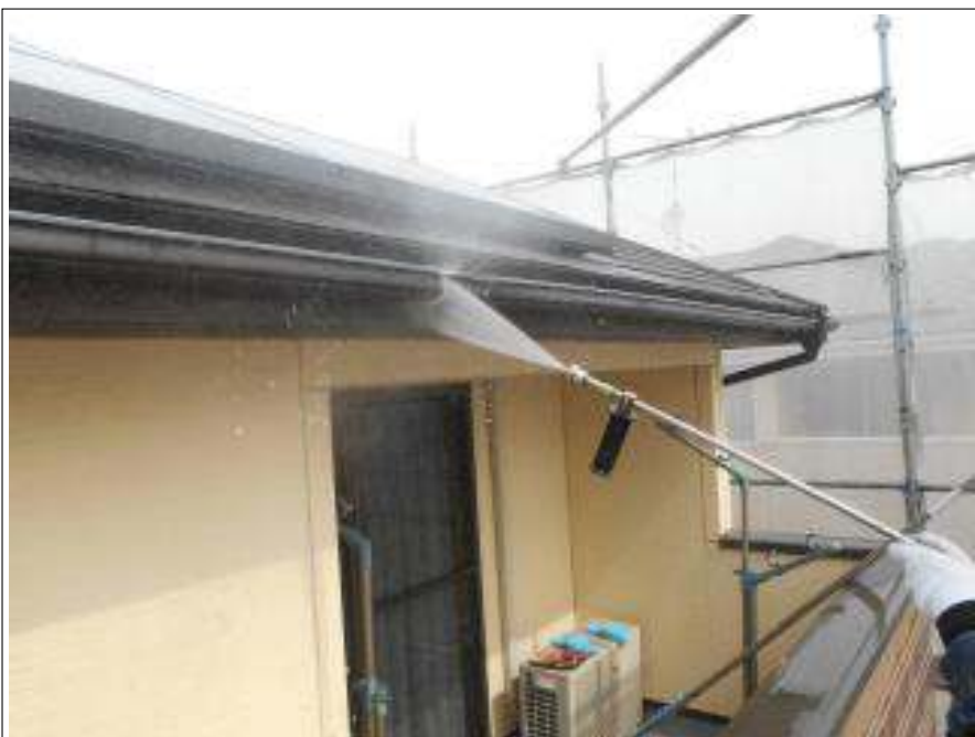
破風板高圧洗浄施工中
