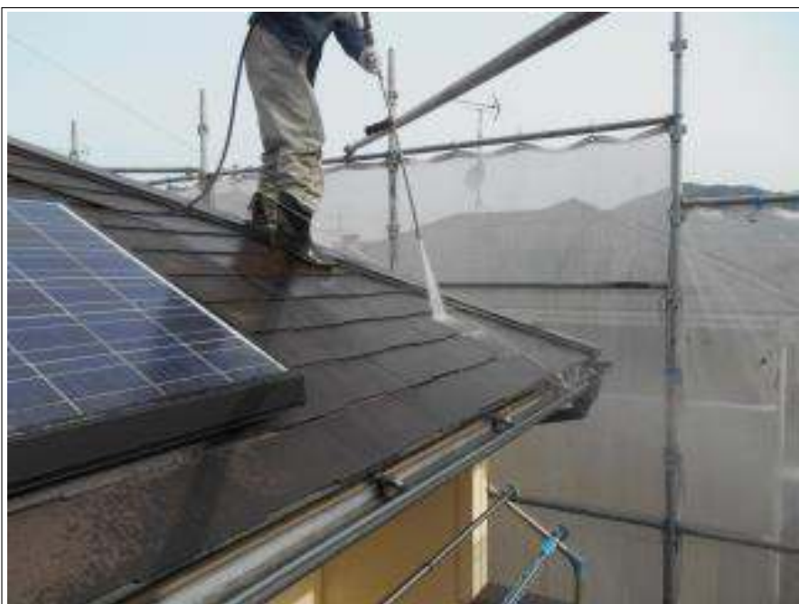
屋根高圧洗浄施工中
