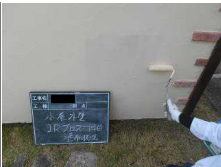
小屋外壁塗装中塗り施工中
