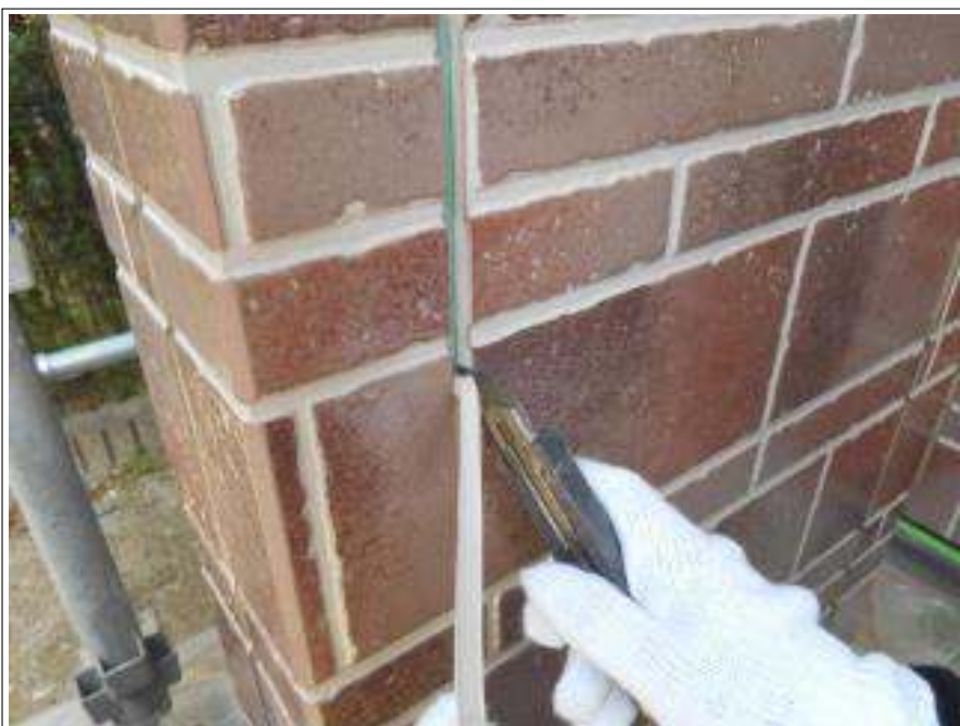
外壁シーリング撤去施工中
