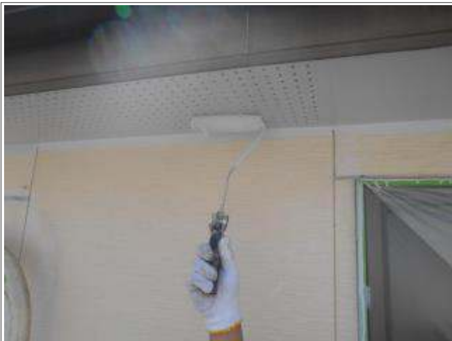
軒天塗装 2 回目施工中
