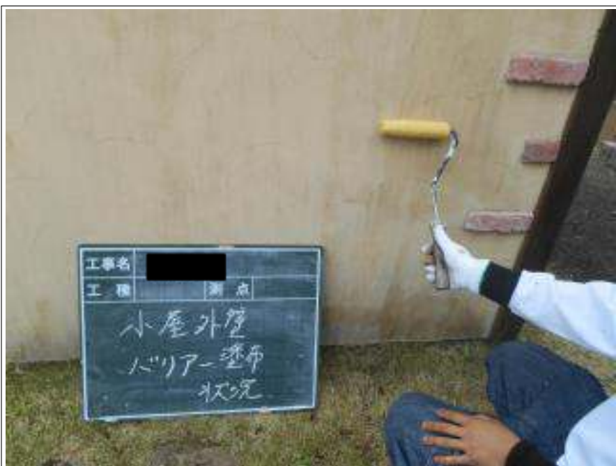
小屋外壁バリアー施工中
