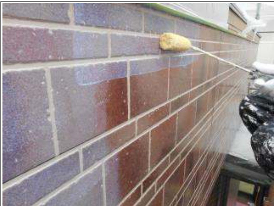
外壁塗装上塗り施工中
