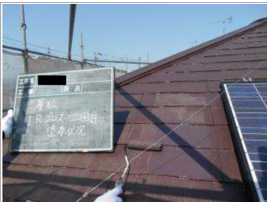
屋根塗装上塗り施工中
