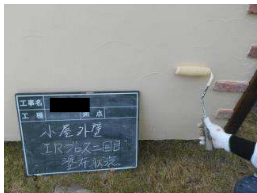
小屋外壁塗装上塗り施工中
