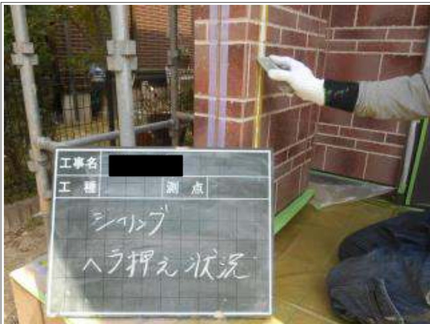
外壁シーリング補修施工中
