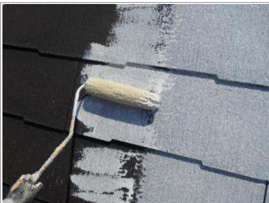
屋根塗装下塗り施工中
