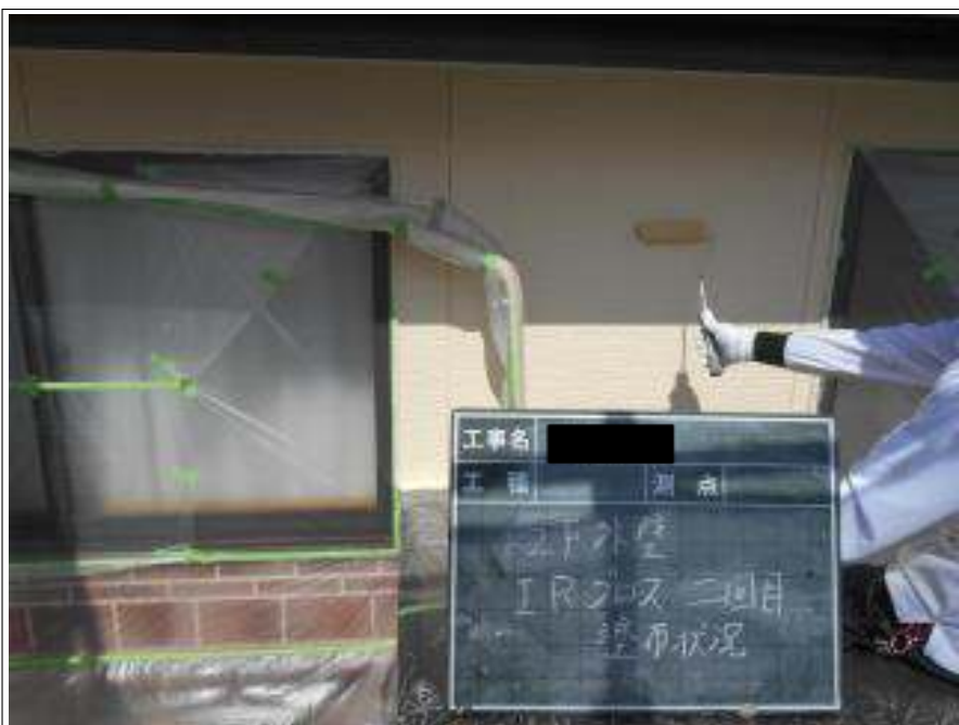
外壁塗装上塗り施工中
