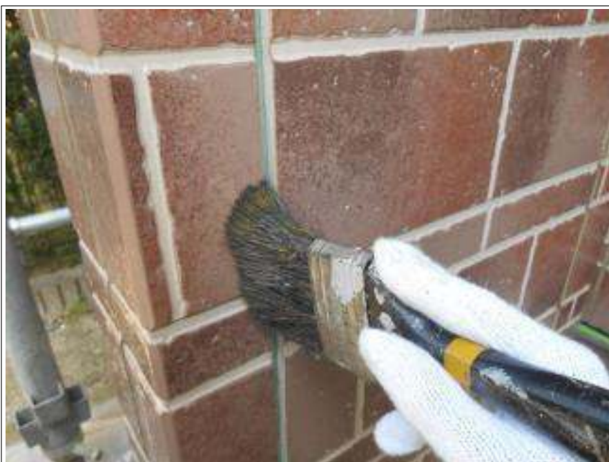
外壁シーリング掃除施工中
