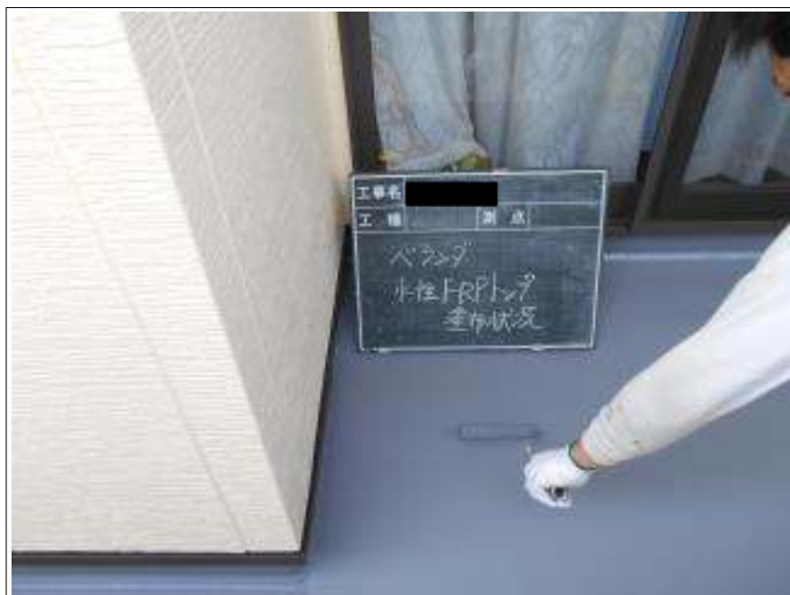
ベランダ塗装上塗り施工中
