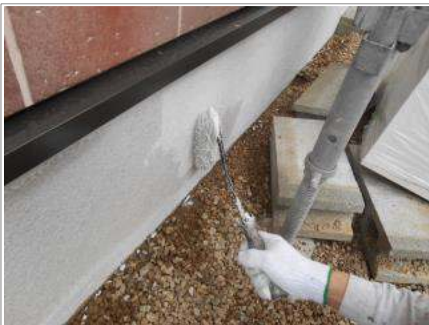
基礎塗装 1 回目施工中
