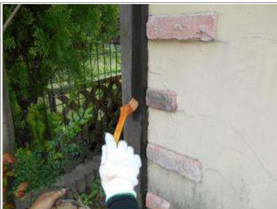
木部塗装 1 回目施工中
