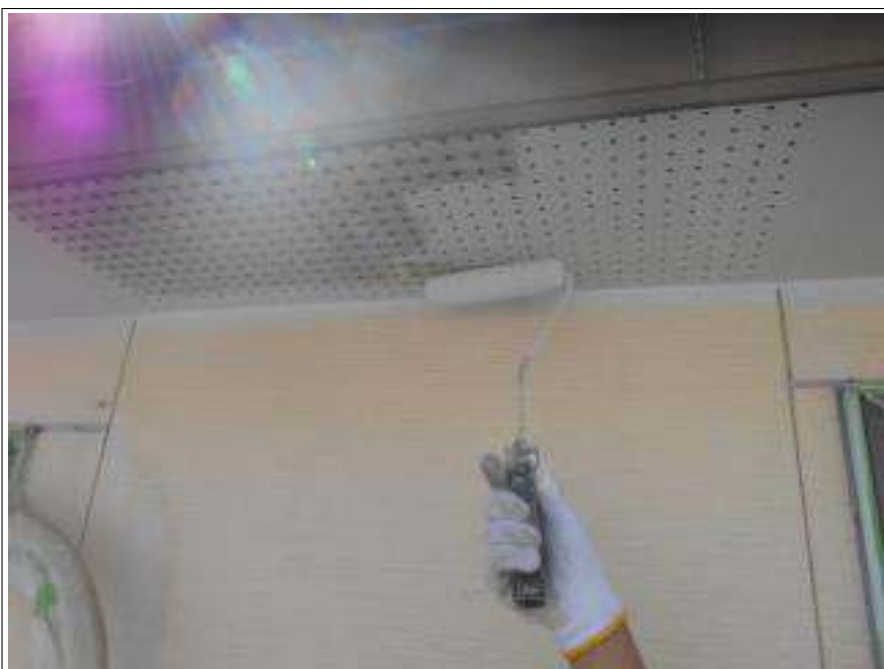
軒天塗装 1 回目施工中
