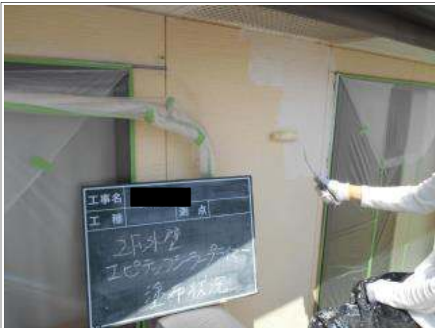
外壁塗装下塗り施工中
