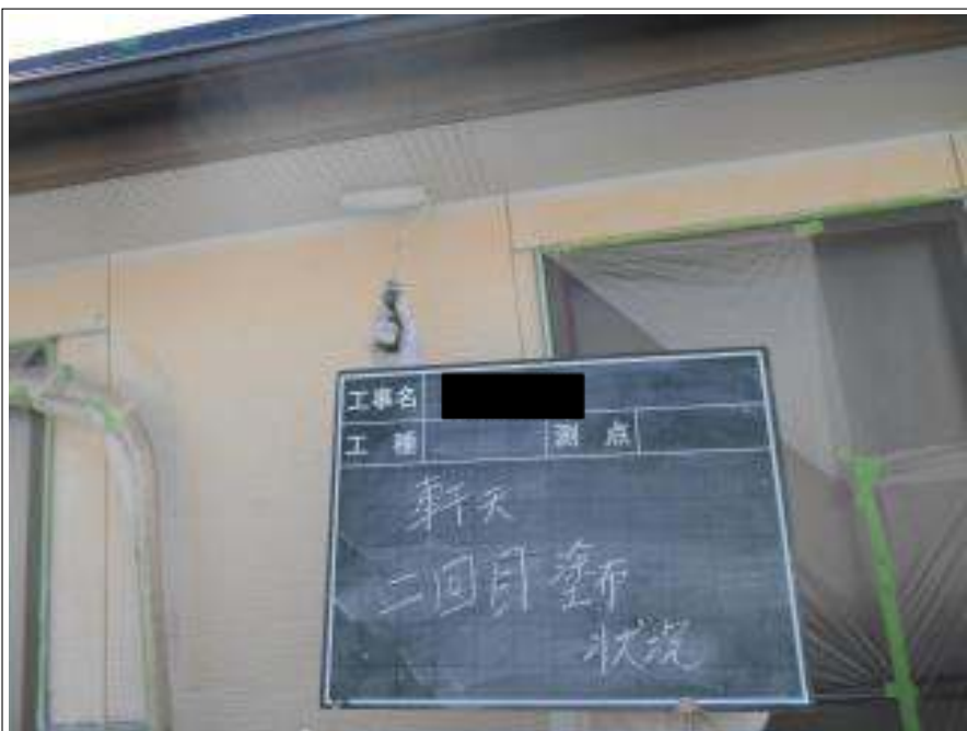
軒天塗装 2 回目施工中
