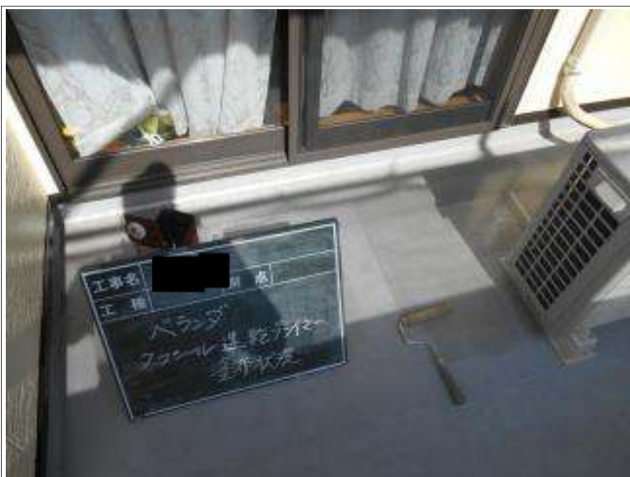
ベランダ塗装下塗り施工中
