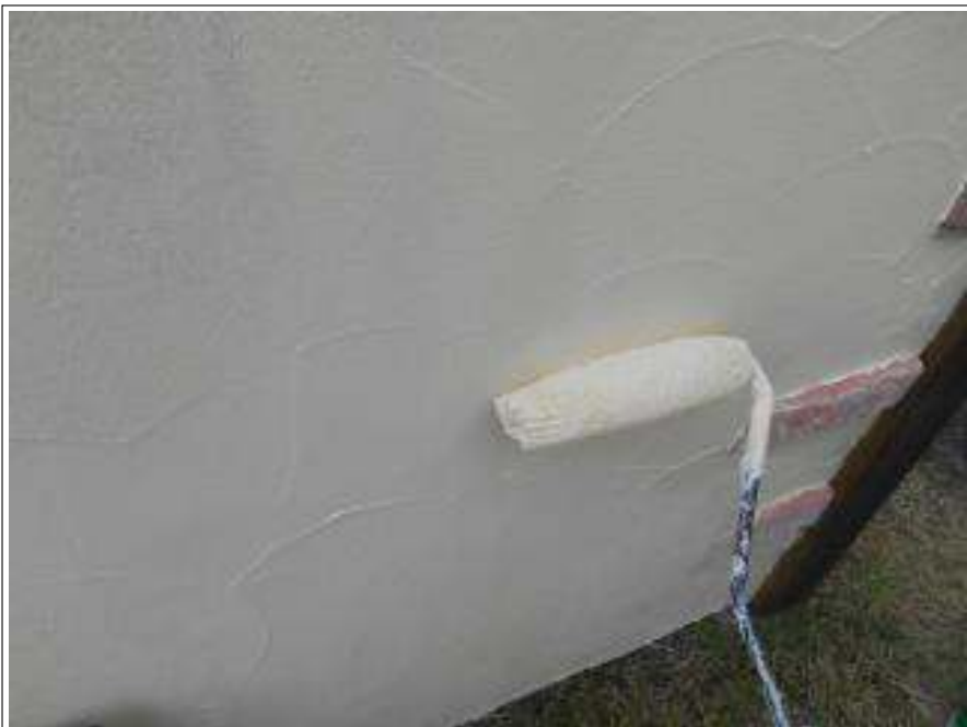
小屋外壁塗装中塗り施工中
