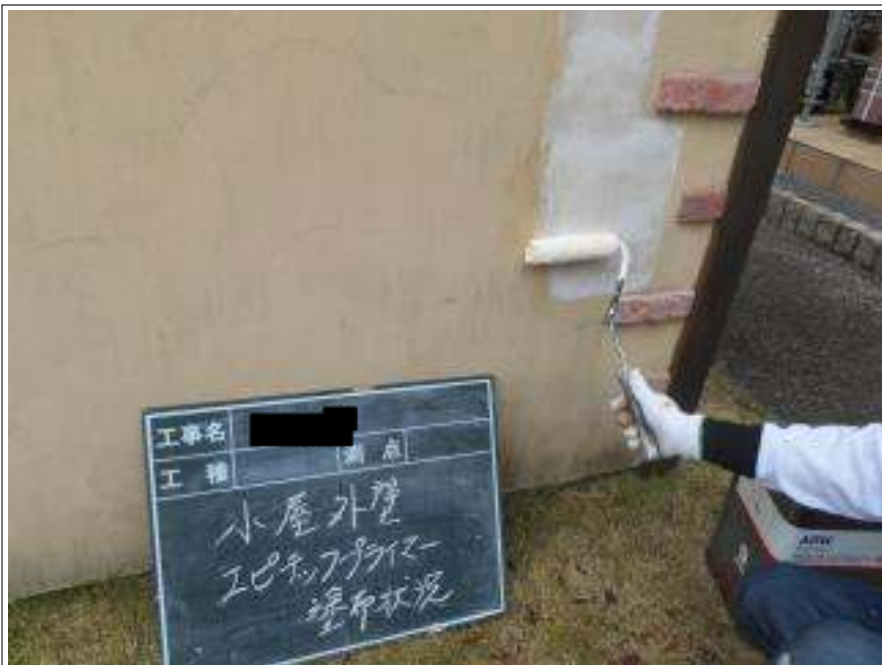
小屋外壁塗装下塗り施工中
