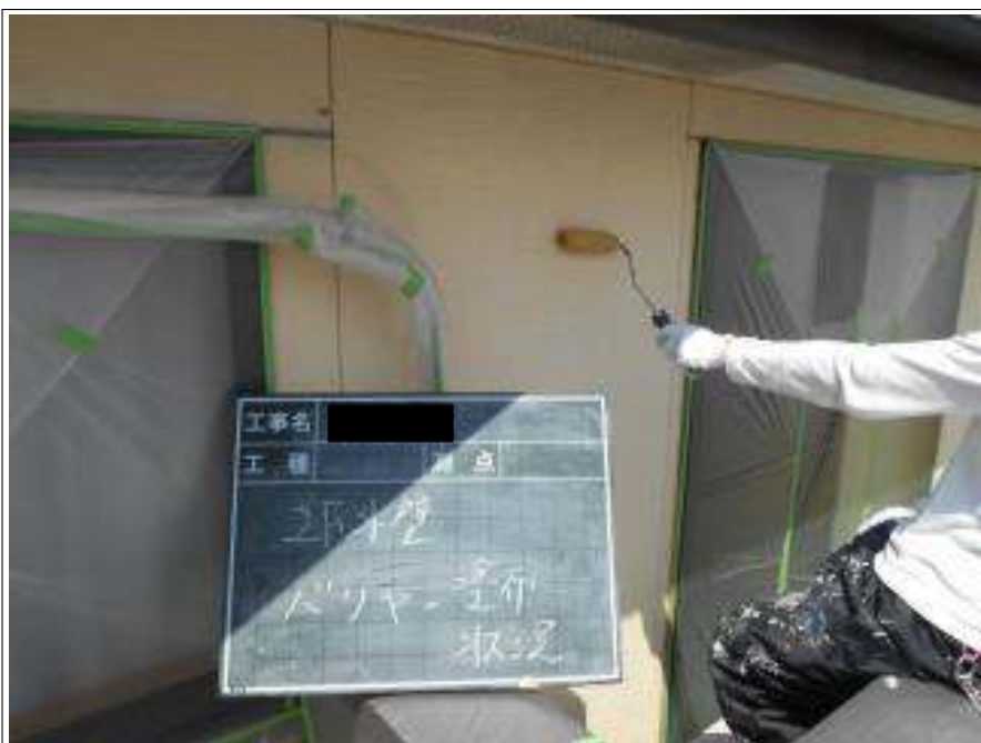
外壁バリアー施工中
