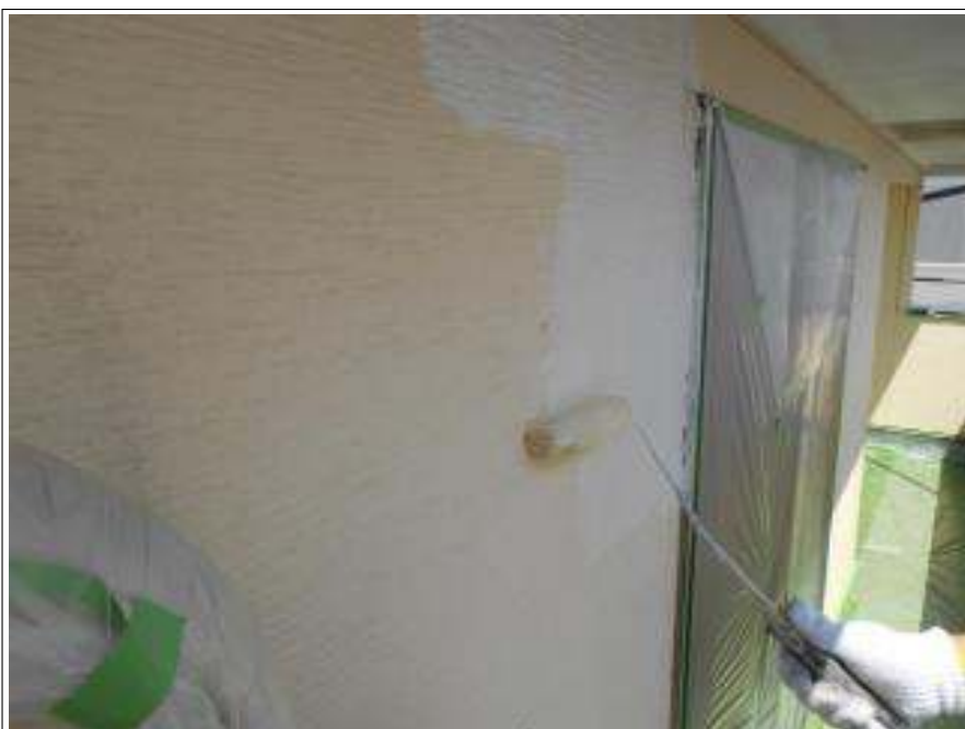
外壁塗装下塗り施工中
