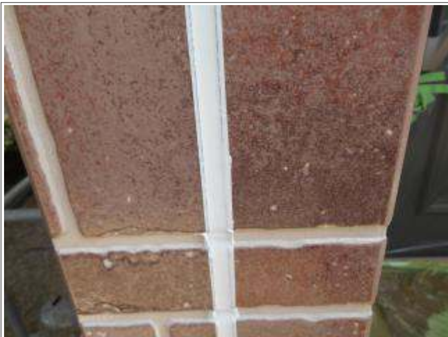
外壁シーリング補修施工完了
