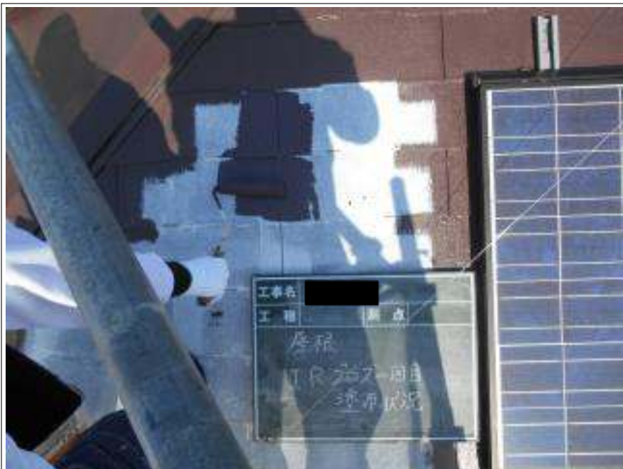
屋根塗装中塗り施工中
