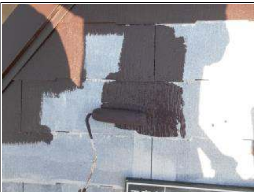
屋根塗装中塗り施工中
