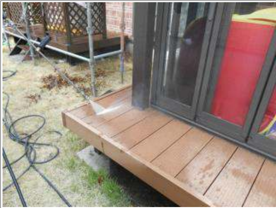
サンルーム高圧洗浄施工中
