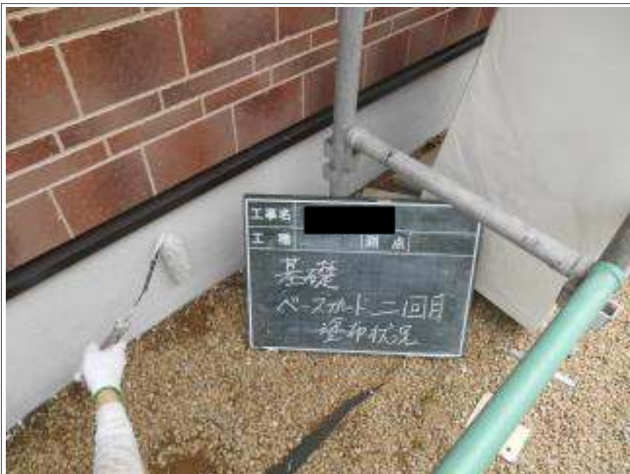
基礎塗装 2回目施工中
