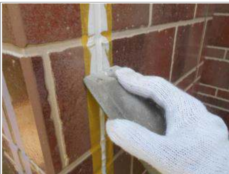
外壁シーリング補修施工中
