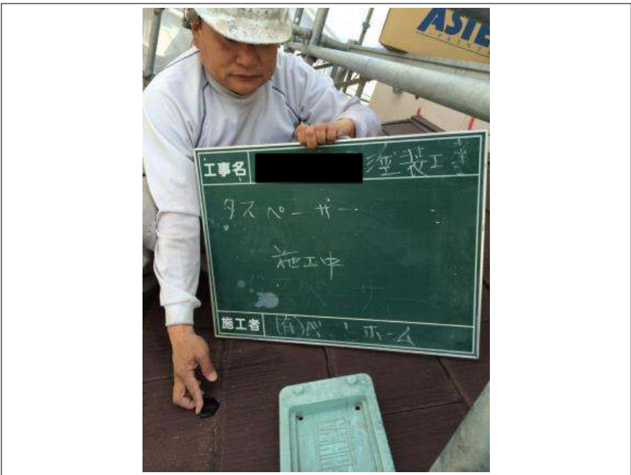
屋根タスペーサー施工中
