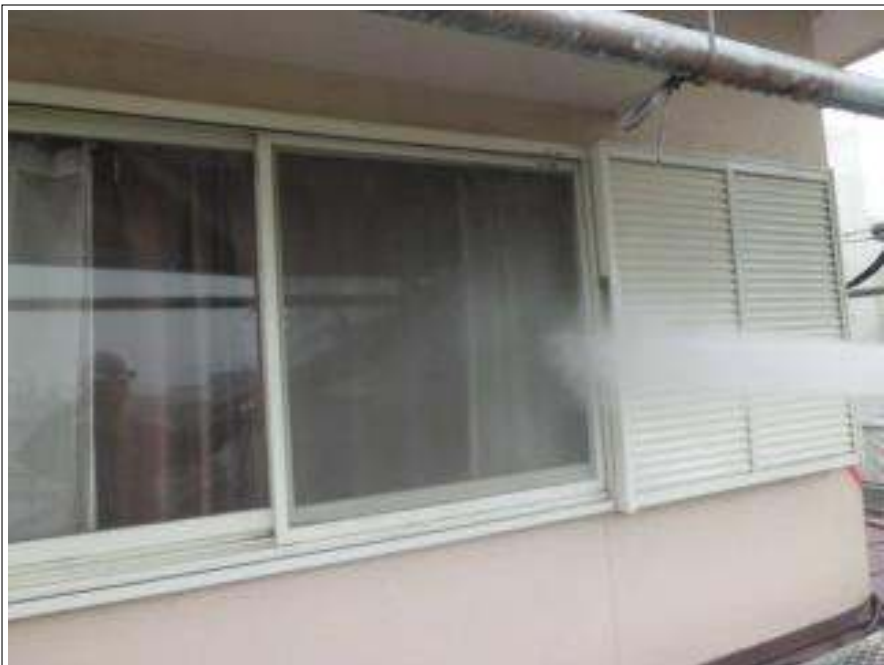
窓高圧洗淨施工中
