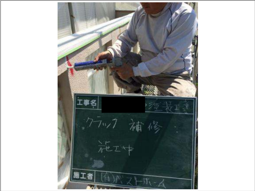
外壁クラック補修施工中
