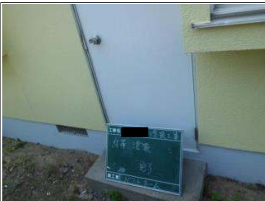
勝手口塗装施工完了
