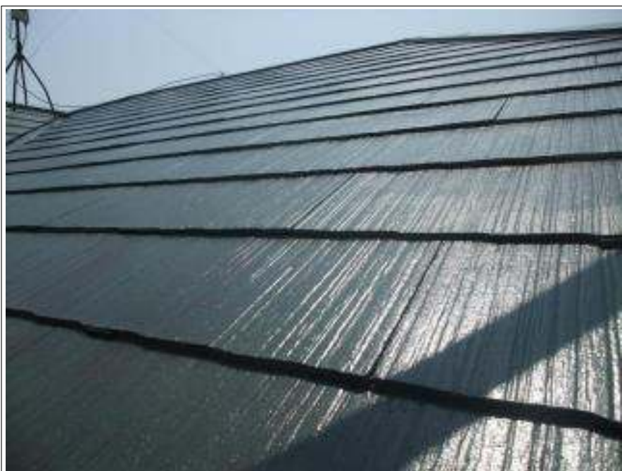
屋根中塗り施工完了
