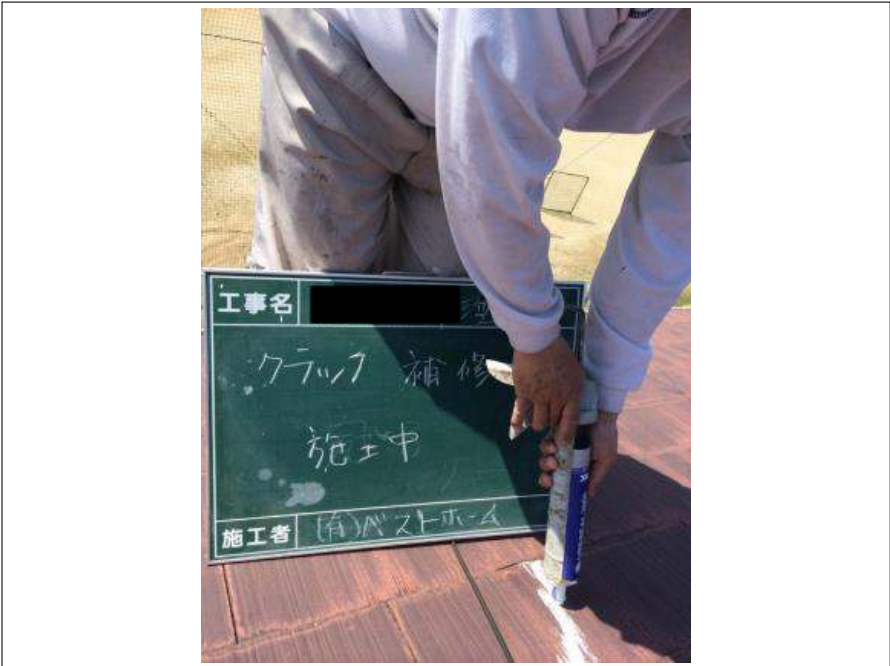
屋根クラック補修施工中
