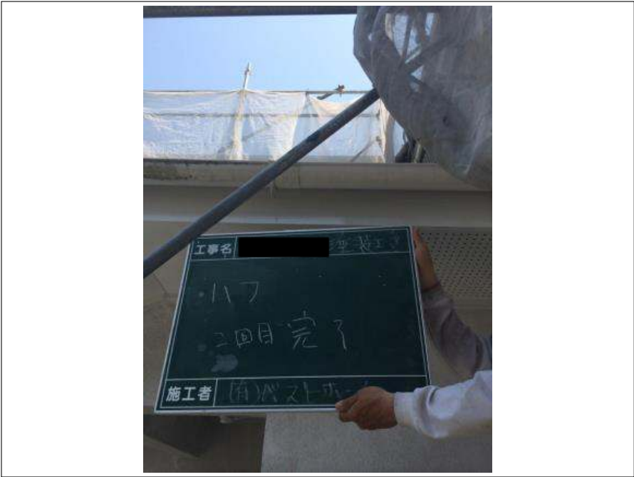
破風板塗装 2 回目施工完了
