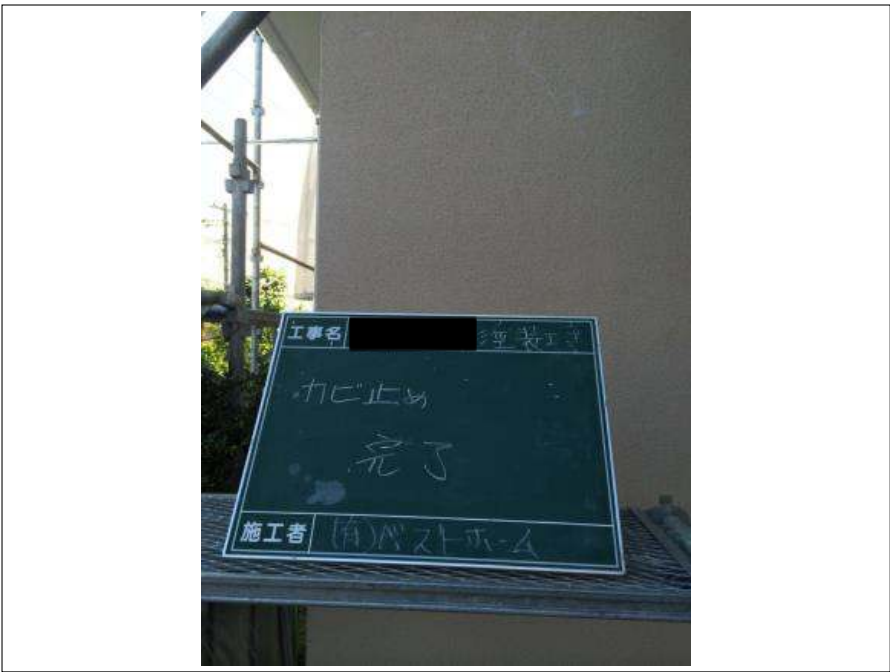
外壁バリアー施工完了
