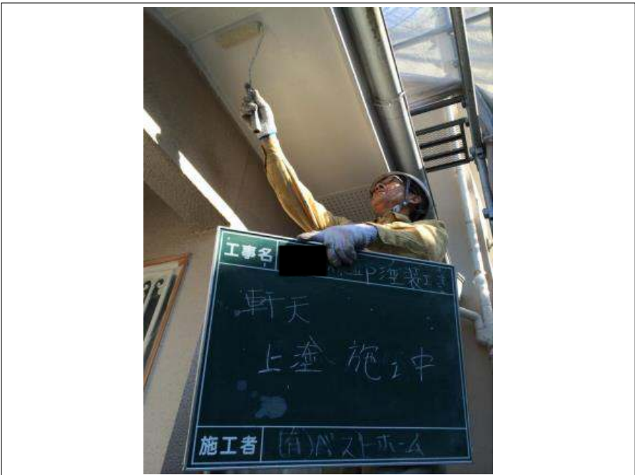
軒天塗装上塗り施工中
