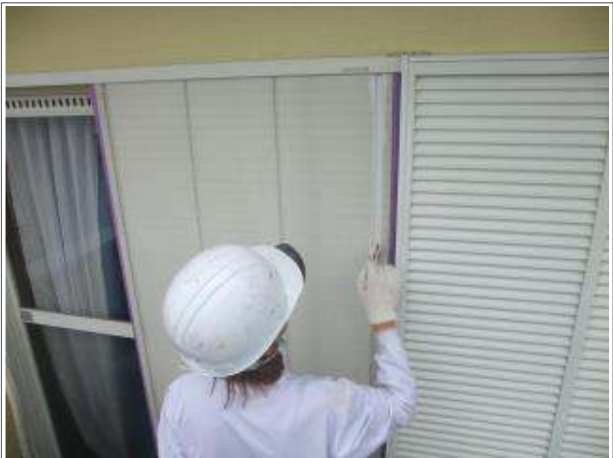
雨戸塗装施工中
