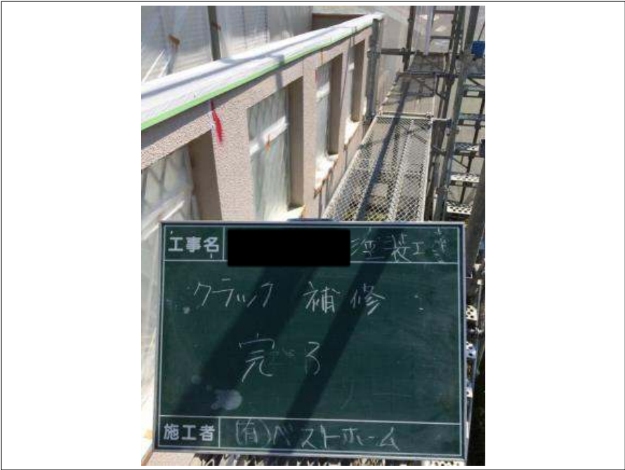
外壁クラック補修施工完了
