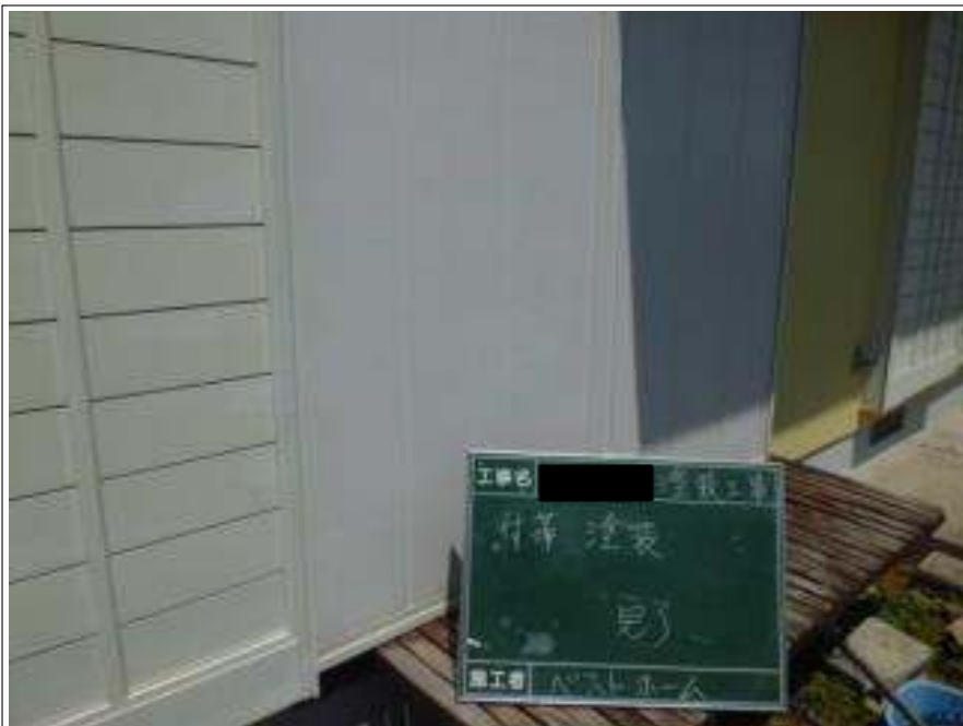
雨戸塗装施工完了
