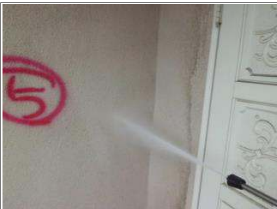
外壁高压洗净施工中
