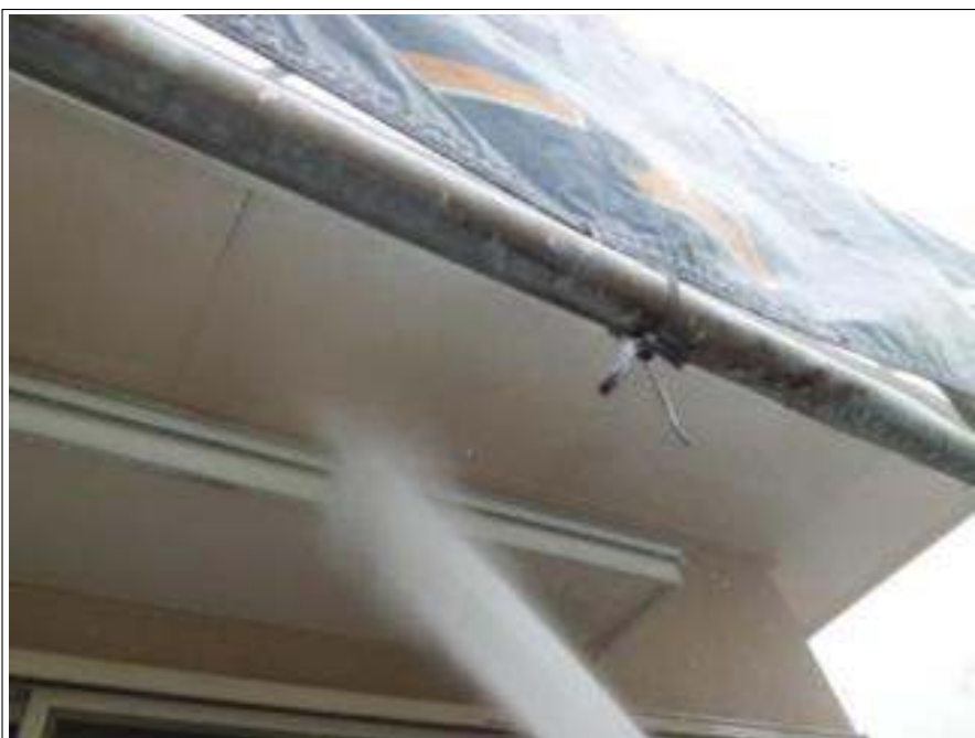
軒天高压洗净施工中
