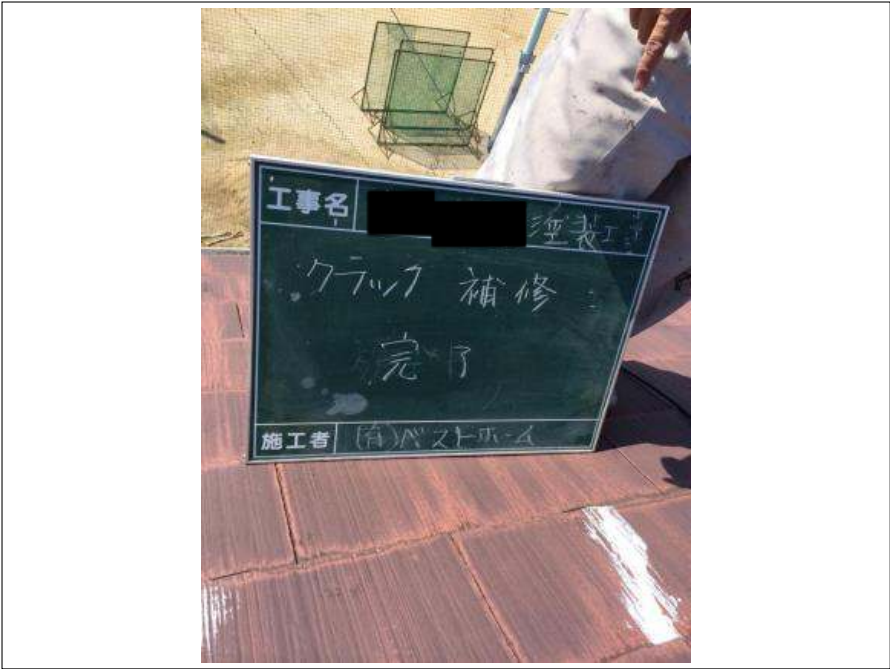
屋根クラック補修施工完了
