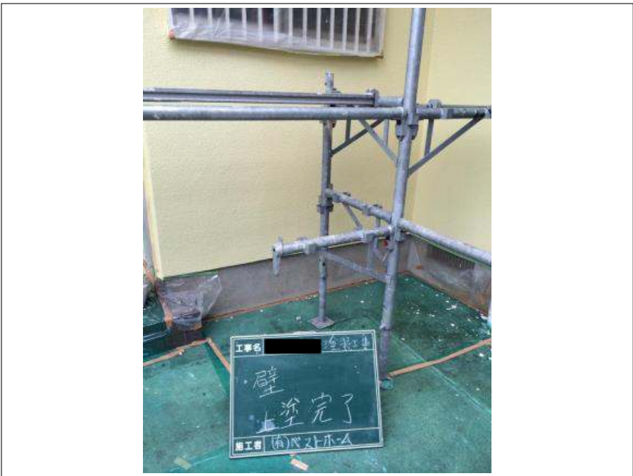
外壁塗装上塗り施工完了
