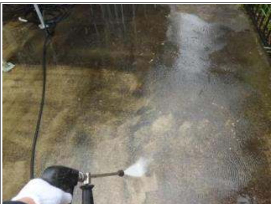
土間高圧洗淨施工中
