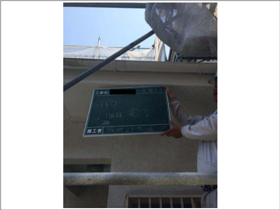
破風板塗装 1 回目施工完了
