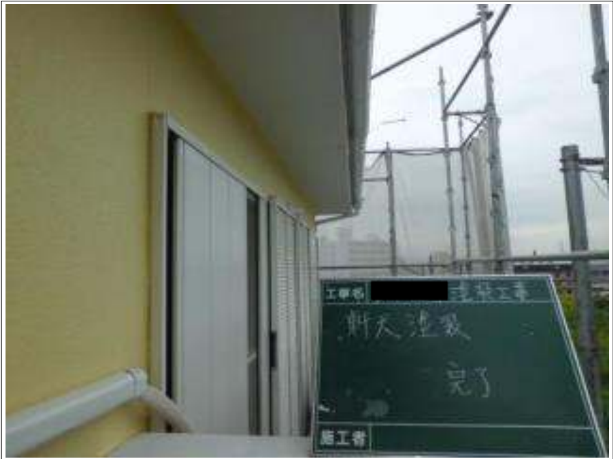
軒天塗装施工完了
