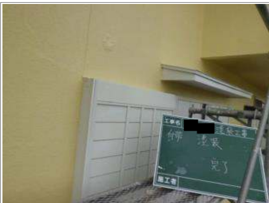
付帯塗装施工完了
