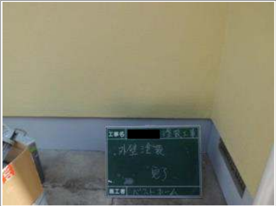
外壁塗装施工完了
