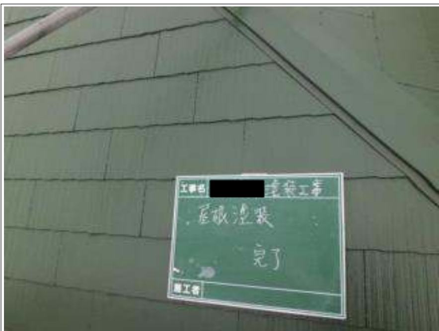
屋根塗装施工完了
