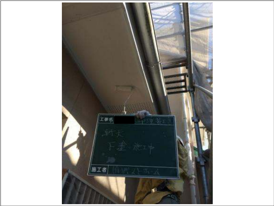
軒天塗装下塗り施工中
