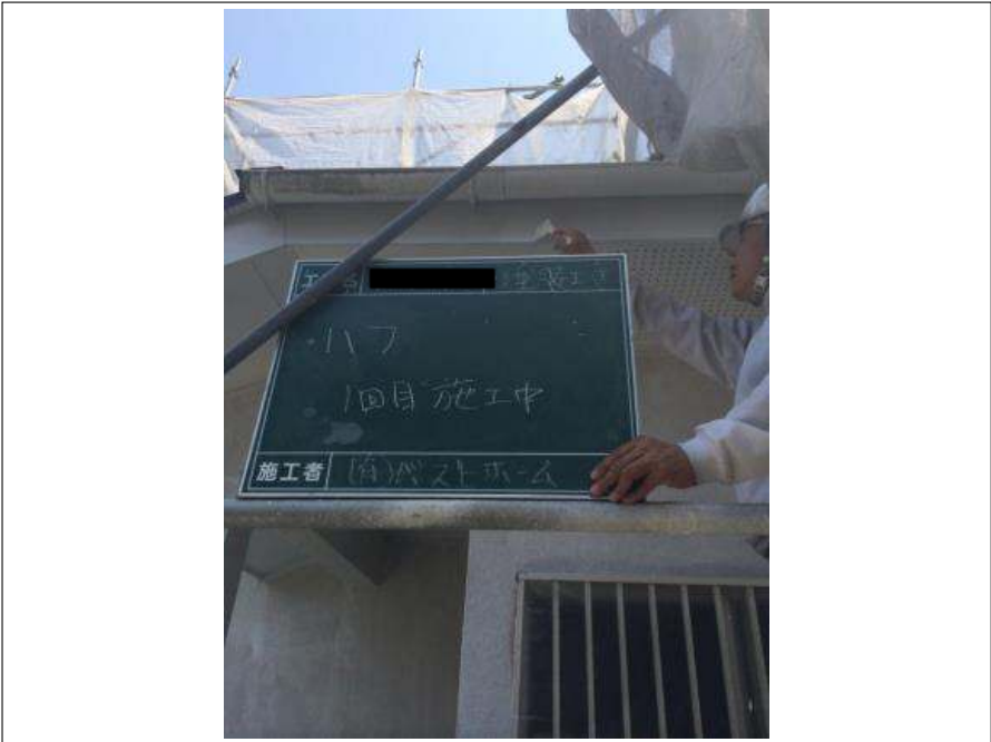
破風板塗装 1 回目施工中
