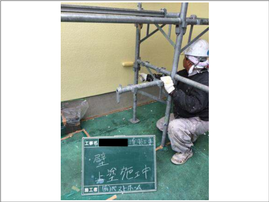
外壁塗装上塗り施工中
