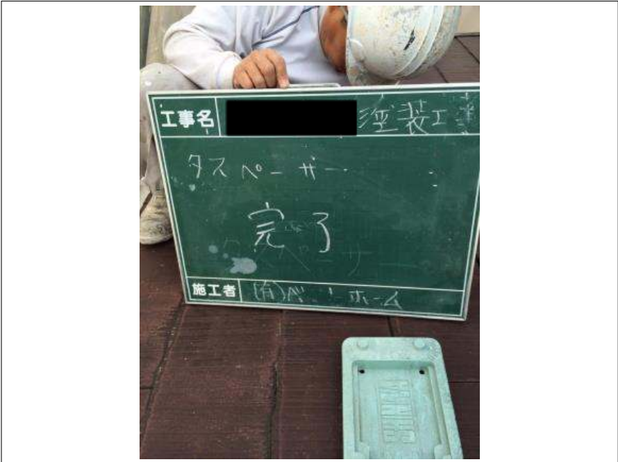
屋根タスペーサー施工完了
