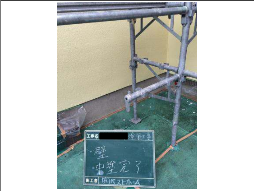
外壁塗装中塗り施工完了
