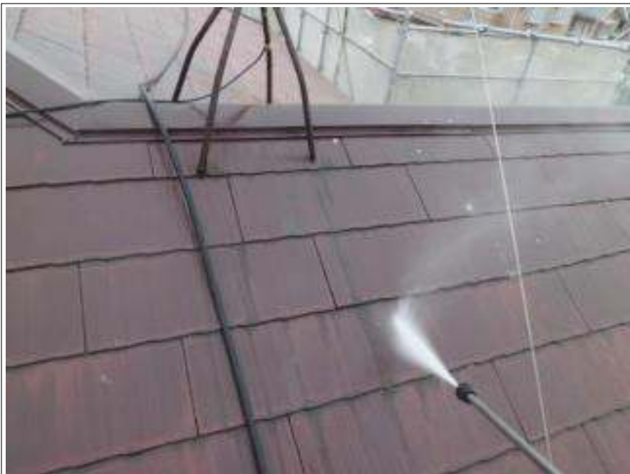
屋根高压洗净施工中
