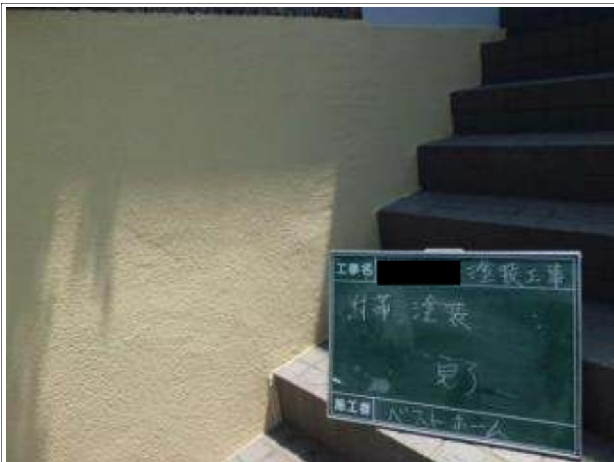
塀塗装施工完了
