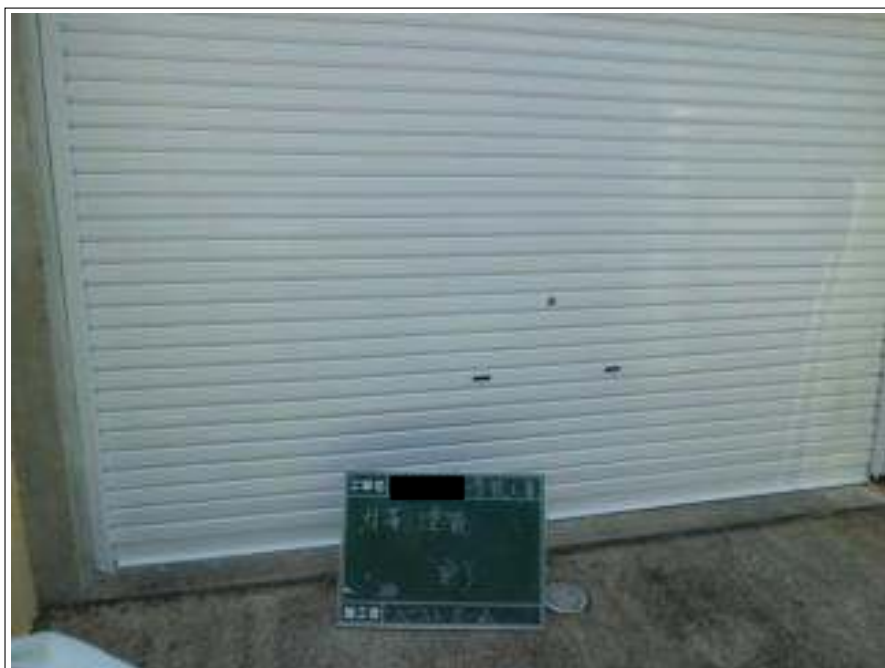
車庫シャッター塗装施工完了
