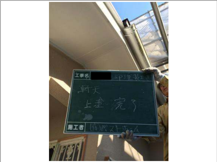
軒天塗装上塗り施工完了
