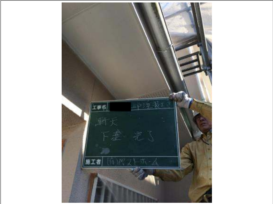
軒天塗装下塗り施工完了
