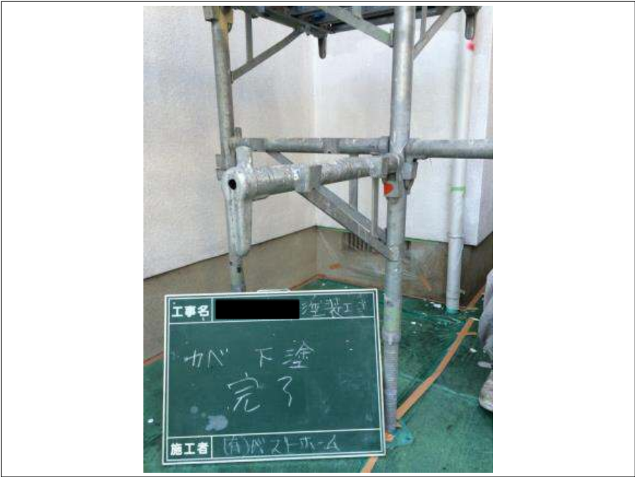
外壁塗装下塗り施工完了
