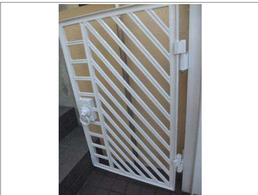
門扉塗装施工完了
