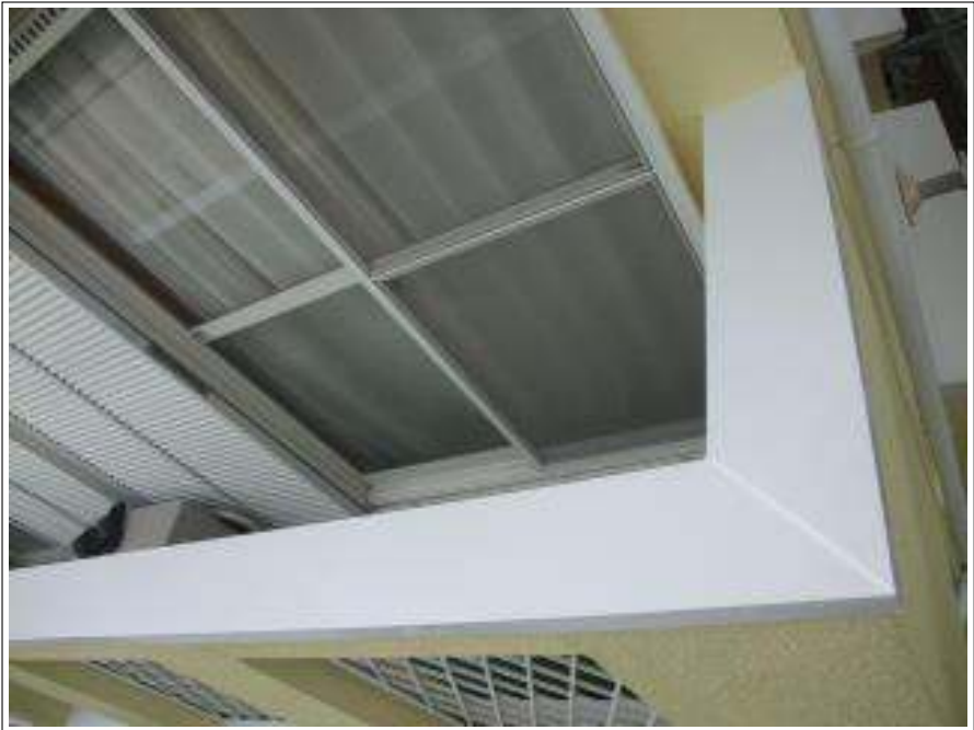
ベランダ手摺塗装施工完了
