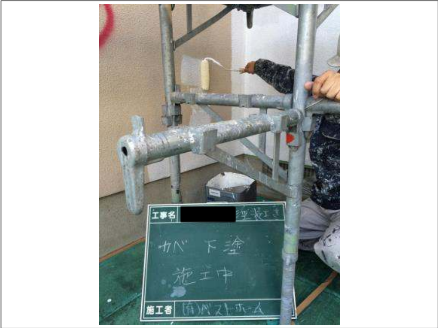
外壁塗装下塗り施工中
