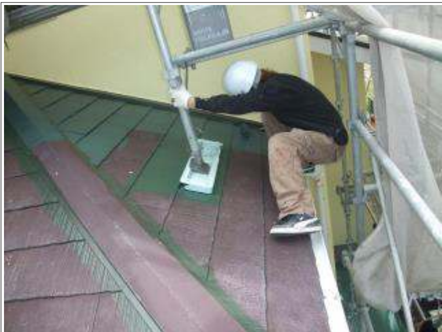
屋根中塗り施工中
