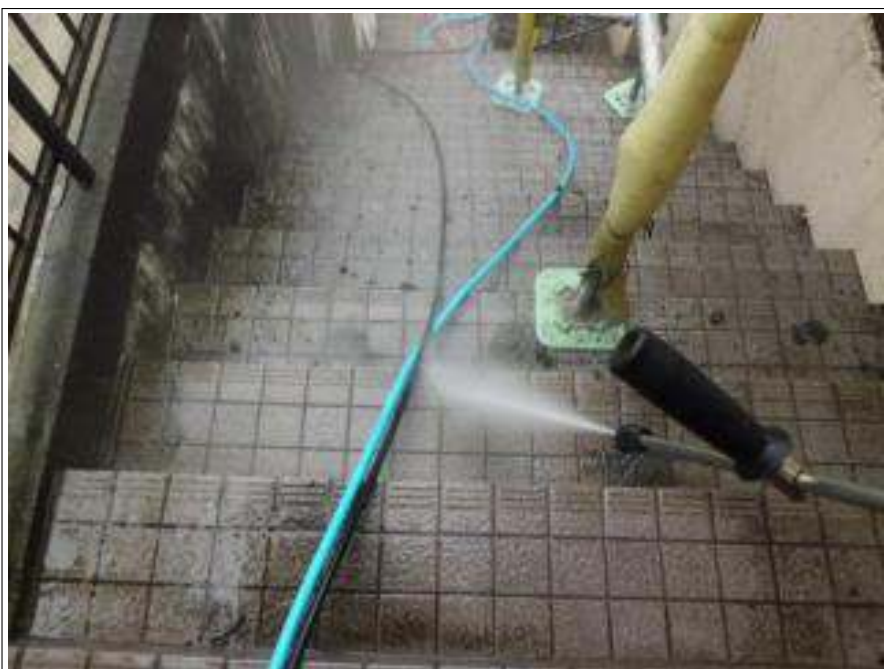
階段高圧洗淨施工中
