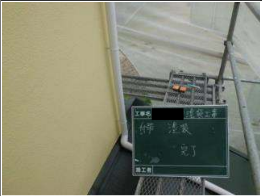
樋塗装施工完了
