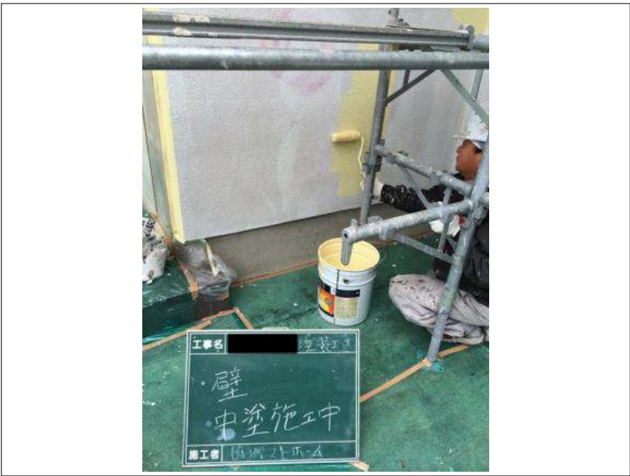
外壁塗装中塗り施工中
