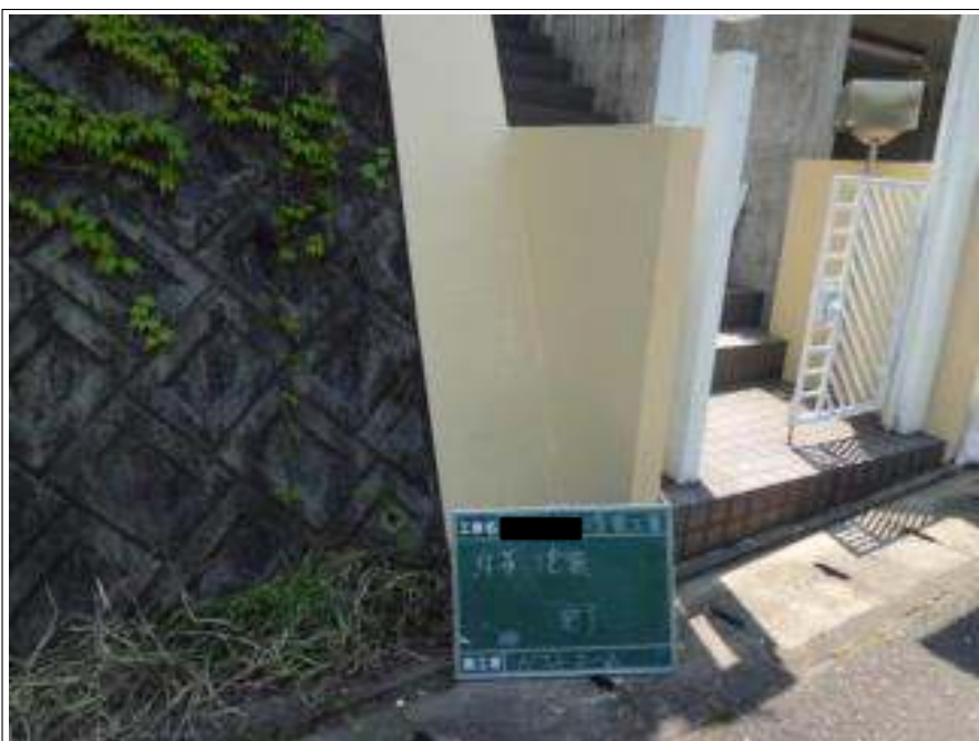
塀塗装施工完了
