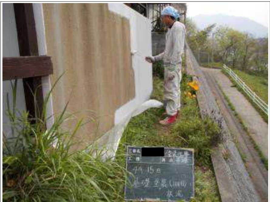
基礎塗装施工中
