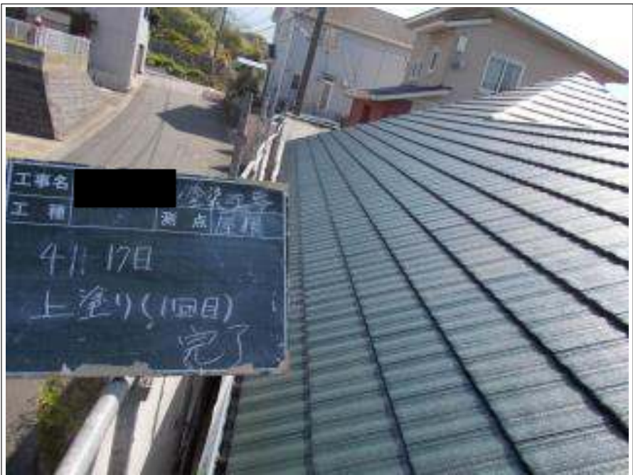
屋根上塗り塗装施工完了
