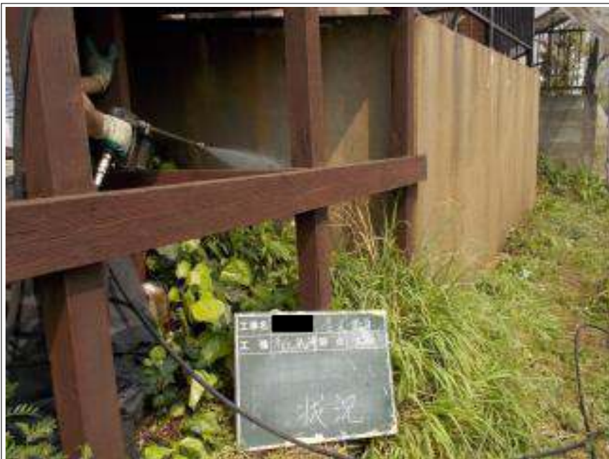
基礎高圧洗浄施工中
