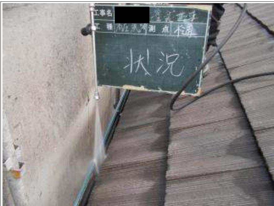
樋高圧洗浄施工中
