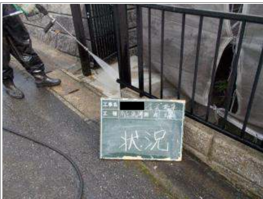
塀高圧洗浄施工中
