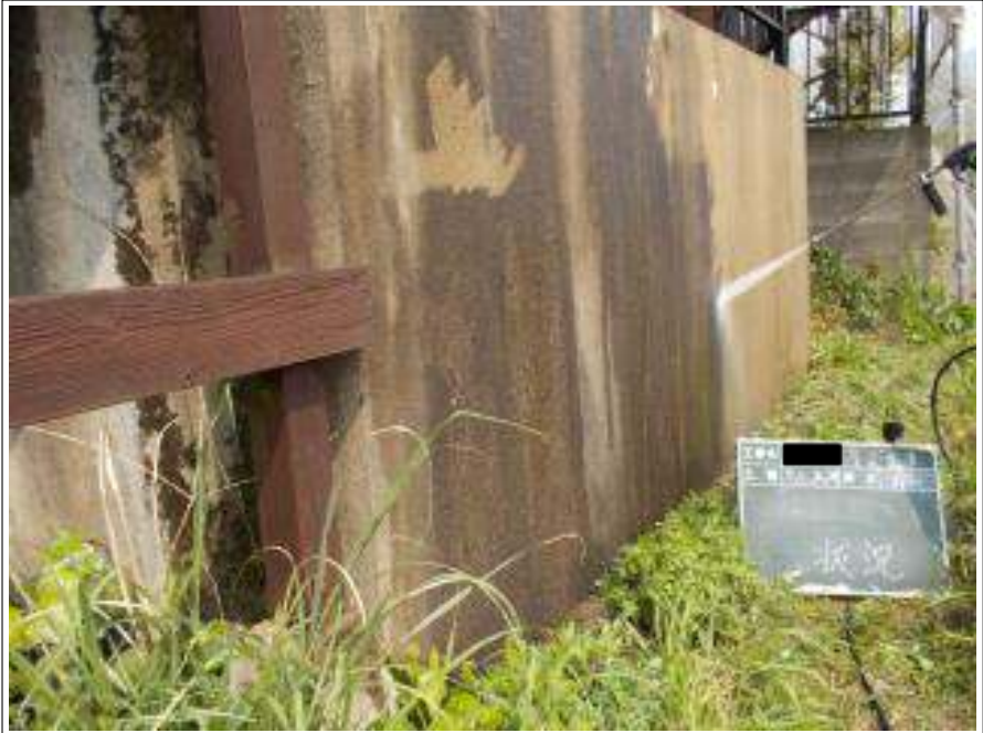
基礎高圧洗淨施工中
