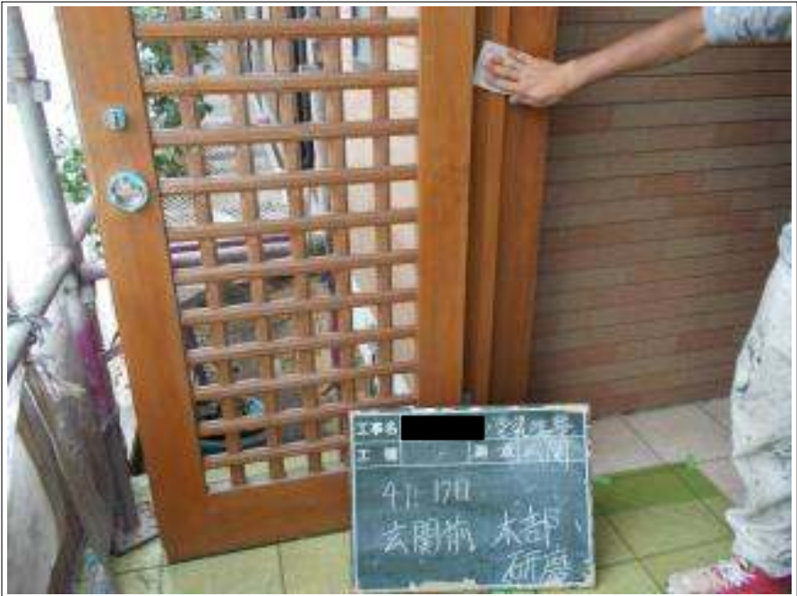
玄関前木部研磨施工中
