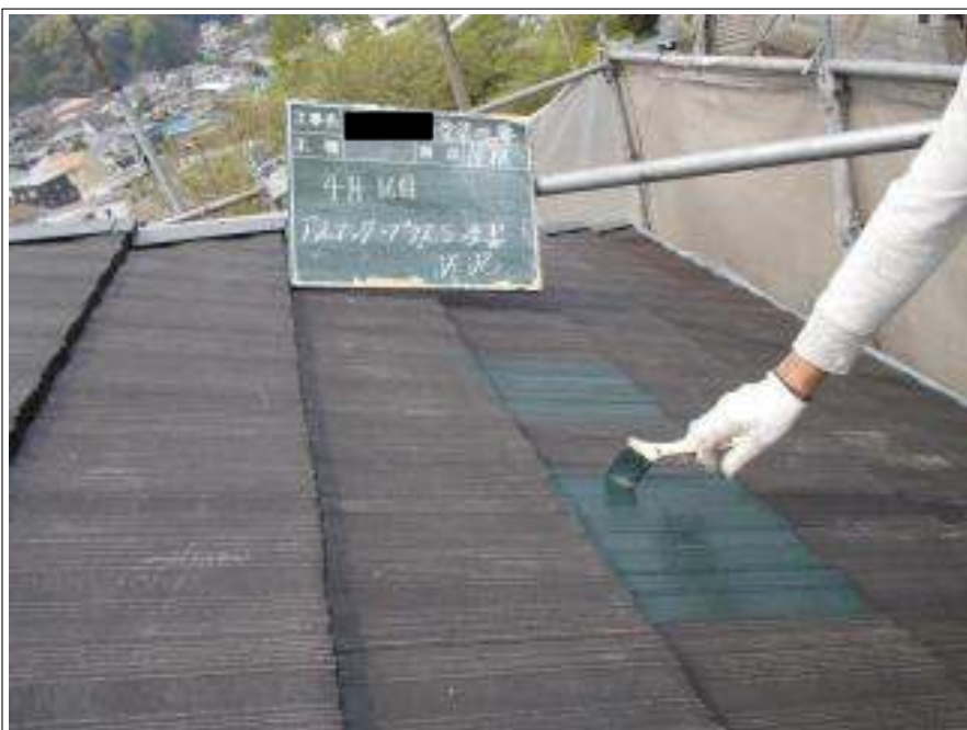
屋根上塗り塗装施工中
