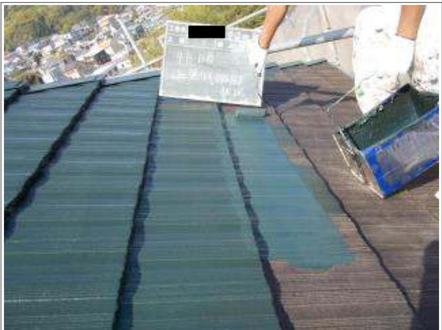
屋根上塗り塗装施工中
