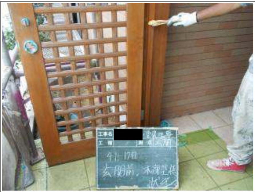
玄関前木部塗装施工中
