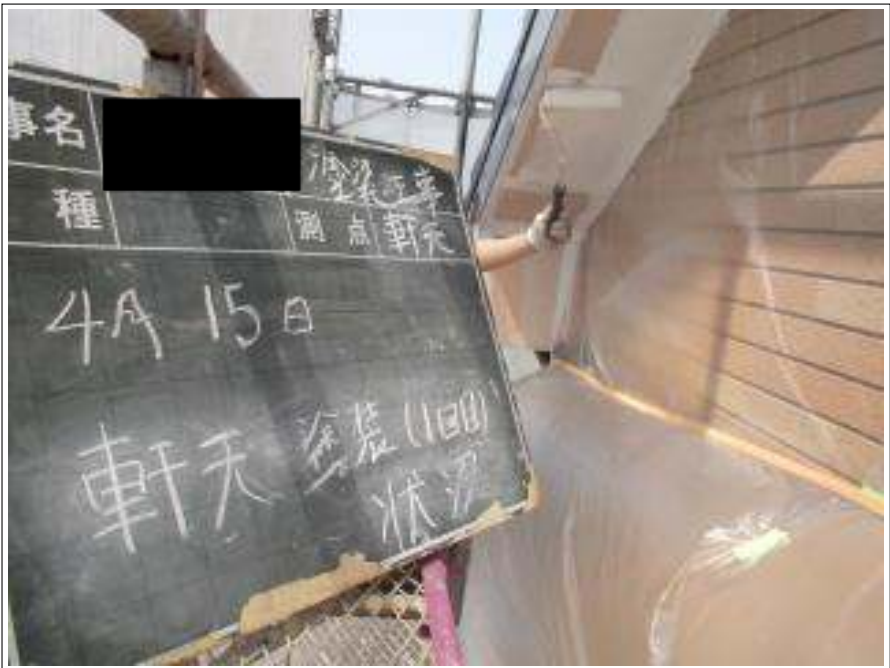
軒天塗装1回目施工中
