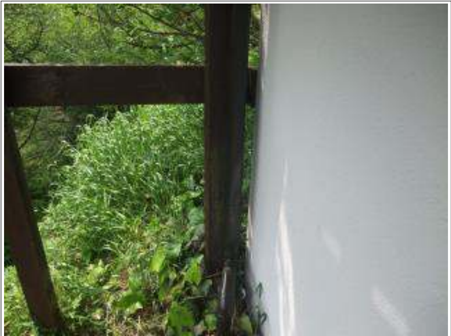
樋 破損部交換完了
