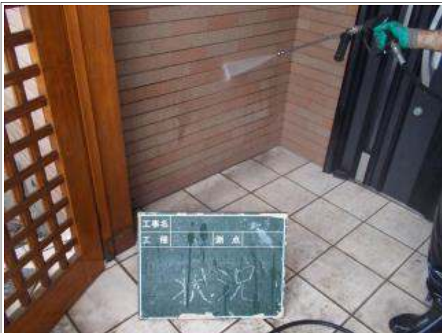
高圧洗浄施工中
