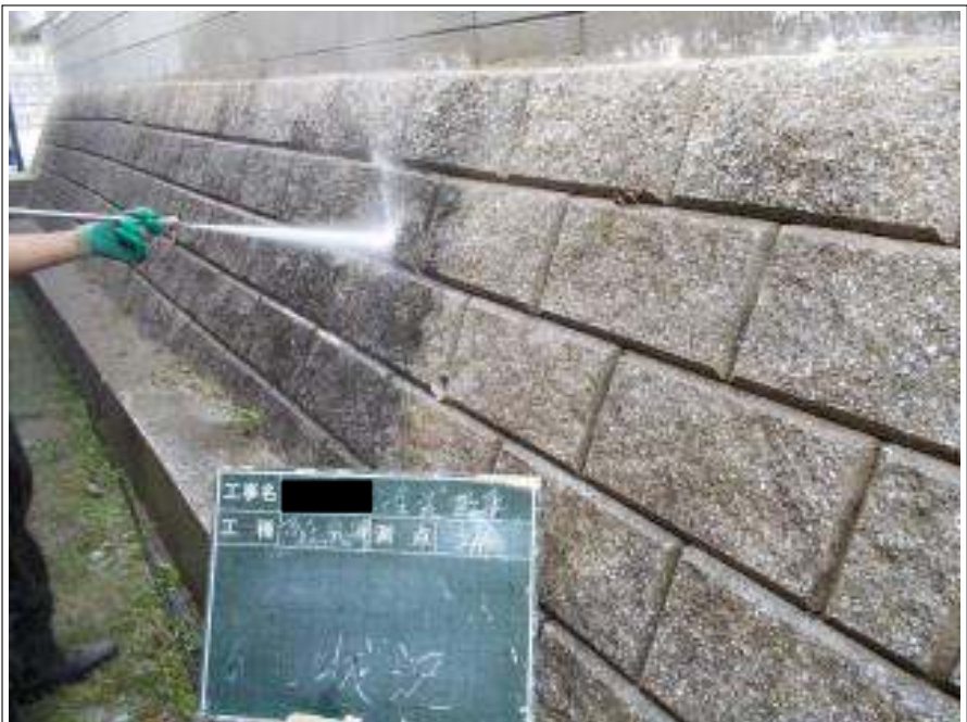
塀高圧洗淨施工中
