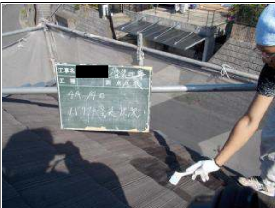
屋根バリアー施工中
