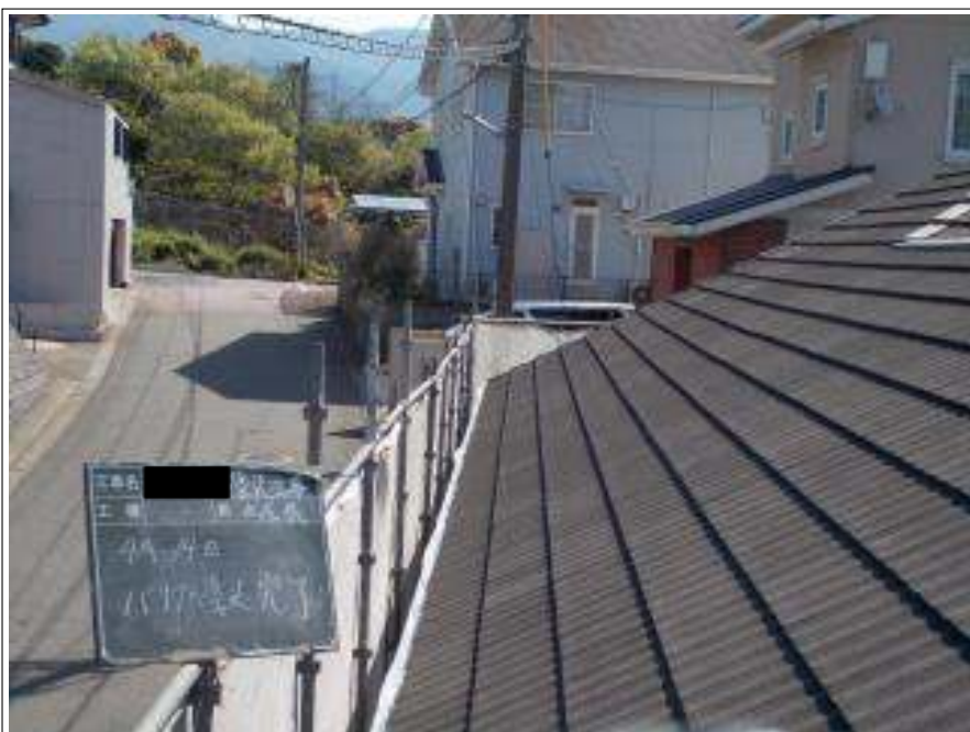
屋根バリアー施工完了
