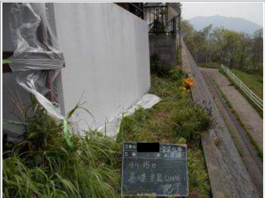
基礎塗装施工完了
