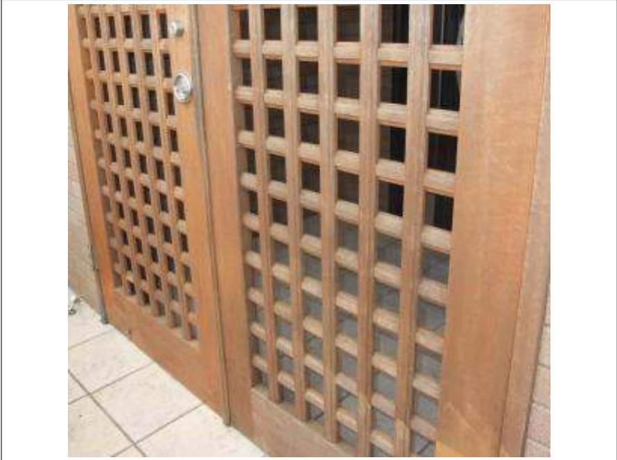
玄関木部塗装施工完了
