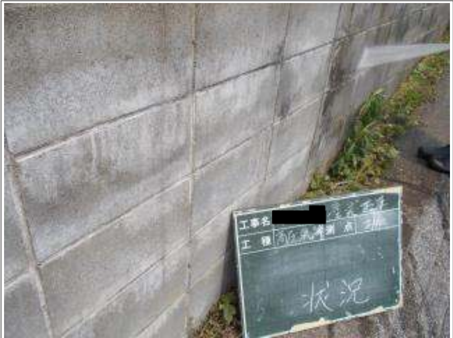
塀高圧洗淨施工中
