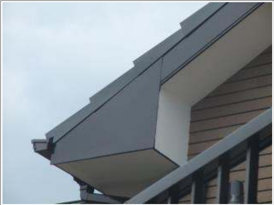
破風板 補修施工完了
