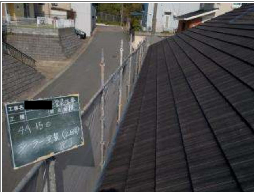
屋根下塗り塗装2回目施工完了
