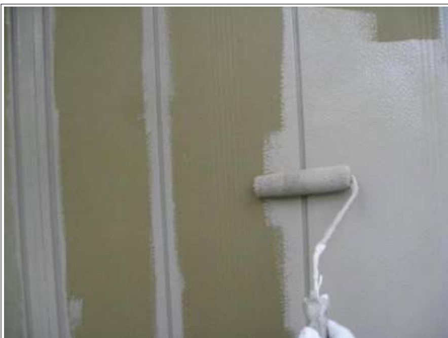
雨戸塗装施工中
