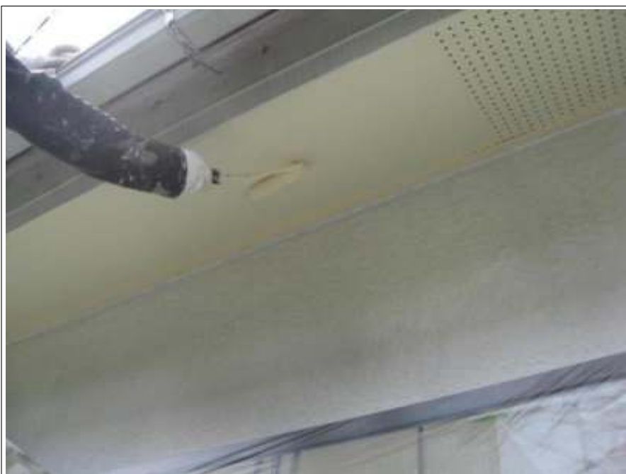
軒天塗装施工中
