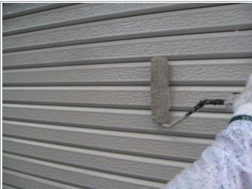
シャッター塗装施工中
