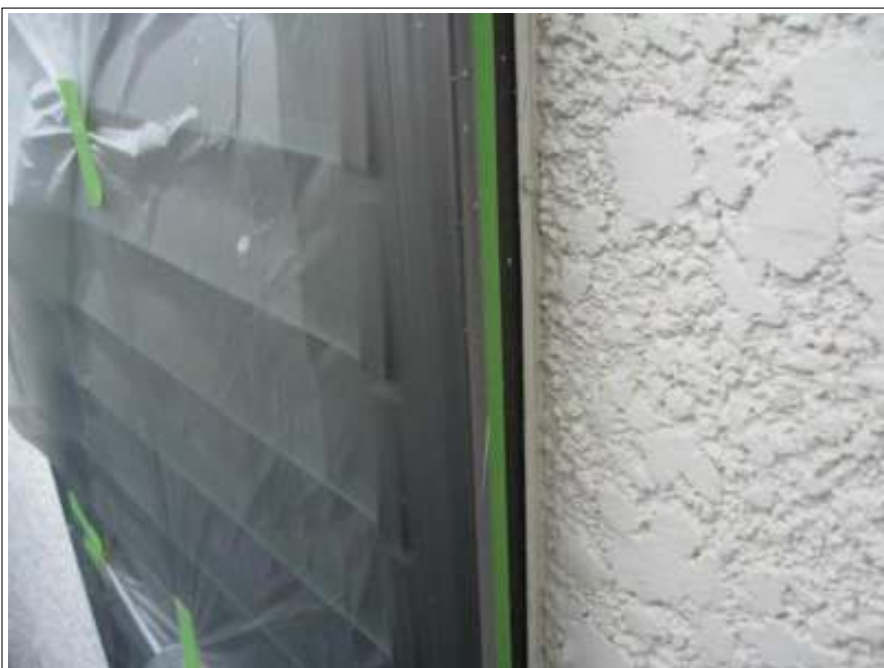
外壁シーリング補修施工前
