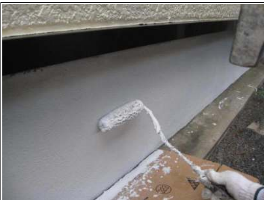
基礎塗装施工中
