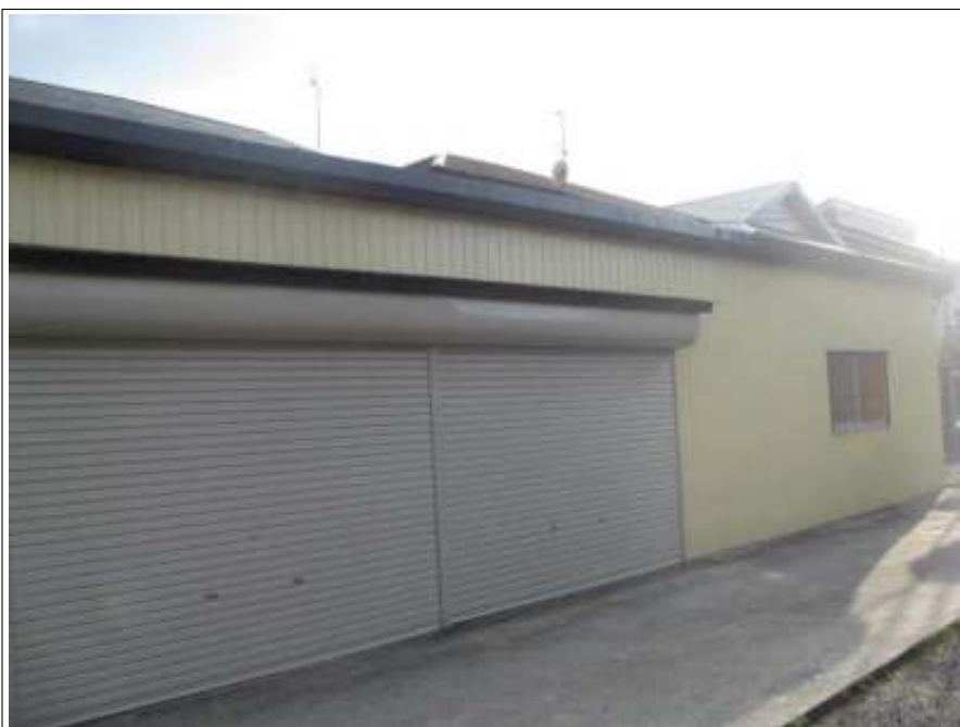
塗装施工完了
