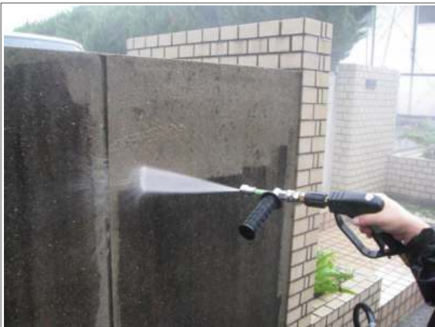
塀高压洗净施工中
