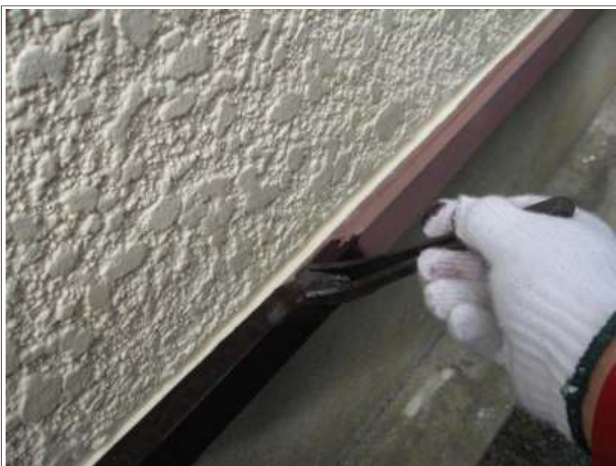
付帯塗装施工中
