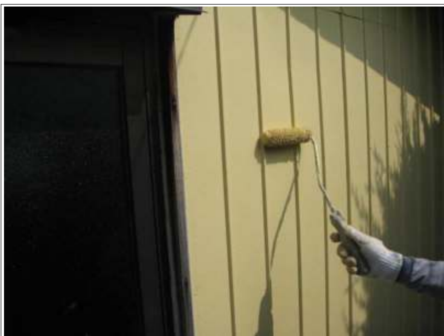
車庫塗装施工中
