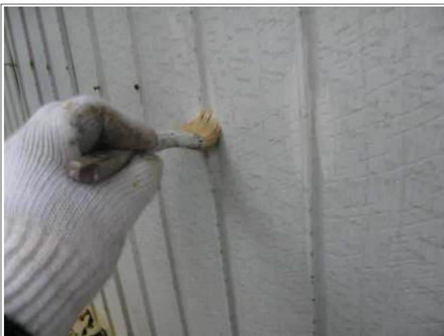
車庫塗装下塗り施工中
