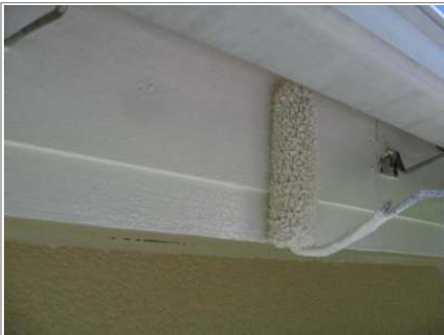
破風板塗装施工中
