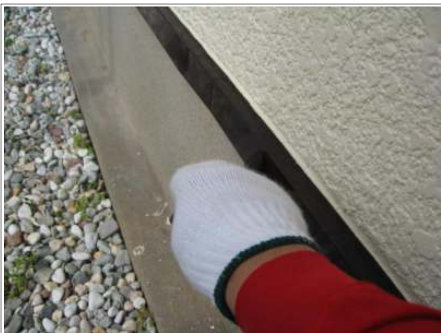
付帯塗装施工中
