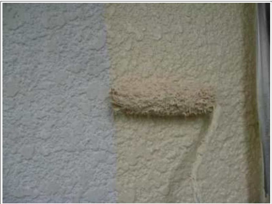
外壁塗装中塗り施工中
