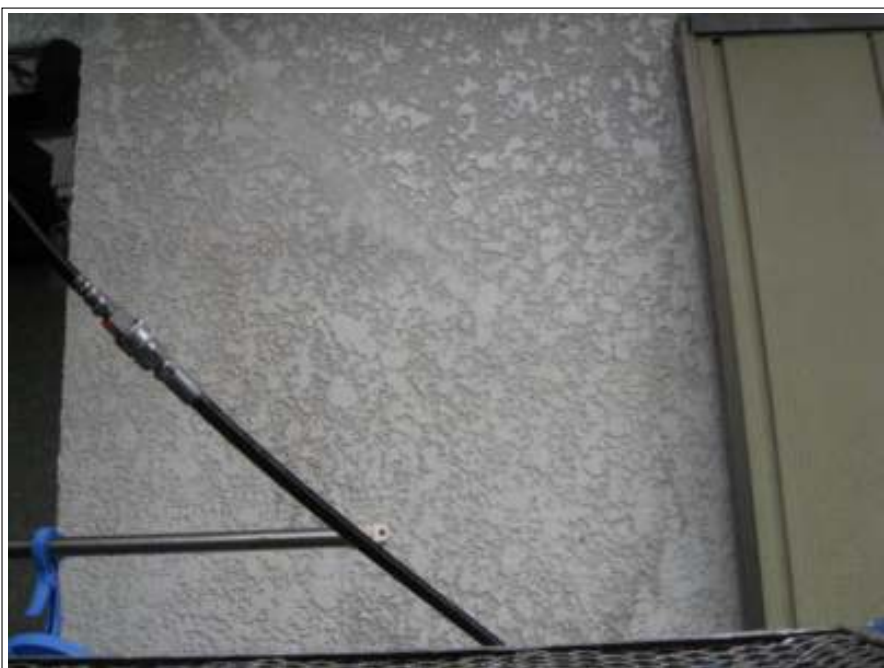
外壁高圧洗浄施工中
