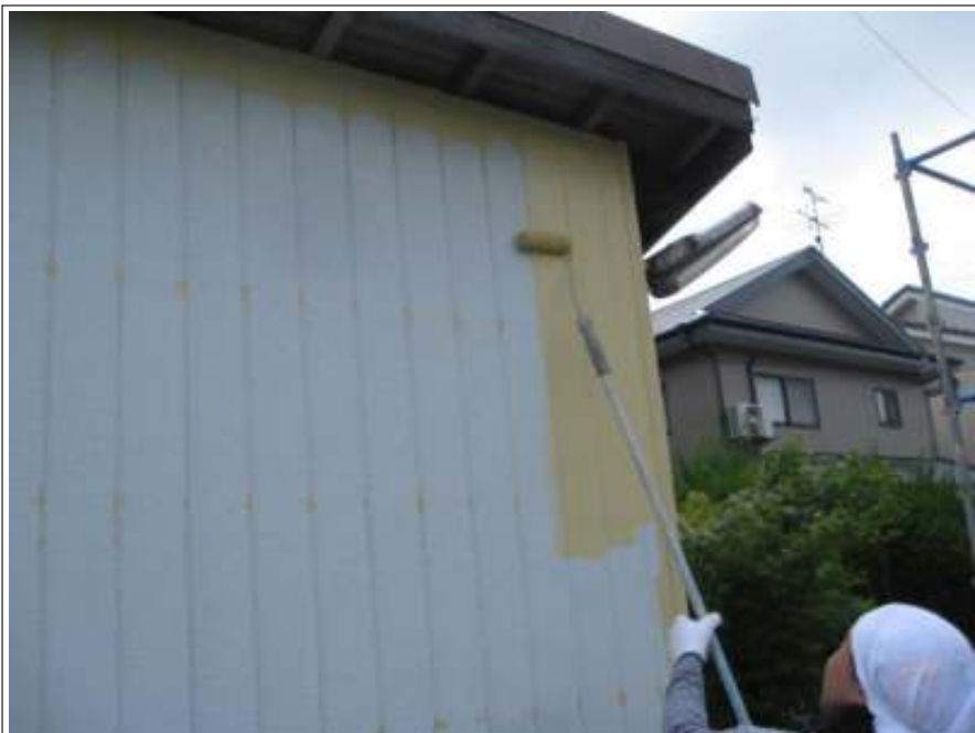
車庫塗装施工中
