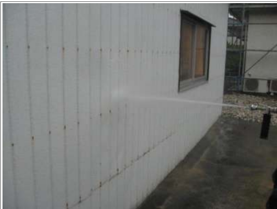
車庫高圧洗浄施工中
