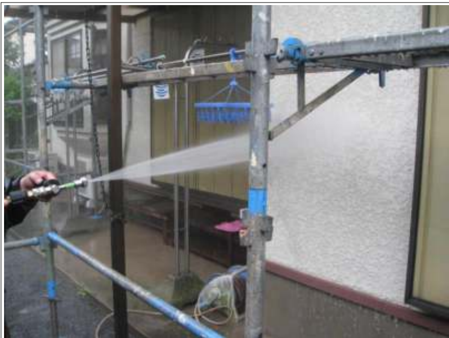
外壁高压洗净施工中
