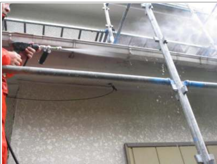
樋高圧洗浄施工中
