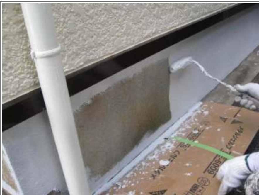
基礎塗装施工中
