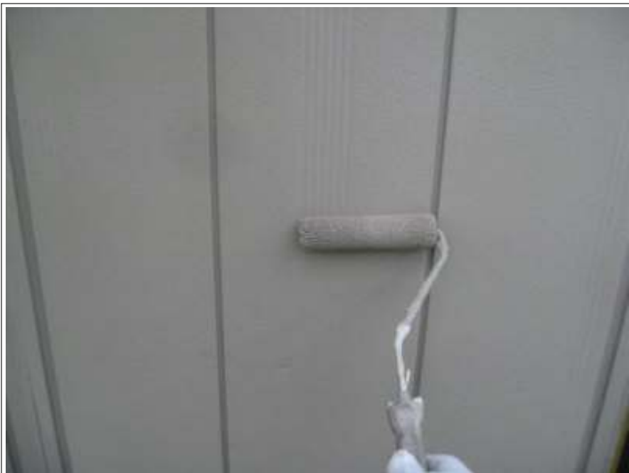
雨戸塗装施工中
