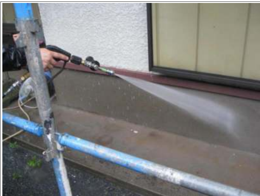
基礎高压洗净施工中
