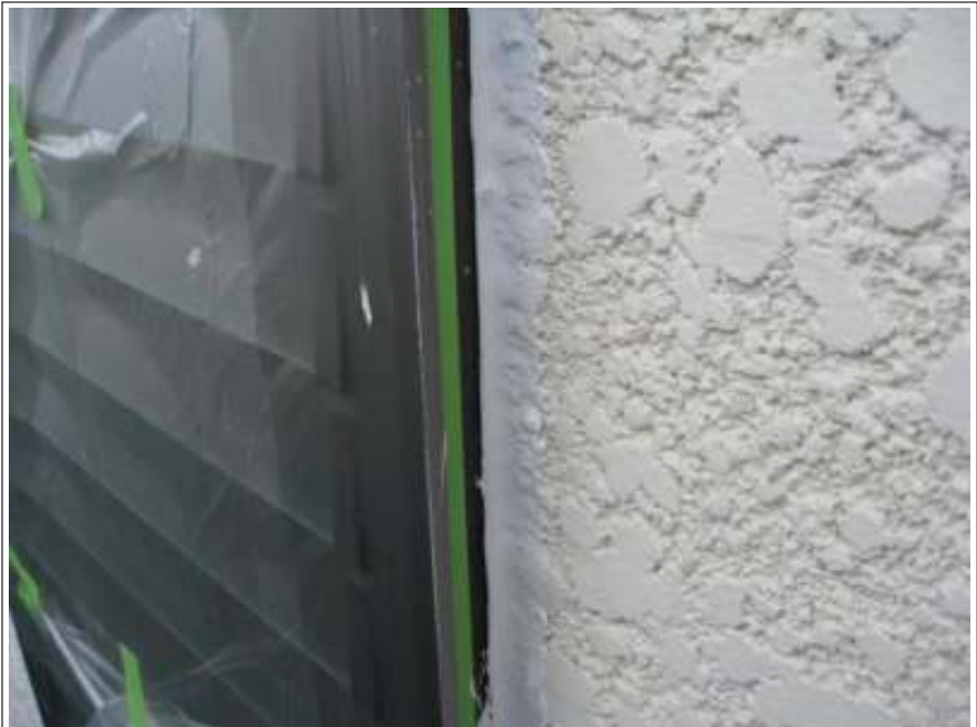
外壁シーリング補修施工完了
