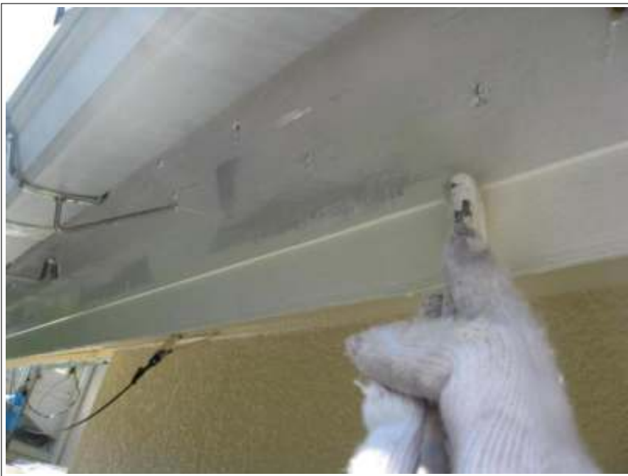
破風板塗装施工中
