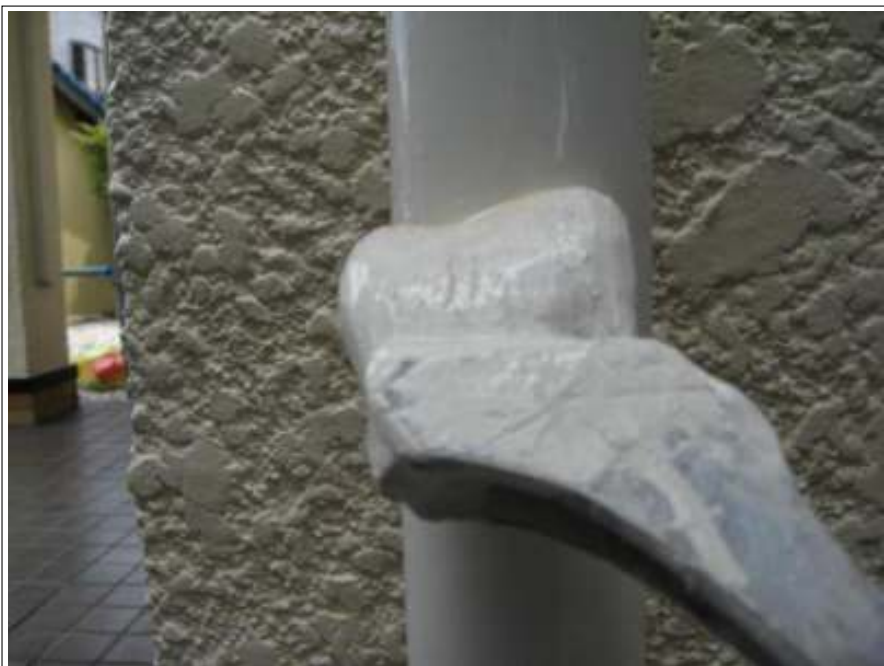
樋塗装施工中
