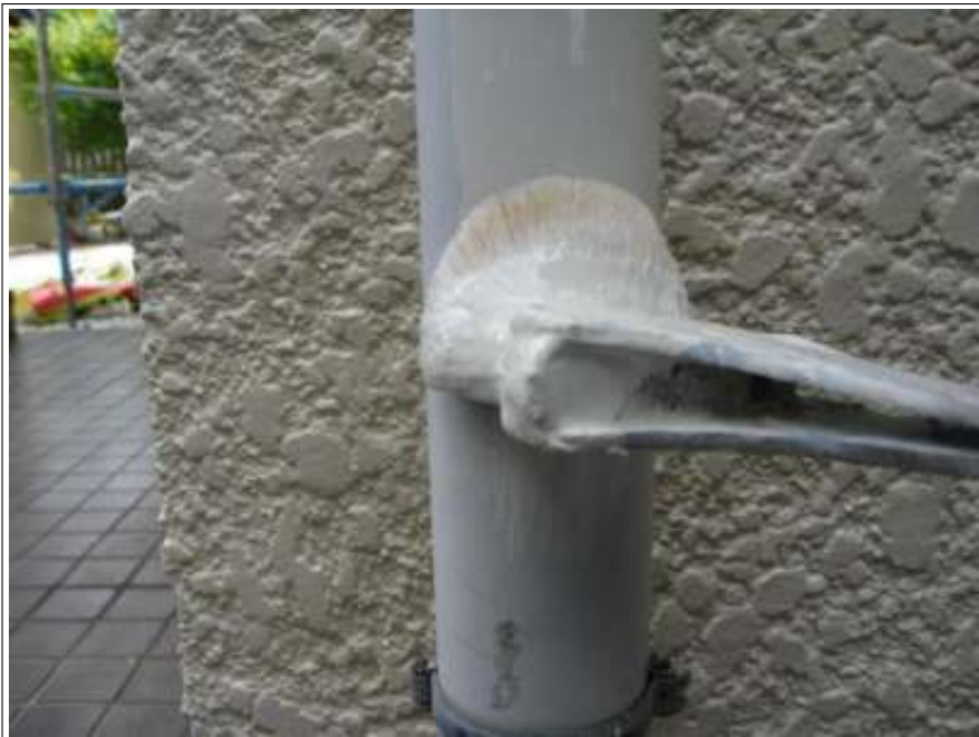
樋塗装施工中
