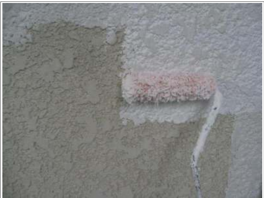
外壁塗装下塗り施工中
