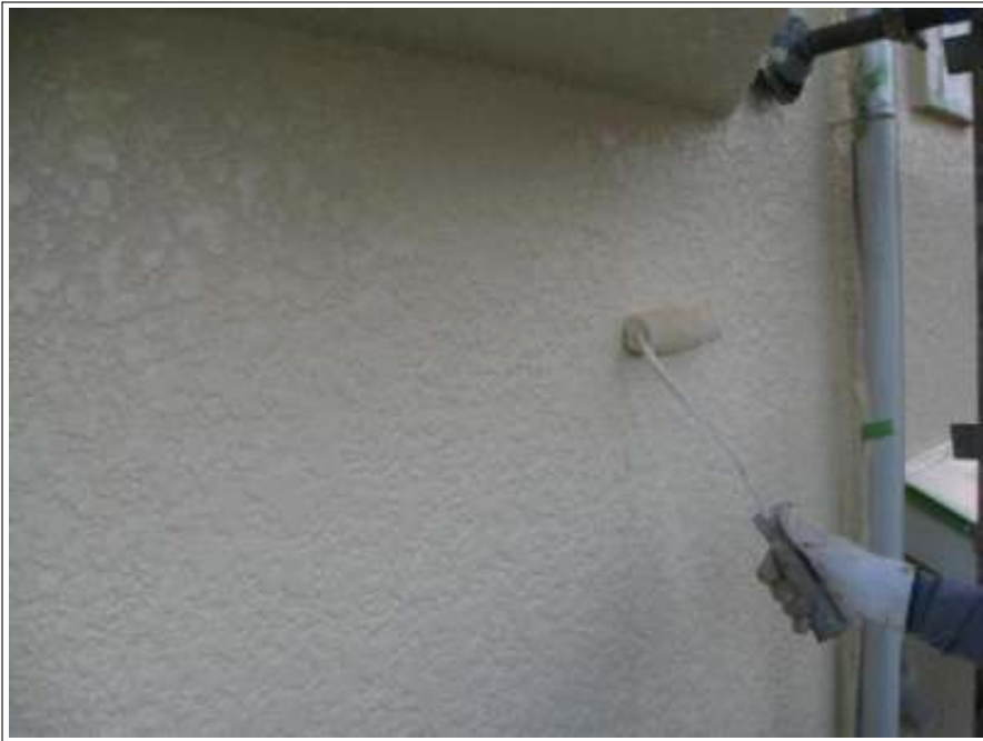
外壁塗装上塗り施工中
