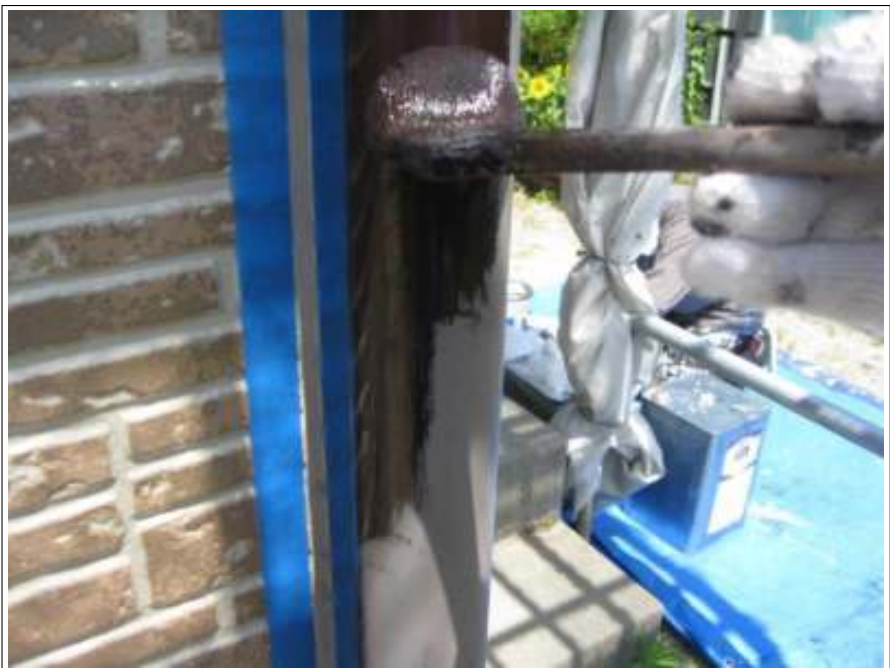
樋塗装施工中
