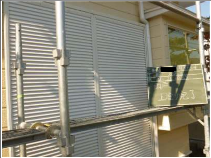
雨戸塗装施工完了
