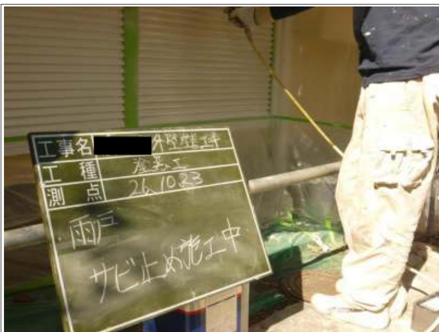
雨戸サビ止め施工中
