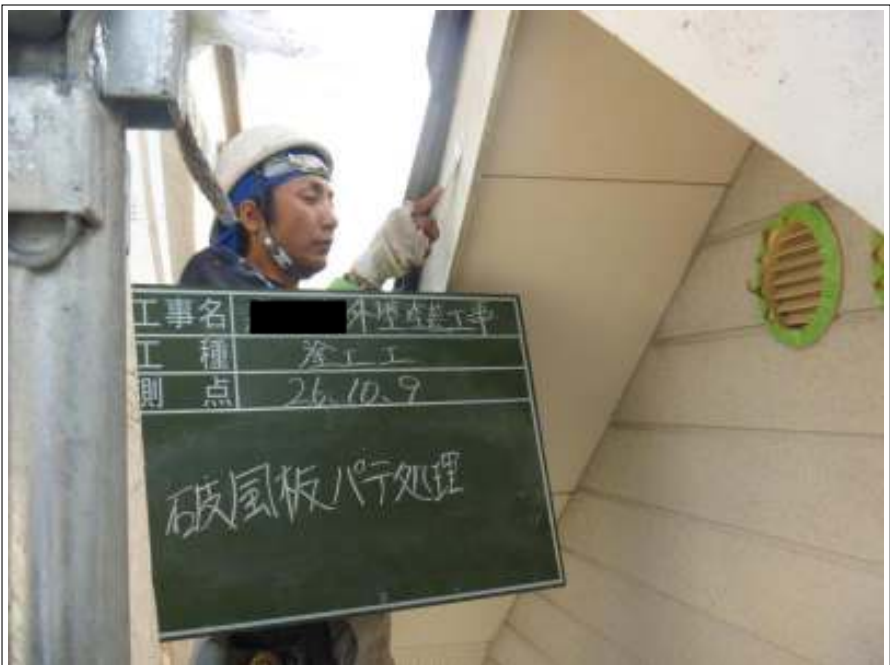
破風板パテ処理施工中
