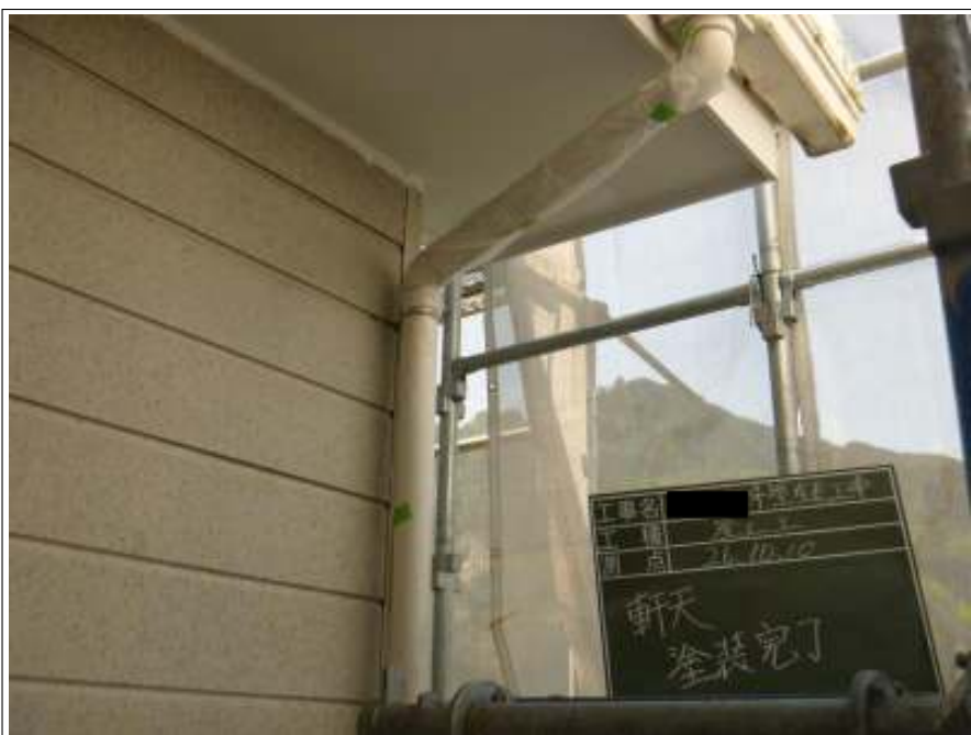
軒天塗装施工完了
