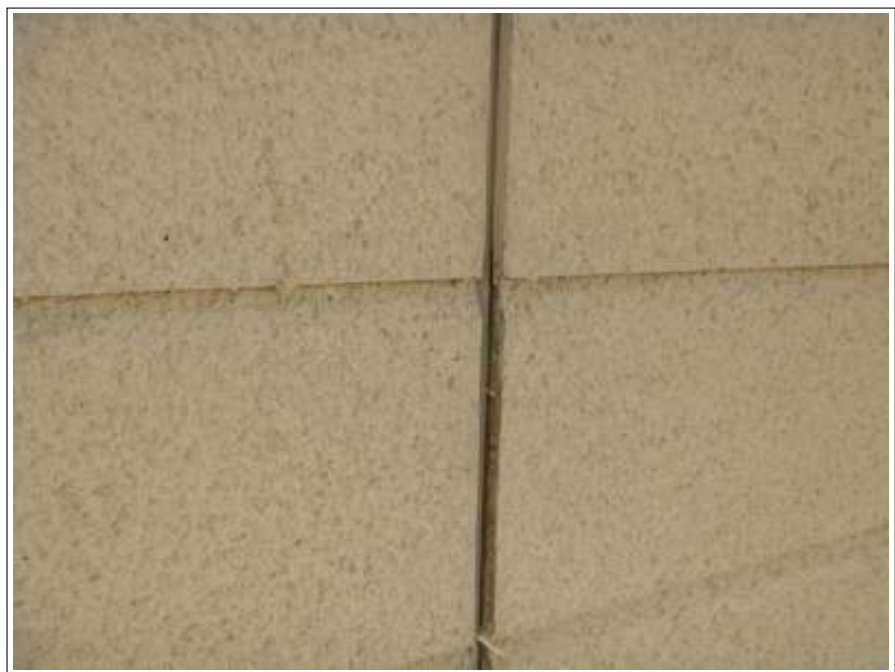
外壁シーリング撤去施工完了
