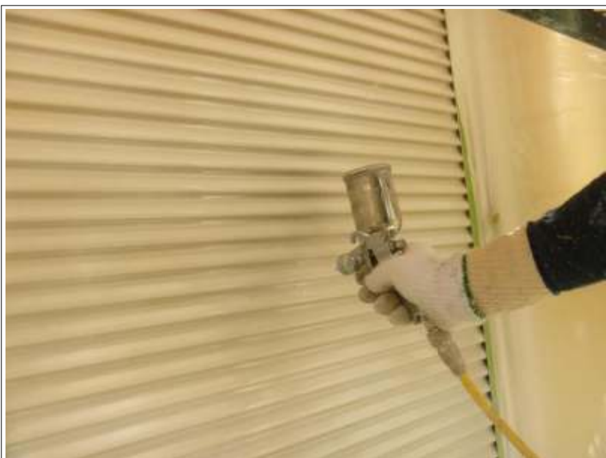
雨戸サビ止め施工中
