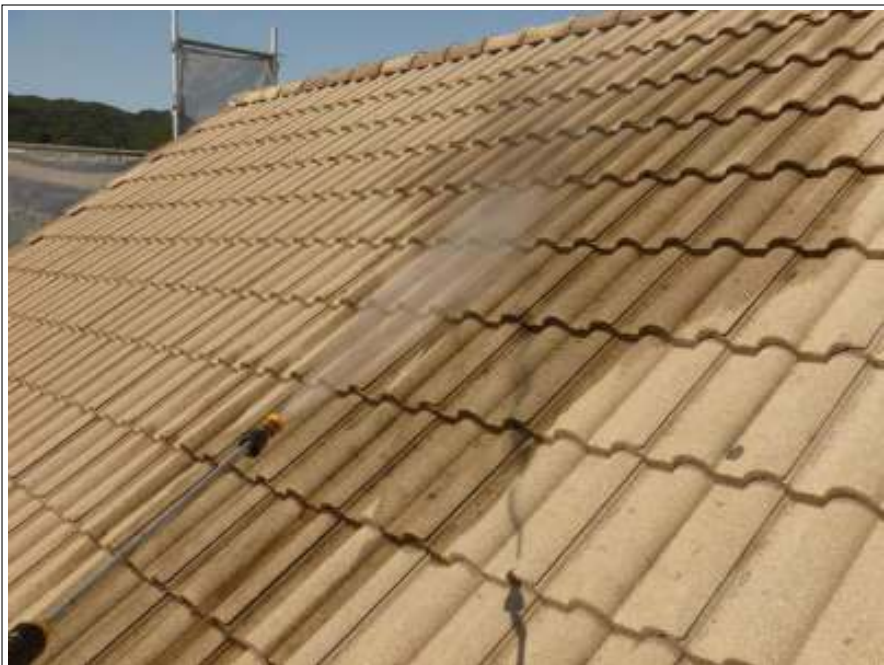
屋根高压洗净施工中
