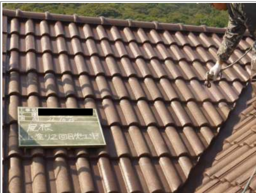
屋根塗装上塗り2回目施工中
