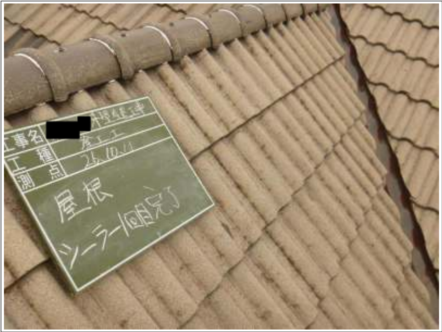
屋根塗装下塗り 1 回目施工完了
