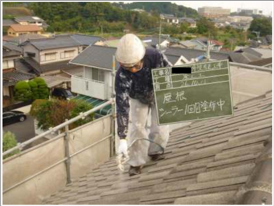
屋根塗装下塗り 1 回目施工中
