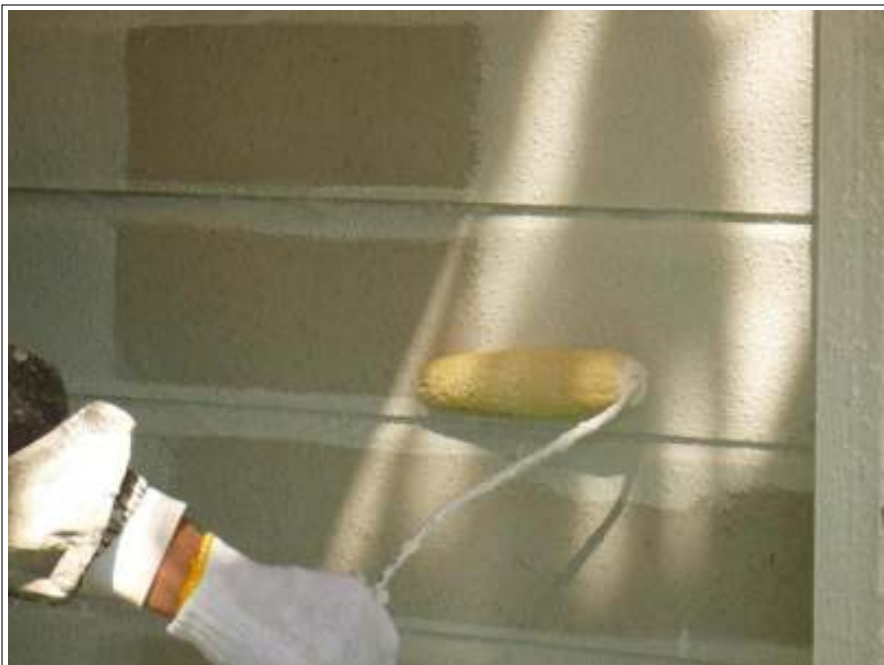
外壁塗装下塗り施工中
