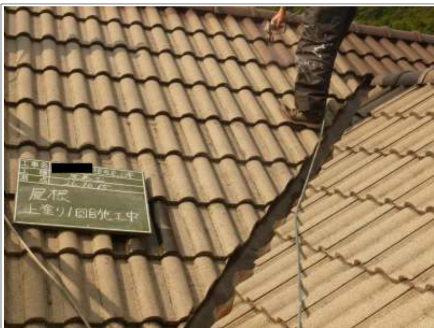
屋根塗装上塗り1回目施工中
