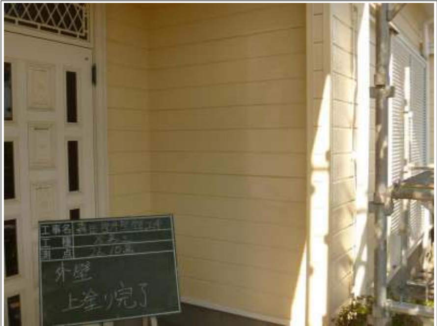
外壁塗装施工完了
