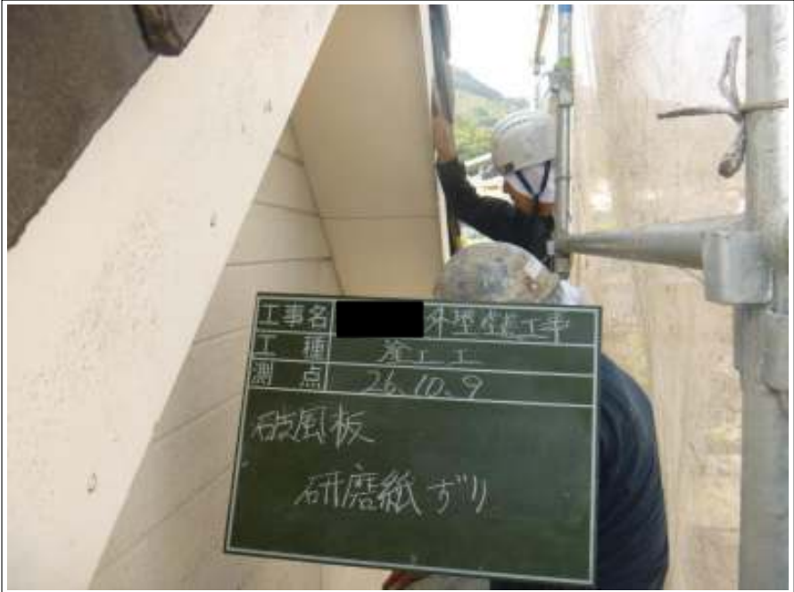
破風板ケレン施工中
