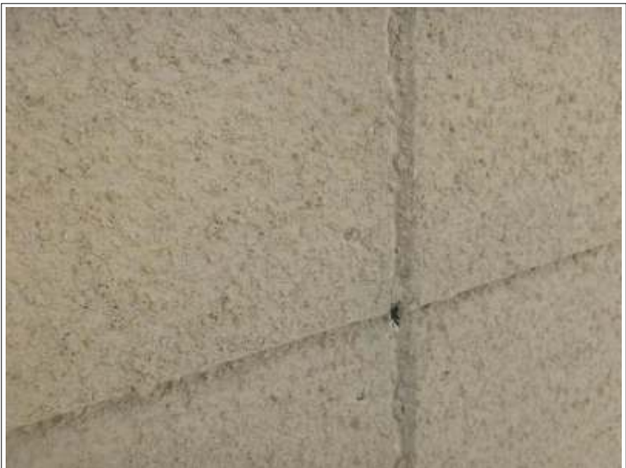
外壁シーリング補修施工前
