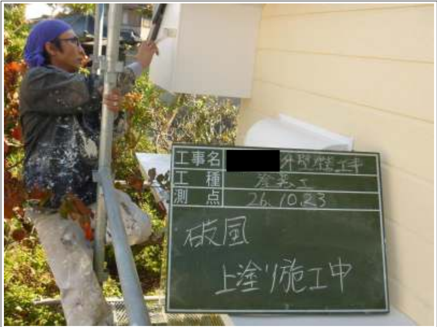
破風板塗装上塗り施工中
