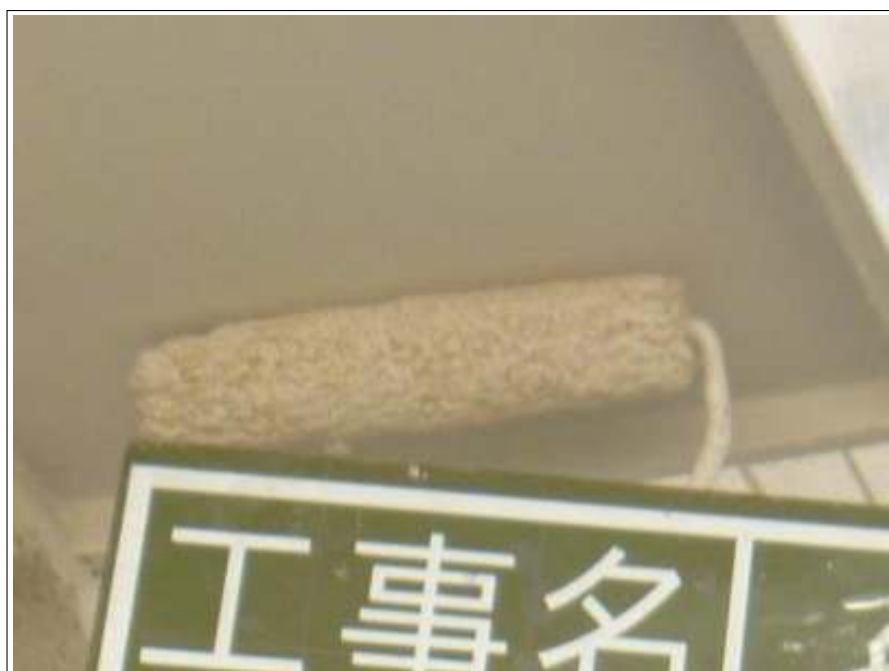
軒天塗装 1 回目施工中
