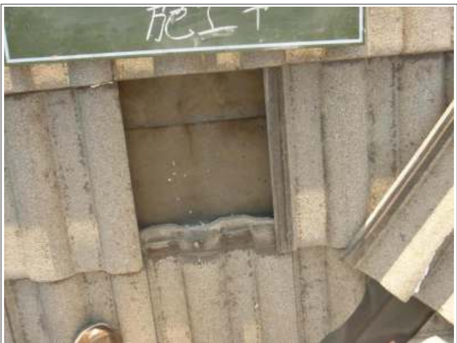
瓦葺き替え施工中
