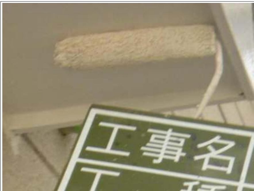
軒天塗装 2回目施工中
