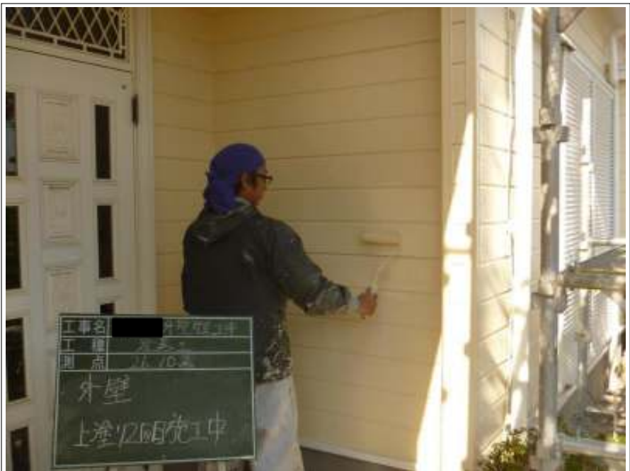
外壁塗装上塗り2回目施工中
