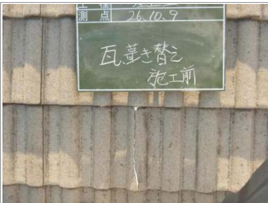
瓦葺き替え施工前
