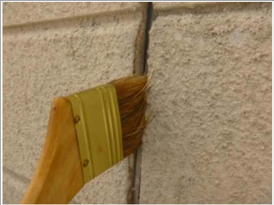
外壁シーリングプライマー施工中
