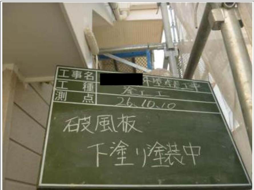
破風板塗装下塗り施工中
