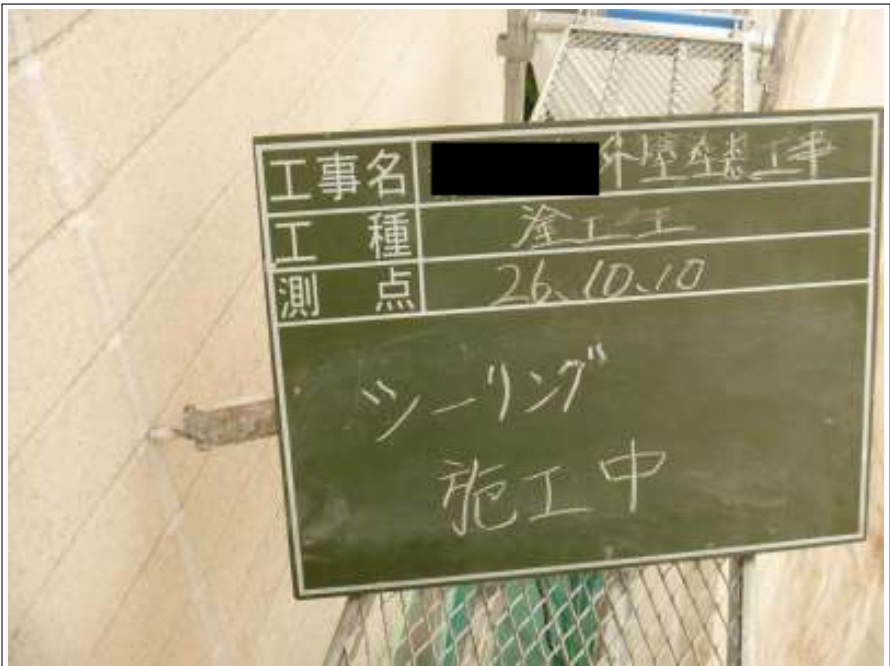
外壁シーリング補修施工中
