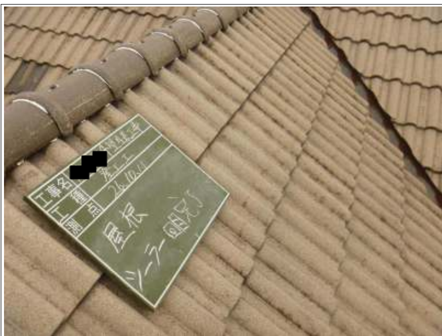
屋根塗装下塗り2回目施工完了
