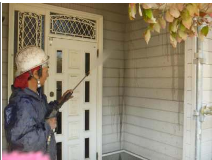
外壁高压洗净施工中
