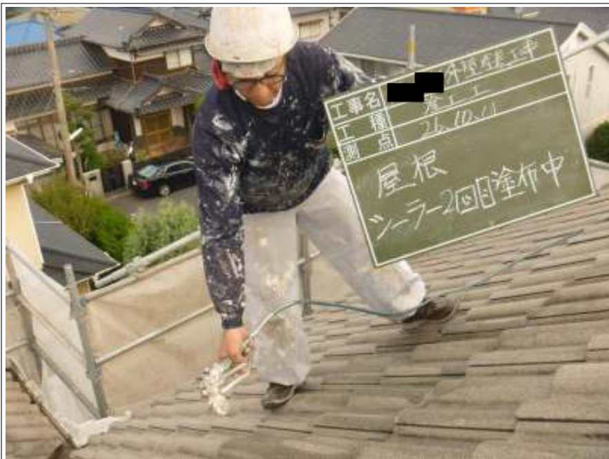
屋根塗装下塗り2回目施工中
