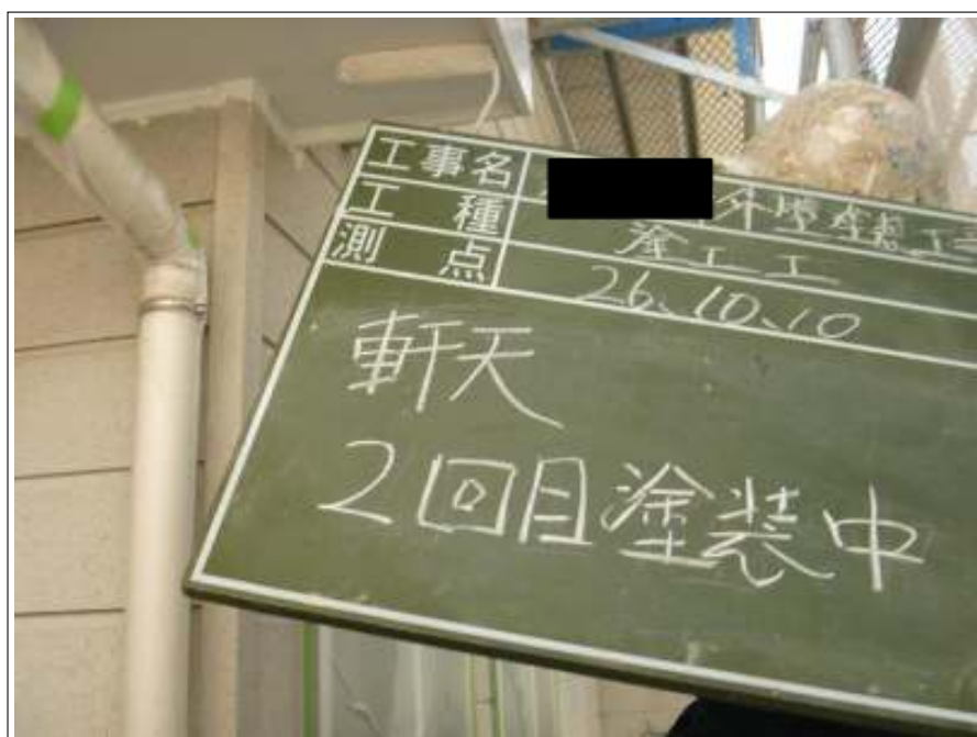
軒天塗装 2 回目施工中
