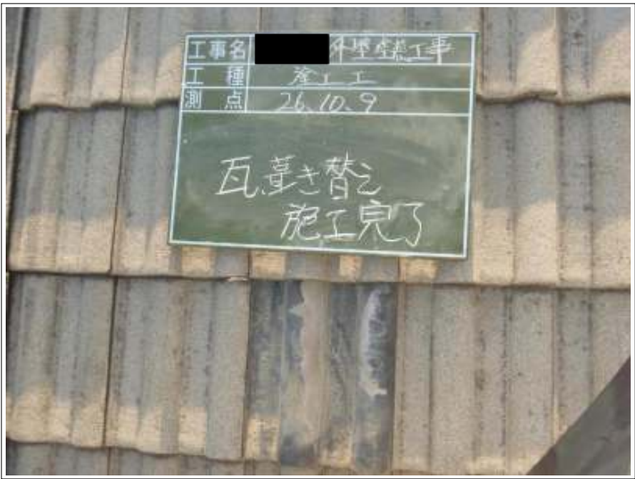
瓦葺き替え施工完了
