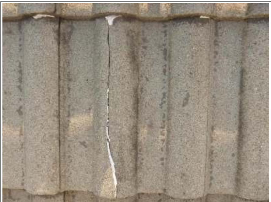
瓦葺き替え施工前
