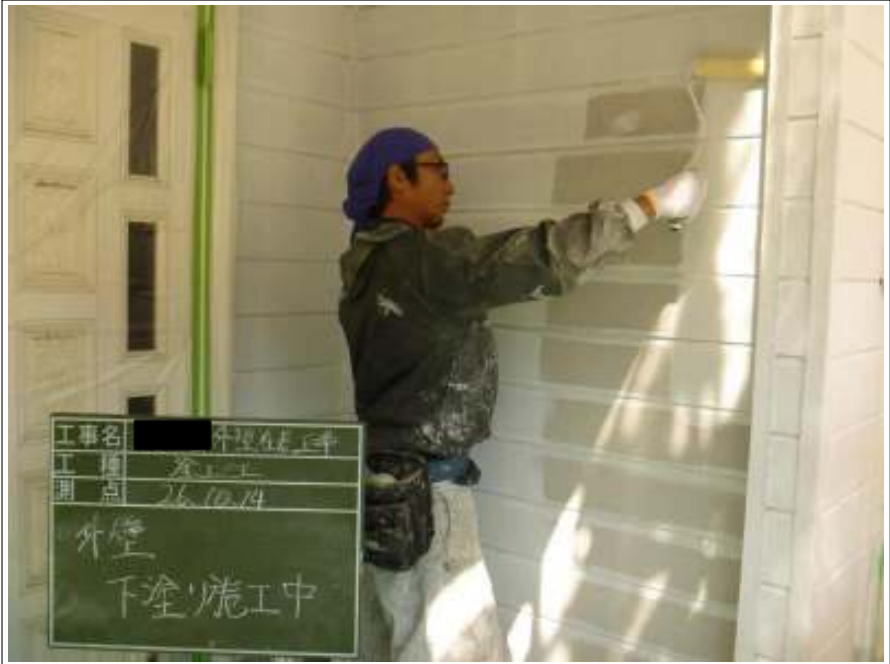
外壁塗装下塗り施工中
