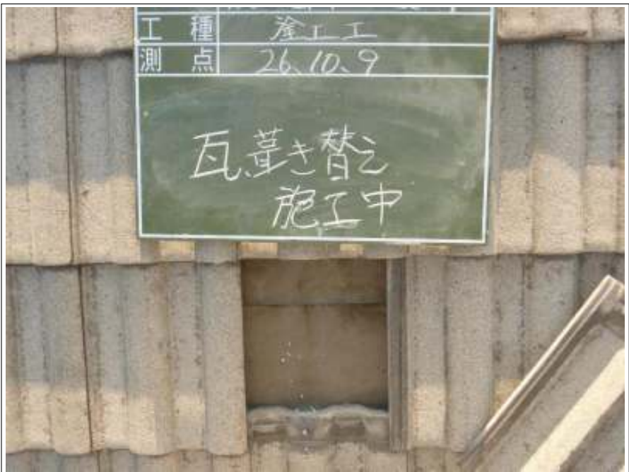
瓦葺き替え施工中
