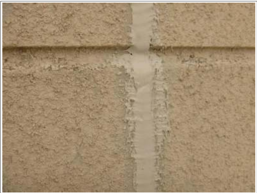
外壁シーリング補修施工完了
