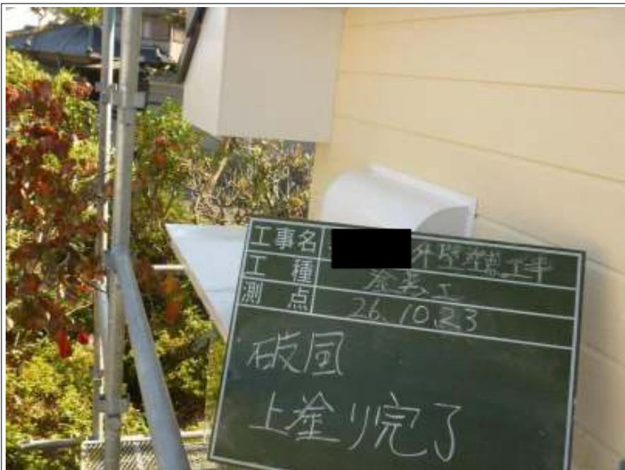
破風板塗装施工完了
