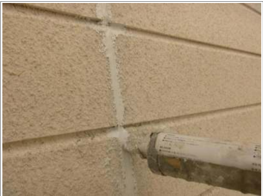
外壁シーリング補修施工中
