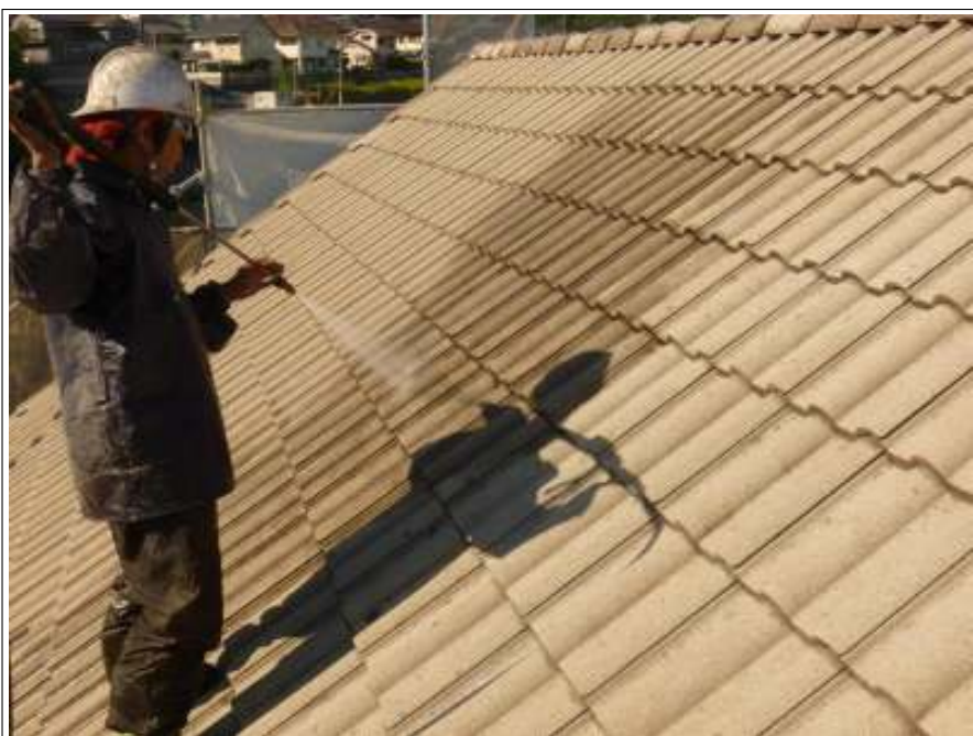
屋根高压洗净施工中
