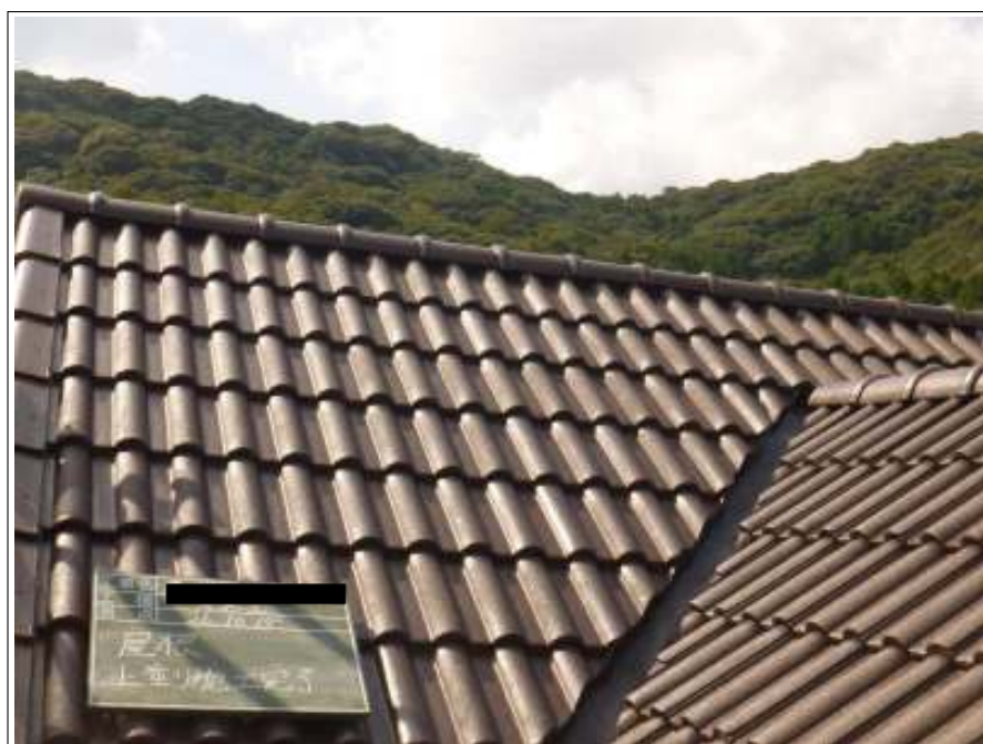
屋根塗装施工完了
