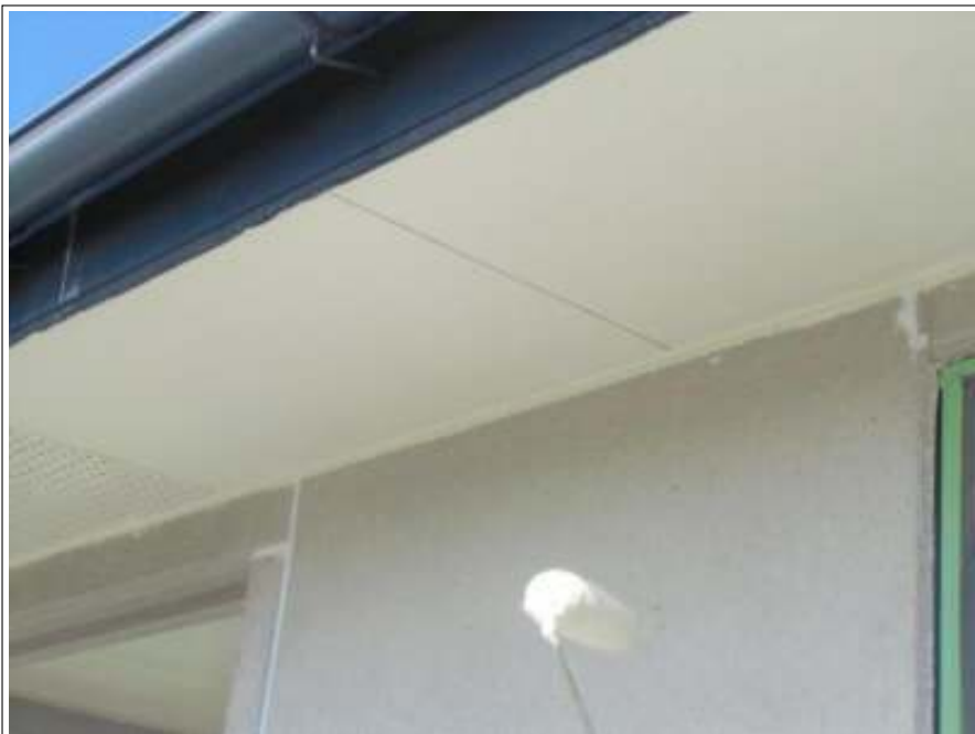
軒天塗装 2回目施工中
