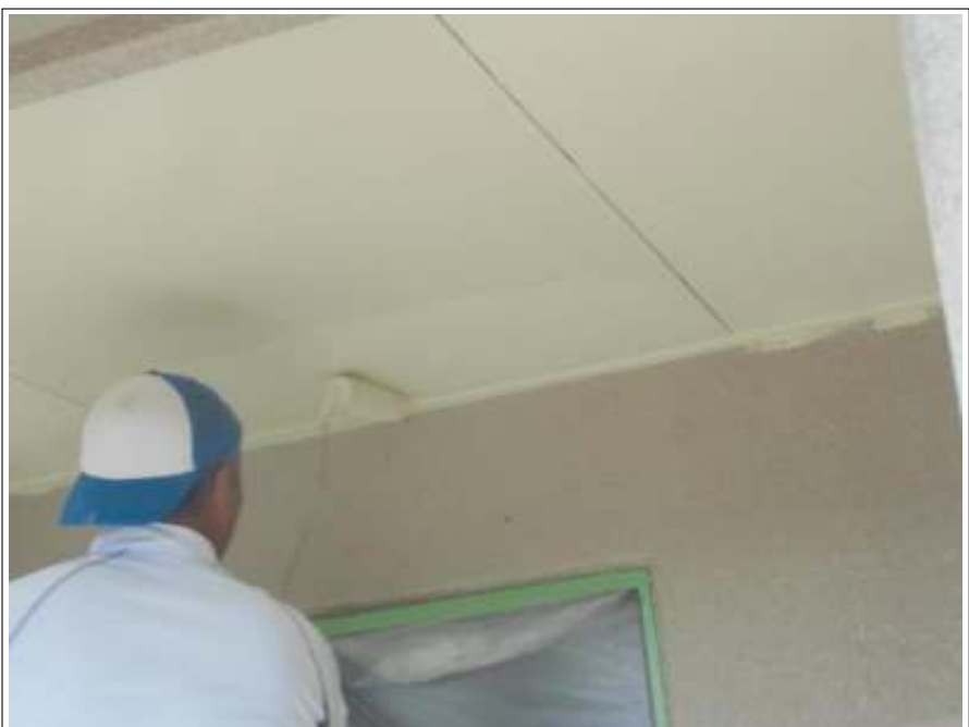
軒天塗装 2 回目施工中
