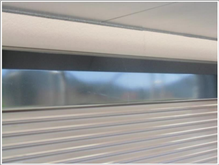
シャッターボックス施工完了
