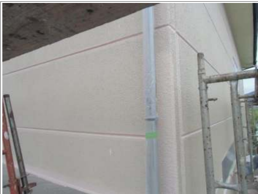
外壁塗装中塗り施工中
