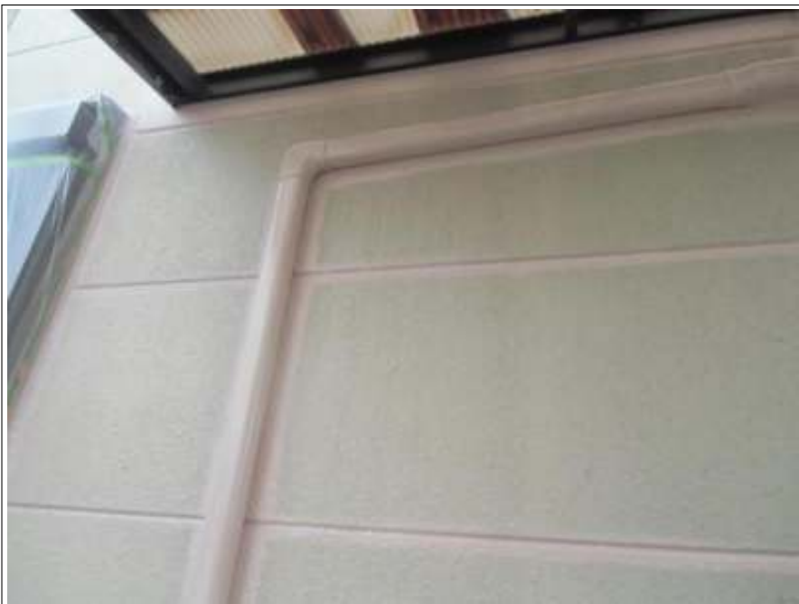
外壁塗装中塗り施工中
