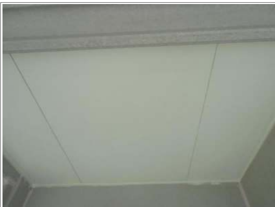
玄関部軒天施工完了
