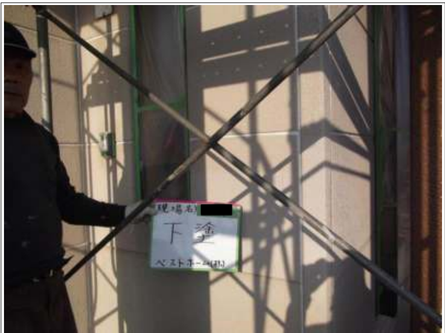
外壁塗装下塗り施工完了
