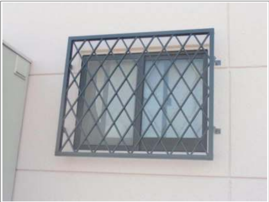
窓格子取付施工完了
