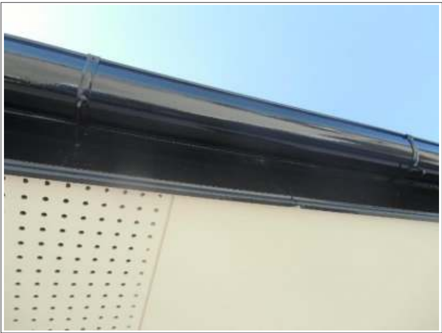
樋塗装施工完了
