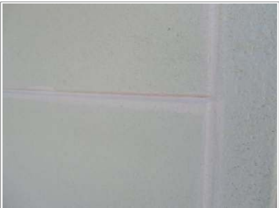
外壁塗装中塗り施工中
