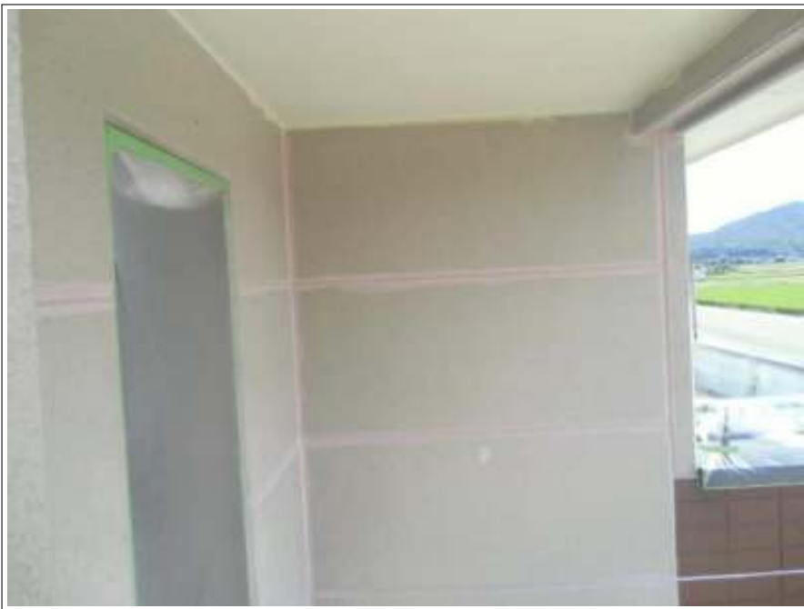
外壁塗装中塗り施工中
