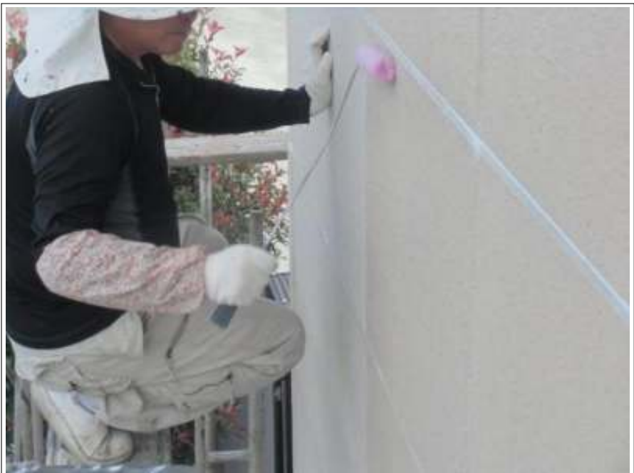
外壁塗装下塗り施工中
