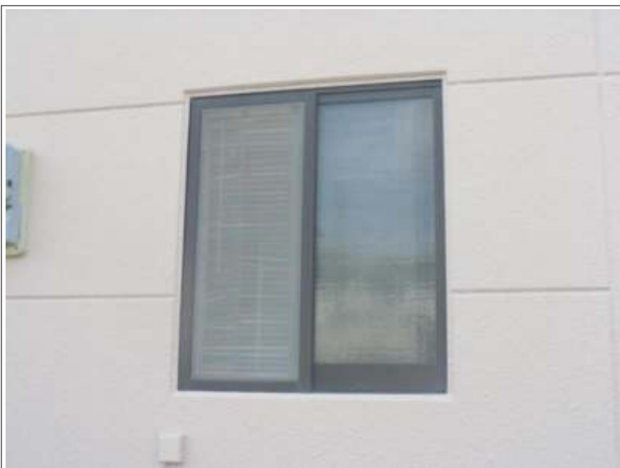
窓格子取付施工前
