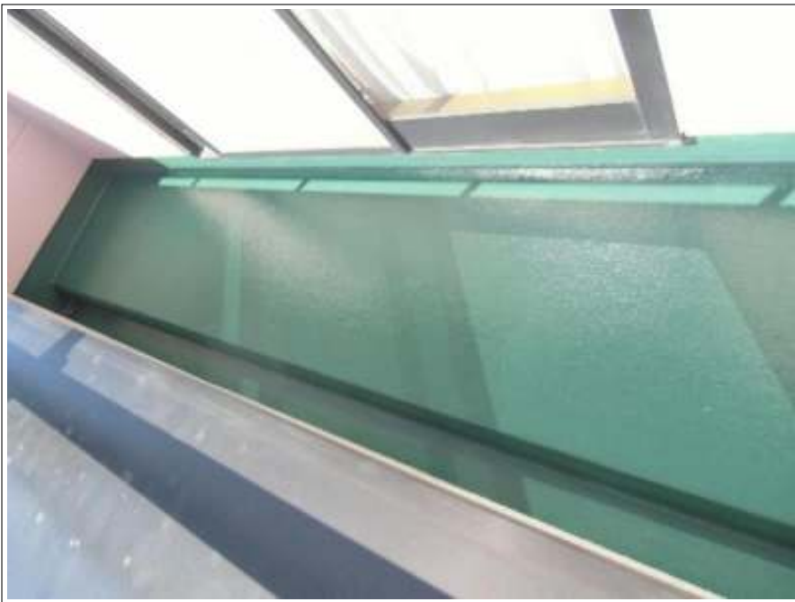
ベランダ塗装施工完了
