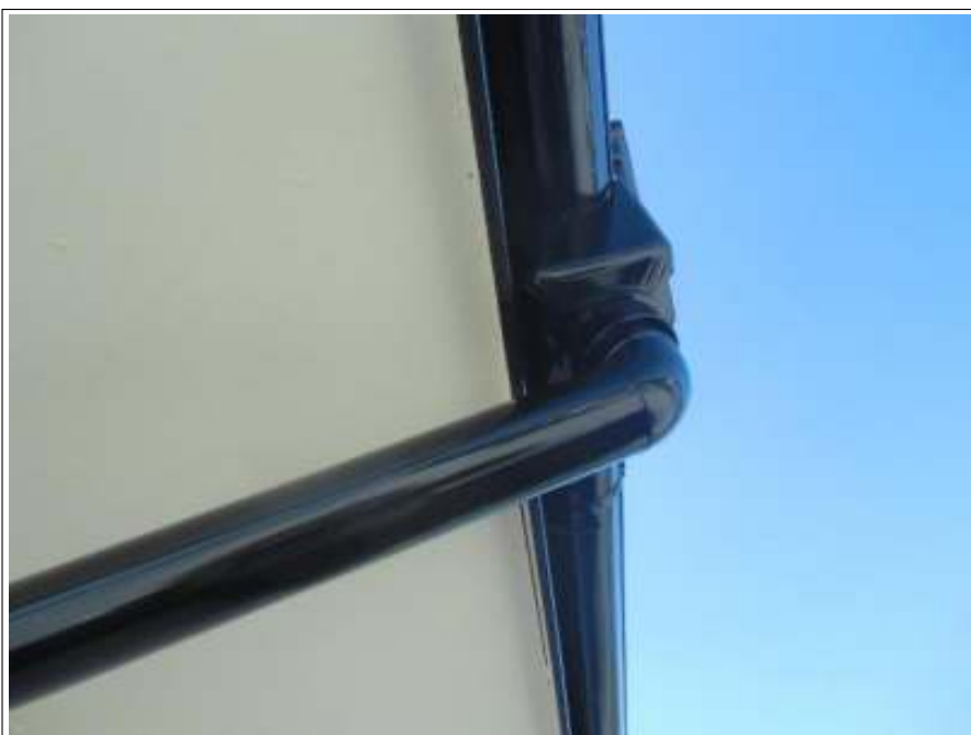
樋塗装施工完了
