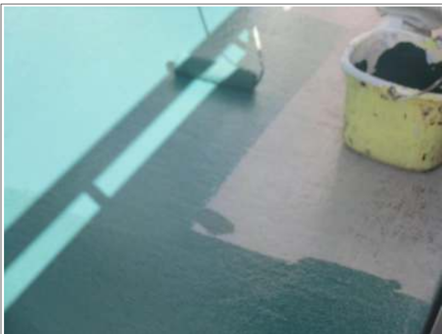
ベランダ塗装施工中
