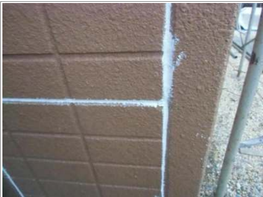
外壁シーリング補修施工完了
