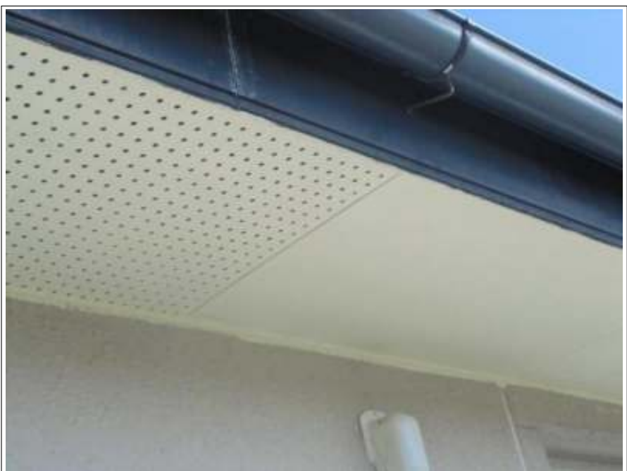
軒天塗装 1 回目施工完了
