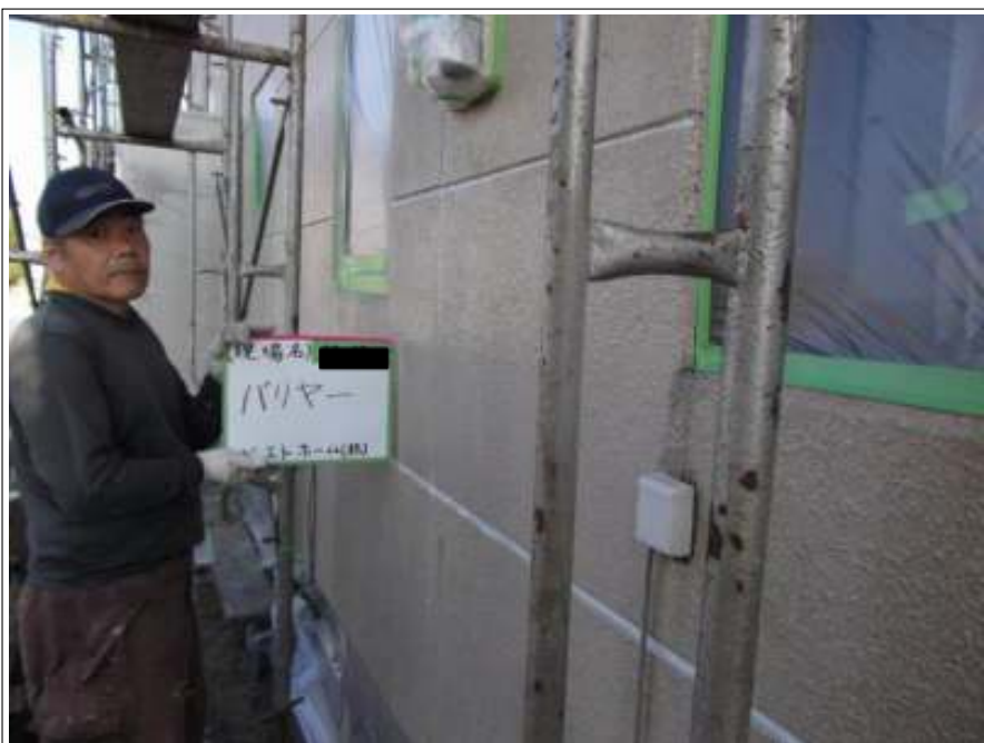
外壁塗装バリアー施工完了
