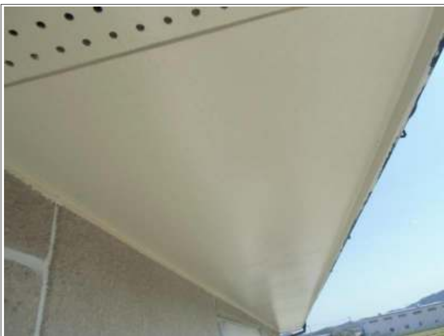
軒天塗装施工完了
