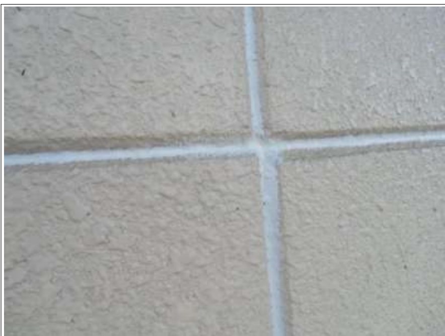
外壁シーリング補修施工完了
