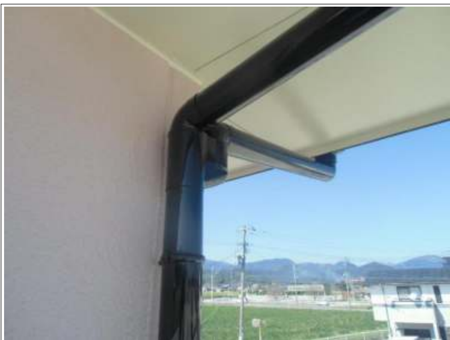
樋塗装施工完了
