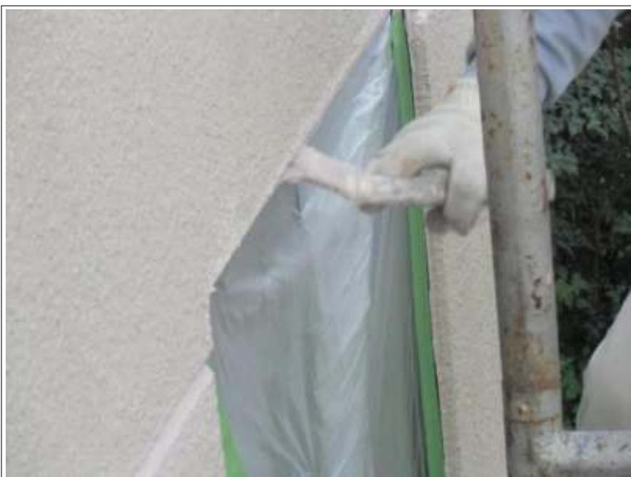
外壁塗装中塗り施工中
