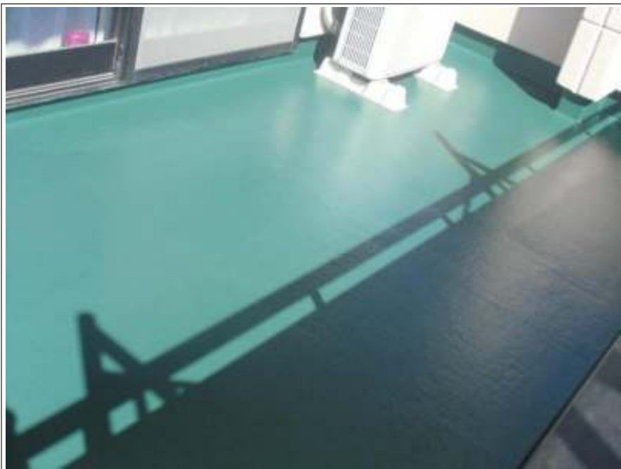
ベランダ塗装施工完了
