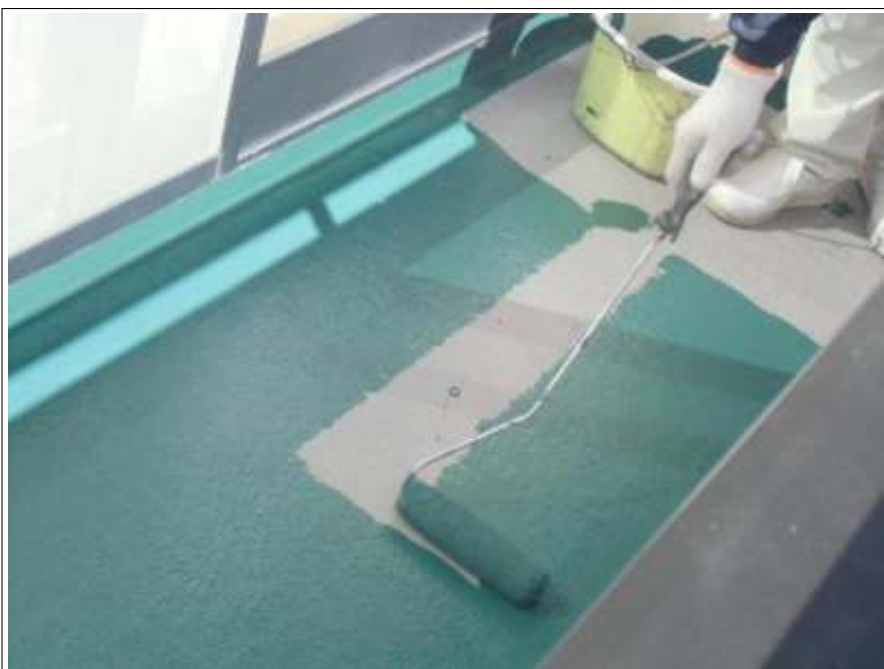
ベランダ塗装施工中
