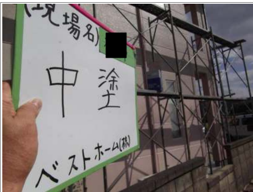
外壁塗装中塗り施工完了
