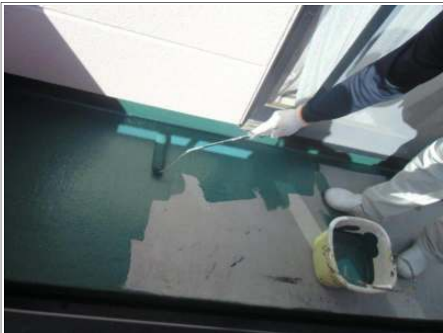
ベランダ塗装施工中
