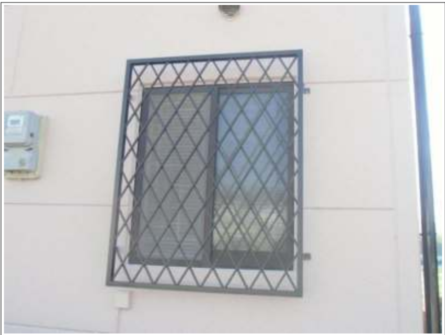
窓格子取付施工完了
