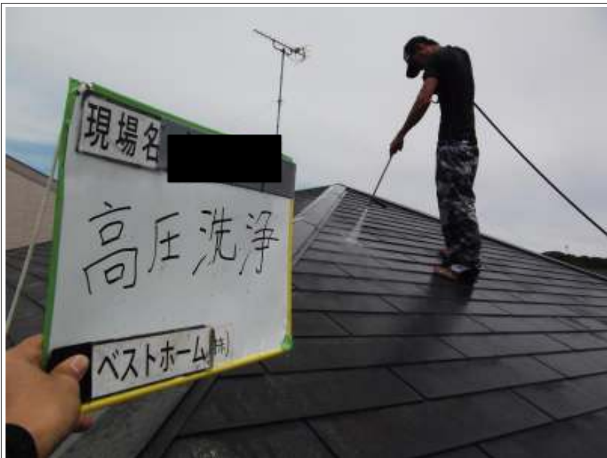
屋根高圧洗浄施工中
