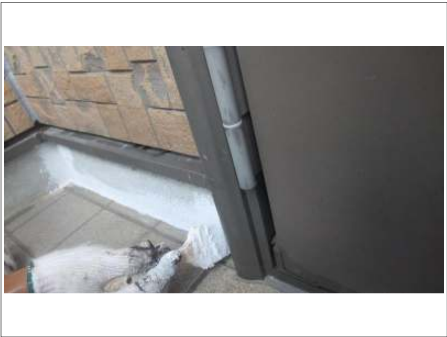
基礎塗装施工中
