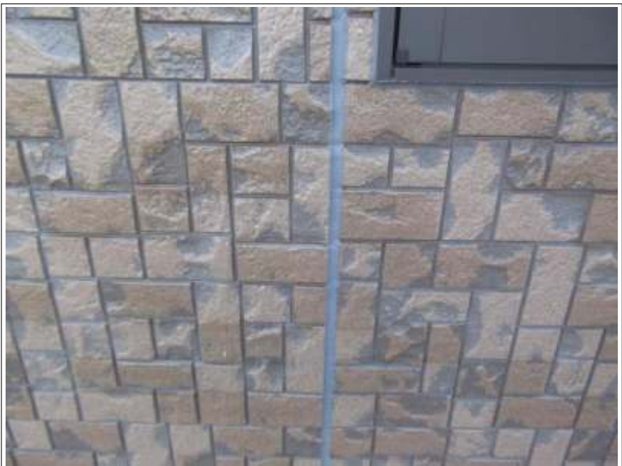
外壁コーキング補修施工完了
