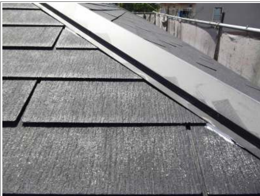
屋根棟鉄板ラバー止め施工中
