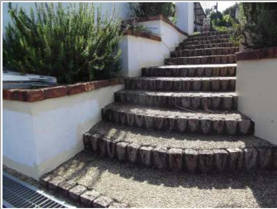
塀塗装上塗り施工中
