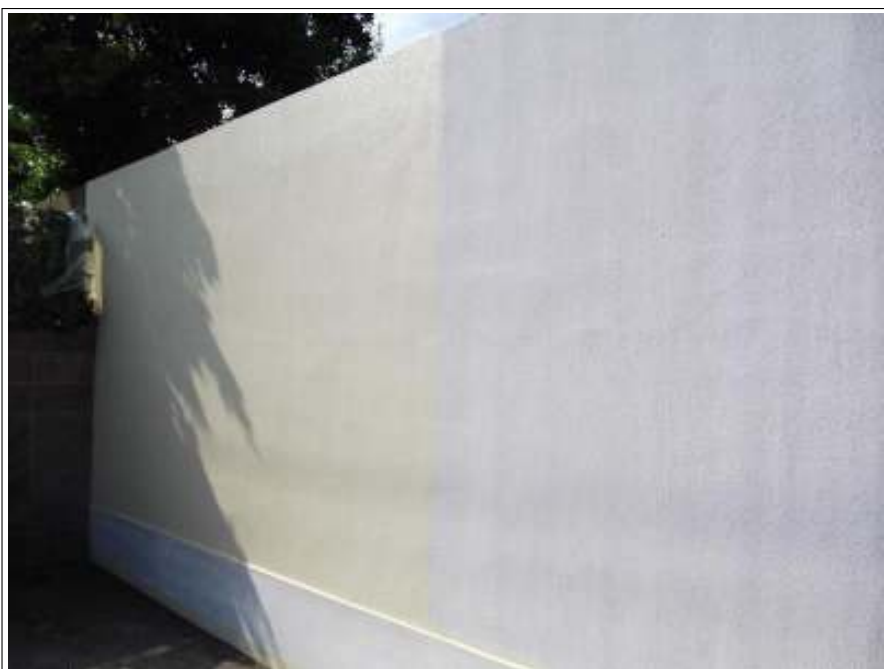
塀塗装上塗り施工中
