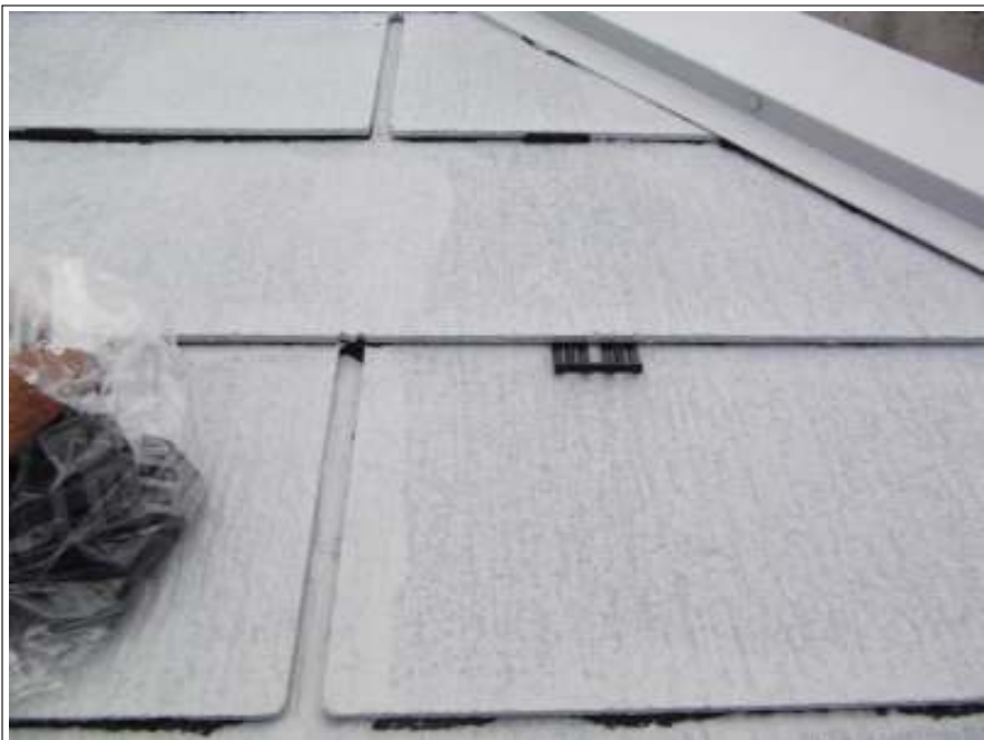
屋根タスペーサー施工中
