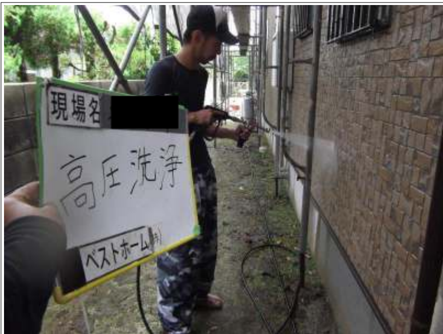
外壁高压洗浄施工中
