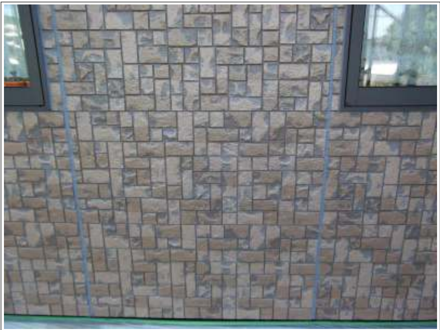
外壁コーキング補修施工完了
