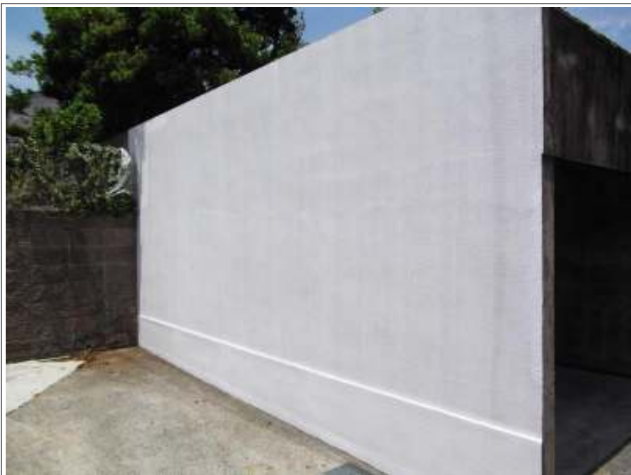
塀塗装下塗り施工完了
