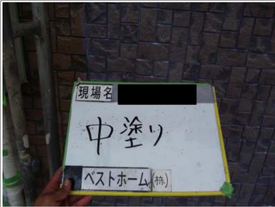
外壁塗装中塗り施工中
