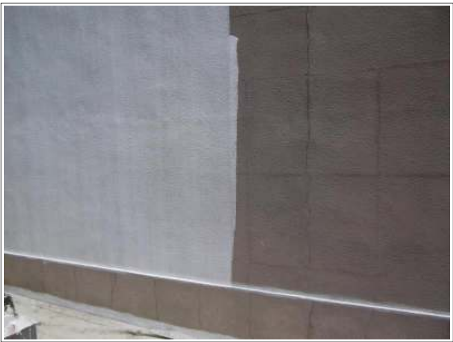
塀塗装下塗り施工中
