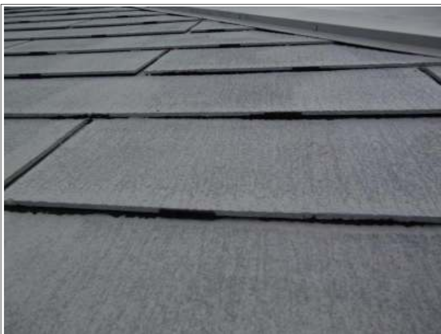
屋根タスペーサー施工完了
