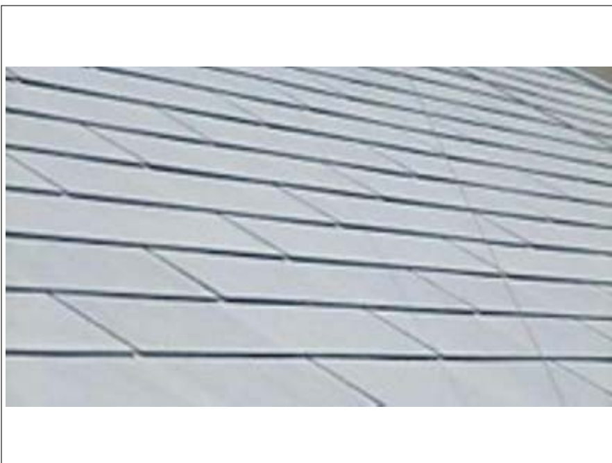
屋根塗装下塗り施工完了
