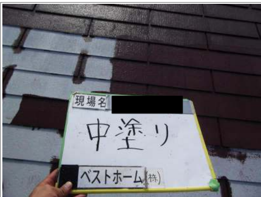
屋根塗装中塗り施工中
