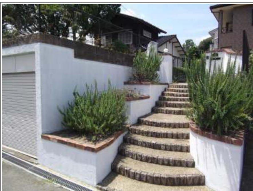
塀塗装下塗り施工完了
