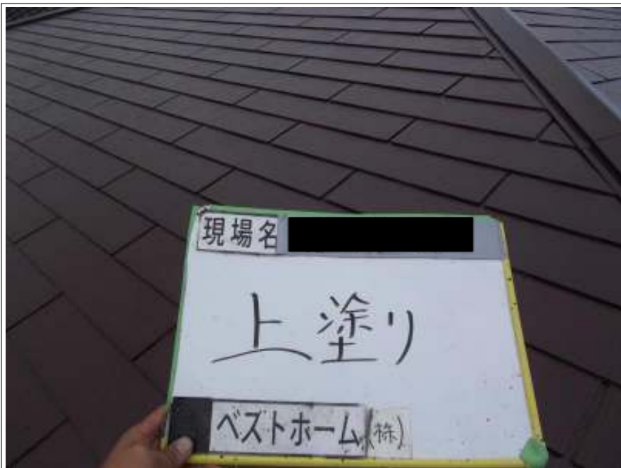
屋根塗装上塗り施工完了
