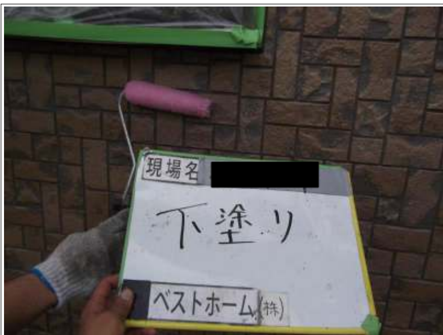
外壁塗装下塗り施工中
