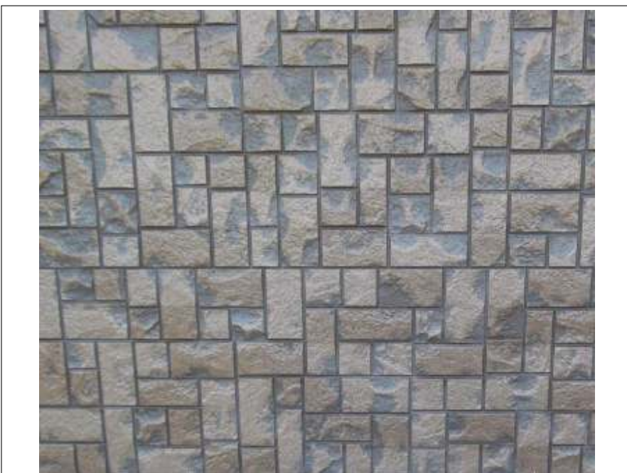
外壁塗装上塗り施工完了
