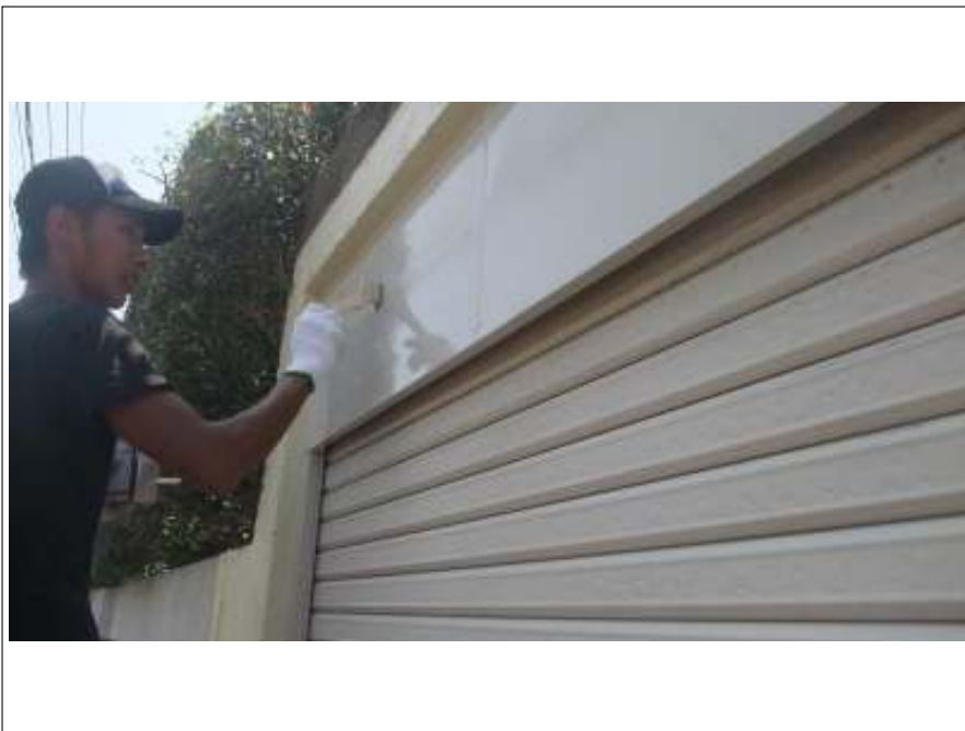
車庫シャッター塗装施工中
