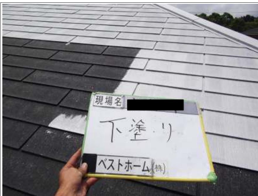
屋根塗装下塗り施工中
