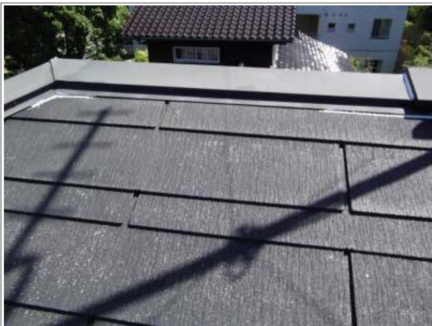
屋根棟鉄板ラバー止め施工完了
